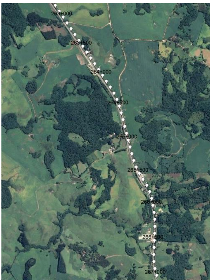
Figura 13 – Segmento do Km 263+000 ao 267+000 Fonte - Google Earth (2018)
