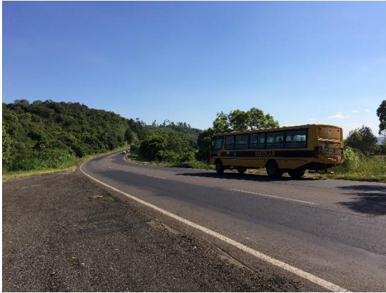
Figura 566 – Travessia de escolares sem sinalização horizontal, Fontoura Xavier, Coord.: S29°5'56.03"; W52°14'59.26".
