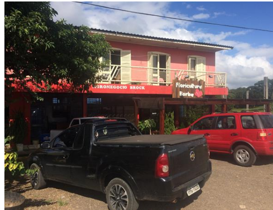
Figura 556 – Estabelecimento comercial passível de desapropriação- Coord.: S28°58'42.77"; W52°22'2.63".
