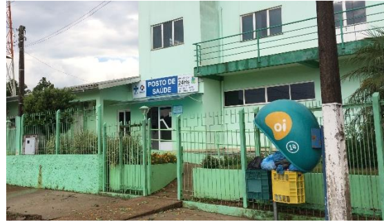
Figura 451 – UBS Santo Antônio do Planalto, Distrito Sede Coordenadas: S28°23'56.63"; W52°41'34.28".
