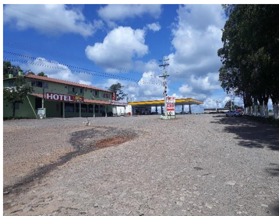
Figura 482 – Hotel e Posto de Combustíveis, Botucaraí, Soldade/RS: S28°48'10.00"; W52°30'29.00".
