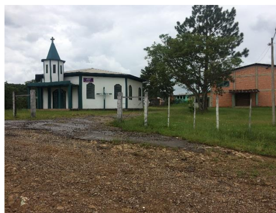
Figura 476 – Capela e salão paroquial da comunidade São Roque Espraiado, interior de Soledade/RS: S28°43'14.01"; W52°33'45.69".
