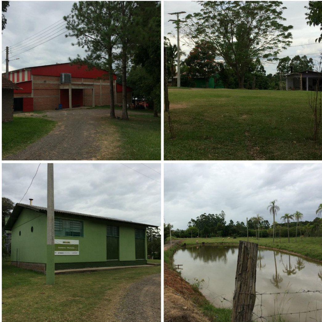
Figura 559 – Sede do Assentamento Capela, interceptado pela rodovia BR-386, no município de Nova Santa Rita - Coord.: S29°27'1.00"; W51°58'5.00"".
