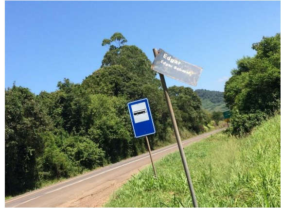
Figura 567 – Ponto de ônibus, sem abrigo e trecho sem sinalização horizontal para travessia de pedestres, Lajeado, Coord.: S29°24'33.66"; W52°1'47.53".
