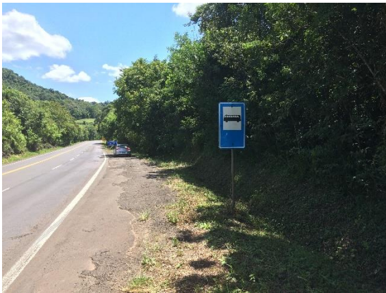
Figura 568 – Ponto de ônibus, sem abrigo e trecho sem sinalização horizontal para travessia de pedestres, Marques de Souza, Coord.: S29°23'28.60", W52°2'31.12".
