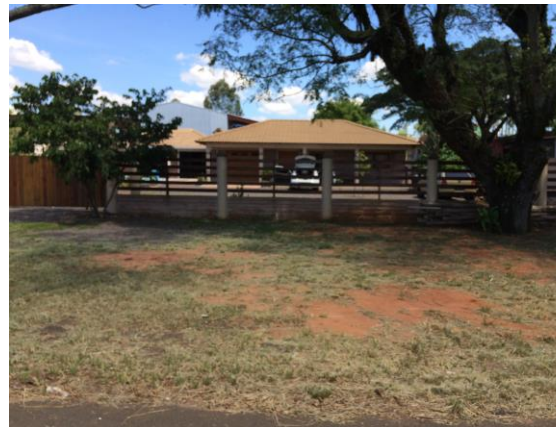
Figura 558 – Residência passível de desapropriação - Coord.: S29°41'40.85"; W51°41'39.35".
