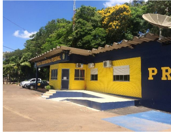
Figura 517 – Polícia Rodoviária Federal, Bairro Conventos, Lajeado/RS, Coord.: S29°25'54.83", W52°0'43.40".
