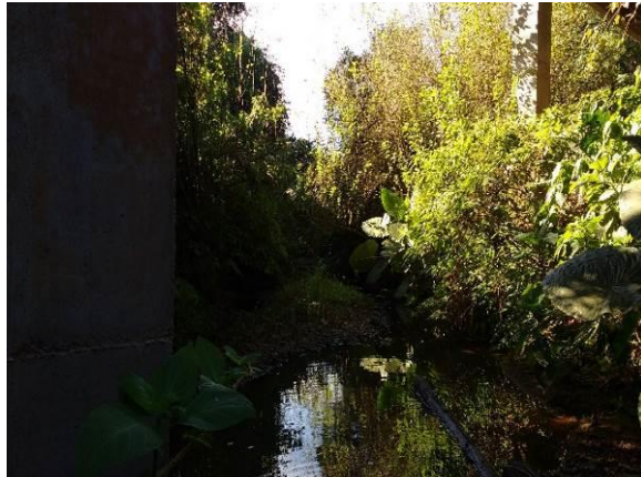
Figura 129 – P-13 (Sanga Picada Flor) à Montante da Ponte de Intersecção com a BR-386/RS
