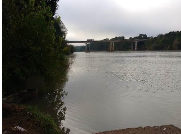
Figura 133 – P-15 (Rio Taquari) à Montante da Ponte de Intersecção com a BR-386/RS
