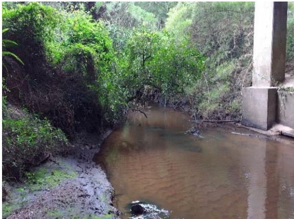
Figura 139 - P-18 (Arroio Gil) à Montante da Ponte de Intersecção com a BR-386/RS
