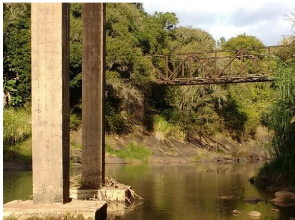
Figura 131 – P-14 (Arroio Forquetinha) à Montante da Ponte de Intersecção com a BR-386/RS
