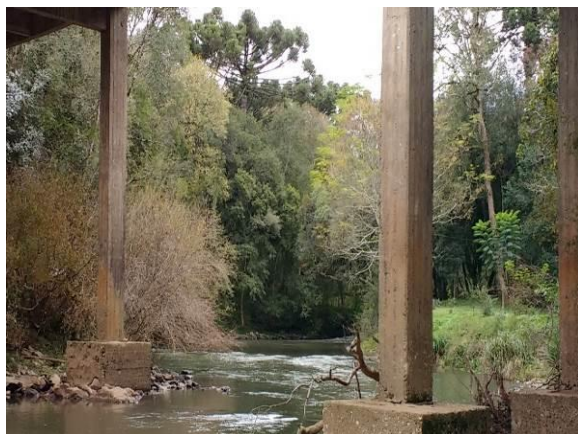
Figura 115 - P-06 (Rio Espriado) à Montante da Ponte de Intersecção com a BR-386/RS
