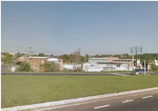
Figura 16 - Detalhe das construções existentes na área de estudo (Nova Santa Rita, RS).
