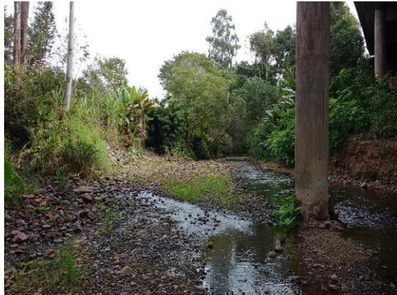
Figura 125 – P-11 (Arroio Tamanduá) à montante da ponte de intersecção com a BR-386/RS
