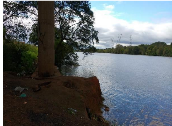
Figura 146 – P-21 (Rio dos Sinos) à Jusante da Ponte de Intersecção com a BR-386/RS
