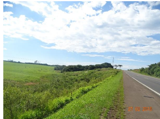
Figura 39 - Detalhe da faixa de domínio e o mosaico com lavouras e pequenos fragmentos florestais.
