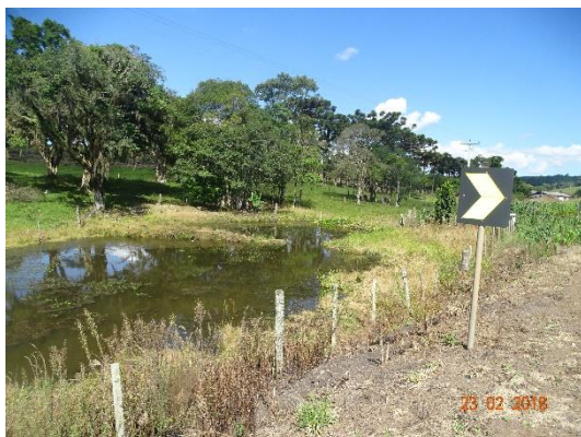
Figura 73 - Açude localizado na faixa de domínio – desprovido de vegetação no entorno (15 metros).
