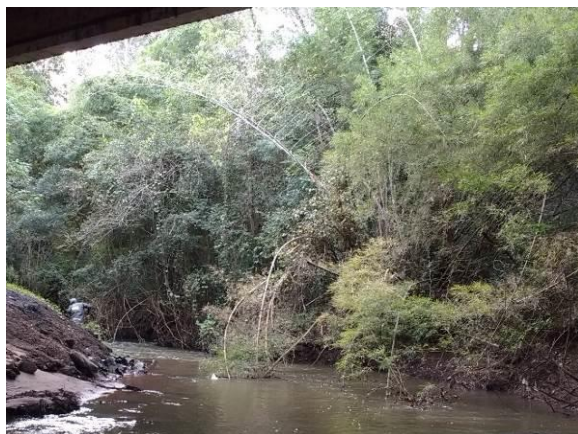
Figura 135 – P-16 (Arroio Santa Cruz) à Montante da Ponte de Intersecção com a BR-386/RS
