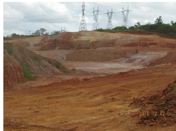
Figura 93 - Solos argilosiltosos pouco arenosos da unidade geoambiental DSVMPaef. À esquerda. Erosão em talude de corte; à direita, escavabasilções em área de empréstimo na região de Nova Santa Rita.
