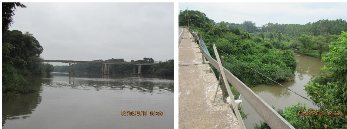
Figura 102 – À esquerda, ponte da BR-386 sobre rio Caí; à direita, diadema sobre arroio Boa, afluente do rio Caí, com planície de inundação ao fundo, município de Estrela.
