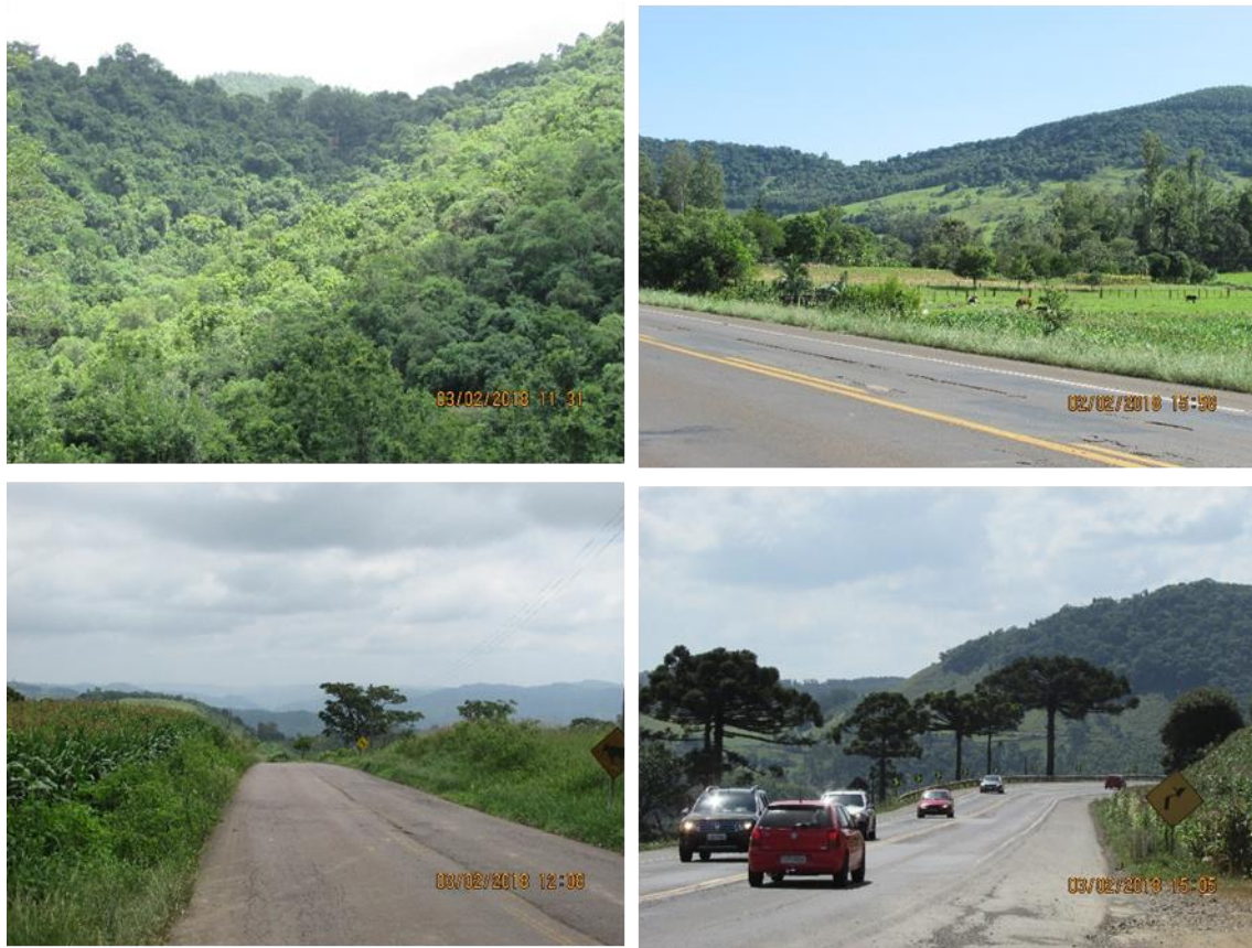
Figura 70 - Paisagem ao longo da rodovia BR-386/RS configurada por serras elevadas, encostas com declividade acentuada e vales profundos. Relevo R4d.
