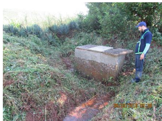
Figura 110 - Nascente d'água em Faixa de Domínio
