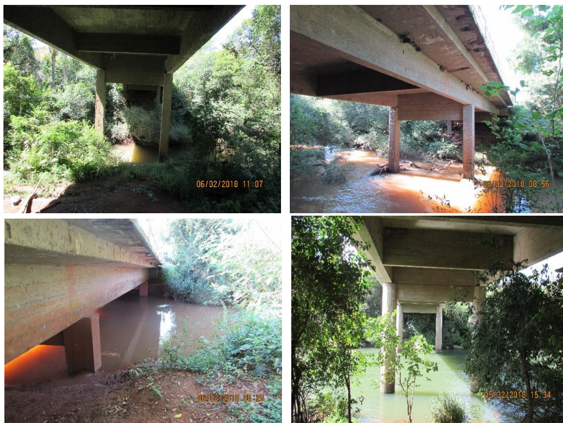
Figura 96 - Pontes sobre o rio Glória (esq. no alto), arroio do Herval (dir. no alto), arroio Grande (esq. inferior) e rio Jacuí (dir. inferior).
