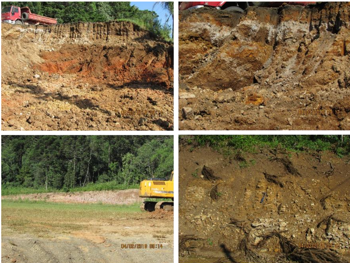
Figura 78 - Argissolo Vermelho alumínico com horizontes pedológicos bem definidos em cada de jazida de empréstimo para aterro.
