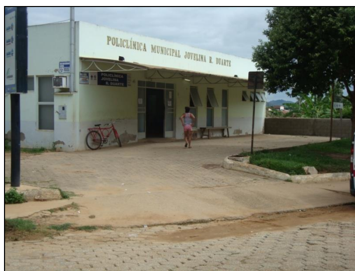
Foto 22: Policlínica Municipal – Campanário/MG
