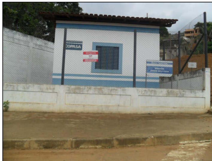
Foto 13: Booster da COPASA Jardim Bela Vista – Leopoldina/MG.
