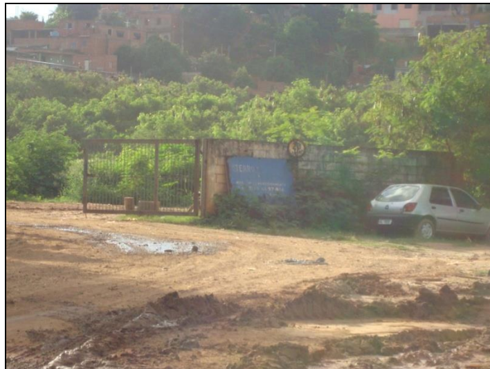
Foto 18: Entrada do Aterro Sanitário de Governador Valadares/MG (acesso pela BR-116/MG)
