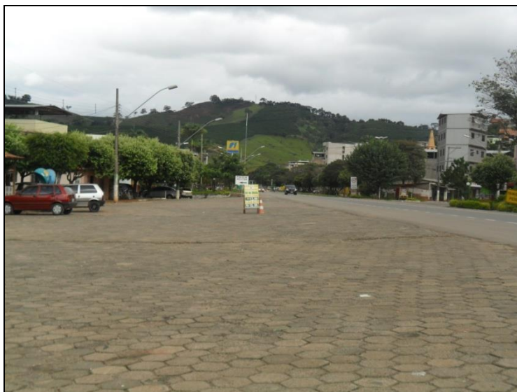
Foto 100: Vista do Perímetro Urbano de Santa Rita de Minas/MG
