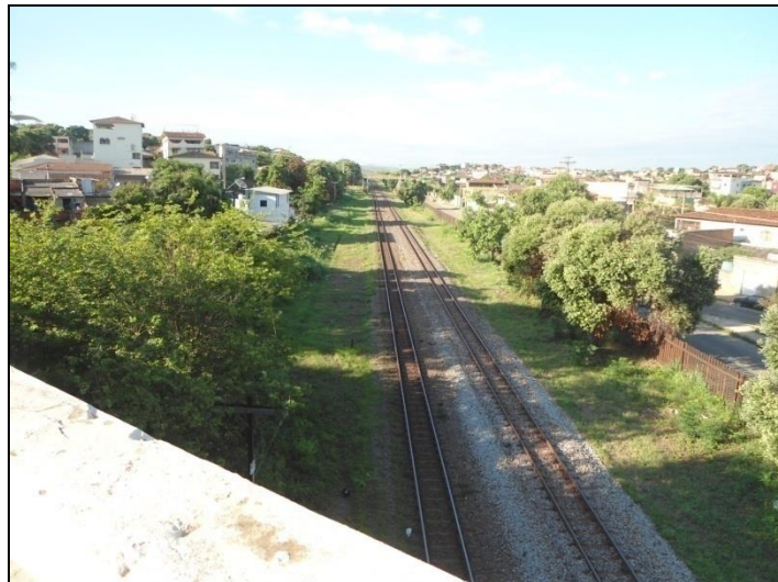
Foto 106: Ponte da BR-116/MG sobre a EFVM. Governadora Valadares/MG
