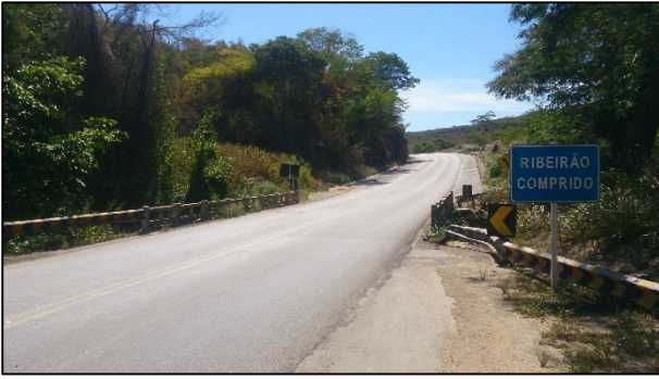
Figura 90 - Ponte sobre o Rbeirão Comprido, localizado na APP 28 da rodovia BR-116/MG, com presença de espécies exóticas.
