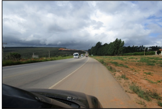
Figura 109 - Vista da rodovia BR-116/MG sobre diferentes paisagens
