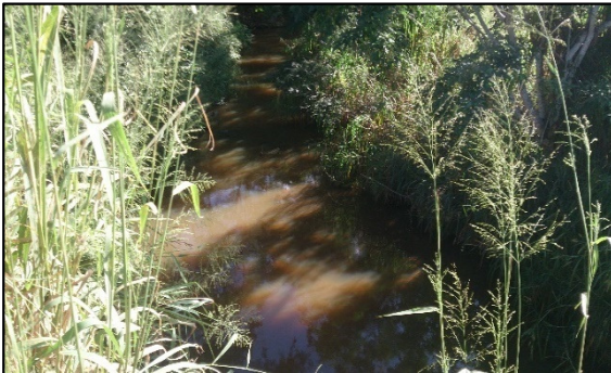
Figura 94 - APP 27 degradada, localizada na rodovia BR-116/MG, com presença de muito capim, sem espécies arbóreas.
