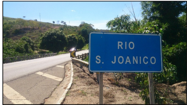
Figura 87 - Ponte sobre o Rio S. Joanico, localizado na APP 20 da rodovia BR-116/MG, com presença de espécies exóticas.
