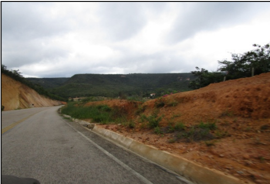
Figura 110 - Ausencia de vegetação e parte do solo exposto localizado na rodovia BR-116/MG
