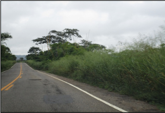
Figura 108 - Rodovia BR-116/MG com presença de capim invasor
