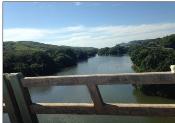
Figura 83 - Ponte sobre o Rio Paraíba do Sul (APP 159) localizado da rodovia BR-116/MG
