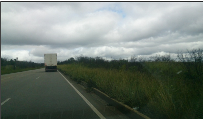
Figura 120 - Presença de capim invasor localizada na rodovia BR-116/MG
