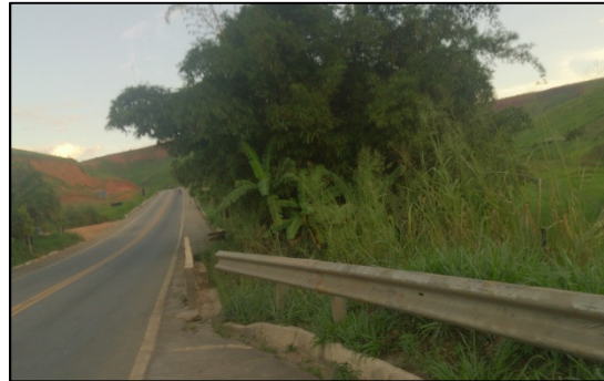
Figura 95 - APP degradada, localizada na rodovia BR-116/MG, com presença de capim e espécies invasoras.
