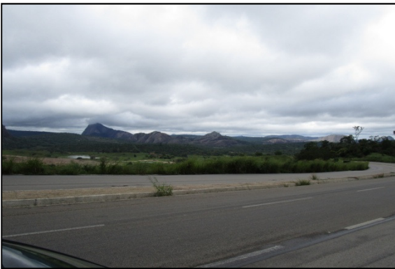
Figura 114 - Vista da rodovia BR-116/MG no município de Pedra Azul
