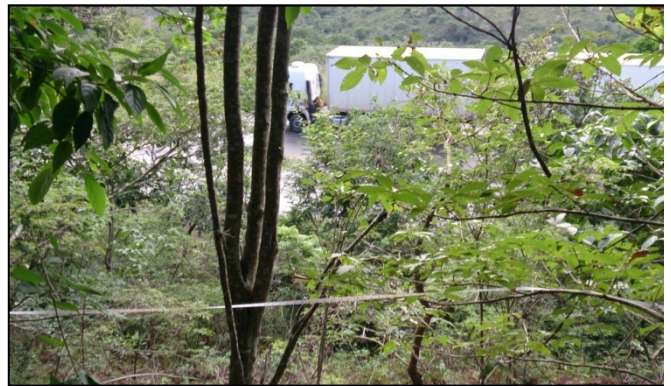
Figura 115 - Alocacao da parcela FED 11 com detalhe para a fita devidamente esticada localizada na rodovia BR-116/MG
