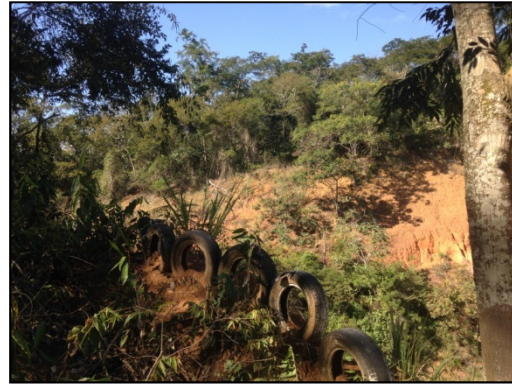
Figura 139 - Ação antrópica na parcela FES 1 localizada na rodovia BR-116/MG.
