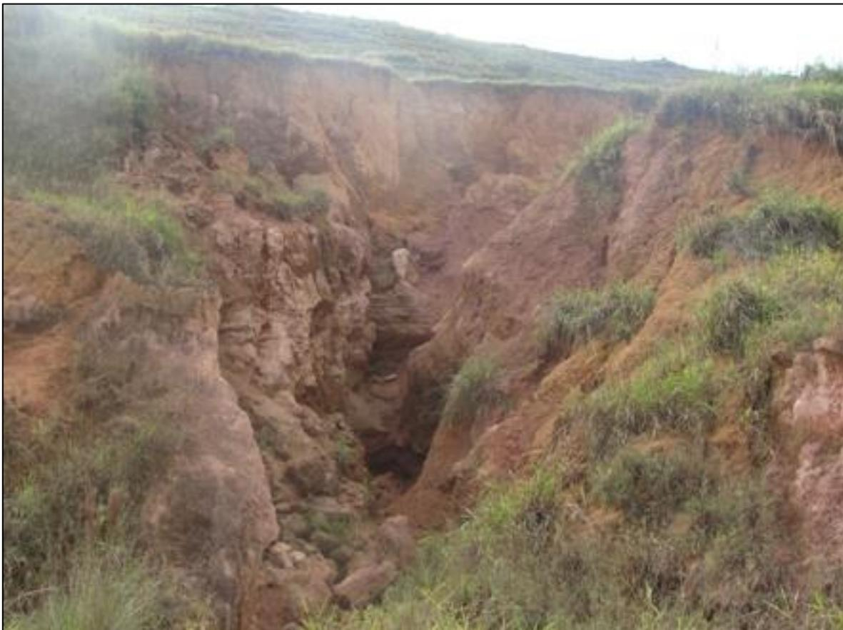
**Figura 107 Processo erosivo na base do talude devido à falta de cobertura vegetal.**
