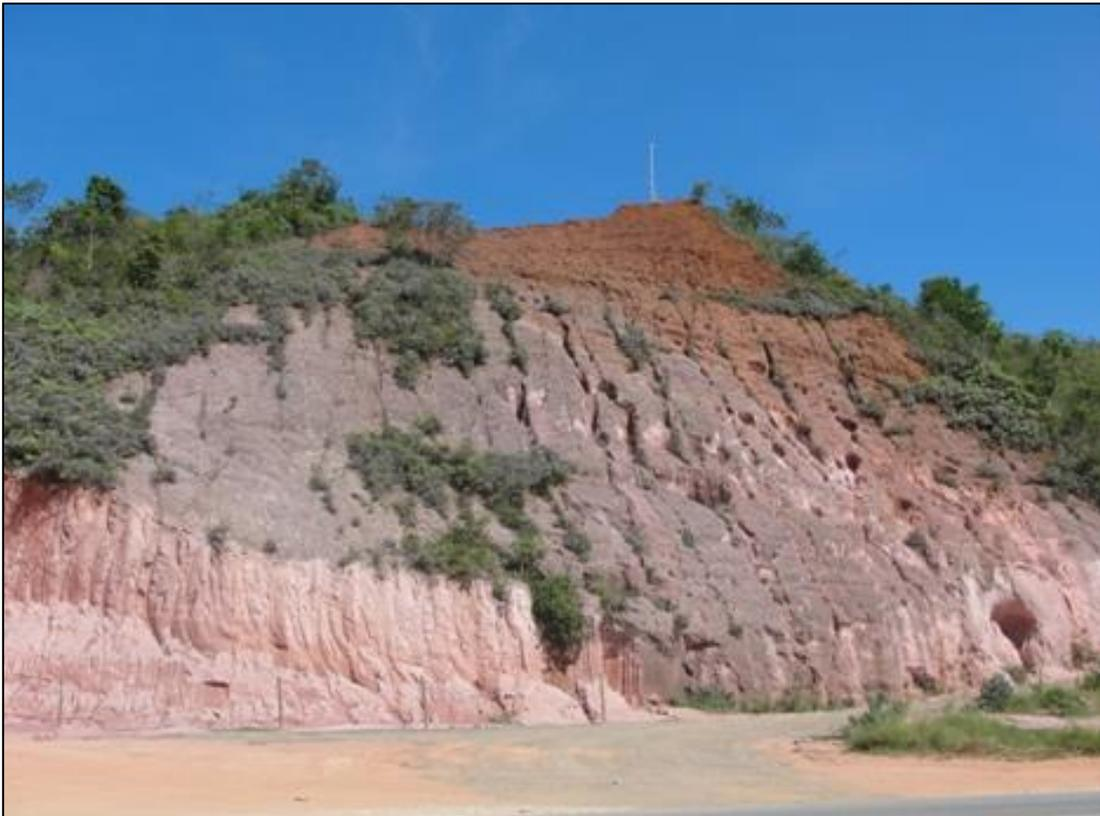
Figura 112 – Início do processo de desestabilização do talude, processo causado pela falta de cobertura vegetal, bermas e calhas para condução das águas meteóricas.
