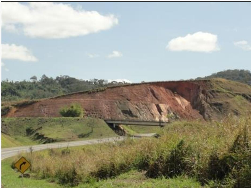
**Figura 109 – Talude sem cobertura vegetal e com deslocamento de massa.**
