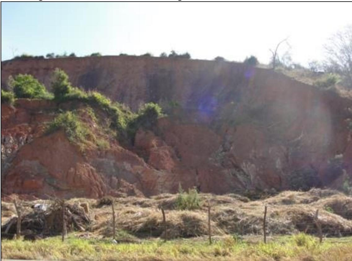
**Figura 111 – Talude desagregando devido à falta de cobertura vegetal, bermas e calhas para escoamento das águas meteóricas.**
