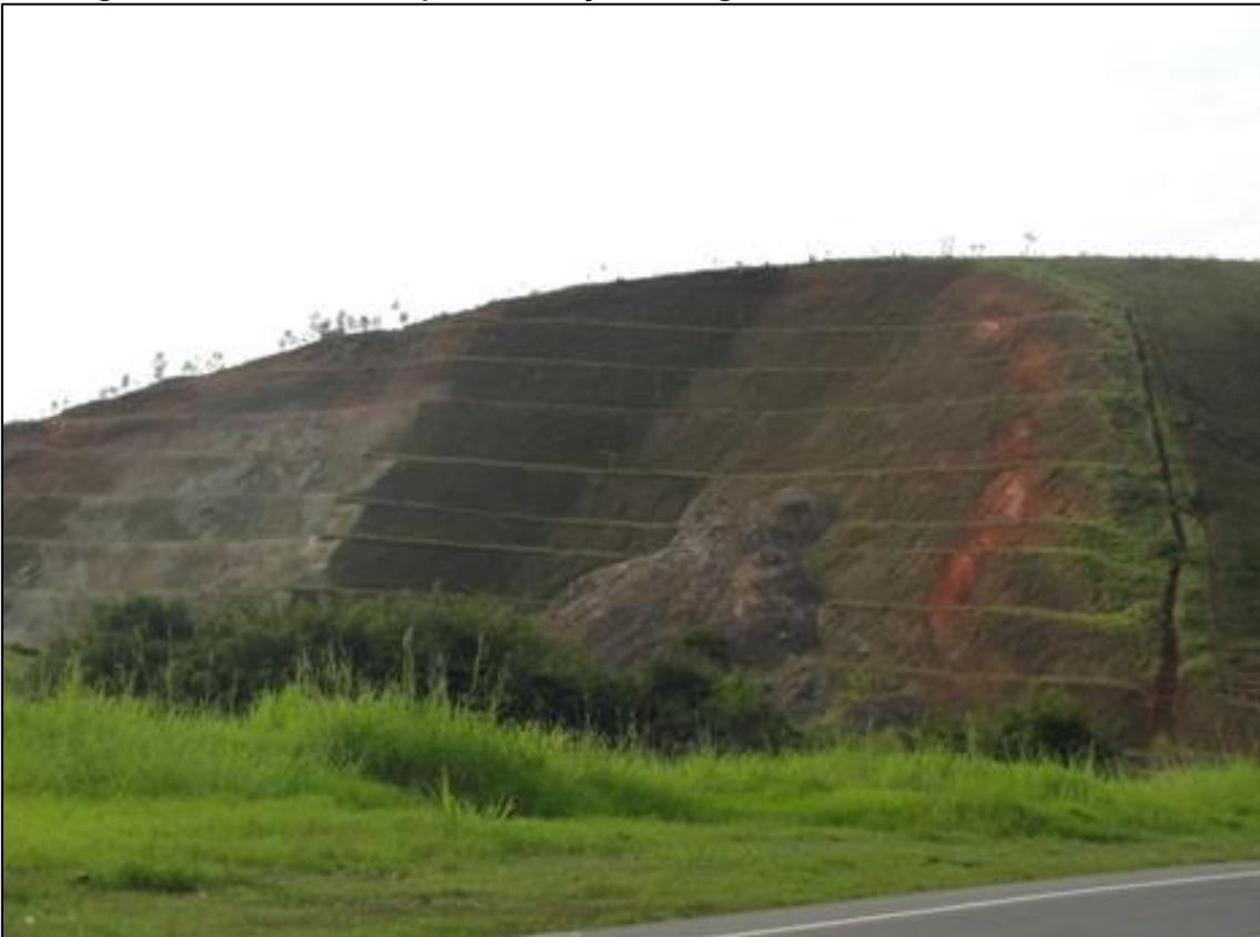
Figura 113 – Talude devidamente protegido com bermas, cobertura vegetal e calhas para condução das águas meteóricas.
