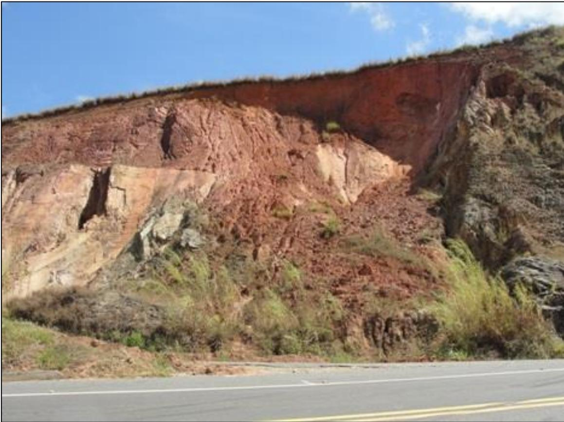
**Figura 110 - Talude sem cobertura vegetal e com deslocamento de massa.**
