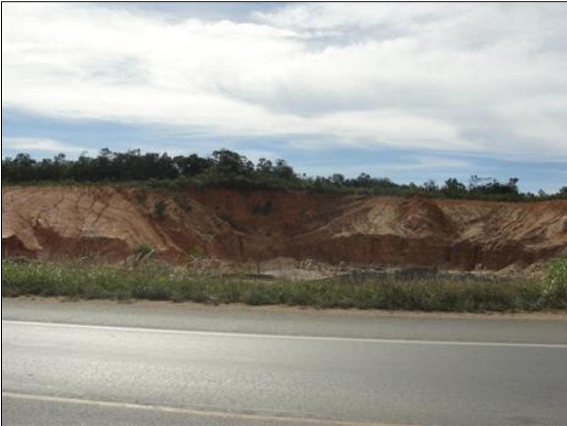
**Figura 106 - Processo erosivo na base do talude devido à falta de cobertura vegetal.**
