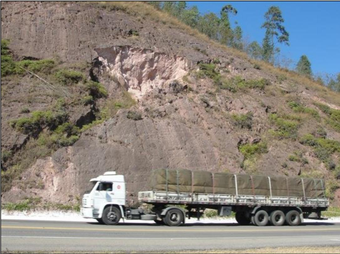
**Figura 108 – Talude sem cobertura vegetal ou bermas e com deslocamento de massa.**
