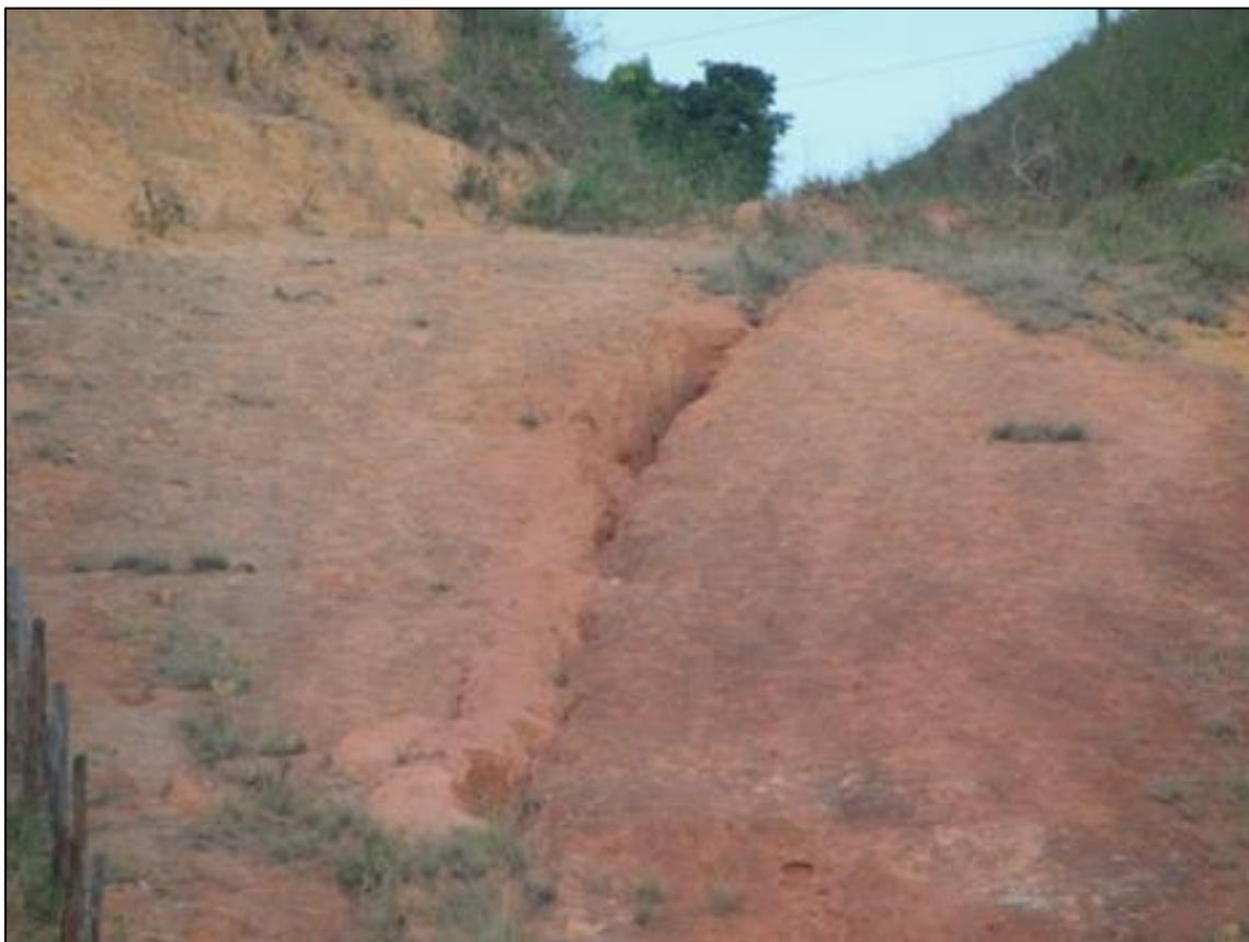
**Figura 104 Início de processo erosivo principalmente laminar devido à baixa declividade**
