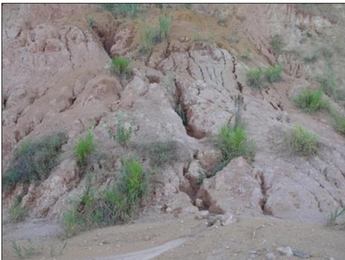
**Figura 105 – Processo erosivo na base do talude devido à falta de cobertura vegetal.**
