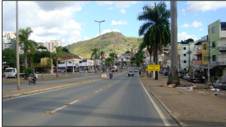
Figura 3 - Vista do Trecho da BR-116/MG no perímetro Urbano de Caratinga/MG.
