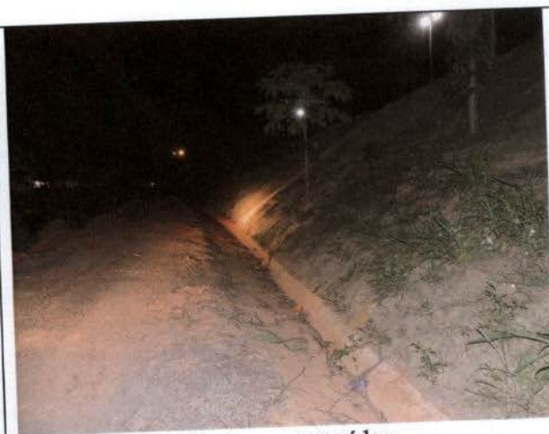
Foto 02 – Canaletas construídas
