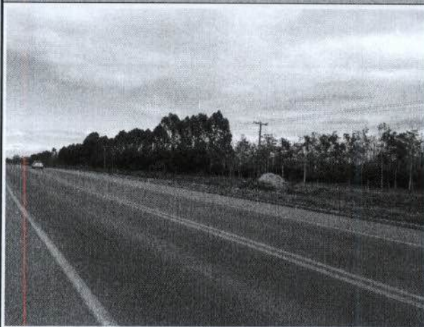
Foto 17: contexto geral do local onde pretende-se implantar a praça de pedágio 03.
