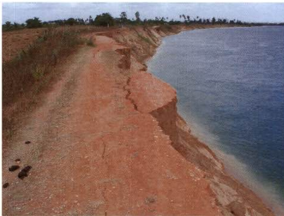
Figura 52: Dique de contenção que está em obras de recuperação. Área 1.
