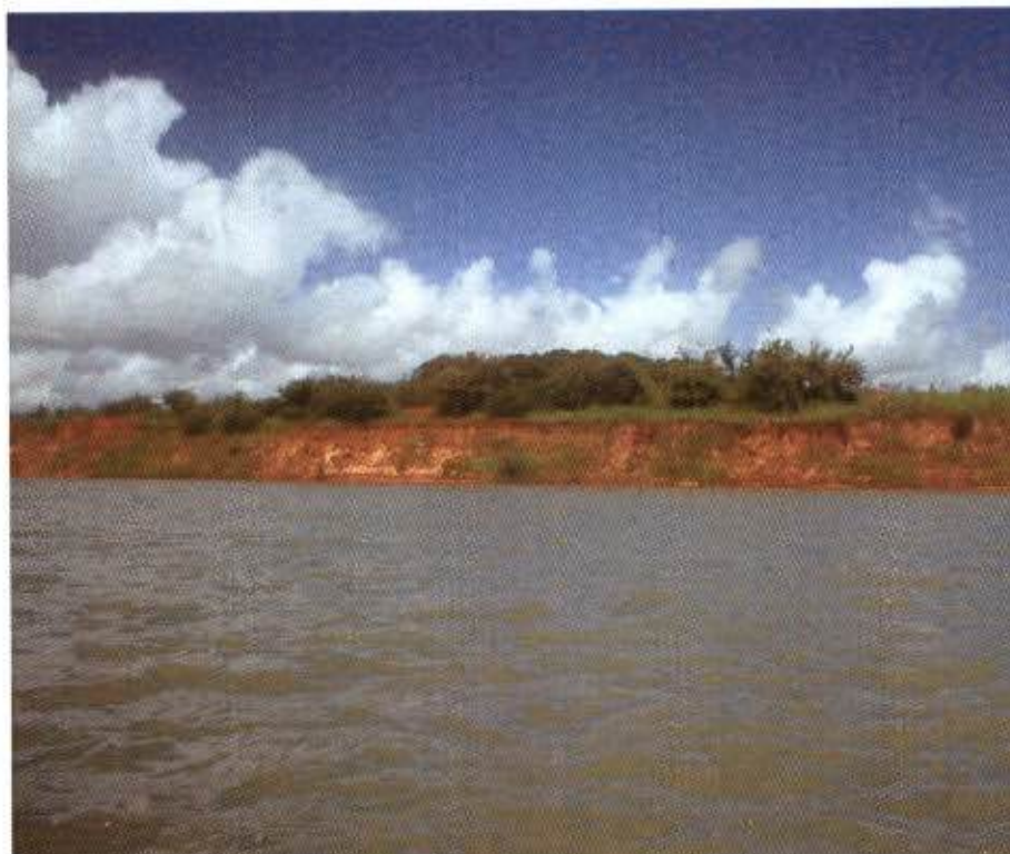
Figura 53: Ausência de mata ciliar contribuindo com os processos erosivos dos diques.
