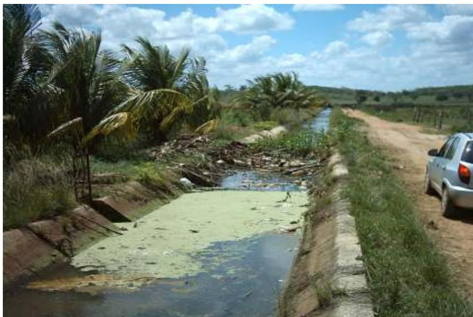
**Figura 21: Restos de cultura e resíduos sólidos obstruindo a passagem de água no canal de irrigação.**
