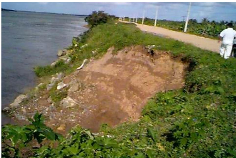
**Figura 27: Trecho erodido no Dique do Serrão do PI de Betume, no município de Ilha das Flores.**
