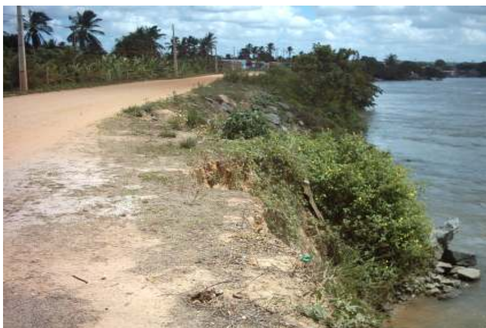
Figura 19: Dique construído às margens do rio São Francisco.
