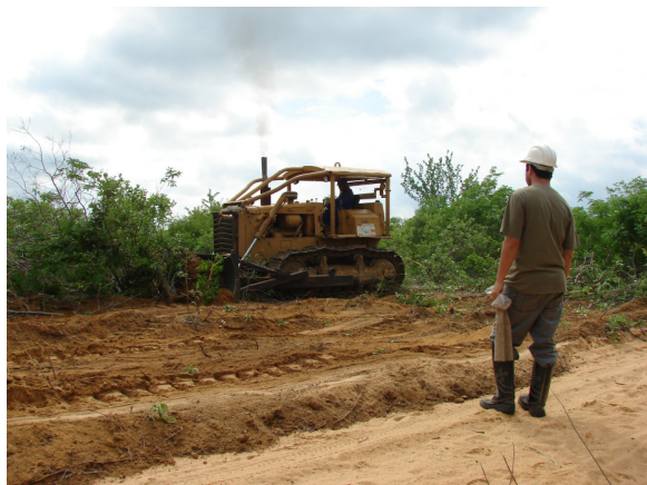
Foto 1. Biólogo acompanhando a maquina D6 em áreas de expurgo Lote 9.
