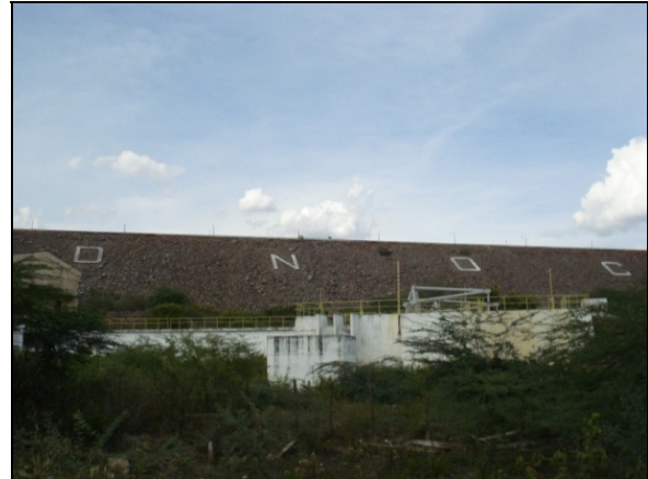
Foto 02: Instalação do DNOCS abandonada, próximo ao município de Ibimirim - PE.
