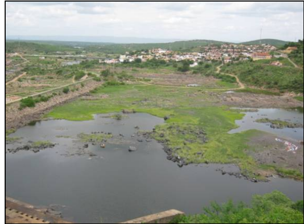
Foto 02: Montante da confluência com Rio Salgado, no município de Icó-CE.
