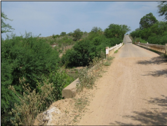
Foto 01: Ponte do Rio Moxotó, no município de Inajá-PE.
