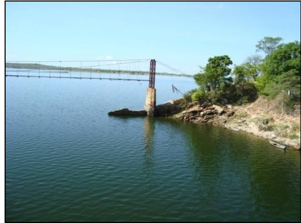
Foto 02: Açude Coremas – Mãe d'água, no município de Coremas-PB.
