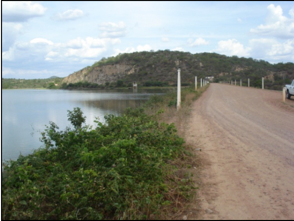
Foto 01: Eixo da barragem do Açude Poço da Cruz no município de Ibimirim - PE.
