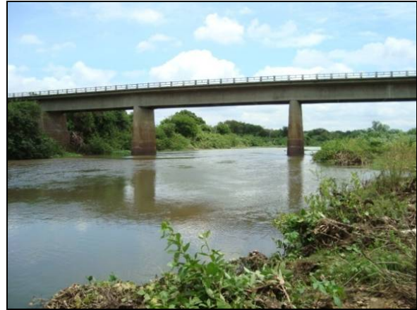
Foto 02: Ponte da rodovia BR 230 sob Rio Piranhas, próximo ao município de Pombal - PB.
