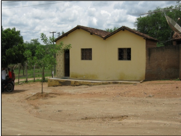
Foto 01: Acesso ao Rio Paraíba, à jusante do Açude Boqueirão, próximo a município de Boqueirão - PB.
