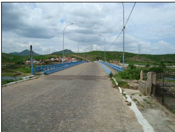
Fonte 01: Ponte sob Rio Salgado, no município de Icó-CE.
