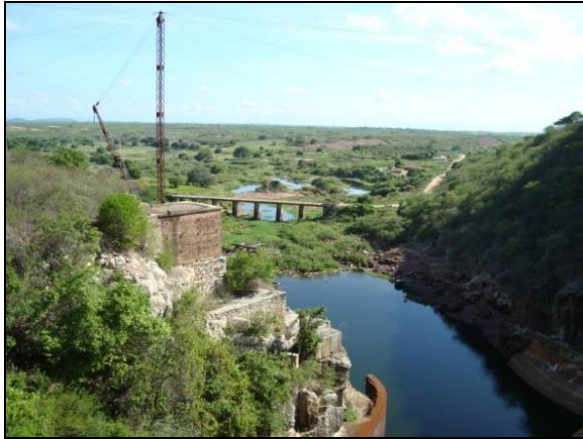
Foto 01: Açude Coremas – Mãe d'água, no município de Coremas-PB.
