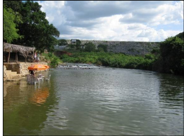
Foto 02: Jusante do Açude Eng. Ávidos, no Distrito de Eng. Ávidos, no município de Cajazeiras-PB.
