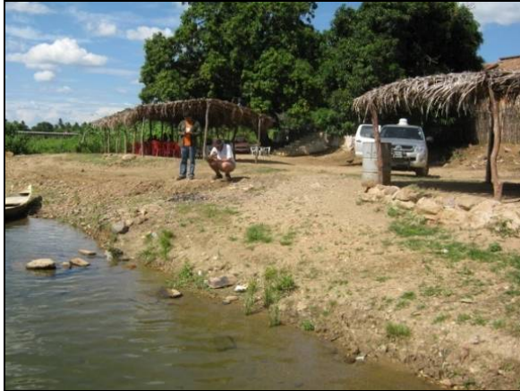
Foto 01: Jusante do Açude Eng. Ávidos, no Distrito de Eng. Ávidos, no município de Cajazeiras-PB.
