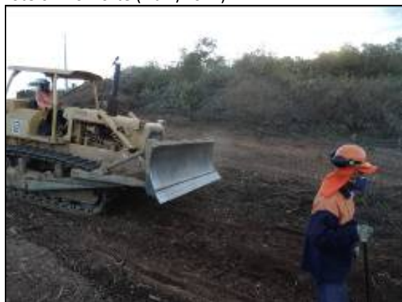
Foto 4.23.680. Remoção de expurgo Lote 3 Eixo Norte (Junho/2011).
