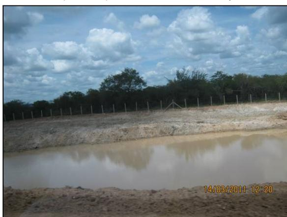
Foto 4.27.88. Bacia de contenção lateral ao canal de adução, como medida de controle de processo erosivo (mar/11).
