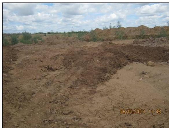
Foto 4.27.68. Nivelamento de aterro e acondicionamento de solo na área do bota fora BF03-CL (jan/11).
