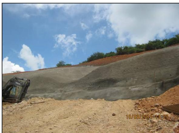
Foto 4.27.144. Talude superior do espelho concretado – método preventivo de processo erosivo (mar/11).
