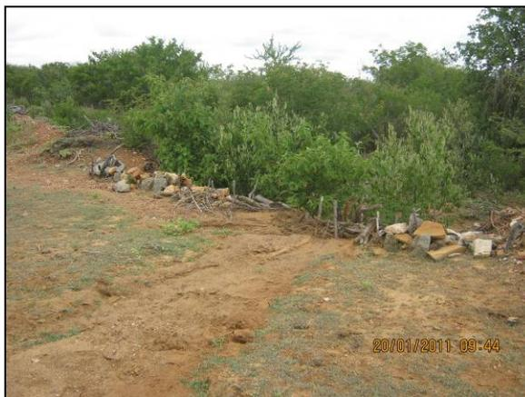
Foto 4.27.10. Cerca paliçada e filtro de rocha para contenção de sedimentos (jan/11).
