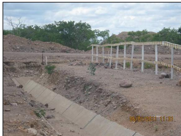
Foto 4.27.113. Dreno lateral na plataforma superior da estação de bombeamento (jan/11).
