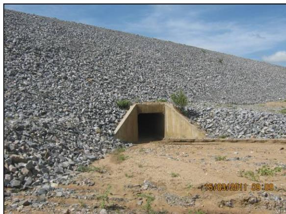
Foto 4.27.110. Enrocamento como medida preventiva de processos erosivos próximo ao bueiro (mar/11).
