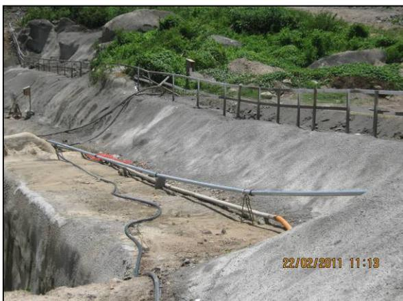
Foto 4.27.134. Projeção de concreto em talude, como medida preventiva a erosão, na área do desemboque (fev/11).
