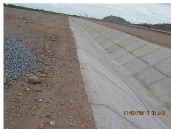
Foto 4.27.72. Medida preventiva de processo erosivo por canaleta trapezoidal lateral ao canal próximo a EBV-1 (mar/11).
