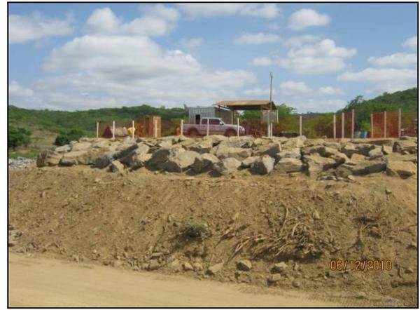
Foto 4.27.137. Talude reconformado e com enrocamento na janela do túnel Cuncas (dez/10).
