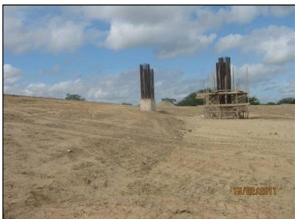
Foto 4.27.79. Aterro do aqueduto Jacaré reconformado após ocorrência de processos erosivos (fev/11).
