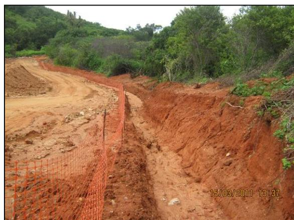
Foto 4.27.145. Canaleta de drenagem pluvial na lateral da via do caminho de serviço, dentro da área do desemboque (mar/11).
