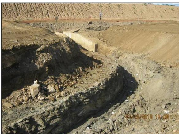
Foto 4.27.11. Abertura de vala para escoamento de água proveniente do bueiro B 001 (dez/10).
