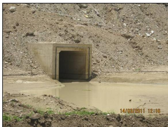
Foto 4.27.87. Bueiro em funcionamento, como medida de controle de processo erosivo (mar/11).
