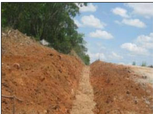
Foto 4.27.93. Implantação de drenos laterais ao longo do segmento de canal (dez/10).
