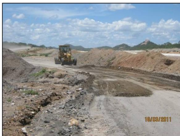
Foto 4.27.13. Manutenção em vias de acesso e conformação de bigode para escoamento de água pluvial (mar/11).
