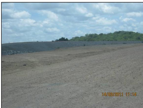
Foto 4.27.82. Enrocamento na área do reservatório Cacimba Nova (mar/11).
