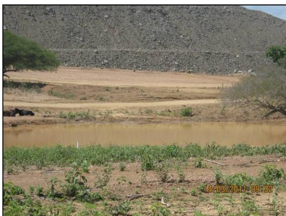
Foto 4.27.121. Bacia de contenção na área da EBV-4, como medida de controle de processos erosivos (mar/11).
