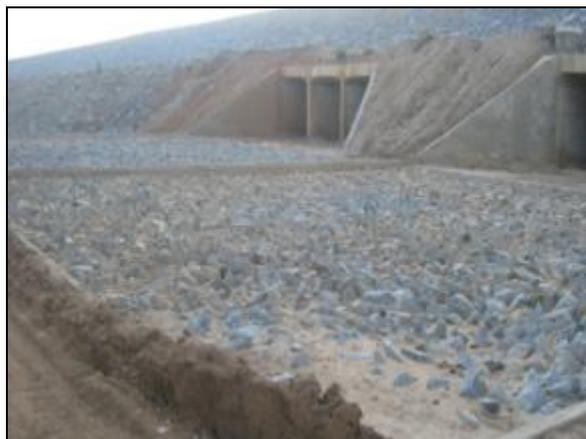
Foto 4.27.92. Implantação de dissipadores de energia na saída do bueiro (dez/10).
