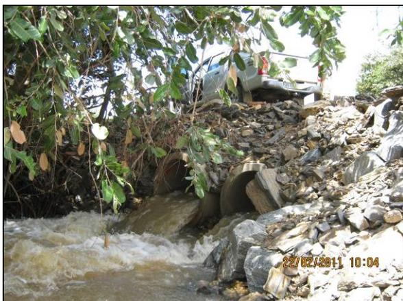
Foto 4.27.49. Dispositivo de drenagem, no riacho Tamanduá, em funcionamento (fev/11).
