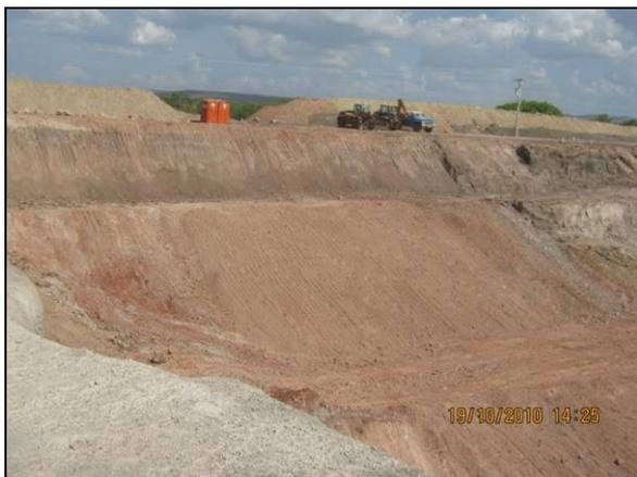
Foto 4.27.125. Bancada implantada no talude de corte do emboque do túnel Cuncas I (out/10).
