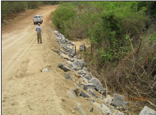
Foto 4.27.136. Medida de contenção de processo erosivo na via de acesso da janela do túnel Cuncas I (nov/10).
