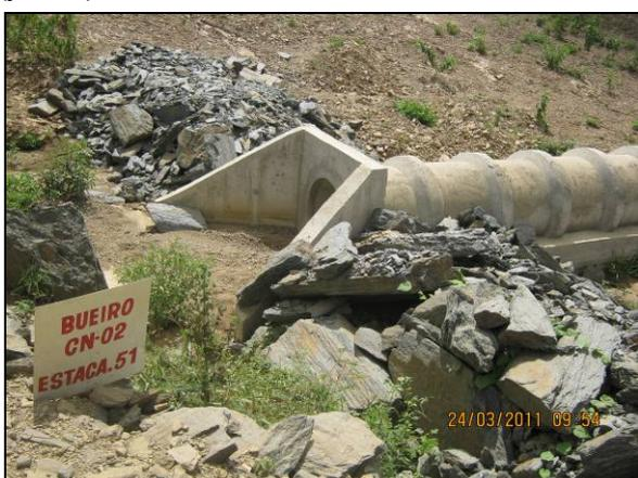
Foto 4.27.61. Enrocamento como medida preventiva, para contenção do fluxo hídrico no bueiro – estaca 51 (mar/11).
