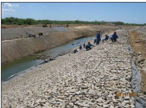
Foto 4.27.1. Implantação de colchão Reno em taludes do canal de aproximação (nov/10).
