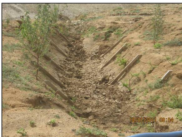
Foto 4.27.122. Implantação de drenagem lateral à via de acesso (jan/11).
