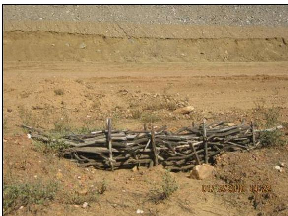
Foto 4.27.6. Paliçada utilizada como medida paliativa para contenção de processos erosivos (dez/10).
