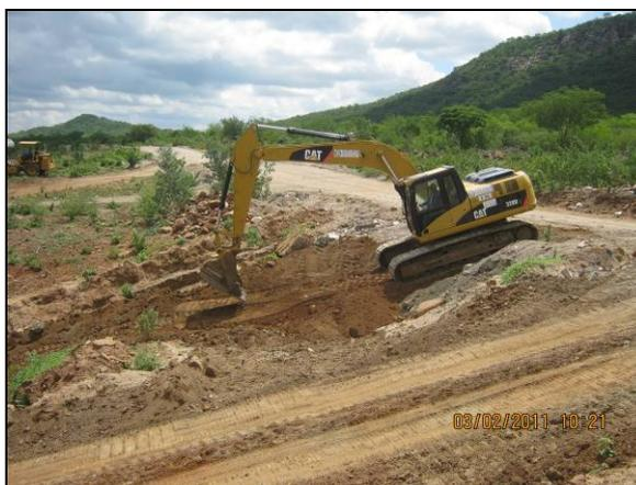
Foto 4.27.18. Manutenção em vias de acesso e talude (fev/11).
