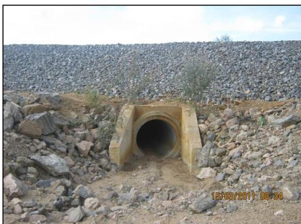
Foto 4.27.105. Enrocamento e dissipadores de energia no ponto saída do bueiro, para prevenção de processos erosivos (mar/11).
