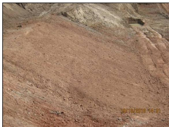
Foto 4.27.124. Suavização da inclinação de talude na área do emboque (out/10).
