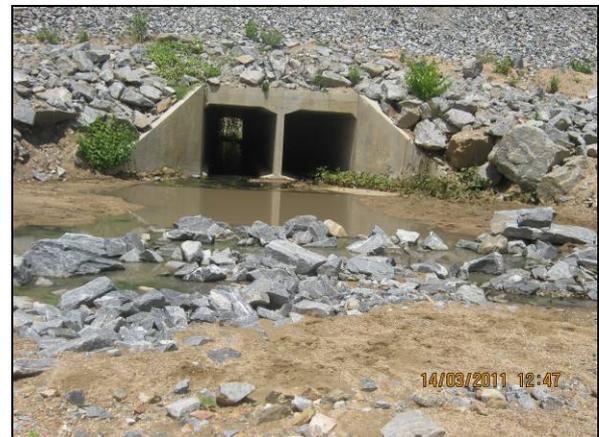
Foto 4.27.100. Enrocamento e dissipadores de energia no ponto saída do bueiro para contenção de processos erosivos (mar/11).
