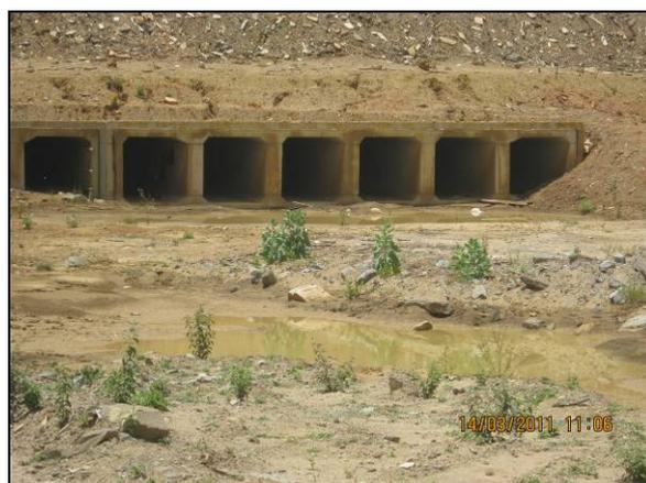
Foto 4.27.81. Bueiro instalado como medida de controle de processo erosivo (mar/11).
