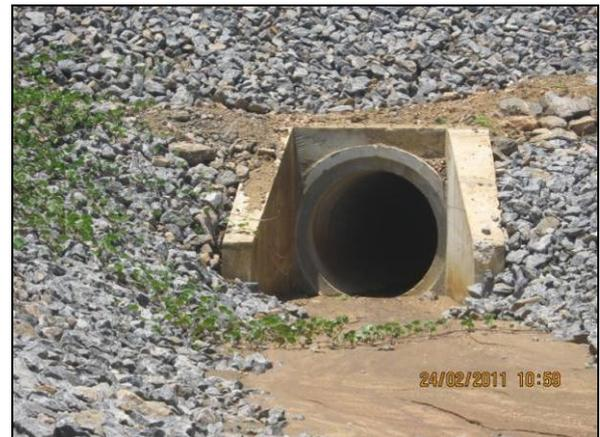
Foto 4.27.109. Enrocamento próximo ao bueiro (fev/11).
