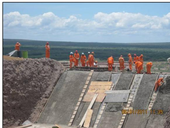
Foto 4.27.115. Concretagem de canal na plataforma superior da estação de bombeamento (jan/11).
