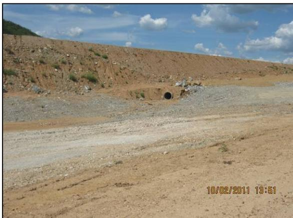
Foto 4.27.89. Instalação de drenagem por tubulações, como medida de controle de processos erosivos (fev/11).
