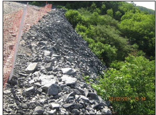
Foto 4.27.139. Enrocamento como método preventivo de erosão na via de acesso à janela do túnel (fev/11).
