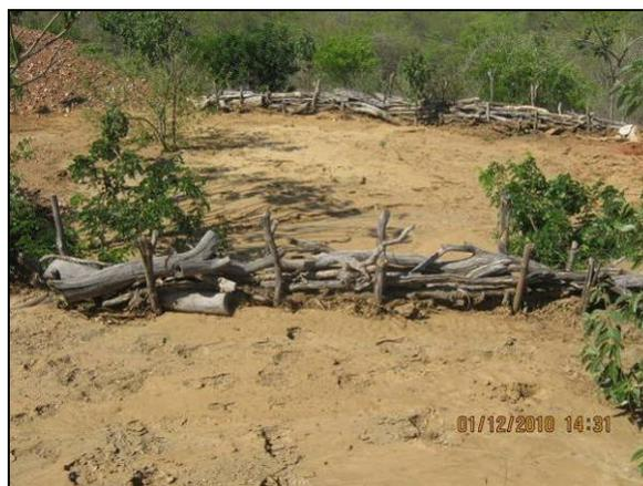
Foto 4.27.7. Cerca paliçada para contenção de sedimentos (dez/10).
