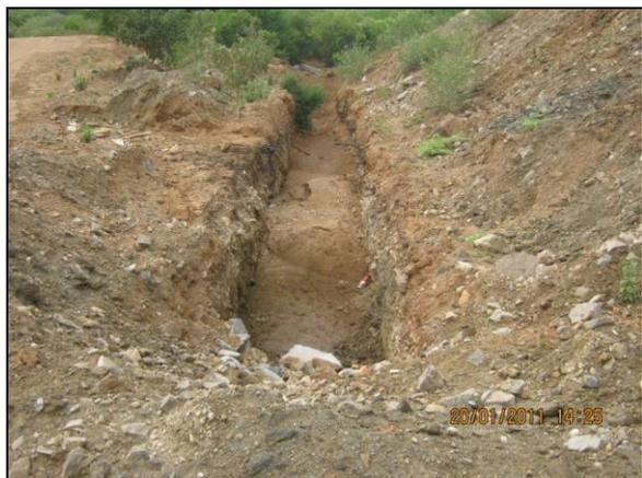
Foto 4.27.15. Sistema de drenagem implantado para evitar acúmulo de água (jan/11).
