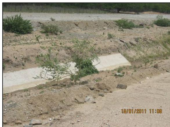
Foto 4.27.96. Dreno lateral à via de acesso para escoamento de águas pluviais (jan/11).
