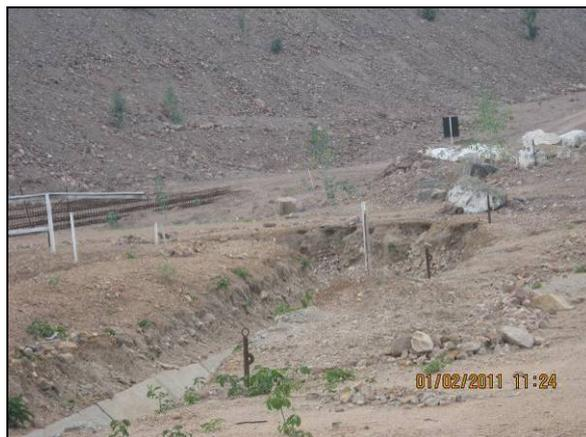
Foto 4.27.116. Dreno lateral na plataforma inferior da estação de bombeamento (fev/11).
