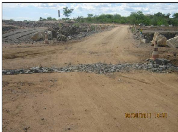
Foto 4.27.117. Implantação de filtro de rochas para dissipação de energia da água (jan/11).
