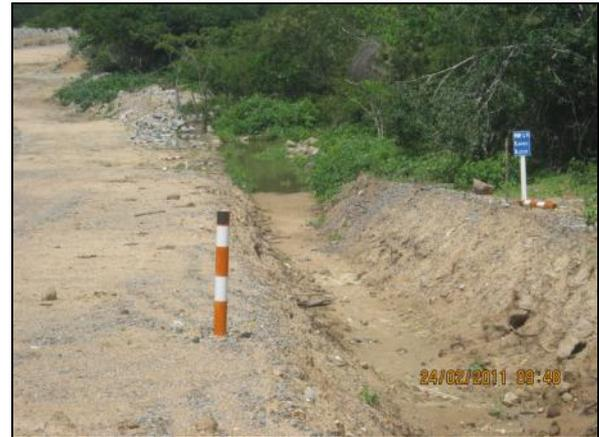
Foto 4.27.98. Dreno lateral à via de acesso para escoamento de águas pluviais (fev/11).
