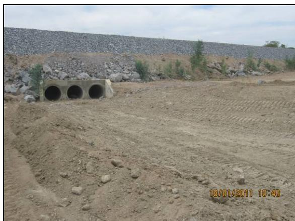
Foto 4.27.94. Enrocamento para contenção de processos erosivos (jan/11).
