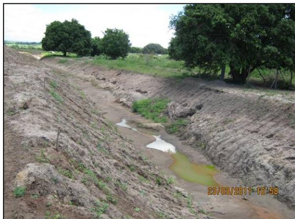
Foto 4.27.44. Início da atividade de construção do canal de restituição da travessia 13 (mar/11).
