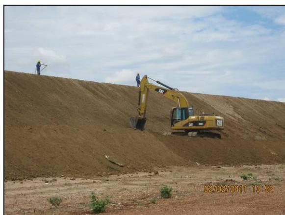
Foto 4.27.9. Conformação de talude do canal (fev/11).
