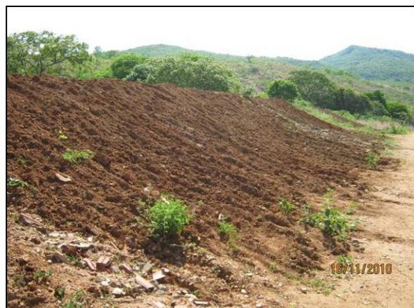
Foto 4.27.140. Suavização de desnível na área do canteiro de obras, como medida preventiva à erosão (nov/10).
