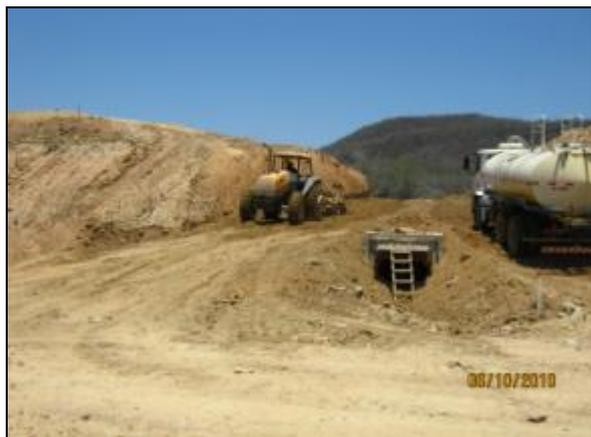
Foto 4.27.84. Nivelamento do solo sobre bueiro (out/10).
