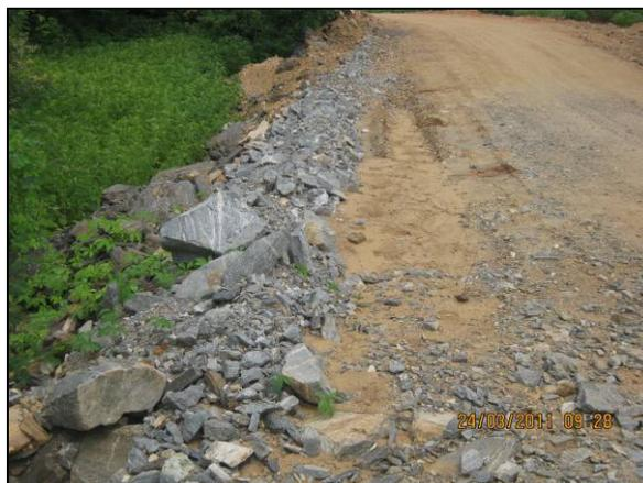
Foto 4.27.50. Enrocamento na lateral da via de acesso ao britador (mar/11).
