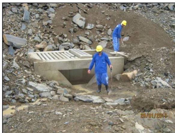
Foto 4.27.58. Retirada de sedimentos carreados pela água pluvial (jan/11).
