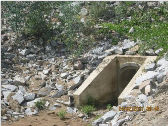
Foto 4.27.97. Enrocamento como medida de controle de processos erosivos em área de instalação de bueiro (fev/11).
