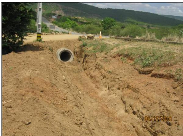
Foto 4.27.142. Instalação de canal de escoamento de água pluvial, com manilha, como medida preventiva à processos erosivos no canteiro de obras (dez/10).
