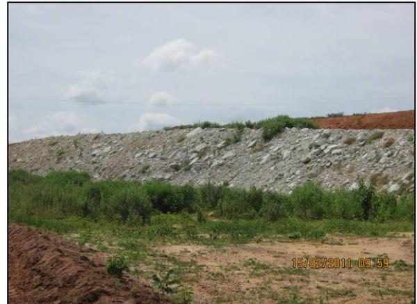
Foto 4.27.40. Enrocamento de talude próximo a travessia 26 (fev/11).
