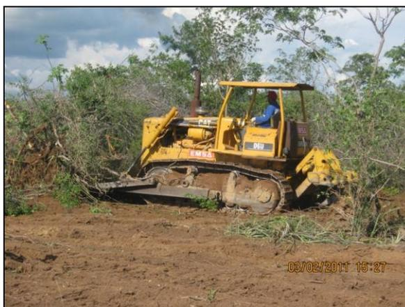
Foto 4.10.41. Supressão vegetal mecanizada e remoção de expurgo (fev/11).
