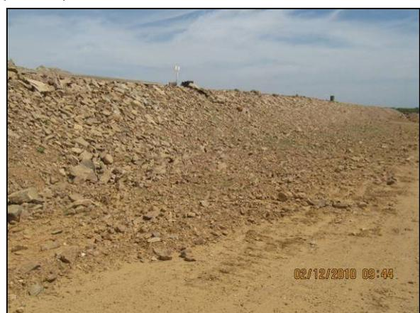
Foto 4.27.24. Enrocamento do talude no aterro do canal (dez/10).
