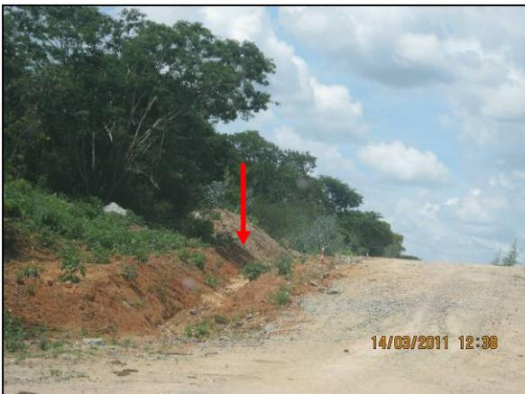
Foto 4.27.99. Dreno lateral à via de acesso para escoamento de águas pluviais (mar/11).
