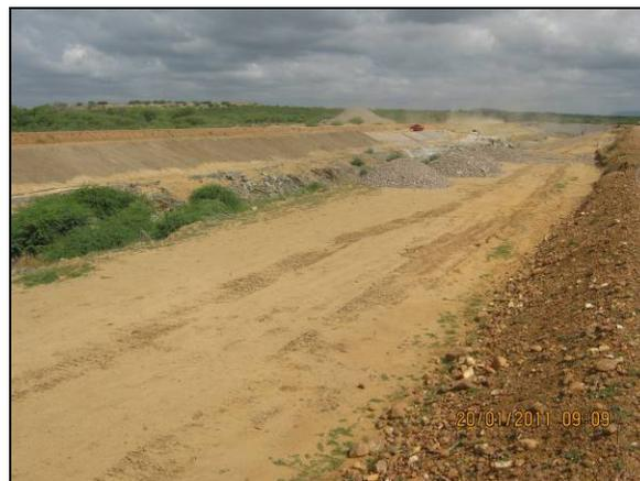
Foto 4.27.4. Conformação de vias de acesso em ponto de monitoramento – estaca 41 (jan11).
