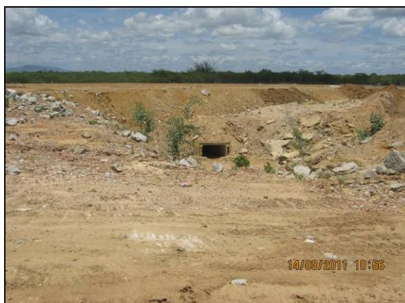
Foto 4.27.80. Bueiro em funcionamento, como medida de controle de processo erosivo (mar/11).
