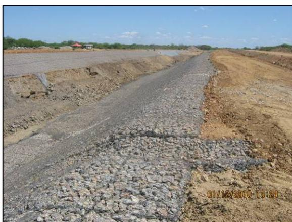
Foto 4.27.5. Implantação de colchão Reno em taludes do canal de aproximação (dez/10).
