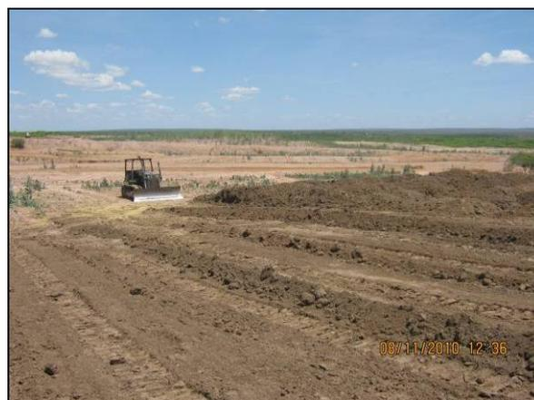
Foto 4.9.62. Reconformação topográfica do terreno (nov/10).
