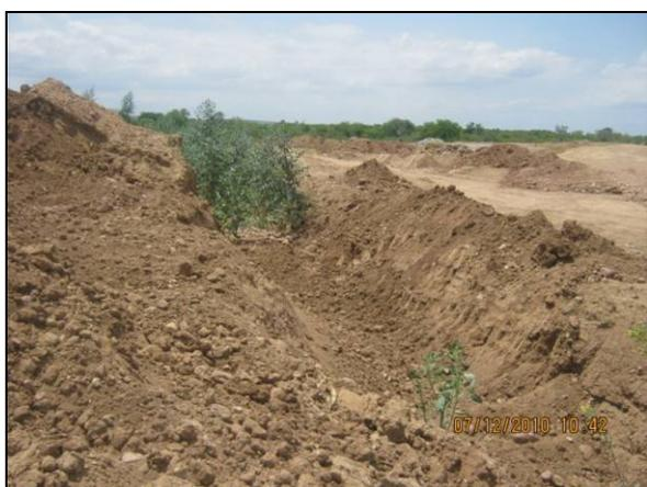
Foto 4.27.65. Abertura de dreno na saída de bueiro e nivelamento de aterro na área do bota fora BF03-CL (dez/10).
