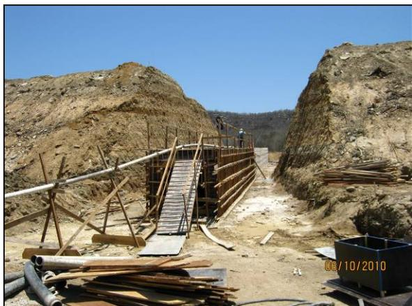
Foto 4.27.77. Implantação de bueiro como medida de controle de processo erosivo (out/10).
