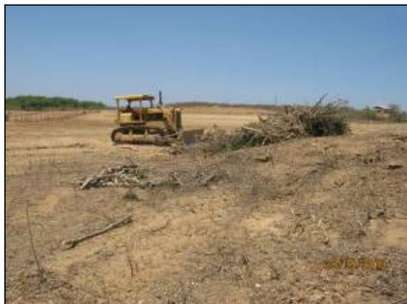
Foto 4.10.18. Remoção de expurgo com trator esteira (out/10).
