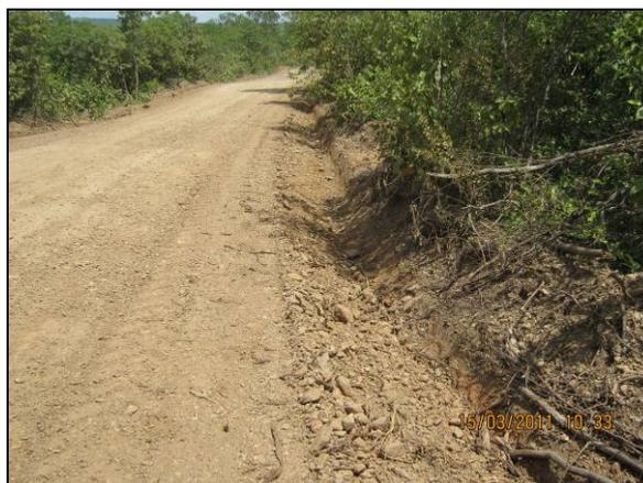
Foto 4.27.135. Canaleta como método preventivo de processo erosivo na lateral da via de acesso ao desemboque do túnel (mar/11).
