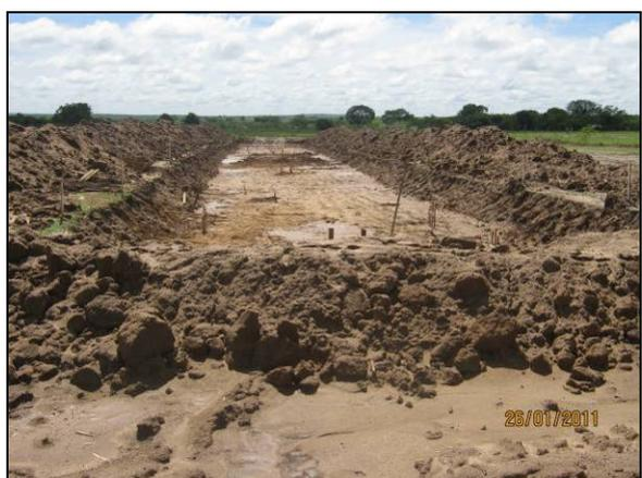
Foto 4.27.30. Demarcação da área de construção da base do bueiro B 004 (jan/11).
