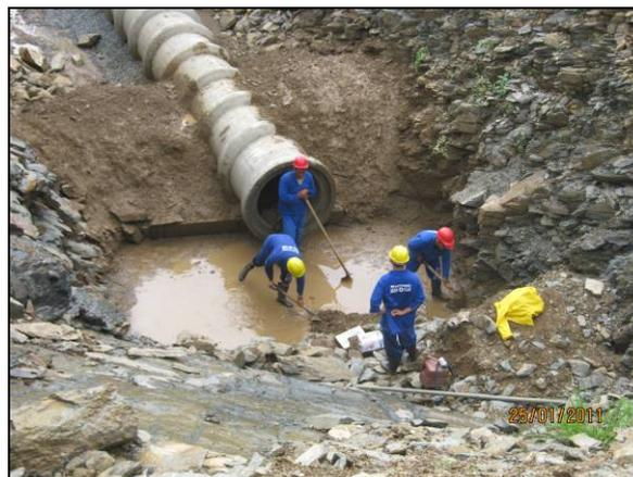
Foto 4.27.54. Instalação do bueiro da travessia 05 - estaca 118 (jan/11).
