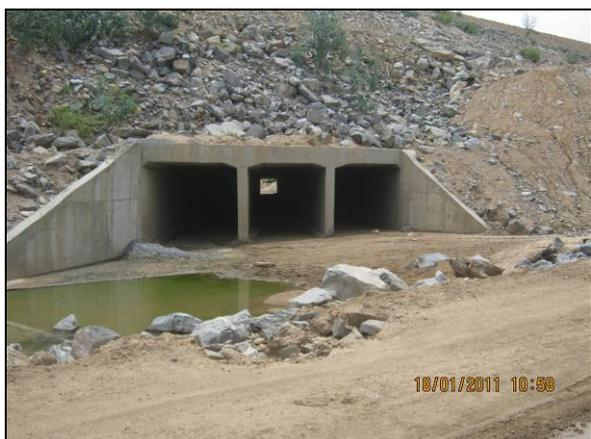
Foto 4.27.95. Início da implantação de enrocamento de talude (jan/11).
