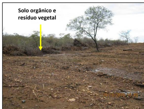
Foto 4.9.13. Deposição de camada orgânica de solo e resíduo vegetal na área de segmento de canal WBS 1405 (out/10).
