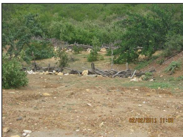
Foto 4.27.8. Cerca paliçada e filtro de rocha instalado (fev/11).
