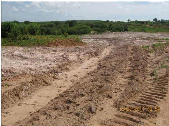
Foto 4.27.39. Curva de nível disposta lateralmente à via de acesso (fev/11).
