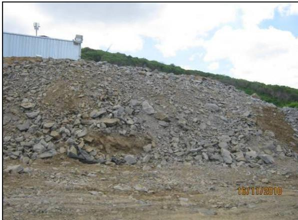
Foto 4.27.138. Medida preventiva à erosão na área da janela do túnel Cuncas (nov/10).
