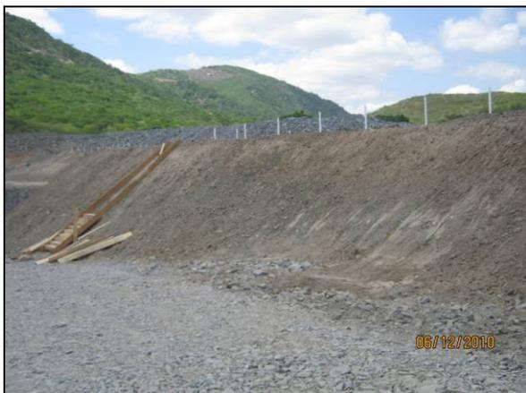
Foto 4.27.130. Suavização de talude na área do desemboque do túnel Cuncas I (dez/10).
