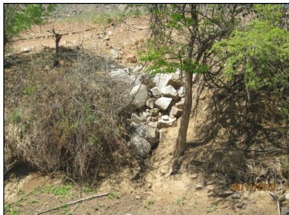
Foto 4.27.14. Medida para contenção de processo erosivo na margem do riacho Grande (nov/10).
