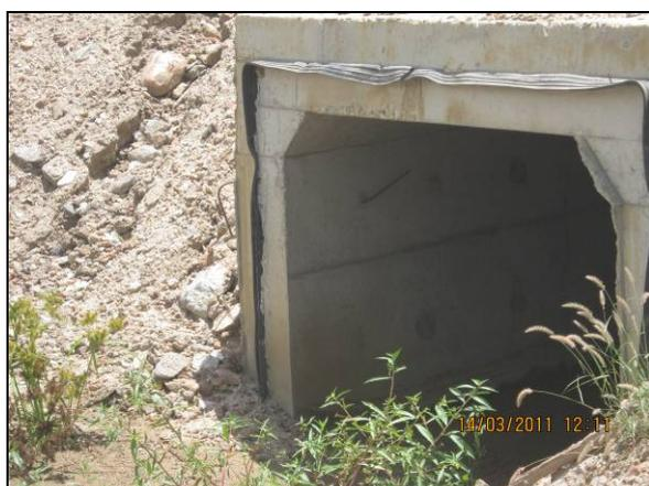
Foto 4.27.86. Bueiro em funcionamento, como medida de controle de processo erosivo (mar/11).
