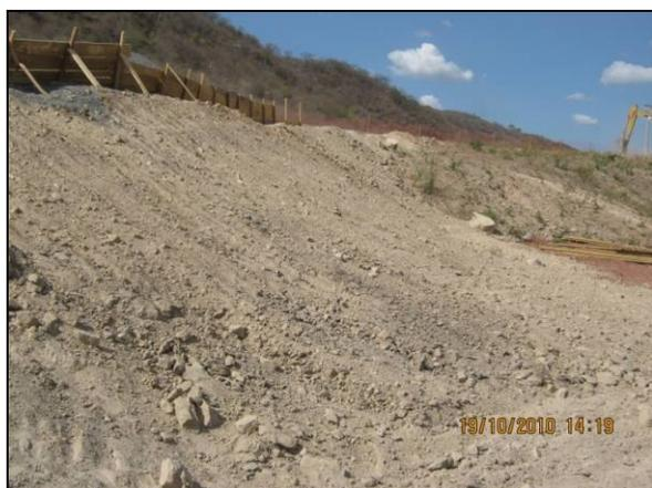
Foto 4.27.123. Suavização da inclinação do talude no emboque do túnel, próximo à área da central de armação (out/10).
