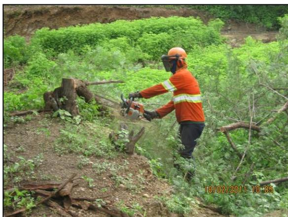
Foto 4.10.35. Supressão vegetal semimecanizada com uso de motosserra (fev/11).
