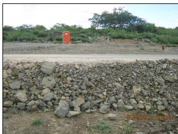
Foto 4.27.62. Enrocamento em área sensível na via de acesso, próximo a bueiro (mar/11).
