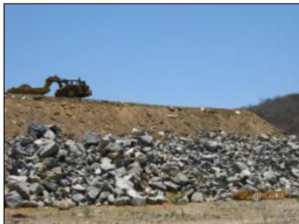
Foto 4.27.85. Disposição de material para realização de enrocamento no aterro do canal (out/10).
