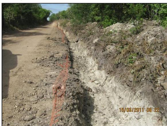
Foto 4.27.129. Canaleta lateral, como método preventivo de erosão, na via de acesso ao emboque do túnel (mar/11).
