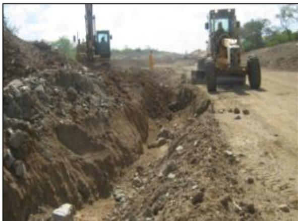
Foto 4.27.91. Suavização de terreno e abertura de dreno lateral à jusante do bueiro - Estaca 7307 (dez/10).
