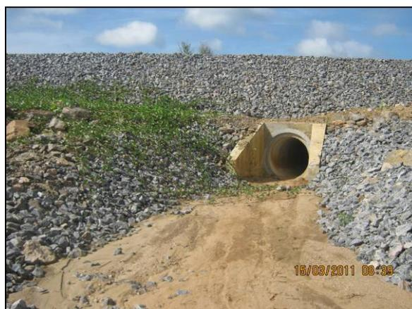
Foto 4.27.106. Enrocamento próximo ao bueiro para prevenção de processos erosivos (mar/11).
