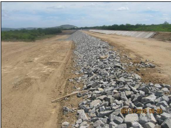
Foto 4.27.108. Enrocamento de taludes da via de acesso (dez/10).
