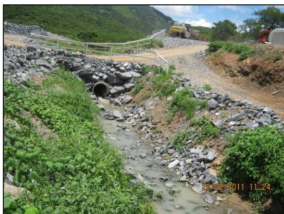
Foto 4.27.133. Sistema de drenagem de água pluvial instalado como medida preventiva (fev/11).
