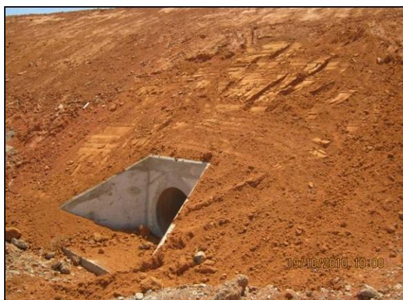
Foto 4.27.38. Recomposição de aterro do talude onde está construída a travessia 32 (out/10).
