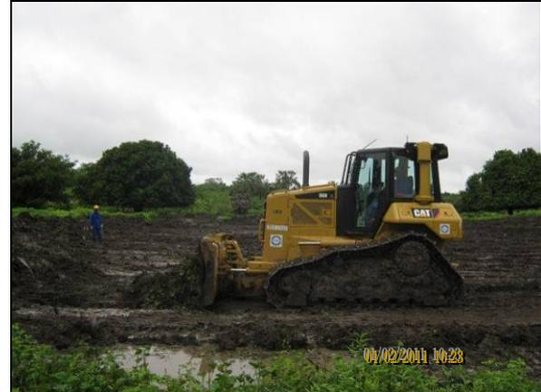
Foto 4.10.30. Atividade de remoção de expurgo com uso de trator de esteira (fev/11).
