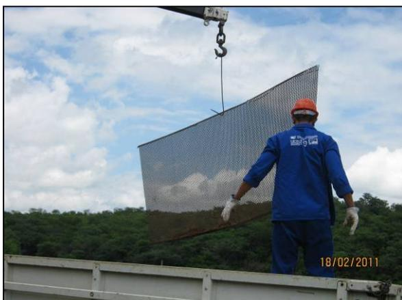
Foto 4.23.9. Grade para contenção da ictiofauna a ser instalada no Açude.
