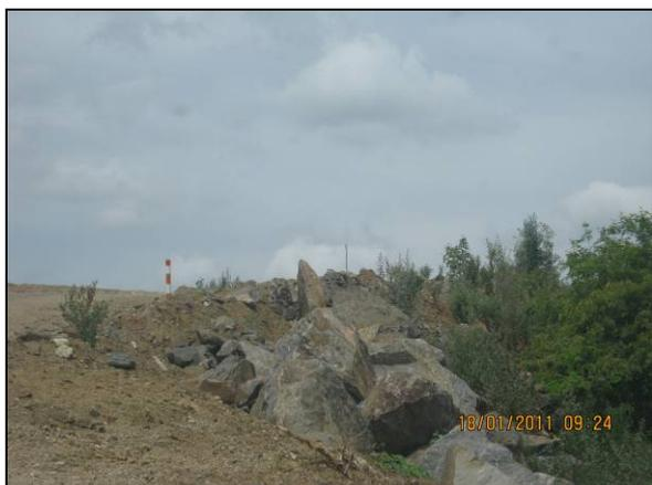
Foto 4.27.103. Enrocamento na lateral da via de acesso (jan/11).
