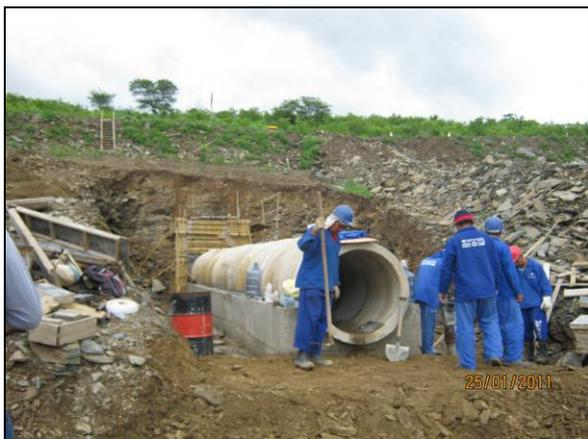
Foto 4.27.59. Instalação do bueiro - estaca 120 (jan/11).
