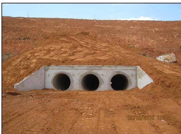
Foto 4.27.37. Recomposição de aterro do talude da travessia 31 (out/10).
