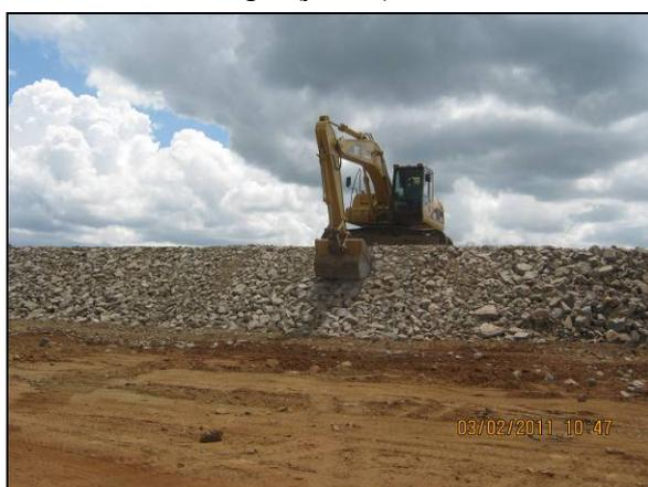
Foto 4.27.17. Conformação de talude do canal (fev/11).
