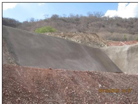
Foto 4.27.128. Vista frontal da contenção do talude realizada com concreto projetado (out/10).
