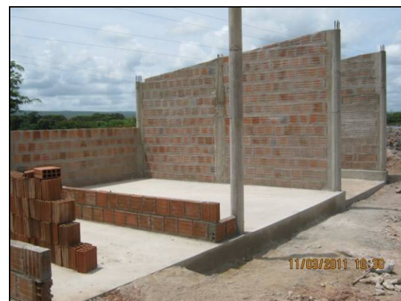
Foto 4.2.869.Construção de baias na área do emboque do túnel Cuncas I (mar/11).
