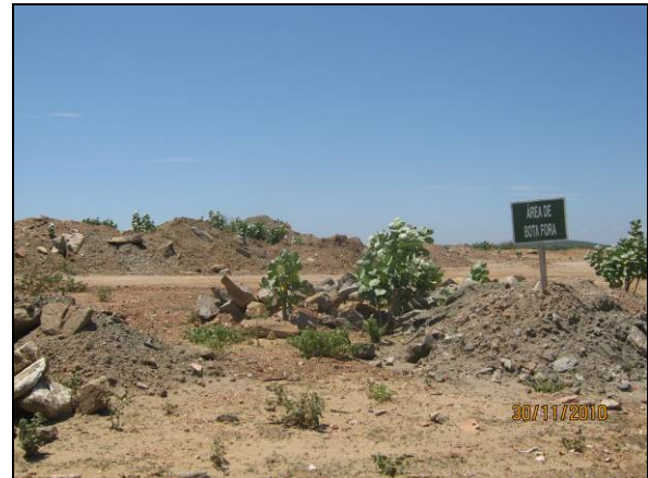
Foto 4.2.24. Área de bota-fora no reservatório Tucutu (nov/10).
