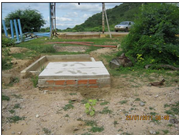
Foto 4.2.100. Separador de água e óleo ligado à saída da bacia de contenção para grupo gerador na captação de água do rio São Francisco (jan/11).
