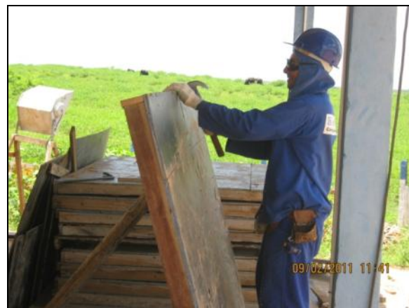
Foto 4.2.308. Colaborado utilizando EPI adequados para realização de atividade na carpintaria (fev/11).
