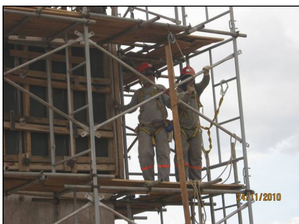
Foto 4.2.483. Colaboradores utilizando EPI durante as atividades no aqueduto BR-316 (nov/10).
