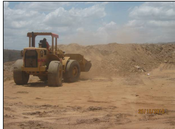
Foto 4.2.249. Bota-fora localizado na área de influência do reservatório Milagres (out/10).
