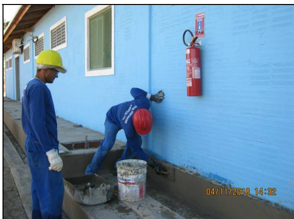
Foto 4.2.839. Extintor de incêndio instalado no refeitório do canteiro de obras (nov/10).
