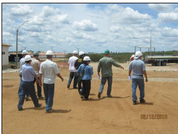
Foto 4.1.15. Equipes do IBAMA, MI e CMT em vistoria no canteiro do Lote 12 (dez/10).
