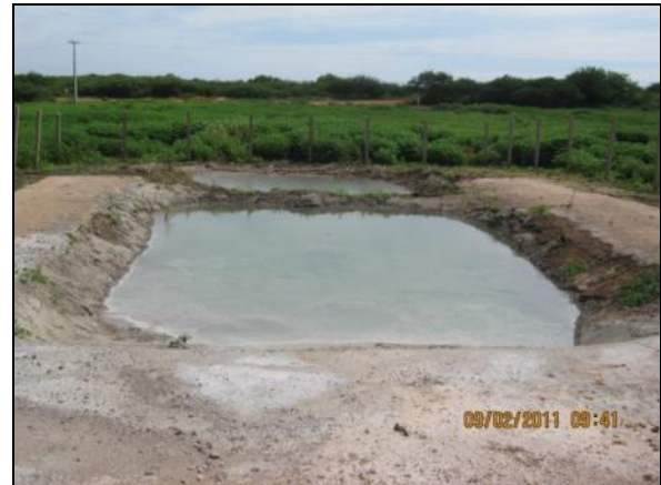
Foto 4.2.341. Bacia de decantação impermeabilizada (fev/11).
