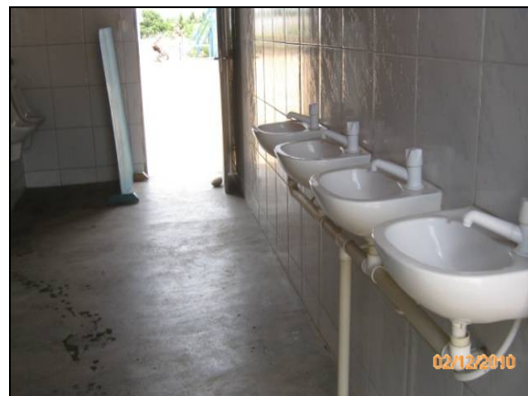
Foto 4.2.882. Lavatórios no banheiro do alojamento (dez/10).
