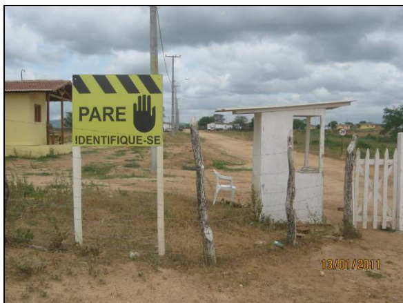
Foto 4.2.967. Guarita para controle do acesso de pessoas e veículos ao núcleo habitacional (jan/11).
