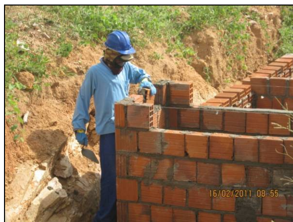
Foto 4.2.916. Colaborador utilizando EPI adequado em construção de unidade habitacional (fev/11).
