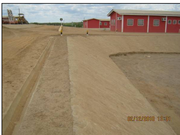
Foto 4.2.280. Canaletas e revestimentos dos taludes com concreto (dez/10).
