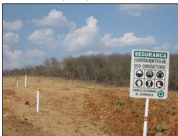
Foto 4.2.750. Sinalização de segurança instalada na área da EBV-5 (out/10).
