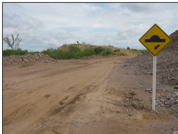
Foto 4.2.746. Sinalização para redução de velocidade instalada em via de acesso a EBV-1 (dez/10).
