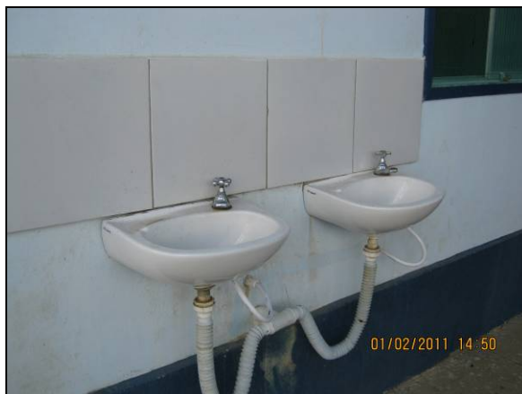
Foto 4.2.62. Lavatórios na área externa do refeitório geral (fev/11).
