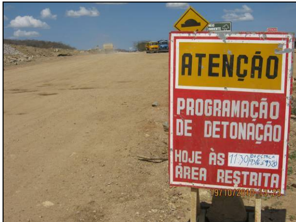
Foto 4.2.655. Sinalização indicando a programação de detonação, prezando a segurança no WBS 2226 (out/10).
