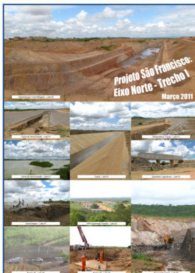
Figura 4.3.9. Cartaz fotográfico – Obras no Trecho I (mar/11).
