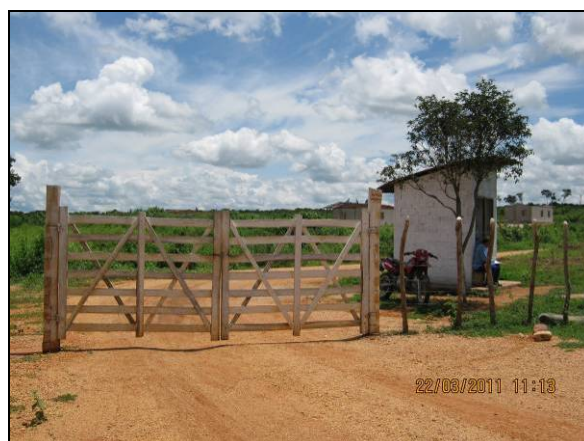
Foto 4.2.936. Guarita e portão para controle de acesso (mar/11).
