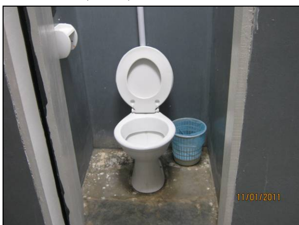
Foto 4.2.473. Sanitários em condições adequadas de limpeza (jan/11).
