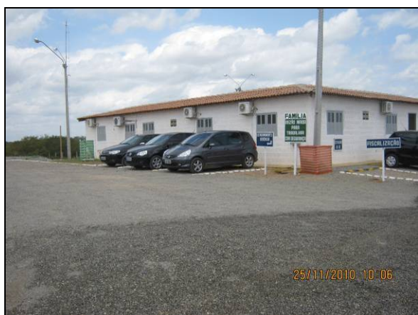
Foto 4.2.636. Instalações da unidade administrativa (nov/10).
