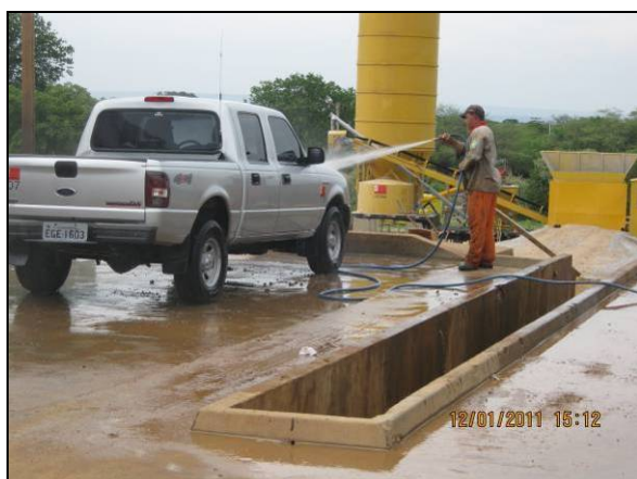
Foto 4.2.235. Rampa de lavagem de veículos da obra impermeabilizada (jan/11).
