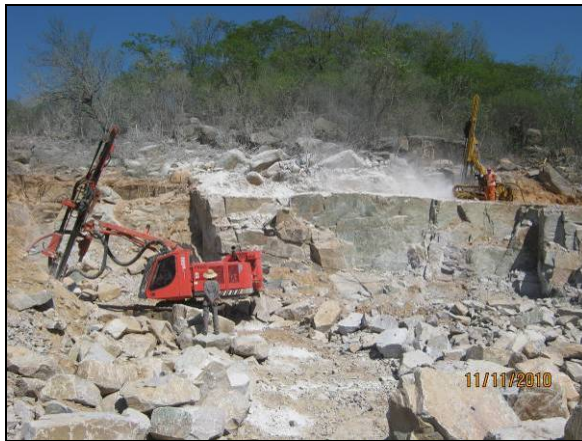
Foto 4.2.169. Jazida de material de 3ª categoria localizada na área do reservatório Negreiros (nov/10).
