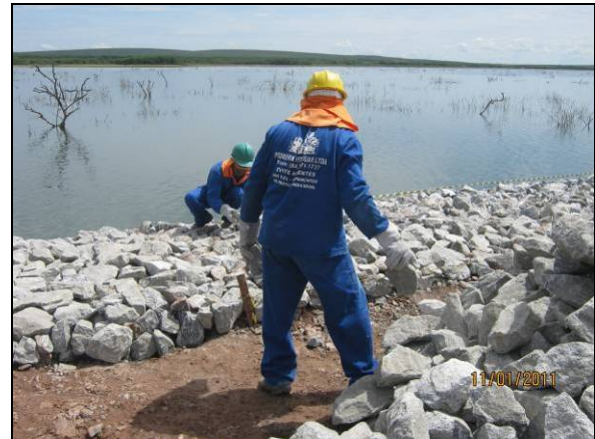
Foto 4.2.442. Colaboradores utilizando EPI, WBS 2204 (jan/11).
