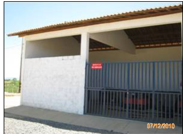
Foto 4.2.421. Local de armazenamento de óleo novo coberto, com piso impermeável (dez/10).
