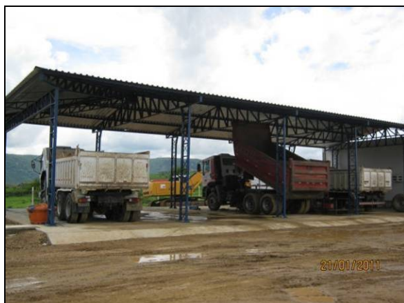
Foto 4.2.370. Oficina mecânica com cobertura da área de trabalho (jan/11).
