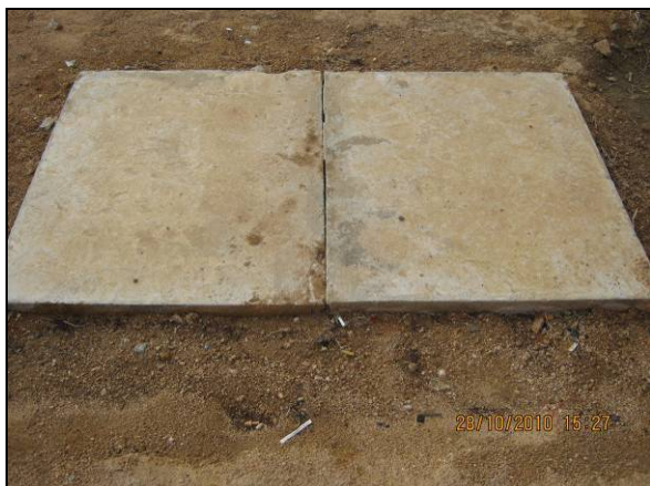
Foto 4.2.198. Vista da caixa de gordura (out/10).
