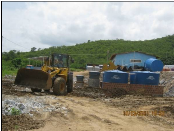
Foto 4.2.860. Instalação da ETE (mar/11).
