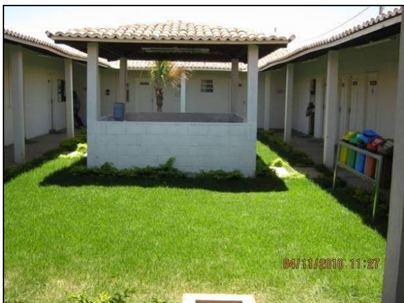
Foto 4.2.352. Área comum do consórcio construtor, limpa, com coletores de resíduos e bebedouro (nov/10).
