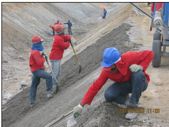
Foto 4.2.536.Colaboradores utilizando EPI durante as atividades no segmento de canal WBS 2212 (out/10).
