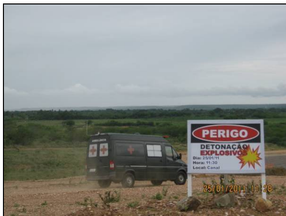
Foto 4.2.28. Placa de advertência e ambulância realizando a ronda antes da detonação no WBS 1204 (jan/11).
