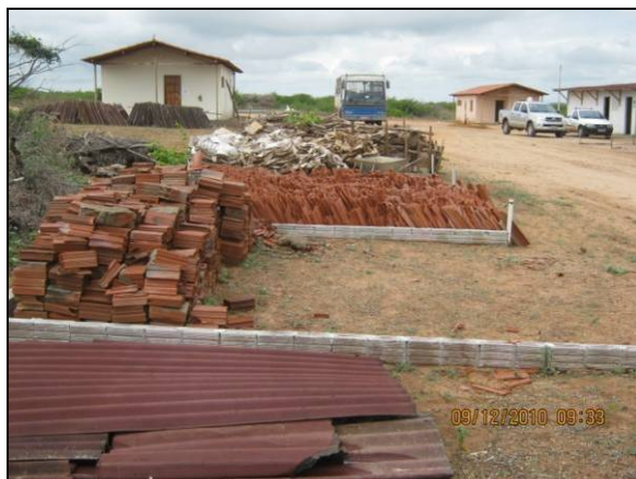
Foto 4.2.955. Resíduos inertes dispostos separadamente (dez/10).
