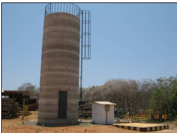
Foto 4.2.293. Reservatório de água para abastecimento do canteiro (out/10).
