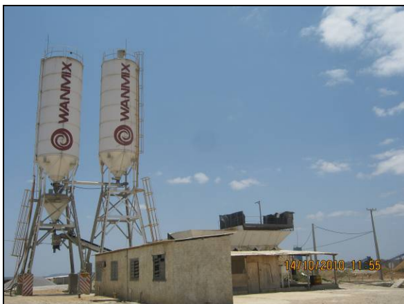
Foto 4.2.106. Central de concreto no WBS 1207 (out/10).
