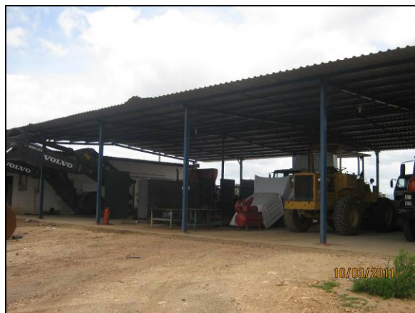
Foto 4.2.645. Oficina mecânica coberta e com piso impermeabilizado (mar/11).
