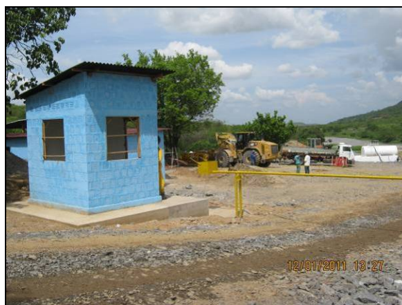
Foto 4.2.851. Guarita de controle de acesso no desemboque do túnel Cuncas I (jan/11).
