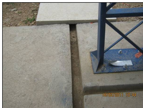
Foto 4.2.371. Piso impermeabilizado e canaletas na oficina mecânica (fev/11).
