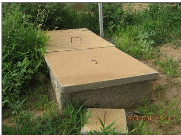
Foto 4.2.196. SAO do posto de abastecimento do canteiro (fev/11).
