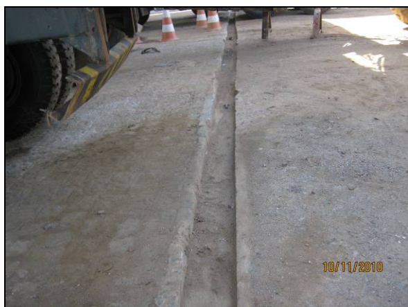
Foto 4.2.14. Vista da canaleta da oficina mecânica (nov/10).
