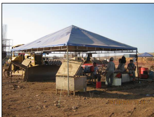
Foto 4.2.506. Estrutura de apoio para os colaboradores no Aqueduto da BR-316, WBS 2304 (out/10).
