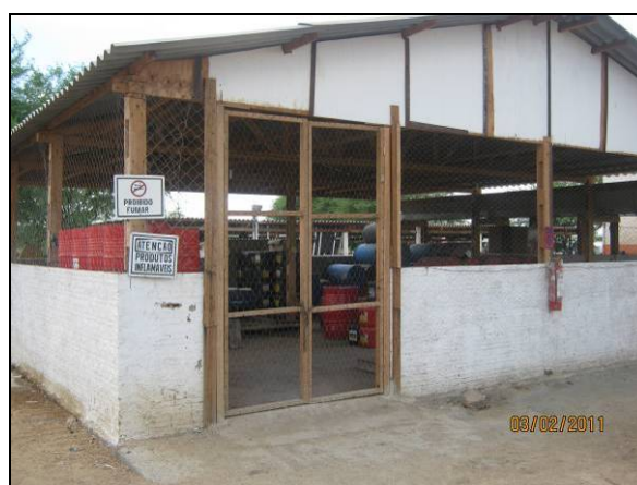
Foto 4.2.503. Baia para acondicionamento de resíduos perigosos presentes no canteiro de obras (fev/11).
