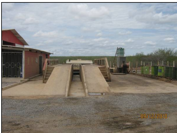
Foto 4.2.725.Vista do lavajato com rampa e piso impermeabilizado, no canteiro de obras de Floresta - PE (dez/10).
