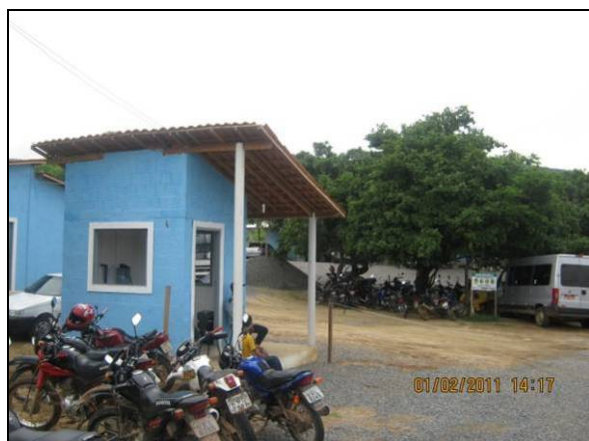
Foto 4.2.850. Guarita de acesso ao canteiro de obras (fev/11).
