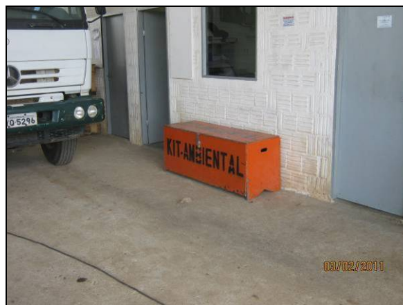
Foto 4.2.697. Kit ambiental visando mitigar vazamentos de produtos perigosos no canteiro de obras (fev/11).
