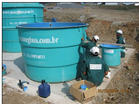
Foto 4.2.671. Técnicos de empresa contratada durante instalação da estação de tratamento de esgoto do canteiro (out/10).
