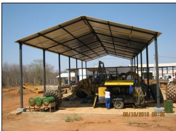
Foto 4.2.299. Oficina coberta, com piso impermeabilizado e canaletas de drenagem (out/10).
