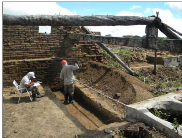
Foto 4.6.26. Abertura da sondagem para documentação da fundação.
