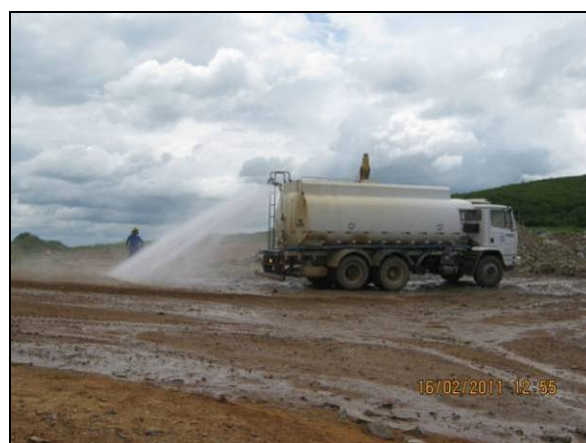
Foto 4.2.351. Umectação em via de acesso próximo ao britador (fev/11).
