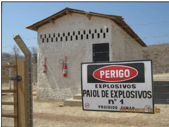
Foto 4.2.394. Paiol de explosivos cercado, com sinalização e extintores de incêndio (out/10).
