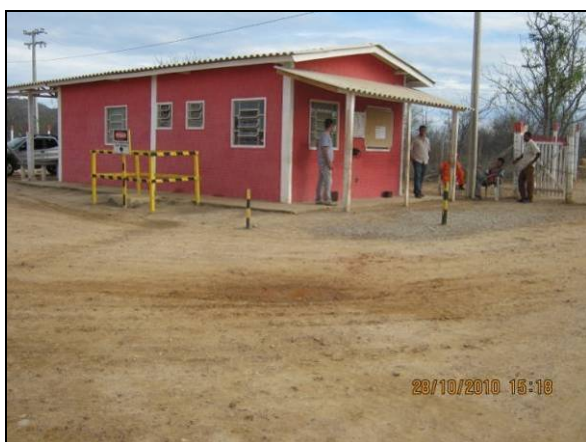
Foto 4.2.181. Guarita de controle do acesso ao canteiro de obras do consórcio construtor (nov/10).
