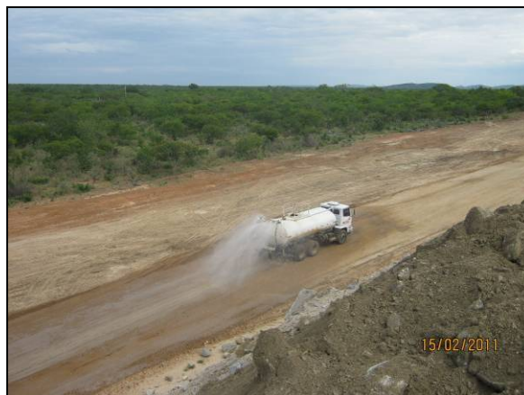
Foto 4.2.517. Aspersão de água em via de acesso no WBS 2213 (fev/11).
