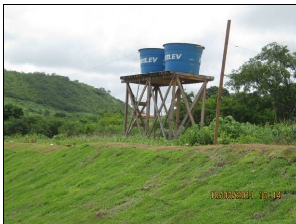
Foto 4.2.821. Armazenamento de água para distribuição no canteiro de obras (mar/11).
