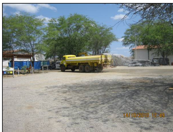
Foto 4.2.574. Umectação sendo realizada em via interna do canteiro de obras (out/10).
