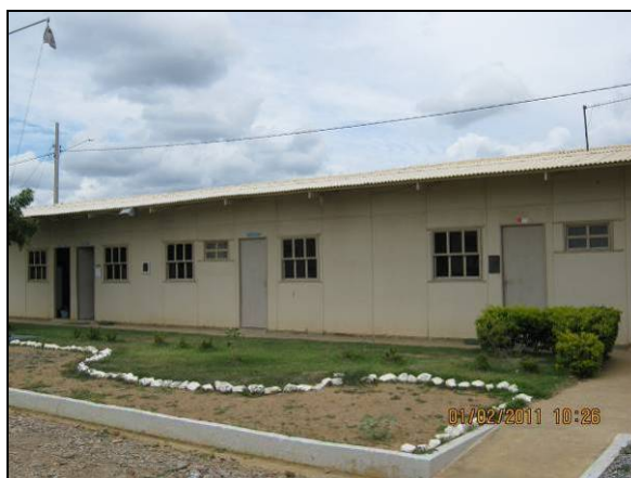
Foto 4.2.5. Vista frontal das salas técnicas e administrativas (fev/11).
