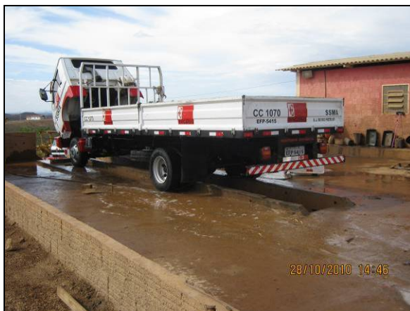
Foto 4.2.156. Rampa de lavagem em boas condições (out/10).
