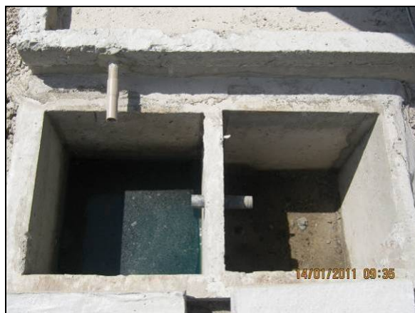
Foto 4.2.201. Caixa de retenção de óleo ligada à bacia de contenção do grupo gerador (jan/11).
