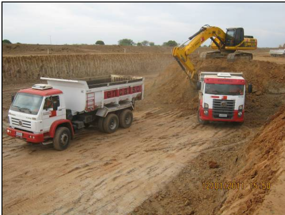
Foto 4.2.248. Caixa de empréstimo localizada no bordo direito do segmento de canal WBS 1223 (jan/11).
