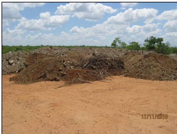
Foto 4.2.171. Bota-fora localizado dentro da faixa de domínio no WBS 1219 (nov/10).
