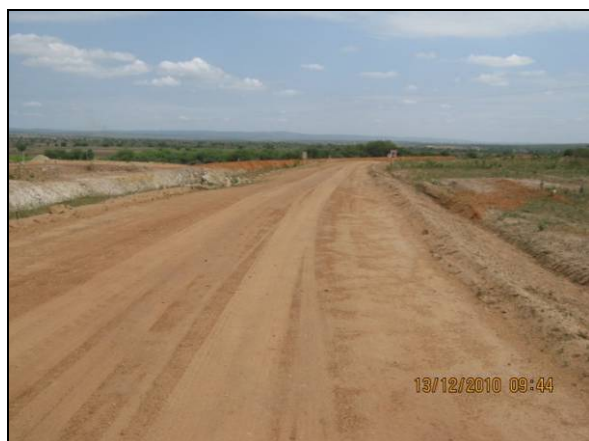
Foto 4.2.283. Via de acesso aplainada no segmento de canal WBS 1231 (dez/10).
