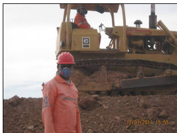
Foto 4.2.244. Uso de EPI por colaboradores em atividade de terraplenagem no WBS 1223 (jan/11).
