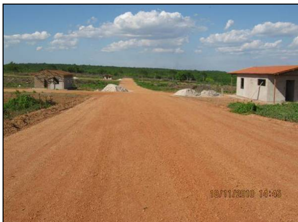
Foto 4.2.929. Via interna bem dimensionada e em boas condições de trafegabilidade (nov/10).
