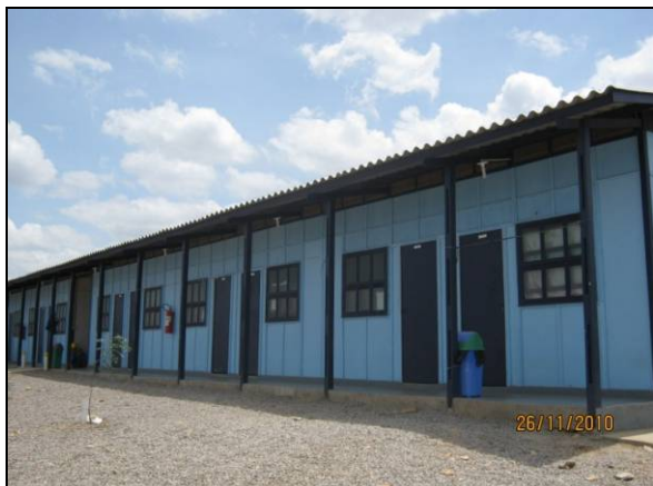
Foto 4.2.112. Vista dos alojamentos do canteiro de apoio de Umãs (nov/10).
