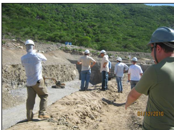
Foto 4.1.13. Vistoria emboque do túnel Cuncas I, Lote 14 (dez/10).
