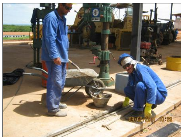
Foto 4.2.300. Manutenção das canaletas de drenagem (fev/11).
