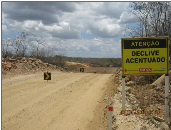
Foto 4.2.543. Sinalização de advertência em local adequado no WBS 2212 (out/10).
