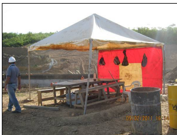
Foto 4.2.213. Tenda de apoio instalada na frente de serviço do bueiro B 020, WBS 1219 (fev/11).
