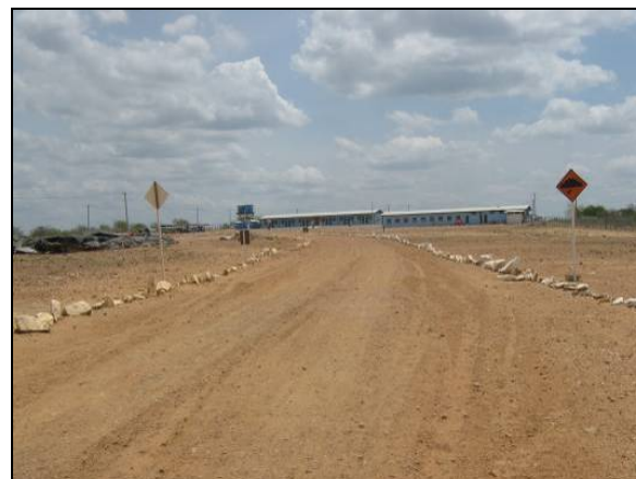
Foto 4.2.109. Via interna do canteiro de apoio em boas condições de tráfego (dez/10).
