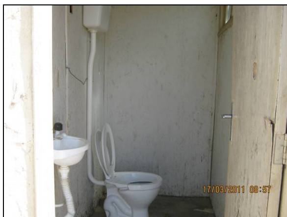
Foto 4.2.51. Banheiro em boas condições uso na área externa do refeitório do Canal de Aproximação (mar/11).
