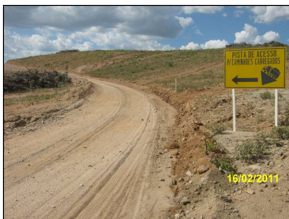
Foto 4.2.748. Placa de sinalização informativa em via de acesso a EBV-3 (fev/11).
