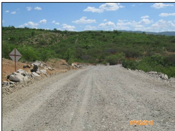
Foto 4.2.348. Via de acesso ao britador em condições de trafegabilidade (dez/10).
