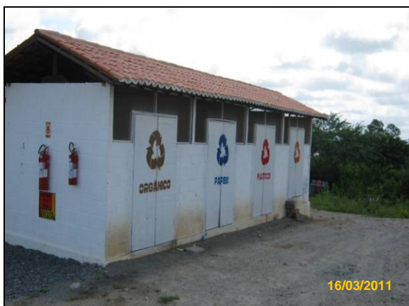
Foto 4.2.417. Baia de resíduos com identificação e portas (mar/11).
