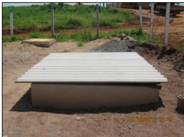
Foto 4.2.326. Construção de câmara de alvenaria para o SAO (fev/11).
