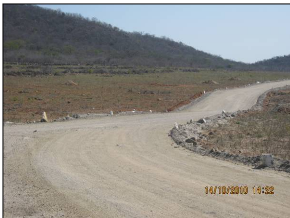
Foto 4.2.108. Via de acesso conservada no reservatório Serra do Livramento (out/10).
