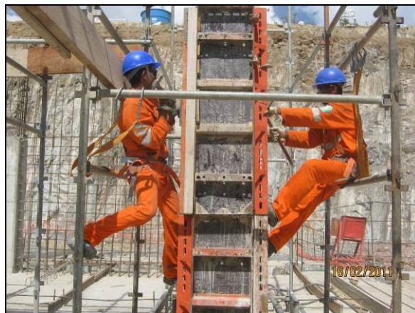
Foto 4.2.740. Colaboradores utilizando EPI específicos para trabalho em alturas na EBV-2 (fev/11).
