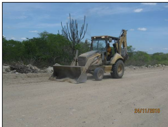
Foto 4.2.572. Máquina realizando melhoria em via de acesso no WBS 2219 (nov/10).
