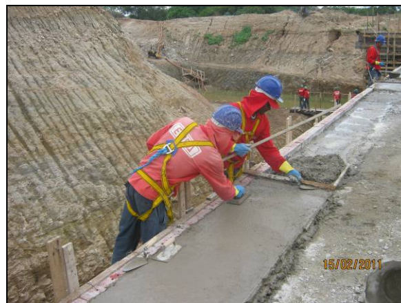
Foto 4.2.537.Colaboradores utilizando EPI durante atividade de concretagem no reservatório Muquém (fev/11).
