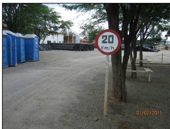
Foto 4.2.598. Sinalização para controle de velocidade instalada em via interna do canteiro de obras (fev/11).
