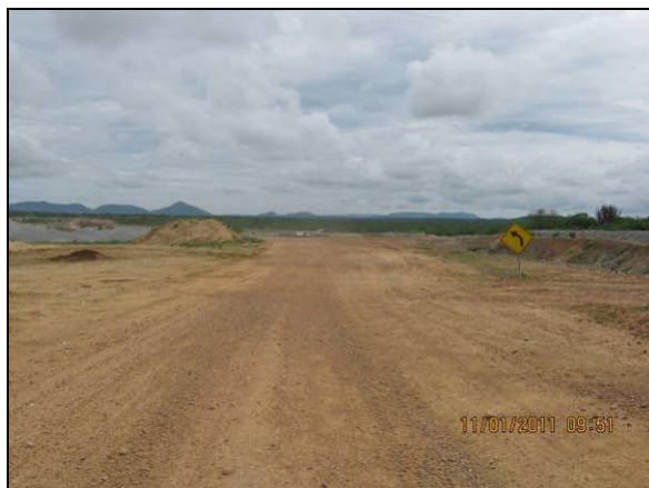
Foto 4.2.3. Via de acesso do reservatório Tucutu em boas condições de trafegabilidade (jan/11).
