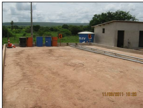
Foto 4.2.862. Pista do lavajato impermeabilizada, com muretas e canaletas no emboque do túnel Cuncas I (mar/11).
