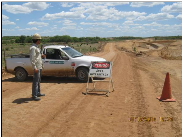
Foto 4.2.250. Barreira de segurança implantada durante o desmonte de rocha no WBS 1222 (dez/10).
