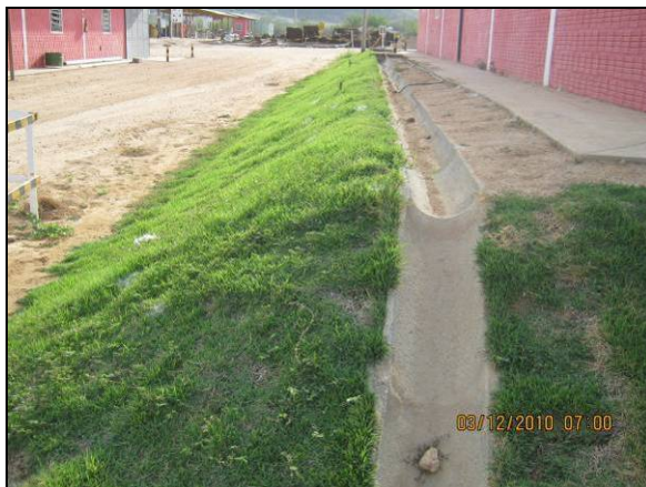
Foto 4.2.218. Taludes do canteiro com gramíneas e canaleta de drenagem (dez/10).
