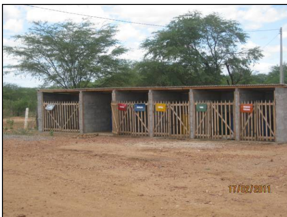
Foto 4.2.447. Baias para separação e acondicionamento de resíduos no canteiro de obras (fev/11).
