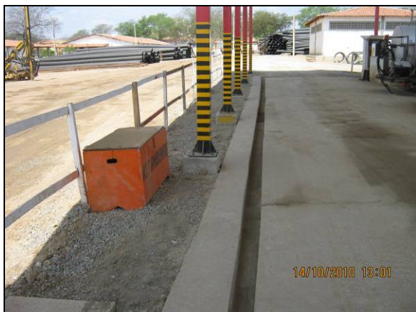
Foto 4.2.579. Presença de kit mitigador, piso impermeável e canaletas de drenagem do SAO (out/10).
