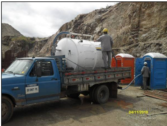
Foto 4.2.761. Coleta de efluentes sanitários e higienização de banheiros químicos na área da EBV-6 (nov/10)
