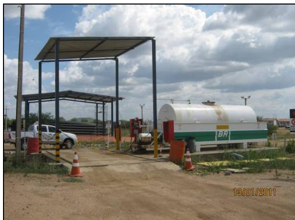
Foto 4.2.644. Vista geral do posto de abastecimento com cobertura, piso impermeabilizado e canaletas (jan/11).
