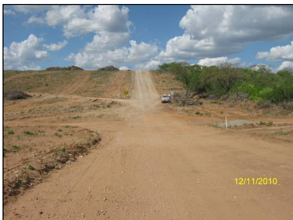
Foto 4.2.700. Via de acesso em boas condições de trafegabilidade na EBV-3 (nov/10).
