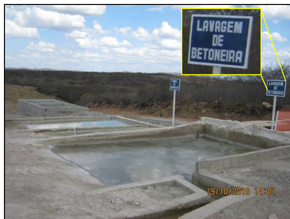
Foto 4.2.687. Sistema de Tratamento dos efluentes oriundos da central de concreto no WBS 2225 (out/10).
