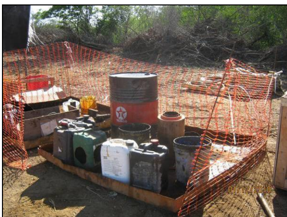
Foto 4.2.102. Resíduos Classe I dispostos sobre badejas coletoras nas frentes de serviço (dez/10).
