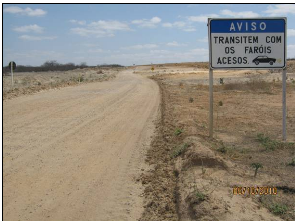
Foto 4.2.185. Placa orientando a conduta dos veículos em via de acesso WBS 1218 (out/10).
