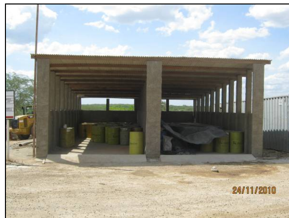
Foto 4.2.616. Baía para acondicionamento de produtos químicos na central de concreto do WBS 2220 (nov/11).
