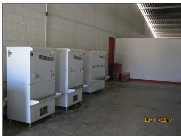
Foto 4.2.525. Bebedouros com água potável no interior do refeitório (nov/10).
