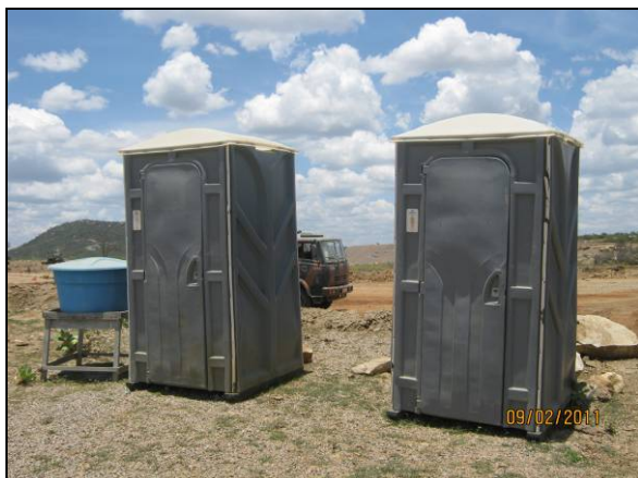
Foto 4.2.47. Banheiros químicos disponibilizados na frente de serviço do reservatório Tucutu (fev/11).
