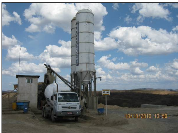
Foto 4.2.694. Central de concreto em condições adequadas ao funcionamento no WBS 2225 (out/10).
