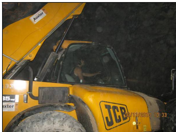
Foto 4.2.830. Operador com protetor auricular na aplicação de tirantes no desemboque do túnel Cuncas I (nov/10).
