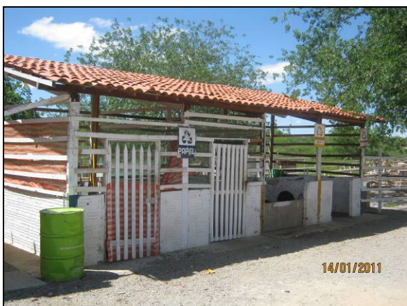
Foto 4.2.613. Baía separadora de resíduos sólidos localizada no canteiro de obras (jan/11).
