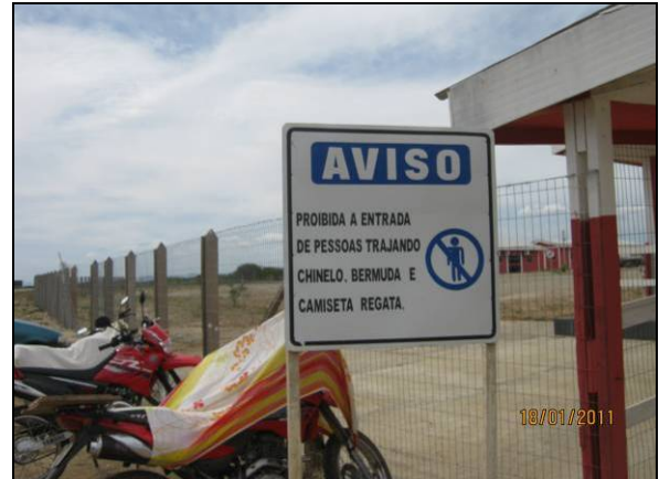
Foto 4.2.754. Placa informando as normas a serem seguidas no canteiro de obras em Sertânia - PE (jan/11).
