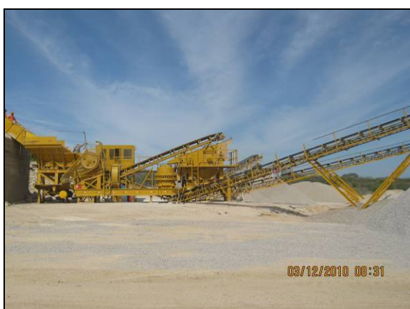
Foto 4.2.207. Britador em funcionamento, WBS 1218 (dez/10).
