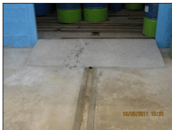
Foto 4.2.819. Piso impermeabilizado e canaleta em condições adequadas (mar/11).
