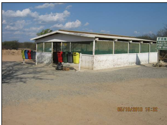
Foto 4.2.688. Ponto de apoio em condições adequadas protegido por telas no WBS 2224 (out/10).
