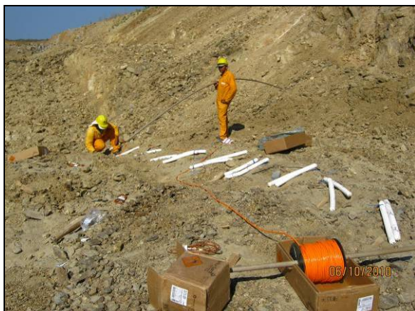
Foto 4.2.591. Execução de plano de fogo por colaboradores treinados no WBS 2220 (out/10).
