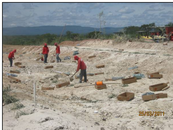
Foto 4.2.540. Colaboradores realizando o carregamento de explosivos no segmento de canal WBS 2213 (mar/11).
