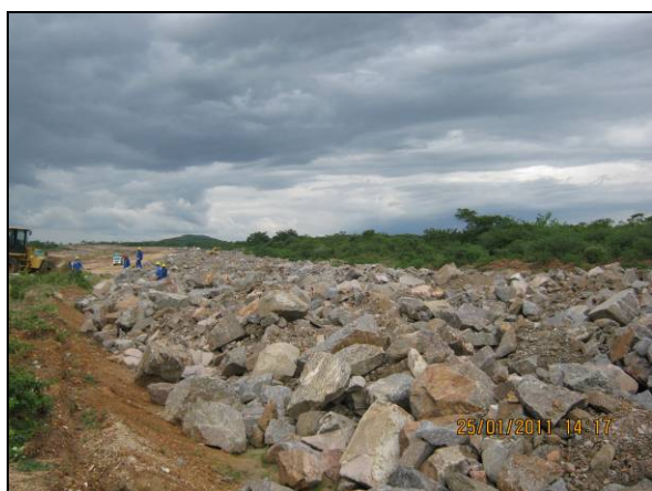
Foto 4.2.76. Área de empréstimo e bota-fora na faixa de domínio do canal, WBS 1208 (jan/11).
