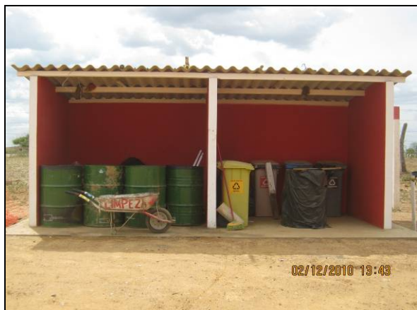
Foto 4.2.257. Baía para acondicionamento de resíduos sólidos (dez/10).
