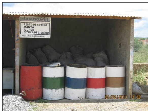
Foto 4.2.97. Baía de resíduos do canteiro de obras (fev/11).
