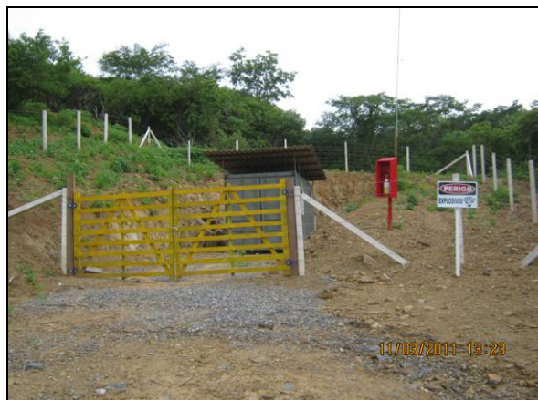
Foto 4.2.846. Instalações do paiol com pára-raio, extintor de incêndio e sinalização (mar/11).
