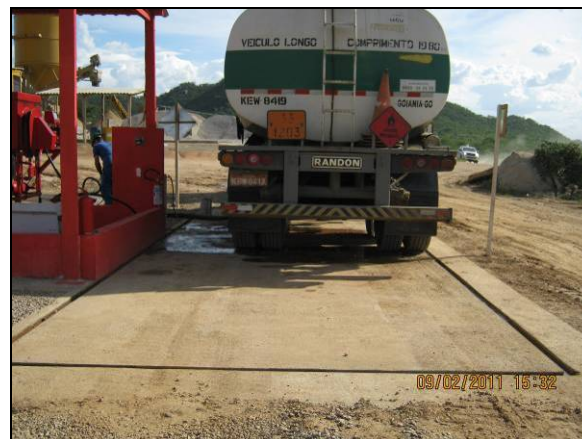
Foto 4.2.203. Pista de abastecimento impermeabilizada e canaletas desobstruídas (fev/11).
