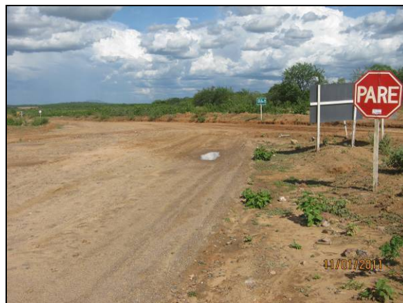
Foto 4.2.444. Sinalização em condição adequada a longo do trecho no reservatório Areias WBS 2104 (jan/11).
