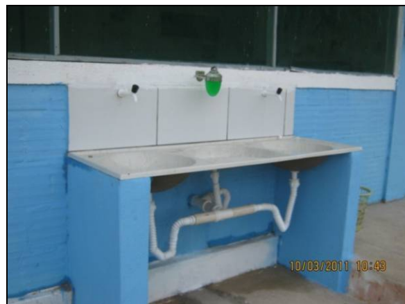
Foto 4.2.817. Lavatório na parte externa do refeitório (mar/11).
