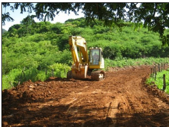
Foto 4.2.805. Manutenção em via de acesso ao desemboque do túnel Cuncas II (jan/11).
