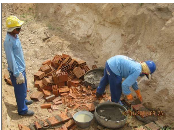
Foto 4.2.917. Uso correto de equipamentos de proteção individual por colaboradores na construção de fossa séptica (jan/11).
