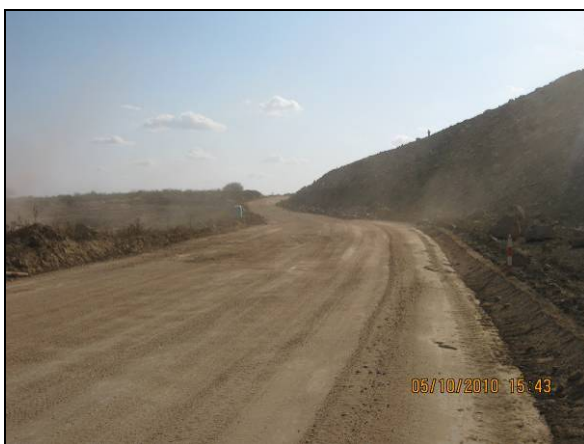
Foto 4.2.632. Via de acesso aplainada, propiciando bom dimensionamento no segmento WBS 2224 (out/10).
