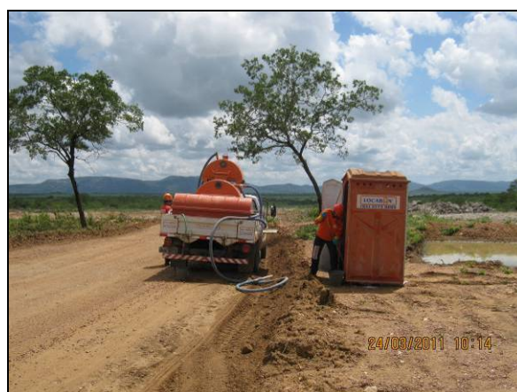
Foto 4.2.92. Realização de manutenção no banheiro químico (mar/11).
