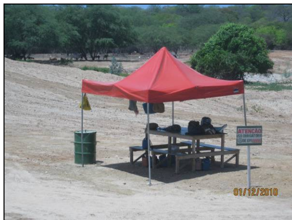
Foto 4.2.564. Tenda de apoio presente no Aqueduto Jacaré WBS 2305 (dez/10).
