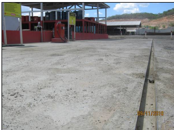
Foto 4.2.555. Canaleta de direcionamento de efluentes ao SAO do posto de abastecimento (nov/10).
