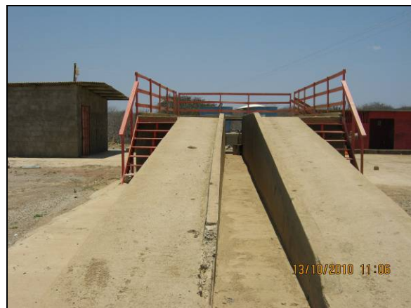
Foto 4.2.726.Rampa e piso impermeabilizada no lavajato do canteiro de apoio a EBV-6 em Sertânia - PE (out/10).
