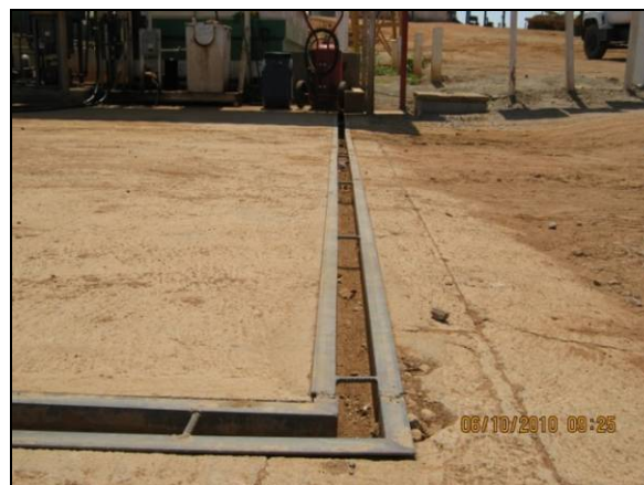
Foto 4.2.302. Canaleta de drenagem com manutenção adequada (out/10).
