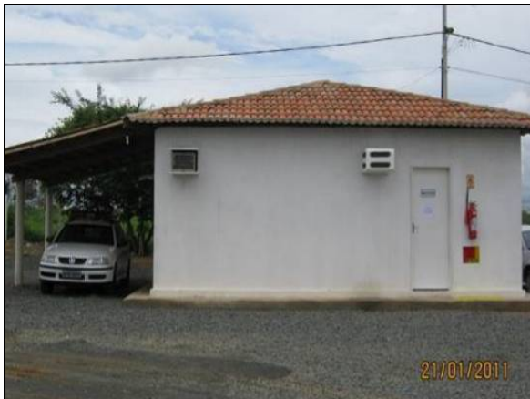
Foto 4.2.378. Ambulatório com extintor de incêndio no canteiro de obras (jan/11).
