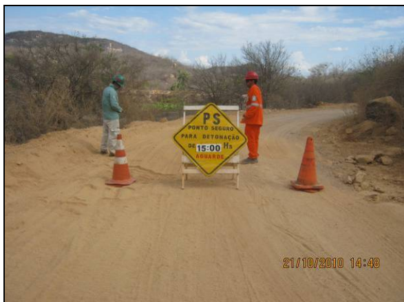
Foto 4.2.173. Barreira de proteção durante detonação no reservatório Negreiros (out/10).
