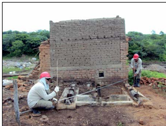
Foto 4.6.17. Levantamento planialtimétrico do sítio.
