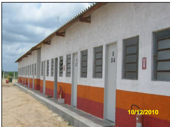
Foto 4.2.471. Alojamento com infraestrutura para os colaboradores (dez/10).
