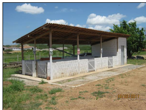
Foto 4.2.683. Baia separadora de resíduos sólidos localizada no canteiro de obras (fev/11).
