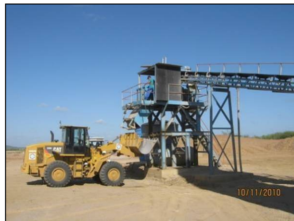
Foto 4.2.107. Usina de solo-cimento no WBS 1207 (nov/10).
