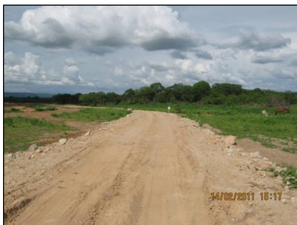
Foto 4.2.284. Via de acesso em boas condições de trafegabilidade no WBS 1232 (fev/11).
