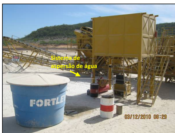
Foto 4.2.208. Reservatório de água usado no processo de britagem para redução da emissão de particulados (dez/10).
