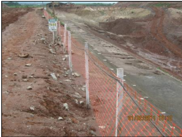
Foto 4.2.833. Tela sinalizadora instalada na borda do talude, na área do emboque do túnel Cuncas I (fev/11).
