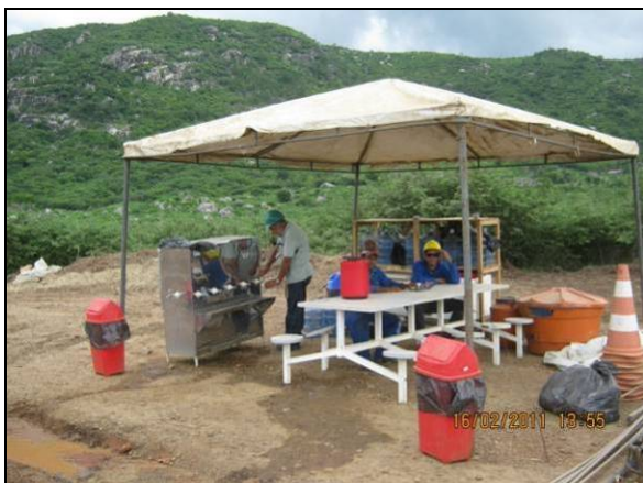
Foto 4.2.425. Tenda de apoio no segmento WBS 1235 (fev/11).
