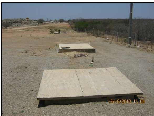
Foto 4.2.767. SAO do lavajato do canteiro de apoio da EBV-6 em Sertânia - PE (out/10).
