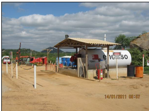
Foto 4.2.158. Posto de abastecimento em condições adequadas de funcionamento (jan/11).
