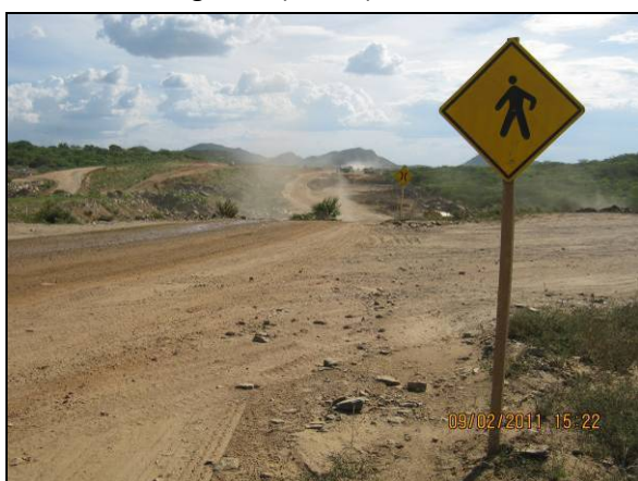
Foto 4.2.179. Placa de advertência implantada no WBS 1218 (fev/11).
