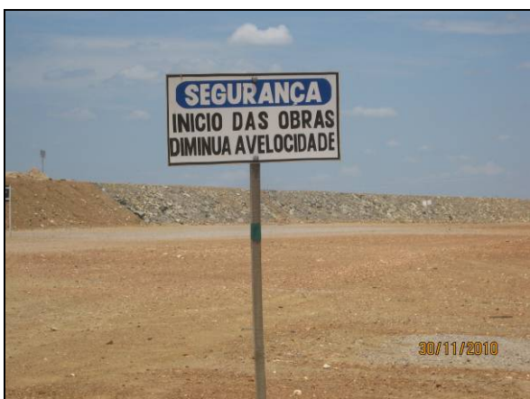
Foto 4.2.84. Placas de sinalização, WBS 1205 (nov/10).
