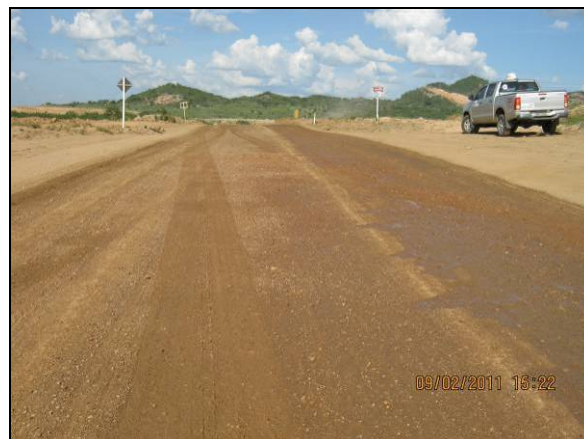
Foto 4.2.145. Via de acesso bem dimensionada e conservada no WBS 1219 (fev/11).
