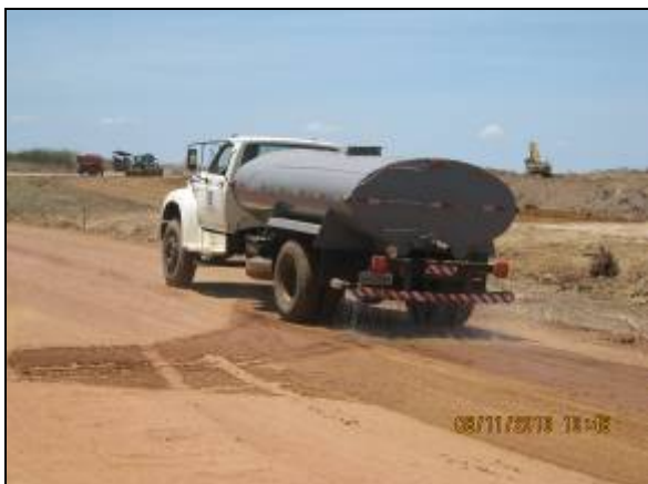
Foto 4.2.285.Umectação da via de acesso no segmento de canal WBS 1232 (nov/10).
