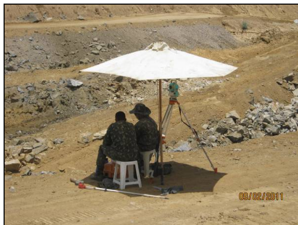
Foto 4.2.20. Colaboradores utilizando guarda-sol (EPC) no WBS 1204 (fev/11).
