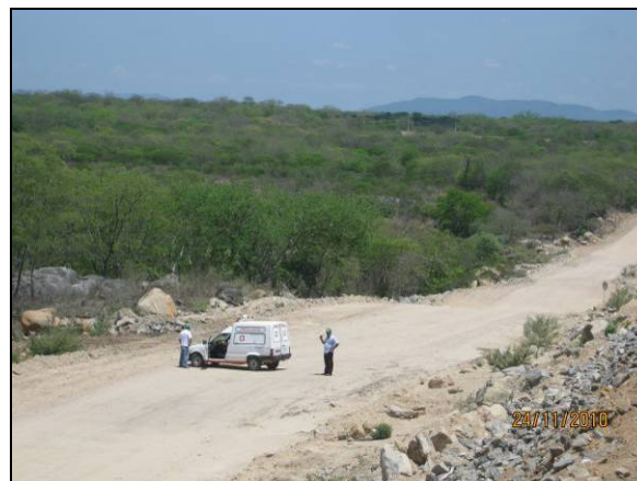
Foto 4.2.592. Procedimento de segurança em via de acesso em momento de detonação no WBS 2218 (nov/10).
