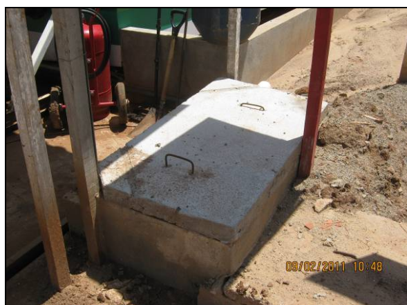
Foto 4.2.328. Construção de caixa separadora de areia para a pista de abastecimento (fev/11).
