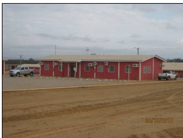
Foto 4.2.226. Vista externa do escritório administrativo (out/10).
