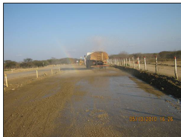
Foto 4.2.633. Umectação da via de acesso no segmento WBS 2223 (out/10).
