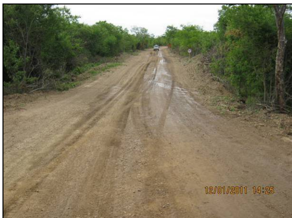
Foto 4.2.804. Via de acesso ao desemboque do túnel Cuncas I umectada para controle de emissão de poeira (jan/11).
