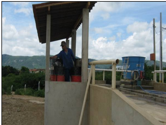
Foto 4.2.420. Baia coberta para armazenamento de tambores de óleo usados na área do lavajato (mar/11).
