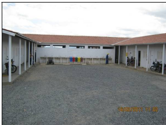
Foto 4.2.353. Área externa do alojamento em boas condições de limpeza (fev/11).
