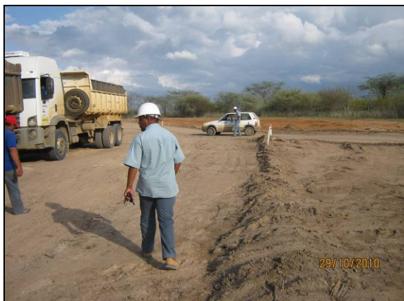
Foto 4.2.541. Blaster responsável orientando sobre o bloqueio da via e evacuação da área, no WBS 2217 (out/10).
