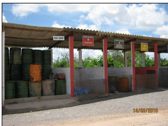
Foto 4.2.777. Baía separadora de resíduos sólidos no canteiro de obras de Floresta - PE (mar/11)
