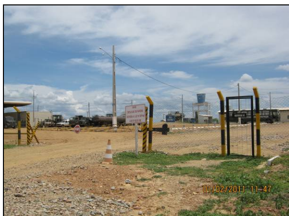
Foto 4.2.29. Entrada do canteiro de obras do 2º BEC com controle de acesso de pessoas e veículos (fev/11).
