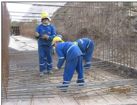
Foto 4.2.652. Colaboradores utilizando EPI durante atividade de montagem de forma no WBS 2225 (nov/10).
