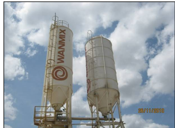
Foto 4.2.142.Central de concreto no WBS 1214 (nov/10).
