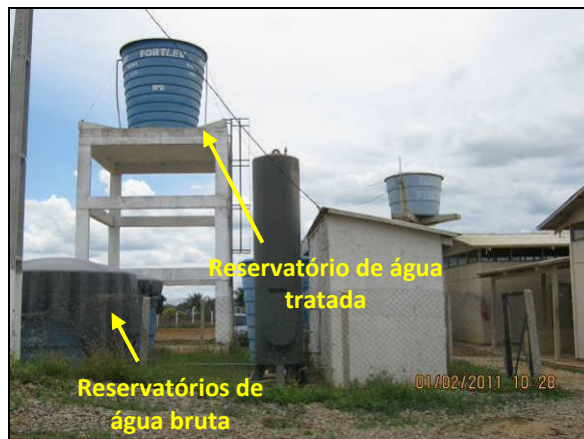
Foto 4.2.13. Vista geral dos reservatórios de água (fev/11).
