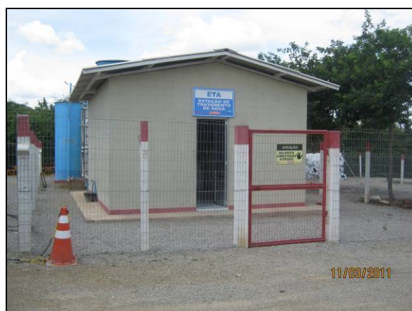
Foto 4.2.527. Instalações da Estação de Tratamento de Água (mar/10).
