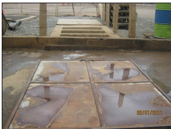
Foto 4.2.768. SAO do lavajato do canteiro de obras de Floresta - PE (jan/11).
