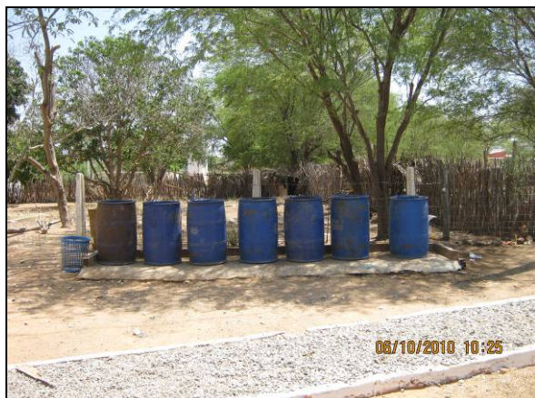
Foto 4.2.449. Recipientes para acondicionamento de resíduos no canteiro de obras (out/10).
