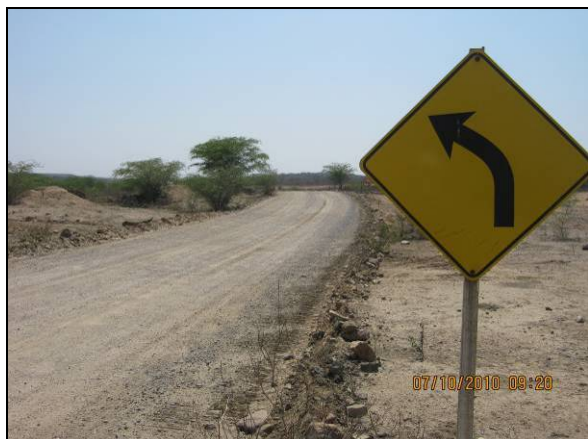
Foto 4.2.443. Sinalização de advertência em via de acesso ao reservatório Areias WBS 2104 (out/10).
