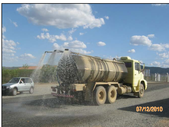
Foto 4.2.350. Aspersão de água em via interna do canteiro de obras (dez/10).
