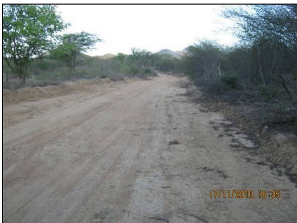
Foto 4.2.913. Via de acesso em boas condições de trafegabilidade (nov/10).
