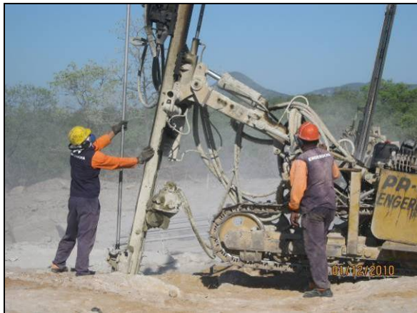
Foto 4.2.78. Perfuração em rocha no WBS 1208 (dez/10).
