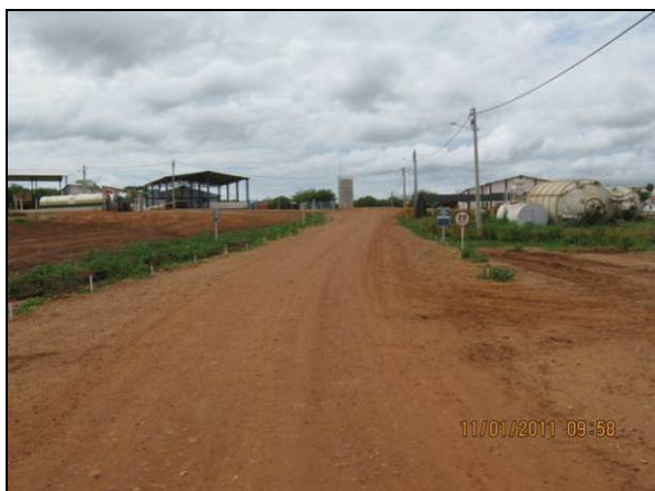
Foto 4.2.281. Via de acesso com dimensionamento adequado no canteiro de obras (jan/11).
