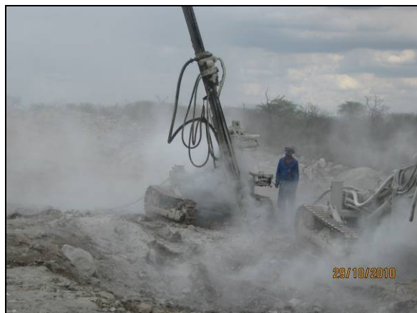
Foto 4.2.487. Uso da perfuratriz para instalação de explosivos no WBS 2208 (out/10).
