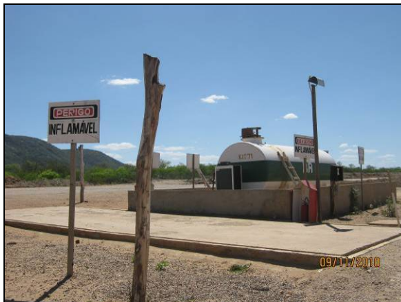
Foto 4.2.141.Posto de abastecimento com pista impermeabilizada, bacia de contenção, canaletas e SAO (nov/10).
