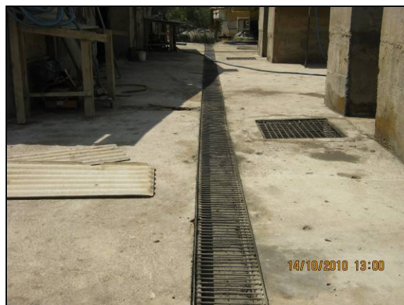
Foto 4.2.606. Canaleta de direcionamento ao SAO do lavajato (out/10).
