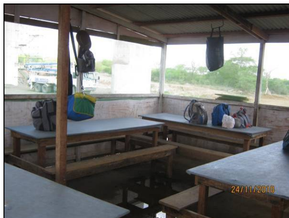
Foto 4.2.621. Ponto de apoio do Aqueduto Barreiros, WBS 2308 (nov/10).
