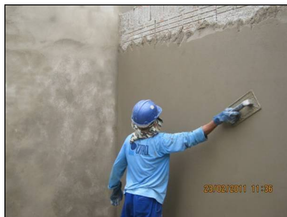
Foto 4.2.932. Colaborador utilizando EPI em atividade de acabamento (fev/11).
