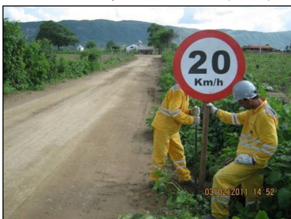
Foto 4.2.854. Instalação de placa de regulamentação em via de acesso ao desemboque do túnel Cuncas I (fev/11).
