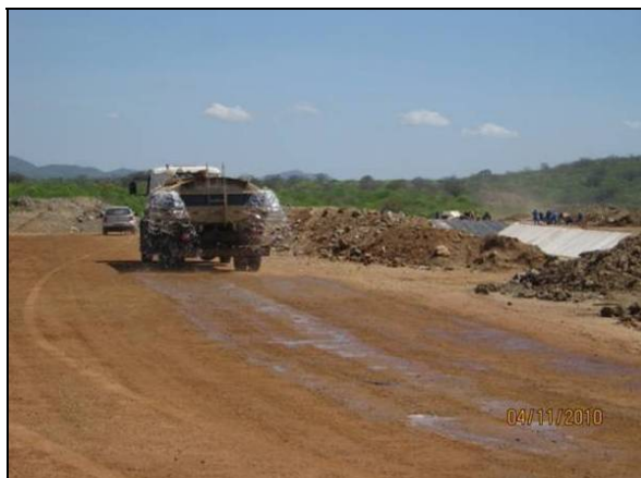
Foto 4.2.110. Umectação da via de acesso, WBS 1214 (nov/10).
