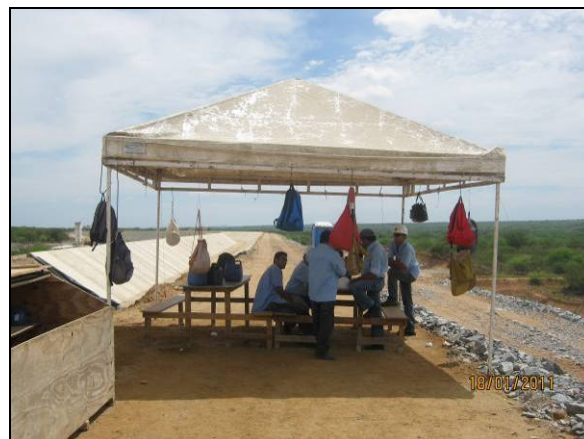
Foto 4.2.623. Tenda de apoio instalada na área do Aqueduto Barreiro, WBS 2308 (jan/10).
