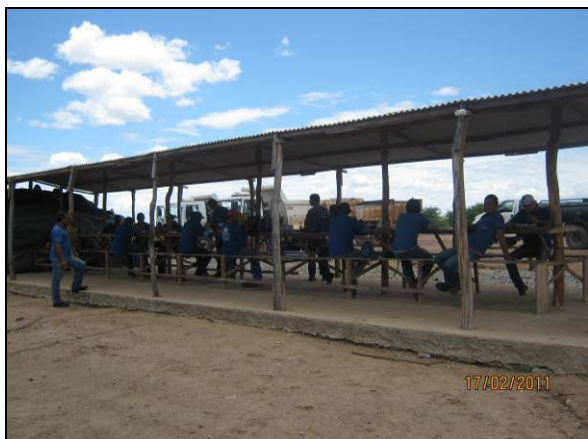
Foto 4.2.456. Estrutura de apoio disponibilizada no trecho II do WBS 2204 (fev/11).
