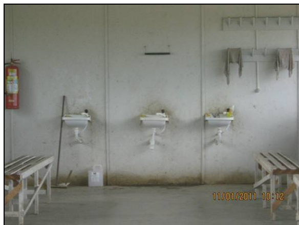
Foto 4.2.54. Lavatórios adequados e extintor de incêndio no refeitório do reservatório Tucutu (jan/11).
