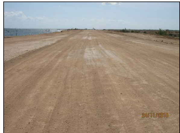
Foto 4.2.434. Via com dimensionamento adequado, propiciando a boa trafegabilidade no WBS 2204 (nov/10).
