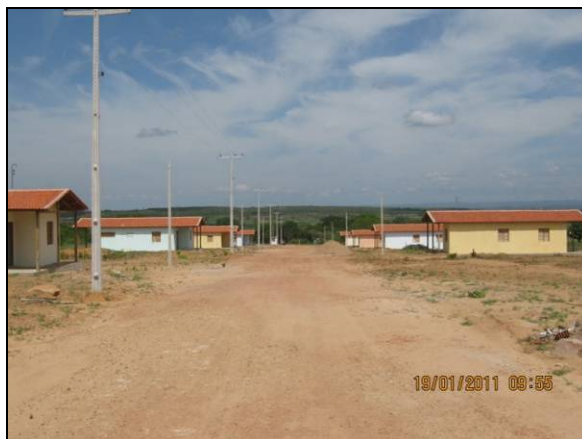
Foto 4.2.947. Via interna com dimensionamento adequado (jan/11).
