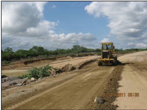
Foto 4.2.57. Máquina realizando manutenção de via de acesso no WBS 1208 (jan/11).
