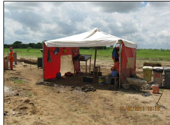
Foto 4.2.272. Tenda de apoio implantada na frente de serviço do bueiro B 05, WBS 1224 (fev/11).
