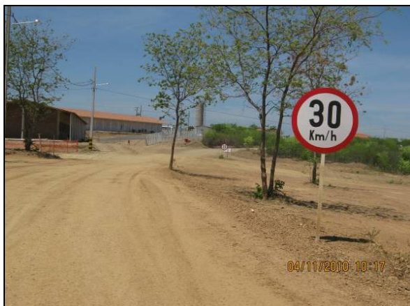
Foto 4.2.396. Placa de regulamentação em via de acesso do canteiro de obras (nov/10).
