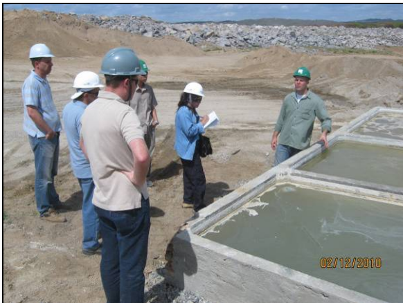
Foto 4.1.19. Vistoria no tanque de sedimentação na Central de Concreto, Lote 12 (dez/10).
