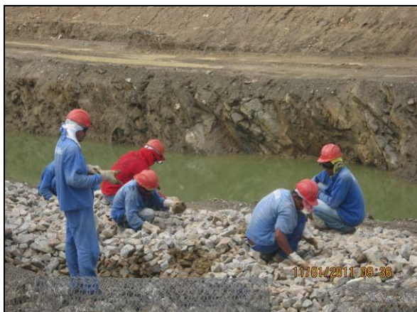
Foto 4.2.19. Colaboradores utilizando EPI no Canal de Aproximação (jan/11).
