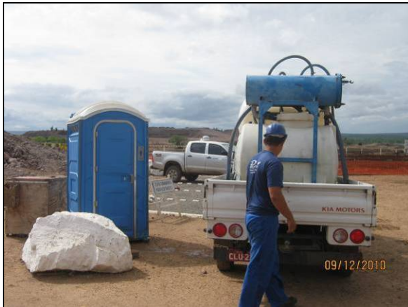
Foto 4.2.759. Coleta de efluentes sanitários em banheiro químico no ponto de apoio da EBV-1 (dez/10).
