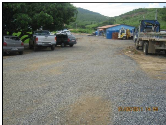
Foto 4.2.801. Via principal do canteiro (fev/11).
