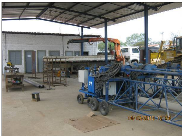
Foto 4.2.581. Oficina mecânica com cobertura e piso impermeável (out/10).
