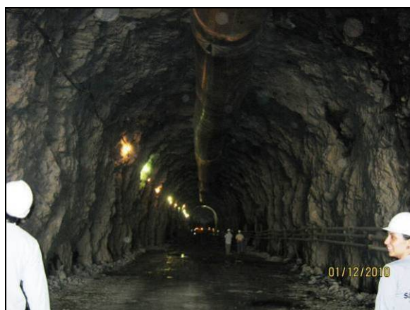
Foto 4.1.14. Técnicos do IBAMA e MI em vistoria no túnel Cuncas I (dez/10).
