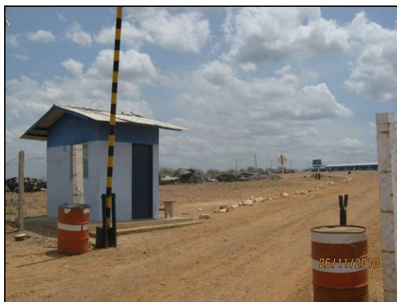
Foto 4.2.129. Guarita de controle da entrada ao canteiro de apoio (nov/10).
