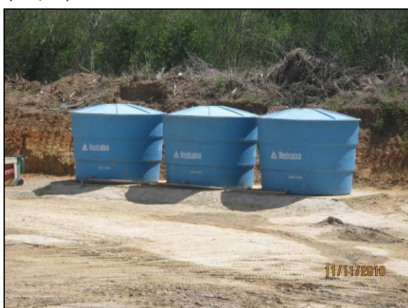
Foto 4.2.210. Reservatório d'água para uso na produção de solo-cimento (nov/10).
