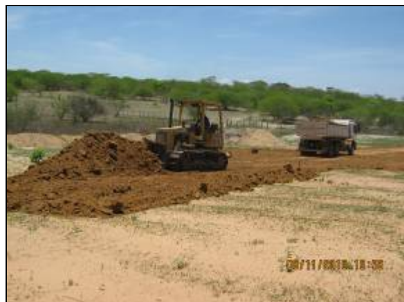
Foto 4.2.286.Abertura de via de acesso na faixa de servidão no segmento de canal WBS 1232 (nov/10).
