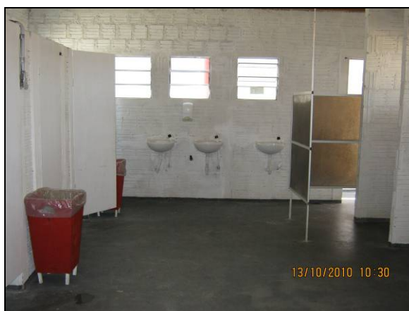
Foto 4.2.714. Sanitário em boas condições de limpeza no canteiro de Sertânia - PE (out/10).
