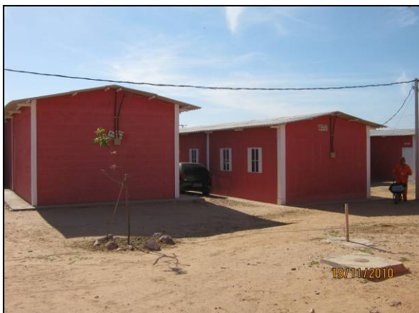
Foto 4.2.709. Alojamentos no canteiro de obras de Floresta - PE (nov/10).
