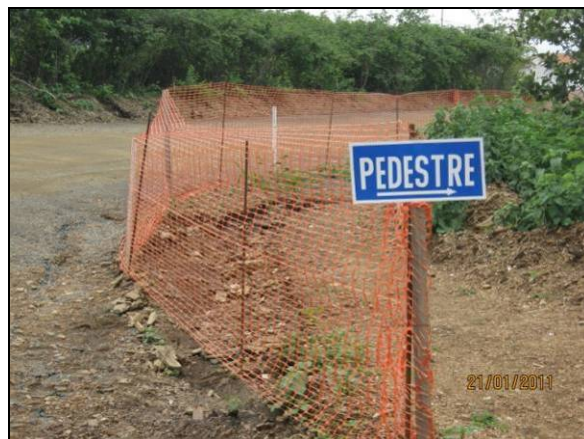
Foto 4.2.397. Placa de orientação e tela como limitação de área para pedestre no canteiro de obras (jan/11).
