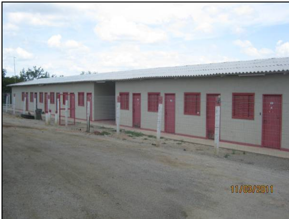
Foto 4.2.520. Estrutura do alojamento para os colaboradores (mar/11).
