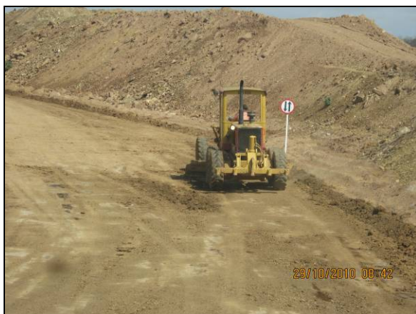
Foto 4.2.223. Melhoramento de via de acesso no WBS 1221 (out/10).
