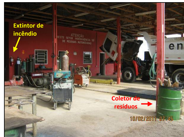
Foto 4.2.157. Oficina com piso impermeabilizado, coletor de resíduos e item de segurança (fev/11).
