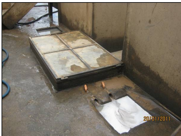
Foto 4.2.769. Caixa de areia do lavajato do canteiro de obras de Floresta - PE (jan/11).
