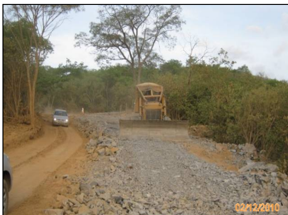
Foto 4.2.802. Aproveitamento de material de 3ª categoria em via de acesso ao emboque do túnel Cuncas I (dez/10).
