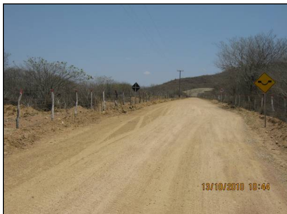
Foto 4.2.702. Via de acesso bem conservada na EBV-6 (out/10).
