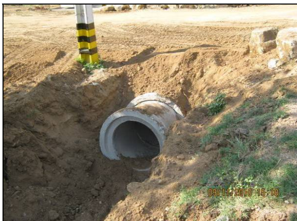
Foto 4.2.800. Instalação de manilhas para manutenção de fluxo hídrico em talvegue na entrada do canteiro (nov/10).
