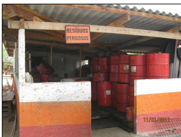
Foto 4.2.502. Baia para armazenamento de resíduos perigosos usados, na área do canteiro de obras (jan/11).
