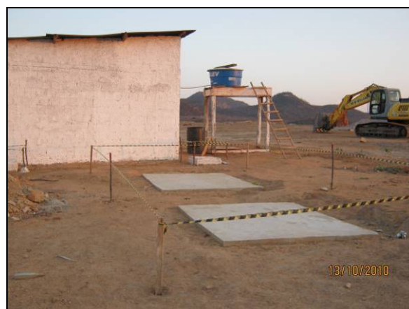
Foto 4.2.924. Sistema fossa-sumidouro (out/10).
