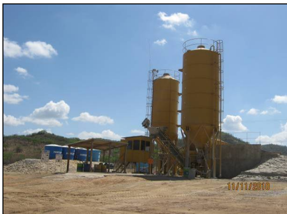
Foto 4.2.205. Central de concreto instalada no segmento de canal WBS 1218 (nov/10).
