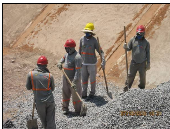
Foto 4.2.484. Colaboradores utilizando EPI na atividade de concretagem do segmento WBS 2208 (out/10).
