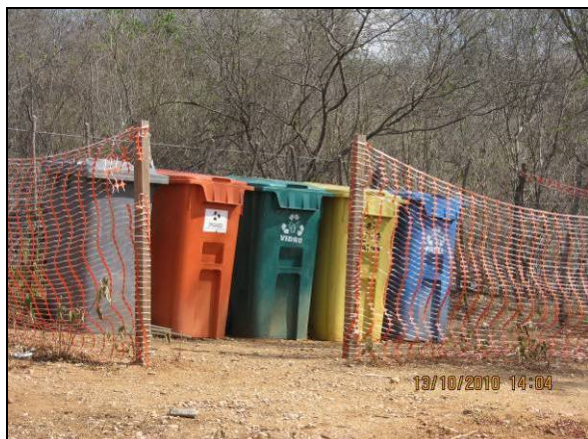
Foto 4.2.773. Coletores seletivos de resíduos em canteiro de apoio da EBV-5 (out/11).
