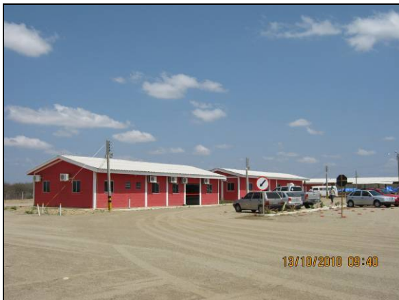
Foto 4.2.707. Estacionamento e estruturas administrativas do canteiro de obras de Sertânia - PE (out/10).
