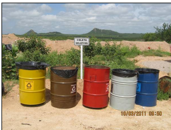
Foto 4.2.189. Coletores de resíduos na frente de serviço do WBS 1218 (mar/10).
