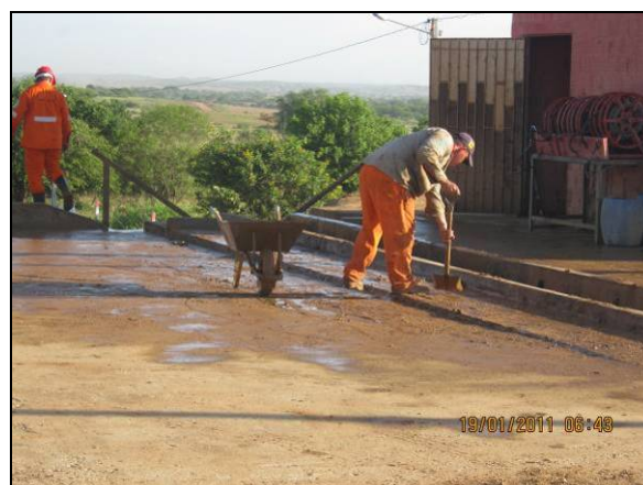
Foto 4.2.236. Manutenção da rampa de lavagem (jan/11).
