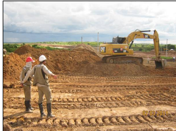
Foto 4.6.8. Acompanhamento de escavação de material de 1ª categoria no WBS 1223, lote 04 – Trecho I – Eixo Norte (mar/11).
