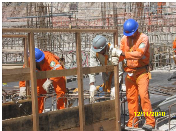
Foto 4.2.739. Colaboradores utilizando EPI em suas atividades na EBV-2 (nov/10).
