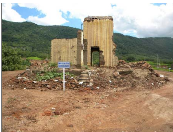
Foto 4.6.14. Edificação identificada como residência.
