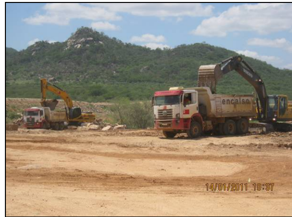
Foto 4.2.170. Extração de material em caixa de empréstimo, WBS 1218 (jan/11).
