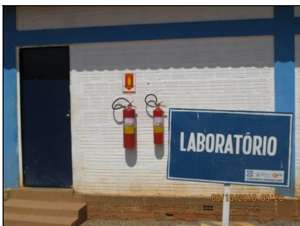
Foto 4.2.309. Extintores na entrada do laboratório de solos/concreto (out/10).
