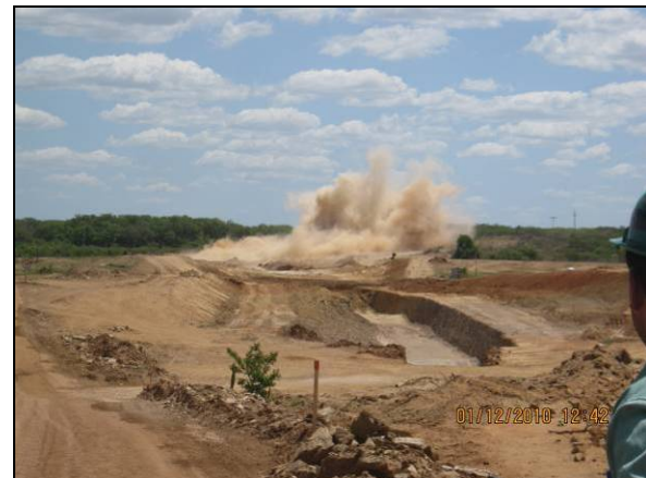
Foto 4.2.251. Momento da detonação no segmento de canal WBS 1222 (dez/10).
