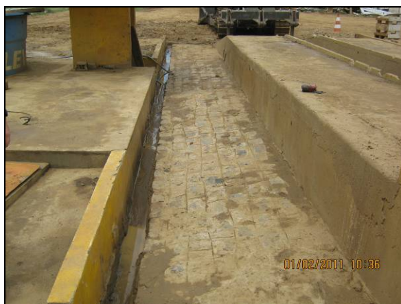
Foto 4.2.15. Vista da canaleta do lavajato (fev/11).
