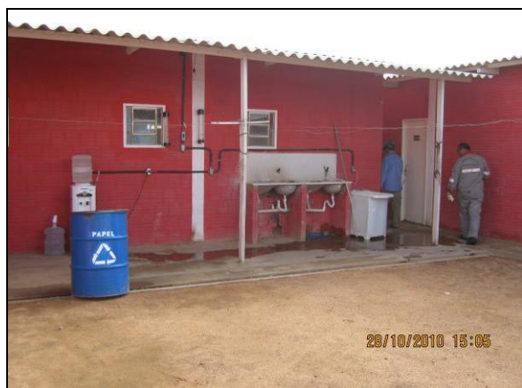
Foto 4.2.148. Lavanderia do alojamento com disponibilidade de bebedouro com água mineral e coletor de resíduos (out/10).
