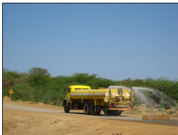
Foto 4.2.576. Umectação em via de acesso na área do Aqueduto Barreiros (out/10)
