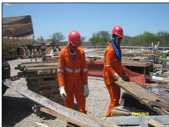
Foto 4.2.742. Colaboradores utilizando EPI na EBV-6 (dez/10).
