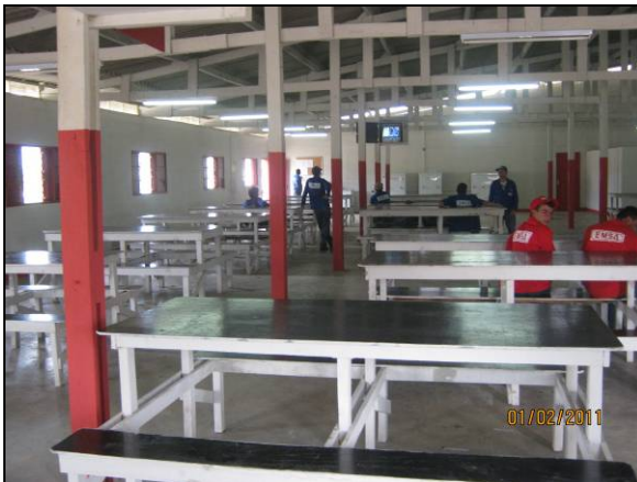
Foto 4.2.522. Interior do refeitório em condições adequadas ao uso dos colaboradores (fev/11).
