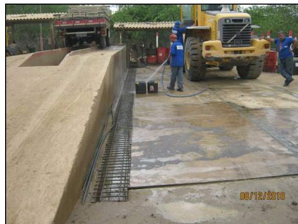
Foto 4.2.531. Lavajato com rampa e piso impermeabilizados (dez/10).
