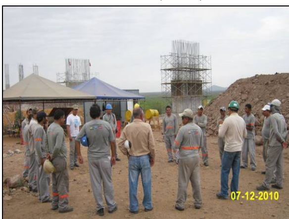
Foto 4.5.43. DDSMS realizado na área do aqueduto BR-316 (dez/10).
