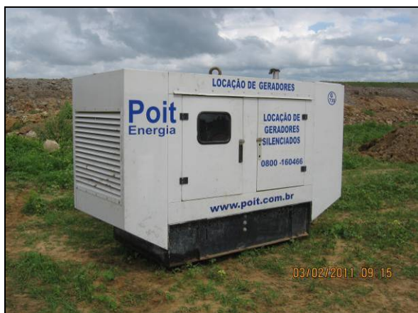
Foto 4.2.269. Grupo gerador com bandeja interna para contenção de vazamentos no WBS 1223 (fev/11).
