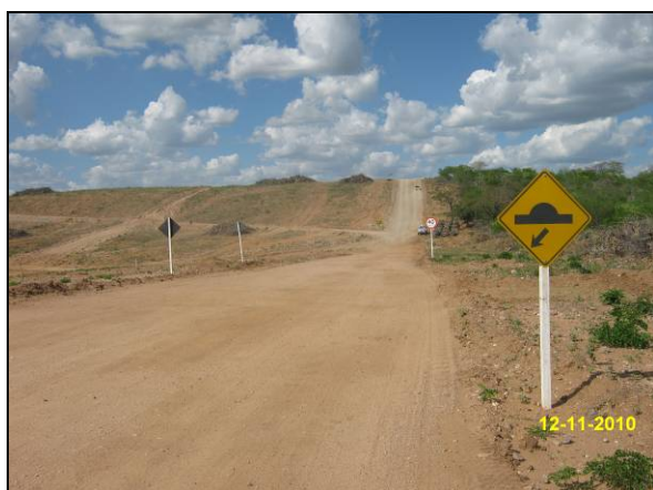
Foto 4.2.747. Sinalização bem distribuída em via de acesso a EBV-3 (nov/10).
