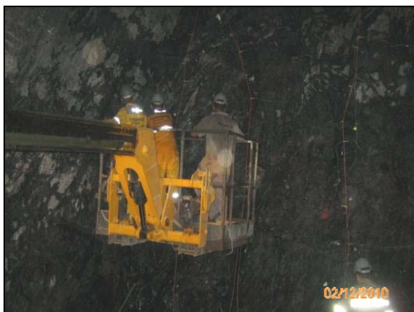
Foto 4.2.844. Instalação de explosivos na área da janela do túnel Cuncas I (dez/10).
