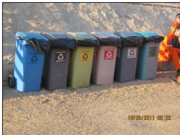
Foto 4.2.258. Coletores disponibilizados no pátio do canteiro de obras (mar/11).
