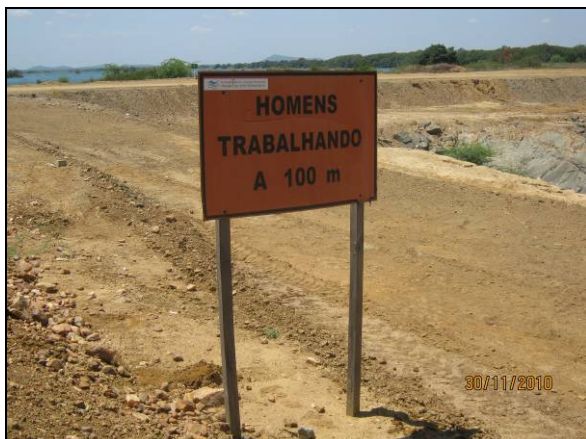
Foto 4.2.31. Placa de advertência adequada ao local no Canal de Aproximação (nov/10).
