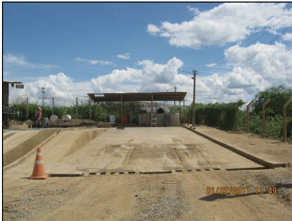
Foto 4.2.65. Lavajato com pista impermeabilizada, canaletas desobstruídas e ligadas ao SAO (fev/11).
