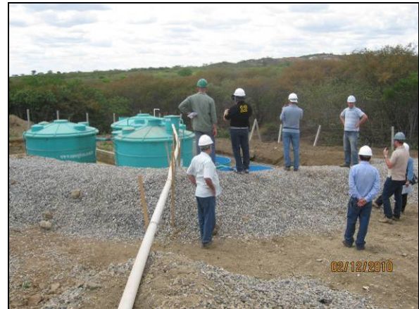
Foto 4.1.18. ETE do Lote 12 sendo vistoriada pela equipe do IBAMA (dez/10).
