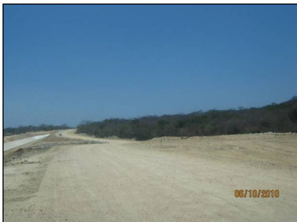
Foto 4.2.571. Via de acesso em bom estado de conservação no WBS 2218 (out/10).
