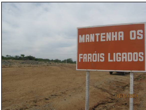
Foto 4.2.599.Placa prezando a segurança no trânsito no WBS 2219 (jan/11).
