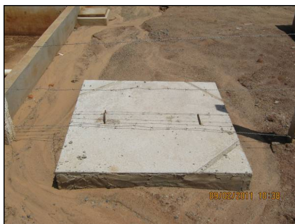
Foto 4.2.329. Construção de caixa separadora de areia para a bacia de contenção do tanque de combustível (fev/11).
