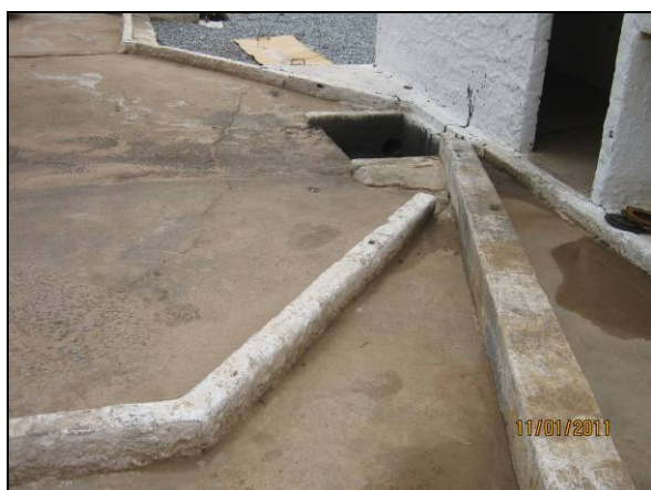
Foto 4.2.451. Canaleta de direcionamento de efluentes do lavajato ao SAO (jan/11).
