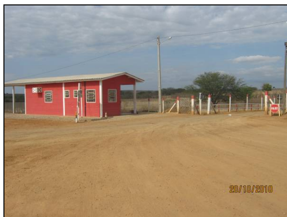
Foto 4.2.254. Guarita de entrada do canteiro de obras
