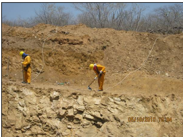
Foto 4.2.651. Colaboradores utilizando cordas de segurança e demais EPI em atividade no WBS 2223 (out/10).
