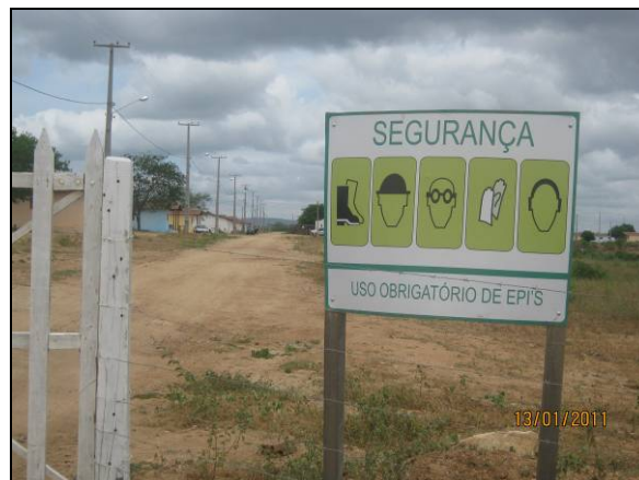
Foto 4.2.968. Sinalização de advertência quanto ao uso de EPI na entrada do núcleo habitacional (jan/11).
