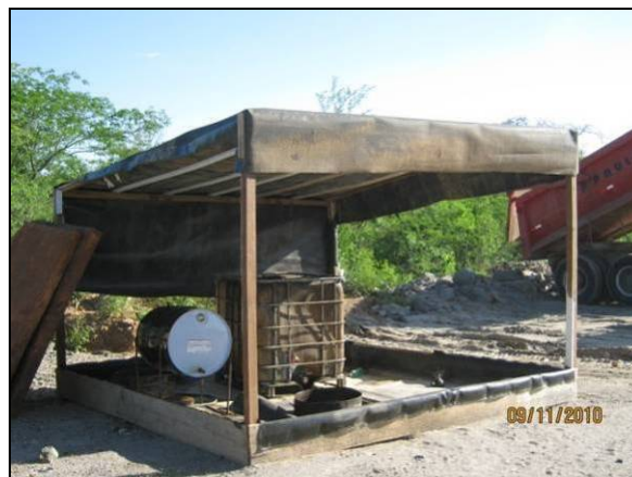
Foto 4.2.101. Armazenamento de óleo lubrificante em local coberto e impermeabilizado (nov/10).
