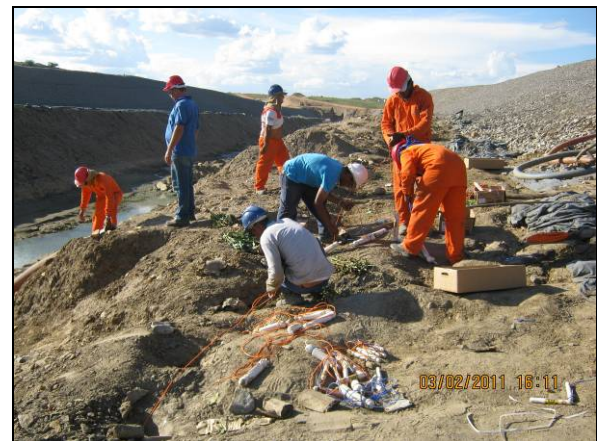
Foto 4.2.26. Montagem de explosivos nos furos no Canal de Aproximação (fev/11).
