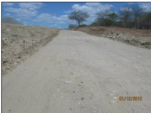
Foto 4.2.516. Via de acesso aplanada no WBS 2213 (dez/10).
