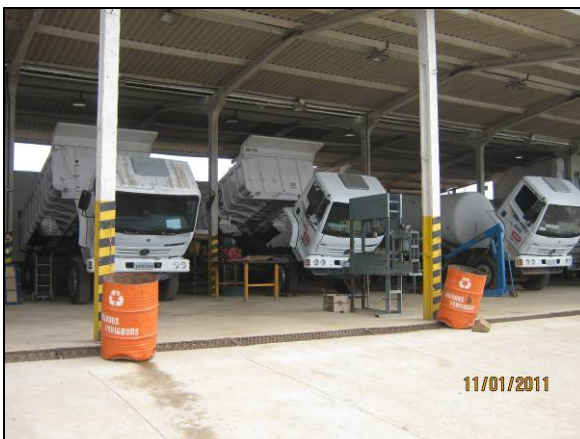
Foto 4.2.469. Oficina mecânica coberta e com piso impermeabilizado (jan/11).
