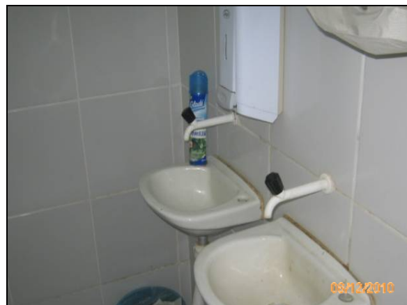
Foto 4.2.809. Lavatórios do consórcio construtor em condições adequadas de limpeza (dez/10).
