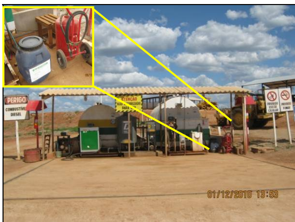
Foto 4.2.301. Posto de abastecimento em condições adequadas de funcionamento (dez/10).
