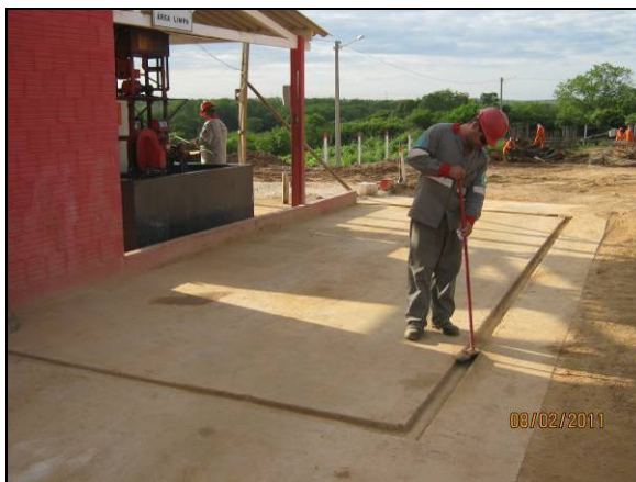
Foto 4.2.238. Pista de abastecimento impermeabilizada e limpeza das canaletas (fev/11).
