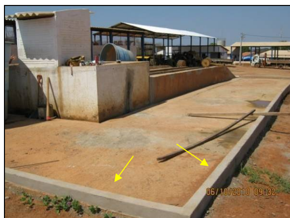
Foto 4.2.298. Piso impermeabilizado com barreiras laterais na área de trabalho (out/10).
