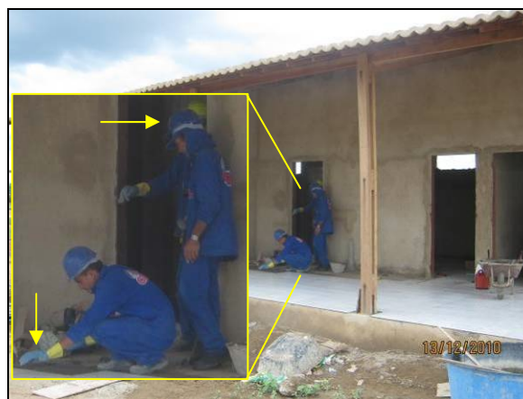
Foto 4.2.966. Uso de EPI pelos colaboradores durante construção (dez/10).
