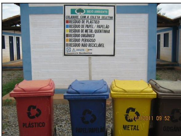
Foto 4.2.313. Placa de conscientização ambiental no canteiro de obras (jan/11).
