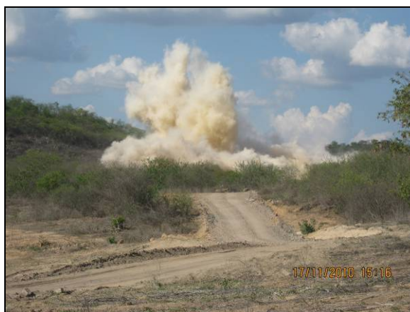
Foto 4.2.176. Momento de detonação em jazida, no reservatório Negreiros (nov/10).
