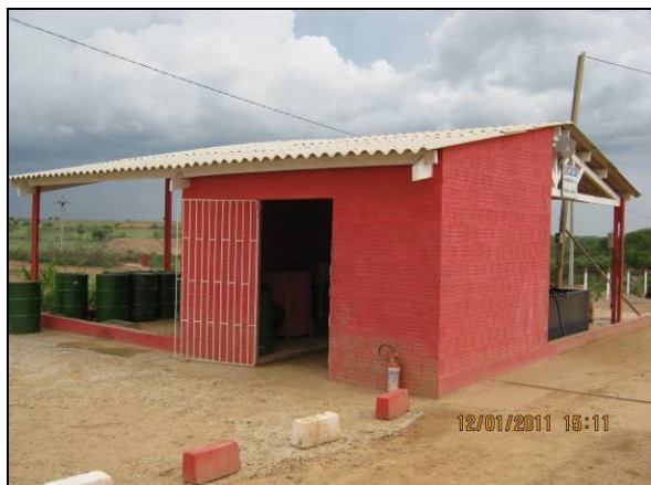
Foto 4.2.265. Baía de lubrificantes coberta (jan/11).
