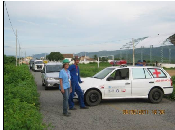
Foto 4.2.393. Barreira com ambulância e técnica de segurança do trabalho na rodovia estadual PB-366 (fev/11).
