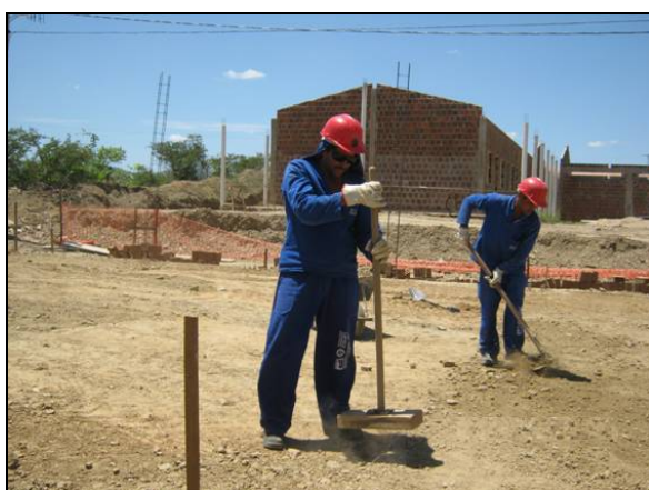
Foto 4.2.383. Colaboradores utilizando EPI na construção de infraestrutura do canteiro (dez/10).
