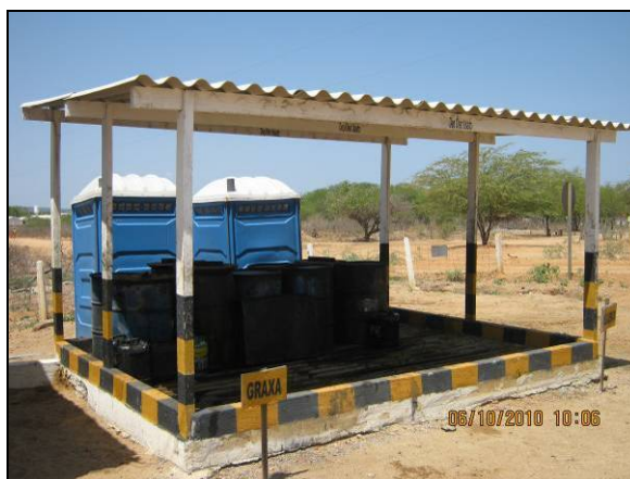
Foto 4.2.453. Recipientes de óleos e lubrificantes armazenados em local apropriado do canteiro (out/10).
