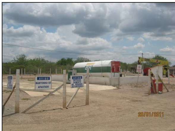
Foto 4.2.721. Instalações do posto de Combustível com piso impermeabilizado no canteiro de Floresta - PE (jan/11).
