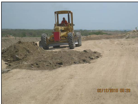
Foto 4.2.144. Melhoramento de via de acesso no segmento de canal WBS 1218 (dez/10).
