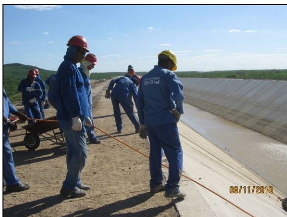
Foto 4.2.74. Utilização de EPI pelos trabalhadores em atividade no canal no WBS 1209 (nov/10).
