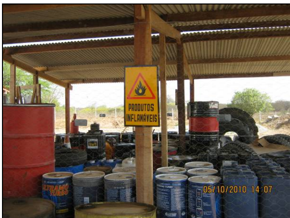
Foto 4.2.684. Acondicionamento adequado de resíduos perigosos no canteiro de obras (out/10).
