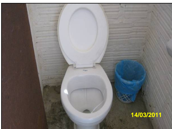
Foto 4.2.713. Sanitário em boas condições de limpeza no canteiro de obras de Floresta - PE (mar/11).
