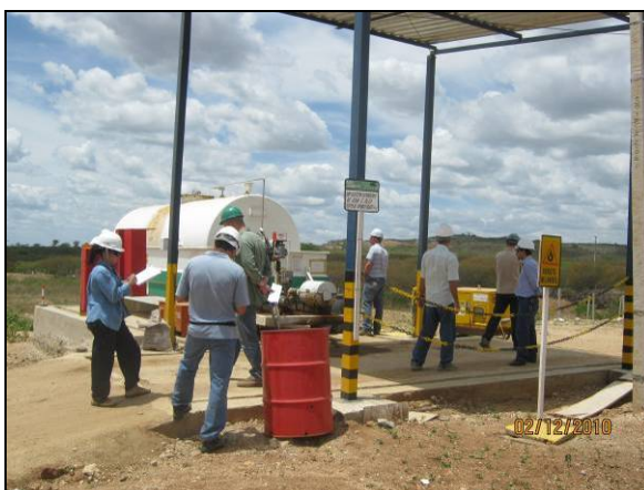
Foto 4.1.16. Vistoria nas instalações do posto de abastecimento (dez/10).
