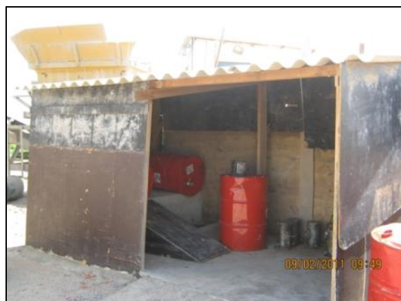
Foto 4.2.339. Área para armazenamento de aditivos para concreto, com cobertura e piso impermeabilizado (fev/11).
