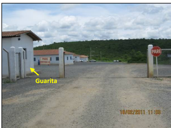
Foto 4.2.400. Guarita de controle e portão de acesso (fev/11).
