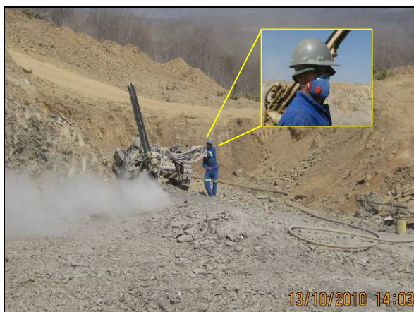
Foto 4.2.390. Perfuração (material de terceira categoria) no segmento de canal WBS 1236 (out/10).
