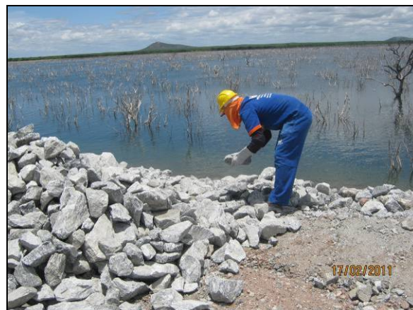
Foto 4.2.461. Enrocamento de talude no Canal de Aproximação, WBS 2204 (fev/11).
