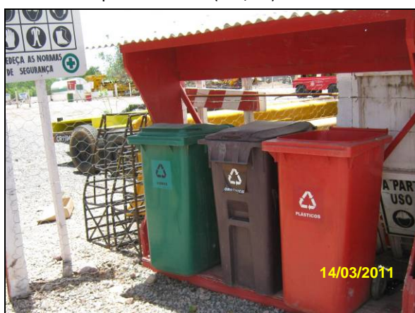
Foto 4.2.775. Coletores de resíduos sólidos disponibilizados na área do canteiro de obras de Floresta - PE (mar/11).
