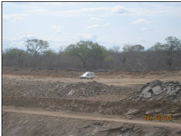
Foto 4.2.80. Ambulância realizando ronda com sirene antes da detonação, WBS 1208 (out/10).
