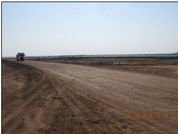
Foto 4.2.433. Via aplainada, propiciando a boa trafegabilidade no WBS 2204 (out/10).
