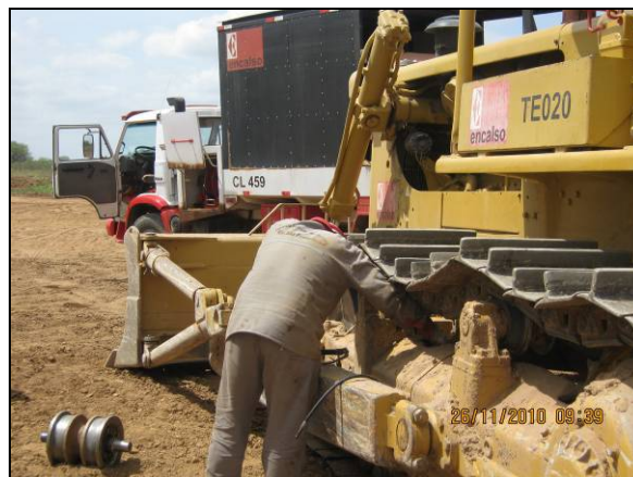
Foto 4.2.279. Manutenção de máquina com auxílio do caminhão comboio no bueiro B 01, WBS 1223 (nov/10).
