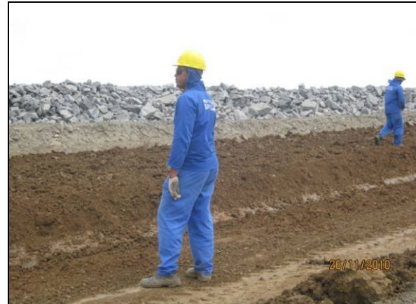
Foto 4.2.122. Colaborador utilizando EPI na barragem do reservatório Serra do Livramento (nov/10).
