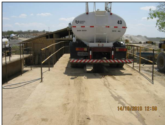
Foto 4.2.582. Lavajato com rampa impermeabilizada (nov/10).
