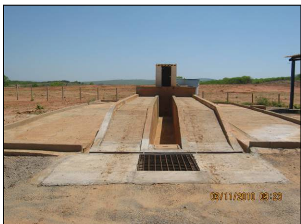
Foto 4.2.297. Rampa de lavagem em condições adequadas com sistema de drenagem e caixa de areia (nov/10).
