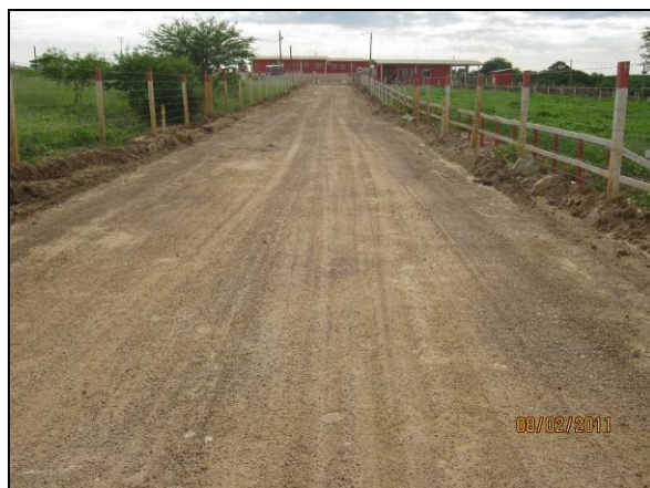
Foto 4.2.222. Via de acesso ao canteiro de obras em condições de trafegabilidade (fev/11).
