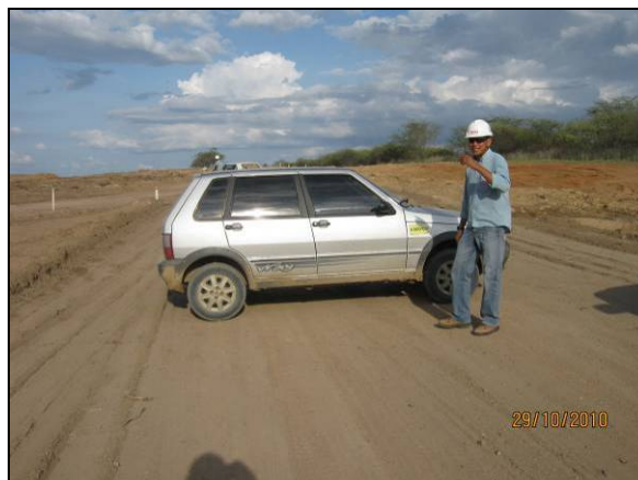
Foto 4.2.542. Técnico orientando procedimentos de segurança com bloqueio de estrada no WBS 2217 (out/10).
