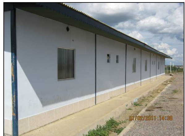
Foto 4.2.60. Vista externa dos alojamentos (fev/11).
