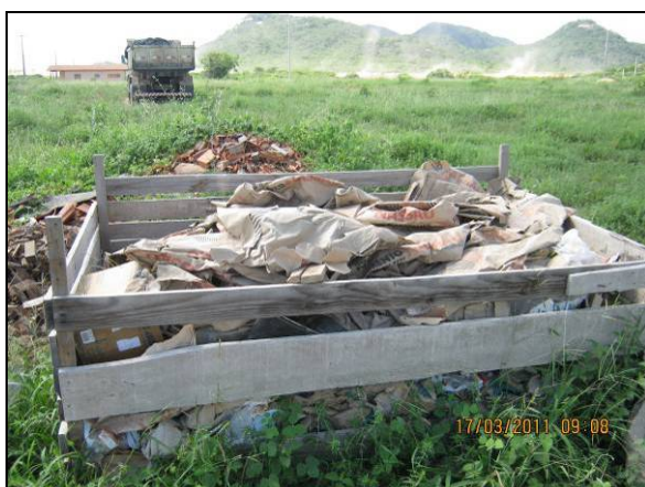
Foto 4.2.923. Baía para acondicionamento de sacos de cimento (mar/11).
