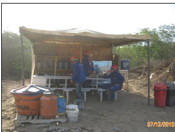
Foto 4.2.427. Tenda de apoio na estaca 89, WBS 1236 (dez/10).
