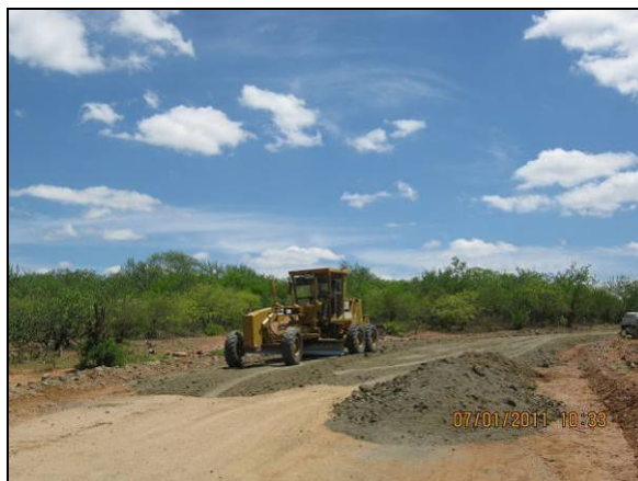
Foto 4.2.111. Manutenção de via de acesso, WBS 1212 (jan/11).
