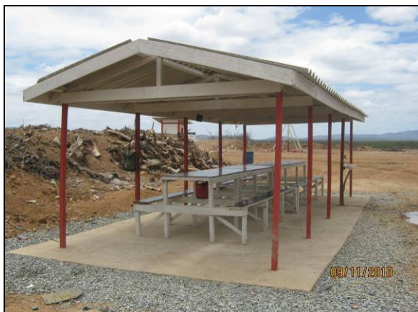
Foto 4.2.563. Ponto de apoio na área do reservatório Muquém, WBS 2108 (nov/10).
