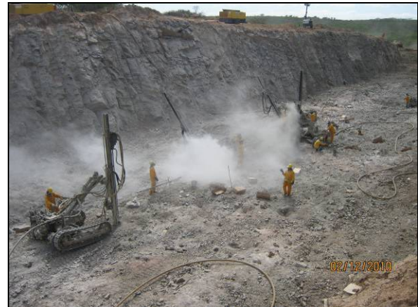
Foto 4.2.656. Atividade de perfuração de rocha em execução no WBS 2225 (dez/10).
