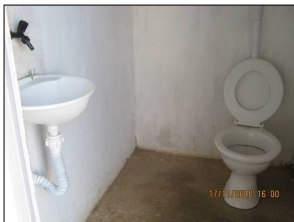
Foto 4.2.927. Banheiros em condições adequadas para uso dos colaboradores (nov/10).
