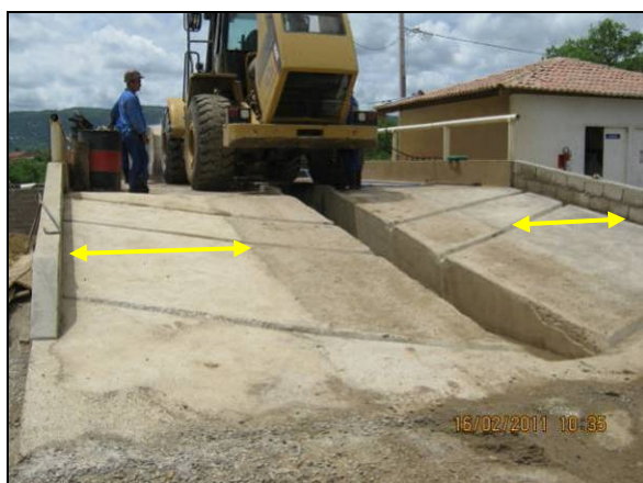
Foto 4.2.372. Ampliação da rampa do lavajato (fev/11).
