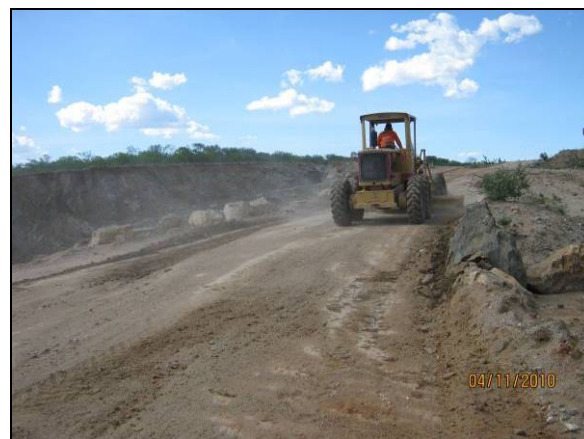
Foto 4.2.701. Realização de manutenção em via de acesso na EBV-5 (nov/10).
