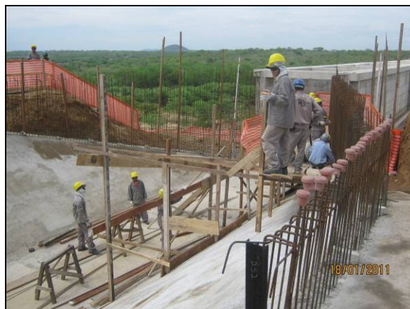
Foto 4.2.590. Colaboradores utilizando EPI em atividade no aqueduto Barreiros WBS2308 (jan/11).
