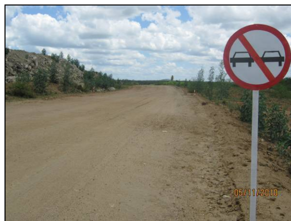
Foto 4.2.594. Sinalização de advertência instalada em local adequado no WBS 2221 (nov/10).
