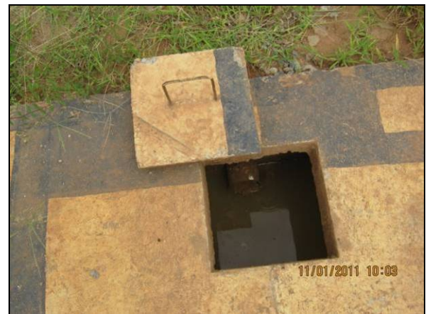
Foto 4.2.325. Manutenção adequada do SAO (jan/11).
