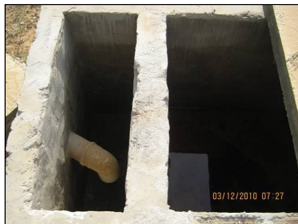
Foto 4.2.197. SAO em condições adequadas de manutenção (dez/10).
