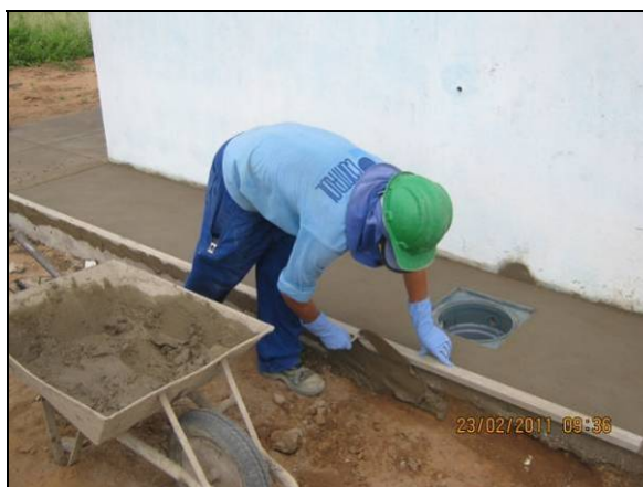
Foto 4.2.949. Colaborador com os EPI adequados na aplicação de argamassa (fev/11).
