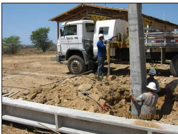
Foto 4.2.965. Colaboradores utilizando EPI durante a instalação de poste de energia elétrica (out/10).
