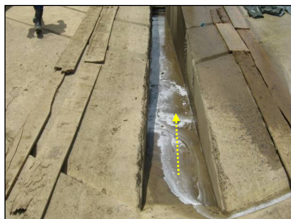
Foto 4.2.373. Rampa de lavagem com sistema de drenagem (mar/11).
