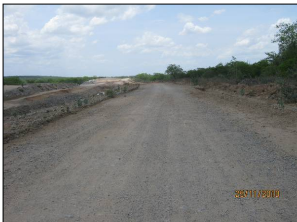
Foto 4.2.464. Via aplainada e bem dimensionada no WBS 2208 (nov/10).
