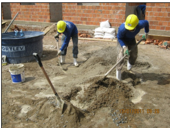
Foto 4.2.831. Uso adequado de EPI pelos colaboradores em atividade no alojamento em Mauriti – CE (jan/11).
