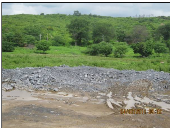
Foto 4.2.843. Área de bota espera para posterior uso do material em melhoramento de vias de acesso, na janela do túnel Cuncas I (fev/11).
