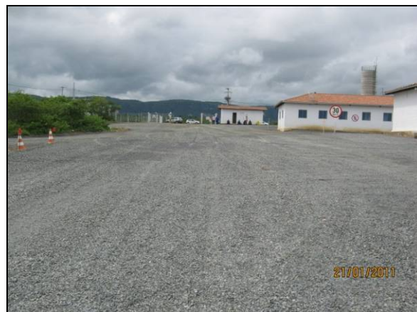
Foto 4.2.349. Via interna do canteiro de obras (jan/11).
