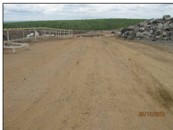
Foto 4.2.699. Via de acesso na EBV-2 (dez/10).
