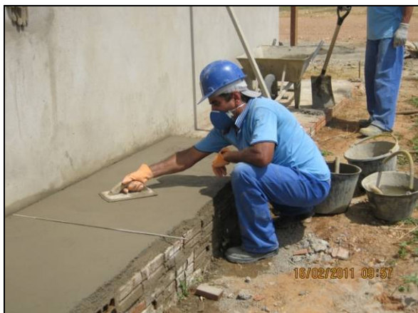
Foto 4.2.903. Colaborador utilizando EPI em atividades de acabamento (fev/11).
