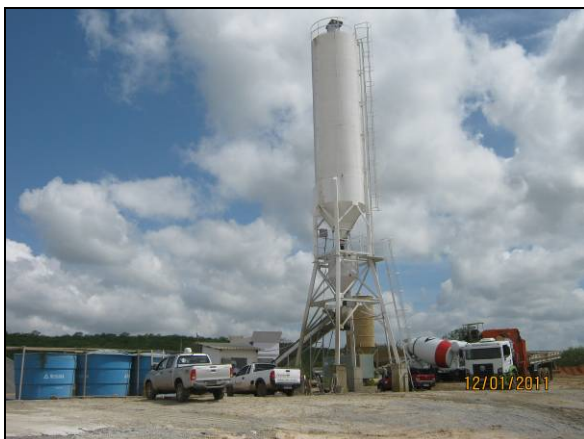
Foto 4.2.512. Central de concreto em área do reservatório Mandantes (jan/11).
