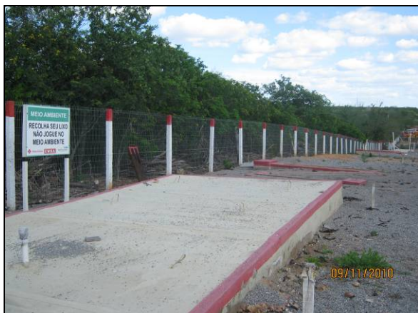
Foto 4.2.551. Tanque séptico para recebimento de efluentes dos alojamentos (nov/10).
