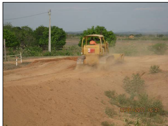
Foto 4.2.225. Máquina realizando a abertura de estrada de serviço no WBS 1224 (jan/11).
