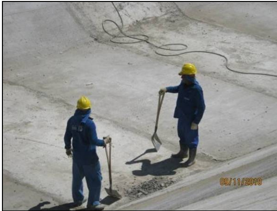
Foto 4.2.121. Colaboradores utilizando EPI na concretagem do canal, WBS 1214 (nov/10).
