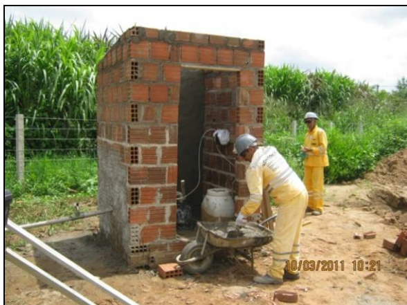
Foto 4.2.820. Instalação de cobertura e sistema de proteção para o poço tubular (mar/11).
