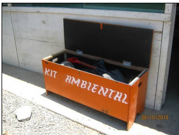
Foto 4.2.630. Kit utilizado em casos de acidentes com resíduos perigosos em ponto de apoio no WBS 2218 (out/10).
