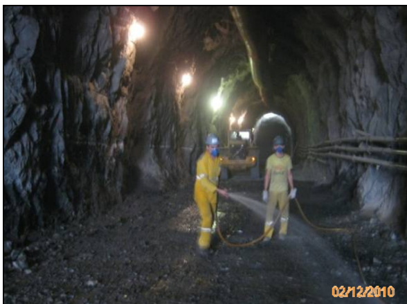
Foto 4.2.829. Colaboradores utilizando EPI após atividade de detonação na janela do túnel Cuncas I (dez/10).
