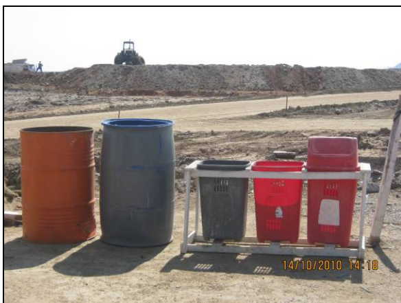
Foto 4.2.133. Coletores de resíduos na frente de serviço, WBS 1107 (out/10).
