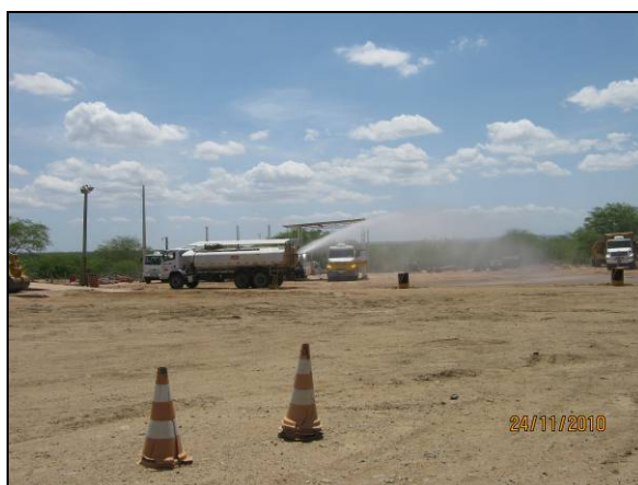
Foto 4.2.466. Umectação sendo realizada nas vias internas do canteiro de obras (nov/10).
