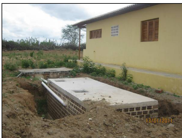
Foto 4.2.973. Fossa séptica sendo finalizada para recebimento dos efluentes de residência (nov/10).
