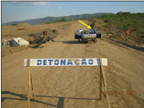
Foto 4.2.392. Procedimentos de detonação no WBS 1236 (nov/10).
