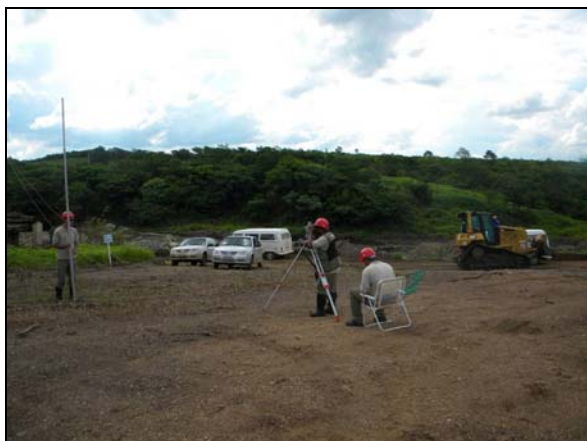
Foto 4.6.16. Levantamento planialtimétrico do sítio.
