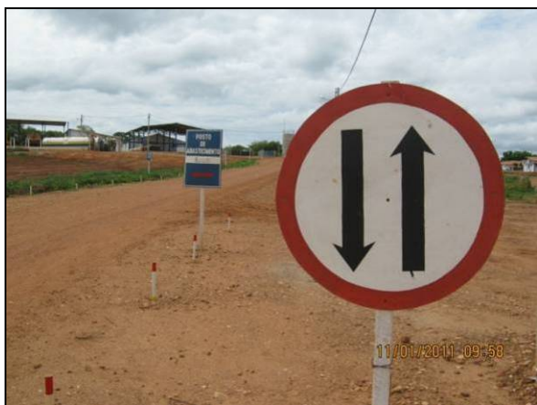
Foto 4.2.311. Placa regulamentadora em via principal do canteiro de obras (jan/11).
