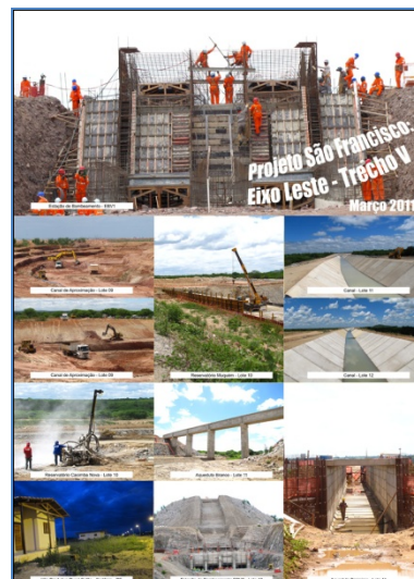
Figura 4.3.11. Cartaz fotográfico – Obras no Trecho V (mar/11).
