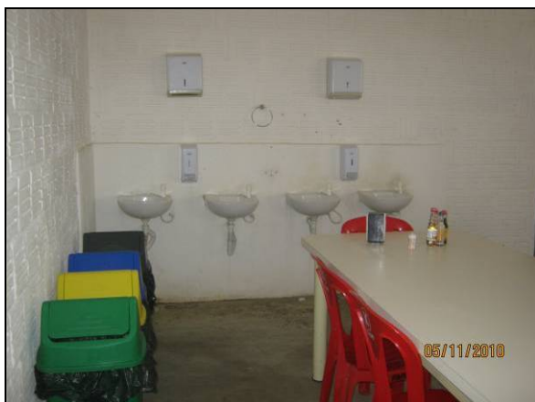
Foto 4.2.577. Coletores de resíduos e pias para higienização no interior do refeitório (nov/10).
