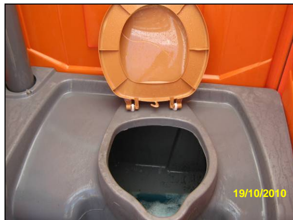
Foto 4.2.977. Banheiro químico em condições adequadas ao uso dos colaboradores (out/10).
