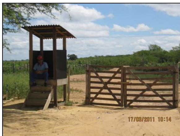
Foto 4.2.906. Controle do acesso de veículos na entrada da VPR (mar/11).
