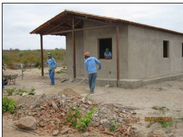
Foto 4.2.948. Colaboradores fazendo uso de EPI corretamente (out/10).
