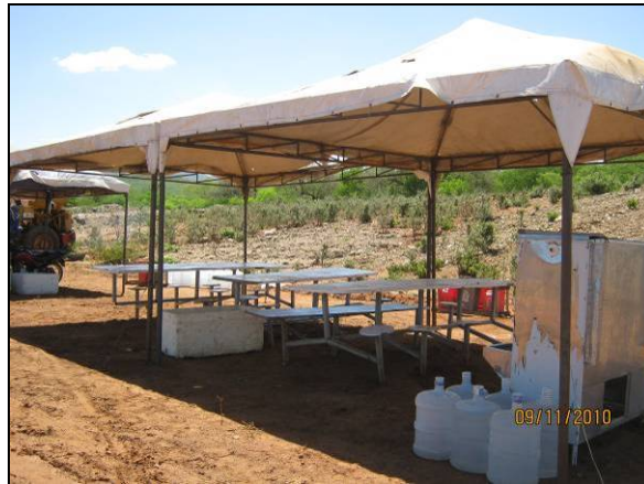
Foto 4.2.140.Tenda de apoio às obras no WBS 1214 (nov/10).
