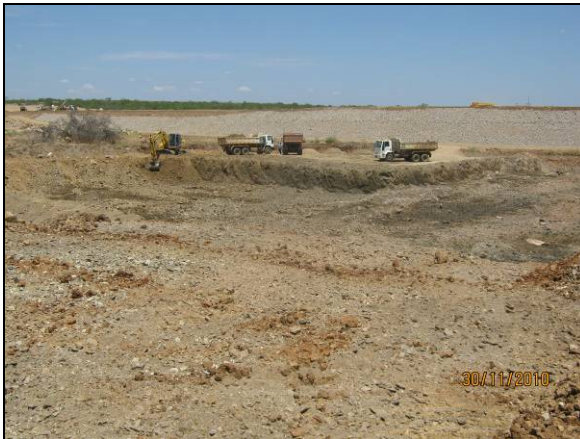
Foto 4.2.23. Escavação de jazida de material de 1ª categoria na área do reservatório Tucutu (nov/10).
