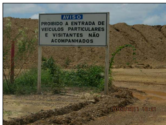
Foto 4.2.182. Placa orientando quanto ao acesso às obras no WBS 1219 (mar/11).
