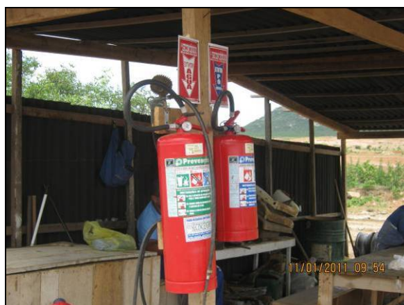
Foto 4.2.22. Extintores de incêndio em tenda de apoio no reservatório Tucutu (jan/11).
