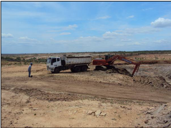
Foto 4.6.5. Acompanhamento de abertura de jazida no Reservatório Tucutu no 2º BEC – Trecho I – Eixo Norte (fev/11).
