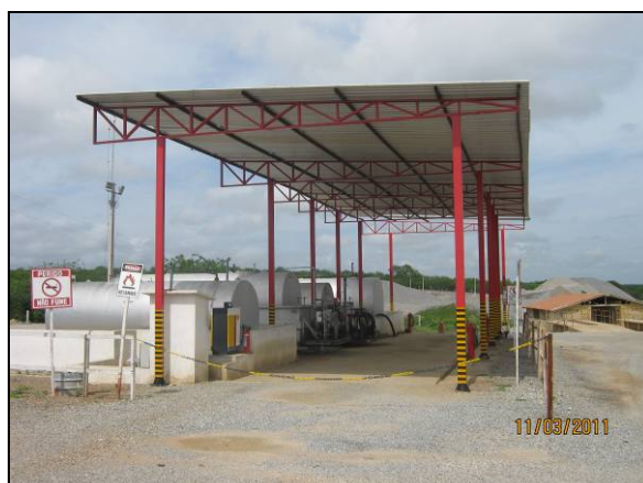
Foto 4.2.580. Posto de abastecimento coberto com a devida sinalização de segurança (mar/11).
