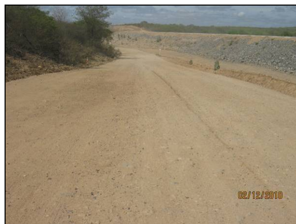
Foto 4.2.635. Via de acesso em boas condições de trafegabilidade no segmento WBS 2225 (dez/10).
