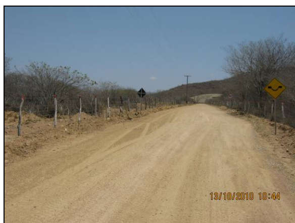
Foto 4.2.704. Via de acesso bem conservada na EBV-6 (out/10).
