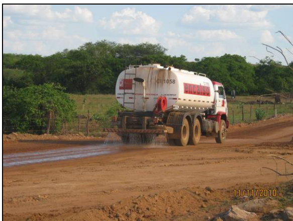
Foto 4.2.224. Umectação da via de acesso no WBS 1222 (nov/10).
