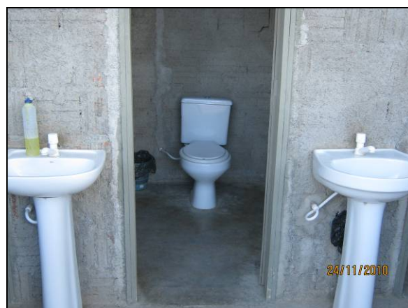
Foto 4.2.625. Sanitário construído no ponto de apoio da central de concreto no WBS 2218 (nov/10).
