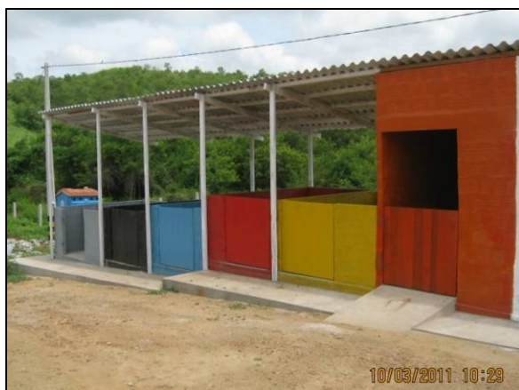
Foto 4.2.868.Baia de resíduos no canteiro de obras (mar/11).
