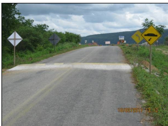
Foto 4.2.398. Redutor de velocidade e placas de sinalização próxima ao canteiro na rodovia estadual PB-366 (fev/11).
