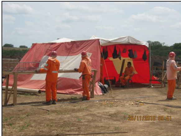
Foto 4.2.271. Tenda de apoio na construção do bueiro B 02, WBS 1223 (nov/10).
