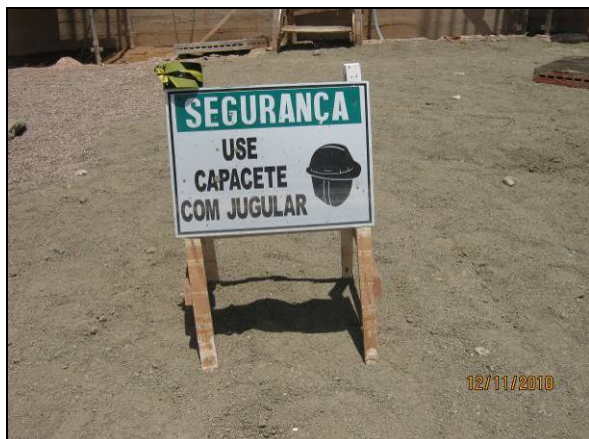
Foto 4.2.745. Sinalização de segurança instalada em área da EBV-1 (nov/10).
