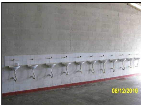
Foto 4.2.524. Pias para higienização no interior do refeitório (dez/10).
