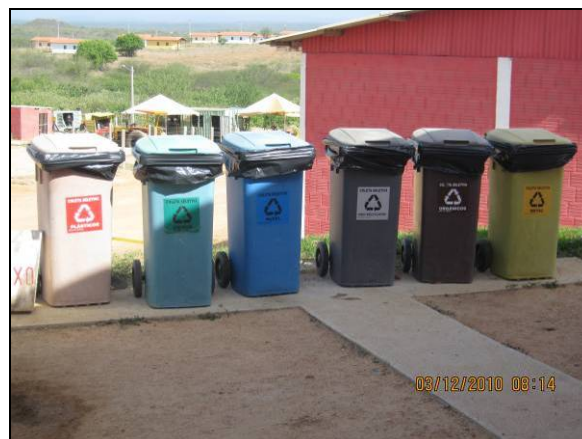
Foto 4.2.188. Coletores seletivos de resíduos sólidos no canteiro de obras (dez/10).
