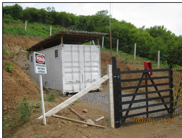
Foto 4.2.847. Paiol de acessórios cercado, com sinalização e extintor de incêndio (mar/11).
