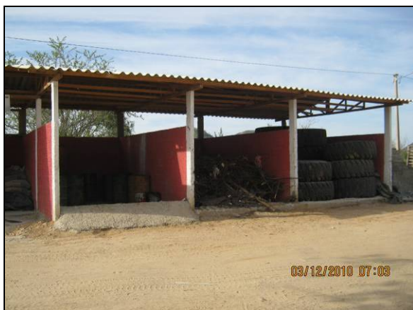
Foto 4.2.187. Baías de segregação de resíduos no canteiro de obras organizadas (dez/10).
