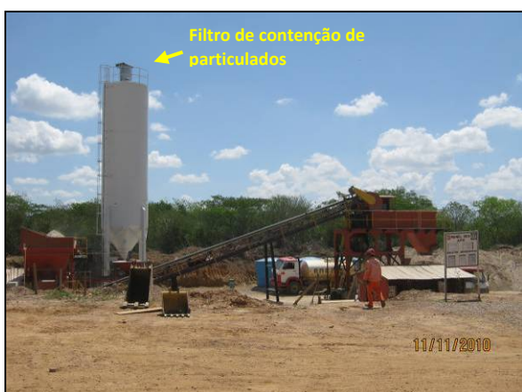
Foto 4.2.209. Usina de solo-cimento implantada, WBS 1219 (nov/10).
