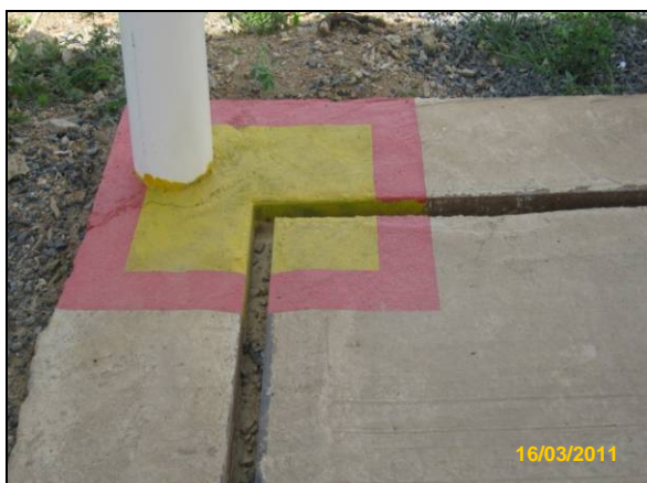
Foto 4.2.368. Piso impermeabilizado e canaletas (jan/11).
