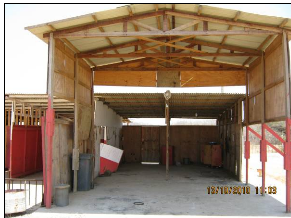
Foto 4.2.724.Oficina coberta e com piso impermeabilizado no canteiro de Sertânia - PE (out/10).
