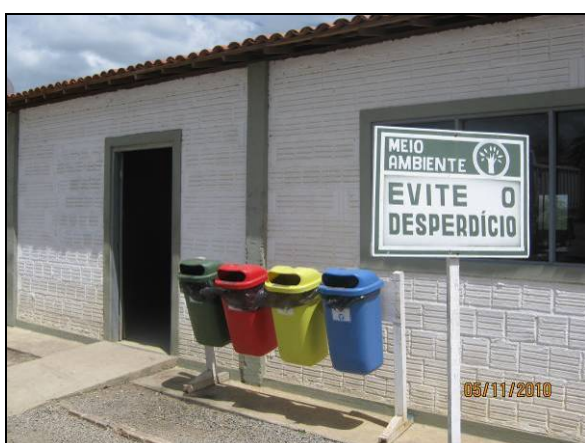
Foto 4.2.609. Coletores de resíduos no pátio do canteiro de obras (nov/10).
