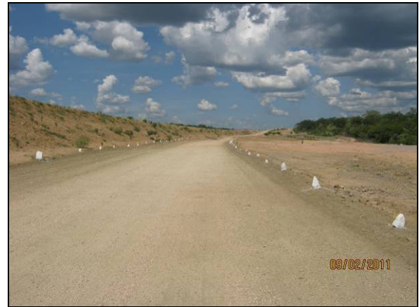
Foto 4.2.58. Via de acesso bem dimensionada e conservada no WBS 1209 (fev/11).
