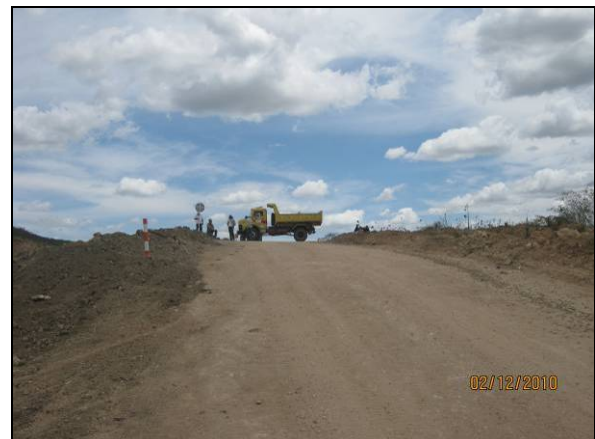
Foto 4.2.658. Procedimentos de segurança em via de acesso durante execução de fogo no WBS 2226 (dez/10).
