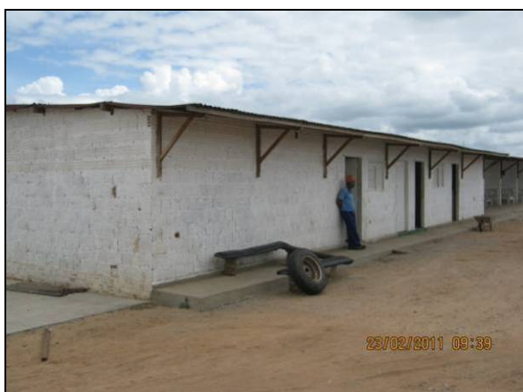
Foto 4.2.958. Vista do escritório e almoxarifado (fev/11).
