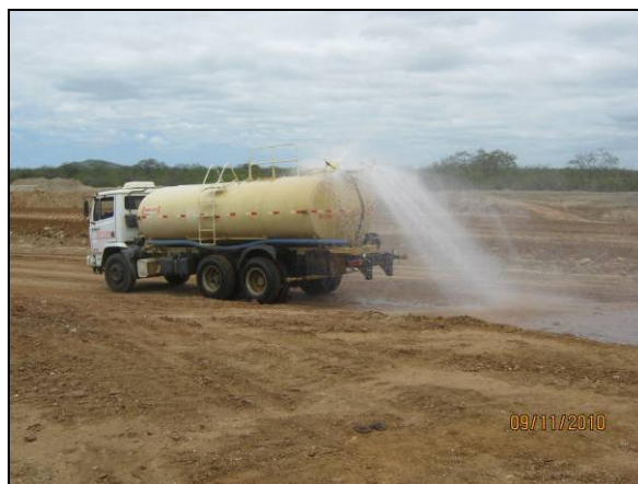
Foto 4.2.515. Umectação de via de acesso para o controle de material particulado no WBS 2108 (Nov/10).
