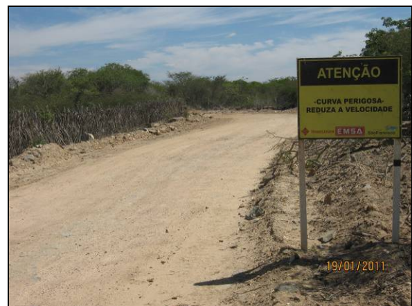
Foto 4.2.546. Sinalização em via de acesso no WBS 2110 (jan/11).
