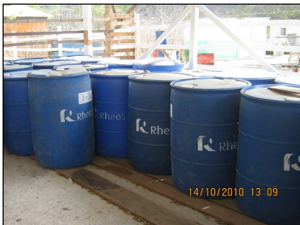
Foto 4.2.615. Acondicionamento adequado de resíduos perigosos no canteiro de obras (out/10).
