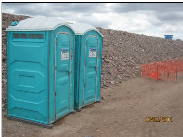
Foto 4.2.787. Banheiros químicos disponibilizados na área da EBV-2 (fev/11).
