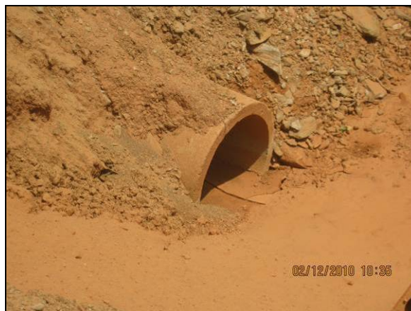
Foto 4.2.221. Manilhas em aterro da via de acesso no WBS 1219 (dez/10).
