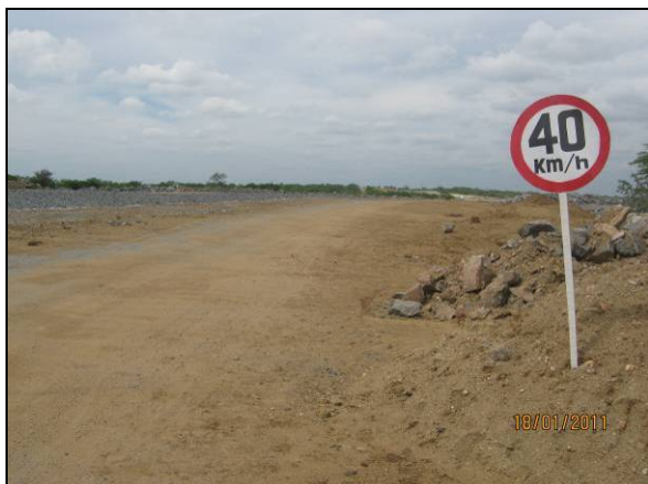
Foto 4.2.595. Sinalização para controle de velocidade instalada no WBS 2220 (jan/11).
