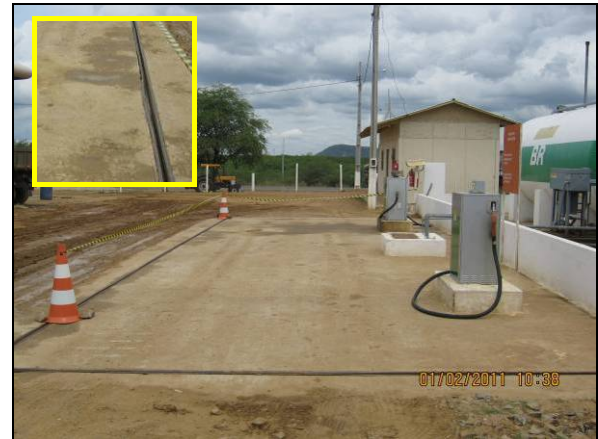
Foto 4.2.17. Piso impermeabilizado e canaletas do posto de abastecimento (fev/11).
