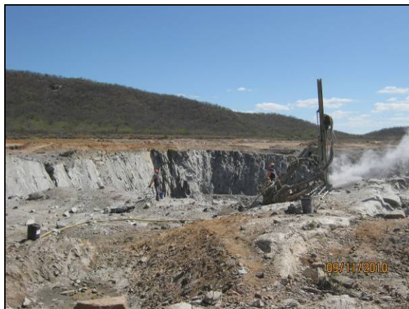
Foto 4.2.125. Jazida de material de 3ª categoria na área do reservatório Serra do Livramento (nov/10).
