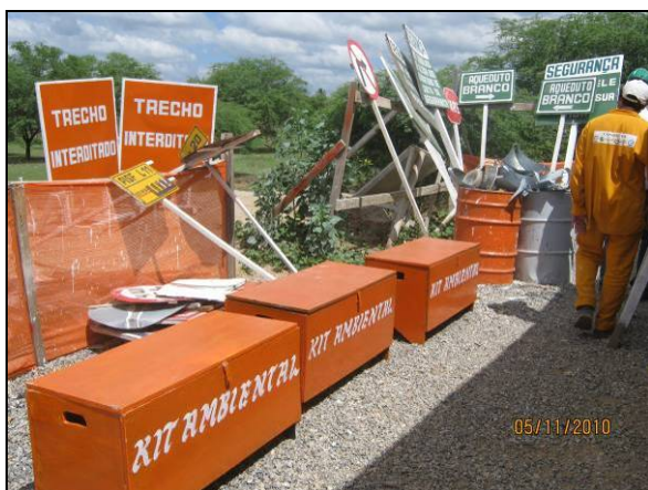
Foto 4.2.593. Confecção de placas no canteiro de obras (nov/10).
