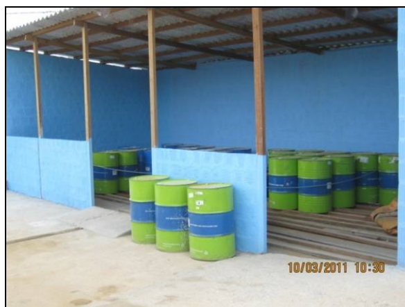
Foto 4.2.873. Armazenamento de aditivos para concreto em área coberta e piso impermeabilizado no canteiro de obras (mar/11).
