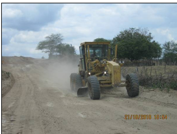
Foto 4.2.514. Aplainamento de via de acesso no WBS 2217 (out/10).
