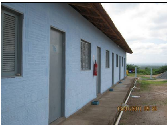
Foto 4.2.879. Alojamento com cerca, extintores de incêndio e coletor de resíduos (jan/11).
