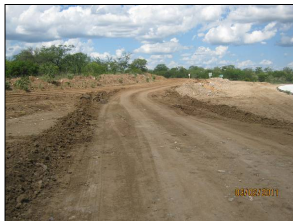
Foto 4.2.463. Manutenção realizada em via de acesso no WBS 2207 (fev/11).
