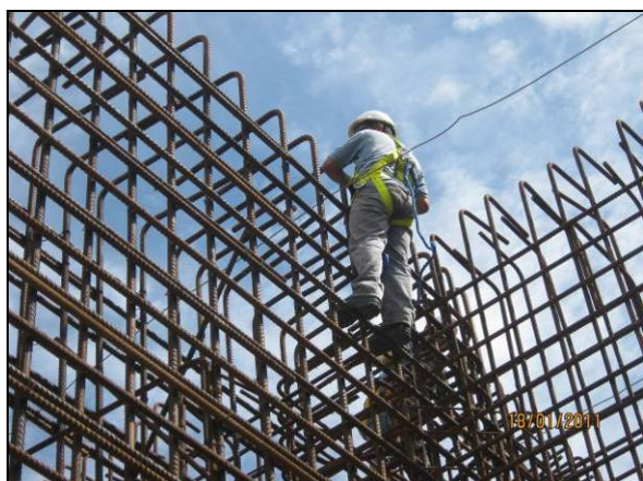
Foto 4.2.741. Colaborador utilizando EPI adequado para trabalhos em altura na EBV-6 (jan/11).
