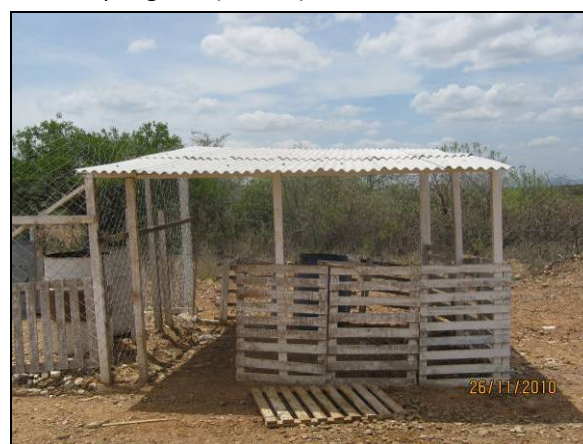
Foto 4.2.136. Baia para resíduos orgânicos no canteiro de apoio (nov/10).
