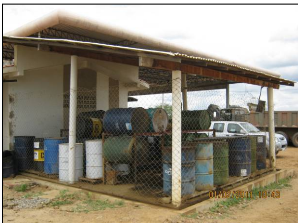
Foto 4.2.43. Área para óleo usado, coberta, piso impermeabilizado e com canaletas para direcionamento do efluente ao SAO (fev/11).
