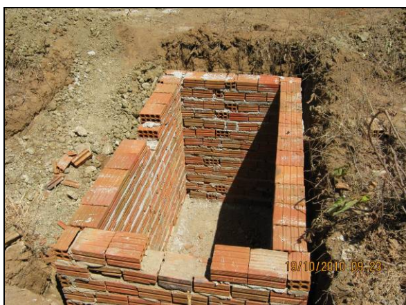
Foto 4.2.972. Construção de fossa séptica das residências do núcleo habitacional (out/10).
