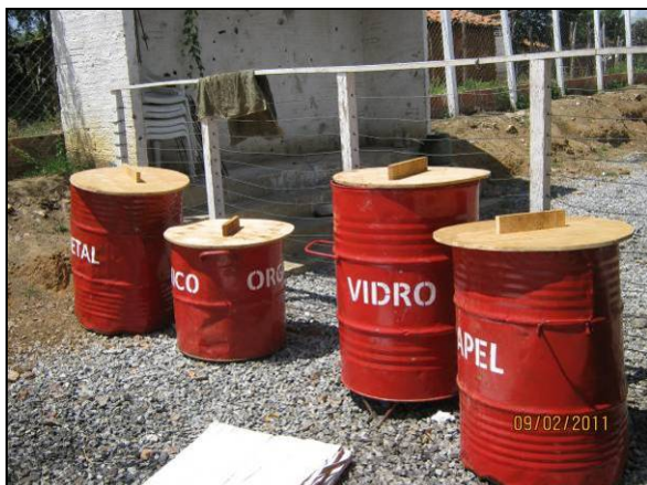
Foto 4.2.39. Coletores de resíduos na área do refeitório do canteiro (fev/11).
