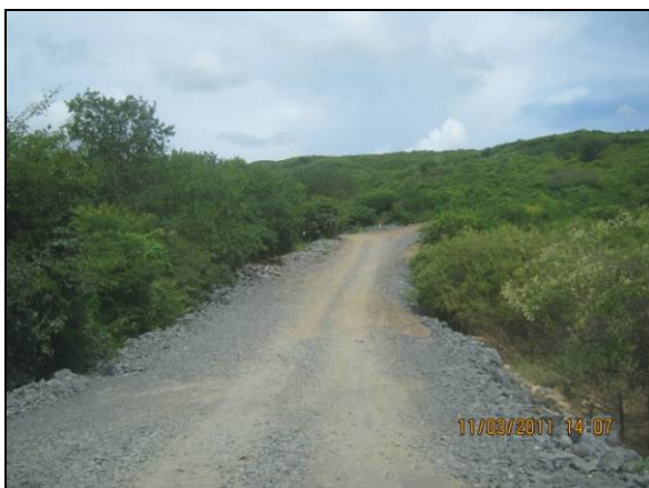
Foto 4.2.803. Via de acesso a janela do túnel Cuncas I com aplicação de material de 3ª categoria (mar/11).
