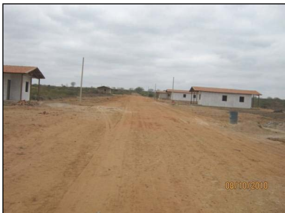
Foto 4.2.946. Via principal bem dimensionada e em bom estado de conservação (out/10).
