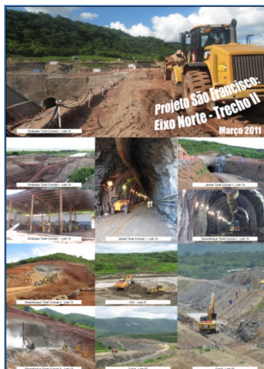
Figura 4.3.10. Cartaz fotográfico – Obras no Trecho II (mar/11).
