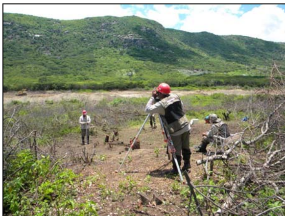
Foto 4.6.20. Levantamento planialtimétrico do sítio.
