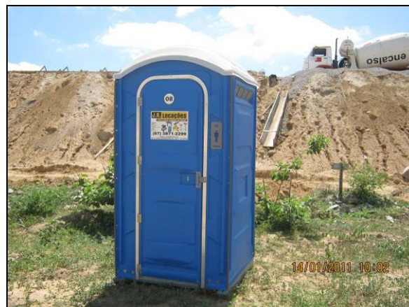
Foto 4.2.212. Banheiro químico na frente de serviço de lançamento de solo-cimento, WBS 1219 (jan/11).
