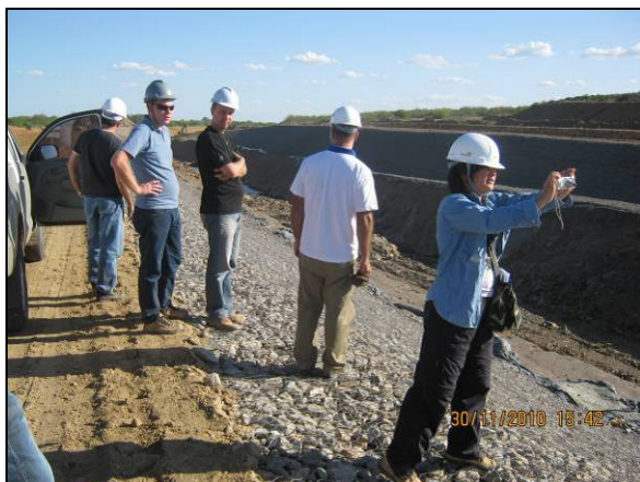
Foto 4.1.5. Equipe do IBAMA em vistoria no canal de aproximação (nov/10).
