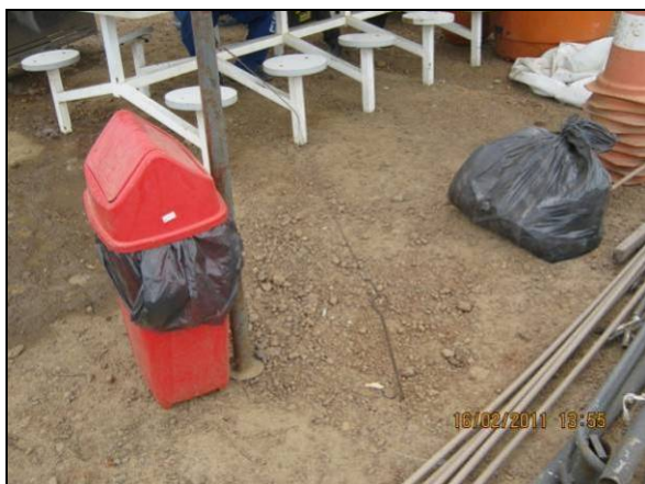
Foto 4.2.415. Coletor de resíduos em tenda de apoio da frente de serviço do segmento WBS 1235 (fev/11).
