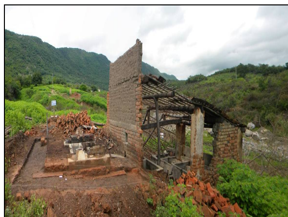
Foto 4.6.18. Abertura de sondagem para documentar as fundações da edificação.
