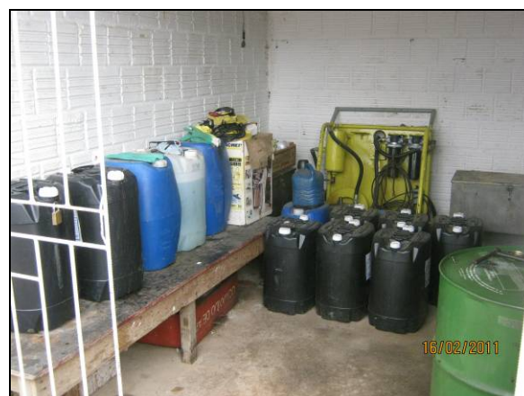
Foto 4.2.782. Recipientes de produtos perigosos do lavajato armazenados no canteiro de Floresta - PE (fev/11)
