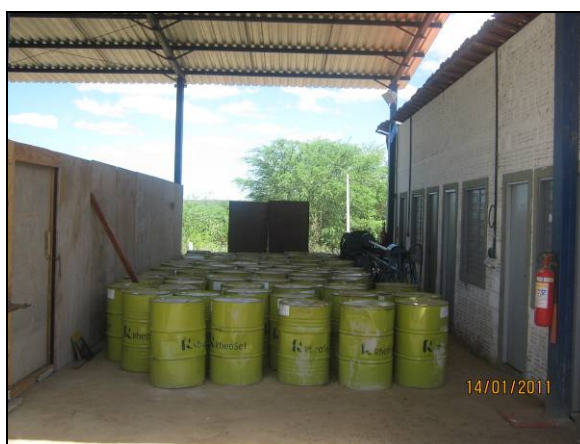
Foto 4.2.617. Armazenamento de produtos químicos na área do canteiro de obras (jan/11).
