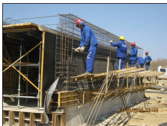
Foto 4.2.388. Colaboradores montando ferragens sobre andaime com altura abaixo de 2m (out/10).
