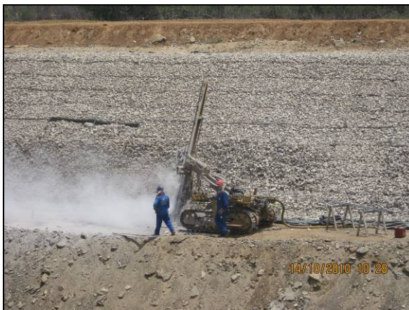
Foto 4.2.25. Perfuração em rocha no canal de aproximação (nov/10).
