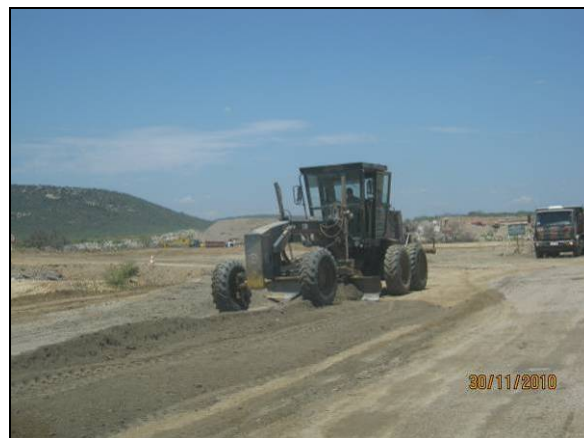
Foto 4.2.2. Manutenção de via de acesso no reservatório Tucutu (nov/10).
