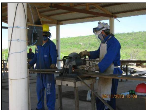
Foto 4.2.382. Colaboradores com EPI na central de armação (nov/10).
