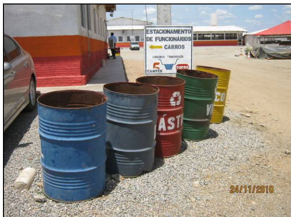
Foto 4.2.500. Coletores de resíduos no pátio do canteiro de obras (nov/10).
