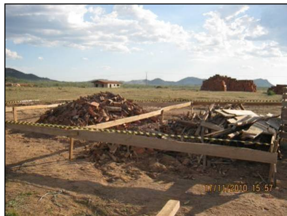
Foto 4.2.922. Segregação dos resíduos inertes gerados na obra (nov/11).
