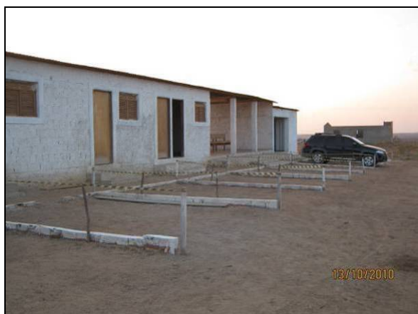
Foto 4.2.925. Vista da estrutura de apoio com estacionamento sinalizado (out/10).
