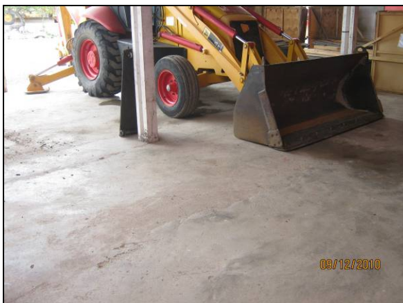
Foto 4.2.723.Oficina mecânica com piso impermeabilizado no canteiro de obras em Floresta - PE (dez/10).
