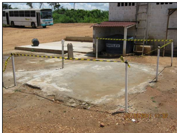
Foto 4.2.941. Fossa séptica utilizada para o tratamento de efluentes provenientes do banheiro (mar/11).
