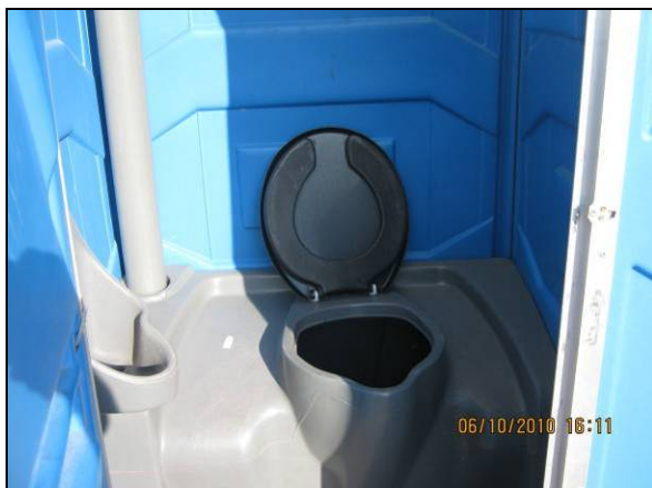
Foto 4.2.508. Banheiro químico instalado no aqueduto da BR-316 (out/10).
