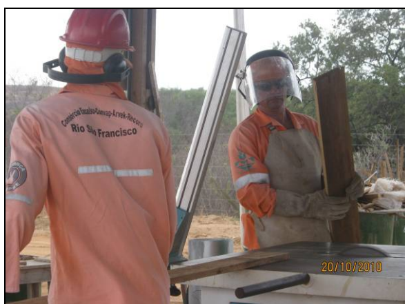
Foto 4.2.243. Colaboradores usando EPI durante atividade na carpintaria do canteiro de obras (out/10).
