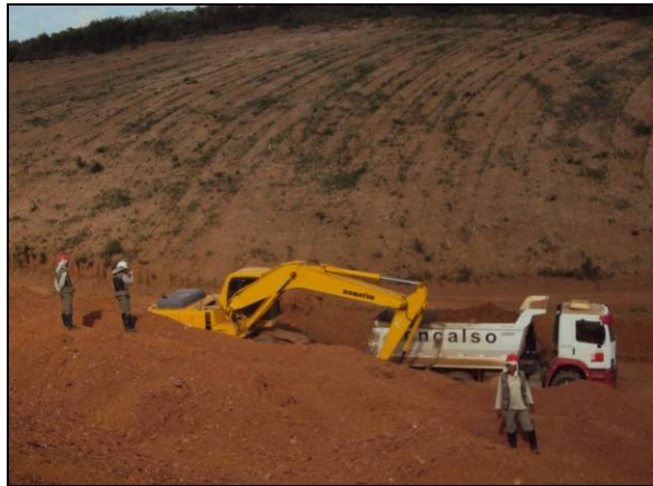
Foto 4.6.6. Acompanhamento de escavação do canal adutor WBS 1219, lote 03 – Trecho I – Eixo Norte (fev/11).
