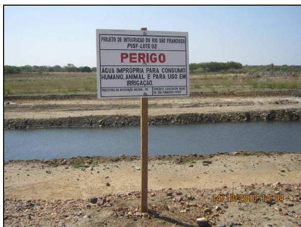
Foto 4.2.127. Placa de advertência no segmento de canal WBS 1112 (out/10).
