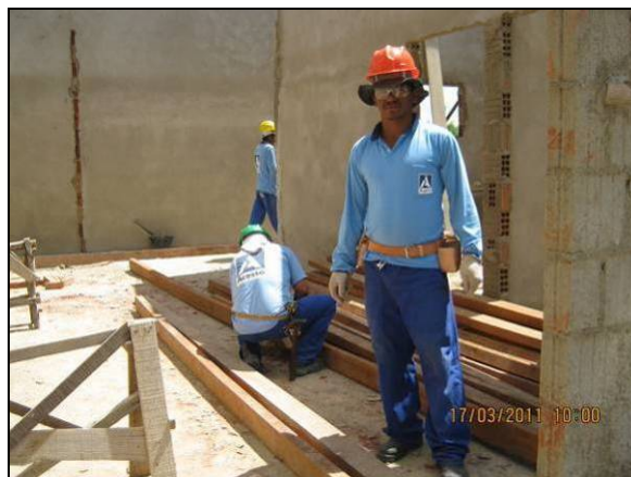
Foto 4.2.904. Colaboradores utilizando EPI adequados à atividade (mar/11).
