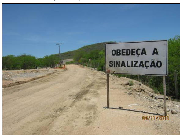
Foto 4.2.749. Sinalização instalada em via de acesso da EBV-5 (nov/10).
