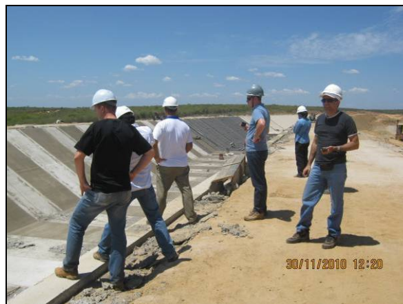
Foto 4.1.6. Vistoria pela equipe do IBAMA no Lote 03 (nov/10).
