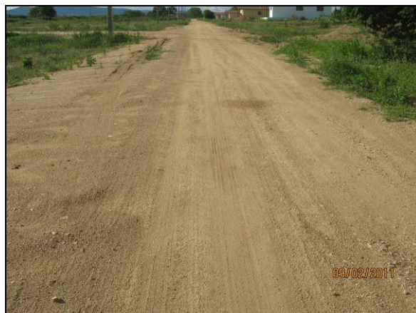
Foto 4.2.964. Via no interior do setor residencial bem conservada (fev/11).
