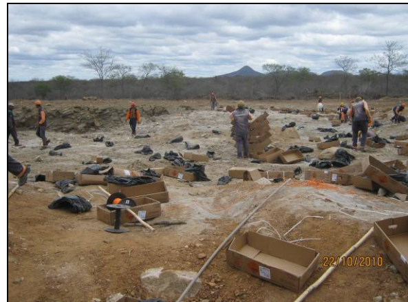
Foto 4.2.79. Colaboradores montando explosivos em bancada no WBS 1208 (out/10).
