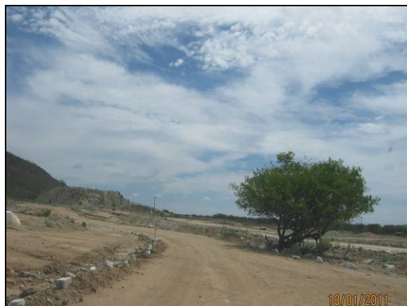
Foto 4.2.703. Via de acesso em bom estado de conservação e bem dimensionada na EBV-6 (jan/11).
