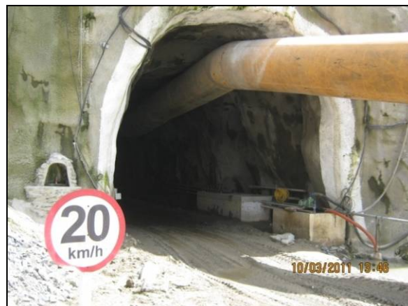
Foto 4.2.853. Instalação de sinalização na entrada do desemboque do túnel Cuncas I (mar/11).
