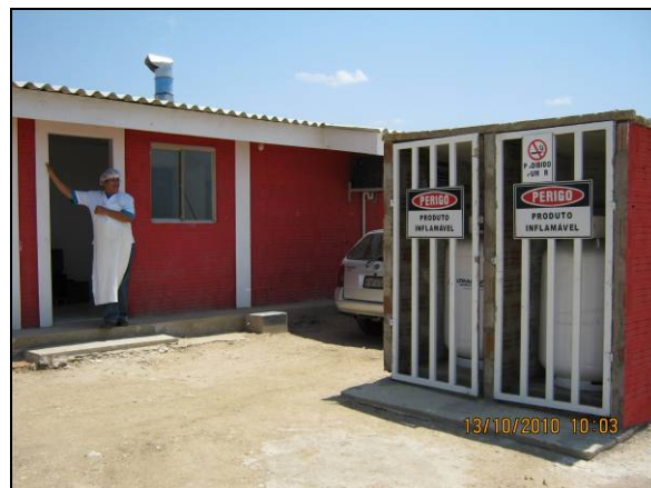
Foto 4.2.728.Botijões de gás (GLP) armazenados em local adequado no canteiro de Sertânia - PE (out/10).
