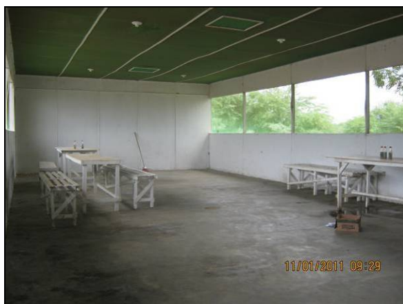
Foto 4.2.49. Refeitório localizado no Canal de Aproximação (jan/11).
