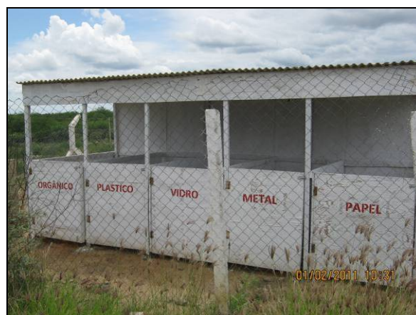
Foto 4.2.42. Baias para acondicionamento dos resíduos (fev/11).
