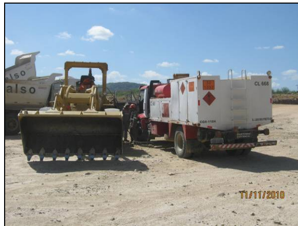
Foto 4.2.217. Lubrificação e abastecimento de máquina no segmento de canal WBS 1218 (nov/10).
