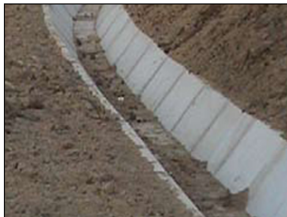
Foto 04: Drenagem superficial: canaleta trapezoidal.
