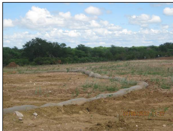
Foto 17: Fibromanta utilizada em curva de nível.
