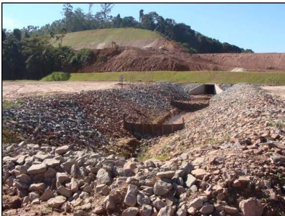
Foto 28: Barreira de contenção de sedimento e decantação.
