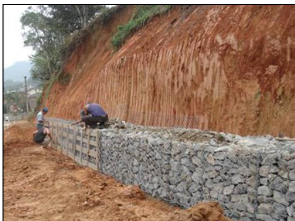
Foto 18: Muro de gabião em talude.
