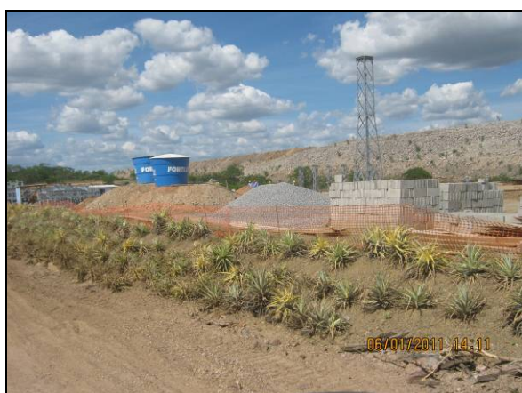
Foto 21: Controle de erosão com revegetação de espécie nativa – macambira.
