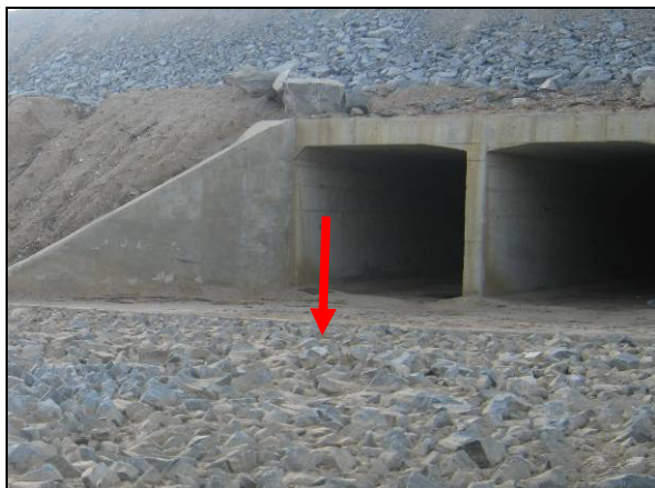
Foto 09: Dissipador de energia em saída de bueiro.
