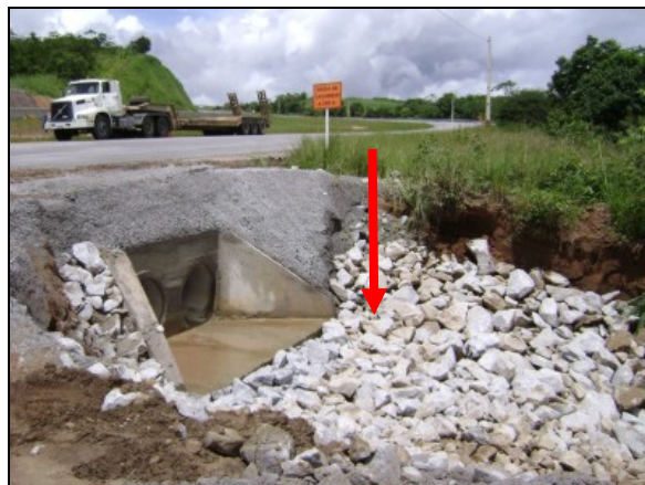
Foto 10: Dissipador de energia em saída de bueiro.
