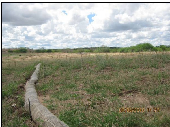
Foto 16: Fibromanta utilizada em curva de nível.
