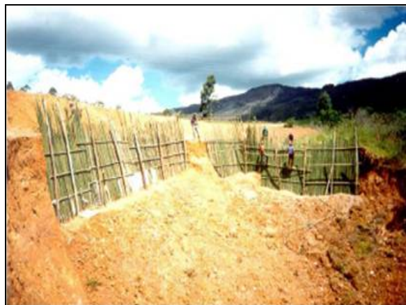
Foto 13: Método de contenção por paliçada.
