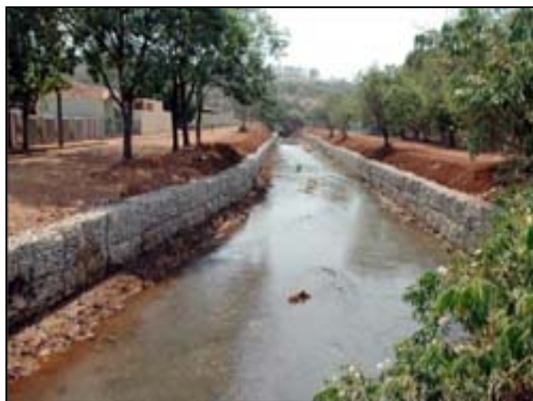
Foto 20: Muro de gabião na margem do córrego.
