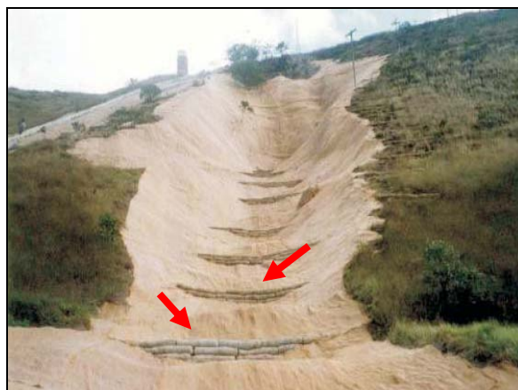
Foto 15: Disposição das bermalongas perpendicularmente ao sentido do escoamento superficial da enxurrada.
