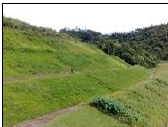
Foto 22: Revegetação de talude.
