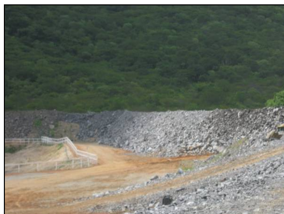
Foto 24: Enrocamento como medida preventiva de erosão.
