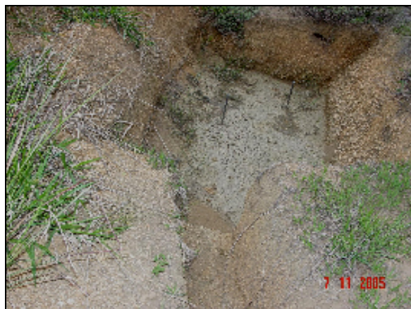
Foto 11: Dissipador de energia em saída de bueiro.
