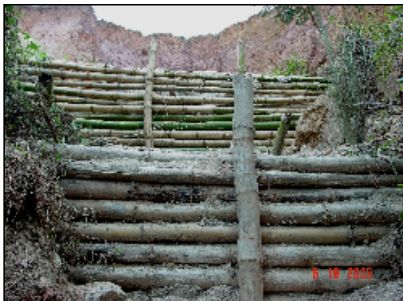
Foto 12: Método de contenção por paliçada.
