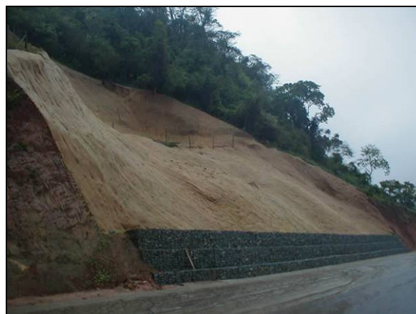
Foto 19: Muro de gabião e aplicação de fibromanta em encostas.
