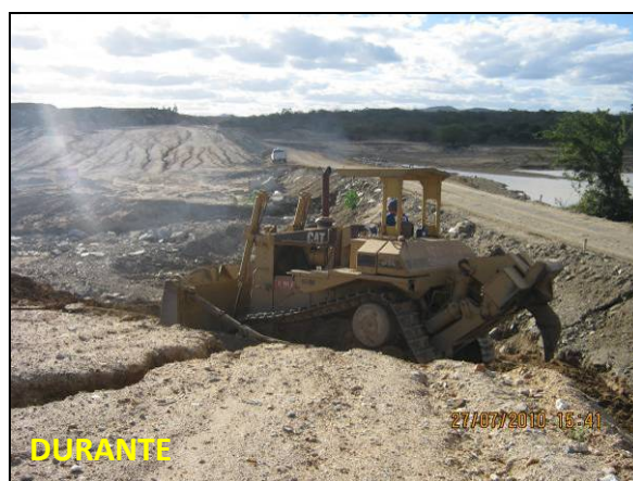
Foto 26. Visita in loco acompanhando implantação de medida de controle.
