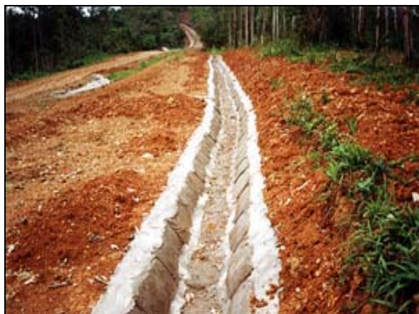
Foto 03: Drenagem superficial: canaleta trapezoidal.
