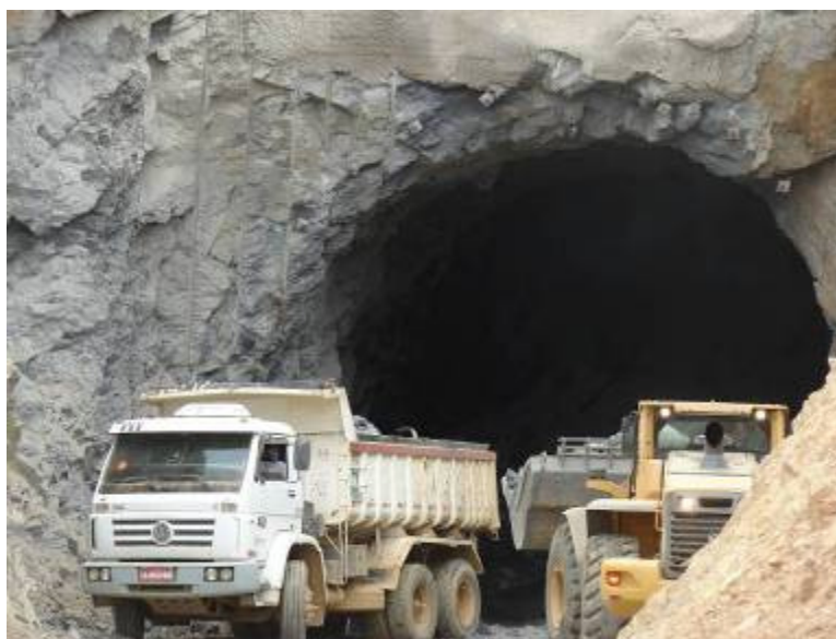
Fotos 1 e 2 . Emboque e janela respectivamente do Tunel Cuncas Lote 14.
