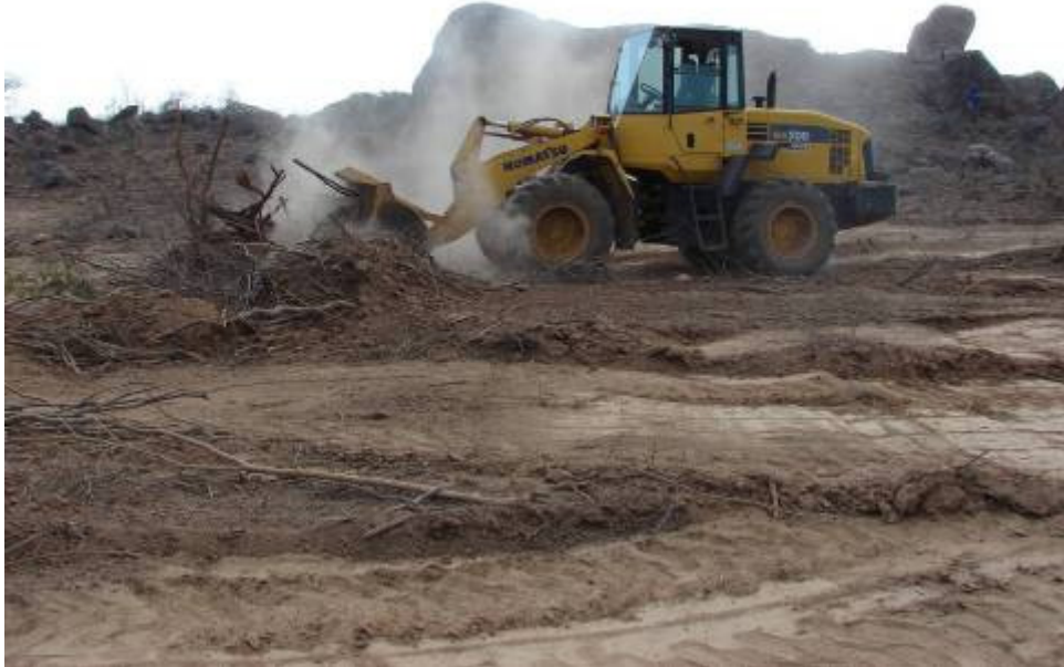
Foto 04 . Remoção da Vegetação no Lote 12
