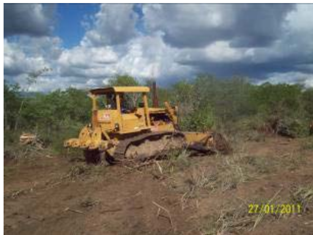
Foto 05 Supressão da Vegetação Maquinas Reservatório Bagres
