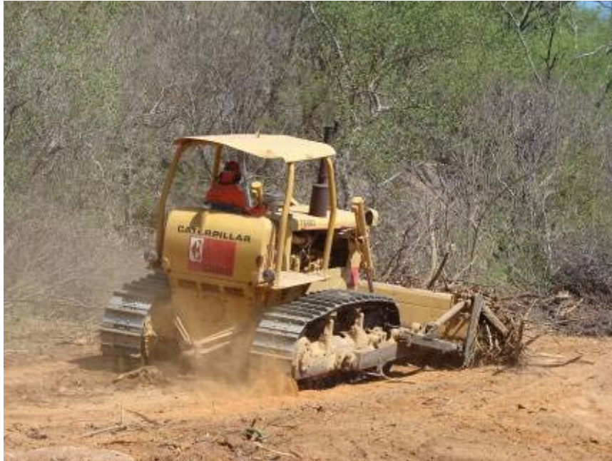
Foto 07 . Remoção da Vegetação D6 no Reservatório Negreiros
