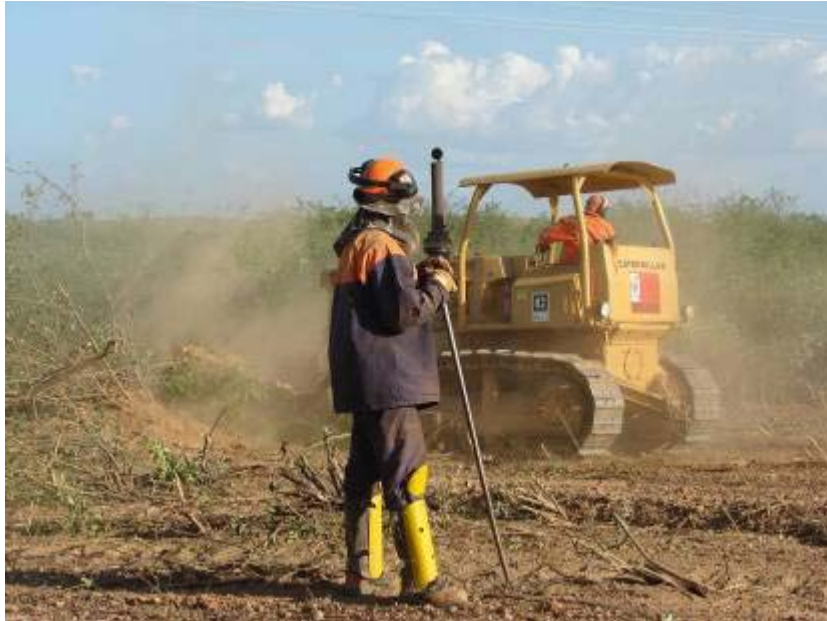
Foto 05 . Remoção da Vegetação no Lote 04 Pena-forte.
