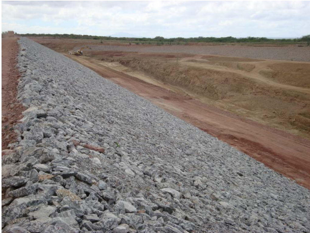
Figura 5: Proteção de talude em aterro com enrocamento sem finos e sem transição granular talude x enrocamento, não observando-se erosão linear a partir do topo do talude.
