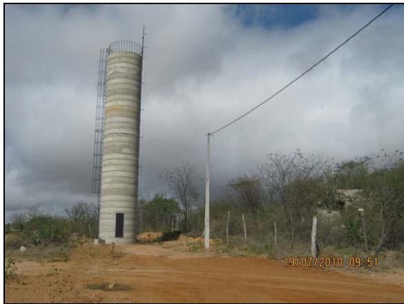
Foto 03: Detalhe do reservatório de água
