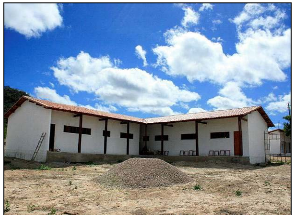
Foto 04: Vista geral da Escola
