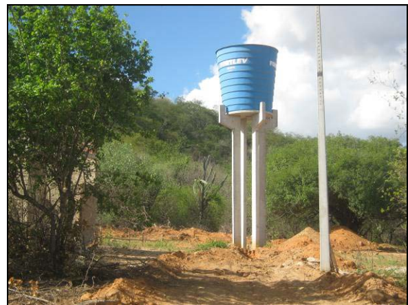
Foto 03: Detalhe do reservatório de água
