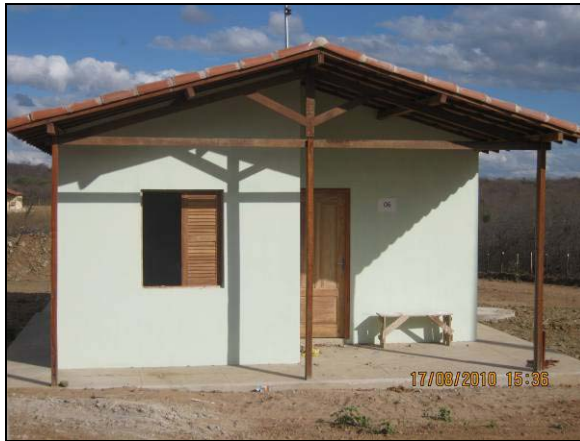
Foto 03: Detalhe da casa
