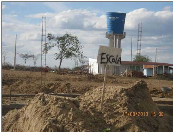
Foto 05: Vista geral da construção da Escola
