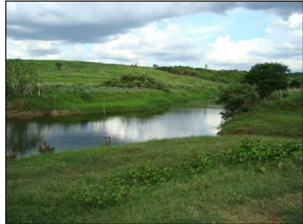
Foto 02: Montante do remanso do açude Eng. Ávidos, no município de Cajazeiras - PB.
