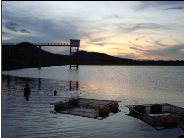
Foto 01: Açude Entremontes no município de Parnamirim - PE.
