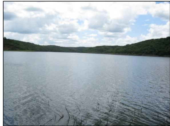
Foto 02: Eixo da barragem do Açude Terra Nova no município de Terra Nova-PE..
