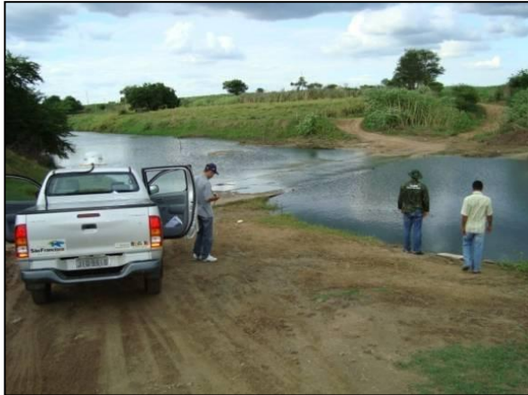
Foto 01: Montante do remanso do açude Eng. Ávidos, no município de Cajazeiras - PB.
