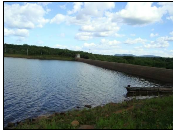
Foto 02: Eixo da barragem do Reservatório Terra Nova, no município de Terra Nova-PE.
