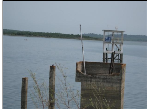
Foto 02: Açude Poço da Cruz no município de Ibimirim - PE.
