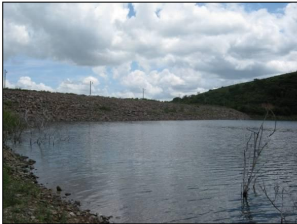
Foto 01: Eixo da barragem do Açude Terra Nova, no município de Terra Nova-PE.
