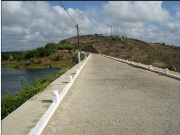
Foto 01: Eixo da barragem do Açude Boqueirão, próximo ao município de Campina Grande - PB.
