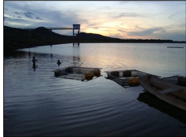
Foto 01: Açude Entremontes no município de Parnamirim - PE.
