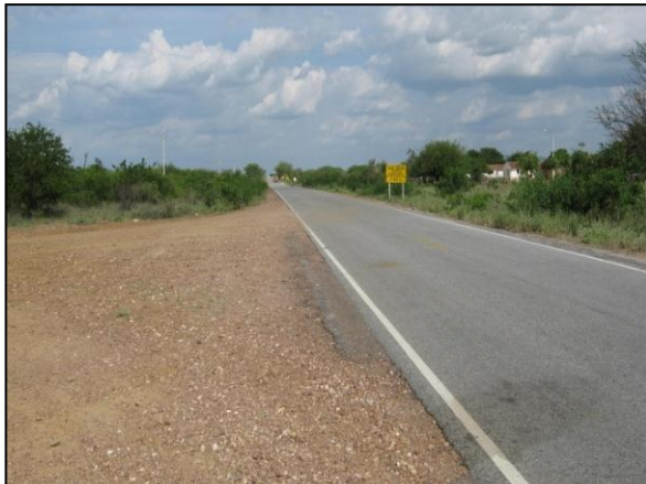
Foto 01: Acesso ao açude Barra de Juá na rodovia PE-360 próximo ao município de Airi - PE.
