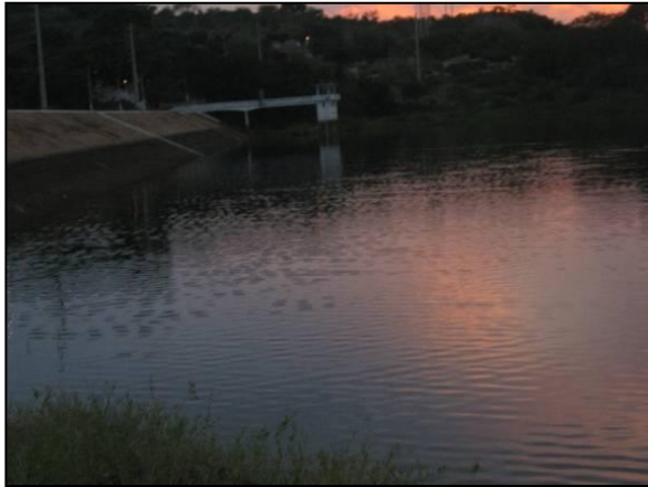
Foto 01: Eixo da barragem do açude São Gonçalo no município de Souza-PB.
