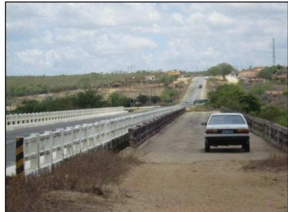
Foto 02: Ponte sob Rio Paraíba, no município de Barra de Santana - PB.
