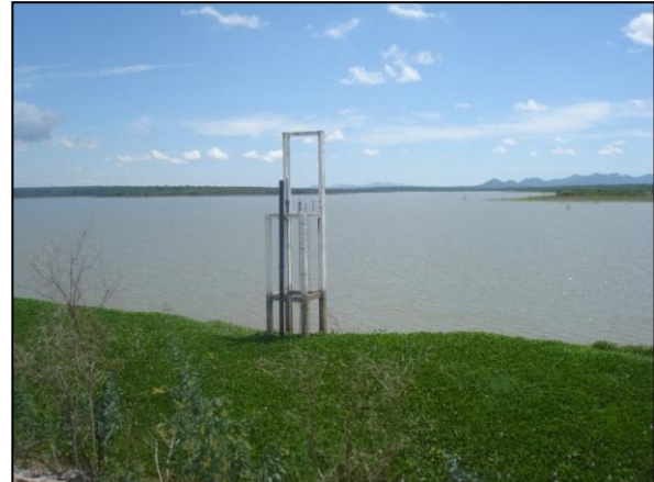
Foto 02: Eixo da barragem do Açude barra de Juá próximo ao município de Airi - PE.
