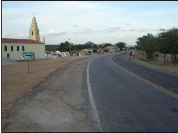
Foto 01: Ponto de acesso à jusante do Açude Poço da Cruz, no município de Ibimirim - PE.
