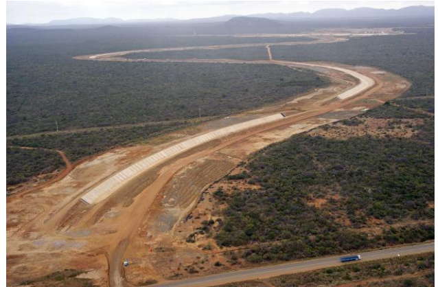
Foto 2 – Canal de adução – Lote 01
