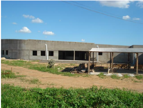
Foto 09: Construção do recinto de reabilitação das aves do CEMAFAUNA Caatinga
