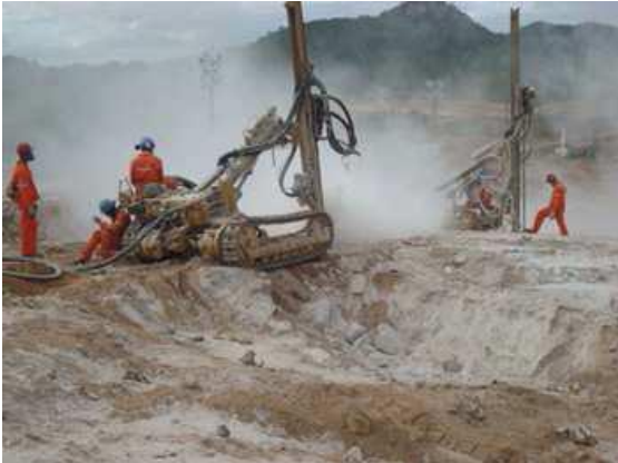
Foto 13 – WBS-1218 - Desmanche de rocha – Preparação para o carregamento – Lote 03
