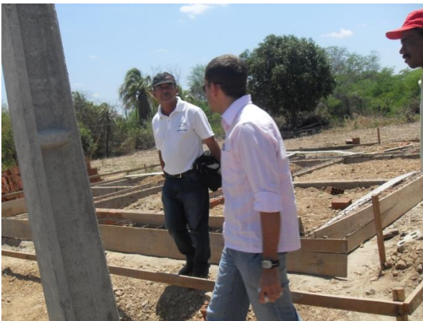
Foto 3 - Acompanhamento da construção das casas – Tribo Indígena Truká
