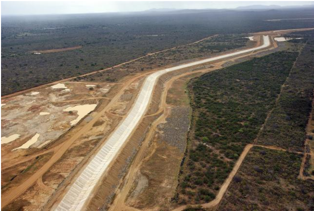
Foto 1 – Canal de adução – Lote 01
