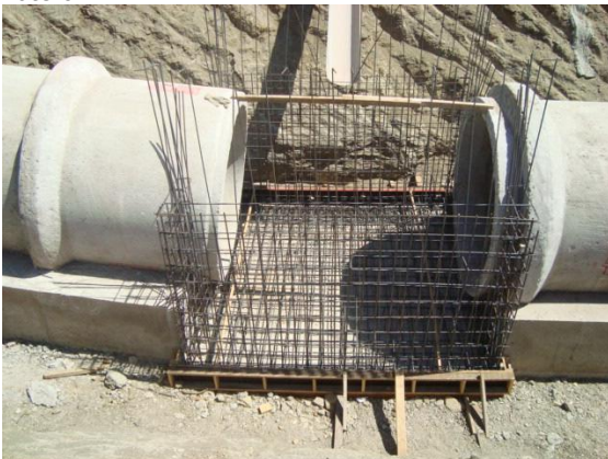
Foto 3 - Canal CN-1214/CN-10 - Implantação do bueiro tubular no 13, estaca 3073+4,006 - Lote 02
