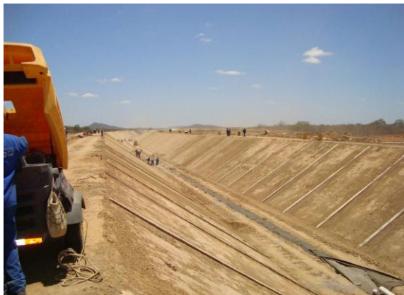
Foto 11 – CN-1207/CN-03 - Serviços de regularização dos taludes com solo cimento e implantação do dreno do fundo do canal – Lote 01
