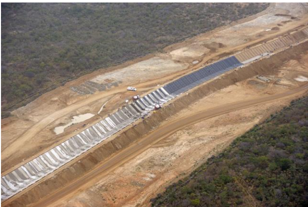
Foto 05 Concretagem do canal de adução – Lote 01
