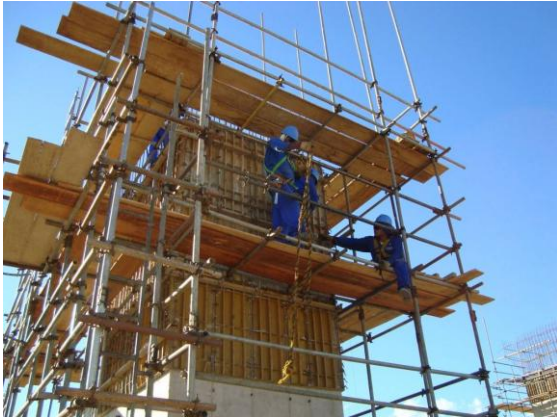
Foto 03 – Funcionários com EPI adequado nas frentes de serviços – Lote 1.
