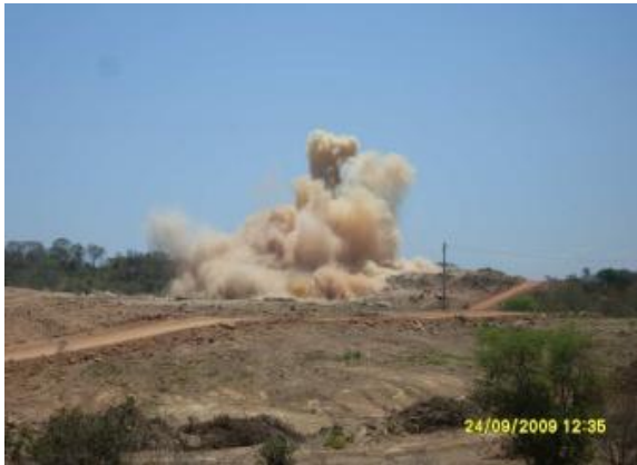
Foto 15 – Detonação de explosivos – Lote 6.
