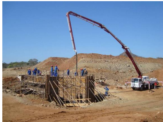
Foto 4 - Canal CN-1214/CN-10 - Implantação da galeria no 23-estaca 3275+11,629 - Lote 02
