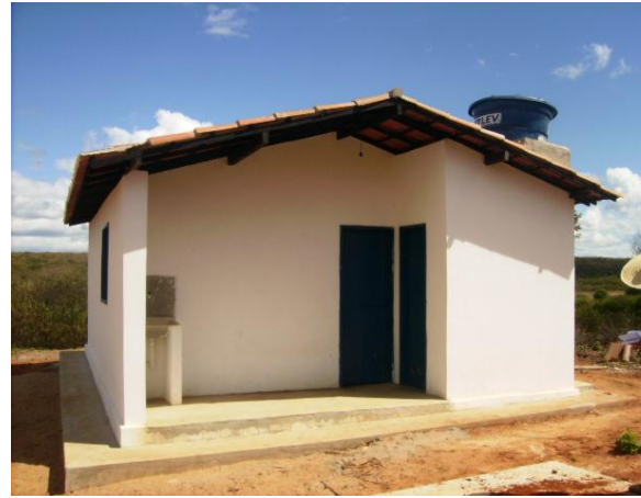
Foto 8: Acompanhamento do processo de construção das Casas – Comunidade Quilombola Cajueiro Grande -Mirandiba/PE
