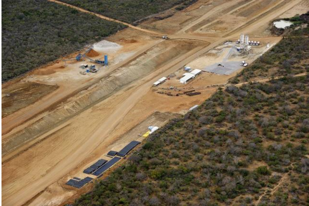
Foto 07 – Central de concreto e solo cimento - Lote 01
