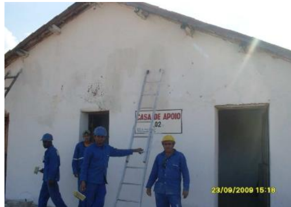
Foto 12 – Reforma de casa que servirá como ponto de apoio aos trabalhadores – Lote 6.
