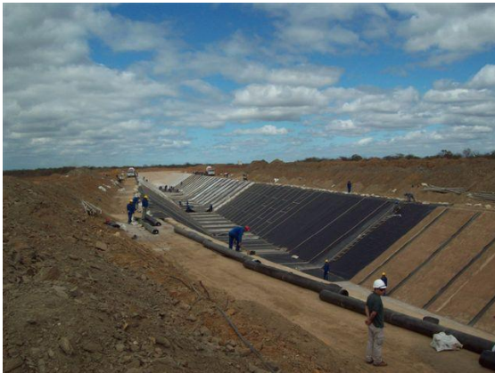
Foto 15 – Atividade de concretagem de canal de adução – Lote 01.
