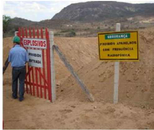
Foto 10 – Isolamento do Paiol – Lote 3.
