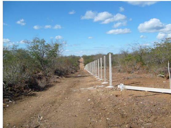
Foto 16 – Isolamento do canal de adução – Lote 10
