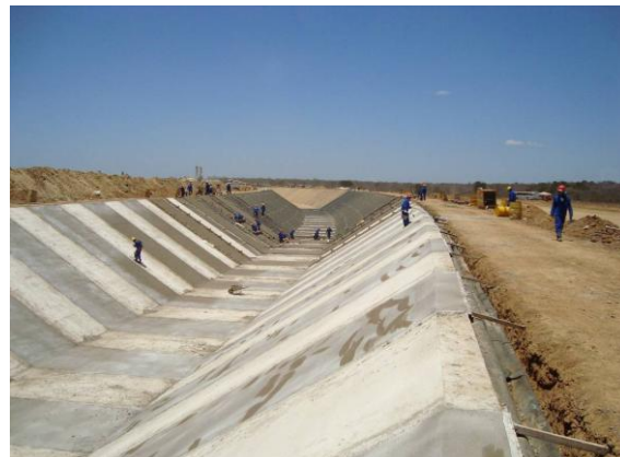
Foto 16 – CN-1207/CN-03 - Serviços de lançamento do concreto de revestimento de proteção da geomembrana, entre as estacas 935 a 942 – Lote 01
