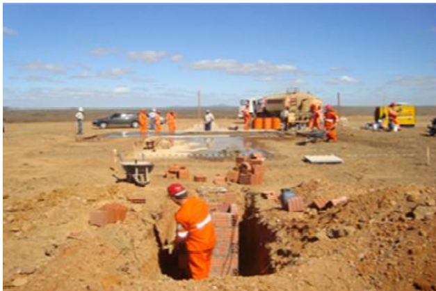
Foto 11 – Instalação do Posto de Combustível – Lote 3.
