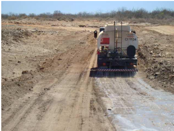
Foto 09 – Serviço de umectação de vias de acesso – Lote 3.
