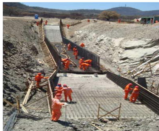
Foto 6 - WBS-1218 - Implantação do bueiro 01 - Lote 03
