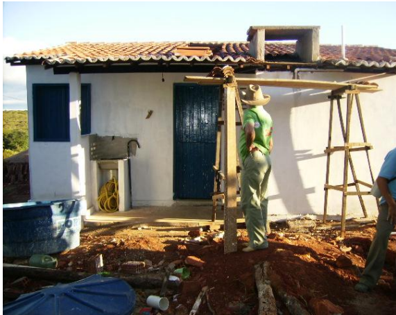
Foto 7: Acompanhamento do processo de construção das Casas – Comunidade Quilombola Serra do Talhado-Mirandiba/PE
