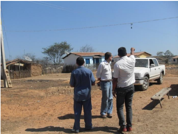
Foto 5 - Acompanhamento da construção das casas – Tribo indígena Pipipan
