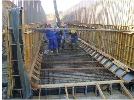
Foto 2 - Canal CN-1214/CN-10 - Implantação da galeria nº 02, estaca 2827 - Lote 02
