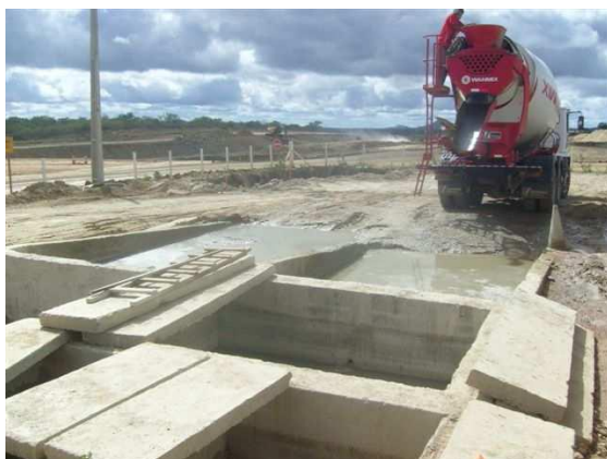
Foto 07 – Local para lavagem de caminhão de concreto com bacia de decantação – Lote 2.
