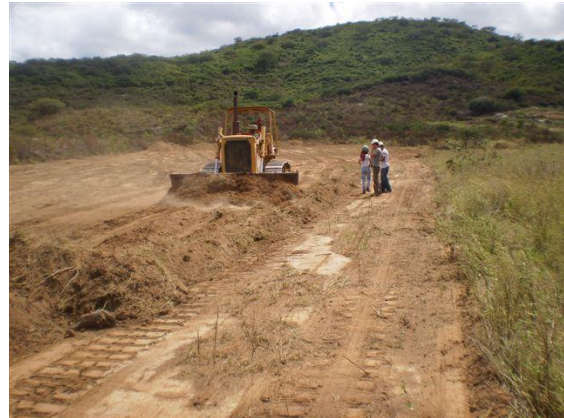
Foto 08 – Supressão vegetal e remoção de expurgo – EBV 06 com acompanhamento da equipe de resgate de fauna – Lote 13
