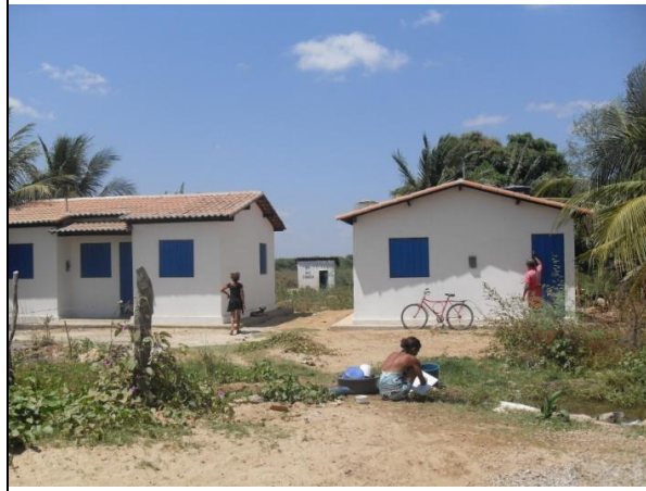
Foto 6 - Acompanhamento da construção das casas – Tribo indígena Truká
