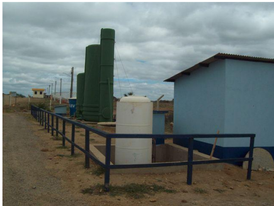
Foto 05 - Estação de tratamento de efluentes – Canteiro de obras Lotes 01 e 02
