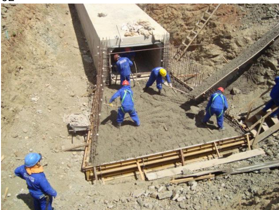
Foto 5 - Canal CN-1214/CN-10 - Implantação da galeria nº 24, estaca 3285+12,860 - Lote 02
