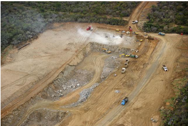
Foto 03 – Desmonte de rocha – Lote 01
