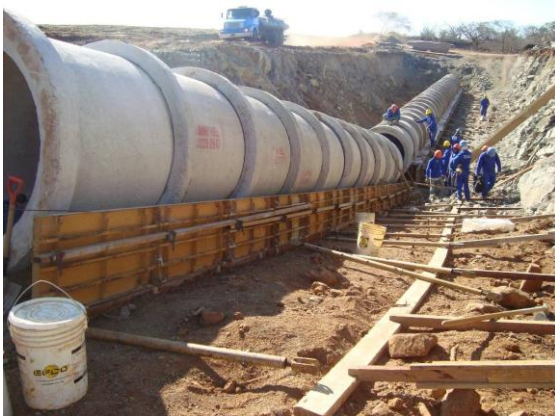
Foto 1 - Canal CN-1214/CN-10 - Implantação do bueiro tubular nº 01, estaca 2803+19,207 - Lote 02
