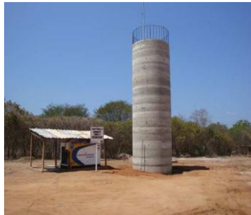
Foto 14 – Reservatório de água para consumo humano – Lote 6.
