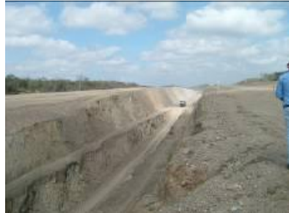
Foto 14 – Escavação da calha final do canal estaca 6015 – Lote 10
