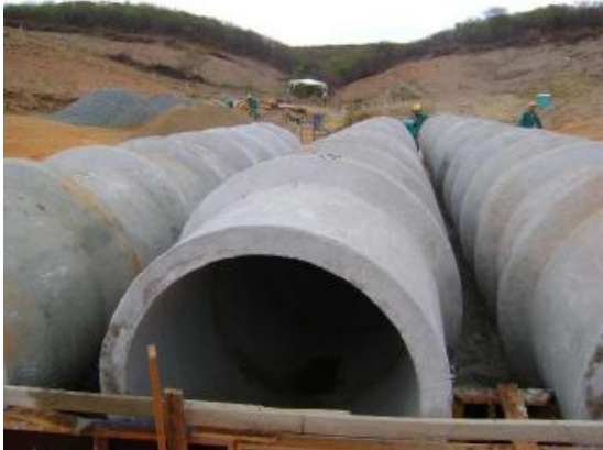
Foto 07 – Implantação de Bueiro na travessia 32, estaca 499+13,00 – Lote 06
