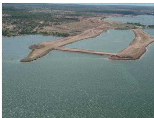
**Figura 3.10:** Ensecadeira da Tomada D'água do Eixo Leste - Itaparica
