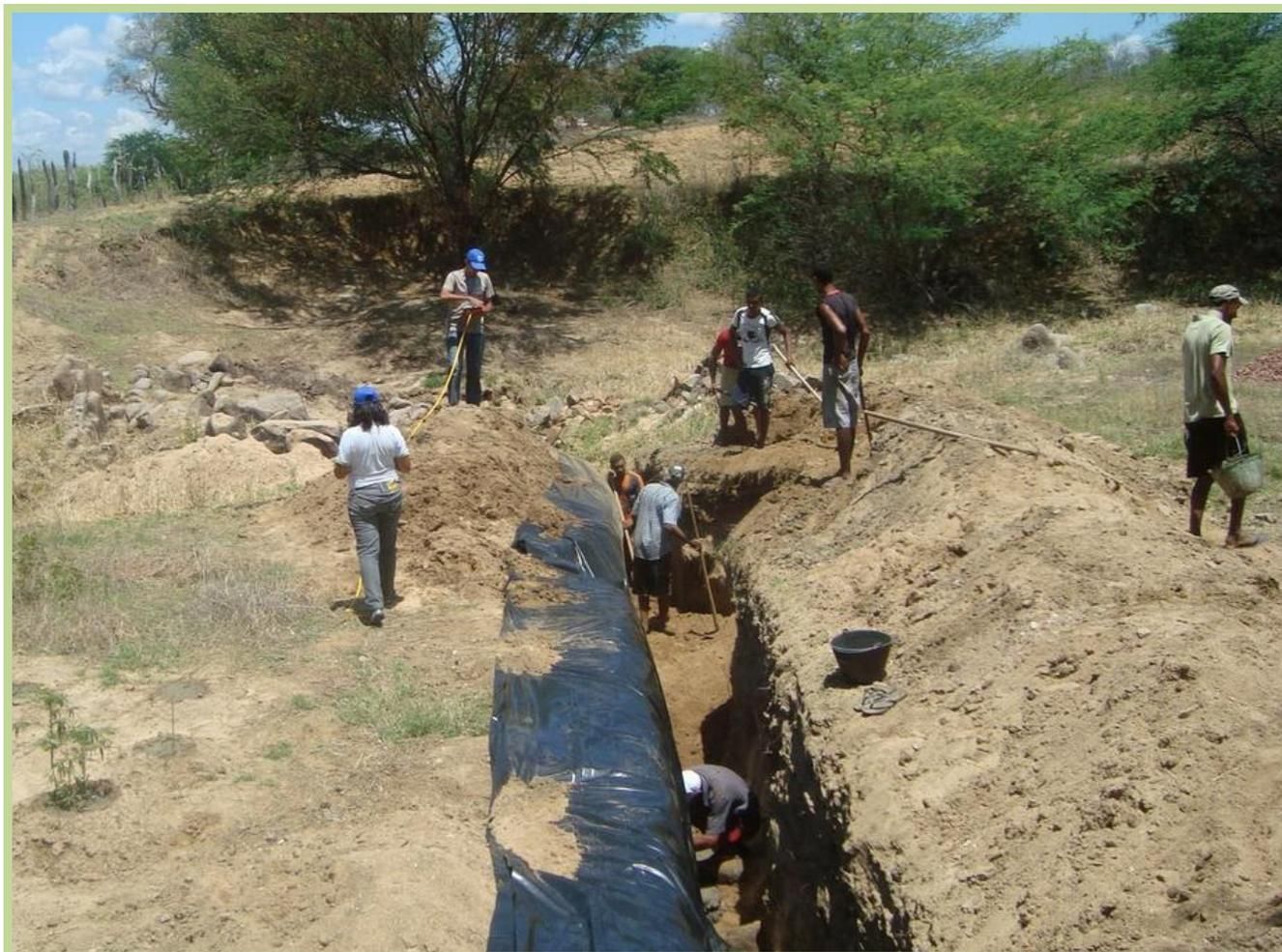
**Figura 5 – Construção de barragem subterrânea em mutirão**
