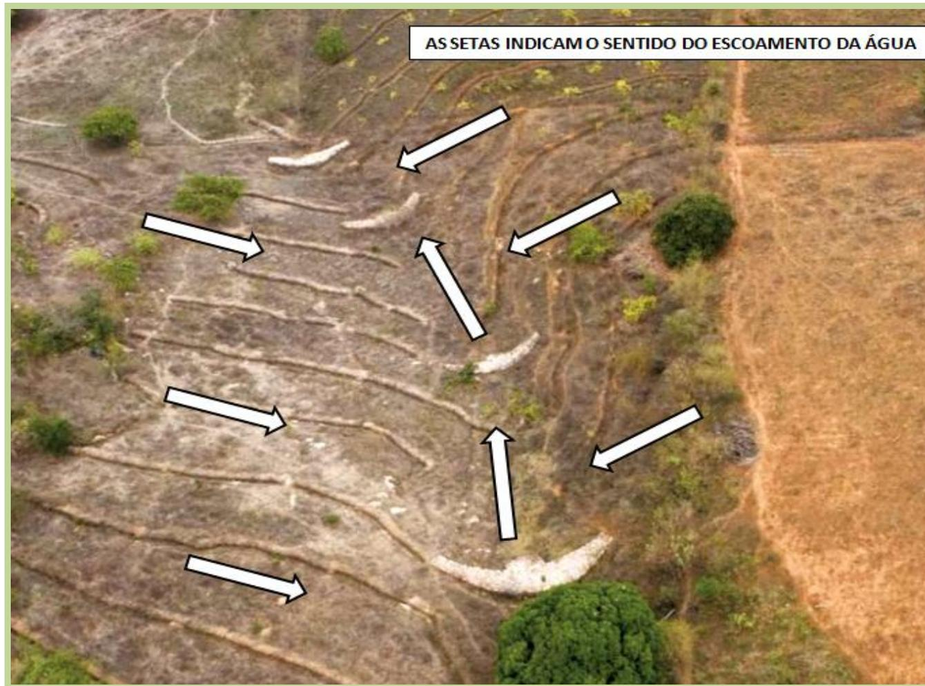
**Figura 3 – Barragens de retenção em de pedra arrumada em arco romano combinadas a cordões de pedra**
