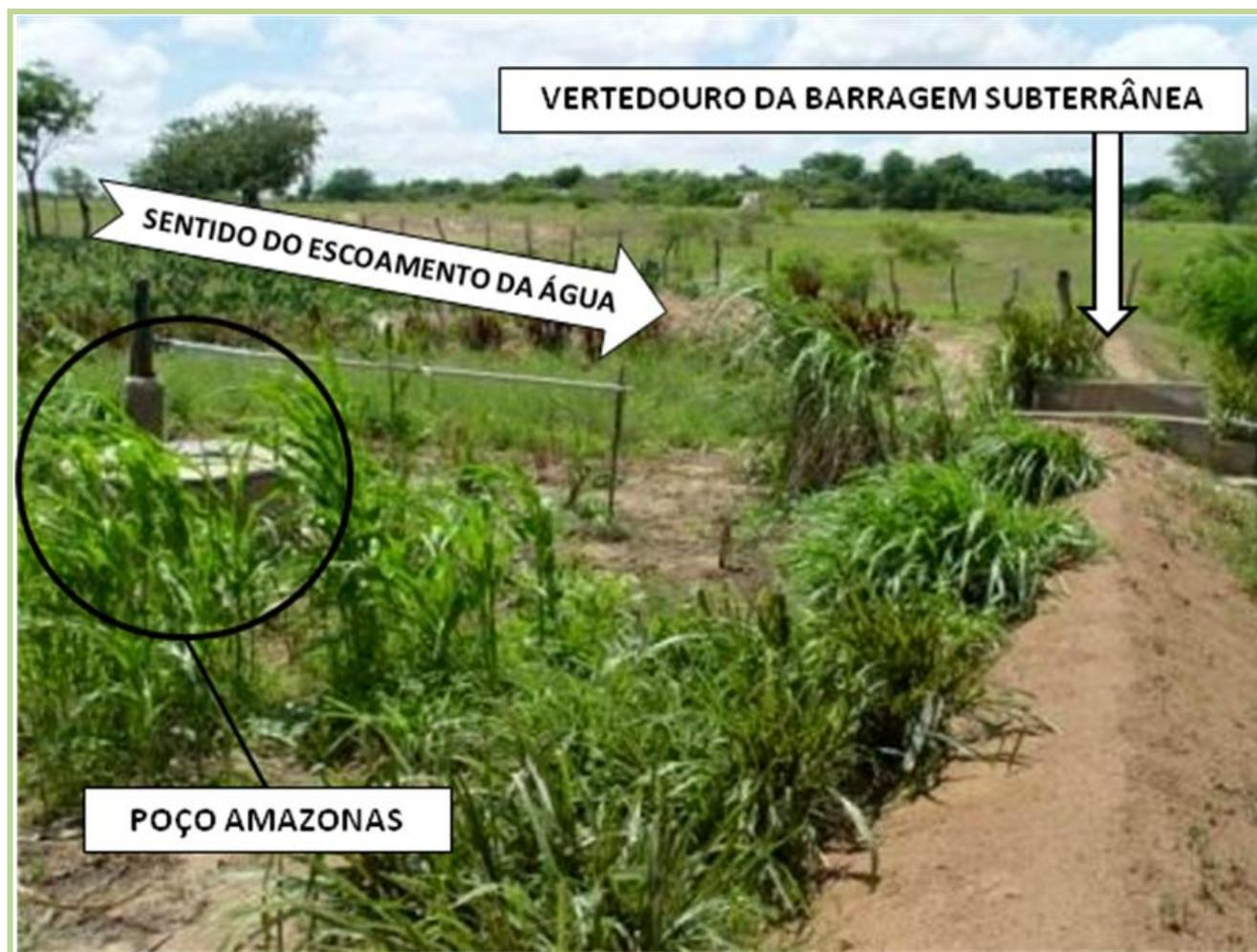
**Figura 6 – Barragem subterrânea em pleno funcionamento**
