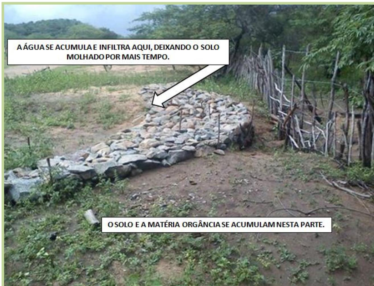
**Figura 4 – Resultado da utilização da barragem de contenção em arco romano**
