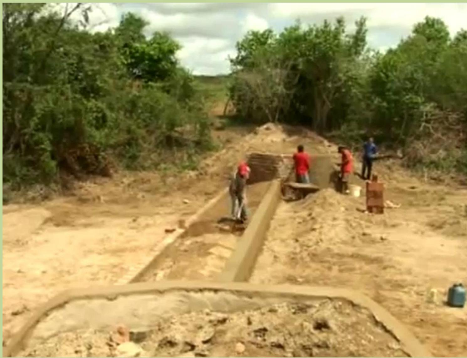
**Figura 10 - Construção do vertedouro da barragem subterrânea**
