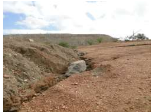
Figura 6 - Erosão em sulco no contato entre o material estéril depositado e o solo da área. (S - 08°31'34.0" W - 039°27'42.9")
