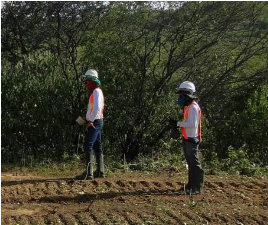
Figura 4.23.8.4. Auxiliares de campo durante a supressão vegetal utilizando todos os EPI's necessários.
