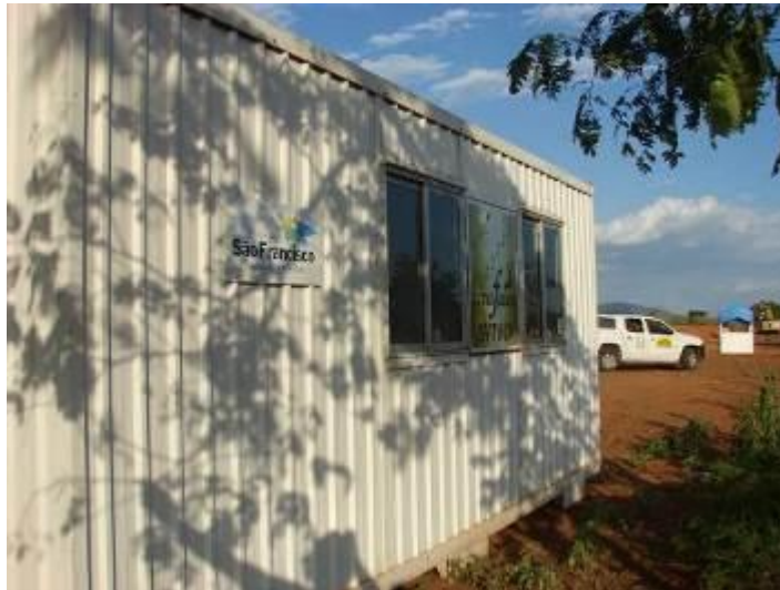
Figura 4.23.8.5. CETAS-MÓVEL localizado no canteiro de obras da empresa Serveng, Lote 5, Brejo Santo - CE.
