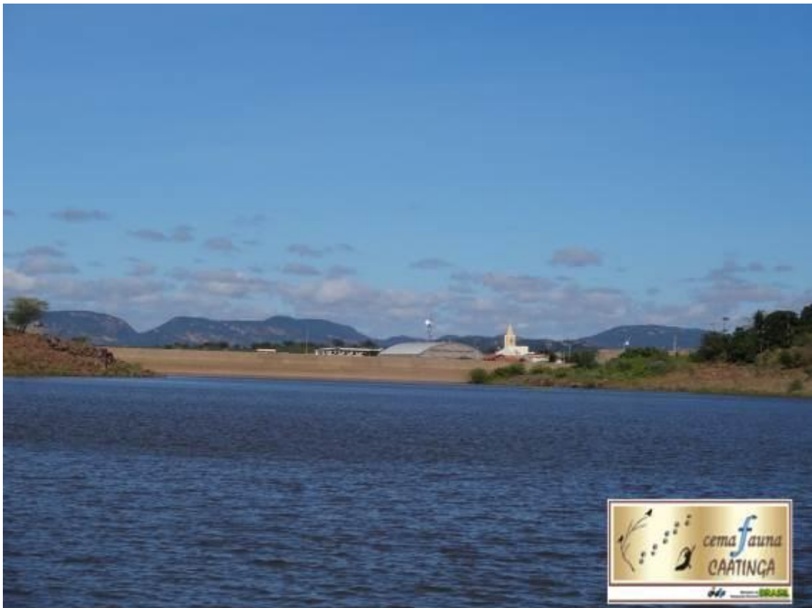
Figura 7.23.7. 26 - PM17 - Açude Terra Nova, visão a montante do barramento.
