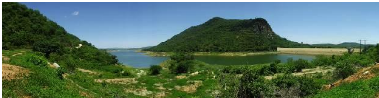
Figura 0.46 - Vista geral do Açude Engenho Ávido – Ponto de Monitoramento 24.
