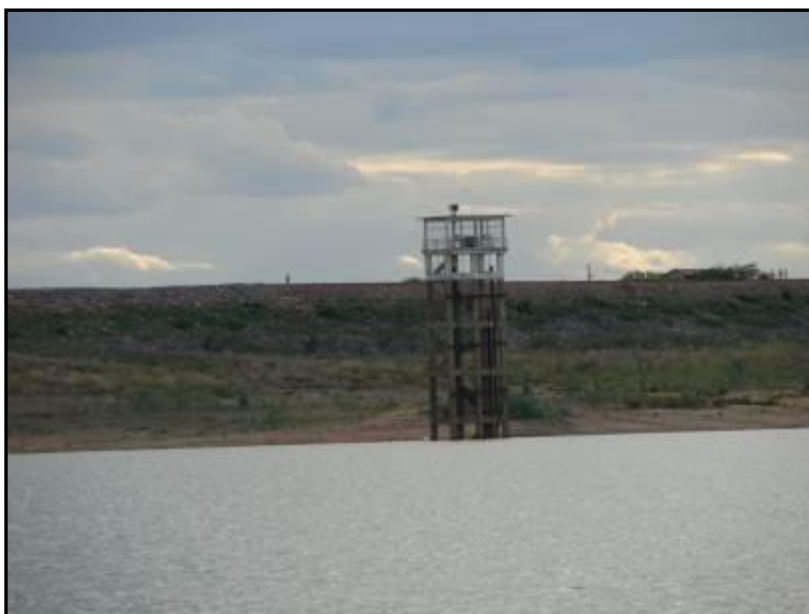
Figura 7.23.7. 10 - PM09 – Reservatório Engenheiro Francisco Sabóia (Poço da Cruz). Evidenciando o baixo nível hídrico e margens expostas.
