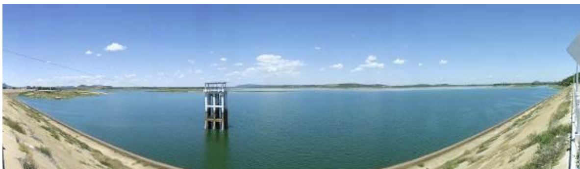
Figura 0.48 - Vista geral do Açude Coremas – Ponto de Monitoramento 26
