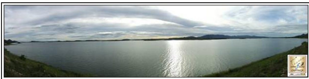
Figura 7.23.7. 54 - Visão panorâmica do Açude de Orós - PM35, município de Orós/CE.
