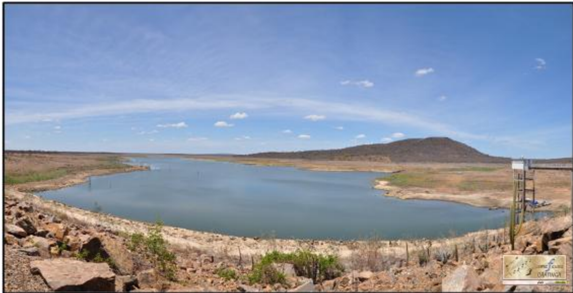
Figura 7.23.7. 18 - PM13 - Reservatório Entremontes.
