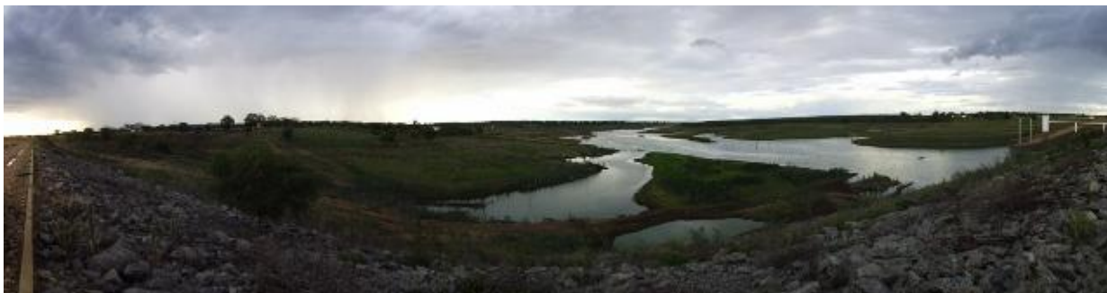
Figura 0.30 - Vista geral do Açude do Chapéu – Ponto de Monitoramento 15
