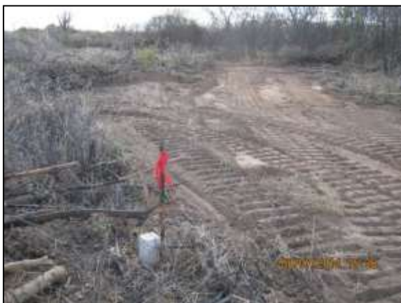
Foto 4.10 106. Delimitação da área a ser suprimida por estacas referenciadas na VPR Uri (jul/2014).
