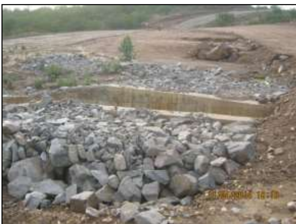
Foto 4.27 42. Medida de proteção contra processos erosivos com enrocamento do talude em cabeceira de sistema de drenagem (abr/2014).
