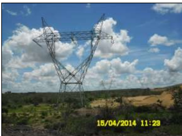
Foto 4.37.1. Verificação do revestimento vegetal na faixa de servidão da LT próximo à subestação O Trecho I (abr/2014).
