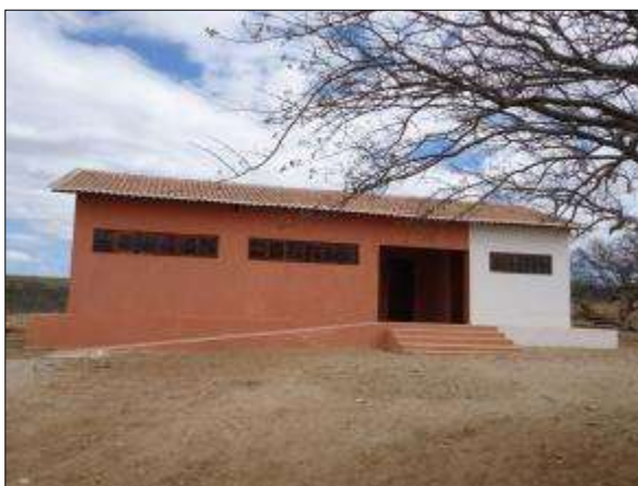
Foto 4.8.1. Vista parcial da sede da associação da VPR Captação (jul/2014).
