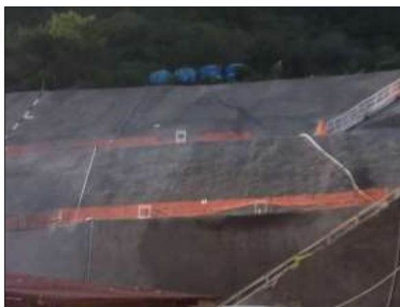
Foto 4.27 95. Concreto projetado no espelho do túnel para prevenção e controle de processo erosivo (ago/2014).
