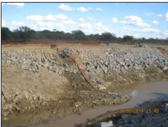
Foto 4.20 15. Esgotamento de acúmulo de água no segmento de canal WBS 1214, para evitar possível proliferação de vetores e hospedeiros de doenças (ago/2014).
