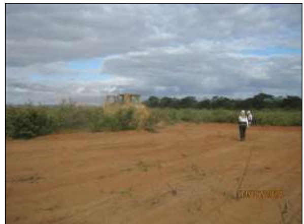
Foto 4.10 76. Supressão mecanizada acompanhada por técnicos da UNIVASF para eventual resgate de fauna (jun/2014).
