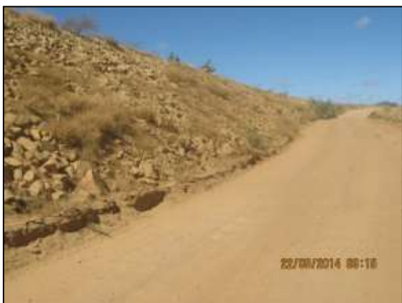
Foto 4.27 50. Talude de canal enrocado com surgimento espontâneo de espécies herbáceas que auxiliam na dissipação de escoamento de águas pluviais e na estabilização do talude (ago/2014).
