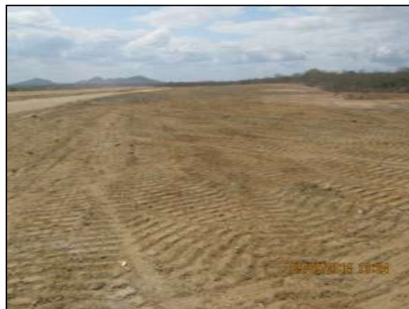
Foto 4.27 23. Faixa marginal ao canal adequadamente reconformada (set/2014).
