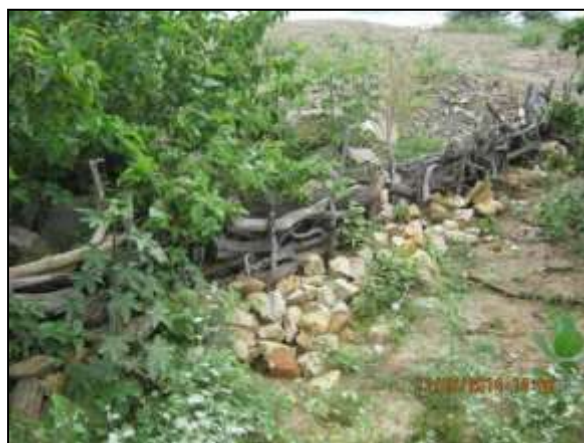
Foto 4.27 6. Cerca paliçada implantada como medida preventiva ao carreamento de sedimentos (maio/2013).
