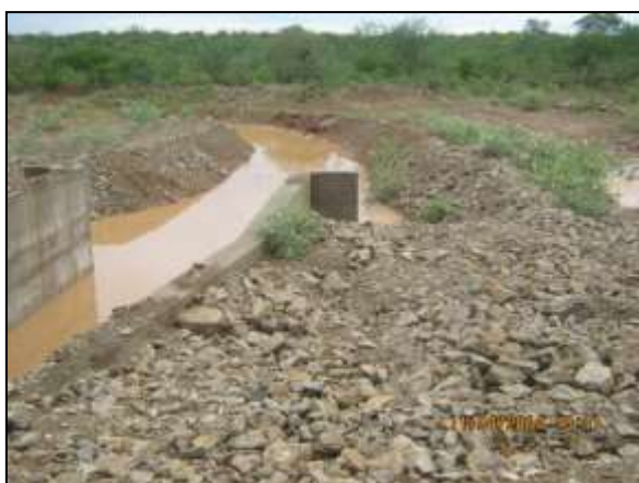
Foto 4.27 36. Medida de proteção contra processos erosivos com enrocamento do talude em saída sistema de drenagem (abr/2014).
