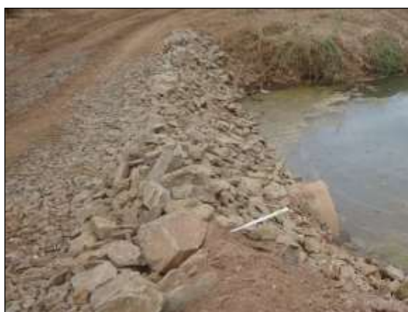
Foto 4.27 57. Medida de contenção de processos erosivos com enrocamento do talude no entorno do sistema de drenagem (set/2014).
