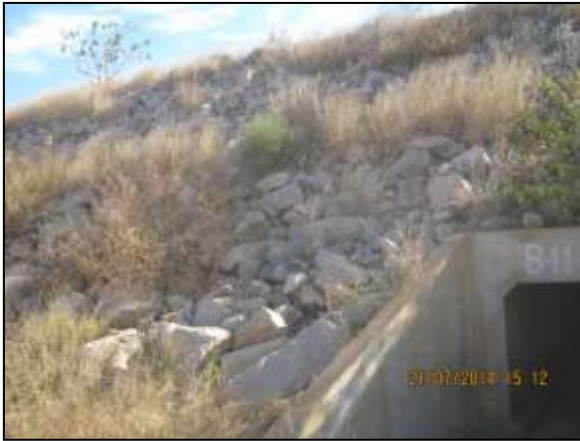
Foto 4.27 54. Enrocamento de talude de canal em cabeceira de drenagem para dissipação das águas drenadas superficialmente (jul/2014).
