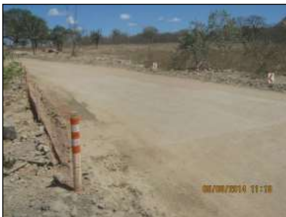
Foto 4.27 70. Implantação de passagem molhada na via de acesso ao canteiro de obras e EBI-03 (ago/2014).
