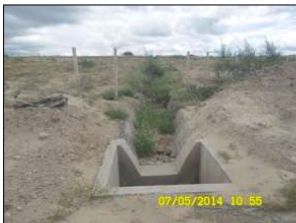
Foto 4.27.3. Caixa coletora na base da ecocalha, construída na saída da bacia de sedimentação da BF-04-CL como medida preventiva de processos erosivos (maio/2014).
