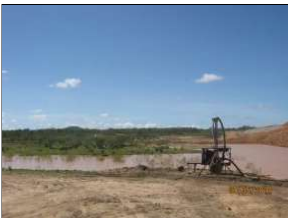
Foto 4.20 3. Esgotamento de água em caixa de empréstimo para evitar possível proliferação de vetores e hospedeiros de doenças (maio/2014).
