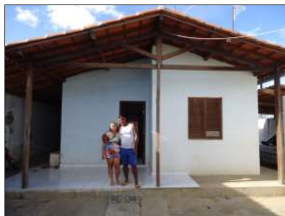
Foto 4.8.91. Acompanhamento social e verificação de permanência na VPR Baixio dos Grandes, Cabrobó – PE (ago/2014).
