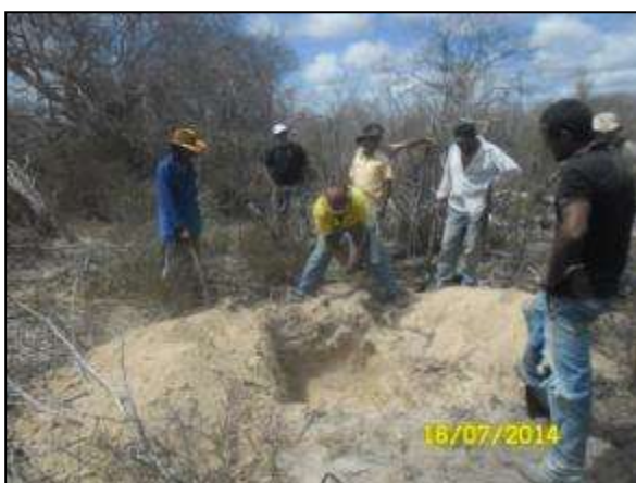
Foto 4.16. 13. Abertura de trincheiras para seleção de área para implantação do projeto de irrigação no Assentamento Eloita Pereira, Cabrobó – PE (jul/2014).
