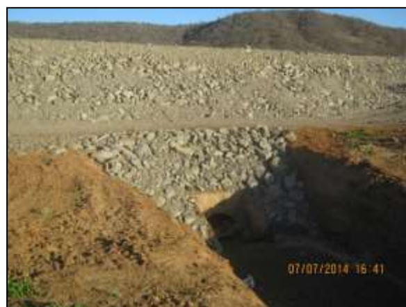
Foto 4.27 39. Enrocamento de talude implantado em cabeceira de sistema de drenagem como medida preventiva e de controle (jul/2014).
