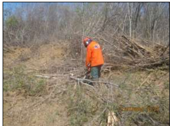
Foto 4.10 117. Supressão semimecanizada da vegetação na área da VPR Retiro (jul/2014).
