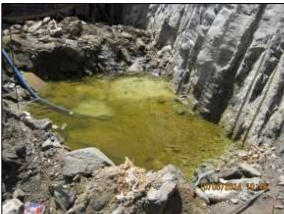
Foto 4.20 7. Esgotamento de água acumulada em escavação do poço de sucção da estação de bombeamento EBI-02, para evitar possível proliferação de vetores e hospedeiros de doenças (jun/2014).
