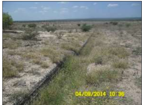
Foto 4.9.33. "Ecocalha" instalada no interior da área em recuperação, BF 04-CL (set/2014).
