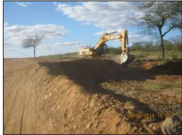
Foto 4.27 53. Reconformação topográfica de talude para implantação de medida preventiva a ocorrência de processos erosivos (jun/2014).
