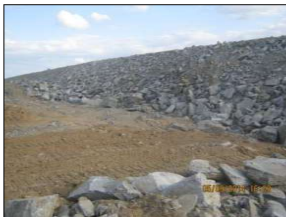
Foto 4.27 29. Enrocamento do talude do canal de adução para dissipação das águas drenadas superficialmente (set/2014).
