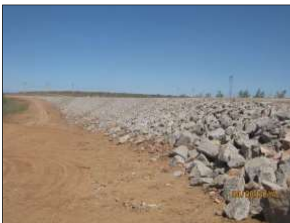
Foto 4.27 73. Enroncamento do talude de aterro no WBS 2205 como medida preventiva ao surgimento de processos erosivos (ago/2014).
