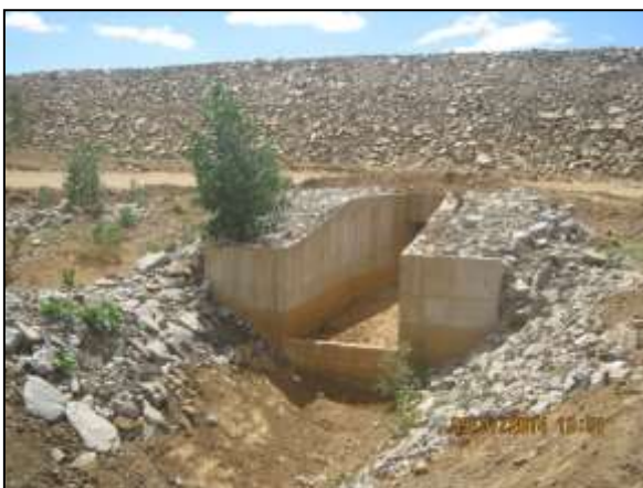
Foto 4.27 44. Medida de proteção contra processos erosivos com enrocamento do talude em cabeceira de sistema de drenagem (jul/2014).
