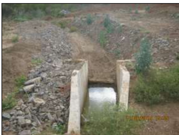
Foto 4.27 38. Estabilização de talude de canal e de sistema de drenagem por enrocamento (jun/2014).
