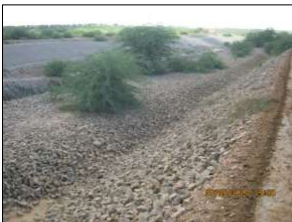
Foto 4.27 1. Canal de escoamento revestido por enrocamento na margem da estrada de acesso do canal de aproximação (mai/2014).
