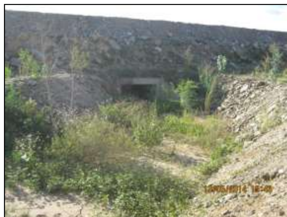
Foto 4.27 25. Restabelecimento da vegetação e saída de drenagem com enrocamento de proteção (maio/2014).
