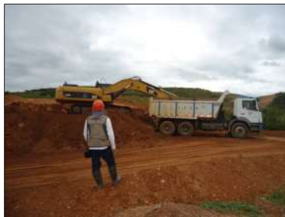
Foto 4.6 26. Técnico do INAPAS acompanhando atividade de escavação no reservatório Jati – WBS 111, meta 2N (maio/2014).
