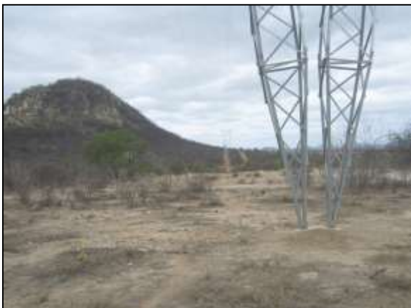
Foto 4.37.11. Verificação da estabilidade das superfícies adjacente às torres de transmissão próximas ao reservatório Negreiros, Trecho I, Eixo Norte (jul/2014).
