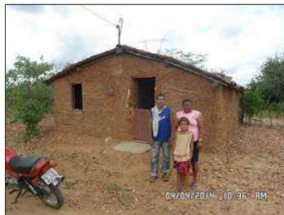
Foto 4.7 10. Elaboração de PTT do Sr. Uenio Erlan da Silva Ferreira – ENTI-119=TN-025-1 H no lote 02, Trecho I, Eixo Norte do PISF (abr/2014).
