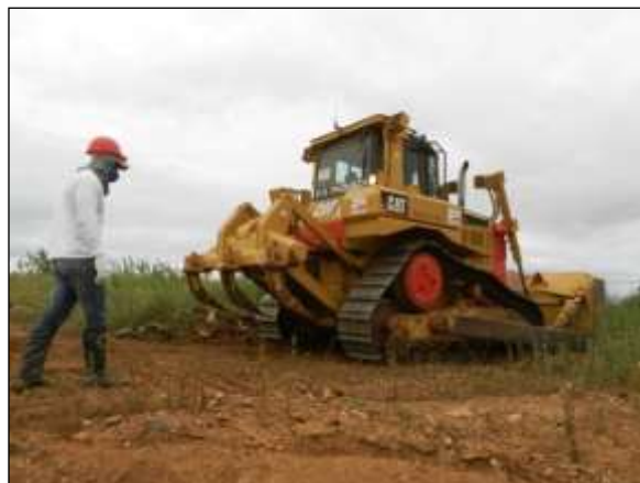
Foto 4.6 4. Acompanhamento de supressão vegetal mecânica no Reservatório Areias (WBS 1204), Meta 2L (jun/2014).
