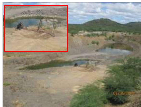
Foto 4.20 4. Esgotamento de água acumulada na EBV-04 para evitar possível proliferação de vetores e hospedeiros de doenças (maio/2014).
