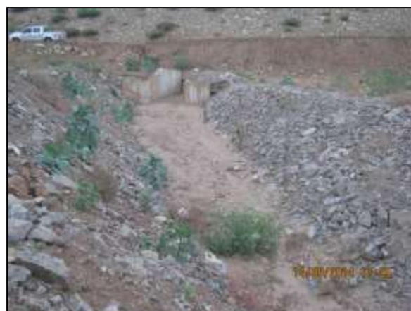
Foto 4.27 37. Enrocamento de talude de canal para dissipação das águas drenadas superficialmente (maio/2014).
