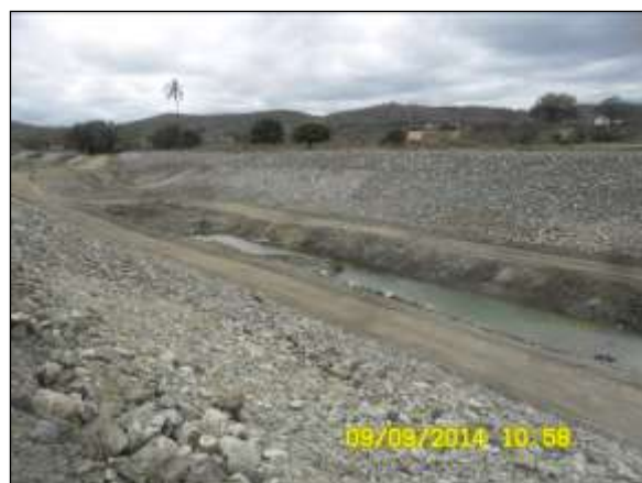
Foto 4.27 84. Espalhamento e reconformação topográfica em caixa de empréstimo na lateral da via de acesso do WBS 2226 (abr/2014).
