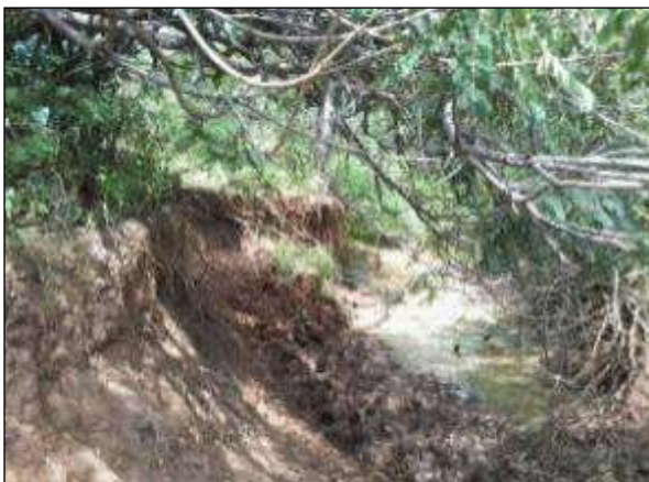
Foto 4.8.120. Detalhe de recursos hídricos da VPR Retiro, em Penaforte – CE (maio/2014).
