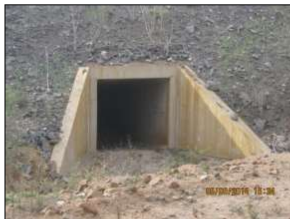
Foto 4.27 35. Enrocamento de talude de cabeceira de bueiro como medida para a estabilização topográfica (ago/2014).
