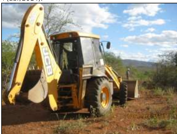
Foto 4.37.3. Remoção da cobertura vegetal em regeneração na faixa de servidão da LT próxima ao reservatório Mangueira - Trecho I (jun/2014).
