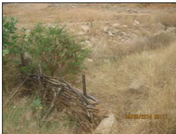
Foto 4.27 56. Cerca paliçada implantada a jusante de canal de restituição enrocado apresentando cobertura vegetal que auxilia na retenção de sedimentos (set/2019).
