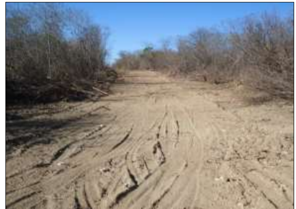
Foto 4.8.28. Vias de acesso dos setores residenciais e produtivo da VPR Pilões (jul/2014).
