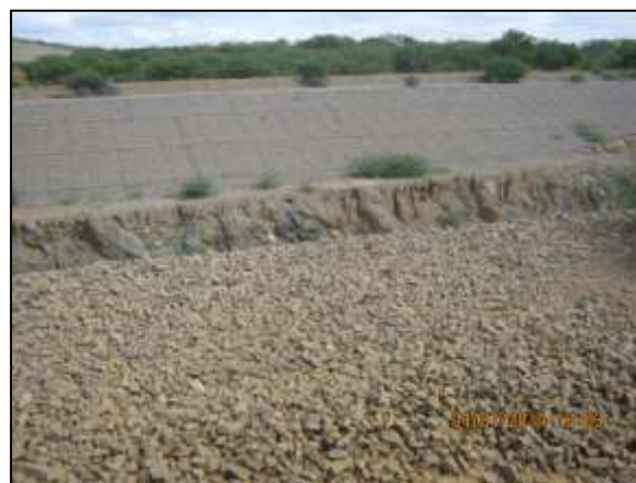
Foto 4.27 2. Colchão Reno para estabilização de margens do canal de aproximação (jul/2014).
