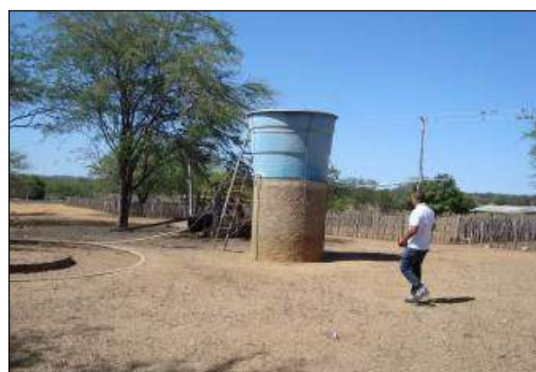
Foto 4.7 50. Vistoria complementar na VPR de Lafayette no município de Monteiro-PB (set/2014).
