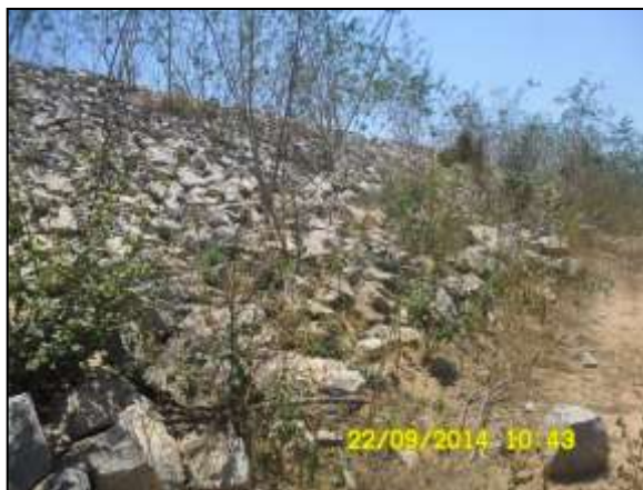
Foto 4.27 81. Estabelecimento natural da vegetação em meio ao enrocamento marginal da estrada de acesso (set/2014).
