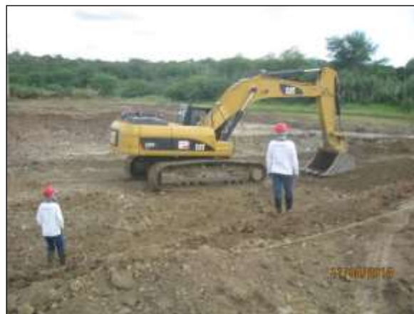
Foto 4.6 28. Abertura de canal inspecionada por técnicos do INAPAS no WBS 2226, meta 2L/3L (abr/2014).
