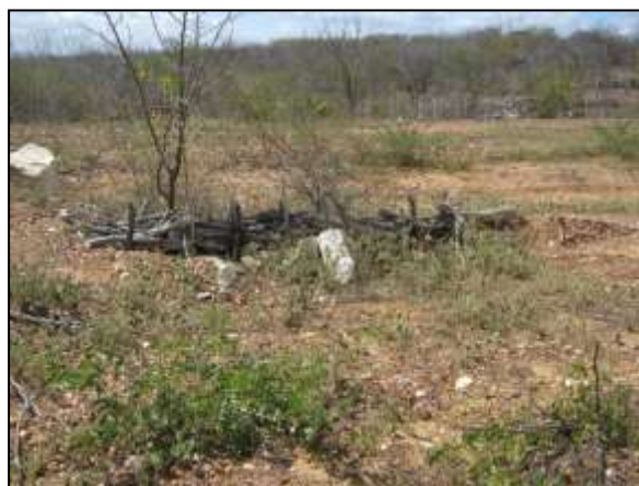
Foto 4.27 8. Cerca paliçada implantada como medida preventiva ao carreamento de sedimentos apresentando regeneração natural (jul/2013).
