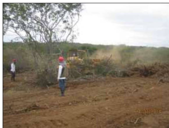
Foto 4.6 30. Acompanhamento de supressão mecanizada por técnicos do INAPAS no reservatório Campos, Meta 2L/3L (jul/2014).
