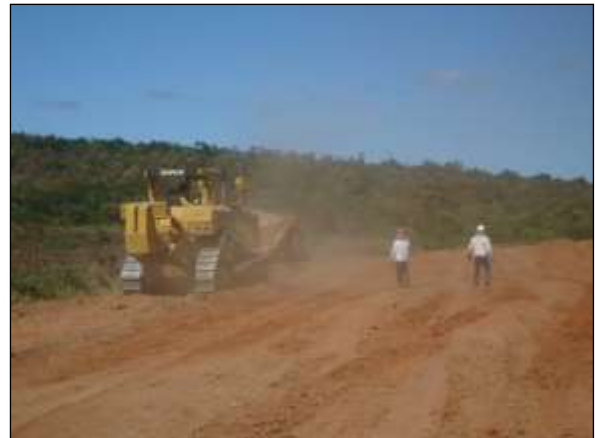
Foto 4.10 34. Equipe da UNIVASF acompanhando atividade de supressão vegetal mecanizada (jul/2014).
