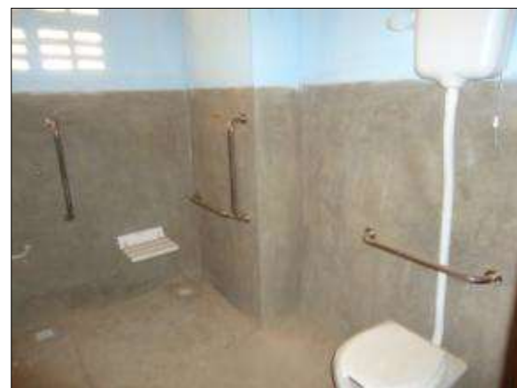
Foto 4.8.6. Vista parcial da residência com implantação de equipamentos de acessibilidade para membros de beneficiários com deficiência e/ou mobilidade reduzida, VPR Queimada Grande (ago/2014).
