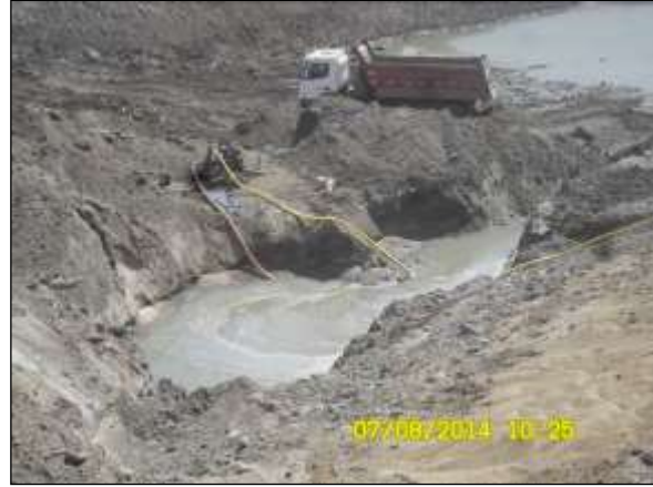
Foto 4.20 16. Esgotamento de água acumulada no segmento de canal para evitar possível proliferação de vetores e hospedeiros de doenças (ago/2014).
