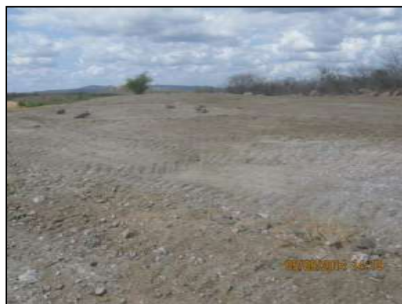
Foto 4.27 27. Faixa marginal ao canal adequadamente reconformada (set/2014).
