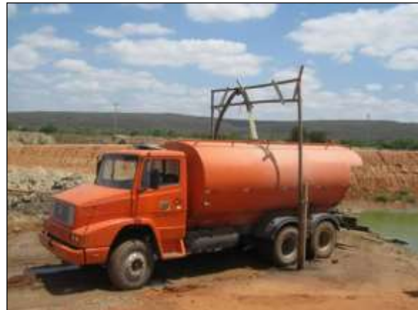
Foto 4.20 18. Esgotamento de água acumulada em área de implantação do segmento de canal - WBS 1233 para evitar possível proliferação de vetores e hospedeiros de doenças (set/2014).
