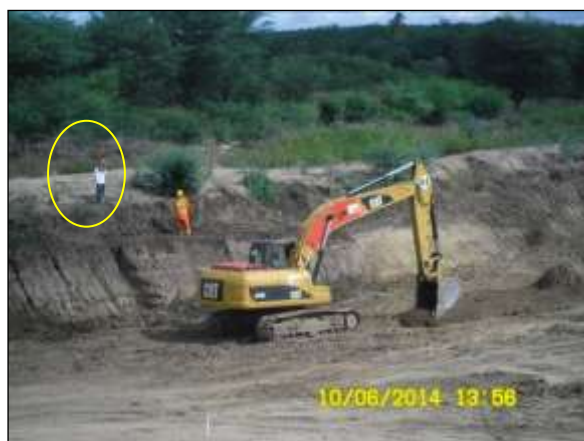
Foto 4.6 29. Acompanhamento de abertura de canal por técnico do INAPAS no WBS 2226, meta 2L/3L (jun/2014).
