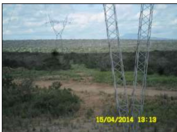
Foto 4.37.9. Verificação da estabilidade das superfícies adjacente às torres de transmissão próximas a subestação 0, Trecho V, Eixo Leste (abr/2014).
