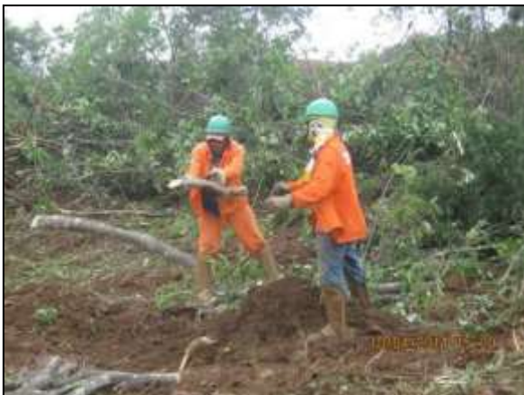
Foto 4.10 5. Segregação manual de material vegetal sectionado (abr/2014)
