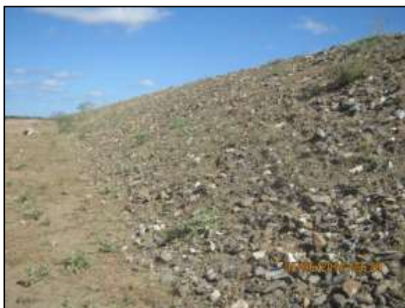
Foto 4.27 13. Talude estabilizado por enrocamento para dissipação de energia de águas drenadas superficialmente (jun/2014)
