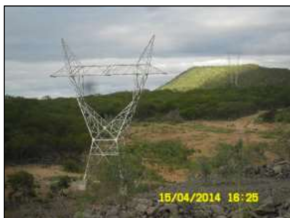
Foto 4.37.10. Verificação da estabilidade das superfícies adjacente às torres de transmissão próximas a EBV-4, Trecho V, Eixo Norte (abr/2014).
