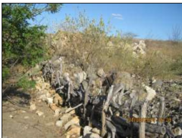
Foto 4.27 9. Cerca paliçada em consórcio com filtro de rocha como medida preventiva de carreamento de sedimentos (ago/2014).
