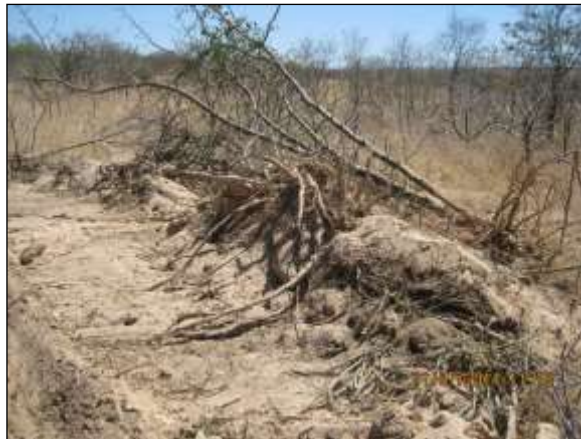
Foto 4.10 110. Armazenamento de expurgo nas margens da área suprimida (jul/2014).
