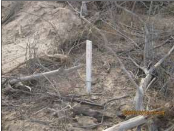
Foto 4.10 16. Delimitação da área a ser suprimida por estacas referenciadas (jun/2014).
