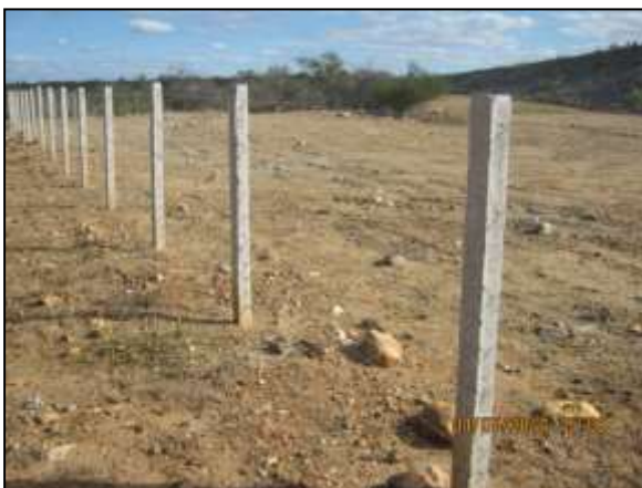
Foto 4.9.20. Cerca em bom estado de conservação, impedindo a entrada de animais domésticos na área de recuperação BF 04-BT (jul/2014).
