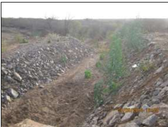
Foto 4.27 40. Enrocamento para estabilização dos taludes do canal de restituição (ago/2014).
