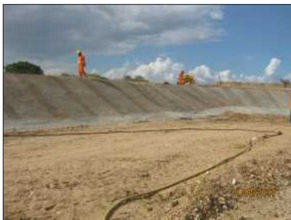
Foto 4.27 83. Aplicação de solo cimento em talude do túnel Monteiro como medida preventiva a ocorrência de processos erosivos (abr/2014).
