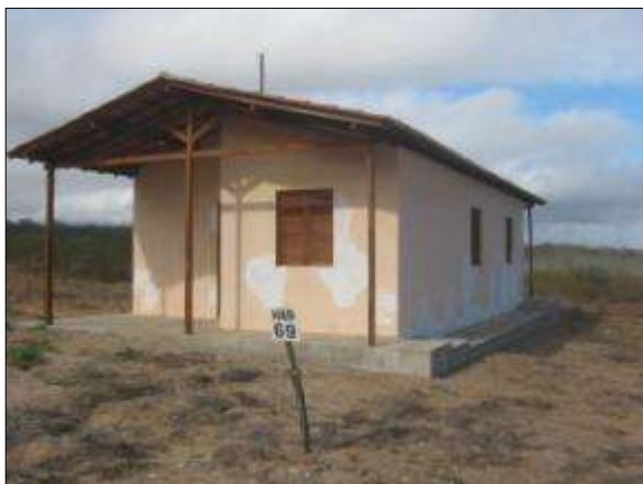
Foto 4.8.18. Acompanhamento das obras de construção do setor residencial da VPR Descanso, Mauriti - CE (ago/2014).
