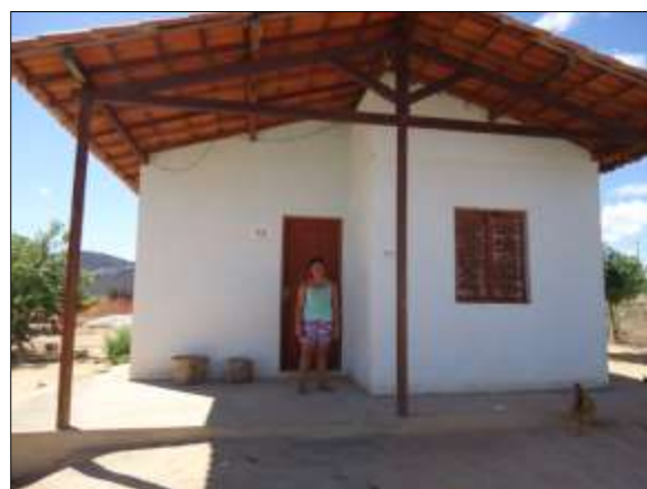
Foto 4.8.93. Acompanhamento social e verificação de permanência na VPR Uri, Salgueiro – PE (ago/2014).
