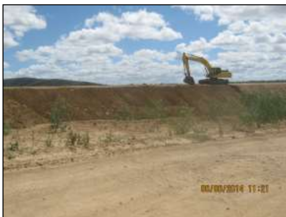
Foto 4.27 28. Reconformação e enrocamento de talude para prevenção de processos erosivos e carreamento de sedimentos (jun/2014).
