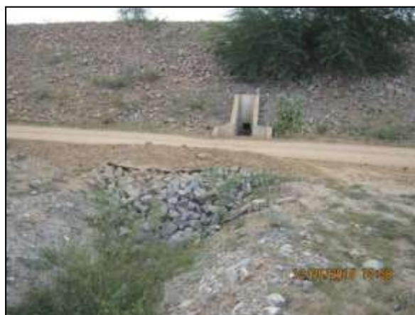
Foto 4.27 12. Enrocamento de talude de canal e cabeceira de drenagem para dissipação das águas drenadas superficialmente (maio/2014).
