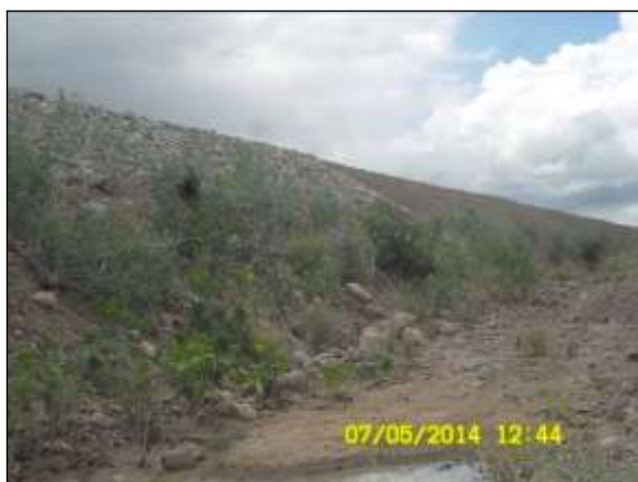
Foto 4.27 71. Enroncamento de talude como medida preventiva ao surgimento de processo erosivos no WBS 2205 (mai/2014).
