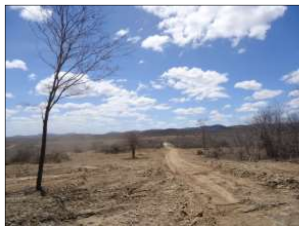
Foto 4.8.17. Acompanhamento das obras de construção do setor residencial da VPR Jurema, São José de Piranhas - PB (ago/2014).
