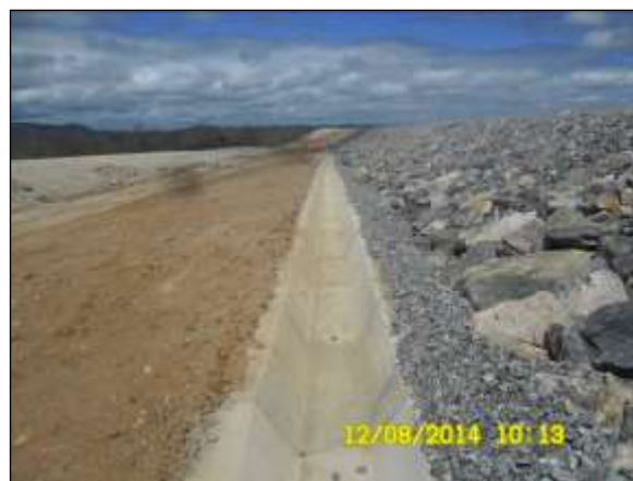
Foto 4.27 78. Execução de canaleta trapezoidal no barramento do reservatório Bagres (ago/2014)
