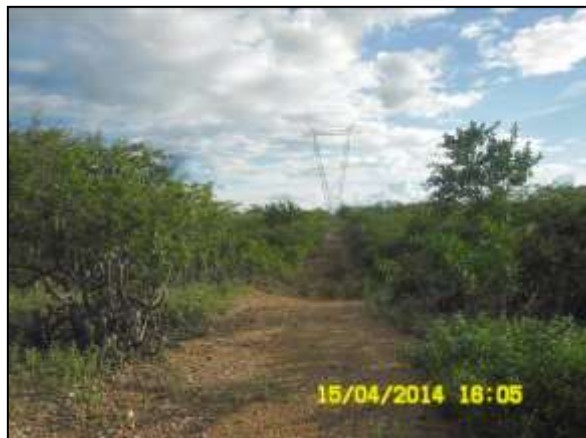
Foto 4.37.6. Monitoramento sistemático das áreas sob a linha de transmissão próxima à EBV-4, Trecho V, Eixo Leste (abr/2014).
