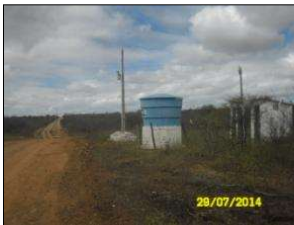
Foto 4.16. 21. Vista de infraestrutura elétrica que corta a área selecionada para implantação do projeto de irrigação no Assentamento Curralinhos Angicos, Floresta – PE (jul/2014).
