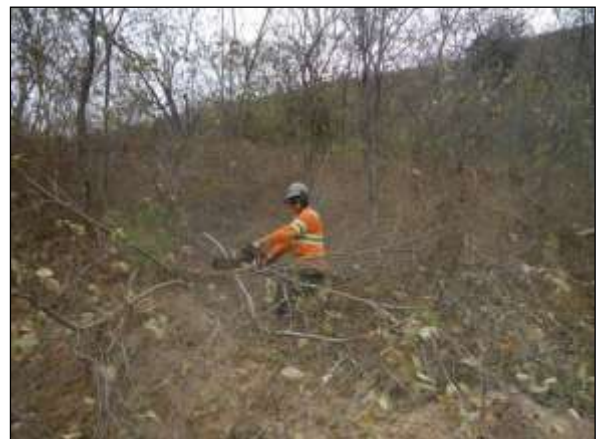
Foto 4.10 38. Supressão semimecanizada em via de acesso na área do reservatório Canabrava – WBS 1114 (jul/2014).
