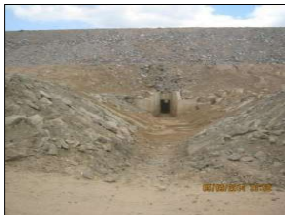
Foto 4.27 19. Talude de canal de adução e do sistema de drenagem adequadamente enrocado (set/2014).
