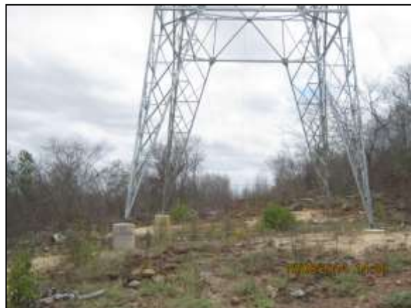
Foto 4.37.1. Verificação da estabilidade das superfícies adjacente às torres de transmissão próximas ao reservatório Serra do Livramento, Trecho I, Eixo Norte (ago/2014).
