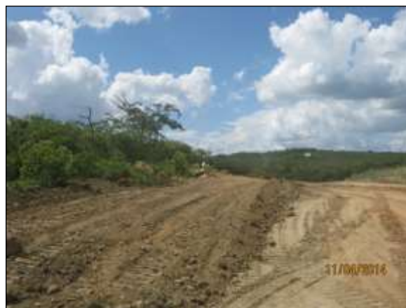
Foto 4.27 84. Espalhamento e reconformação topográfica em caixa de empréstimo na lateral da via de acesso do WBS 2226 (abr/2014).
