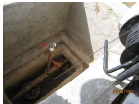
Foto 4.26.12. Mensuração do nível da água no poço 51, Monteiro - PB (ago/2014).
