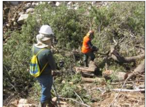
Foto 4.10 50. Supressão vegetal semimecanizada acompanhada pela equipe UNIVASF (ago/2014).
