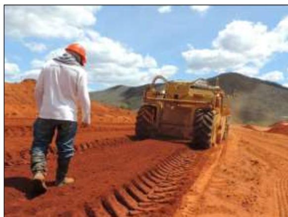
Foto 4.6 6. Acompanhamento de escavação de caixa de empréstimo, Res. Caiçara, Meta 3N (ago/2014).
