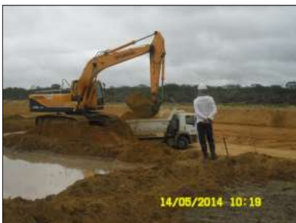
Foto 4.6 31. Abertura do canal adutor sendo acompanhada por técnico do INAPAS, Meta 1L/2L (maio/2014).
