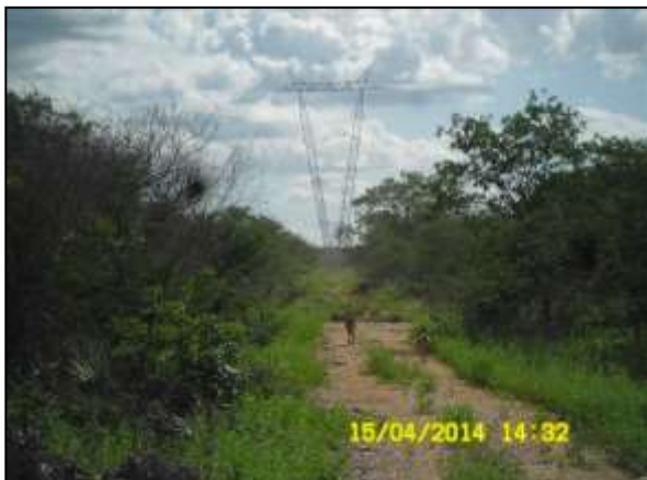
Foto 4.37.5. Monitoramento sistemático das áreas sob a linha de transmissão próxima à EBV-2, Trecho V, Eixo Leste (abr/2014).
