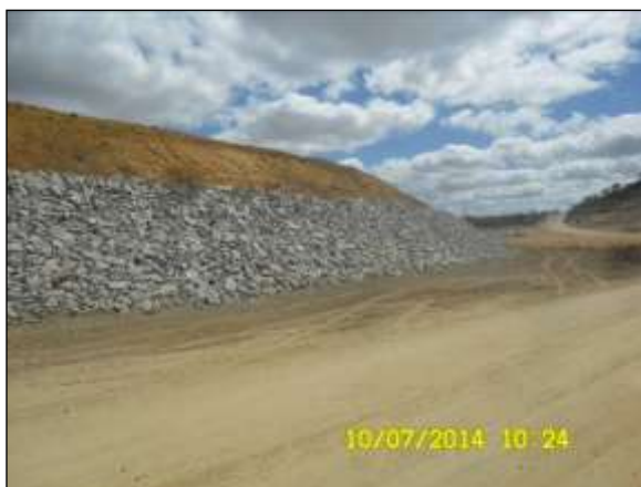
Foto 4.27 75. Enroncamento de talude no canal do WBS 2211 como medida preventiva ao surgimento de processos erosivos (jul/2014).
