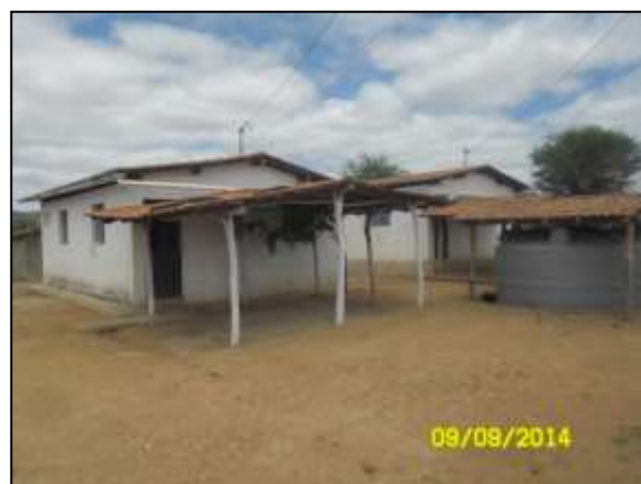
Foto 4.17 2. Casa concluída na comunidade quilombola Fazenda Santana, Cabrobó - PE (set/2014).
