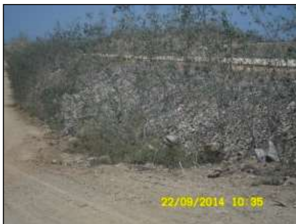
Foto 4.27 82. Enrocamento marginal da estrada de acesso (set/2014).
