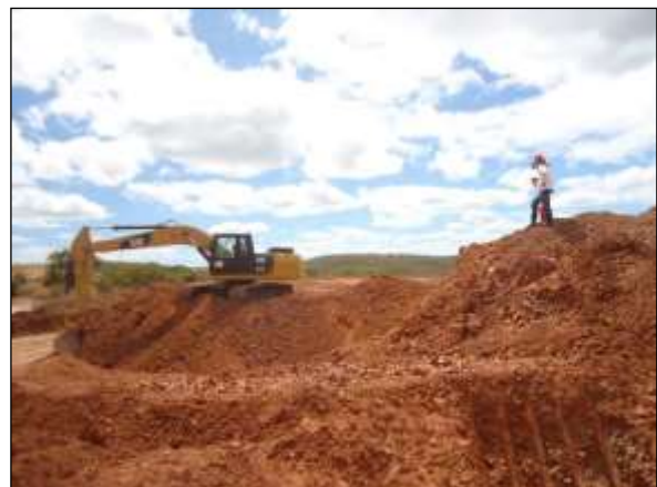
Foto 4.6 24. Equipe do INAPAS durante acompanhamento de atividade de escavação na jazida Balança, meta 2N (jul/2014).
