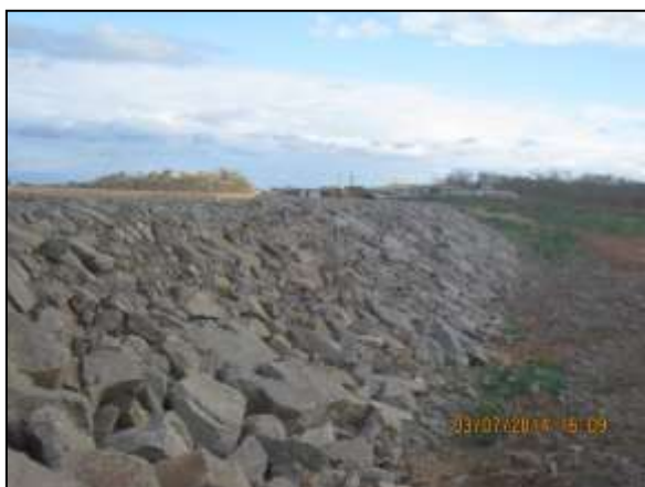
Foto 4.27 34. Enrocamento de talude de canal margeando estrada de serviço atuando como medida preventiva a processos erosivos (jul/2014).
