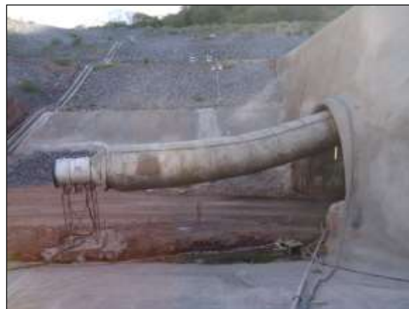
Foto 4.27 94. Talude enrocado e canaleta de escoamento pluvial adjacente ao espelho do túnel (jun/2014).
