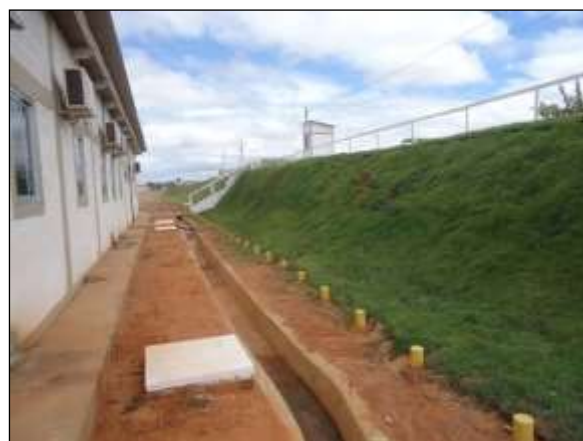
Foto 4.27 61. Canaleta de escoamento pluvial e talude revestido com gramínea para prevenção e controle de erosão (set/2014).
