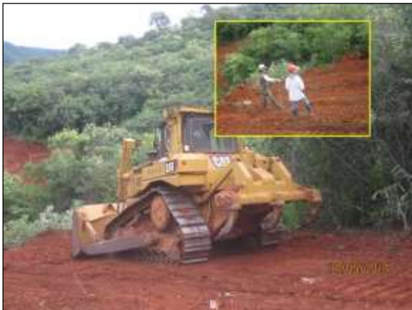
Foto 4.10 42. Supressão da vegetação mecanizada acompanhada pela equipe UNIVASF (maio/2014).
