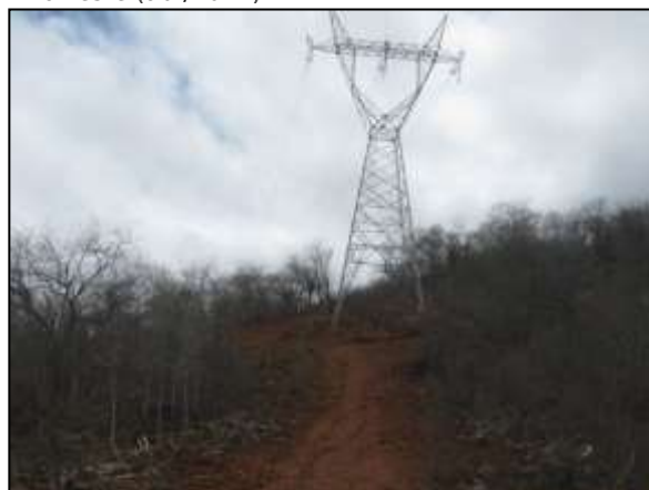
Foto 4.37.8. Monitoramento sistemático das áreas sob a linha de transmissão próxima ao reservatório Serra do Livramento, Trecho I, Eixo Norte (set/2014).
