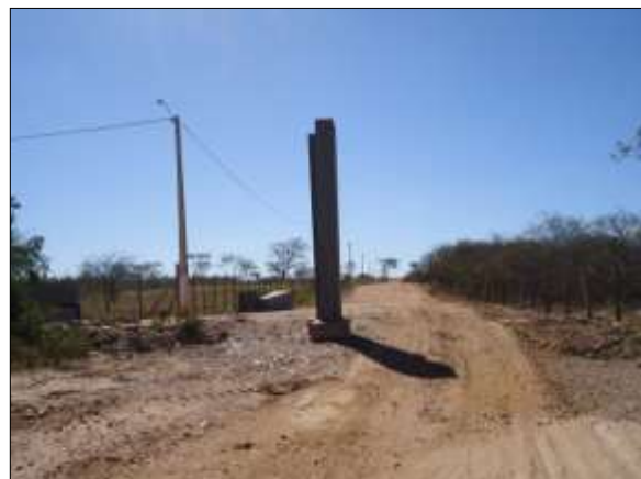
Foto 4.8.4. Vista parcial das instalações do pórtico de entrada da VPR Pilões (jul/2014).
