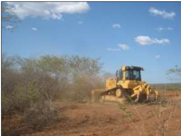
Foto 4.10 65. Supressão vegetal mecanizada na área da jazida 14 (set/2014).
