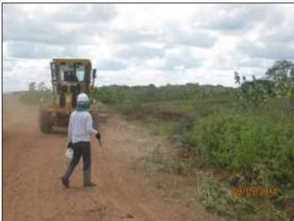
Foto 4.10 55. Supressão mecanizada e remoção de "top soil" acompanhada por técnico especializado do CEMAFAUNA para possíveis resgates (maio/2014).
