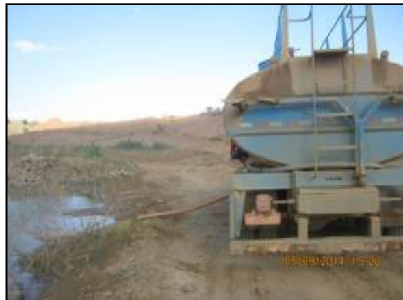
Foto 4.20 20. Esgotamento de acúmulo de água em jazida no reservatório Mangueira, para evitar possível proliferação de vetores e hospedeiros de doenças (set/2014).
