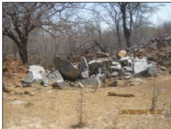
Foto 4.27 41. Deposição de rocha nos limites da faixa de servidão como medida de prevenção ao carreamento de sedimentos (set/2014).
