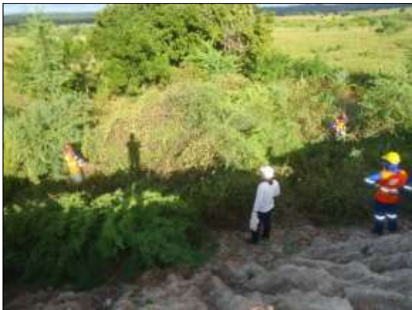
Foto 4.10 57. Supressão semimecanizada acompanhada pela equipe especializada do CEMAFAUNA para possíveis resgates (jun/2014).
