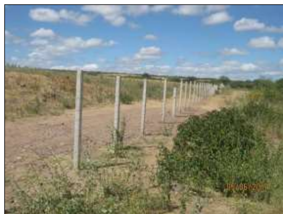
Foto 4.9.23. Cerca instalada em bom estado de conservação (jun/2014).
