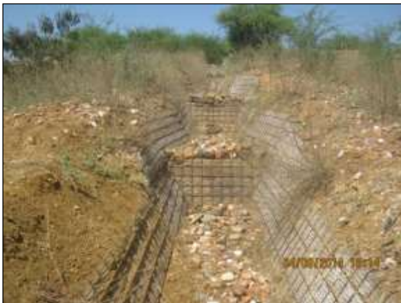
Foto 4.9.13. Ecolalha com dissipadores de energia implantada na área de recuperação BF 06-CN (set/2014).
