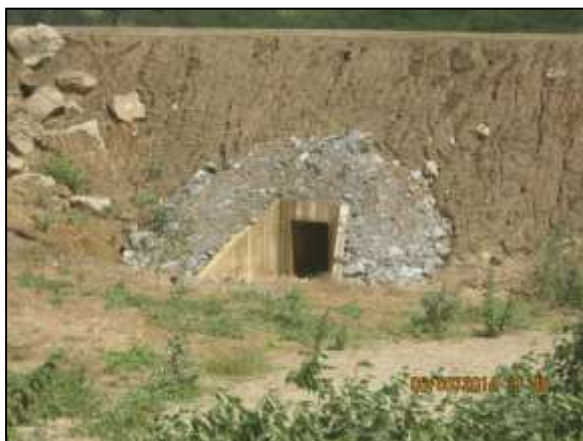
Foto 4.27 30. Início de enrocamento em talude de cabeceira de bueiro para estabilização topográfica (jun/2014).
