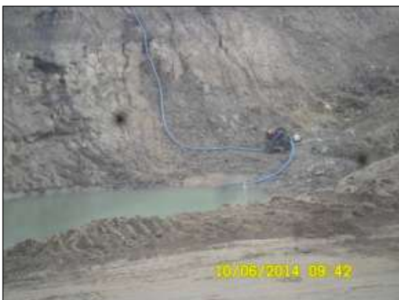
Foto 4.20 9. Esgotamento de água na área de escavação do canal para evitar possível proliferação de vetores e hospedeiros de doenças (jun/2014).
