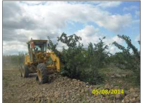
Foto 4.10 2. Supressão mecanizada no WBS 2205 (ago/2014).
