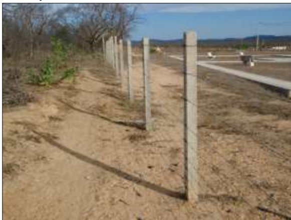
Foto 4.8.29. Vista parcial da cerca de delimitação da área da VPR Negreiros (ago/2014).
