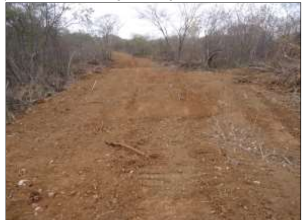
Foto 4.8.32. Vias de acesso dos setores residenciais e produtivo da VPR Queimada Grande (ago/2014).
