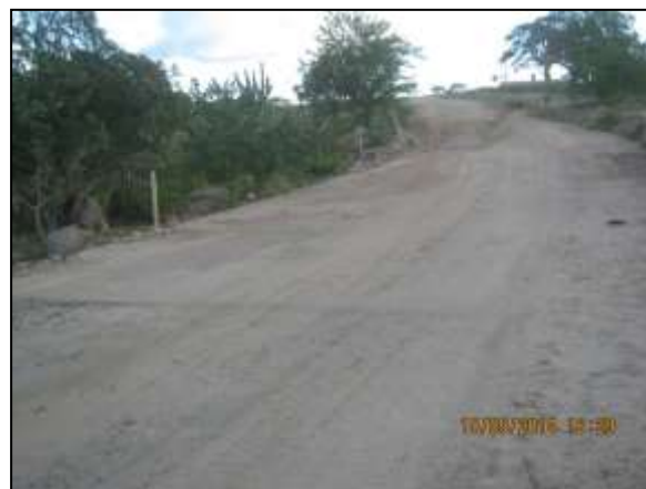
Foto 4.27 69. Passagem molhada implantada em estrada de acesso ao bota-fora na área do reservatório Negreiros (mai/2014).
