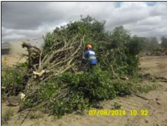
Foto 4.10 96. Supressão semimecanizada no segmento de canal WBS 2227 (ago/2014).
