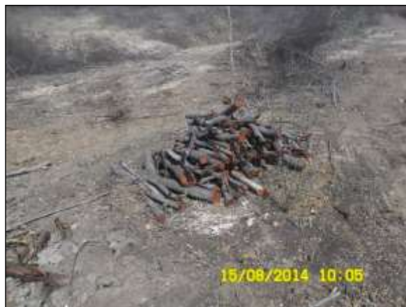
Foto 4.10 91. Enleiramento de material oriundo de supressão semimecanizada (ago/2014).
