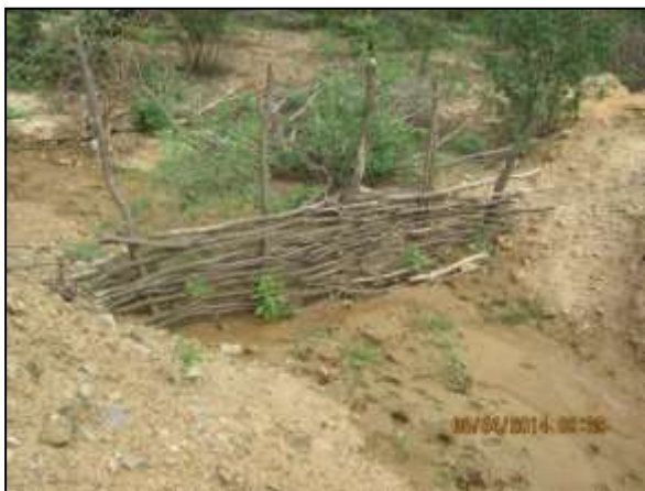
Foto 4.27 46. Cerca paliçada implantada como medida preventiva ao carreamento de sedimentos (abr/2014).
