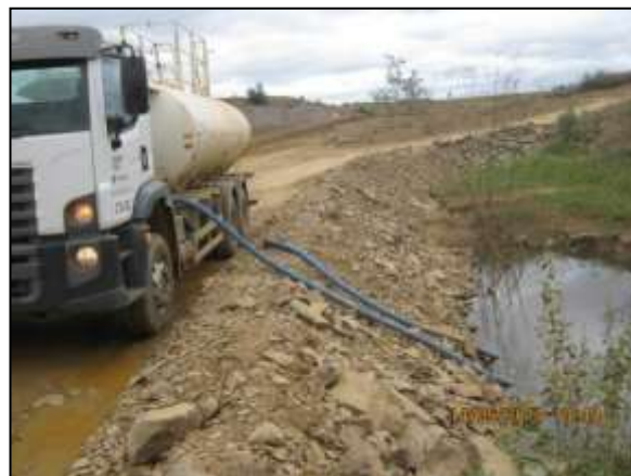
Foto 4.20 6. Esgotamento de acúmulo de água às margens da via de acesso para evitar possível proliferação de vetores e hospedeiros de doenças (maio/2014).
