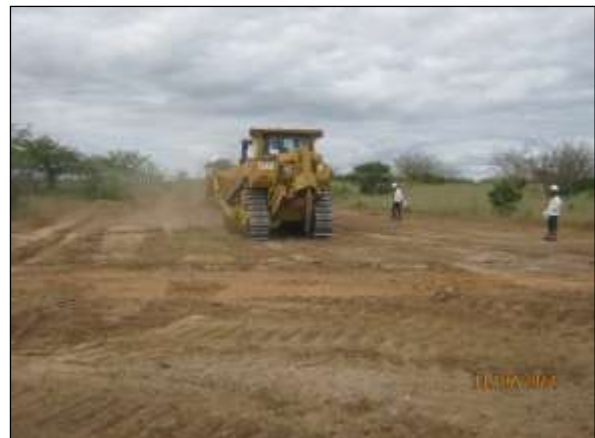
Foto 4.10 71. Supressão mecanizada e remoção de "top soil" acompanhada por técnico especializado do CEMAFAUNA para possíveis resgates (jun/2014).
