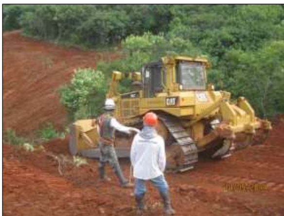
Foto 4.6 25. Técnico do INAPAS acompanhando atividade de supressão vegetal em área do reservatório Caiçara – WBS 1120, Meta 3N (maio/2014).
