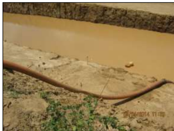
Foto 4.20 2. Esgotamento de água acumulada na escavação do canal para evitar possível proliferação de vetores e hospedeiros de doenças (abr/2014).
