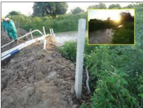
Foto 4.20 1. Esgotamento de água em área de implantação do segmento de canal – WBS 1234 para evitar possível proliferação de vetores e hospedeiros de doenças (abr/2014).
