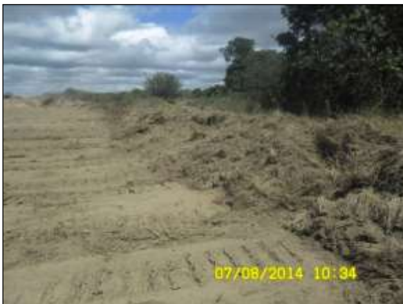
Foto 4.10 98. Expurgo armazenado nas margens da área suprimida do canal WBS 2227 (ago/2014).
