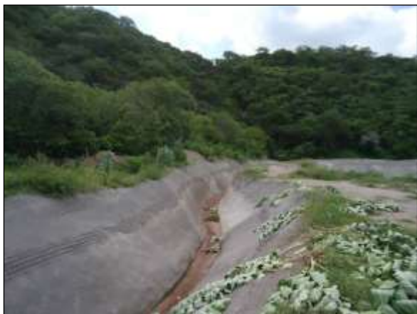
Foto 4.27 93. Canaleta de direcionamento do escoamento pluvial revestida de concreto projetado como medida preventiva (abr/2014).
