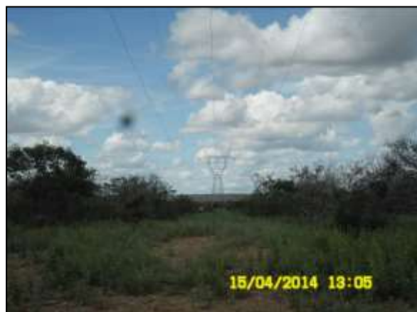
Foto 4.37.2. Verificação do revestimento vegetal na faixa de servidão da LT próximo a subestação O Trecho V (abr/2014).
