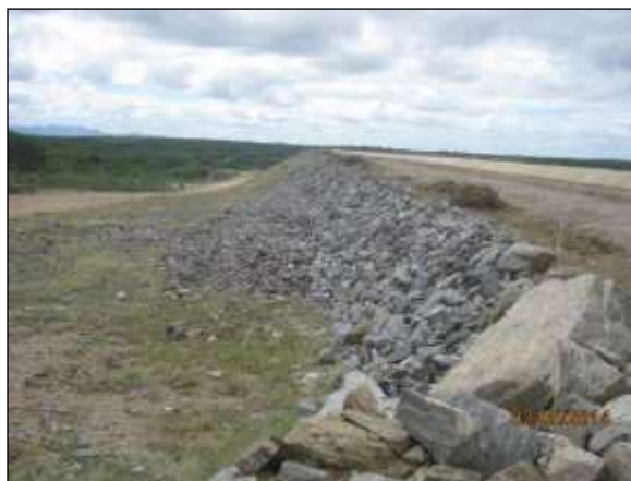
Foto 4.27 79. Enrocamento para proteção de talude e contenção de carreamento de sedimentos no WBS 2219 (maio/2014).
