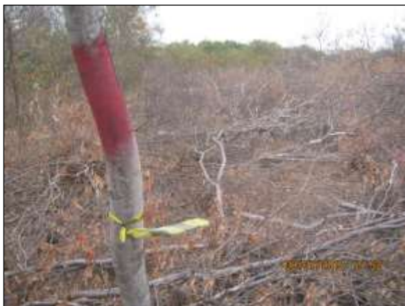
Foto 4.10 116. Delimitação por estaca do perímetro de supressão da vegetação na área da VPR Retiro (jul/2014).
