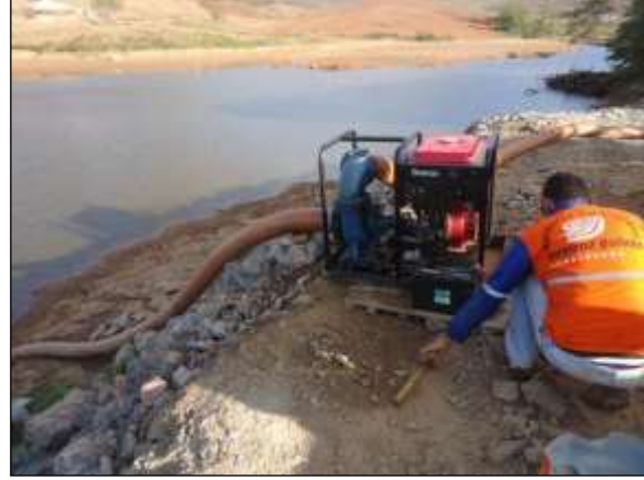
Foto 4.20 14. Esgotamento de água acumulada em área de implantação do reservatório Caiçara para evitar possível proliferação de vetores e hospedeiros de doenças (ago/2014).
