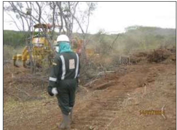
Foto 4.10 90. Supressão mecanizada acompanhada pela equipe especializada do CEMAFAUNA para possíveis resgates (jul/2014).
