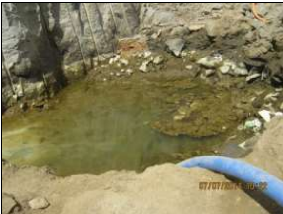
Foto 4.20 11. Acúmulo de água na área de implantação da estação de bombeamento EBI-02 sendo esgotado para evitar possível proliferação de vetores e hospedeiros de doenças (jul/2014).
