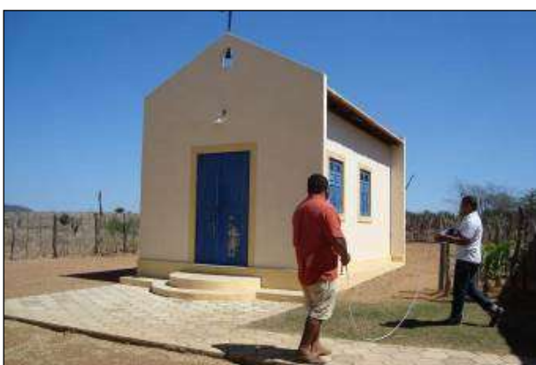
Foto 4.7 49. Vistoria complementar na VPR de Lafayette no município de Monteiro-PB (set/2014).
