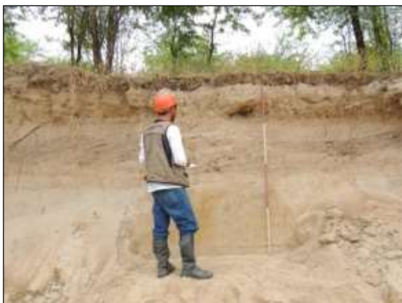
Foto 4.6 7. Acompanhamento de escavação da jazida Areal do Urubu, Meta 1N (jun/2014).
