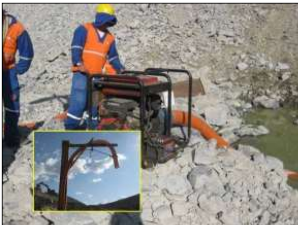
Foto 4.20 17. Esgotamento de água acumulada em área de implantação do segmento de canal - WBS 1235 para evitar possível proliferação de vetores e hospedeiros de doenças (set/2014).
