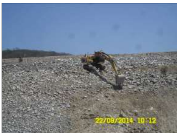
Foto 4.27 83. Aplicação de solo cimento em talude do túnel Monteiro como medida preventiva a ocorrência de processos erosivos (abr/2014).
