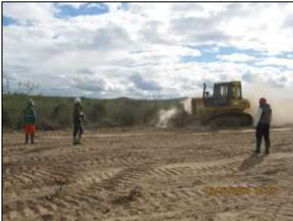
Foto 4.6 21. Técnicos do INAPAS durante acompanhamento das atividades de supressão vegetal mecanizada na área de formação do reservatório Tucutu – WBS 1105, meta 1N (jul/2014).
