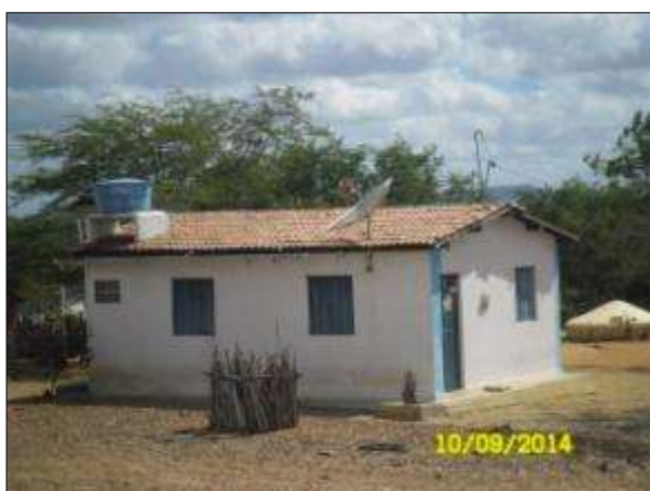
Foto 4.17 1. Casa concluída e habitada, comunidade quilombola Cruz dos Riachos Cabrobó - PE (set/2014).
