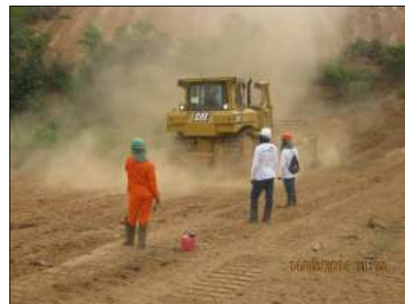
Foto 4.6 18. Acompanhamento de supressão vegetal por técnicos do INAPAS na frente de serviço do reservatório Milagres – WBS 1110, Meta 1N (maio/2014).
