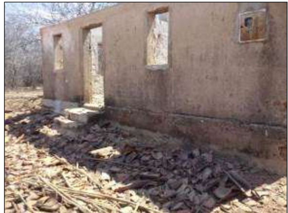
Foto 4.7 60. Visita ao Lote 07, junto a ENERGISA nas propriedades ainda com energia elétrica (set/2014).
