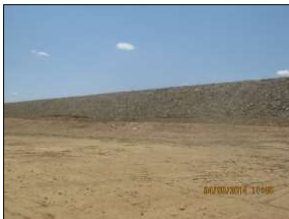
Foto 4.27 10. Talude de canal enrocado e faixa marginal ao canal de adução (set/2014).
