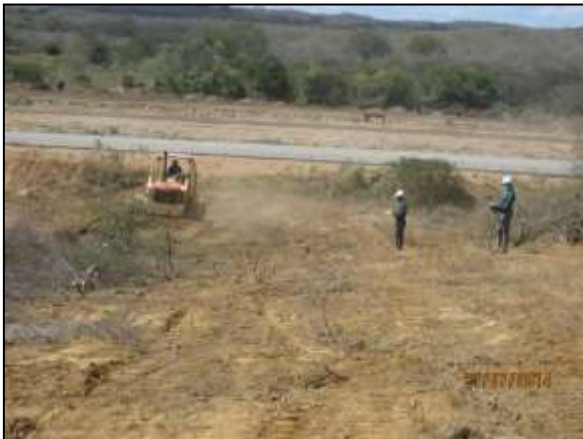
Foto 4.10 92. Supressão mecanizada acompanhada pela equipe especializada do CEMAFAUNA para possíveis resgates (jul/2014).
