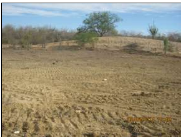
Foto 4.27 18. Faixa marginal ao canal de adução reconformada (ago/2014).
