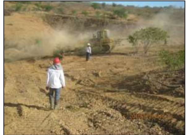
Foto 4.10 23. Remoção de expurgo e da camada orgânica do solo com acompanhamento do CEMAFAUNA para possíveis resgates de fauna (jun/2014).
