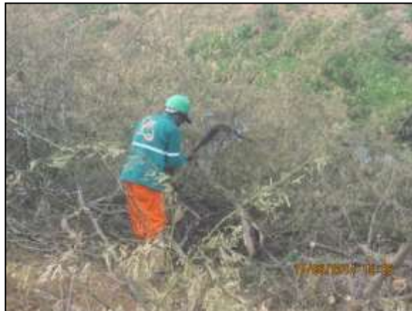
Foto 4.10 9. Atividade de supressão manual em área do reservatório Milagres (jun/2014).
