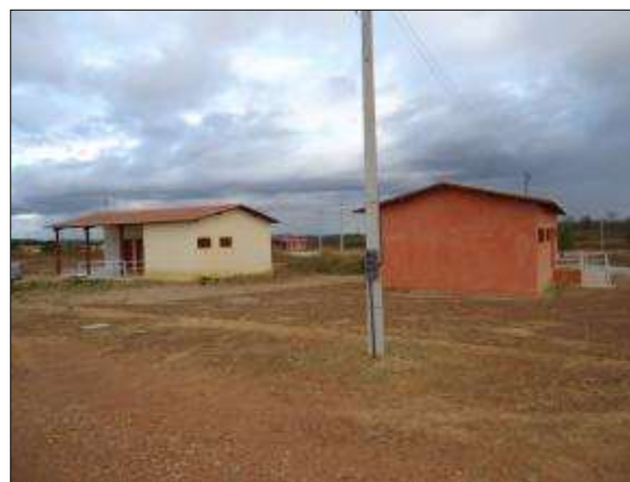
Foto 4.8.2. Vista parcial do posto de saúde e sede da associação da VPR Malícia (jul/2014).
