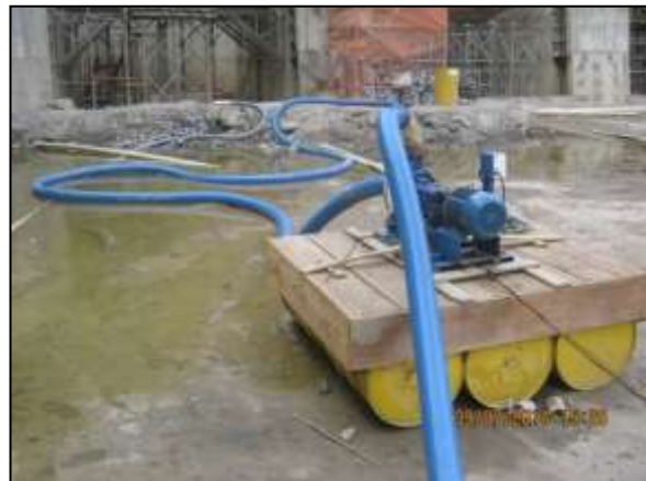
Foto 4.20 12. Esgotamento de água na área de implantação da estação de bombeamento EBI-03, para evitar possível proliferação de vetores e hospedeiros de doenças (jul/2014).
