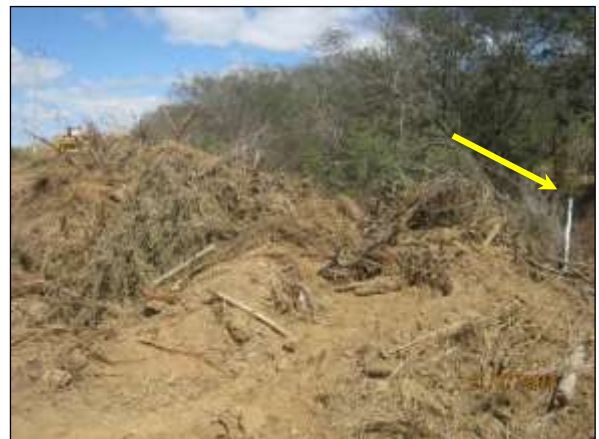
Foto 4.10 95. Expurgo armazenado no limite da área a ser suprimida delimitada por estaca (jul/2014)
