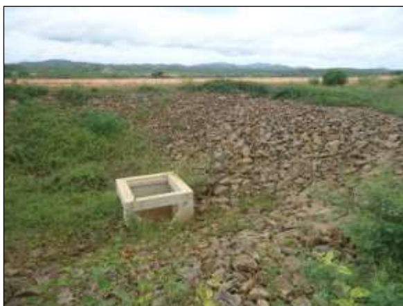
Foto 4.27 62. Enrocamento com material de 3ª categoria nas adjacências da caixa de passagem para prevenção e controle de processo erosivo (abr/2014).
