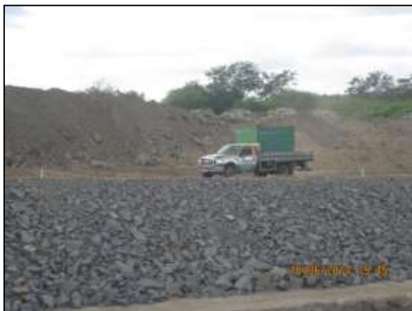
Foto 4.27 32. Medida de proteção contra processos erosivos com enrocamento do talude margeando estrada de serviço (jun/2014).
