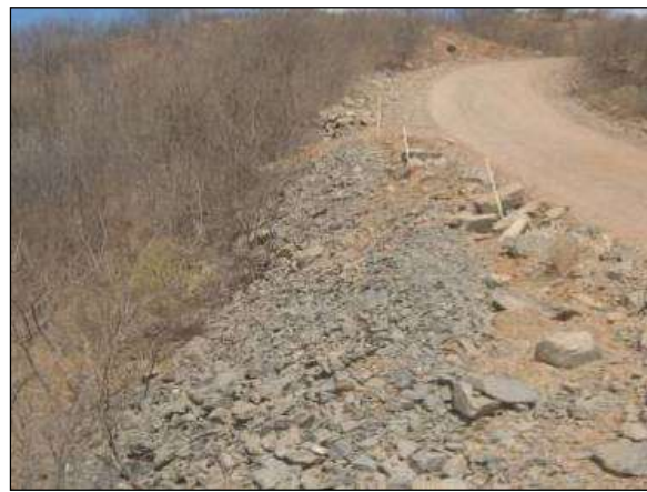
Foto 4.27 92. Talude da Estrada de acesso enrocado para prevenção e controle de processos erosivos (ago/2014).
