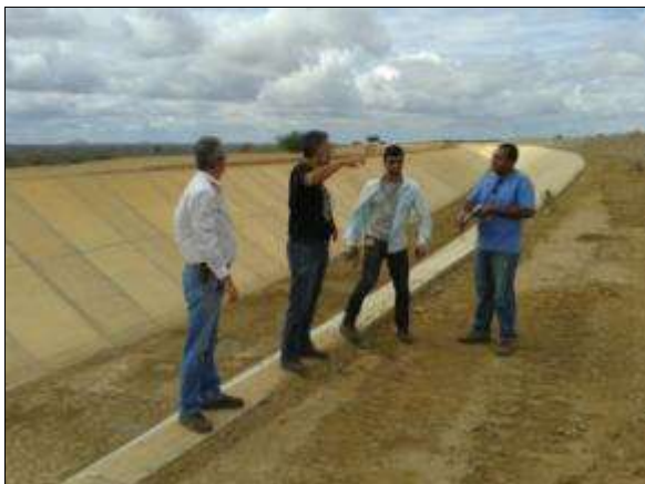
Foto 4.16. 19. Visita com os técnicos da CODEVASF no local onde será implantada a tomada d'água do Projeto de Assentamento Riacho dos Bois, Cabrobó – PE (jul/2014).
