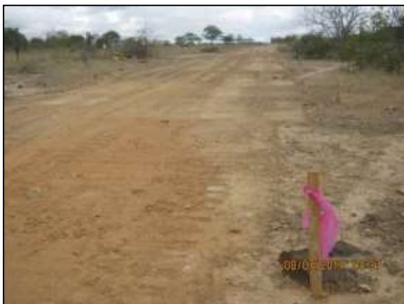
Foto 4.10 104. Delimitação da área de supressão vegetal por meio de fita sinalizadora (jul/2014).
