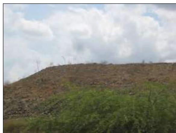
Foto 4.27 65. Talude externo do canal enrocado para prevenção de processos erosivo apresentando estabelecimento de vegetação (set/2014).
