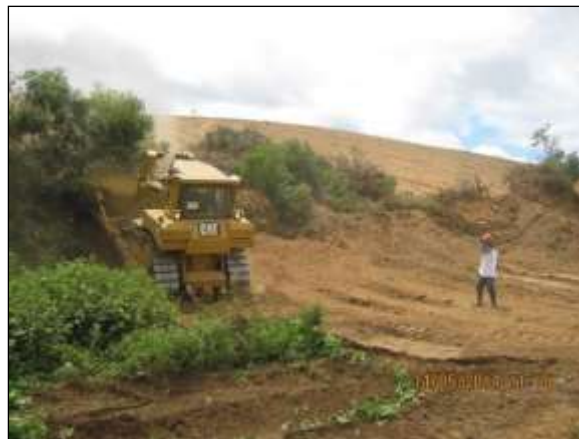
Foto 4.6 20. Técnico do INAPAS durante acompanhamento de supressão vegetal mecanizada na área do reservatório Milagres – WBS 1110, Meta 1N (maio/2014).
