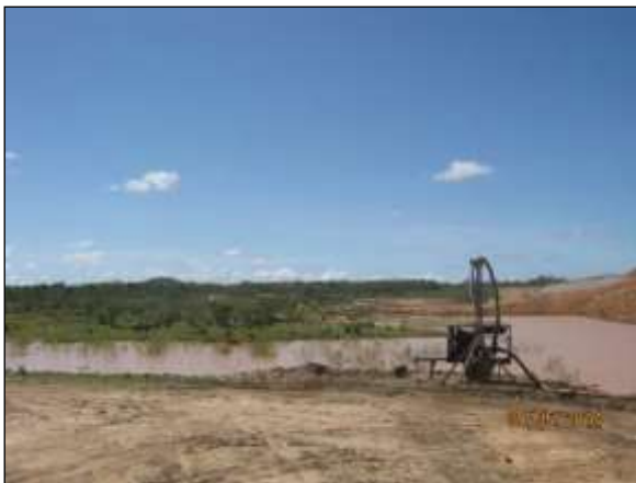
Foto 4.20 3. Esgotamento de água em caixa de empréstimo para evitar possível proliferação de vetores e hospedeiros de doenças (maio/2014).
