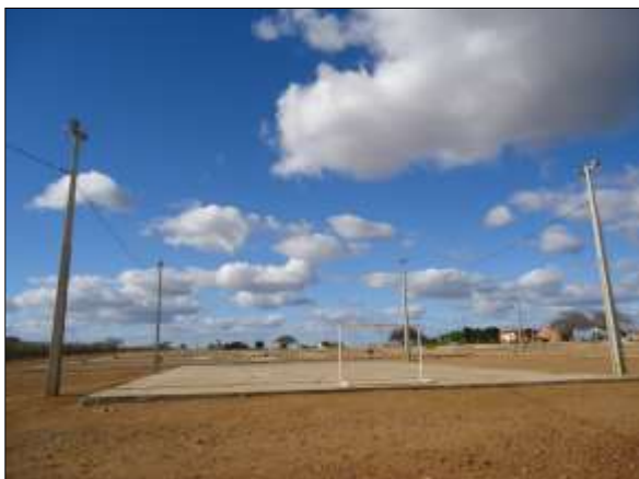
Foto 4.8.3. Vista parcial da quadra poliesportiva da VPR Baixo dos Grandes (jul/2014).
