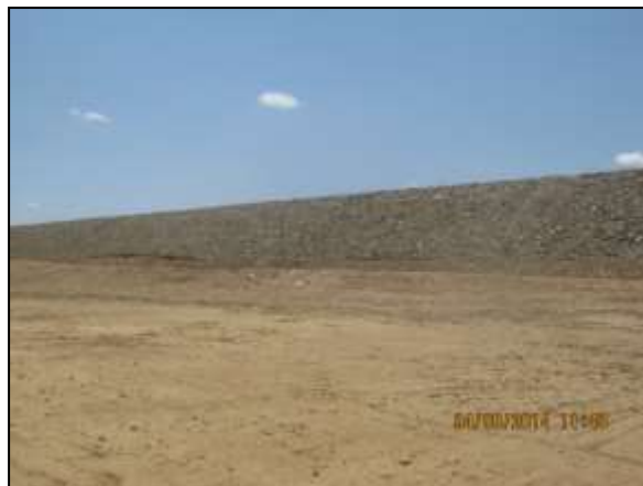
Foto 4.27 10. Talude de canal enrocado e faixa marginal ao canal de adução (set/2014).
