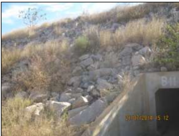
Foto 4.27 54. Enrocamento de talude de canal em cabeceira de drenagem para dissipação das águas drenadas superficialmente (jul/2014).
