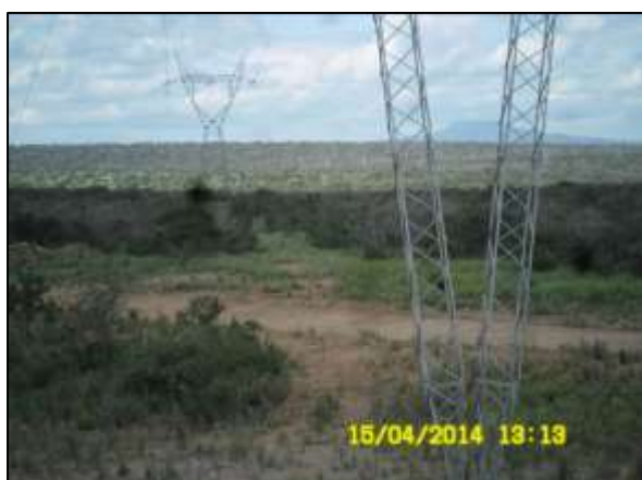
Foto 4.37.9. Verificação da estabilidade das superfícies adjacente às torres de transmissão próximas a subestação 0, Trecho V, Eixo Leste (abr/2014).
