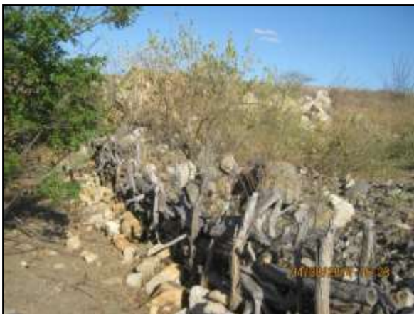
Foto 4.27 9. Cerca paliçada em consórcio com filtro de rocha como medida preventiva de carreamento de sedimentos (ago/2014).
