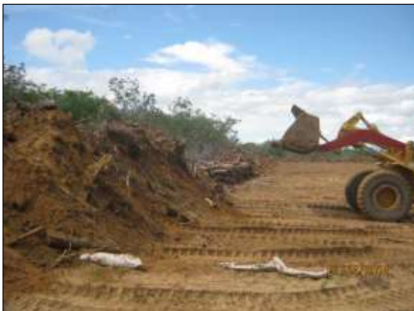
Foto 4.10 73. Disposição de expurgo às margem da área suprimida (abr/2014).
