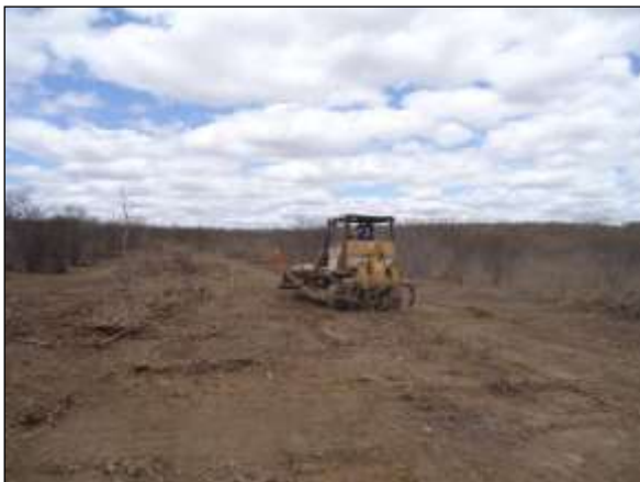
Foto 4.10 129. Supressão mecanizada em área da VPR Jurema, acompanhada por equipe treinada pela UNIVASF para o resgate e afugentamento da fauna (set/2014).
