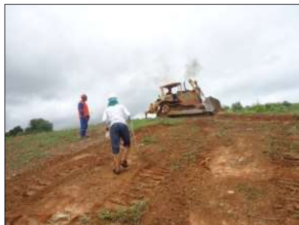
Foto 4.10 45. Supressão vegetal mecanizada acompanhada por técnicos especializados em resgate de fauna da UNIVASF (abr/2014).
