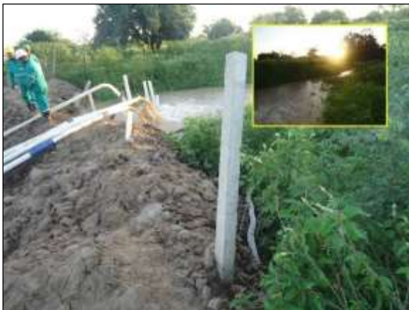
Foto 4.20 1. Esgotamento de água em área de implantação do segmento de canal – WBS 1234 para evitar possível proliferação de vetores e hospedeiros de doenças (abr/2014).
