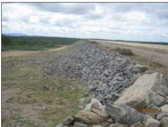
Foto 4.27 79. Enrocamento para proteção de talude e contenção de carreamento de sedimentos no WBS 2219 (maio/2014).
