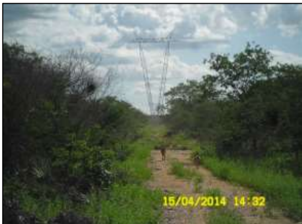
Foto 4.37.5. Monitoramento sistemático das áreas sob a linha de transmissão próxima à EBV-2, Trecho V, Eixo Leste (abr/2014).
