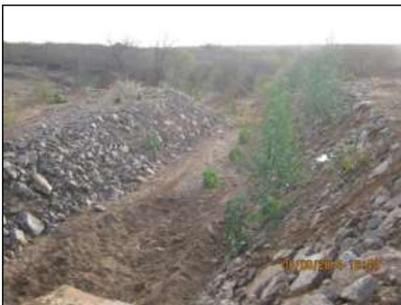
Foto 4.27 40. Enrocamento para estabilização dos taludes do canal de restituição (ago/2014).
