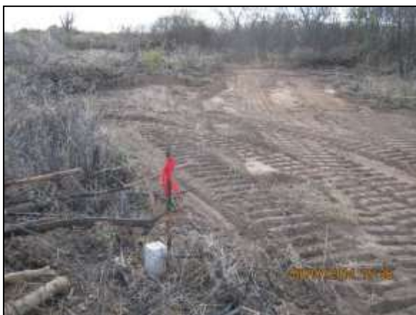
Foto 4.10 106. Delimitação da área a ser suprimida por estacas referenciadas na VPR Uri (jul/2014).
