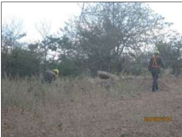
Foto 4.10 1. Colaboradores do exército realizando demarcação da área a ser suprimida (jun/2014).
