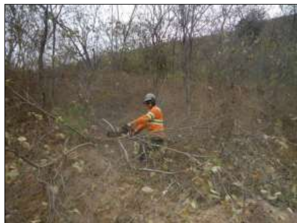
Foto 4.10 38. Supressão semimecanizada em via de acesso na área do reservatório Canabrava – WBS 1114 (jul/2014).
