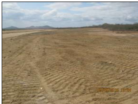
Foto 4.27 23. Faixa marginal ao canal adequadamente reconformada (set/2014).
