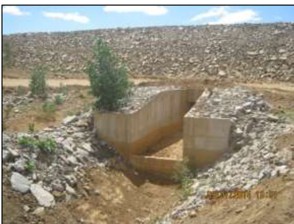
Foto 4.27 44. Medida de proteção contra processos erosivos com enrocamento do talude em cabeceira de sistema de drenagem (jul/2014).
