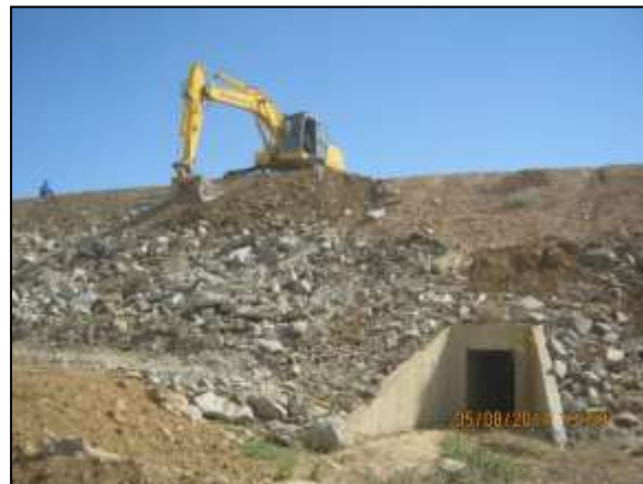
Foto 4.27 14. Enrocamento de talude de canal para estabilização e a dissipação de energia de águas pluviais (ago/2014).
