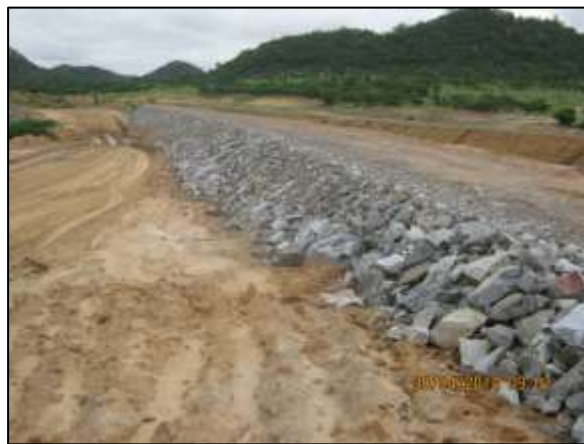
Foto 4.27 47. Enrocamento de talude de canal para dissipação das águas drenadas superficialmente (abr/2014).
