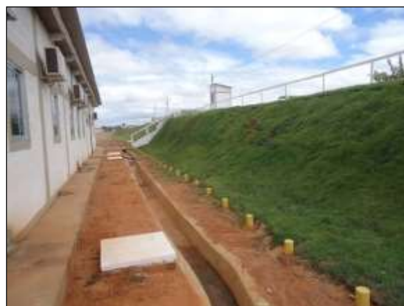
Foto 4.27 61. Canaleta de escoamento pluvial e talude revestido com gramínea para prevenção e controle de erosão (set/2014).
