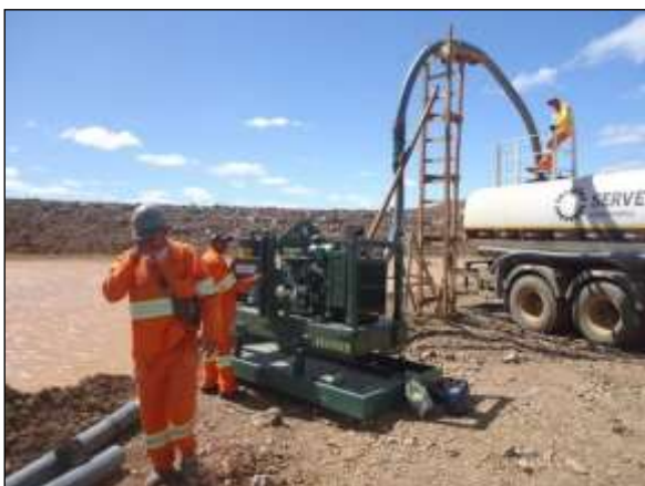
Foto 4.20 13. Esgotamento de água acumulada em área de implantação do reservatório Jati para evitar possível proliferação de vetores e hospedeiros de doenças (jul/2014).
