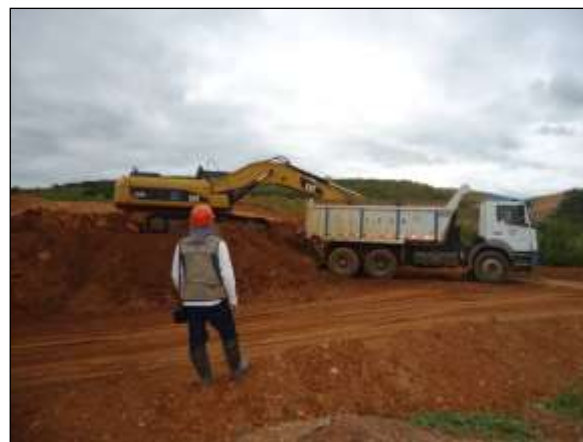
Foto 4.6 26. Técnico do INAPAS acompanhando atividade de escavação no reservatório Jati – WBS 111, meta 2N (maio/2014).
