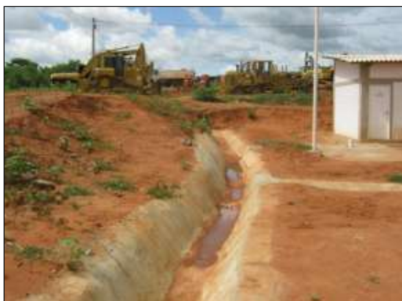
Foto 4.27 58. Canaletas de escoamento pluvial na base do talude para prevenção de erosão (abr/2014).
