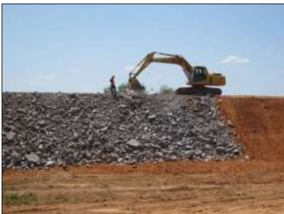
Foto 4.27 66. Enrocamento nos taludes externos do segmento de canal para prevenção e controle de processos erosivos (set/2014).
