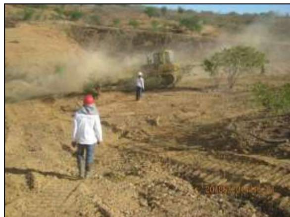
Foto 4.10 23. Remoção de expurgo e da camada orgânica do solo com acompanhamento do CEMAFAUNA para possíveis resgates de fauna (jun/2014).
