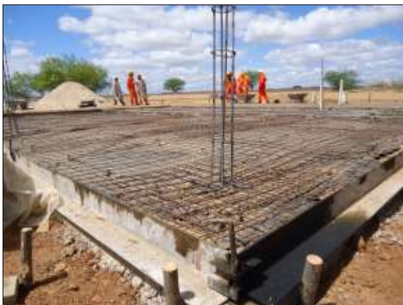
Foto 4.8.14. Acompanhamento das obras de construção do setor residencial da VPR Retiro, Penaforte - CE (ago/2014).
