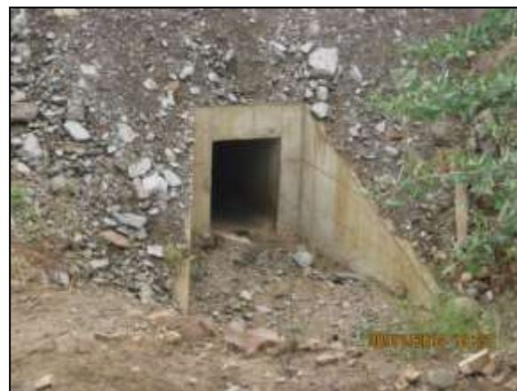
Foto 4.27 31. Enrocamento em talude de cabeceira de bueiro para estabilização topográfica (jul/2014).
