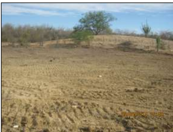
Foto 4.27 18. Faixa marginal ao canal de adução reconformada (ago/2014).
