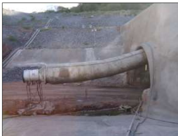
Foto 4.27 94. Talude enrocado e canaleta de escoamento pluvial adjacente ao espelho do túnel (jun/2014).
