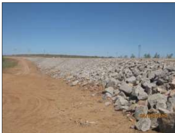
Foto 4.27 73. Enrocamento do talude de aterro no WBS 2205 como medida preventiva ao surgimento de processos erosivos (ago/2014).
