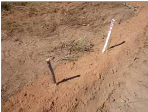
Foto 4.10 33. Delimitação da área a ser suprimida por estacas referenciadas (jul/2014).
