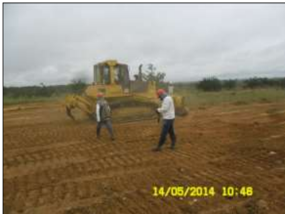
Foto 4.10 79. Supressão mecanizada acompanhada pela equipe especializada do CEMAFAUNA para possíveis resgates (maio/2014).
