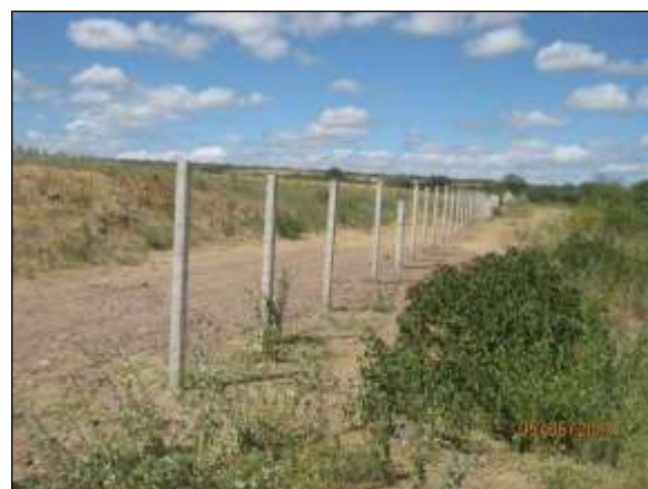
Foto 2.9.23. Cerca instalada em bom estado de conservação (jun/2014).
