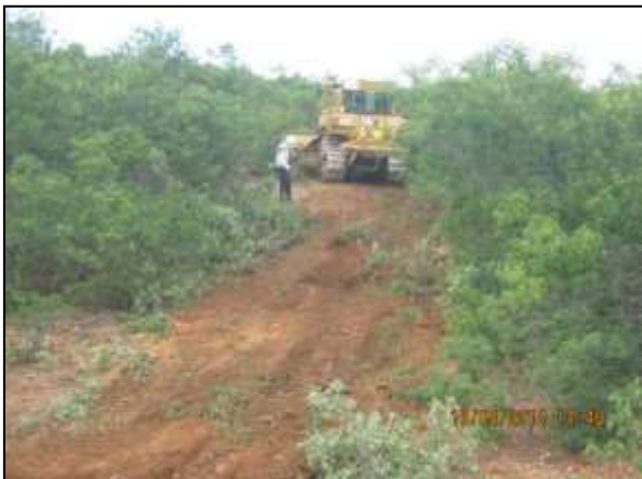
Foto 4.10 3. Delimitação mecanizada dos talhões de supressão vegetal com acompanhamento CEMAFAUNA (abr/2014)
