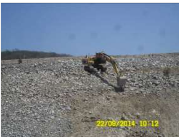
Foto 4.27 83. Aplicação de solo cimento em talude do túnel Monteiro como medida preventiva a ocorrência de processos erosivos (abr/2014).
