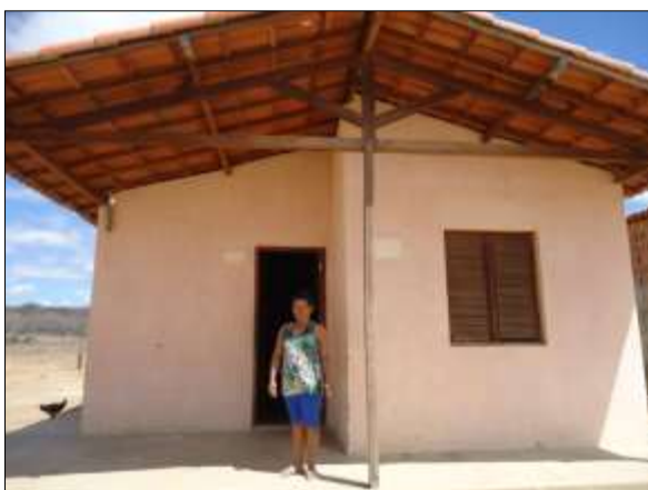
Foto 4.8.90. Acompanhamento social e verificação de permanência na VPR Captação, Cabrobó – PE (ago/2014).
