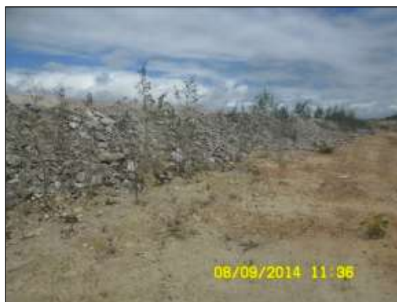
Foto 4.27 76. Enrocamento do talude de aterro no WBS 2212 como medida preventiva a ocorrência de processos erosivos (set/2014).
