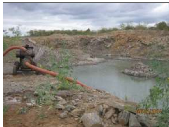
Foto 4.20 10. Esgotamento de água acumulada em caixa de empréstimo (jul/2014).
