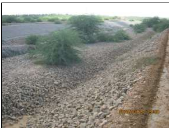
Foto 4.27 1. Canal de escoamento revestido por enrocamento na margem da estrada de acesso do canal de aproximação (mai/2014).
