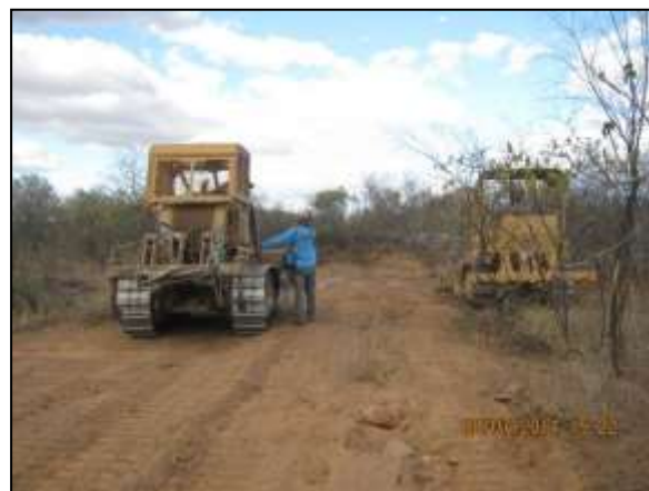
Foto 4.10 107. Supressão mecanizada e remoção de "top soil" acompanhada por técnico especializado do CEMAFAUNA para possíveis resgates (jul/2014)
