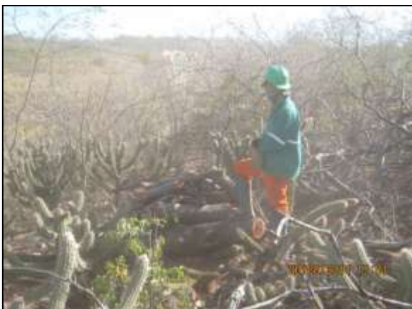
Foto 4.10 24. Segregação manual de material lenhoso oriundo da supressão vegetal do reservatório Mangueira (jun/2014)
