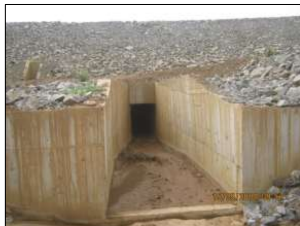
Foto 4.27 43. Enrocamento de talude implantado adjacente a sistema drenagem como medida preventiva e de controle (maio/2014).
