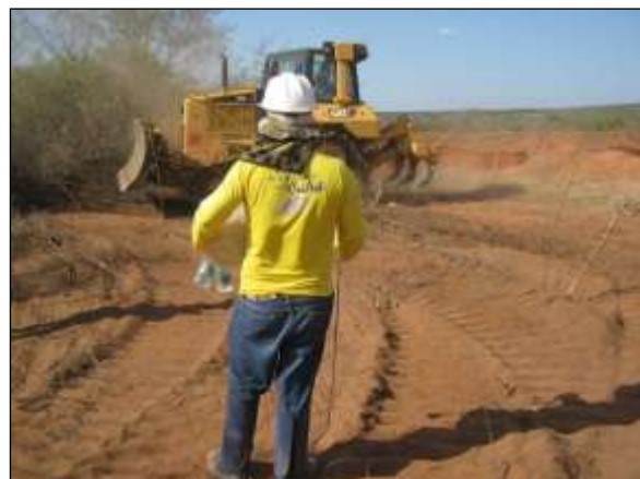
Foto 4.10 66. Técnico da UNIVASF acompanhando supressão vegetal mecanizada (set/2014).
