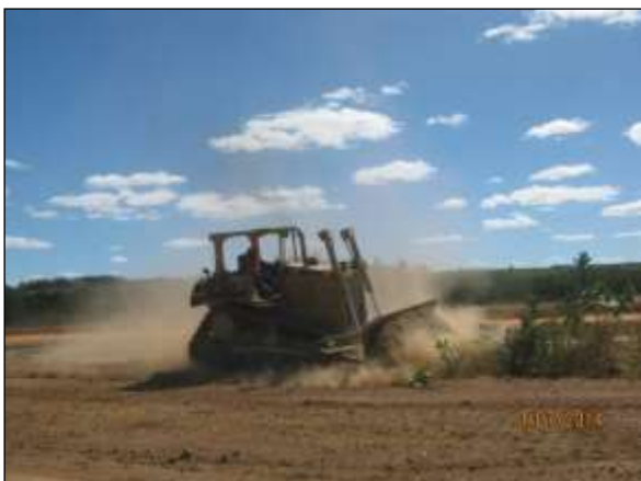
Foto 4.10 61. Supressão vegetal mecanizada (limpeza) na faixa de domínio do canal – WBS 1232 (jul/2014).
