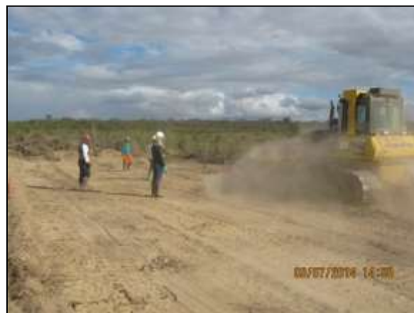
Foto 4.6 22. Acompanhamento de atividade de supressão vegetal mecanizada por técnicos do INAPAS na área de formação do reservatório Tucutu – WBS 1105, meta 1N (jul/2014).
