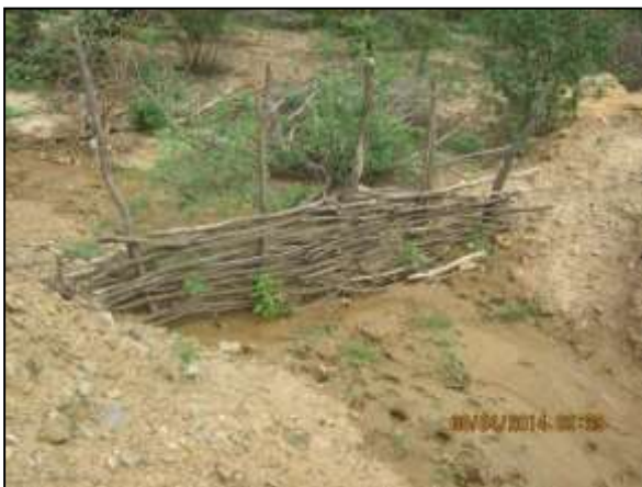
Foto 4.27 46. Cerca paliçada implantada como medida preventiva ao carreamento de sedimentos (abr/2014).
