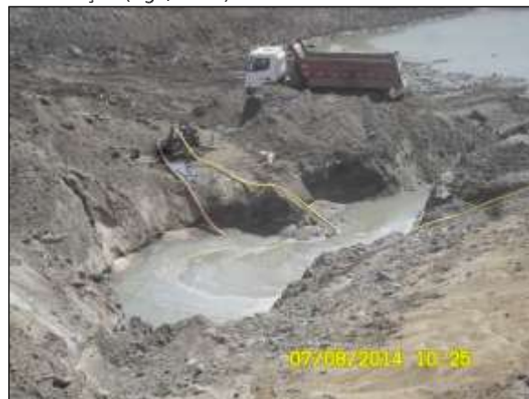
Foto 4.20 16. Esgotamento de água acumulada no segmento de canal para evitar possível proliferação de vetores e hospedeiros de doenças (ago/2014).
