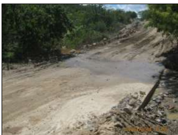
Foto 4.27 68. Passagem molhada implantada em estrada de acesso ao reservatório Negreiros (abr/2014).
