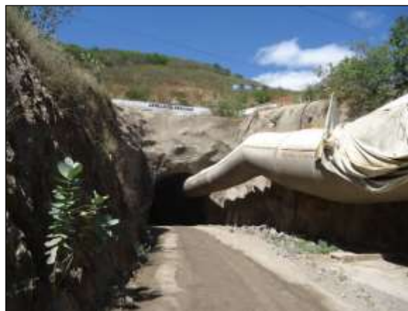
Foto 4.27 90. Concreto projetado na área do espelho do túnel como medida de prevenção e controle de processos erosivos (jun/2014).
