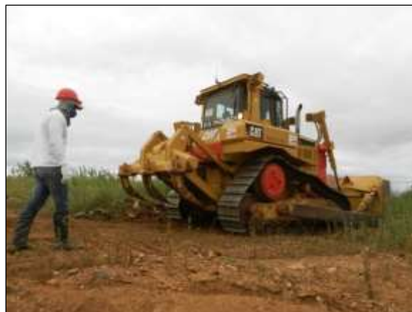
Foto 4.6 4. Acompanhamento de supressão vegetal mecânica no Reservatório Areias (WBS 1204), Meta 2L (jun/2014).
