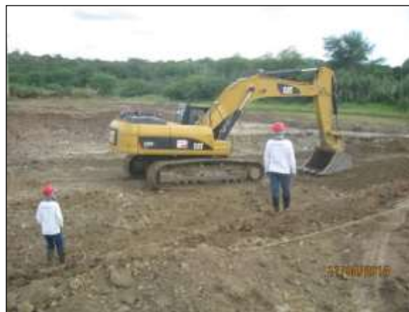
Foto 4.6 28. Abertura de canal inspecionada por técnicos do INAPAS no WBS 2226, meta 2L/3L (abr/2014).
