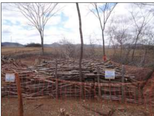
Foto 4.10 124. Material lenhoso proveniente das atividades de supressão vegetal da área da VPR (set/2014).
