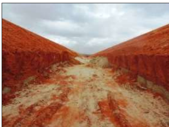
Foto 4.6 39. Sítio Areia Branca. Vista da localização no eixo do segmento de canal CN 25. Meta 3N. Mauriti – CE (maio/2014).
