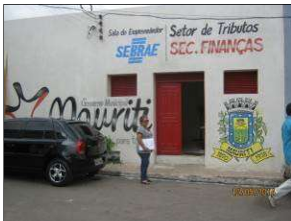
Foto 4.7.12. Acesso à sede da Prefeitura de Mauriti - CE para requerer Certidões Negativas de Ônus para Instrução Processual (maio/2014).
