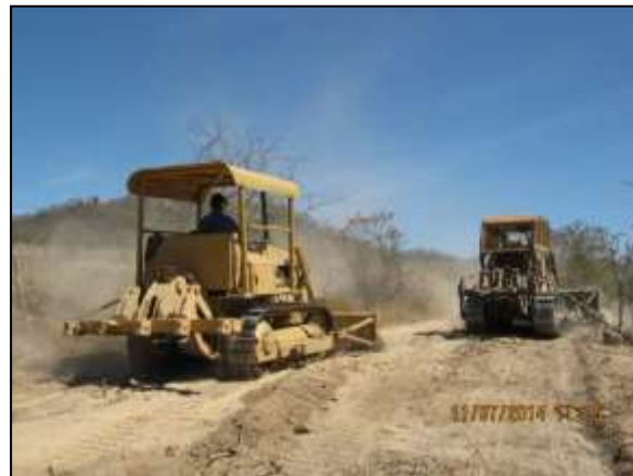
Foto 4.10 109. Supressão mecanizada e remoção de "top soil" na área da VPR Queimada Grande (jul/2014).
