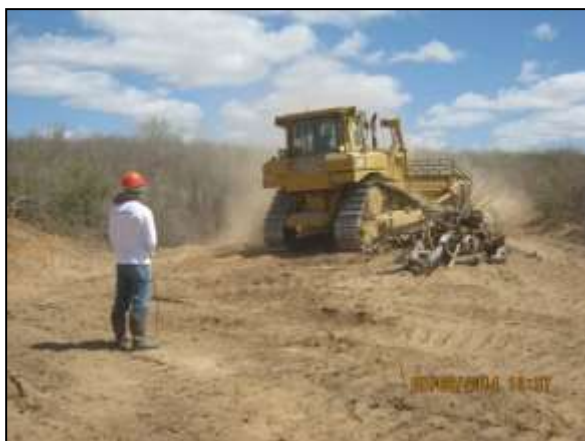
Foto 4.6 23. Técnico do INAPAS durante acompanhamento das atividades de supressão vegetal mecanizada na área de formação do reservatório Tucutu – WBS 1105, meta 1N (ago/2014).
