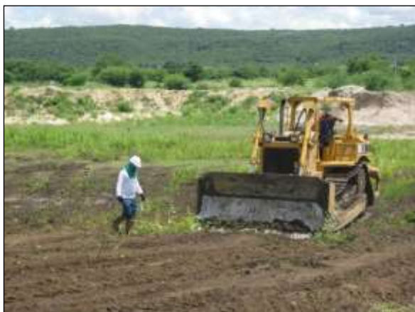
Foto 4.10 53. Supressão mecanizada e remoção de "top soil" acompanhada por técnico especializado do CEMAFAUNA para possíveis resgates (abr/2014).
