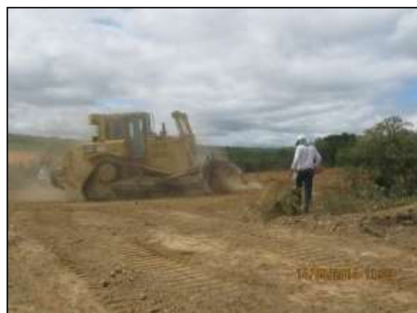
Foto 4.10 8. Atividade mecanizada de remoção de solo vegetal e expurgo com acompanhamento de técnicos do CEMAFAUNA (mai/2014).
