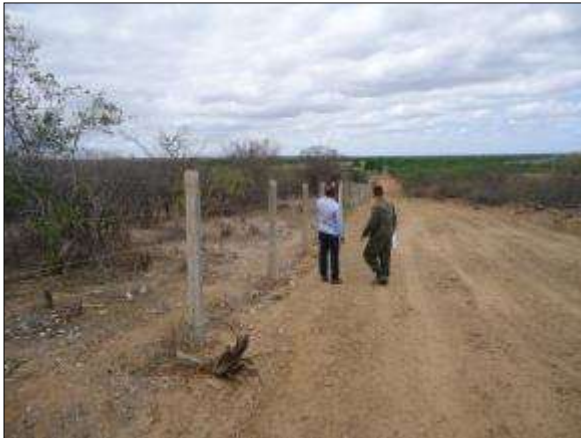
Foto 4.8.21. Vista parcial da cerca de delimitação da área da VPR Captação (jul/2014).
