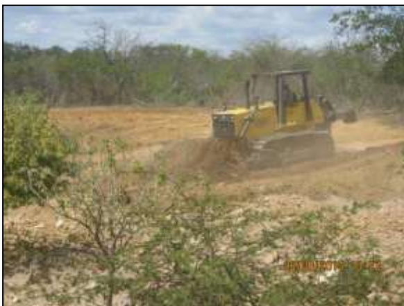
Foto 4.27 22. Atividade de reconformação topográfica na faixa adjacente ao canal de adução (ago/2014).
