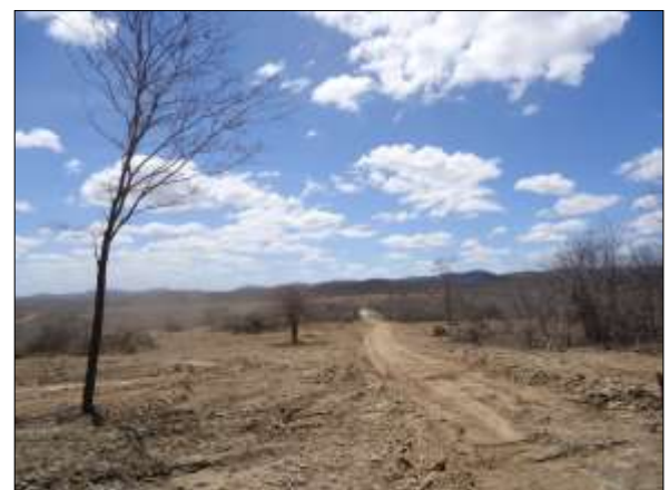
Foto 4.8.17. Acompanhamento das obras de construção do setor residencial da VPR Jurema, São José de Piranhas - PB (ago/2014).
