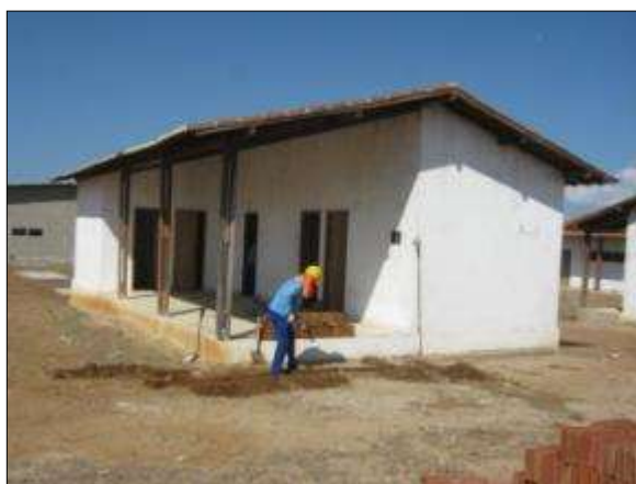
Foto 4.8.20. Acompanhamento das obras de construção do setor residencial da VPR Salão, Sertânia - PE (set/2014).
