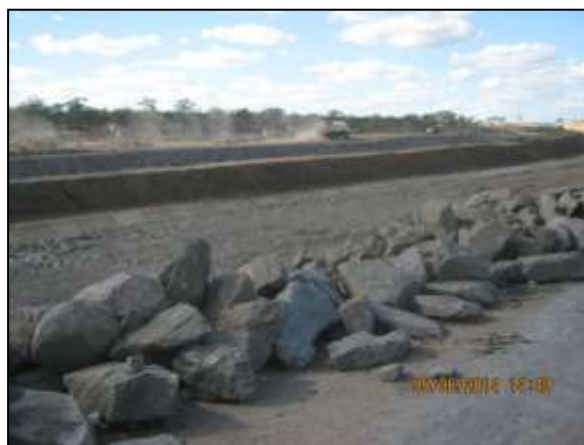
Foto 4.27 21. Disposição de material rochoso para aplicação em talude de canal como medida preventiva a ocorrência de processos erosivos (jun/2014).
