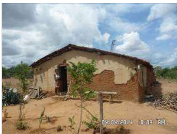
Foto 4.7.9. Elaboração de PTT do Sra. Maria Edileuza da Silva - ENTI-119=TN-025-1 G no lote 02, Trecho I Eixo Norte do Projeto São Francisco (abr/2014).
