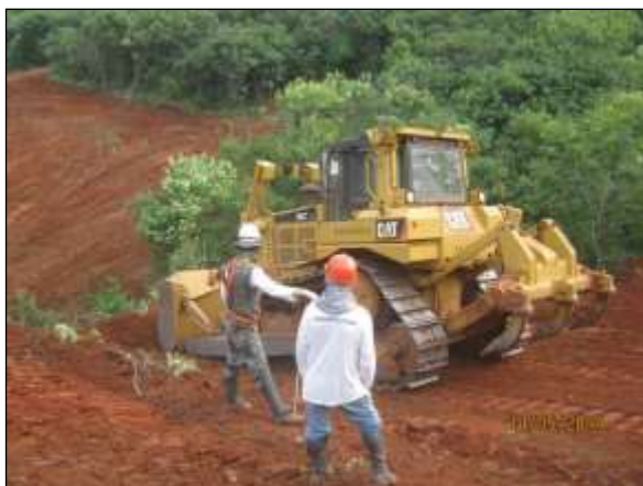
Foto 4.6 25. Técnico do INAPAS acompanhando atividade de supressão vegetal em área do reservatório Caiçara – WBS 1120, Meta 3N (maio/2014).
