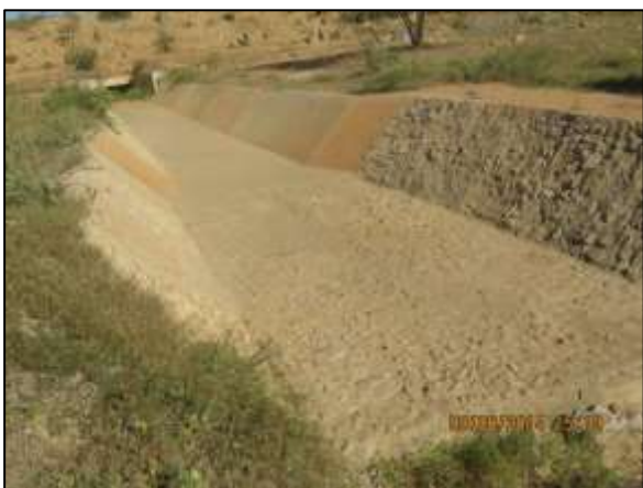
Foto 4.27 48. Canal de restituição implantado em saída de sistema de drenagem (jun/2014).
