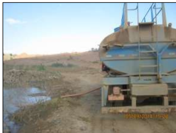
Foto 4.20 20. Esgotamento de acúmulo de água em jazida no reservatório Mangueira, para evitar possível proliferação de vetores e hospedeiros de doenças (set/2014).
