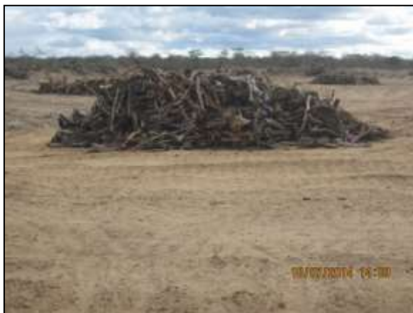
Foto 4.10 18. Segregação do material lenhoso na bacia hidráulica do reservatório Tucutu para posterior transporte e armazenamento adequado (jul/2014)
