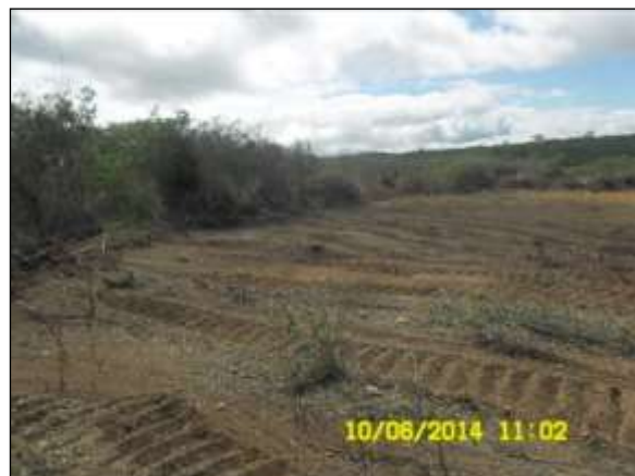
Foto 4.10 87. Expurgo armazenado no limite da supressão do reservatório Barro branco (jun/2014).
