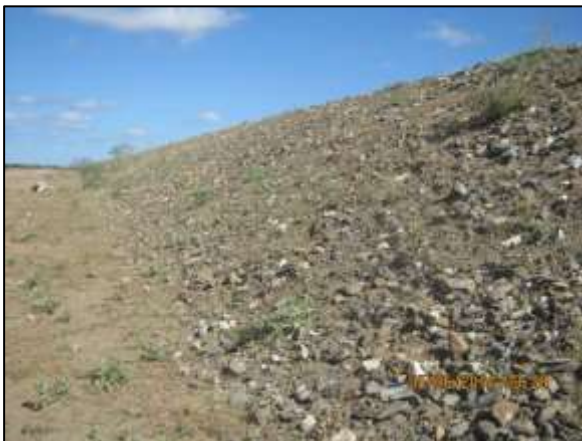
Foto 4.27 13. Talude estabilizado por enrocamento para dissipação de energia de águas drenadas superficialmente (jun/2014)
