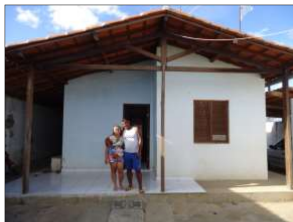
Foto 4.8.91. Acompanhamento social e verificação de permanência na VPR Baixio dos Grandes, Cabrobó – PE (ago/2014).
