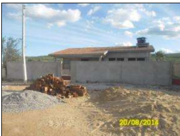
Foto 4.12 6. Posto de saúde com obras em andamento Etnia Kambiá, localizado no município de Inajá – PE (ago/2014).
