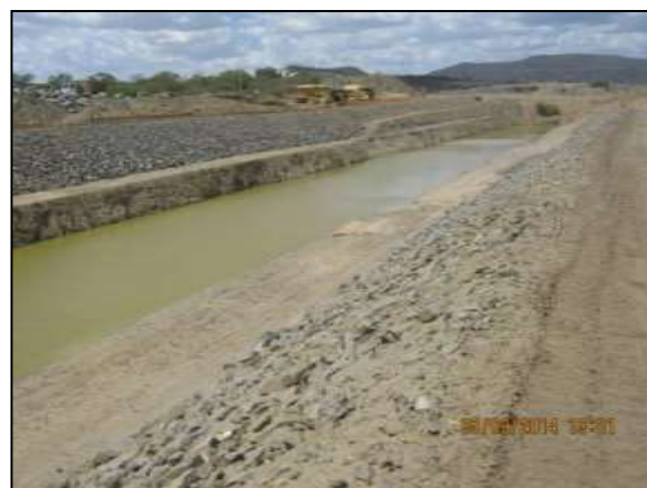
Foto 4.27 33. Enrocamento do talude de canal como medida preventiva à processos erosivos (set/2014).
