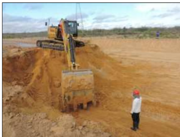
Foto 4.6 8. Acompanhamento de escavação do segmento de canal CL07, Meta 2L, Floresta - PE (jul/2014).
