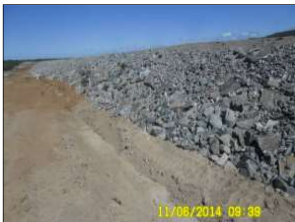
Foto 4.27 77. Enrocamento parcial do barramento do reservatório Bagres (jun/2014).
