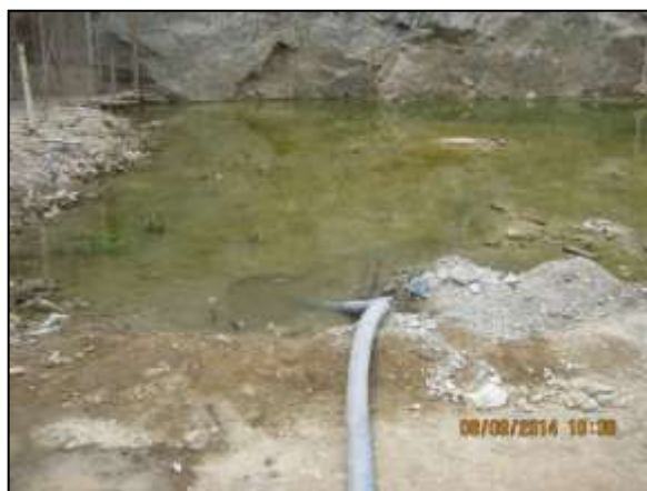
Foto 4.20 21. Esgotamento de água na área de implantação da estação de bombeamento EBI-03 para evitar possível proliferação de vetores e hospedeiros de doenças (set/2014).
