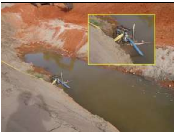
Foto 4.20 19. Esgotamento de água acumulada em área de implantação do reservatório Cana Brava para evitar possível proliferação de vetores e hospedeiros de doenças (set/2014).
