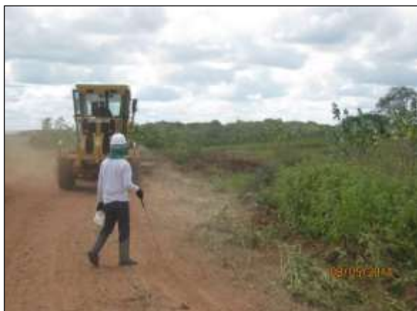
Foto 4.10 55. Supressão mecanizada e remoção de "top soil" acompanhada por técnico especializado do CEMAFAUNA para possíveis resgates (maio/2014).
