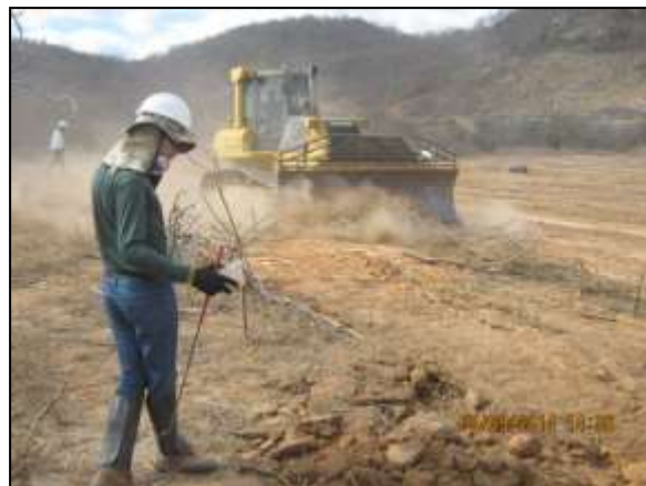
Foto 4.10 15. Resgate de fauna por técnico da CEMAFAUNA durante supressão mecanizada (set/2014).
