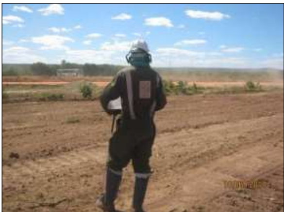
Foto 4.10 63. Equipe UNIVASF no acompanhamento da atividade de supressão da vegetação no seg. canal WBS 1232 (set/2014).
