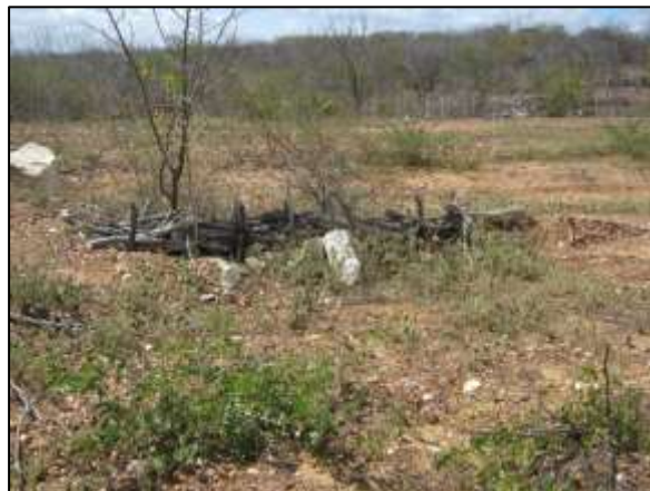
Foto 4.27 8. Cerca paliçada implantada como medida preventiva ao carreamento de sedimentos apresentando regeneração natural (jul/2013).
