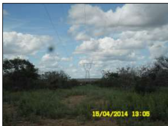
Foto 4.37.2. Verificação do revestimento vegetal na faixa de servidão da LT próximo a subestação O Trecho V (abr/2014).
