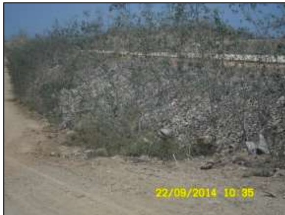
Foto 4.27 82. Enrocamento marginal da estrada de acesso (set/2014).
