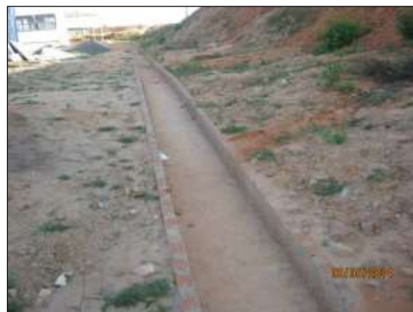
Foto 4.27 63. Canaleta de escoamento pluvial na área do aqueduto Catingueira para prevenção de processos erosivos (maio/2014).
