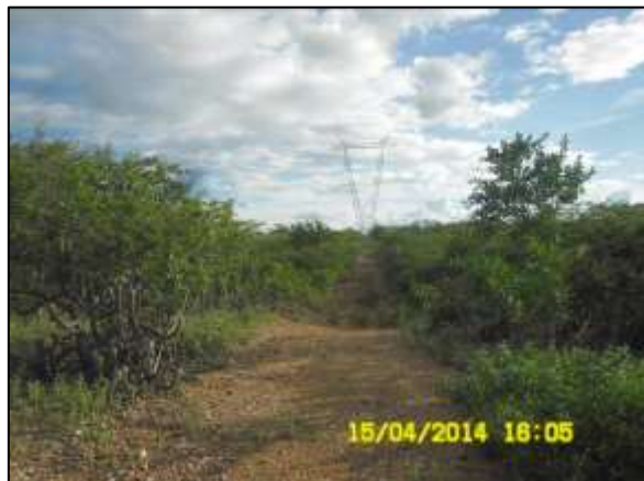
Foto 4.37.6. Monitoramento sistemático das áreas sob a linha de transmissão próxima à EBV-4, Trecho V, Eixo Leste (abr/2014).
