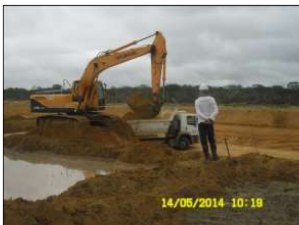
Foto 4.6 31. Abertura do canal adutor sendo acompanhada por técnico do INAPAS, Meta 1L/2L (maio/2014).
