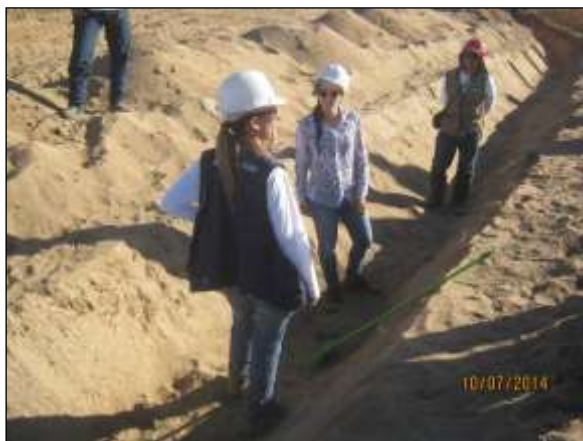
Foto 4.6 27. Equipe do INAPAS em área de escavação do canal de escoamento pluvial onde foi encontrado o possível vestígio arqueológico de combustão WBS 1231, Meta 3N (jul/2014).
