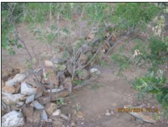
Foto 4.27 11. Filtro de rocha implantado como medida preventiva ao carreamento de sedimentos (abr/2014).
