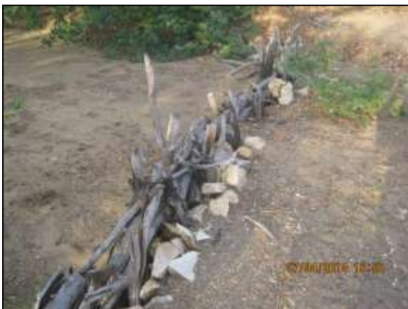
Foto 4.27 5. Cerca paliçada com filtro de rocha implantada auxiliando na retenção de sedimentos (abr/2014).
