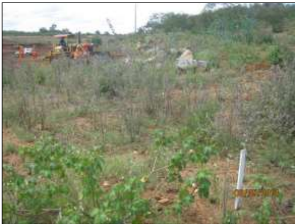
Foto 4.10 82. Delimitação da área a ser suprimida por estacas referenciadas (maio/2014)
