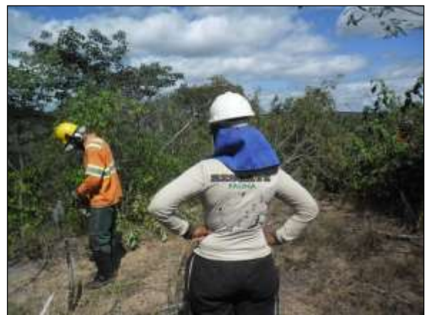
Foto 4.10 31. Supressão vegetal semimecanizada acompanhada pela equipe UNIVASF (jun/2014).
