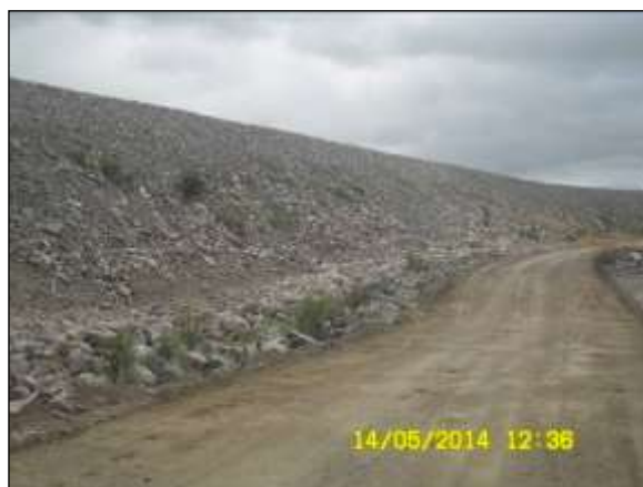
Foto 4.27 74. Enrocamento de talude como medida preventiva ao surgimento de processo erosivos no WBS 2207 (maio/2014).
