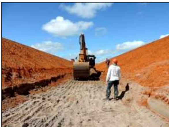
Foto 4.6 5. Acompanhamento de escavação do segmento de canal CN25 (WBS 1232), Meta 3N (maio/2014).
