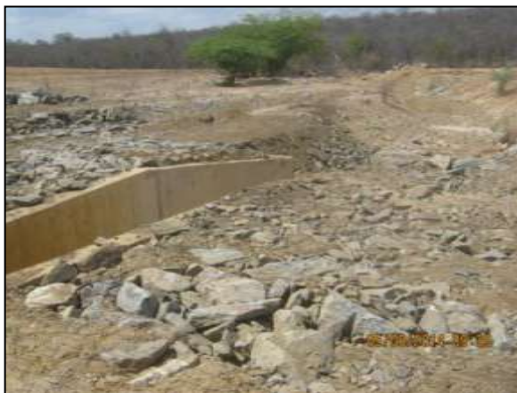
Foto 4.27 15. Talude do sistema de drenagem adequadamente enrocado (set/2014).
