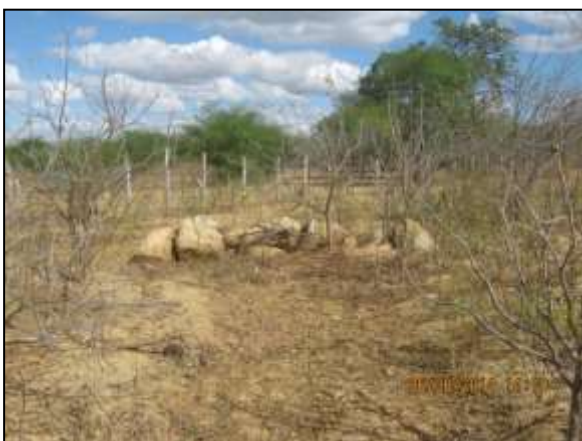
Foto 4.27 26. Filtro de rocha implantado como medida preventiva ao carreamento de sedimentos (ago/2014).
