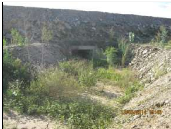
Foto 4.27 25. Restabelecimento da vegetação e saída de drenagem com enrocamento de proteção (maio/2014).
