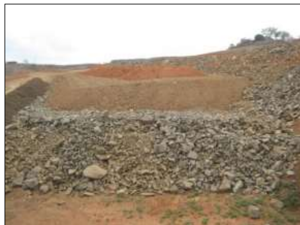
Foto 4.27 67. Enrocamento de proteção nas adjacências a jusante do bueiro (set/2014).
