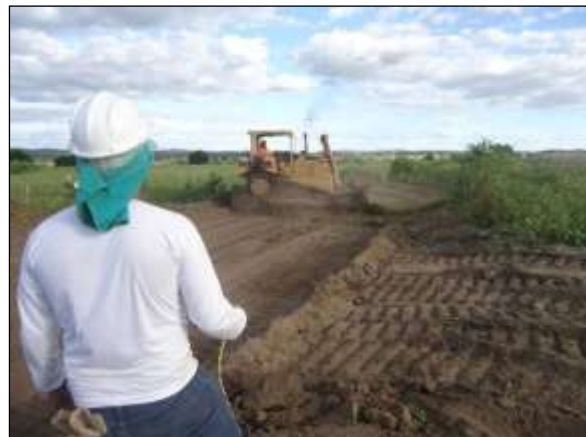
Foto 4.10 58. Supressão mecanizada e remoção de "top soil" acompanhada por técnico especializado do CEMAFAUNA para possíveis resgates (jun/2014).
