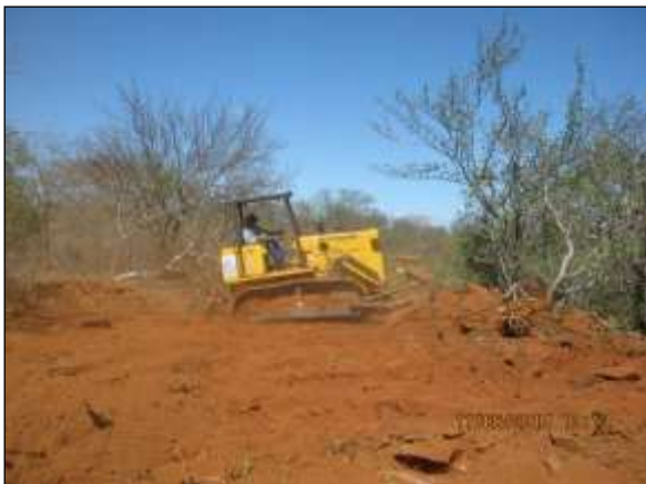
Foto 4.10 100. Supressão mecanizada e remoção de "top soil" na área da VPR Baixio dos Grandes (jun/2014).
