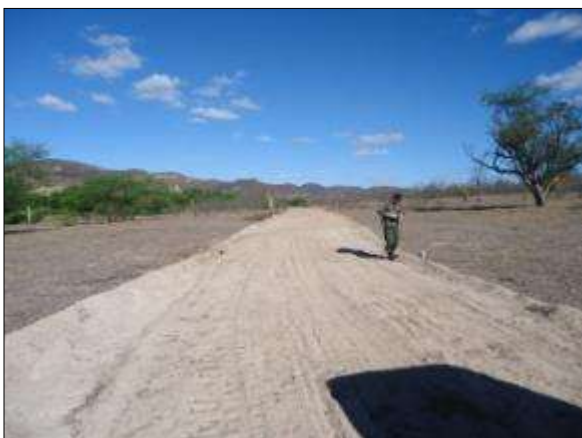
Foto 4.8.33. Vias de acesso dos setores residenciais e produtivo da VPR Uri (ago/2014).
