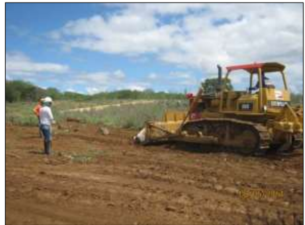
Foto 4.10 83. Supressão mecanizada acompanhada pela equipe especializada do CEMAFAUNA para possíveis resgates (maio/2014).
