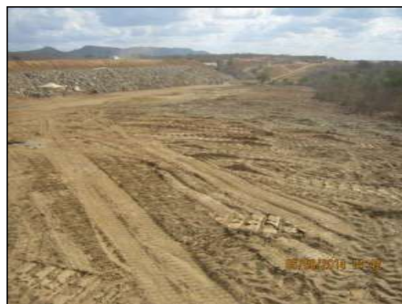
Foto 4.27 45. Faixa marginal ao canal reconformada e talude enrocado (set/2014).
