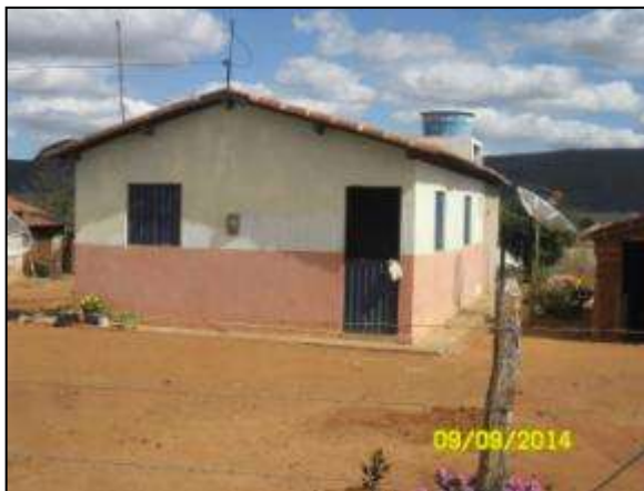
Foto 4.17 3. Casa concluída e habitada, comunidade Jatobá II, município de Cabrobó – PE (set/2014).
