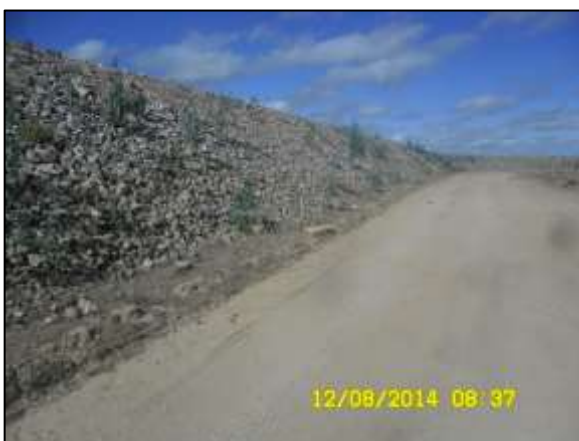
Foto 4.27 80. Enrocamento no talude do canal como medida preventiva a ocorrência de processos erosivos (ago/2014).
