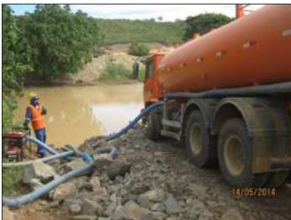
Foto 4.20 5. Esgotamento de água acumulada em área de implantação do reservatório morros para evitar possível proliferação de vetores e hospedeiros de doenças (maio/2014).
