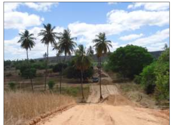
Foto 4.8.15. Acompanhamento das obras de construção do setor residencial da VPR Ipê, Jati - CE (ago/2014).
