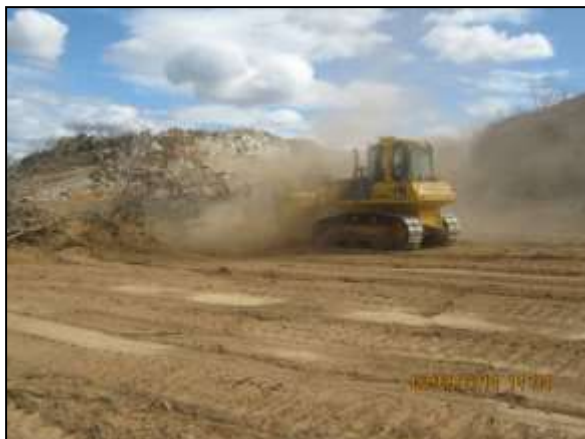
Foto 4.10 14. Remoção de expurgo e da camada orgânica do solo (set/2014).
