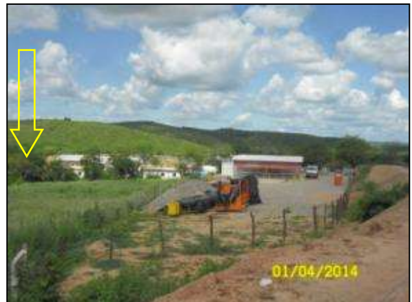
Foto 4.8.11. Visita técnica na área proposta para construção do setor residencial da VPR Ipê, Jati - CE (abr/2014).
