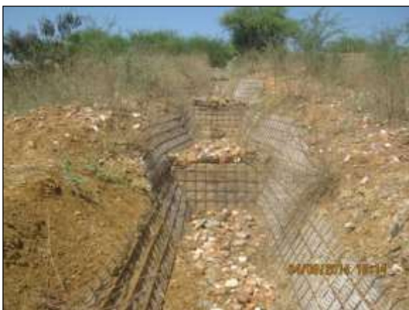
Foto 2.9.13. Ecocalha com dissipadores de energia implantada na área de recuperação BF 06-CN (set/2014).
