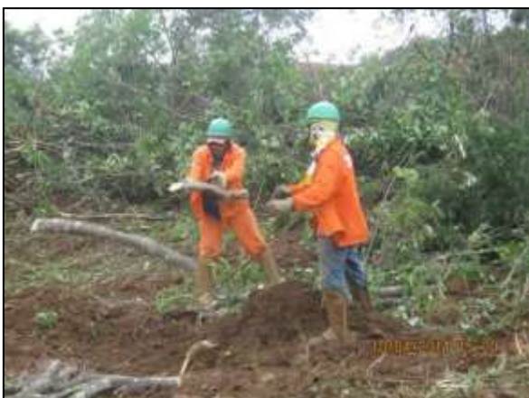
Foto 4.10 5. Segregação manual de material vegetal seccionado (abr/2014)
