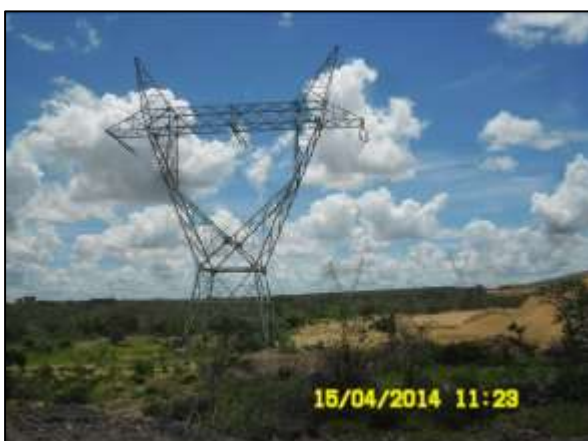
Foto 4.37.1. Verificação do revestimento vegetal na faixa de servidão da LT próximo à subestação O Trecho I (abr/2014).
