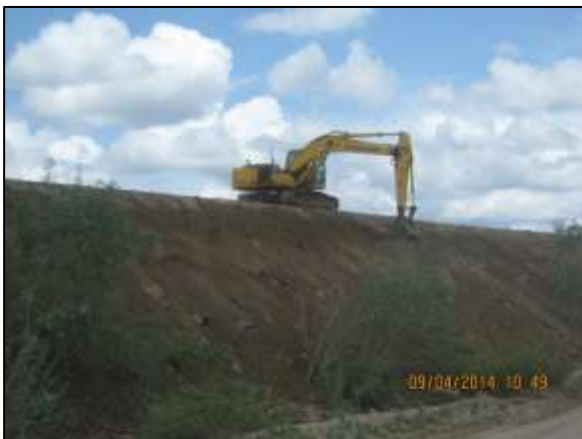
Foto 4.27 24. Reconformação de talude para aplicação de enrocamento de proteção (abr/2014).
