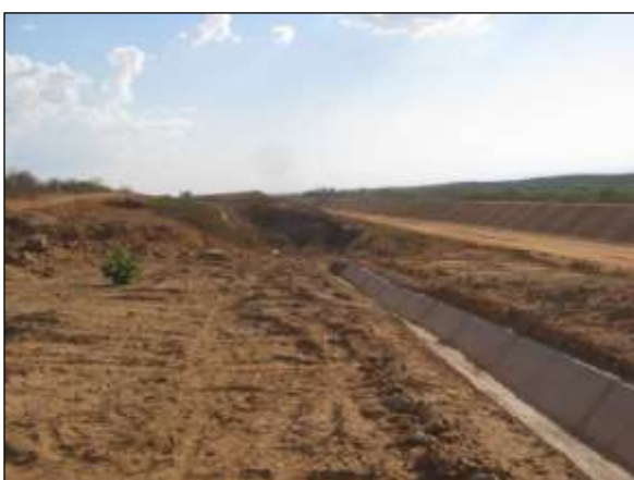
Foto 4.27 64. Canaleta de escoamento pluvial implantada na faixa de domínio do canal para direcionamento de águas pluviais (set/2014).
