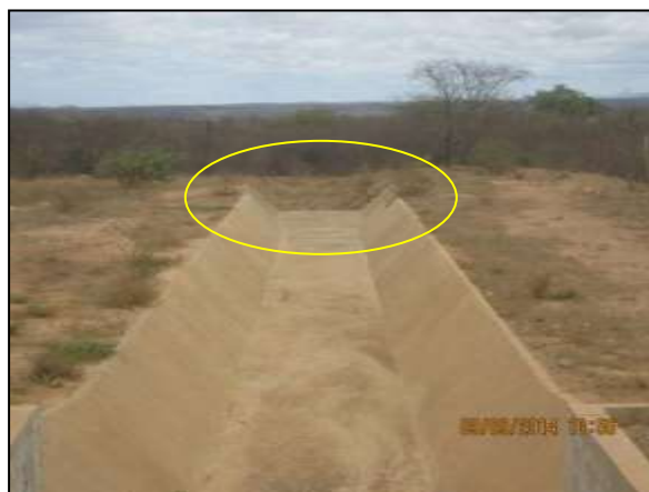
Foto 4.27 51. Sistema de drenagem com canal de restituição concretado e com dissipadores de energia, em destaque (set/2014).
