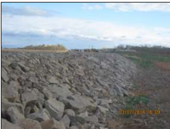
Foto 4.27 34. Enrocamento de talude de canal margeando estrada de serviço atuando como medida preventiva a processos erosivos (jul/2014).
