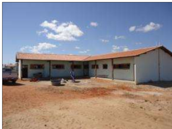
Foto 4.8.19. Acompanhamento das obras de construção do setor residencial da VPR Vassouras, Mauriti - CE (ago/2014).
