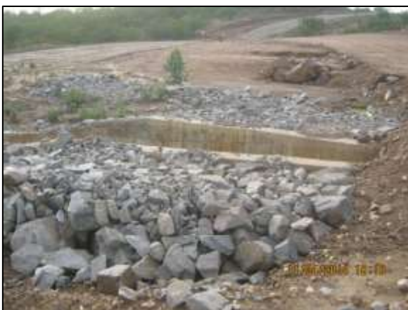
Foto 4.27 42. Medida de proteção contra processos erosivos com enrocamento do talude em cabeceira de sistema de drenagem (abr/2014).
