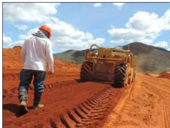
Foto 4.6 6. Acompanhamento de escavação de caixa de empréstimo, Res. Caiçara, Meta 3N (ago/2014).
