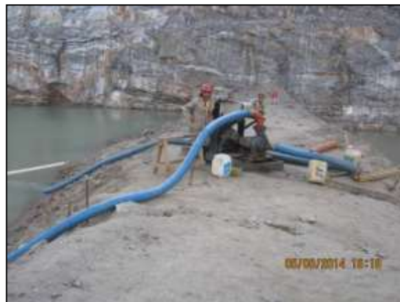
Foto 4.20 8. Esgotamento de água acumulada na estação de bombeamento EBI-03, para evitar possível proliferação de vetores e hospedeiros de doenças (jun/2014).
