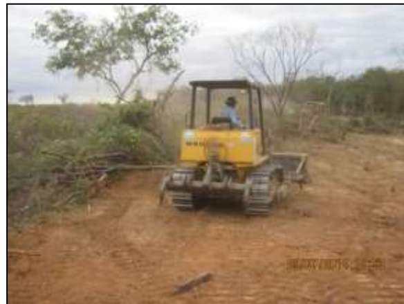
Foto 4.10 112. Supressão mecanizada e remoção de "top soil" (jul/2014).
