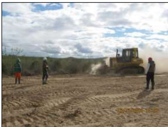
Foto 4.6 21. Técnicos do INAPAS durante acompanhamento das atividades de supressão vegetal mecanizada na área de formação do reservatório Tucutu – WBS 1105, meta 1N (jul/2014).
