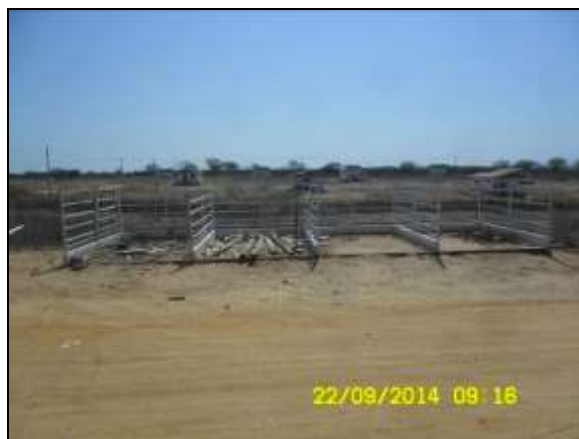
Foto 4.2.835. Baías para armazenamento temporário dos resíduos gerados na estrutura de apoio (set/2014).
