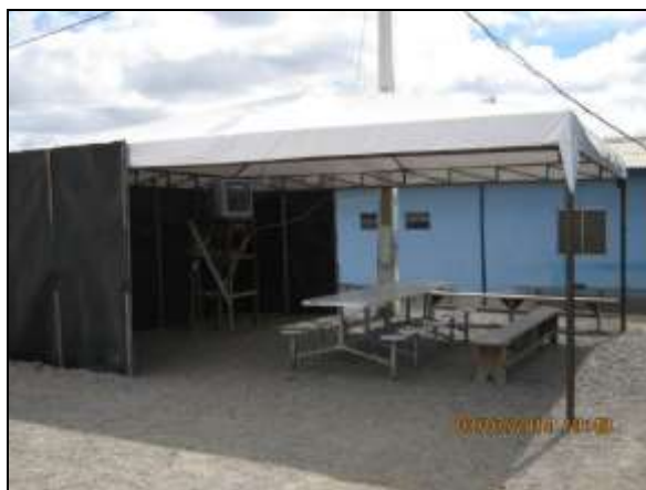
Foto 4.2.16. Área de vivência disponibilizada aos colaboradores alojados no canteiro de obras em Cabrobó - PE (jul/2014).
