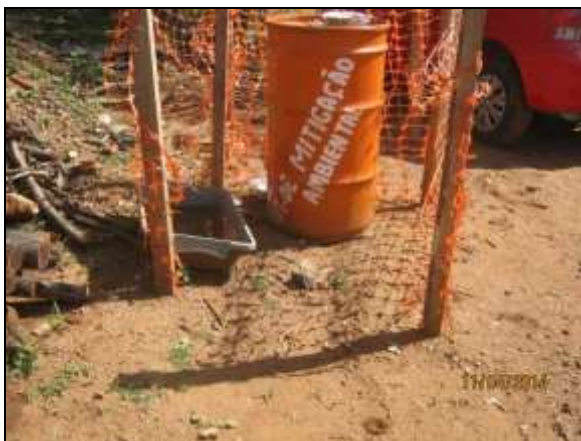
Foto 4.2.553. Kit mitigação disponibilizado na frente de serviços para contenção de vazamentos (abr/2014).
