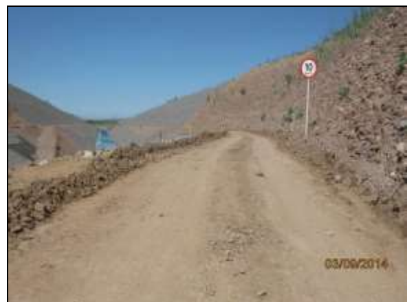
Foto 4.2.416. Estrada de serviço da EBV-01 sinalizada e em condições adequadas de trafegabilidade (set/2014).
