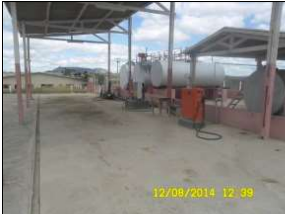
Foto 4.2.496. Posto de abastecimento com pista impermeabilizada, canaleta ligada ao SAO e área para abastecimento coberta (ago/2014).
