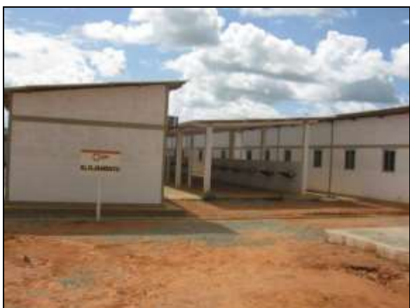
Foto 4.2.188. Alojamentos com respectiva lavanderia no canteiro central (abr/2014).
