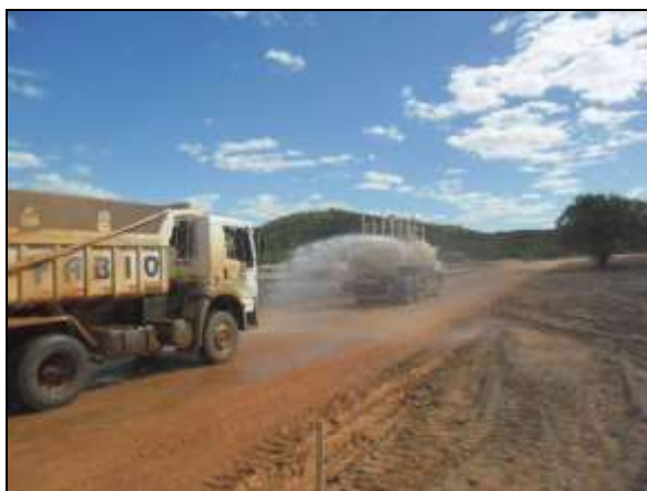
Foto 4.2.138. Umectação da via de acesso à jazida Areal de Porcos (jun/2014).
