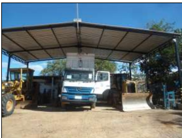
Foto 4.2.198. Oficina mecânica no canteiro de apoio da frente de serviço do reservatório Jati (jun/2014).
