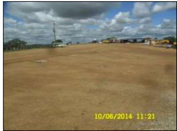
Foto 4.2.511. Vias de acesso no canteiro de obras com boas condições de trafegabilidade (jun/2014).
