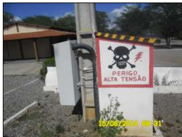
Foto 4.2.517. Sinalização de advertência no canteiro de obras (ago/2014).
