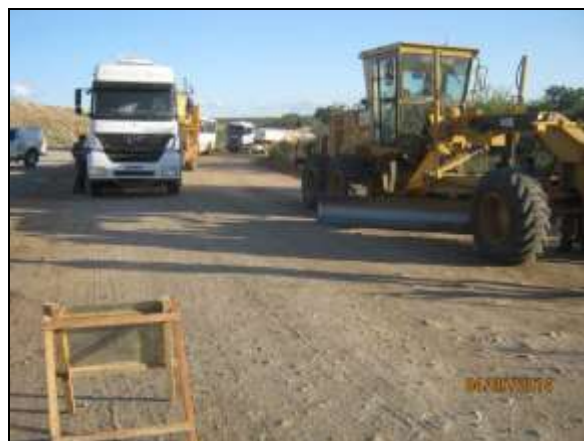
Foto 4.2.464. Barreira formada em distância de segurança para interromper o tráfego na área de desmante de rocha (jun/2014).
