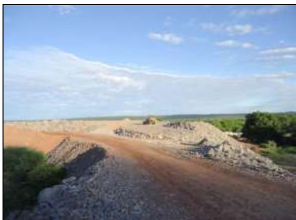
Foto 4.2.662. Bota-fora de material de 1ª e 3ª categorias no emboque do túnel Cuncas I - WBS 1410 (jun/2014).
