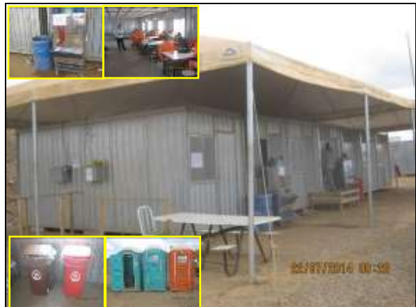
Foto 4.2.118. Estrutura de apoio com bebedouro, refeitório coletores de resíduos e banheiros químicos na frente de serviço de terraplanagem no segmento WBS 1219 (jul/2014).
