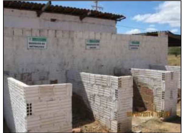
Foto 4.2.742. Disponibilidade de baias para disposição de resíduos sólidos próximas à estrutura de apoio (jun/2014).
