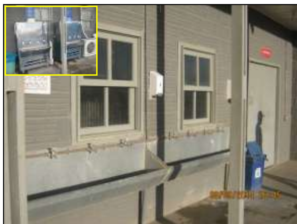
Foto 4.2.362. Disponibilidade de lavatórios e bebedouros com água mineral nas proximidades do refeitório do canteiro de obras (set/2014).
