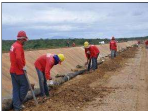
Foto 4.3.93. Frente de serviço em segmento de canal, Custódia - PE, Meta 3L (mai/2014).
