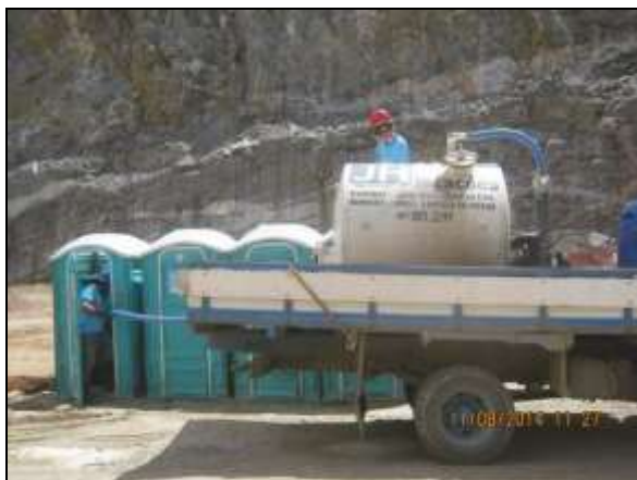
Foto 4.2.367. Realização de atividade de limpeza e higienização dos banheiros químicos disponíveis na frente de serviço da EBI-03 (ago/2014).
