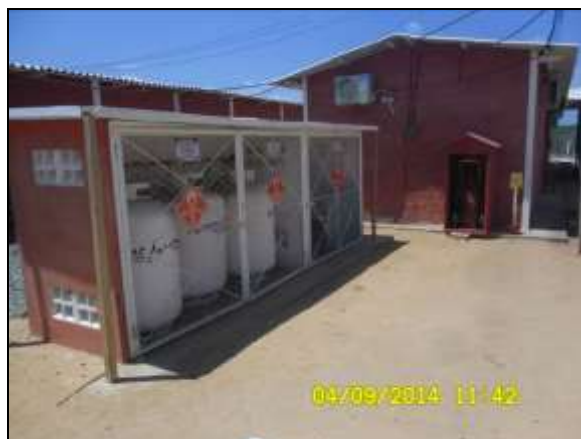
Foto 4.2.435. Armazenamento adequado dos botijões de gás GLP da cozinha no canteiro de obras (set/2014).
