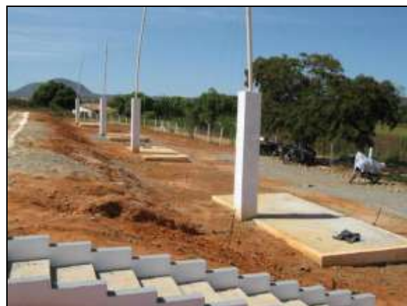
Foto 4.2.213. Fossas sépticas e sumidouros implantados para atender as instalações administrativas do canteiro central (ago/2014).
