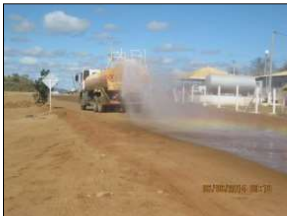
Foto 4.2.336. Umectação da via de acesso em frente ao canteiro de apoio da EBI-02 para minimização da emissão de material particulado (jun/2014).
