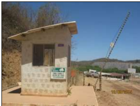
Foto 4.2.579. Guarita de controle de acesso de pessoas e veículos no canteiro de apoio da janelada de serviço do túnel do Cuncas I (set/2014).
