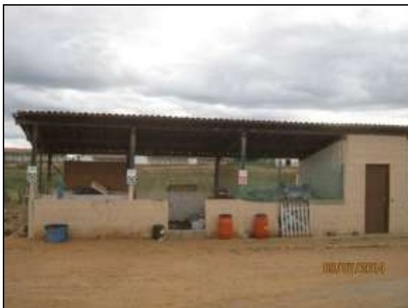
Foto 4.2.557. Baia para acondicionamento temporário de resíduos no canteiro de obras (jul/2013).
