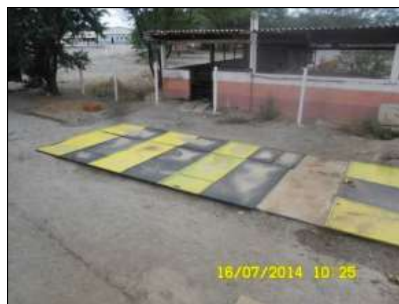
Foto 4.2.410. Separador de água e óleo do lava-jato, oficina e depósito de óleo com manutenção satisfatória (jul/2014).
