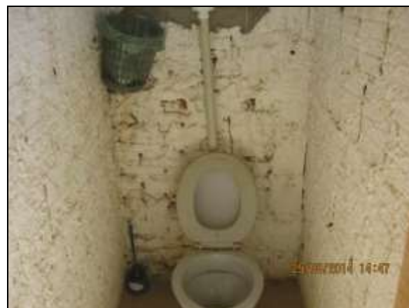
Foto 4.2.755. Gabinete sanitário em condições adequadas de limpeza (ago/2014).
