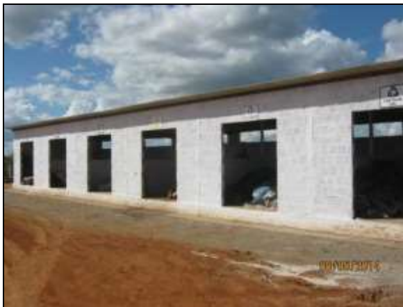
Foto 4.2.326. Baia para o armazenamento temporário de resíduos sólidos em fase final de instalação no canteiro de obras do antigo Lote 06 (maio/2014).
