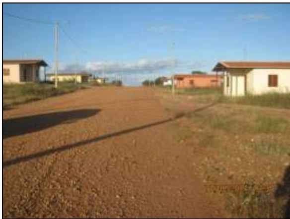
Foto 4.2.743. Via de acesso à VPR em condições adequadas para trafegabilidade (jun/2014).
