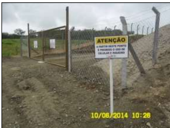
Foto 4.2.532. Placa de orientação de restrição de uso de celular próximo ao paiol de explosivos (jun/2014).
