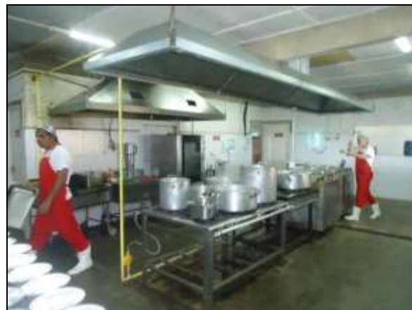
Foto 4.2.181. Cozinha industrial em boas condições de limpeza e organização no canteiro de apoio do reservatório Jati (jul/2014).
