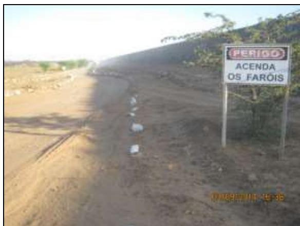
Foto 4.2.354. Placa com sinalização e divulgação do código de conduta próximo à via de acesso ao canteiro e frentes de serviços da EBI-01 (set/2014).
