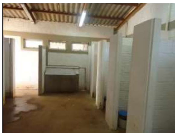
Foto 4.2.189. Banheiros dos alojamentos do canteiro central de obras em condições adequadas de higiene e limpeza (maio/2014).
