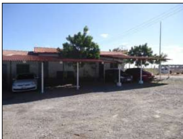
Foto 4.2.633. Alojamentos para os colaboradores da obra, Mauriti – CE (jun/2014).
