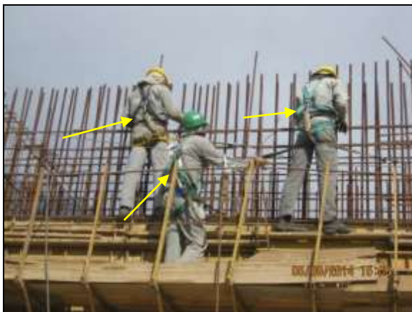
Foto 4.2.53. Colaboradores com EPI adequados à atividade em altura na frente de serviço da estrutura de controle do reservatório Serra do Livramento – WBS 1107 (ago/2014).
