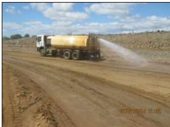
Foto 4.2.40. Veículo em atividade de umectação da via de acesso do segmento de canal WBS 1212 (jul/2014).
