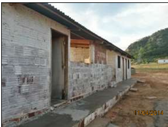
Foto 4.2.704. Vista parcial da estrutura de apoio disponível aos colaboradores (abr/2014).
