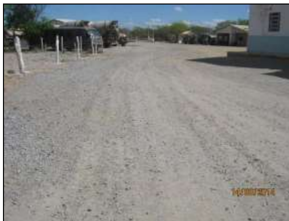
Foto 4.2.386. Vía interna do canteiro de obras aplainada e bem dimensionada (ago/2014).
