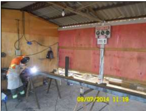
Foto 4.2.424. Colaborador em atividade de solda no canteiro de obras com uso de EPI (jul/2014).
