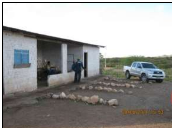
Foto 4.2.771. Vista da estrutura de apoio e estacionamento de veículos (jun/2014).
