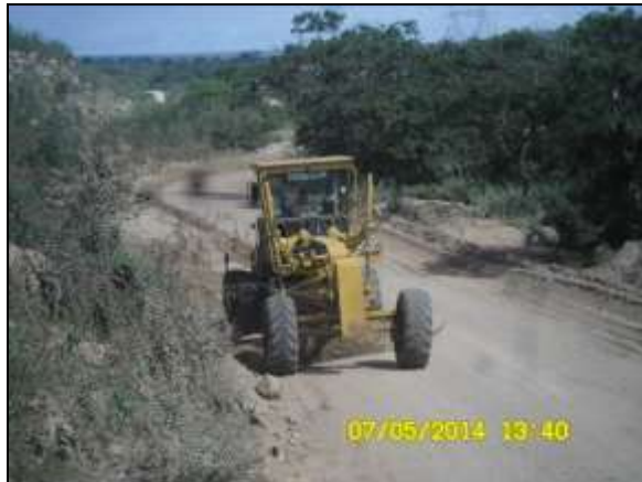
Foto 4.2.413. Via de acesso sendo aplainada garantindo melhor trafegabilidade no WBS 2207 (maio/2014).
