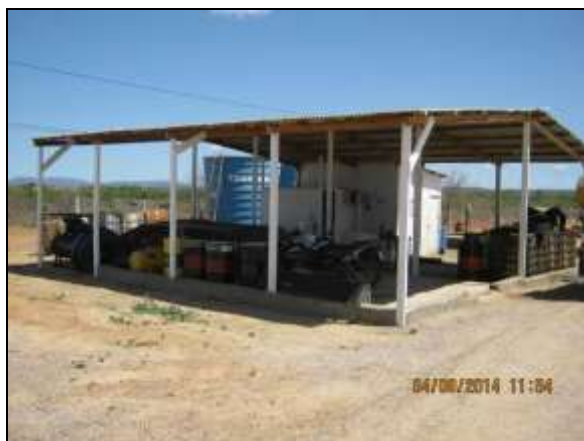
Foto 4.2.68. Local coberto para armazenamento de óleos lubrificantes e combustíveis com piso impermeável e paredes para contenção de vazamentos e/ou derramamentos (ago/2014).
