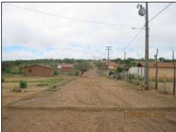
Foto 4.2.664. Via interna de circulação em estado adequado de conservação e favorável à trafegabilidade (abr/2014).
