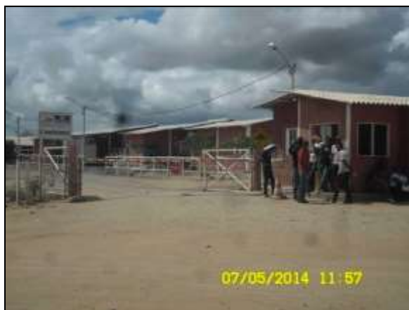
Foto 4.2.418. Guarita do canteiro de obras com vigilância em tempo integral (maio/2014).
