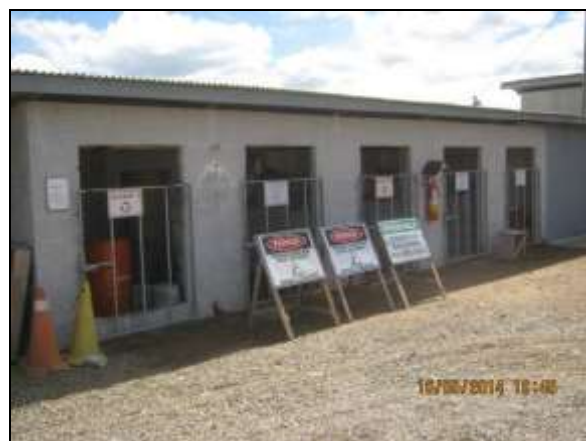
Foto 4.2.376. Baias para armazenamento seletivo e temporário dos resíduos do canteiro de apoio da EBI-01 (maio/2014).
