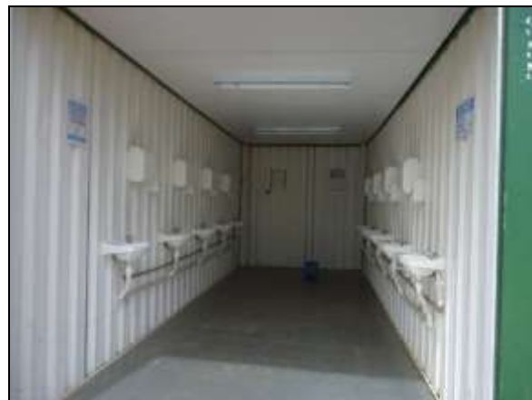
Foto 4.2.294. Local de higienização das mãos com sabonete líquido e papelreira na frente de serviço do reservatório Morros – WBS 1118 (jun/2014).
