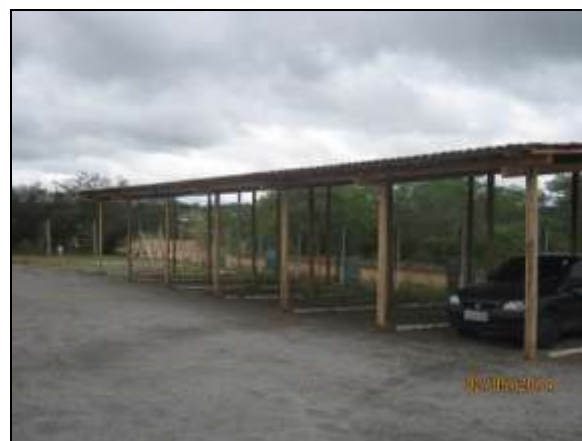
Foto 4.2.535. Estacionamento coberto e sinalizado (maio/2014).
