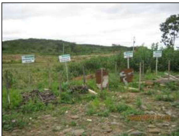
Foto 4.2.772. Baías para armazenamento temporário de resíduos (maio/2014).
