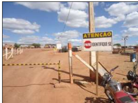
Foto 4.2.243. Guarita de controle de acesso de pessoas e veículos, ao canteiro de obras central do antigo Lote 06. (ago/2014).
