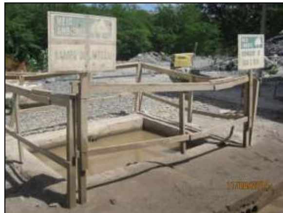
Foto 4.2.659. Separador de água e óleo do lava-jato da janela de serviço do túnel do Cuncas I (ago/2013).
