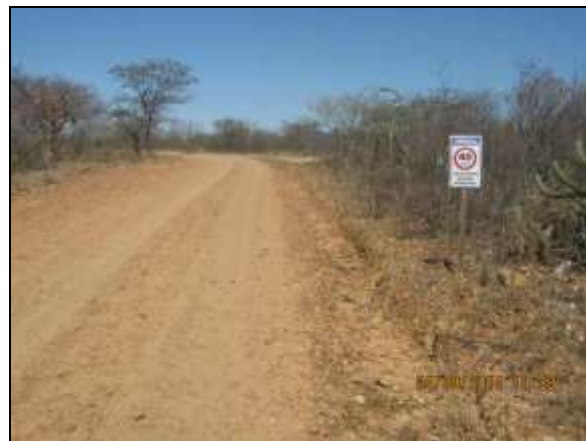
Foto 4.2.665. Via de acesso à VPR em condições favoráveis à trafegabilidade (ago/2014).
