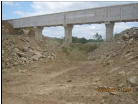
Foto 4.2.38. Canal do fluxo hídrico intermitente do riacho próximo ao aqueduto Saco da Serra – WBS 1306 (set/2014).
