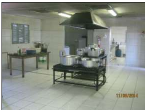
Foto 4.2.629. Cozinha industrial em boas condições de limpeza e organização no alojamento de Mauriti - CE (ago/2014).
