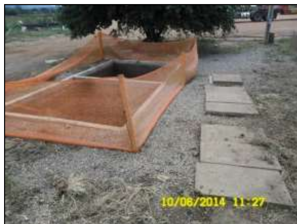
Foto 4.2.552. Estruturas do SAO do lava-jato e depósito de óleo com manutenção adequada (jun/2014).
