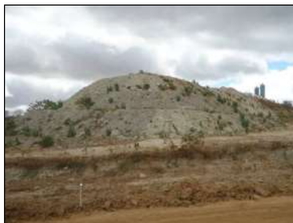
Foto 4.2.226. Bota-fora depositado em área do reservatório Porcos – WBS 1113 (set/2014).
