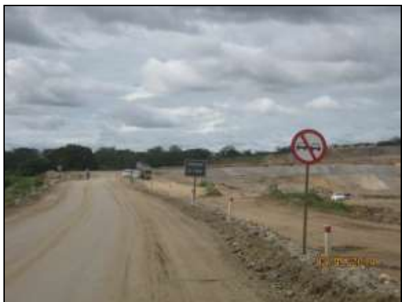
Foto 4.2.514. Trecho com sinalização adequada no WBS 2226 (maio/2014).
