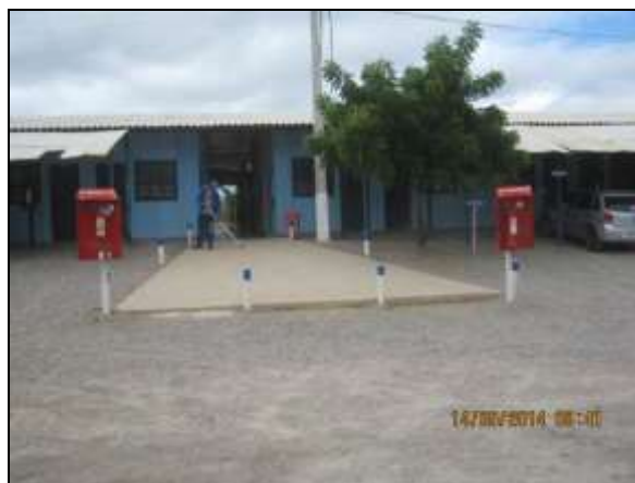
Foto 4.2.58. Vista parcial do escritório administrativo do canteiro de obras no distrito de Umãs, Salgueiro – PE (maio/2014).
