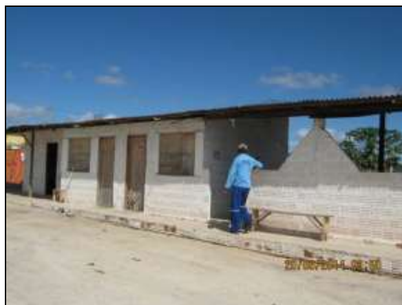
Foto 4.2.719. Colaborador em frente à estrutura de apoio devidamente uniformizado (jun/2014).
