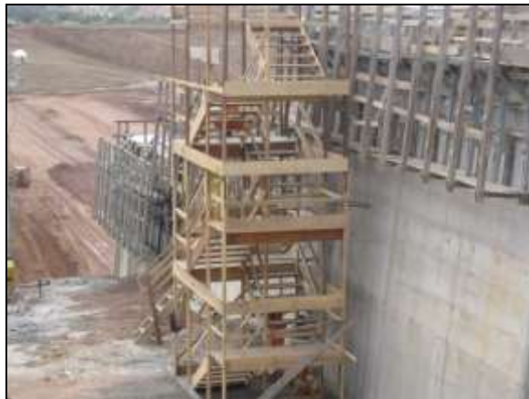
Foto 4.2.161. Escada de segurança implantada na frente de serviço da tomada d'água da barragem de Jati – WBS 1111 (ago/2014).
