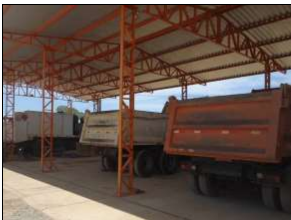
Foto 4.2.313. Veículos pertencentes à obra em manutenção na oficina do canteiro central de São José de Piranhas (ago/2014).
