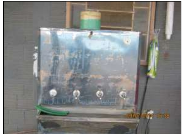
Foto 4.2.110. Bebedouro disponibilizado nas proximidades do refeitório do canteiro de obras de Salgueiro – PE (jul/2014).
