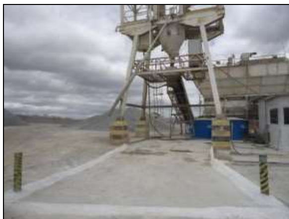
Foto 4.2.210. Central de concreto com pista impermeável e sistema de tratamento de efluentes da área da pedreira/britador de Jati (set/2014).
