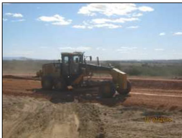
Foto 4.2.234. Manutenção da via de acesso do segmento de canal WBS 1232 (jul/2014).
