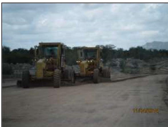
Foto 4.2.466. Via de acesso em manutenção para melhorias na segurança e continuidade do fluxo de veículos (abr/2014).
