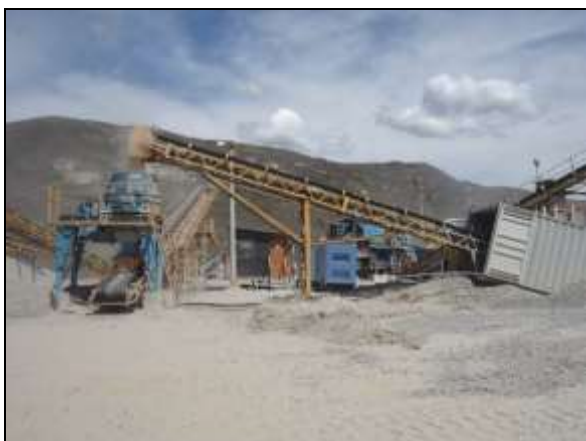
Foto 4.2.319. Britador em funcionamento na frente de serviço do reservatório Morros - WBS 1118 (ago/2014).
