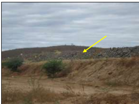
Foto 4.2.230. Bota-fora depositado à margem direita da faixa de domínio do segmento de canal – WBS 1225 (set/2014).
