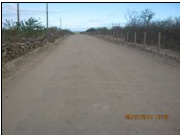
Foto 4.2.337. Via de acesso ao canteiro de obras central com dimensionamento e bom estado de conservação (jul/2014).
