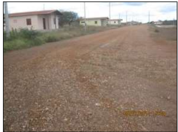
Foto 4.2.744. Via de circulação interna da VPR em estado adequado de conservação e manutenção (jul/2014).
