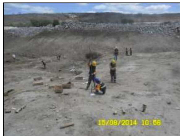
Foto 4.2.564. Inserção de explosivos em área a ser realizado desmonte de rocha (ago/2014).
