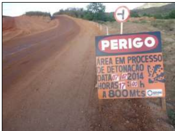
Foto 4.2.218. Placa sinalizando programação de detonação de rocha na área do reservatório Porcos – WBS 1113. (jul/2014).
