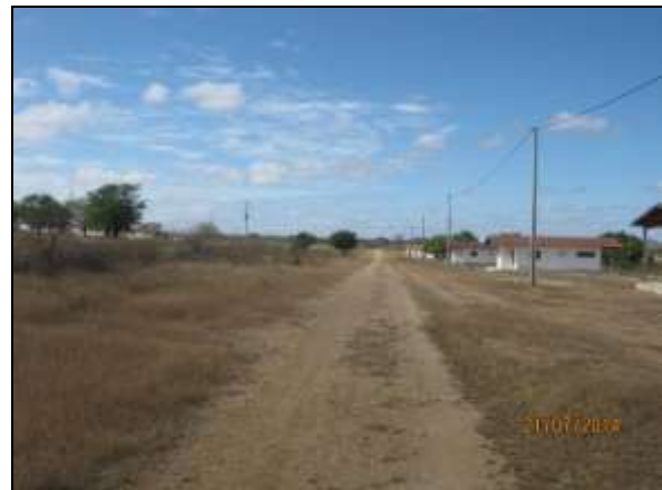
Foto 4.2.822. Via interna do núcleo habitacional em condições adequadas de trafegabilidade (jul/2013).
