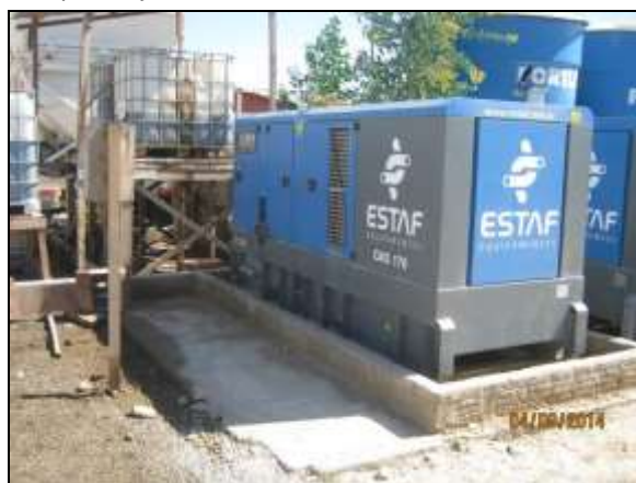
Foto 4.2.461. Gerador disposto sobre bacia de contenção no canteiro de obras (ago/2014).
