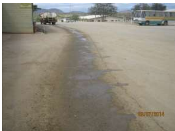
Foto 4.2.468. Umectação em via de acesso do canteiro de obras (jul/2014).
