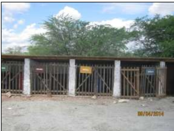
Foto 4.2.407. Baías para acondicionamento de resíduos no canteiro de obras (abr/2014).
