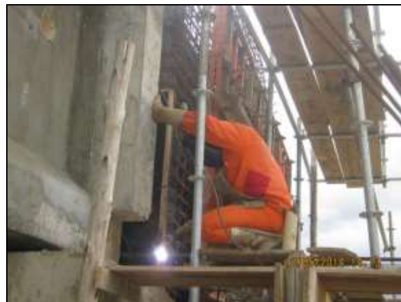
Foto 4.2.102. Colaborador com EPI adequados (aventail, protetor facial e luvas) durante atividade de solda na frente de serviço da ponte WBS 1507 (maio/2014).
