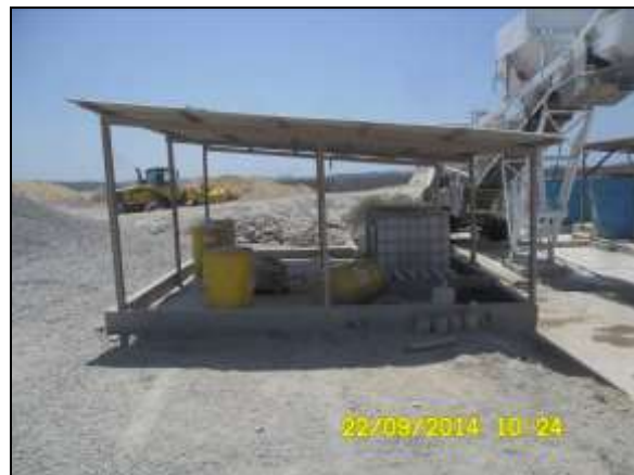
Foto 4.2.543. Aditivos armazenados de forma adequada na central de concreto (set/2014).
