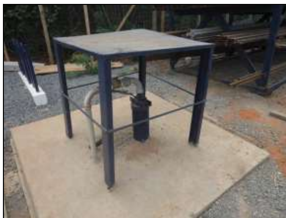
Foto 4.2.192. Poço tubular profundo implantado no canteiro central, com piso impermeável e cobertura (jul/2014).
