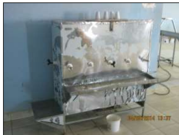
Foto 4.2.22. Bebedouro e copos descartáveis disponibilizados no refeitório do canteiro de obras (ago/2014).
