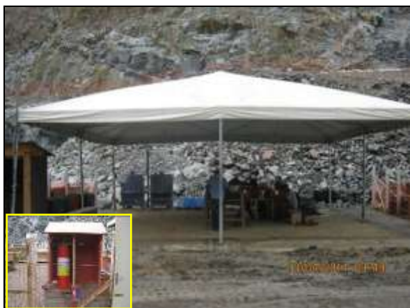
Foto 4.2.363. Tenda disponibilizada aos colaboradores da frente de serviço do poço de sucção da EBI-03 (abr/2014).
