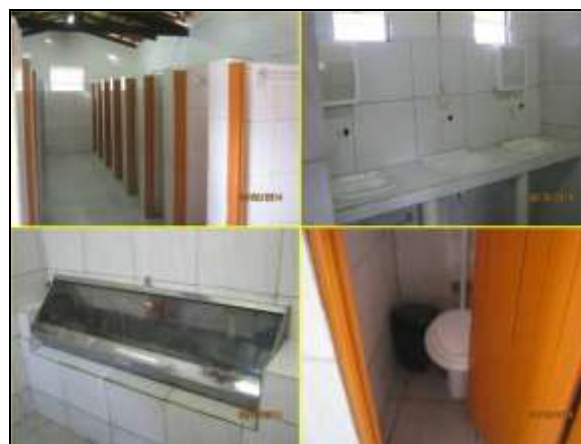
Foto 4.2.302. Visão parcial do banheiro dos alojamentos no canteiro central de obras - Mauriti (maio/2014).
