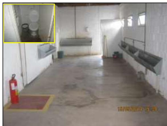
Foto 4.2.360. Banheiro do canteiro de obras em condições adequadas de limpeza e organização (maio/2014).
