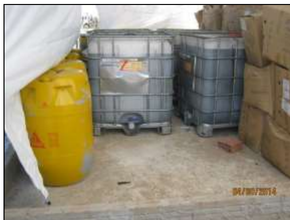
Foto 4.2.453. Acondicionamento de aditivo de concreto de maneira adequada (ago/2014)
