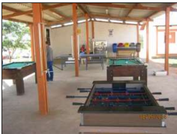
Foto 4.2.291. Área de lazer disponibilizada com TV e mesas de jogos, conforme NR 18, no canteiro central da Meta 2N (maio/2014).
