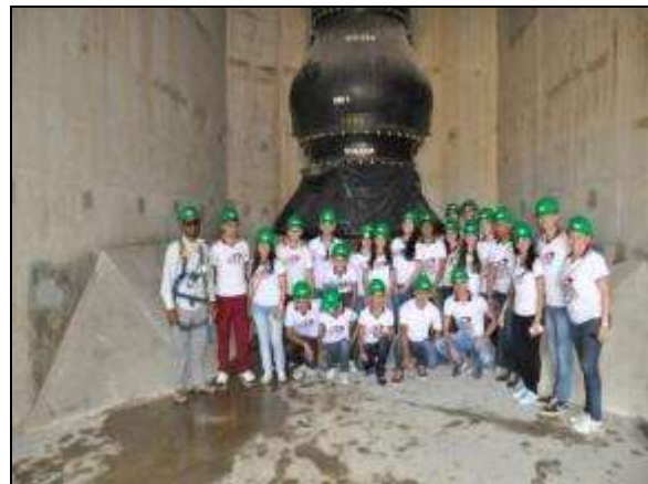
Foto 4.3.65. Alunos da Escola Paulo Freire visitam a estrutura da estação de bombeamento 1 (EBI-1), no Eixo Norte, em Cabrobó - PE (mai/2014).
