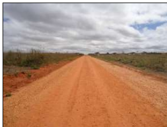
Foto 4.2.774. Via interna com dimensionamento adequado no setor residencial 01 (set/2014).
