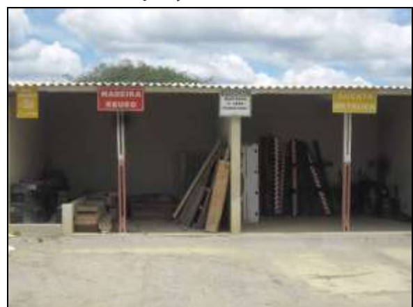
Foto 4.2.507. Resíduos dispostos em baias identificadas no canteiro de obras (set/2014).
