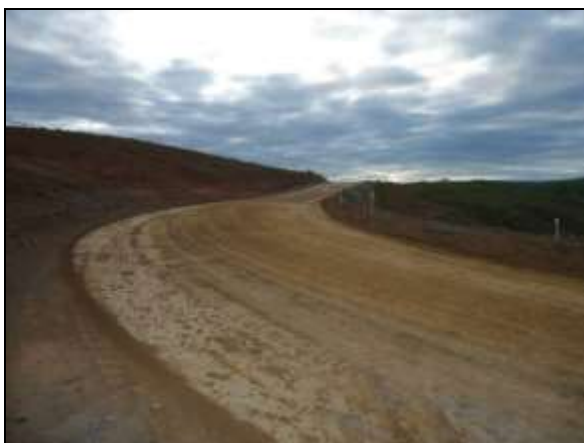
Foto 4.2.137. Via de acesso à frente de serviço do vertedouro Jati - WBS 1111 aplainada (maio/2014).
