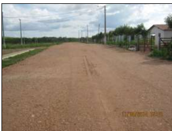
Foto 4.2.760. Via de acesso no interior da VPR com dimensionamento adequado e condições favoráveis à trafegabilidade (abr/2014).
