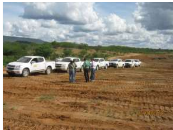
Foto 4.1.10. Vistoria técnica com representantes do IBAMA, MI, UNIVASF e CMT Engenharia na área da jazida WBS 2211-JS-03, trecho V, Eixo Leste (abr/2014).
