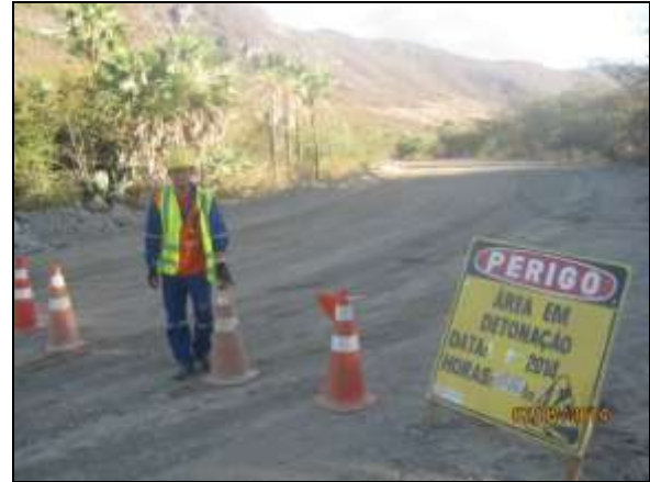
Foto 4.2.332. Barreira formada com distância de segurança para interromper o tráfego na área de desmorte de rocha (jul/2014).
