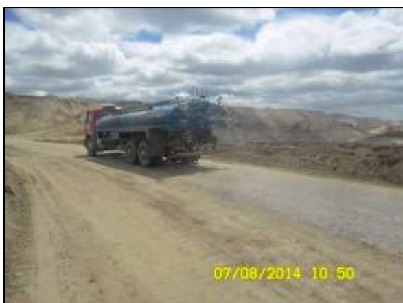
Foto 4.2.512. Umectação de via de acesso no WBS 2226 para controle do material particulado (ago/2014).
