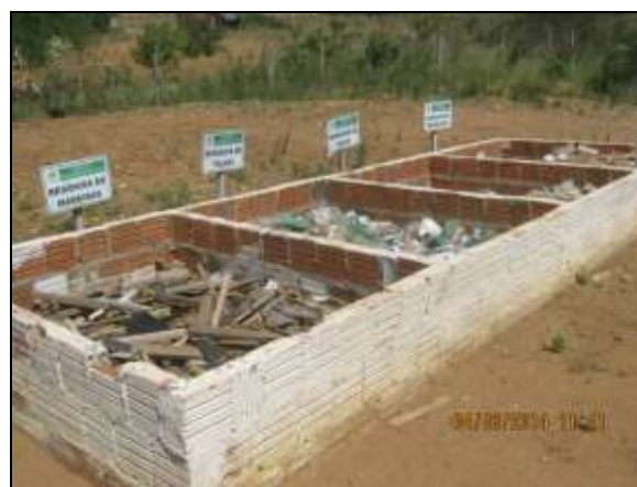
Foto 4.2.681. Baias destinadas ao armazenamento seletivo e temporário dos resíduos sólidos próximas à estrutura de apoio (jun/2014).
