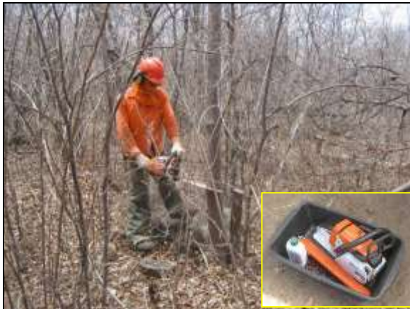
Foto 4.2.850. Bandeja de contenção utilizada no abastecimento de motosserras, durante supressão mecanizada pela equipe da CVR na VPR Quixeramobim (ago/14).
