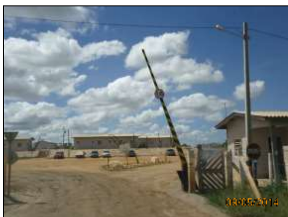
Foto 4.2.92. Guarita com vigilante para controle do acesso de pessoas e veículos ao canteiro de obras de Penaforte – CE (maio/2014).
