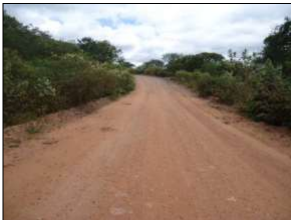
Foto 4.2.567. Via de acesso à frente de serviço da Janela do túnel Cuncas I - WBS 1410 em condições adequadas de conservação (maio/2014).
