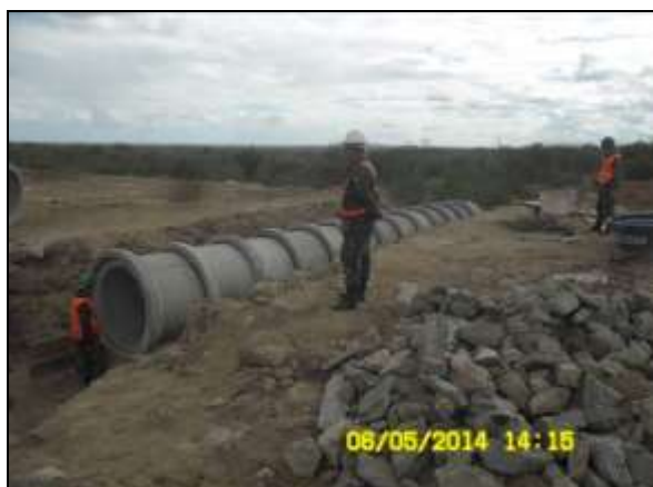
Foto 4.2.391. Disponibilidade e uso dos EPI por colaboradores durante execução das atividades (maio/2014).
