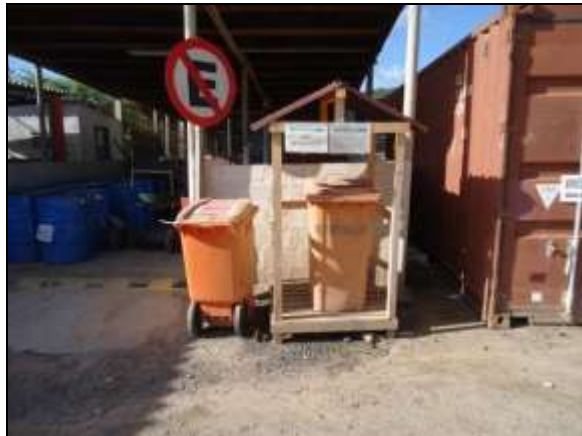
Foto 4.2.641. Kit mitigação com instruções de uso disponível na frente de serviço da janela do túnel Cuncas I (abr/2014).
