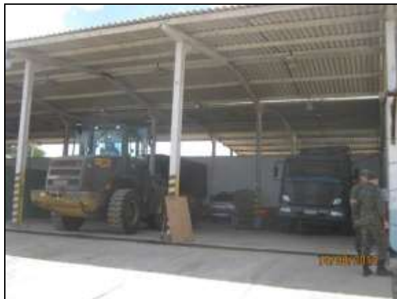
Foto 4.2.402. Oficina mecânica coberta, piso impermeabilizado e canaleta ligada ao sistema de tratamento (ago/2014).
