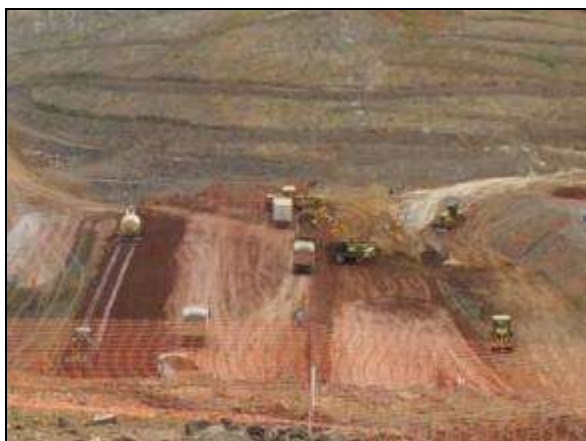
Foto 4.3.86. Construção do reservatório Jati, localizado no município Jati – CE, Meta 2N (abr/2014).
