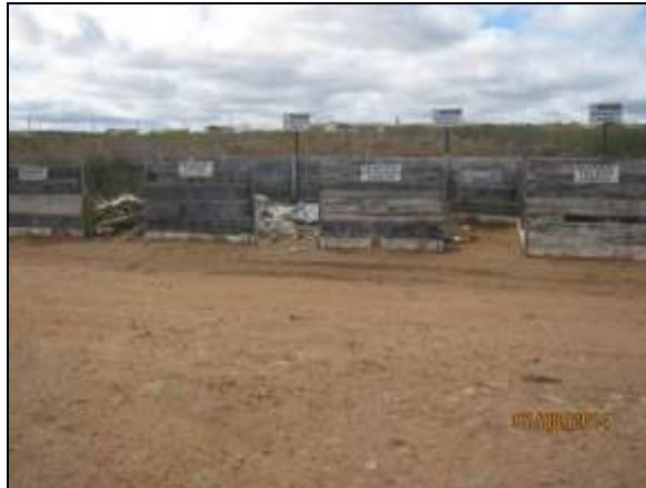
Foto 4.2.819. Baias para armazenamento temporário dos resíduos de construção civil (ago/2014).
