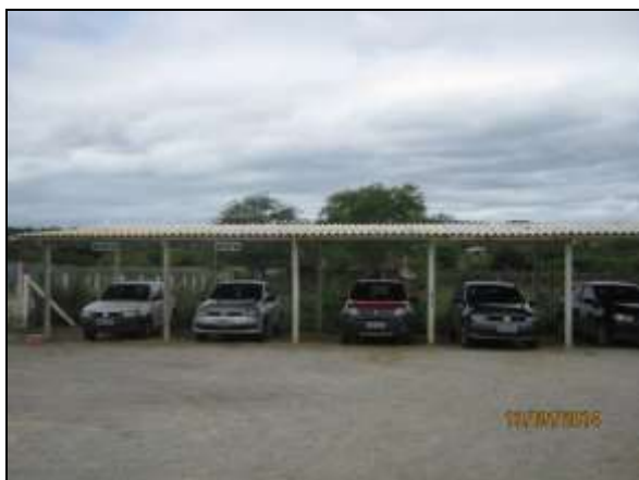
Foto 4.2.490. Disponibilização de estacionamento com cobertura no canteiro de obras (maio/2014).
