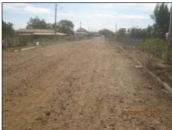
Foto 4.2.683. Via de acesso da VPR em condições favoráveis à trafegabilidade (ago/2014).
