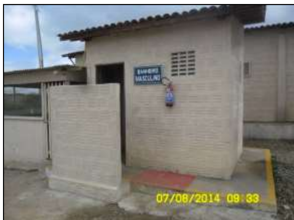
Foto 4.2.536. Instalações sanitárias em condições adequadas de limpeza e com extintor de incêndio (ago/2014).
