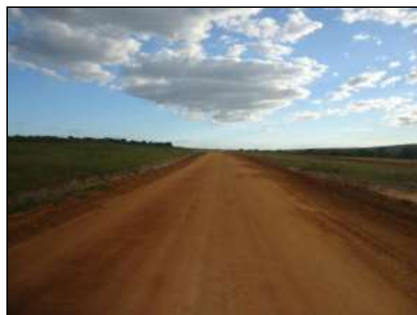
Foto 4.2.233. Via de acesso aplainada no segmento de canal WBS 1233 (jun/2014).
