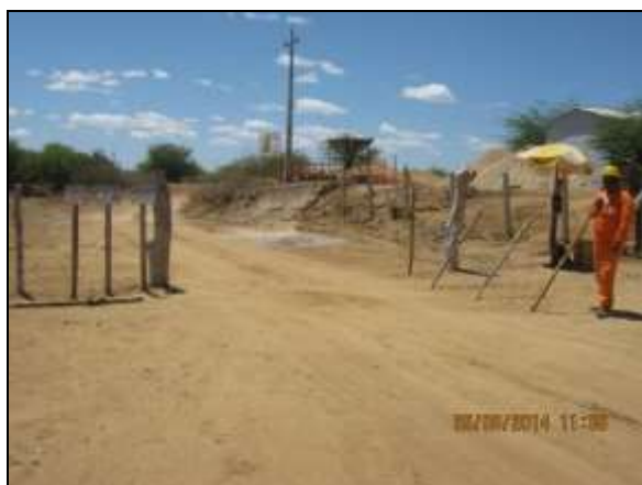
Foto 4.2.839. Guarita para controle de acesso de pessoas e veículos (ago/2014).
