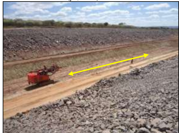
Foto 4.2.334. Área de carregamento de explosivos no segmento de canal WBS 1232 (ago/2014).
