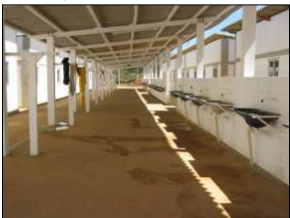
Foto 4.2.186. Área de lavanderia disponibilizada aos colaboradores alojados no canteiro de obras central (ago/2014).
