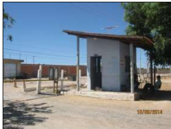
Foto 4.2.580. Guarita de controle de acesso de pessoas e veículos no alojamento/refeitório de Mauriti (set/2014).
