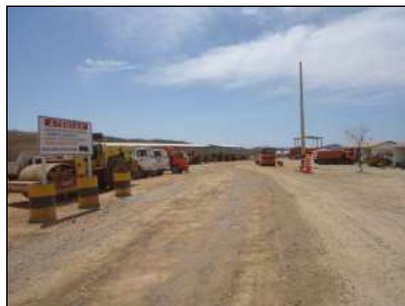
Foto 4.2.235. Via interna do canteiro do antigo lote 7 em boas condições de trafegabilidade (ago/2014).
