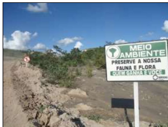
Foto 4.2.142. Placa de proteção ao meio ambiente na frente de serviço do reservatório Porcos – WBS 1113 (maio/2014).
