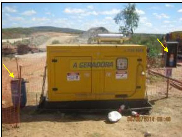
Foto 4.2.123.Gerador sobre bandeja de contenção com disponibilidade de extintor de incêndio e kit mitigação na frente de serviço da ponte WBS 1509 (jun/2014).
