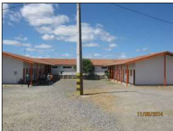
Foto 4.2.303. Visão parcial dos alojamentos dos colaboradores no canteiro central de obras de São José de Piranhas (jun/2014).
