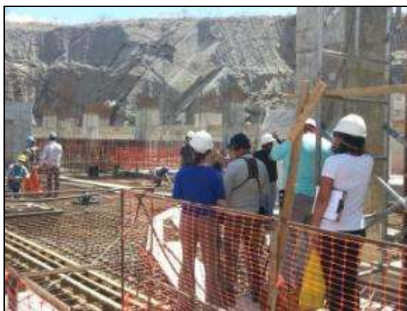
Foto 4.3.78. Equipe grava na Estação de Bombeamento II, em Cabrobó - PE (jul/2014).
