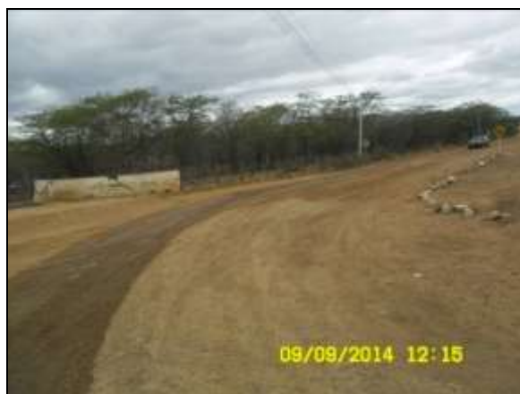
Foto 4.2.513. Umectação das vias de acessos ao canteiro de obras (set/2014).
