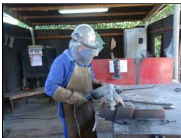
Foto 4.2.598. Colaborador realizando atividade na área da oficina mecânica utilizando adequadamente os EPI na frente de serviço do emboque do túnel Cuncas I - WBS 1410 (jun/2014).
