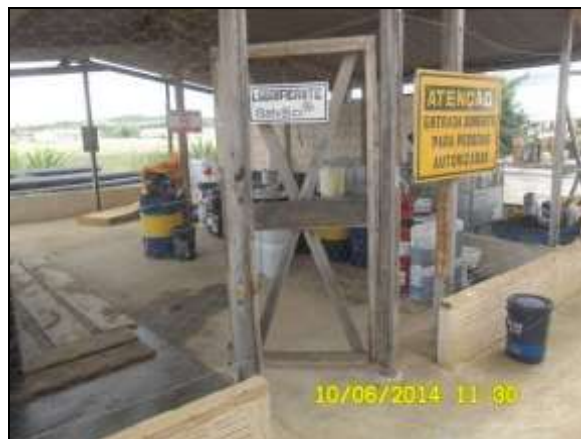
Foto 4.2.556. Lubrificantes acondicionados em local com cobertura, piso impermeável, ventilado e sinalizado (jun/2014).
