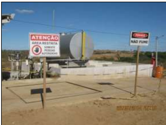
Foto 4.2.95. Placas de sinalização quanto o acesso restrito e cuidado necessário na área do posto de combustível do canteiro de obras de Penaforte – CE (ago/2014).
