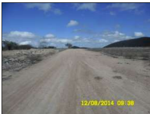
Foto 4.2.469. Via bem dimensionada nas frentes de serviços (ago/2014).
