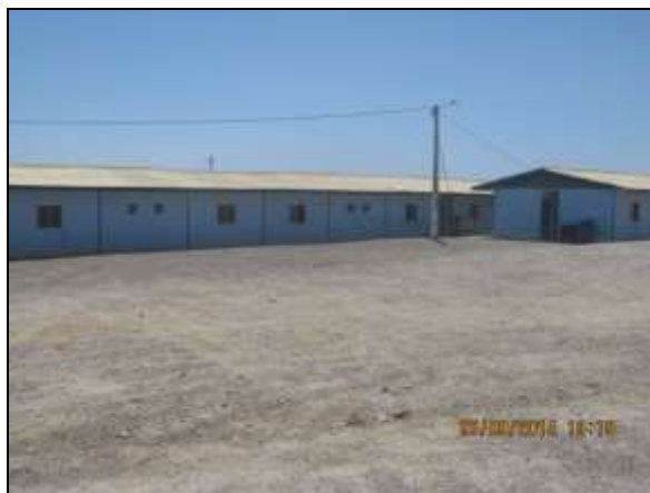
Foto 4.2.18. Vista parcial do alojamento do canteiro de obras em Cabrobó - PE com quartos já desmobilizados (set/2014).
