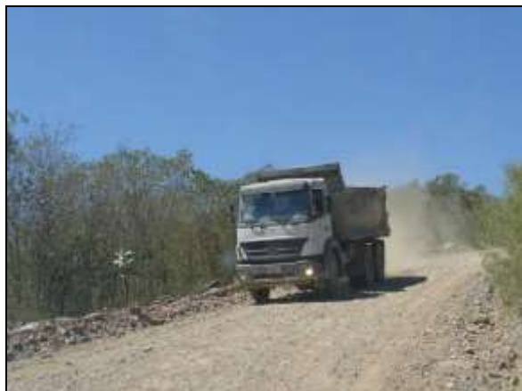
Foto 4.2.623. Caminhão trafegando com os faróis acesos em via de acesso à frente de serviço da janela do túnel Cuncas I – WBS 1410 (jun/2014).
