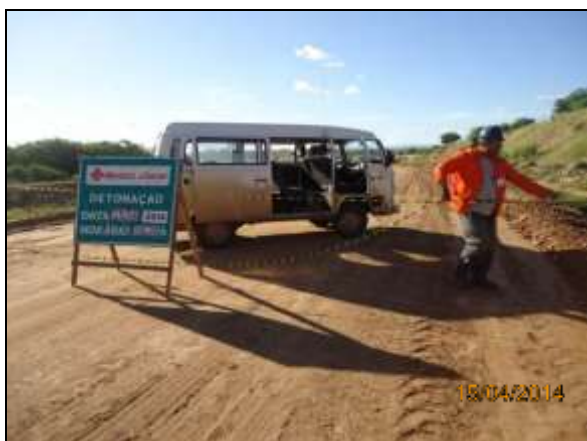
Foto 4.2.133. Colaborador em atividade de sinalização e bloqueio provisório da via de acesso para procedimentos de escavação com explosivos próximo à galeria Milagres – WBS 1365 (abr/2014).
