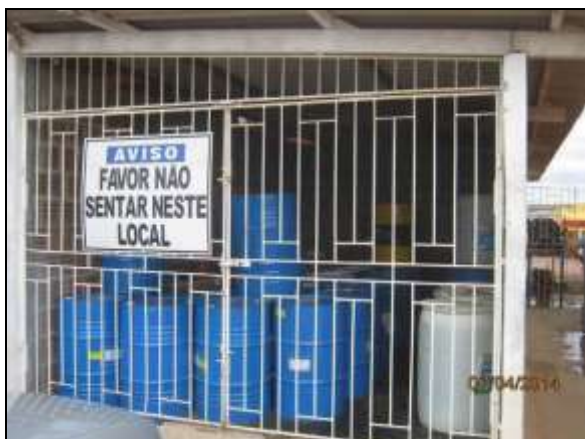
Foto 4.2.450. Acondicionamento de lubrificantes de maneira adequada no canteiro de obras (abr/2014).
