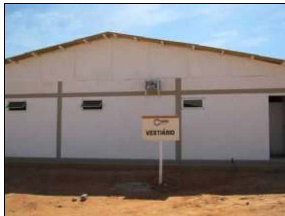
Foto 4.2.191. Vestiário disponibilizado aos colaboradores no canteiro central de obras (ago/2014).
