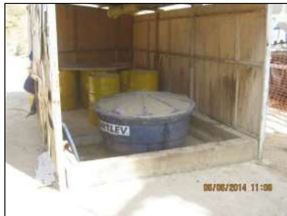
Foto 4.2.28. Local destinado ao armazenamento de aditivos de concreto com piso impermeável e paredes de contenção na central de concreto do WBS 1210 (jun/2014).
