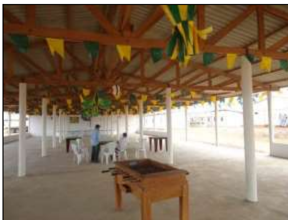
Foto 4.2.185. Área de lazer com TV e mesas de jogos, conforme NR 18, disponibilizada no canteiro de obras central (jul/2014).
