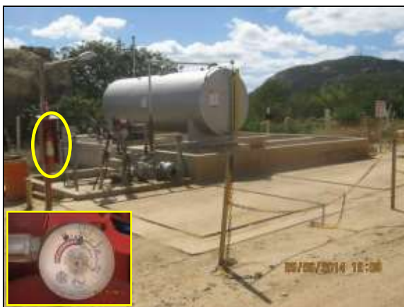
Foto 4.2.103. Extintor de incêndio em estado adequado para uso nas adjacências do posto de combustível do canteiro de obras de Salgueiro - PE (jun/2014).
