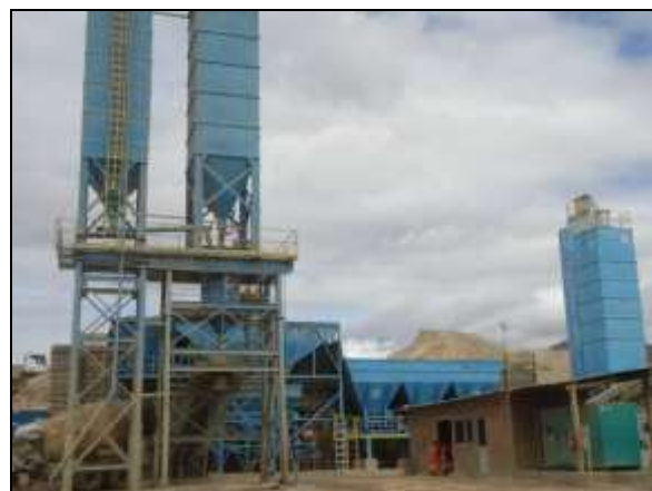
Foto 4.2.211. Central de concreto implantada na área do reservatório Porcos – WBS 1113 (set/2014).
