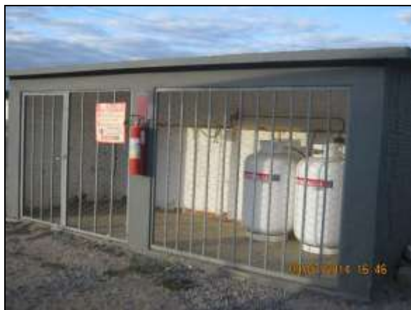
Foto 4.2.357. Baía com armazenamento adequado dos botijões de gás GLP da cozinha do canteiro de obras (jul/2014).
