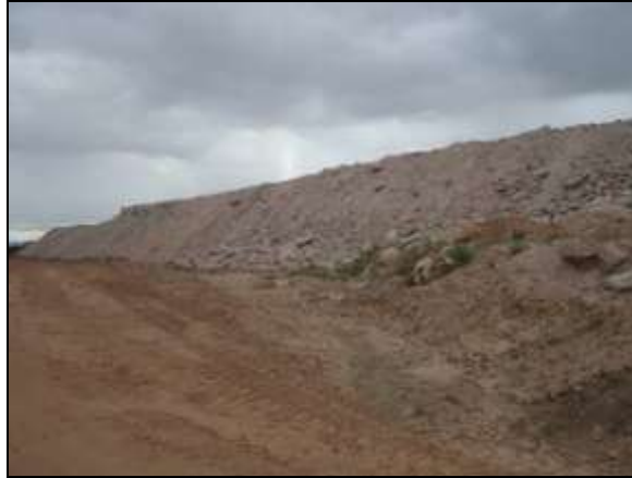
Foto 4.2.227. Bota-fora depositado em área do reservatório Canabrava – WBS 1114 (jul/2014).
