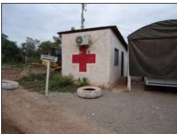
Foto 4.2.585. Vista externa do ambulatório do canteiro de obras central (maio/2014).
