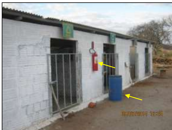
Foto 4.2.378. Vista parcial das baias para armazenamento de resíduos metálicos e Classe I (Perigosos) e disponibilidade de extintor de incêndio e kit mitigação (jul/2014).
