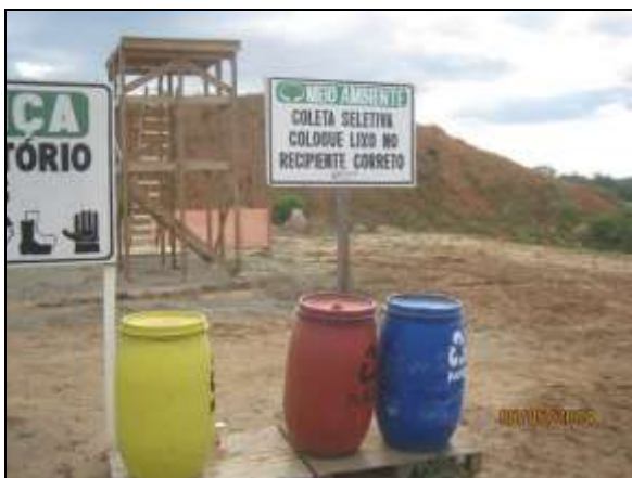
Foto 4.2.328. Coletores seletivos implantados na frente de serviço do aqueduto Catingueira (maio/2014)
