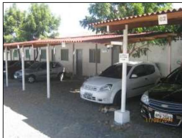
Foto 4.2.636. Estacionamento e alojamentos para os colaboradores da obra, Mauriti - CE (ago/2014).
