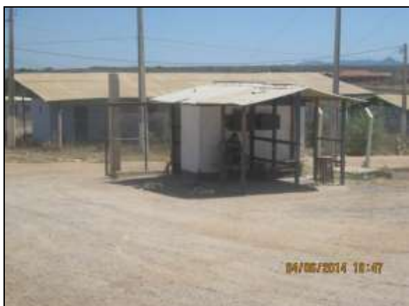
Foto 4.2.3. Guarita com vigilância para controle do acesso de pessoas e veículos ao canteiro de obras de Cabrobó - PE (jun/2014).
