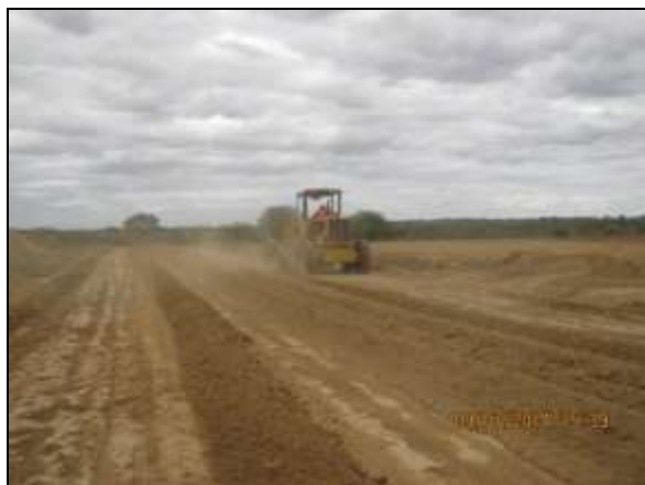
Foto 4.2.836. Abertura de via de acesso no setor residencial (jul/2014).
