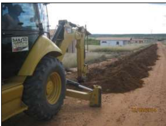
Foto 4.2.800. Manutenção de via de acesso no setor residencial da VPR Descanso (maio/2014).
