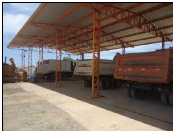
Foto 4.2.308. Oficina mecânica no canteiro central (antigo Lote 07), com canaleta, extintores de incêndio e piso impermeabilizado (ago/2014).
