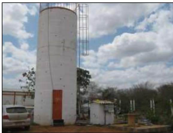
Foto 4.2.282. Armazenamento adequado de água no canteiro central de obras (set/2014).
