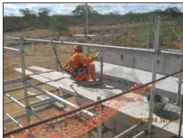
Foto 4.2.104. Colaborador com EPI adequados durante atividade em altura na frente de serviço da Ponte WBS 1508 (ago/2014).
