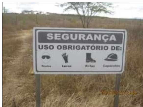
Foto 4.2.748. Placa de segurança referente ao uso obrigatório dos EPI na estrutura de apoio (jul/2014).
