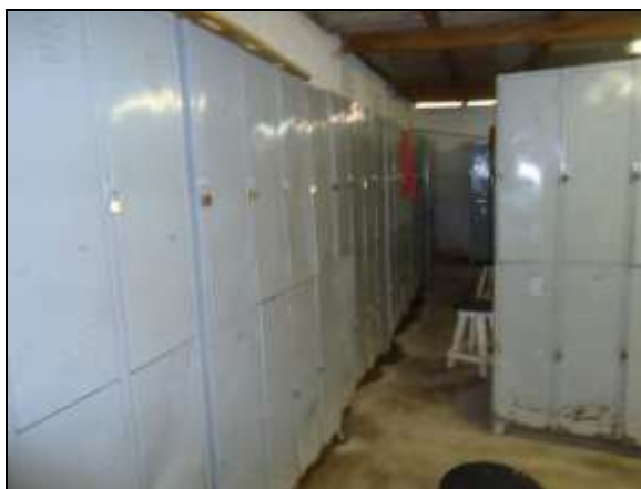
Foto 4.2.632. Vestiário disponível aos colaboradores da frente de serviço da janela do túnel Cuncas I – WBS 1410 (maio/2014).
