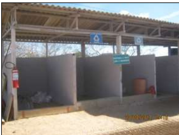
Foto 4.2.131. Baías para armazenamento seletivo e temporário dos resíduos sólidos provenientes do canteiro de obras de Salgueiro – PE (ago/2014).
