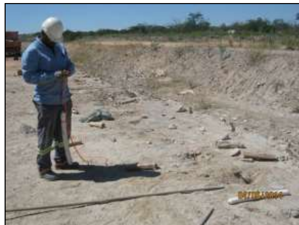
Foto 4.2.463. Atividade de carregamento de explosivos em área do WBS 2208 (jun/2014).
