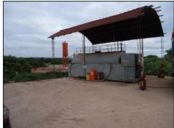
Foto 4.2.642. Posto de combustível coberto, sinalizado e sistema de tratamento de efluentes no canteiro do emboque I (maio/2014).
