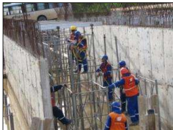
Foto 4.3.89. Construção do Bueiro Palha, localizado no município de Mauriti-CE, Meta 3N (jul/2014).
