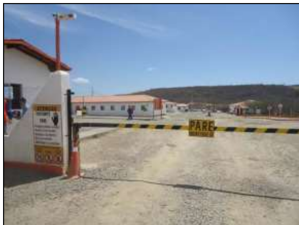
Foto 4.2.242. Guarita de controle de acesso de pessoas e veículos, ao canteiro de obras central do antigo Lote 07 (ago/2014).
