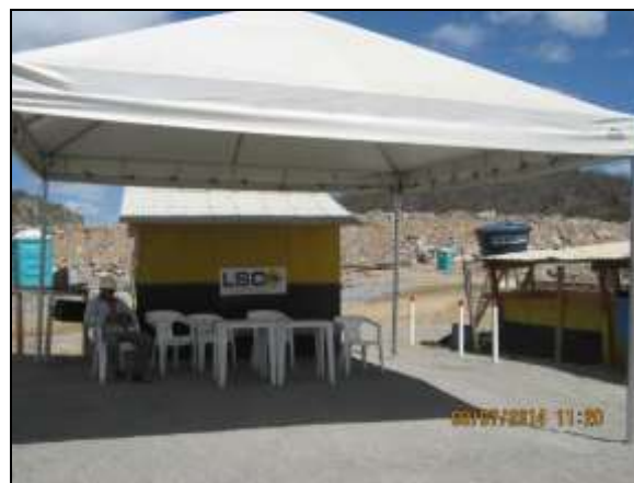
Foto 4.2.366. Tenda de apoio do britador instalado na área de formação do reservatório Negreiros - WBS 1109 (jul/2014).
