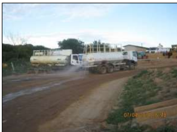
Foto 4.2.89. Umedecção da via de acesso do canteiro de obras de Salgueiro – PE para minimização da emissão de material particulado (abr/2014).
