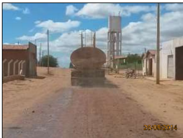
Foto 4.2.90. Umedecção de via de acesso ao Túnel Milagres/Jati – WBS 1403 a qual intercepta a comunidade Montevidéu na divisa entre Salgueiro – PE e Penaforte – CE (ago/2014).
