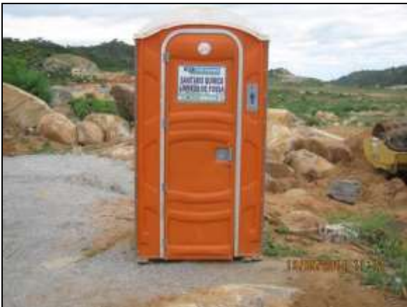
Foto 4.2.117. Banheiro químico instalado próximo à frente de serviço do dique do reservatório Negreiros – WBS 1109 (maio/2014).
