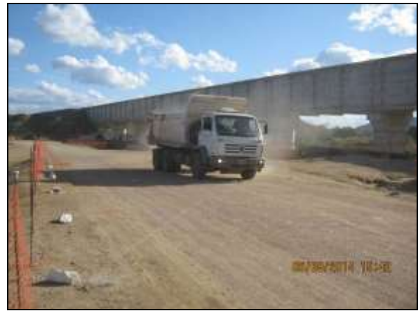
Foto 4.2.13. Caminhão basculante trafegando em via de acesso na frente do aqueduto Mari – WBS 1307 com faróis ligados, conforme código de conduta (ago/2014).
