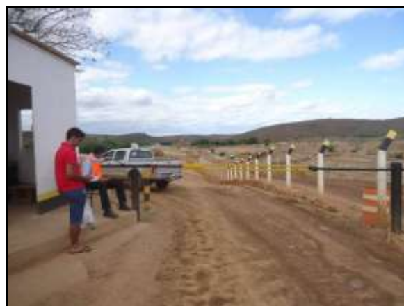
Foto 4.2.146. Guarita de controle de acesso de pessoas e veículos no canteiro de apoio das frentes de serviço do reservatório Jati (set/2014).
