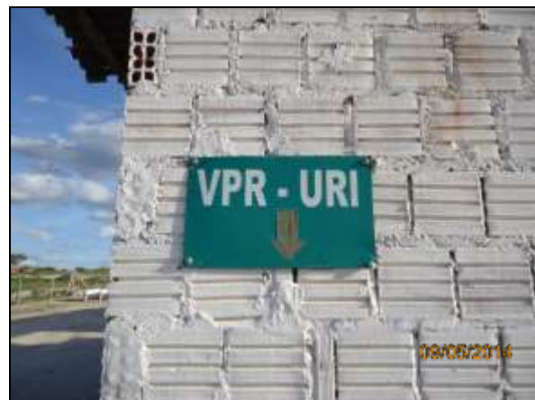
Foto 4.2.715. Placa de identificação da VPR instalada na estrutura de apoio (maio/2014).
