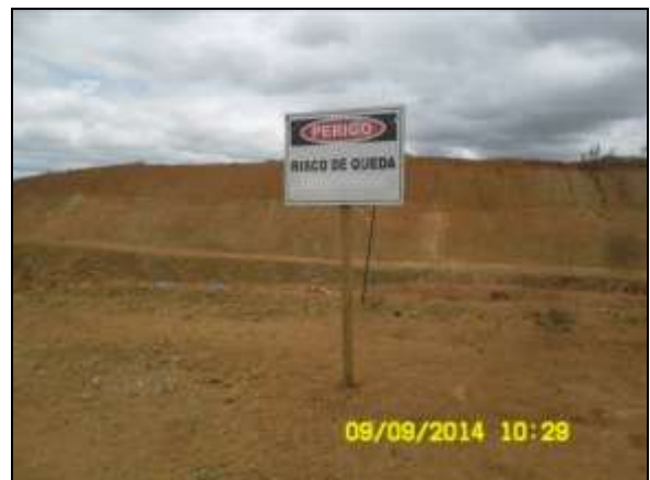
Foto 4.2.527. Sinalização e tela de proteção contra queda (set/2014).
