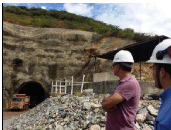
Foto 4.3.73. Técnico de Segurança acompanha visita da Agência de Notícias PT no desemboque do Túnel Cuncas II, em São José de Piranhas - PB (maio/2014).
