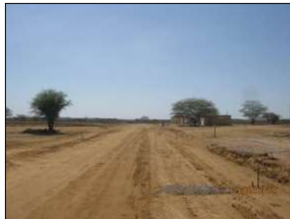
Foto 4.2.837. Via interna com dimensionamento adequado (set/2014).
