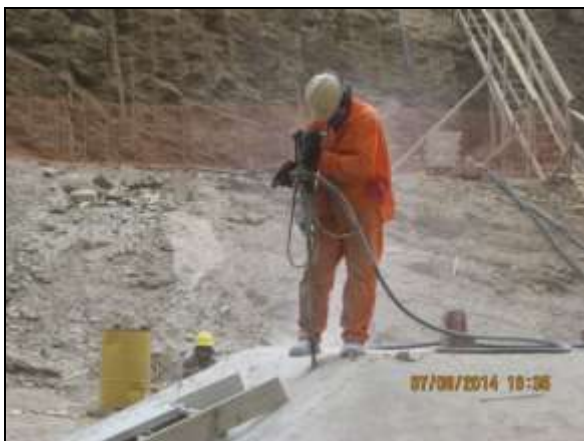
Foto 4.2.349. Colaborador em atividade de perfuração de rocha na frente de serviço da EBI-01 com capacete, protetor auricular, máscara e luvas (ago/2014).
