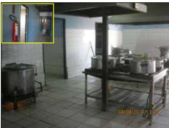
Foto 4.2.21. Cozinha do canteiro de obras de Cabrobó em condições adequadas de limpeza e com extintor de incêndio disponível (ago/2014).
