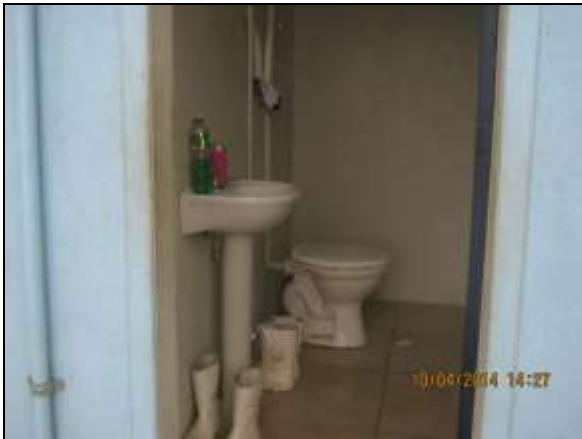
Foto 4.2.59. Banheiro próximo aos refeitórios geral e administrativo do canteiro de obras em estado adequado de limpeza e conservação (abr/2014). Foto 4.2.60.
