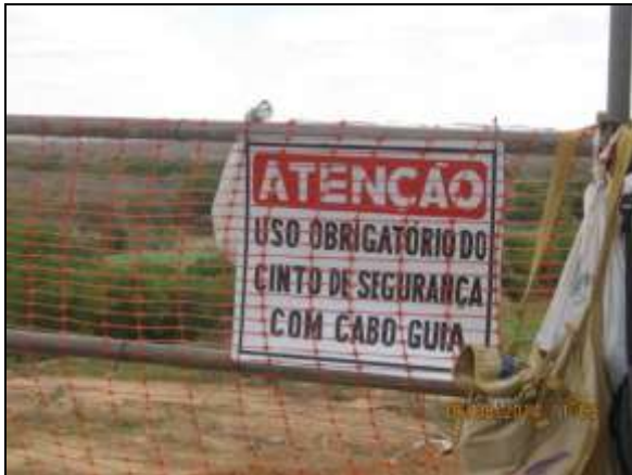
Foto 4.2.43. Placa de sinalização quanto ao uso obrigatório do cinto de segurança com cabo guia durante atividades em altura na frente de serviço do aqueduto Salgueiro – WBS 1309 (ago/2014).
