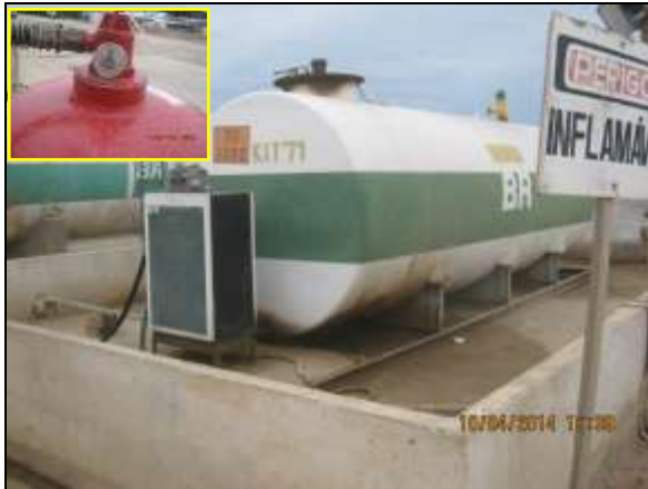
Foto 4.2.51. Extintor de incêndio em condições adequadas de uso próximo ao posto de combustível do segmento de canal WBS 1214 (abr/2014).
