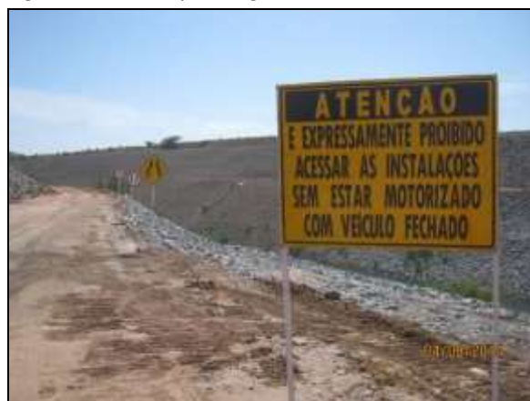
Foto 4.2.420. Manutenção satisfatória da sinalização nas estradas de serviços das Estações de Bombeamento (ago/2014).
