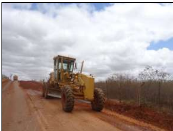
Foto 4.2.140. Manutenção em trecho de estrada vicinal de acesso ao canteiro central e frentes de serviço (set/2014).
