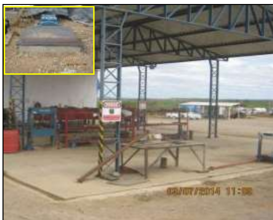
Foto 4.2.67. Oficina mecânica do canteiro de obras com piso impermeável, canaletas de drenagem em todo perímetro associadas ao SAO (jul/2014).
