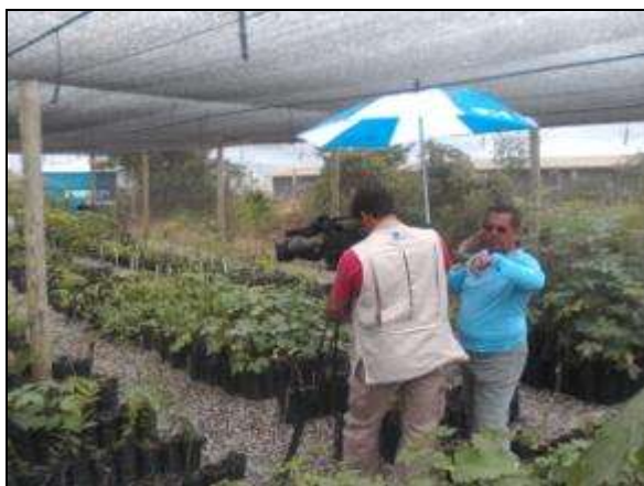
Foto 4.3.71. Equipe da TV Globo Nordeste grava imagens do viveiro de mudas da UNIVASF no canteiro de obras do Lote 08, em Salgueiro - PE (maio/2014).
