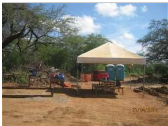
Foto 4.2.544. Estruturas de apoio adequadas ao atendimento dos colaboradores das frentes de serviço (abr/2014).
