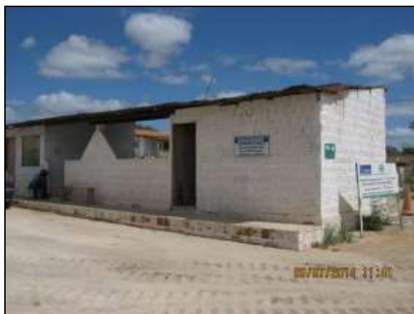
Foto 4.2.724. Vista parcial da estrutura de apoio da VPR (jul/2014).
