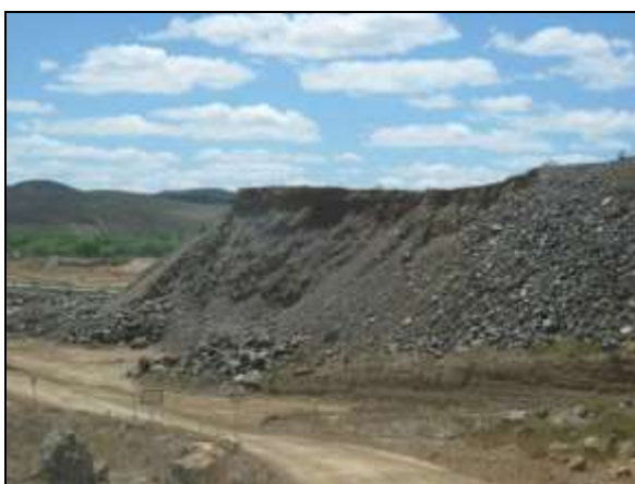
Foto 4.2.224. Bota-espera nº 01 localizado na área da casa de força da barragem Jati – WBS 1111 (ago/2014).
