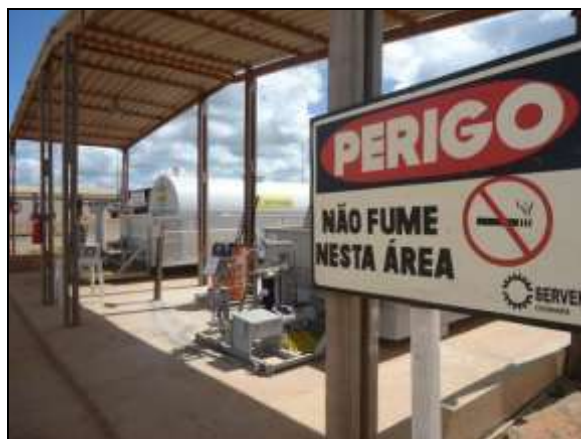
Foto 4.2.195. Posto de abastecimento instalado no canteiro central (maio/2014).
