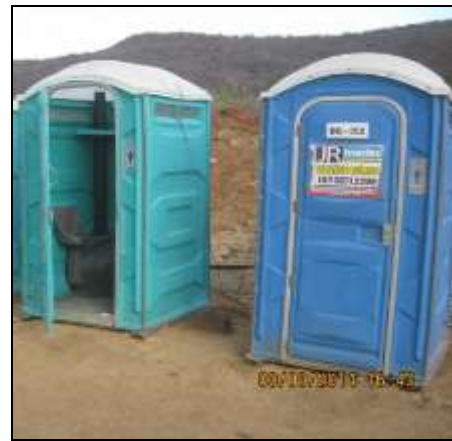
Foto 4.2.72. Banheiros químicos disponíveis próximos à frente de serviço da estrutura de controle do reservatório Serra do Livramento - WBS 1107 (set/2014).
