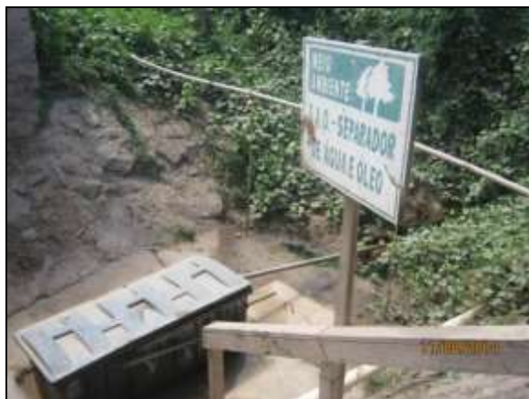
Foto 4.2.643. Sistema de tratamento de efluentes para atendimento do setor de Lava-Jato implantado na frente de serviço do emboque do túnel Cuncas I (ago/2014).
