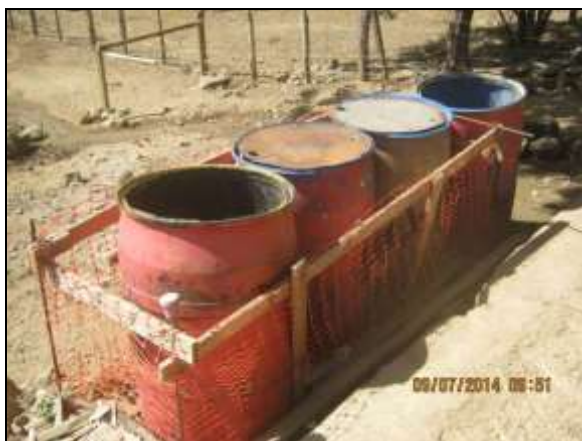
Foto 4.2.84. Coletores de resíduos disponíveis na estrutura de apoio do aqueduto Salgueiro - WBS 1309 (jul/2014).
