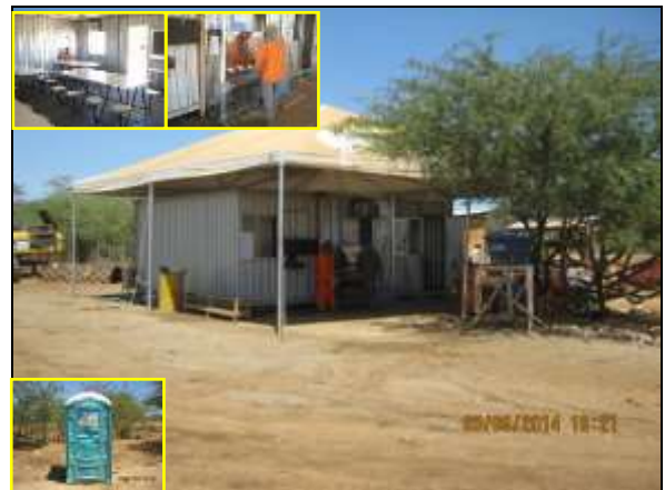
Foto 4.2.120. Estrutura de apoio da frente de serviço da tomada d' água do reservatório Terra Nova – WBS 1106 com refeitório, bebedouro, lavatório e banheiro químico (set/2014).
