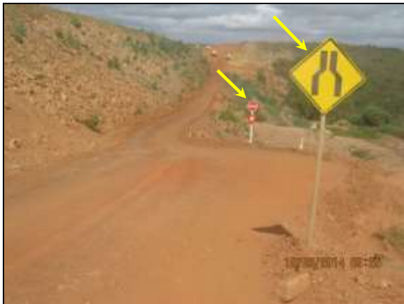
Foto 4.2.93. Placas de sinalização quanto ao estreitamento, parada obrigatória e de preferencial às margens da via de acesso do segmento de canal WBS 1219 (jun/2014).
