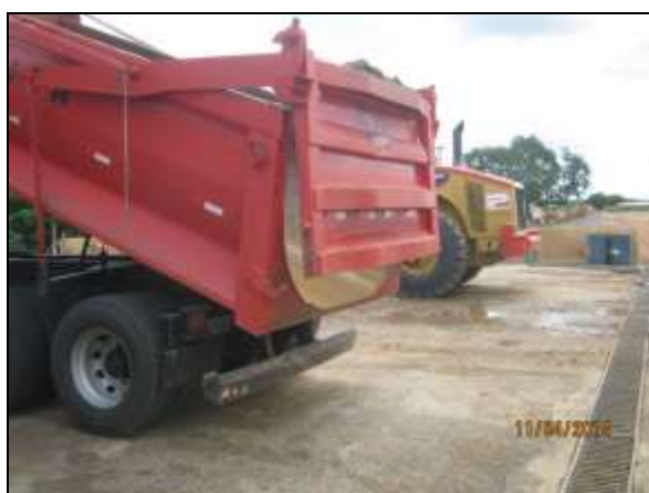
Foto 4.2.550. Canaleta na entrada do lava-jato em bom estado de conservação (abr/2014).
