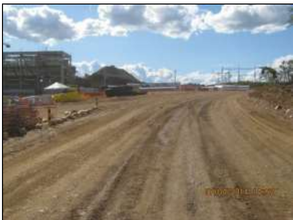
Foto 4.2.335. Via de acesso às frentes de serviço e canteiro de apoio da EBI-01 devidamente umectada e em estado adequado de conservação e manutenção (abr/2014).
