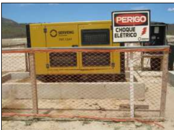
Foto 4.2.216. Gerador implantado em área sinalizada, extintor de incêndio e bacia de contenção na frente de serviço do vertedouro da barragem Porcos (ago/2014).
