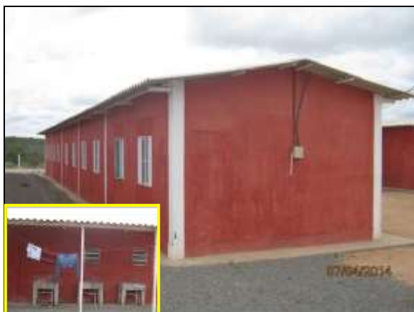
Foto 4.2.430. Alojamentos disponíveis com manutenção adequada em suas estruturas (abr/2014).
