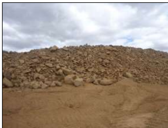
Foto 4.2.225. Bota-fora localizado na área do reservatório Jati – WBS 1111 (set/2014).
