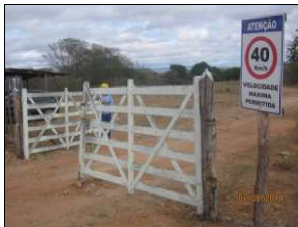
Foto 4.2.814. Guarita para controle de acesso de pessoas e veículos (ago/2014).
