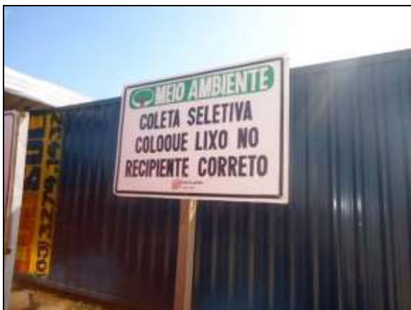
Foto 4.2.236. Placa de incentivo a coleta seletiva implantada na frente de serviço do aqueduto Catingueira (abr/2014).
