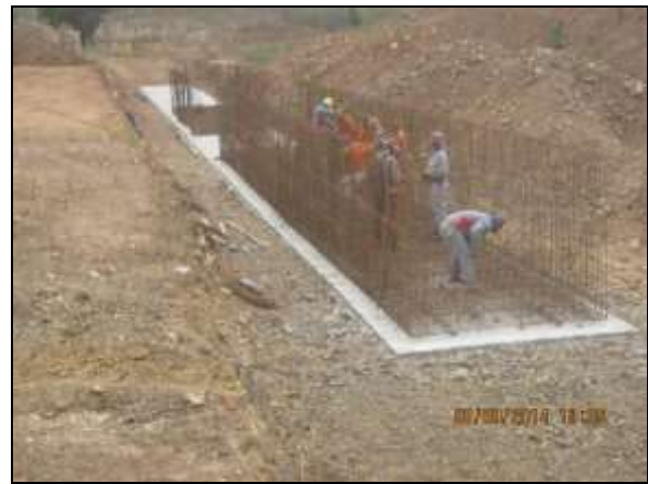
Foto 4.2.136. Atividades de implantação do bueiro 14 no segmento de canal WBS 1224 (set/2014).
