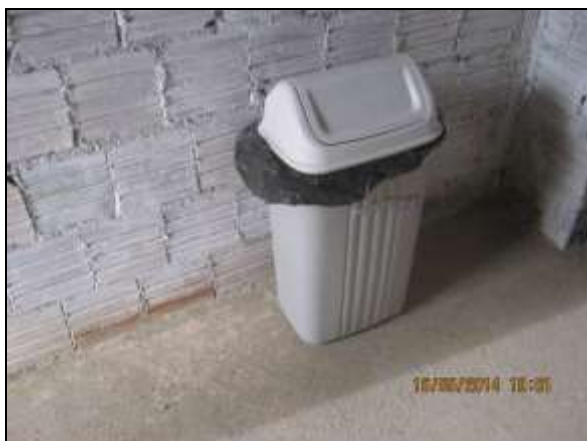
Foto 4.2.694. Disponibilidade de coletor de resíduos sólidos na estrutura de apoio (maio/2014).
