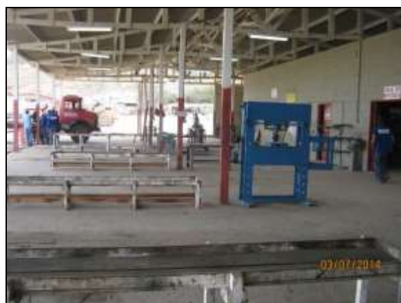
Foto 4.2.495. Oficina mecânica coberta, piso impermeabilizado e canaleta ligada ao SÁO (jul/2014).
