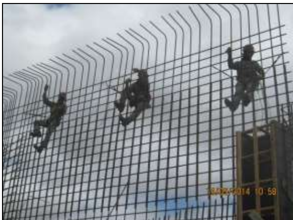
Foto 4.2.347. Colaboradores com EPI adequados à atividade de armação em altura na frente de serviço do deságue da EBI-02 (maio/2014).
