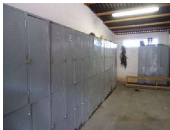
Foto 4.2.634. Armários, no vestiário, disponíveis aos colaboradores da frente de obra do emboque do túnel Cuncas I (jul/2014).
