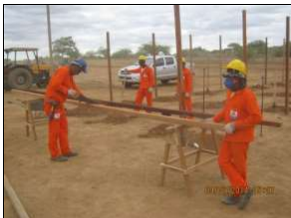
Foto 4.2.843. Colaboradores utilizando EPI em atividade de carpintaria (jul/2014).
