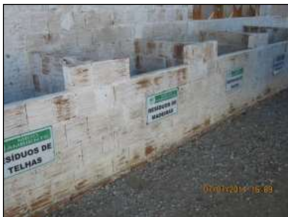
Foto 4.2.695. Baixas para armazenamento seletivo e temporário dos resíduos sólidos (jul/2014).
