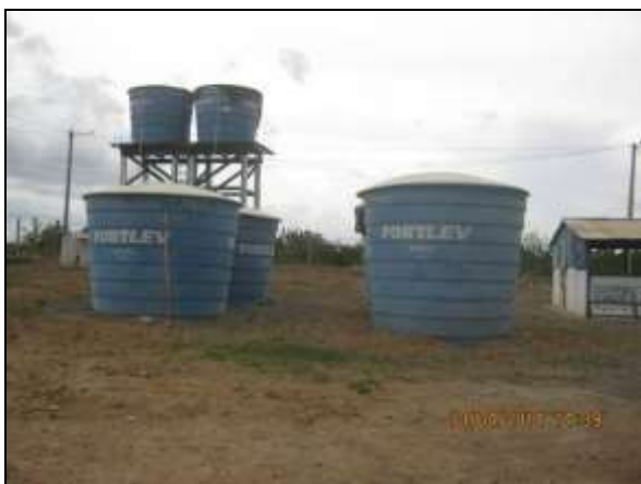
Foto 4.2.57. Reservatórios para armazenamento de água fornecida pela COMPESA e abastecimento do canteiro de obras (abr/2014).
