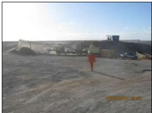
Foto 4.2.384. Britador em atividade de beneficiamento do material de 3ª categoria disposto em bota-espere na área de formação do reservatório Serra do Livramento – WBS 1107 (jul/2014).
