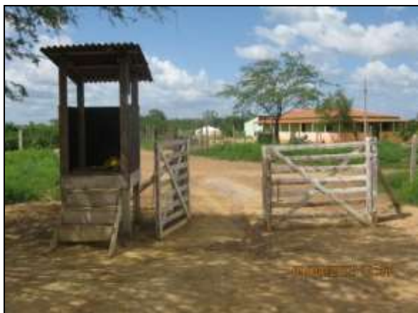
Foto 4.2.745. Guarita e portão para controle do acesso de pessoas e veículos na estrutura de apoio e núcleo habitacional (abr/2014).
