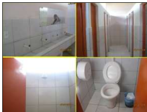
Foto 4.2.304. Visão parcial do banheiro dos alojamentos no canteiro central de obras – São José de Piranhas (jul/2014).
