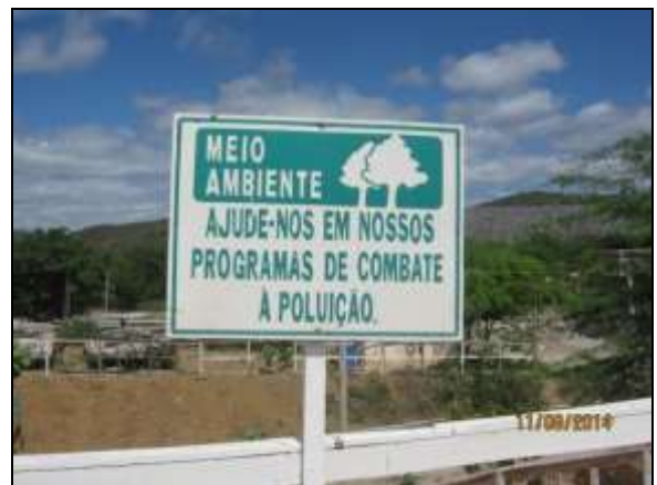
Foto 4.2.573.Sinalização de conduta socioambiental na frente de serviço da Janela do túnel Cuncas I (ago/2014).
