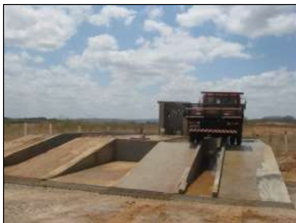
Foto 4.2.307. Lava-jato implantado no canteiro central do antigo Lote 07 (jul/2014).
