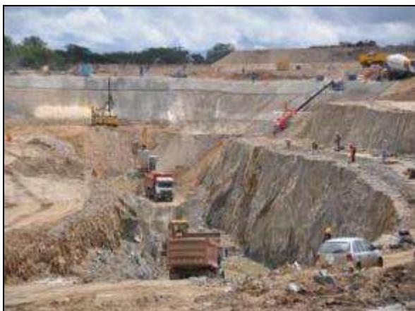
Foto 4.3.94. Emboque do túnel Monteiro, Sertânia - PE, Meta 3L (jun/2014).
