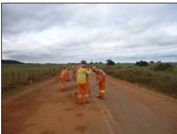
Foto 4.2.139. Manutenção em trechos da estrada vicinal de acesso ao canteiro central e frentes de serviço (jul/2014).
