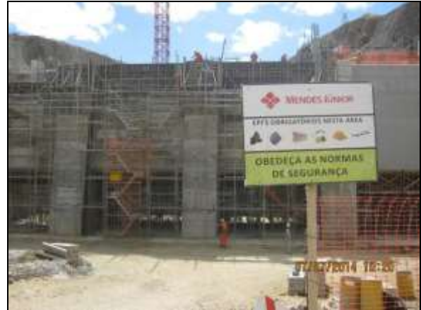
Foto 4.2.340. Placa de segurança quanto à necessidade de uso obrigatório dos EPI na área de serviço da EBI-02 (jul/2014).
