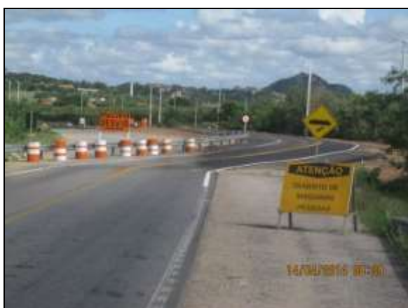
Foto 4.2.91. Sinalização referente ao trânsito de máquinas pesadas e ao desvio provisório construído para atendimento da interferência EN-I-090-RNE na Rodovia Federal BR-232 (abr/2014).
