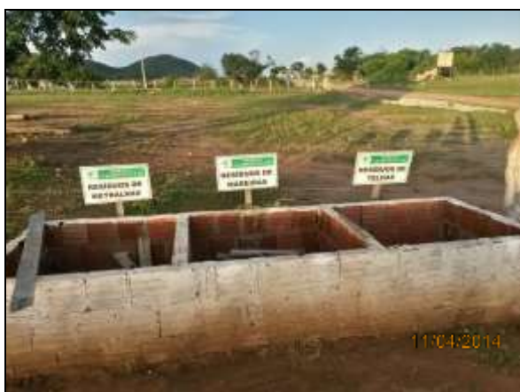
Foto 4.2.710. Baías para armazenamento seletivo e temporário de resíduos sólidos próximas à estrutura de apoio da VPR (abr/2014).
