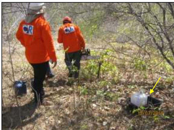
Foto 4.2.852. Bandeja de contenção utilizada no abastecimento de motosserras, durante supressão mecanizada pela equipe da CVR na VPR Ipê (jul/14)
