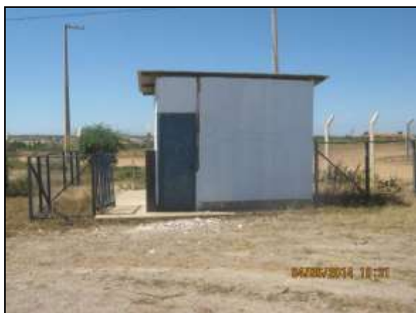
Foto 4.2.36. Baia para armazenamento temporário de resíduos sólidos provenientes do refeitório e alojamento do canteiro de obras, Cabrobó – PE (jun/2014).
