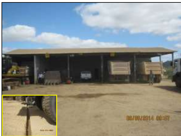
Foto 4.2.115. Oficina mecânica para manutenção dos veículos da empresa construtora com piso impermeável e canaletas de drenagem em todo perímetro (jul/2014).
