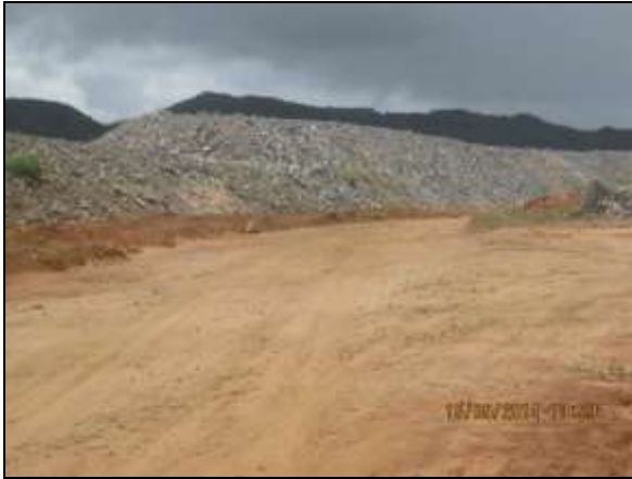
Foto 4.2.87. Disposição de material de 3ª categoria em bota-fora situado às margens do segmento de canal WBS 1216 (maio/2014).
