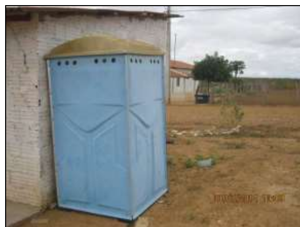
Foto 4.2.709. Banheiro químico móvel disponibilizado nas proximidades da estrutura de apoio (jul/2014).
