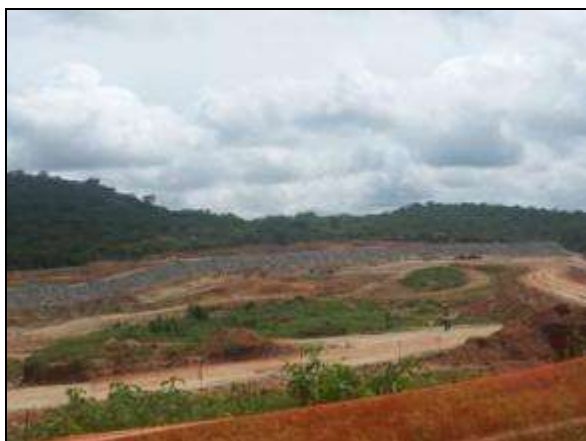
Foto 4.3.88. Construção do reservatório Caiçara, localizado no município de São José de Piranhas – PB, Meta 3N (abr/2014).
