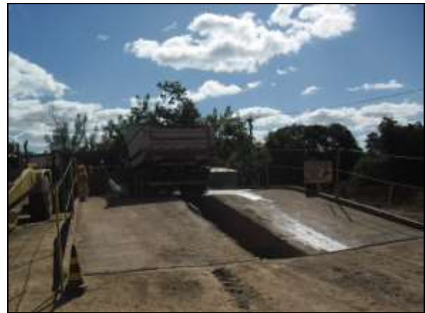
Foto 4.2.201. Dique de lavagem e lubrificação implantado no canteiro de apoio de Jati (set/2014).
