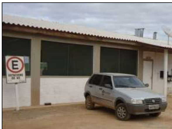
Foto 4.2.178. Placa informativa de conduta do colaborador no canteiro de apoio de jati (maio/2014).
