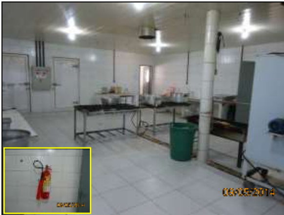
Foto 4.2.109. Cozinha do canteiro de obras de Penaforte – CE em estado adequado de limpeza, organização e com extintor de incêndio (maio/2014).
