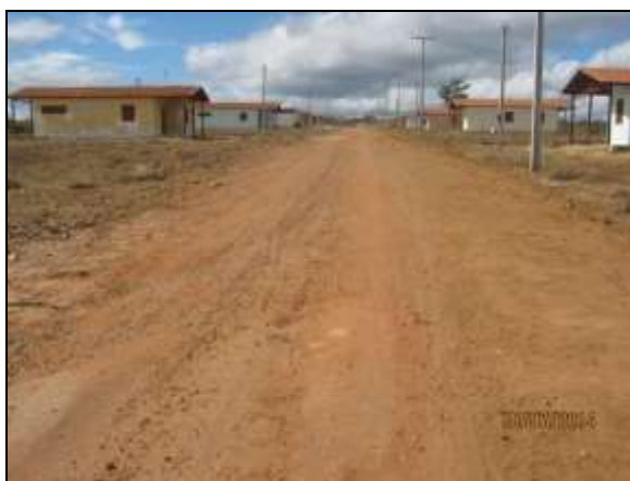
Foto 4.2.801. Via interna com dimensionamento adequado (jul/2014).
