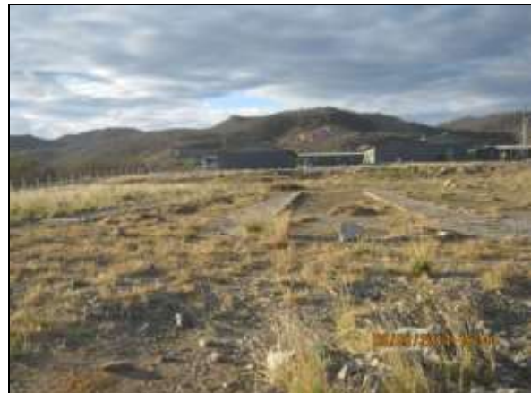
Foto 4.2.382. Vista da área da ETE do canteiro de obras composta por fossa séptica seguido de valas de infiltração (set/2014).
