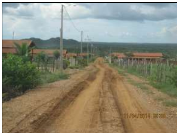
Foto 4.2.712. Via interna da VPR com dimensionamento adequado e em condições favoráveis à trafegabilidade (abr/2014).
