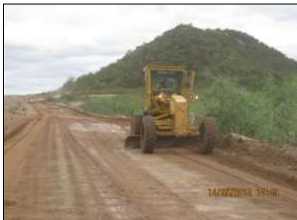
Foto 4.2.39. Motoniveladora em atividade de reconformação topográfica da via de acesso do segmento de canal WBS 1213 (maio/2014).
