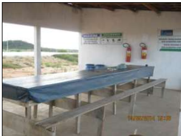
Foto 4.2.738. Refeitório da estrutura de apoio em condições adequadas de limpeza e organização (maio/2014).
