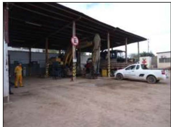
Foto 4.2.644. Oficina mecânica coberta e piso impermeabilizado na frente de serviço da janela do túnel Cuncas I (ago/2014).
