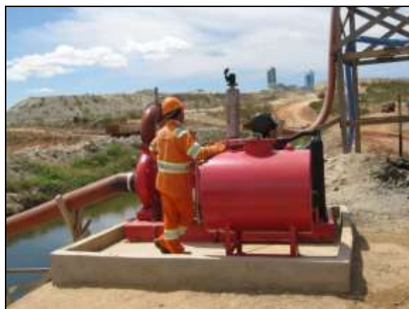
Foto 4.2.217. Motobomba com bacia de contenção na frente de serviço do reservatório Porcos - WBS 1113 (ago/2014).
