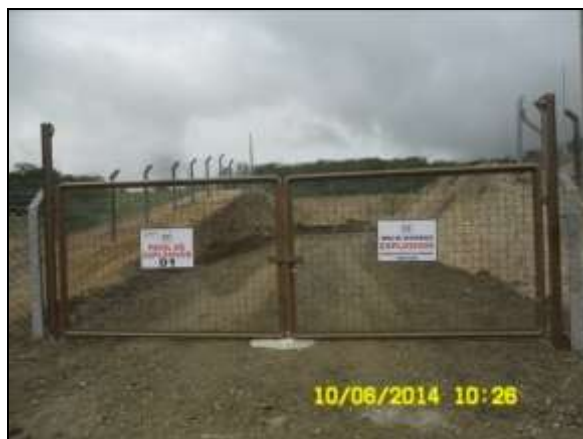
Foto 4.2.563. Entrada do Paiol com grades, telas de proteção e placas de advertência (jun/2014).
