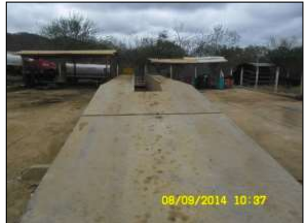
Foto 4.2.497. Lava-jato com piso impermeabilizado, mureta para contenção dos efluentes e canaletas ligadas ao SAO (set/2014).
