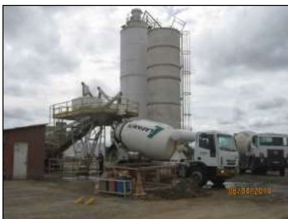
Foto 4.2.436. Central de concreto com manutenção adequada em suas estruturas (abr/2014).
