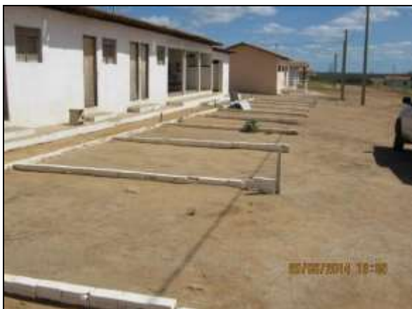
Foto 4.2.739. Disponibilidade de estacionamento na frente da estrutura de apoio (jun/2014).
