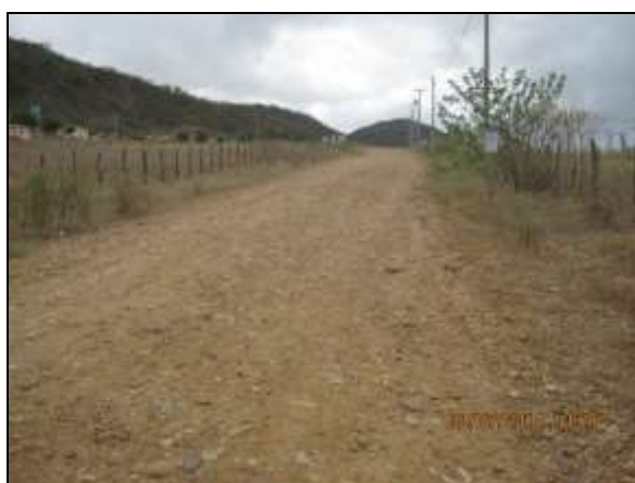
Foto 4.2.697. Via interna da VPR em estado adequado para trafegabilidade (jul/2014).
