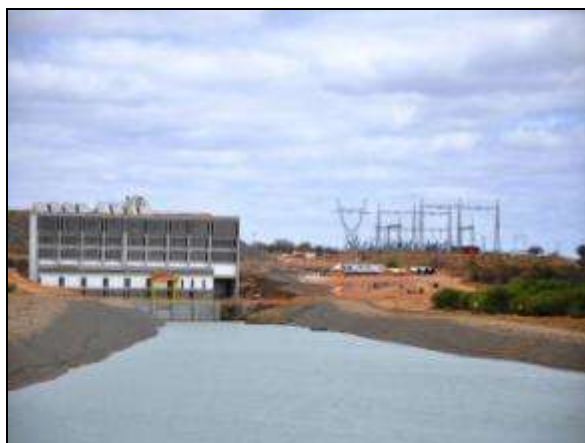
Foto 4.3.81. Estação de bombeamento EBI-1, localizada no município de Cabrobó - PE, Lote 8 (Set/2014).
