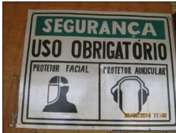
Foto 4.2.56. Placa de segurança quanto ao uso obrigatório de protetor facial e protetor auricular na carpintaria da frente de serviço do vertedouro do reservatório Mangueira – WBS 1109 (ago/2014).
