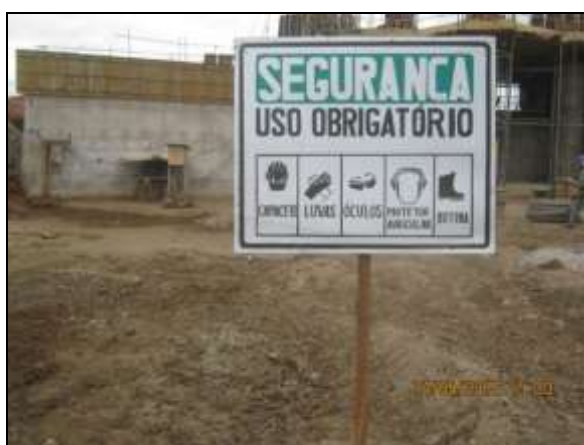
Foto 4.2.42. Placa de sinalização quanto à obrigatoriedade do uso de EPI na frente de serviço da
