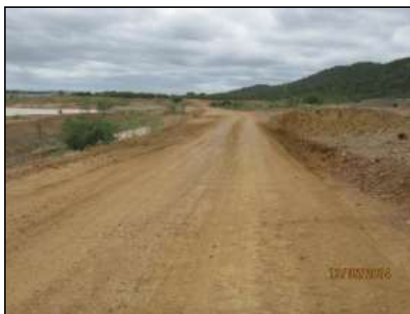
Foto 4.2.467. Condições adequadas de trafegabilidade em via de acesso do WBS 2213 (maio/2014).
