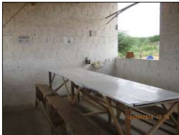
Foto 4.2.676. Local de refeição dos colaboradores com mesa e assentos na estrutura de apoio da VPR (maio/2014).
