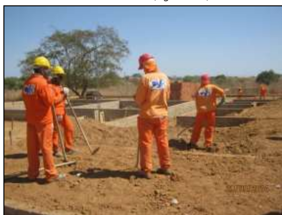
Foto 4.2.845. Colaboradores utilizando EPI adequados à atividade de construção civil (set/2014).
