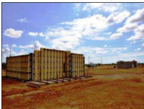
Foto 4.3.85. Construção do setor residencial na VPR Retiro, localizada no município de Penaforte - CE (set/2014).
