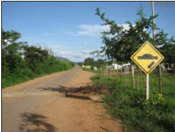
Foto 4.2.153. Sinalização de lombada próxima ao adensamento populacional no acesso ao canteiro central (abr/2014).
