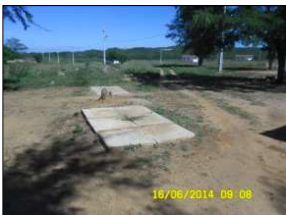
Foto 4.2.833. Sistema de tratamento dos efluentes domésticos oriundos da estrutura de apoio (jun/2014).
