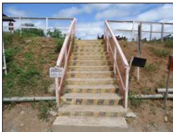
Foto 4.2.600. Escada com corrimão implantada em área de talude na janela do túnel Cuncas I - WBS 1410 (jun/2014).
