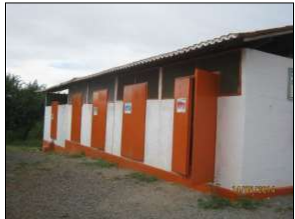
Foto 4.2.327. Baia para o armazenamento temporário de resíduos sólidos no canteiro de obras do antigo Lote 07 (maio/2014).
