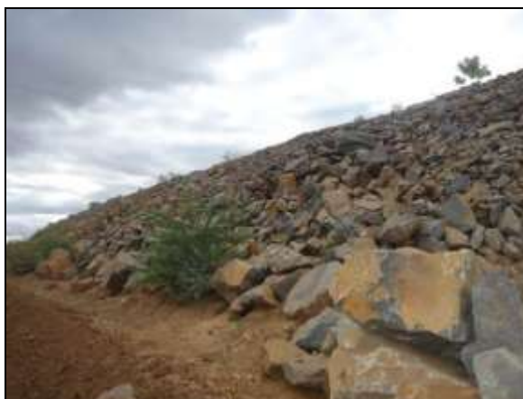
Foto 4.2.231. Bota-fora depositado à margem esquerda da faixa de domínio do segmento de canal – WBS 1225 (set/2014).
