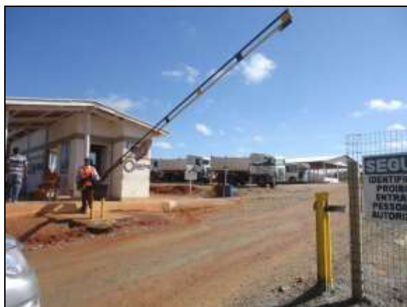
Foto 4.2.141. Guarita de controle de acesso de pessoas e veículos no canteiro de obras central (maio/2014).
