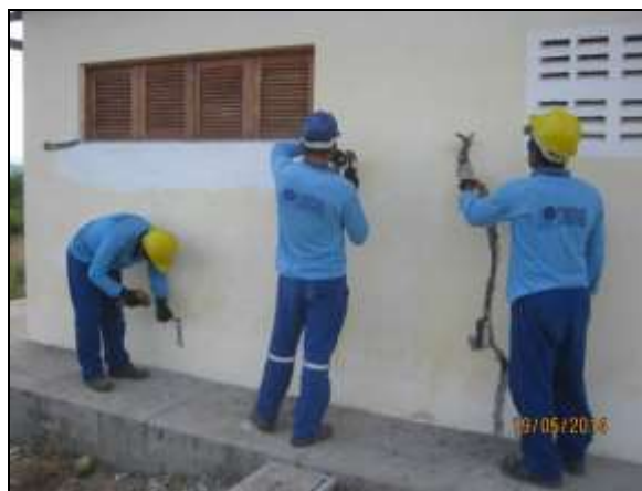
Foto 4.2.807. Colaboradores com EPI corretos para atividade de manutenção das residências (maio/2014).
