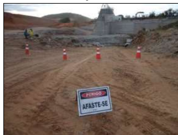
Foto 4.2.221. Área de carregamento de explosivos isolada e sinalizada no vertedouro da Barragem Porcos – WBS 1113 (set/2014).
