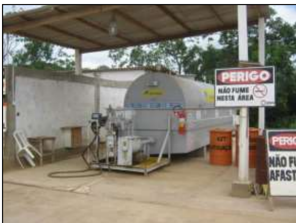
Foto 4.2.194. Posto de abastecimento instalado na frente de serviço do reservatório Jati - WBS 1111 (abr/2014).
