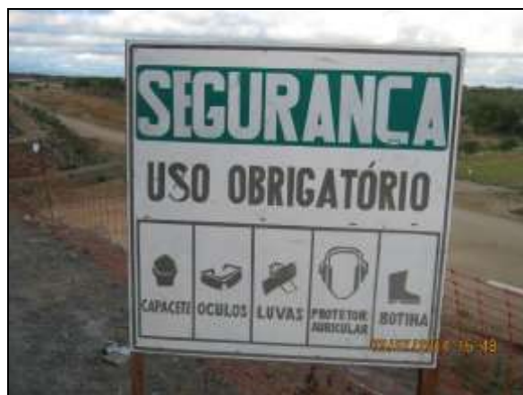
Foto 4.2.4. Placa de segurança referente ao uso obrigatório de equipamentos de proteção individual obrigatórios na frente de serviço do aqueduto Saco da Serra - WBS 1306 (jul/2014).
