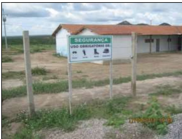
Foto 4.2.714. Placa de segurança quanto ao uso obrigatório de EPI instalada na área da estrutura de apoio da VPR (abr/2014).
