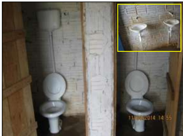
Foto 4.2.769. Banheiro da estrutura de apoio com gabinetes sanitários e lavabos em condições adequadas de limpeza e organização (abr/2014).
