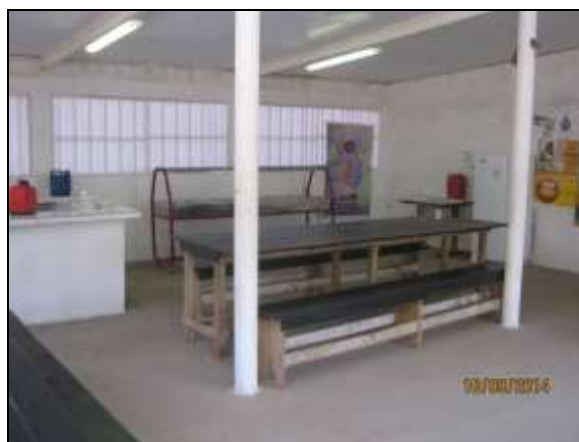
Foto 4.2.631. Refeitório da frente de serviço do emboque do túnel Cuncas I (set/2014).
