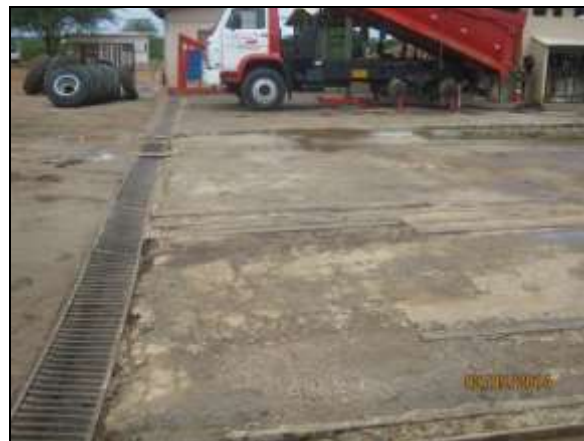
Foto 4.2.541. Lava-jato com manutenção adequada em suas estruturas (maio/2013).
