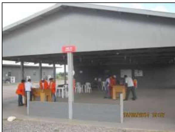
Foto 4.2.355. Área de vivência disponibilizada para recreação e entretenimento dos colaboradores do canteiro de obras (maio/2014).
