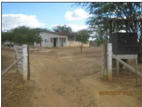
Foto 4.2.754. Estrutura de apoio com guarita, almoxarifado, refeitório, estacionamento para veículos, lavatórios e instalações sanitárias (jul/2014).
