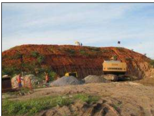
Foto 4.3.90. Construção do Aqueduto Catingueira, localizado no município de Mauriti-CE, Meta 3N (abr/2014).
