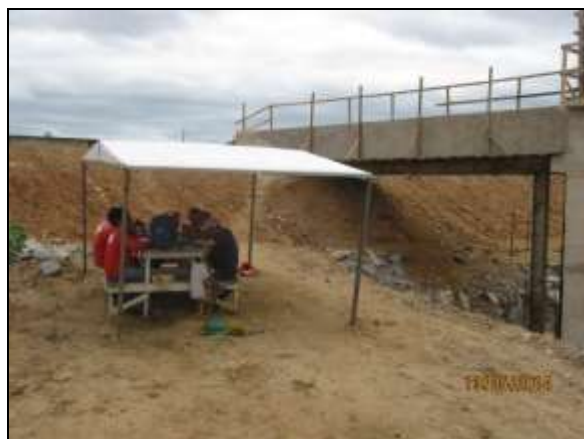
Foto 4.2.498. Estrutura de apoio disponibilizada aos colaboradores com manutenção satisfatória (maio/2014).
