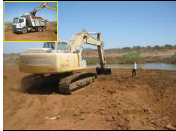
Foto 4.2.88. Escavação de jazida de empréstimo na área do reservatório Terra Nova - WBS 1106 (set/2014).
