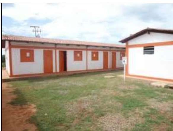
Foto 4.2.301. Visão parcial dos alojamentos dos colaboradores no canteiro central de obras de Mauriti (abr/2014).
