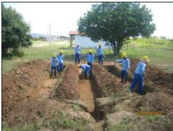
Foto 4.2.825. Colaboradores durante atividade de construção civil com os EPI adequados (abr/2014).
