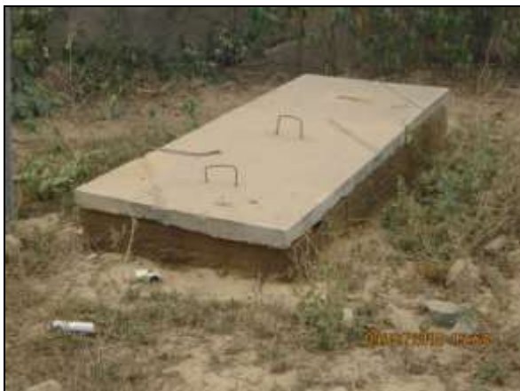
Foto 4.2.127. Caixa do sistema SAO do posto de combustível do canteiro de obras de Salgueiro – PE (jul/2014).
