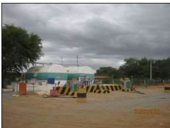
Foto 4.2.400. Posto de abastecimento com bacia de contenção, pista impermeabilizada e canaletas ligadas ao SAO (jun/2014).
