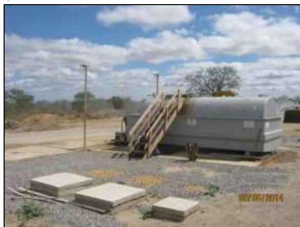
Foto 4.2.457. Separador de água e óleo disponibilizado no posto de abastecimento localizado no WBS 2208 (ago/2014).
