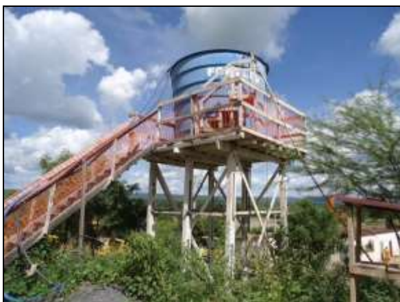
Foto 4.2.619. Armazenamento adequado de água no emboque do túnel Cuncas I (abr/2014).
