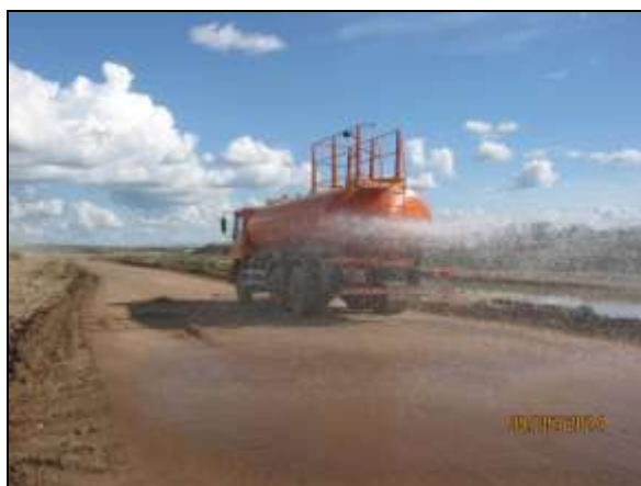
Foto 4.2.232. Umectação da via de acesso às margens do segmento de canal - WBS 1234 (maio/2014).
