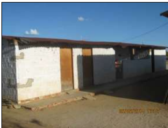
Foto 4.2.693. Vista da estrutura de apoio da VPR (jun/2014).
