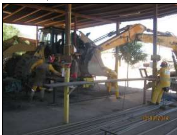
Foto 4.2.650. Equipamentos pertencentes à obra em manutenção (set/2014).
