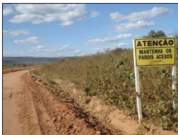
Foto 4.2.290. Sinalização de código de conduta a ser seguida pelos colaboradores no segmento de canal – WBS 1233 (ago/2014).
