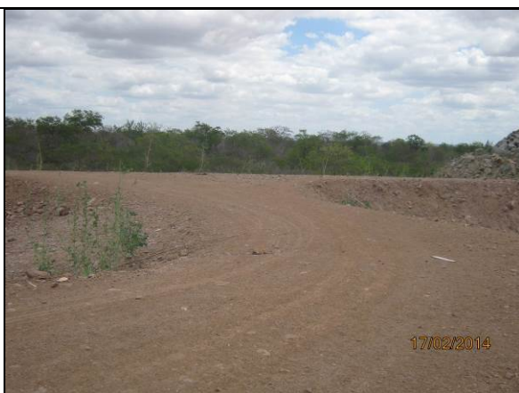
Foto 39. Passagem sobre o canal mantendo o fluxo da estrada vicinal (EL-V-017), aguardando construção da Ponte WBS 2507.
