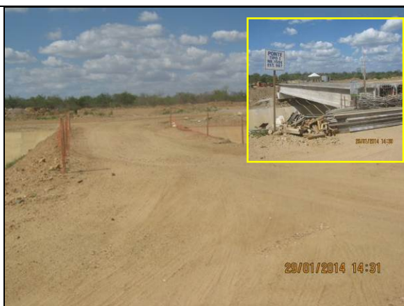
Foto 3. Rodovia estadual PE-499 (EN-I-020) em funcionamento, com acesso provisório próximo ao local da implantação da ponte WBS 1506.
