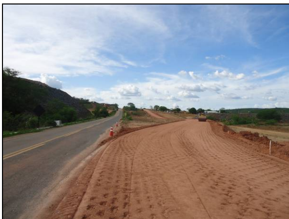
Foto 21. Desvio provisório da rodovia estadual CE-153 (EN-II-002) em construção, permitindo a continuidade do fluxo.
