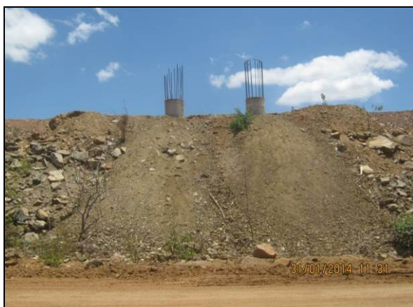
Foto 11. Local de implantação da ponte WBS 1513, solução de engenharia para estrada vicinal (EN-I-059).
