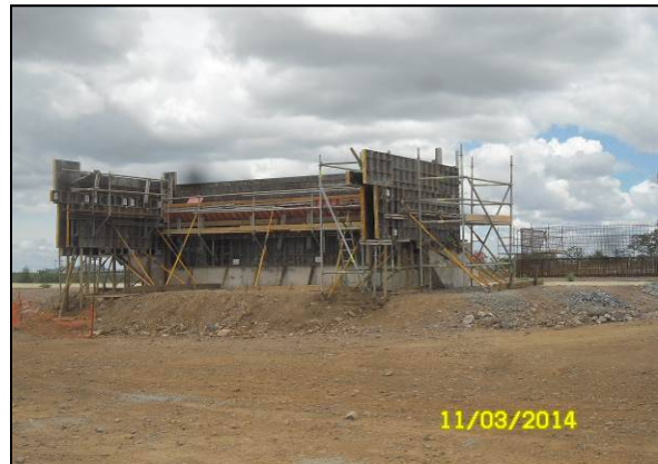
Foto 36. Construção da ponte (WBS 2506) sobre o canal para manutenção do fluxo da estrada vicinal (EL-V-008).
