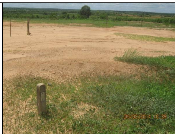
Foto 18. Marco de concreto indicando presença de cabo óptico subterrâneo da Telemar/PE (EN-I-143) aguardando construção da ponte WBS 1523.
