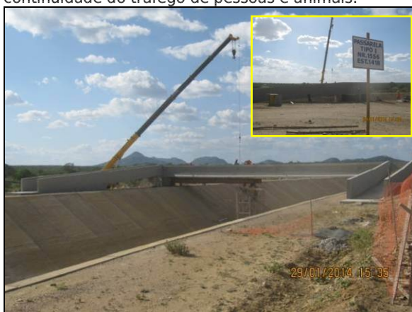
Foto 7. Passarela WBS 1556 em implantação para garantir o fluxo de pessoas e animais na estrada vicinal (EN-I-025).
