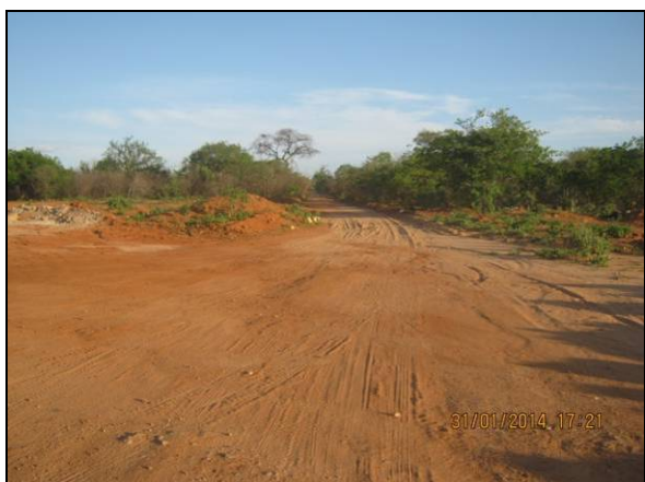
Foto 13. Estrada vicinal (EN-I-077-RMA) em funcionamento, aguardando implantação da ponte WBS 1515 no local indicado.
