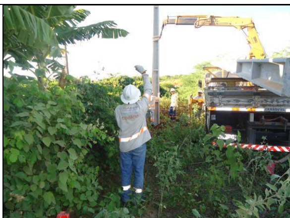
Foto 27. Equipe da concessionária de energia COELCE realizando a relocação da rede elétrica (EN-II-041).
