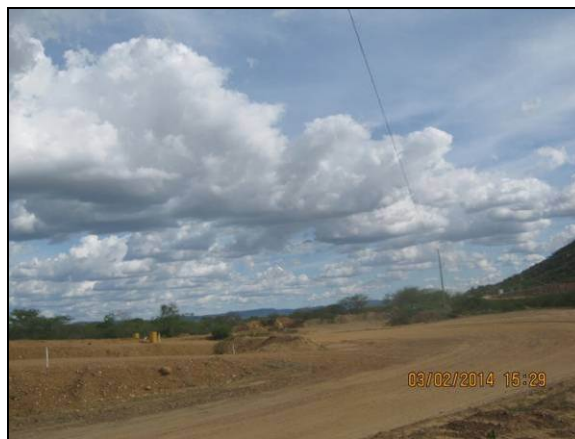
Foto 16. Cabo de fibra óptica da Telemar/PE (EN-I-098), aguardando construção da ponte WBS 1517.
