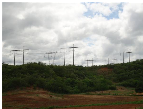
Foto 22. Linhas de transmissão CHESF (EN-II-018-019-20 e 21-RBO) interceptando a área do reservatório Boi II.
