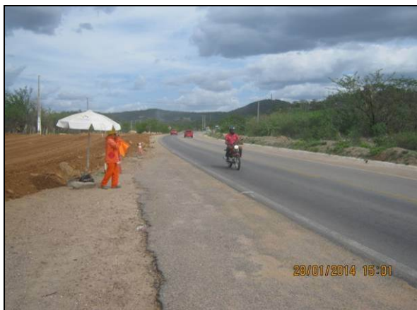
Foto 15. Rodovia federal BR-232 (EN-I-090-RNE) em funcionamento, com instalação do desvio para construção da ponte WBS 1516.
