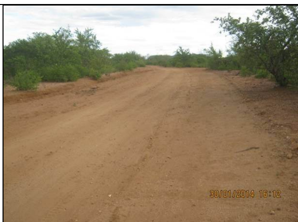
Foto 9. Estrada vicinal (EN-I-047-RTN) em funcionamento, na área do reservatório Terra Nova.
