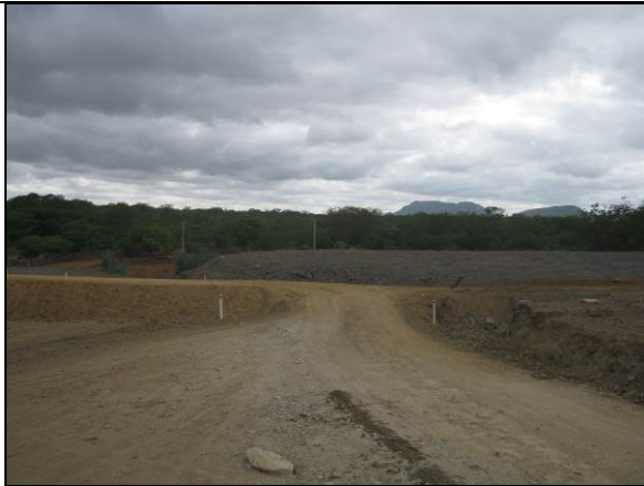
Foto 41. Desvio provisório sobre o canal para manutenção do tráfego das estradas vicinais (EL-V-058 e EL-V-059).
