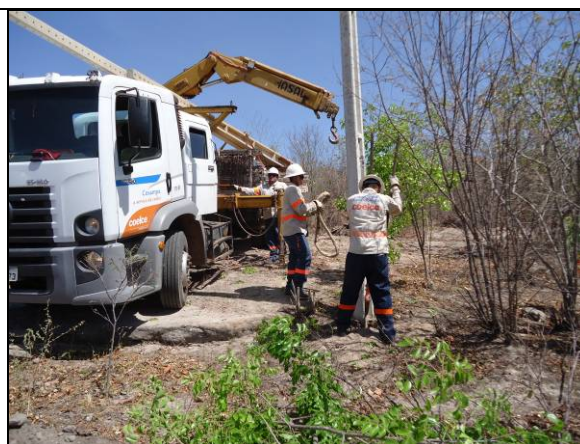
Foto 24. Equipe da Coelce realizando a relocação da rede elétrica (EN-II-016-RCB), área do reservatório Cipó.
