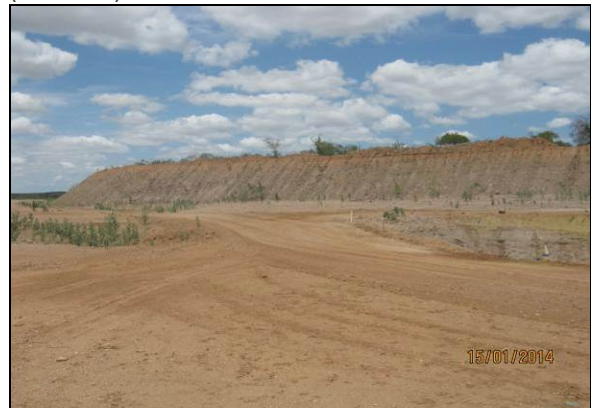
Foto 38. Passagem provisória sobre o canal para manutenção do fluxo das estradas vicinais (EL-V-015 e EL-V-016), aguardando construção da passarela WBS 2556.
