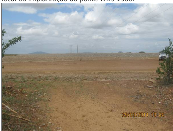
Foto 5. Trecho da estrada de serviço das linhas de transmissão da CELPE (EN-I-008) permitindo a continuidade do tráfego de pessoas e animais.
