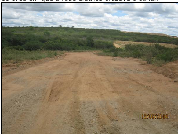
Foto 51. Acesso provisório construído para manutenção do fluxo da estrada vicinal (EL-V-184).
