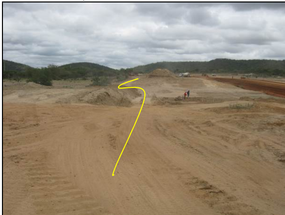
Foto 43. Vista do acesso alternativo implantado para manutenção do tráfego da estrada vicinal (EL-V-074-RBG).
