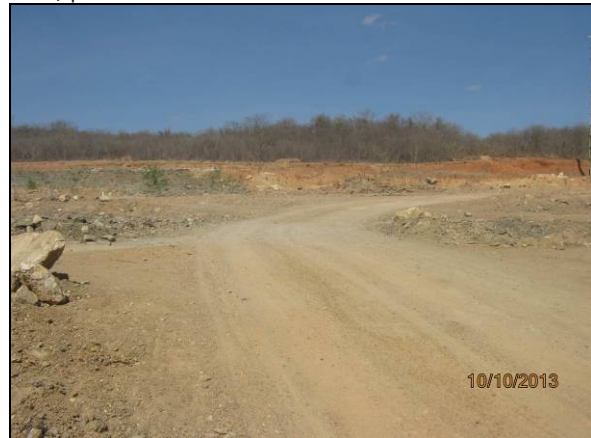
Foto 44. Acesso temporário sobre o canal para continuidade do fluxo da estrada vicinal (EL-V-076) pelas comunidades próximas.
