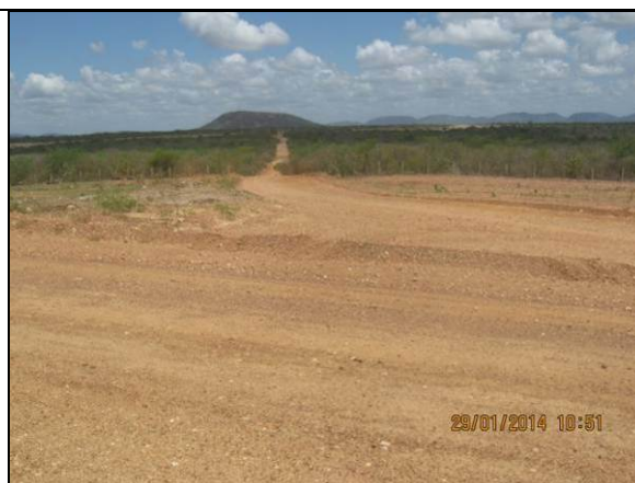
Foto 4. Estrada vicinal (EN-I-012) em funcionamento, aguardando a construção de uma estrada vicinal que será interligada às existentes.
