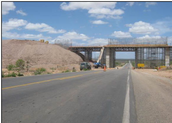
Foto 35. Construção do aqueduto (WBS 2304) sobre a estrada federal BR-316 (EL-V-001) sem alteração no tráfego no local.
