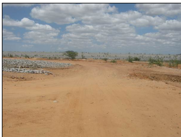
Foto 33. Acesso provisório dentro do reservatório Areias para manutenção do fluxo da estrada vicinal (EL-V-009).
