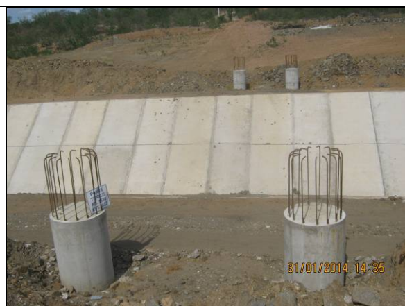
Foto 10. Início das atividades construtivas da ponte WBS 1514: solução de engenharia prevista para a interferência estrada vicinal EN-I-064.
