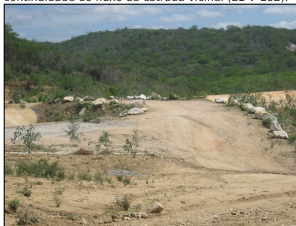
Foto 52. Desvio provisório sobre o canal para manutenção do fluxo da estrada vicinal (EL-V-185).
