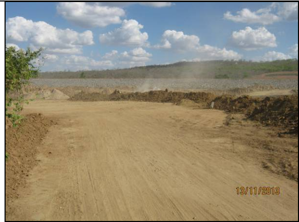
Foto 42. Acesso provisório para propiciar a continuidade do fluxo da estrada vicinal (EL-V-067-RCN) pelas comunidades locais.
