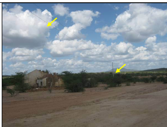
Foto 40. Rede elétrica nova, a ser relocada, localizada no interior do reservatório Mandantes.
