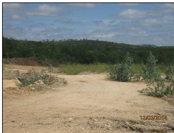
Foto 50. Passagem sobre o canal escavado para continuidade do fluxo da estrada vicinal (EL-V-182).
