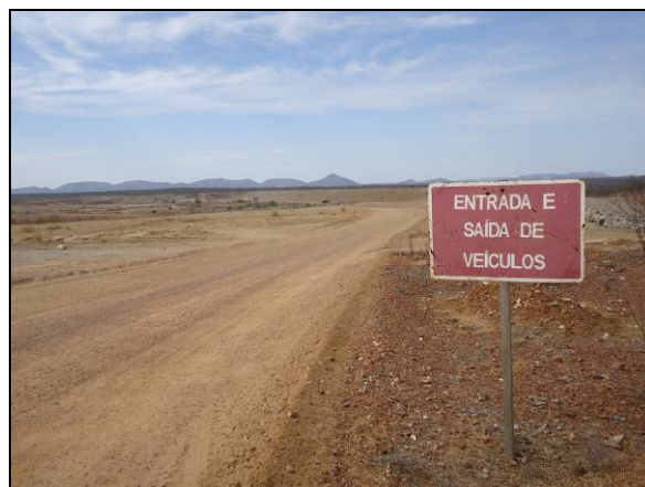
Foto 2. Via de acesso da obra no reservatório Tucutu permitindo a continuidade do tráfego no trecho eliminado da estrada vicinal EN-I-015-RTU.
