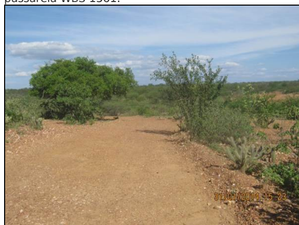
Foto 14. Estrada vicinal (EN-I-067-RMA) em funcionamento e aguardando eliminação dos trechos na área do reservatório Mangueira - WBS 1108.
