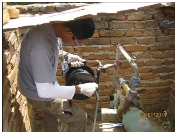
Foto 76. Mensuração do nível estático da água do poço.
