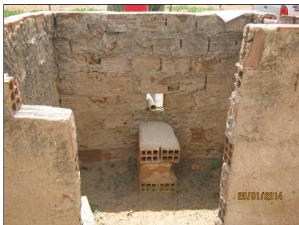
Foto 34. Vista do poço sem o sistema de bombeamento.
