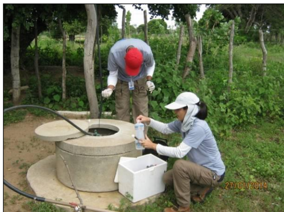
Foto 55. Mensuração do nível estático da água do poço e procedimento de esterilização da torneira pelo método da flambagem.
