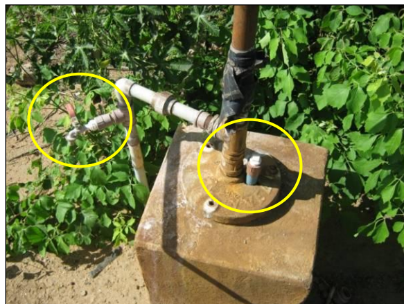
Foto 2. Torneira e tubo guia instalados no Poço nº 49 no município de Sertânia - PE.
