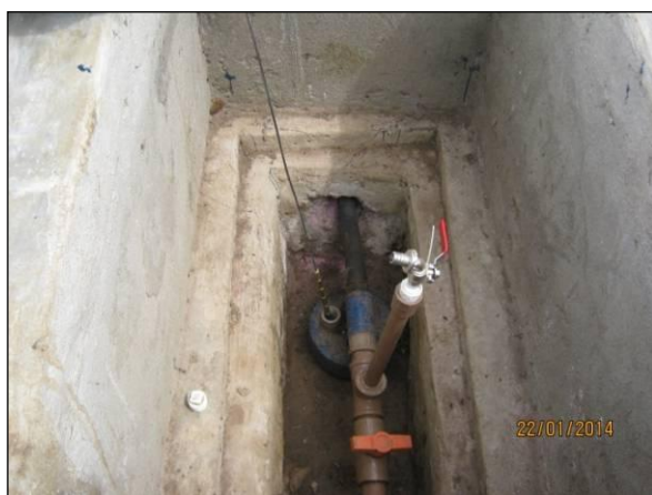
Foto 27. Mensuração do nível estático da água do poço.
