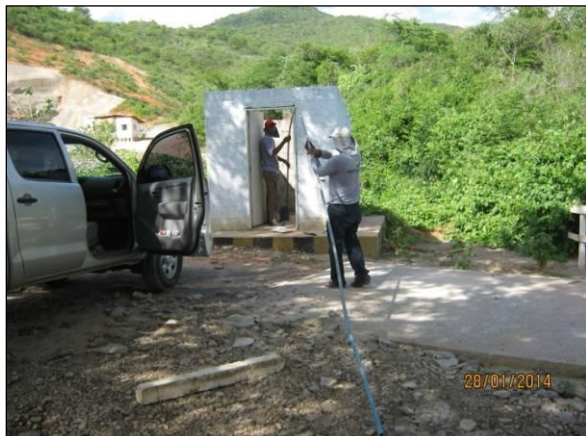
Foto 77. Instalação de um novo tubo guia.
