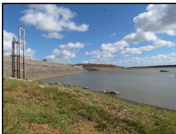
Foto 4.23.177. PM07 – Açude Barra do Juá. Na parte superior da foto área desmatada para utilização em atividades agrícolas e na parte inferior algumas formações rochosas próximas à margem.
