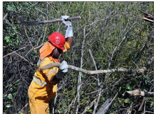
Foto 4.23.196. Supressão manual com uso de foice da área do emboque do Túnel Cuncas II no lote 14 (Agosto/2012).
