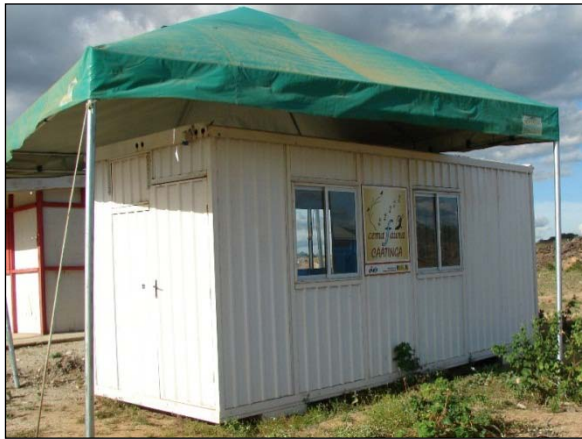
Foto 4.23.209. Cetas-móvel localizado no município de Custódia-PE.
