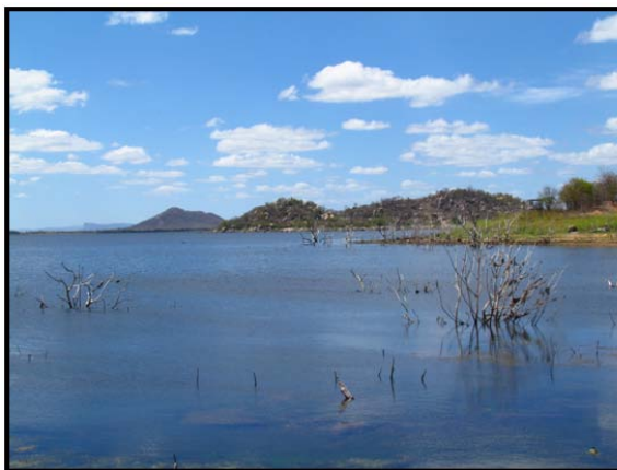
Foto 4.23.175. PM06 – Açude Serrinha. Evidenciando troncos e galhos de árvores que não foram removidos antes da formação do reservatório.
