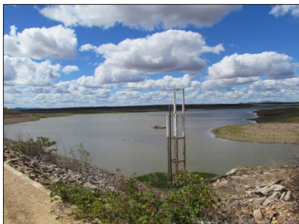
Foto 4.23.88. Ponto de Monitoramento 07, Açude Barra do Juá.
