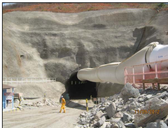
Foto 4.27.116. Talude do espelho concretado como método preventivo a instalação de processos erosivos (set/2012).
