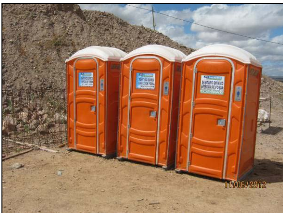
Foto 4.21.226. Banheiros químicos disponibilizados na frente de serviço (jun/2012).
