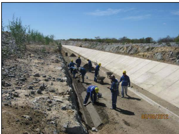
Foto 4.27.78. Construção das canaletas trapezoidais nas vias de serviço do canal (ago/2012).
