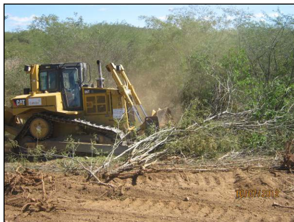
Foto 4.10.62. Remoção da camada de solo orgânico da Jazida JSV1 para armazenamento (jul/2012).
