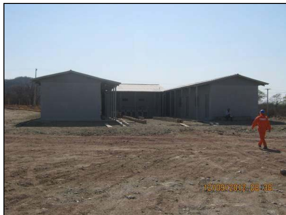
Foto 4.21.104. Área de alojamentos disponíveis para os colaboradores de obras (set/2012).
