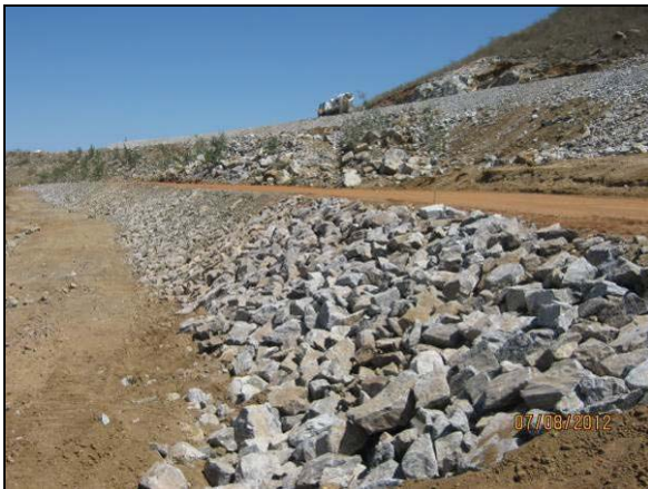
Foto 4.27.92. Enrocamento de talude de canal e via se serviço como medida preventiva a processos erosivos (ago/2012).
