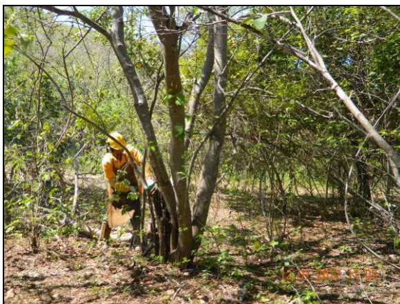
Foto 4.10.83. Supressão vegetal semimecanizada na área da janela do túnel Cuncas I (jul/2012).
