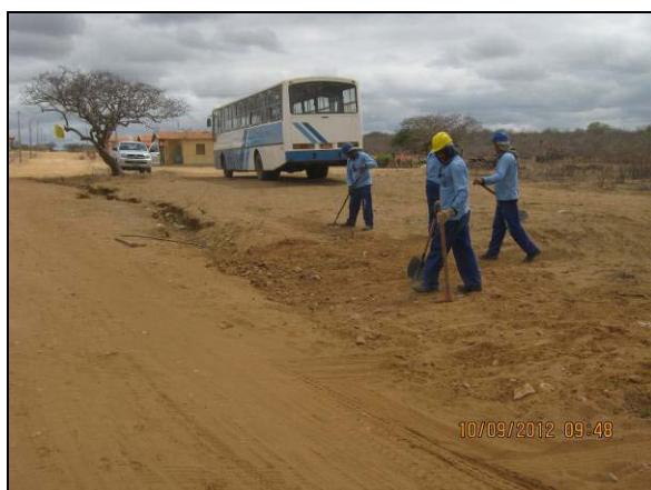
Foto 4.27.119. Atividade de reconformação manual em área de instabilidade em via de circulação (set/2012).
