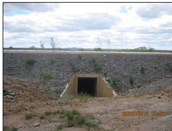
Foto 4.27.56. Enrocamento do talude de canal em cabeceira de sistema de drenagem (jul/2012).
