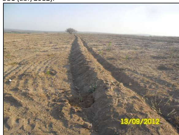
Foto 4.27.14. Construção de terraço de nível para a redução da velocidade do escoamento das águas pluviais (set/2012).
