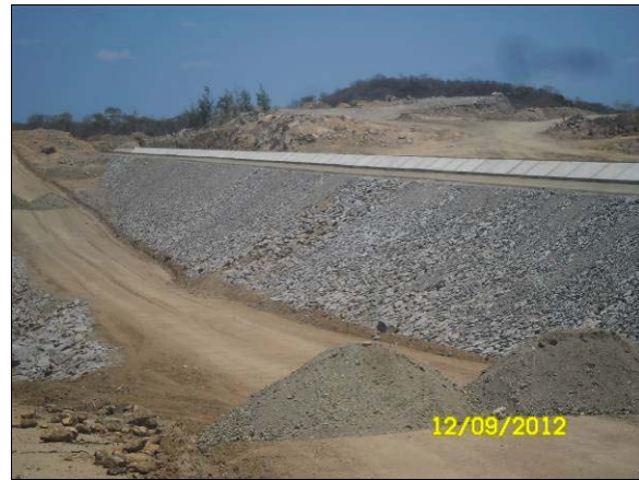
Foto 4.27.93. Enrocamento como medida preventiva a processos erosivos nos taludes do canal e da via se serviço (set/2012).
