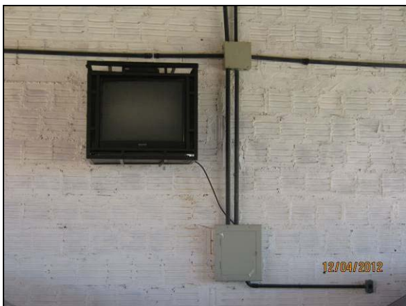
Foto 4.21.204. Televisão disponibilizada aos colaboradores no canteiro de obras (abr/2012).
