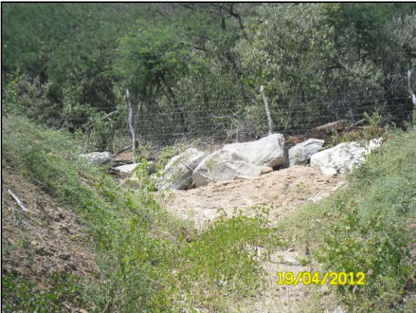
Foto 4.27.29. Barreira física para redução da carga sólida carreada pelas chuvas para os cursos d'água (abr/2012).
