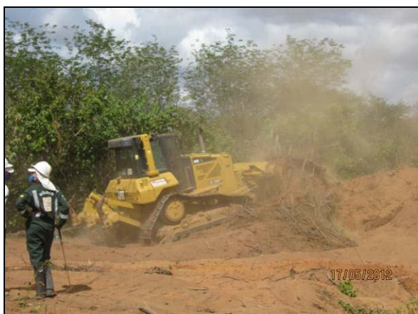
Foto 4.10.33. Supressão mecanizada na área da jazida 11 (mai/2012).
