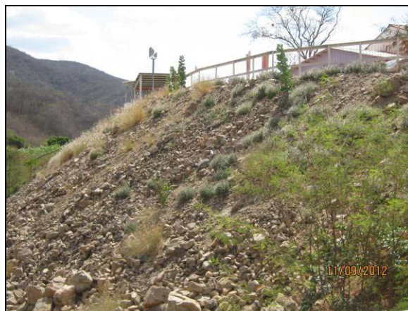
Foto 4.27.114. Talude do canteiro auxiliar enrocado - medida de prevenção à erosão (set/2012).
