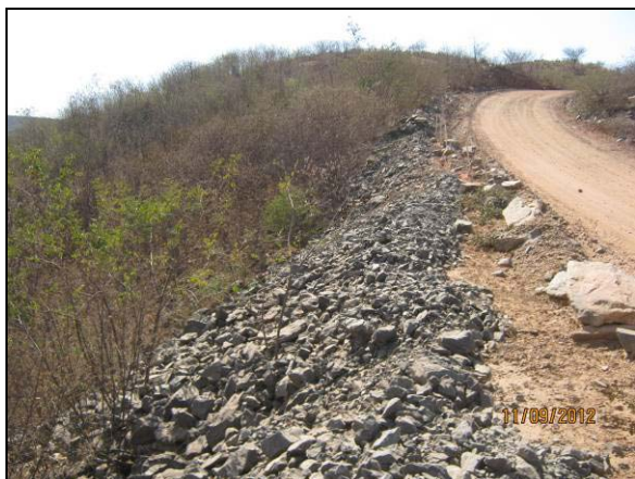
Foto 4.27.100. Enrocamento na via de acesso à janela do túnel Cuncas I (set/2012).
