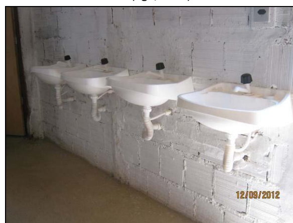
Foto 4.21.338. Banheiro disponível aos colaboradores da obra (set/2012).
