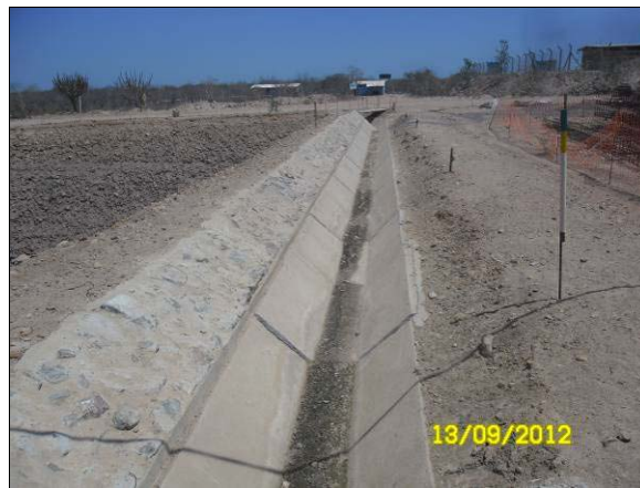
Foto 4.27.99. Canaleta trapezoidal implantada como medida preventiva a processos erosivos (set/2012).
