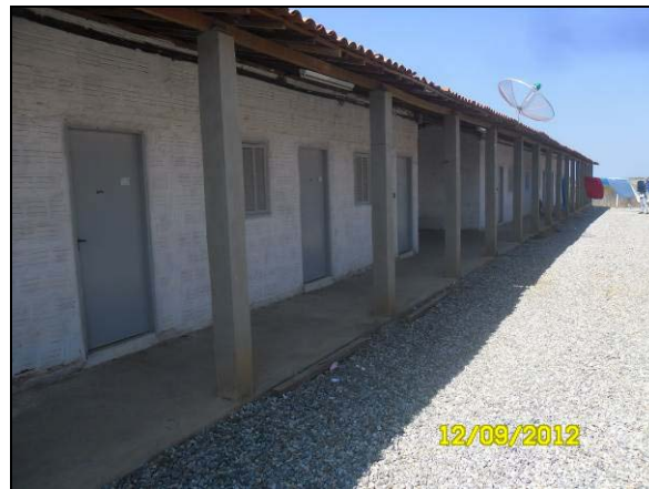
Foto 4.21.200. Vista externa do alojamento disponibilizado aos colaboradores no canteiro de obras (set/2012).
