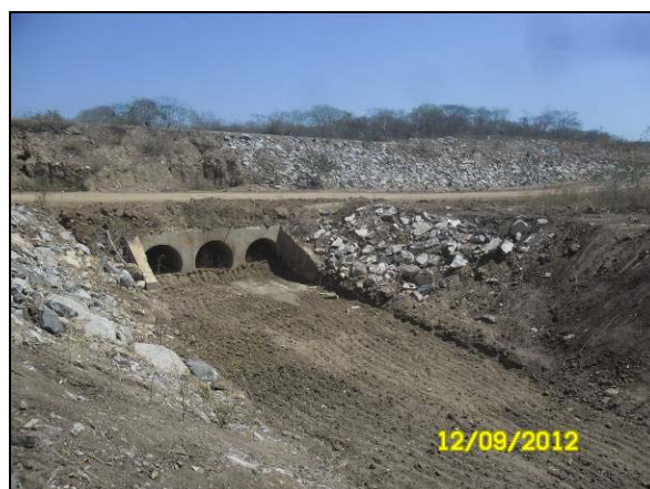
Foto 4.27.97. Enrocamento das laterais do canal de restituição (set/2012).
