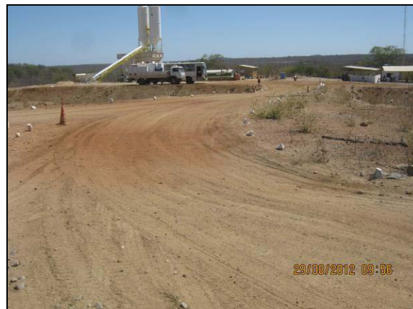
Foto 4.34.9. Estrada vicinal (EN-I-058) no WBS 1214 em funcionamento (ago/2012).
