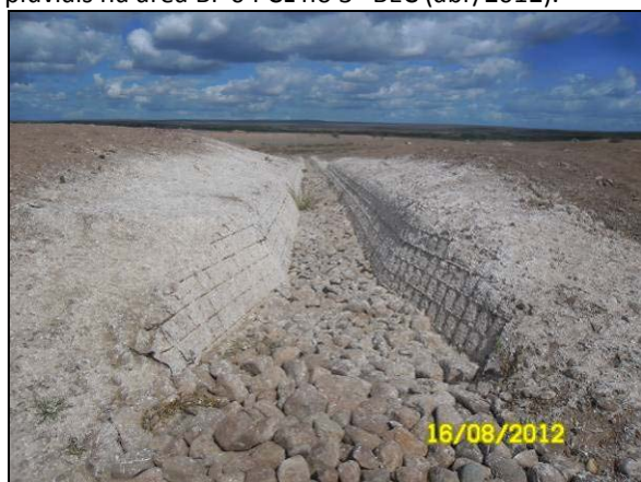
Foto 4.27.13. Aplicação de hidrossemeadura no entorno de ecocalha construída (ago/2012).
