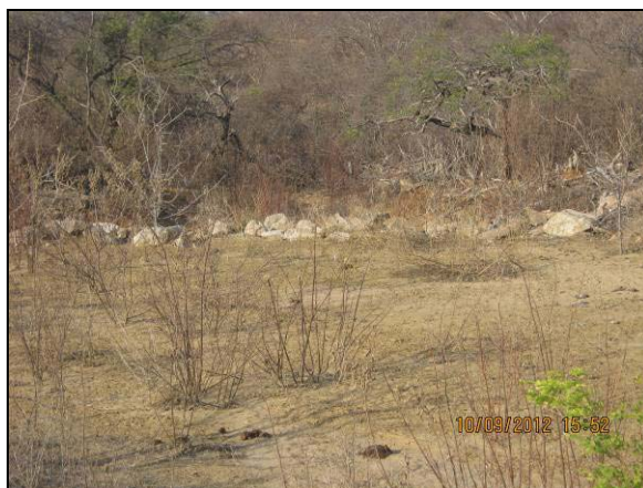
Foto 4.27.46. Filtro de rocha como medida preventiva ao carreamento de sólidos (set/2012).
