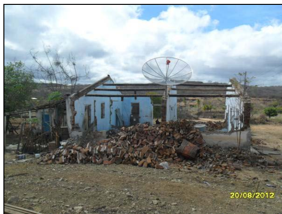
Foto 4.10.77. Casa parcialmente demolida com material sendo retirado para reaproveitamento (ago/2012).
