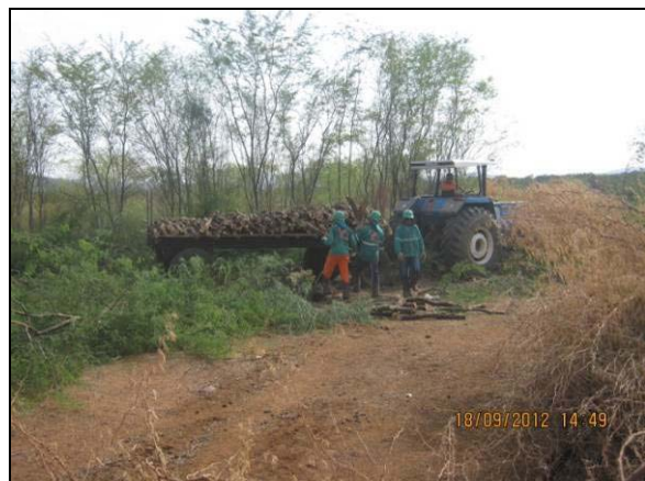
Foto 4.10.24. Carregamento e transporte do material lenhoso segregado para área de armazenamento no reservatório Terra Nova (set/2012).
