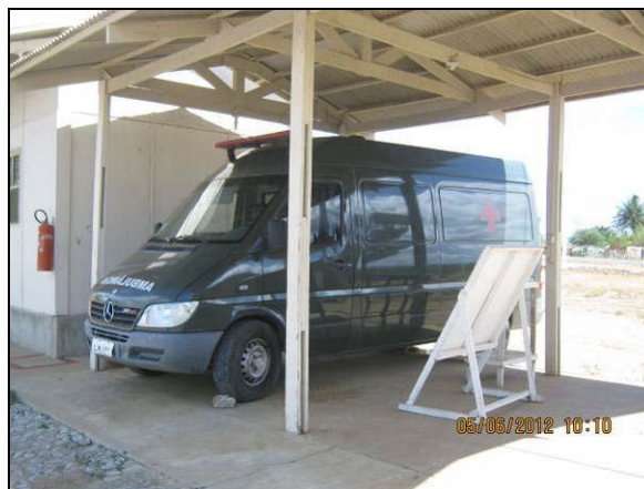
Foto 4.21.20. Presença de ambulância no canteiro de obras para eventuais urgências/emergências (jun/2012).
