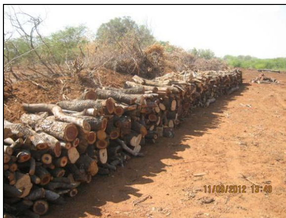
Foto 4.10.7. Material lenhoso e expurgo devidamente armazenado as margens da área suprimida no WBS 1216 (set/2012).
