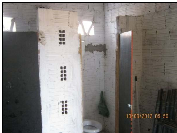
Foto 4.21.289. Banheiro e vestiário disponível aos colaboradores de obras da VPR (set/2012).
