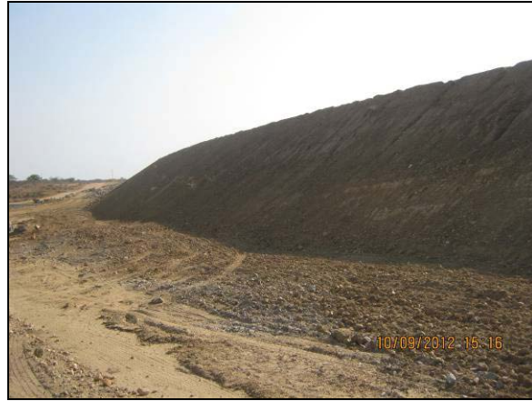
Foto 4.27.42. Talude de canal reconformado (set/2012).
