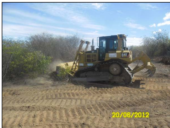
Foto 4.10.54. Supressão vegetal mecanizada na Jazida JSC1 (jun/2012).
