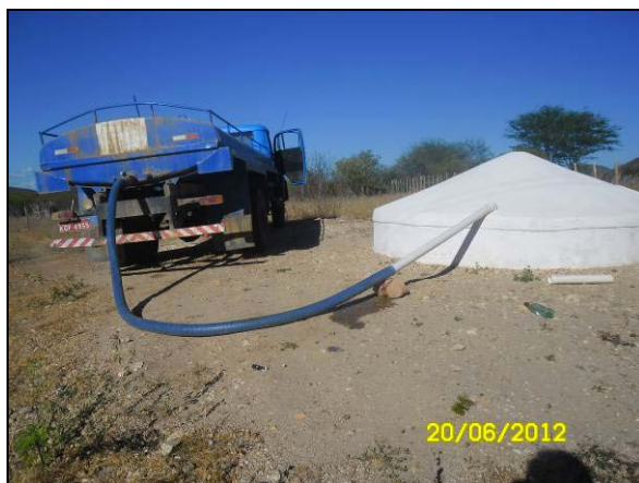
Foto 4.17.5. Cisterna na comunidade quilombola Fazenda Santana, Cabrobó- PE (jun/2012).
