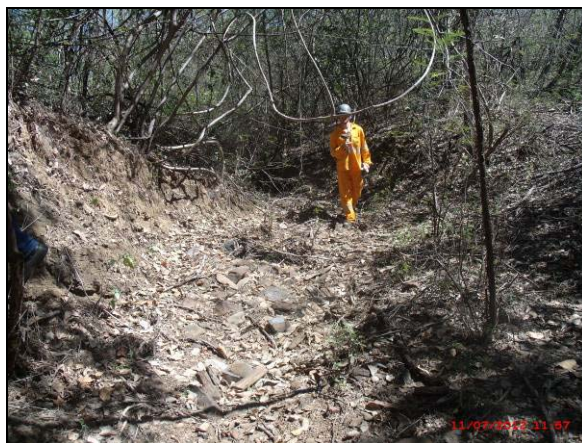
Foto 4.10.96. Identificação e delimitação da área a ser suprimida para ampliação da via de acesso ao emboque do túnel Cuncas II (jul/2012).
