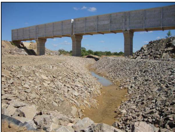
Foto 4.27.35. Enrocamento de canal de drenagem (mai/2012).
