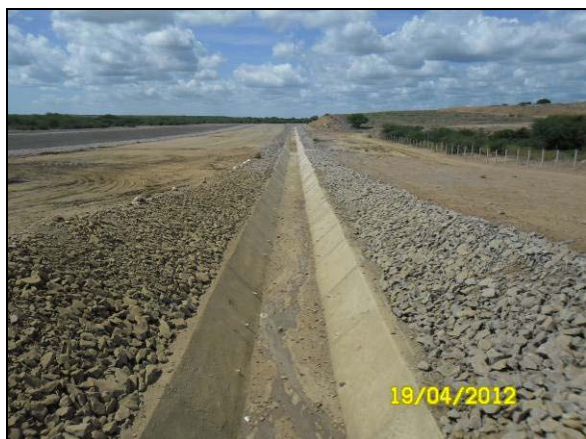
Foto 4.27.1. Instalação de canaleta trapezoidal de drenagem adjacente ao canal de aproximação (abr/2012).
