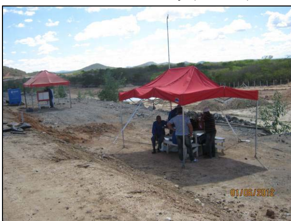
Foto 4.21.139. Tendas de apoio disponibilizadas aos colaboradores na frente de serviço (jun/2012).
