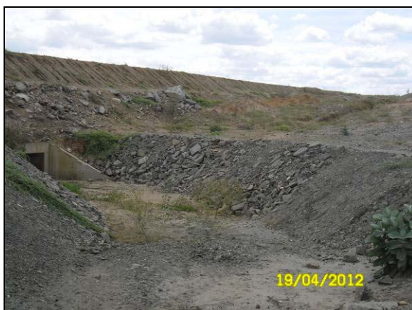
Foto 4.27.47. Enrocamento das laterais do canal de restituição (abr/2012).
