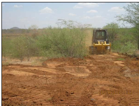
Foto 4.10.16. Supressão mecanizada no reservatório Terra Nova (set/2012).
