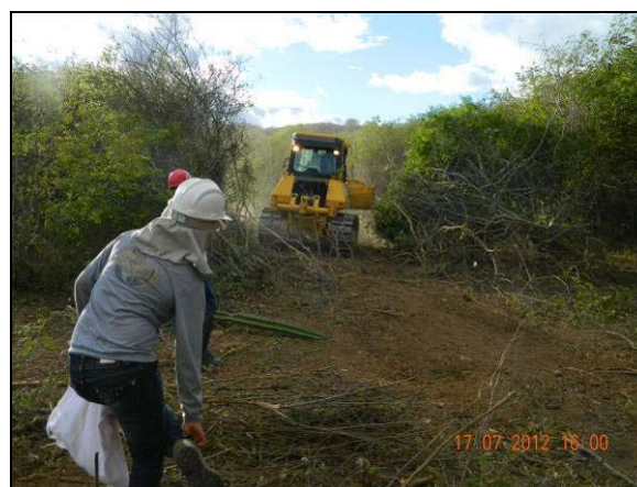
Foto 4.10.86. Equipe UNIVASF em atividade de resgate da fauna durante supressão vegetal mecanizada em área da janela do túnel Cuncas I (jul/2012).
