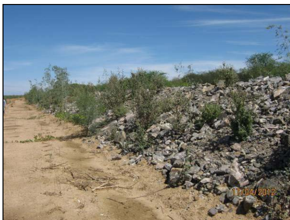
Foto 4.27.87. Talude de canal estabilizado por enrocamento (abr/2012).
