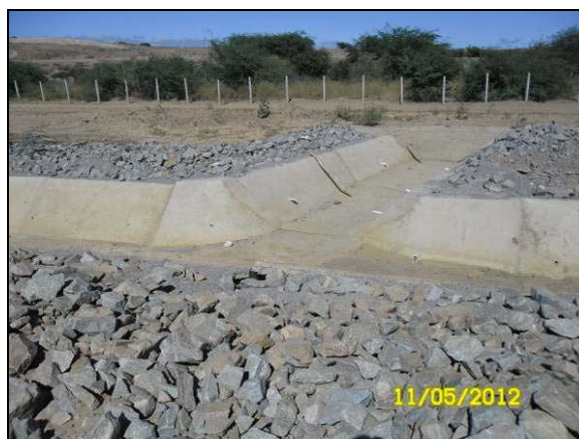
Foto 4.27.4. Instalação de canaleta de drenagem e enrocamento lateral ao canal de aproximação (mai/2012).
