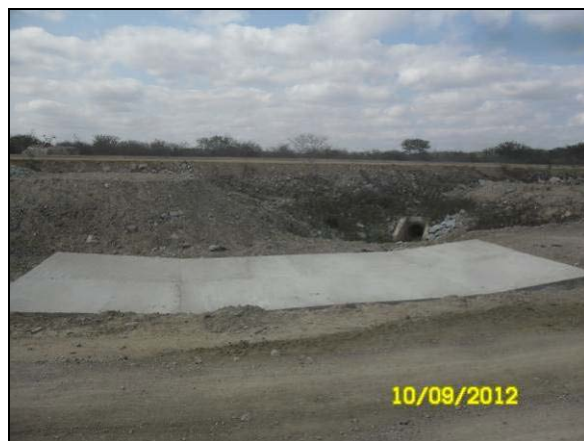
Foto 4.27.81. Construção de passagem molhada em estrada de serviço (set/2012).
