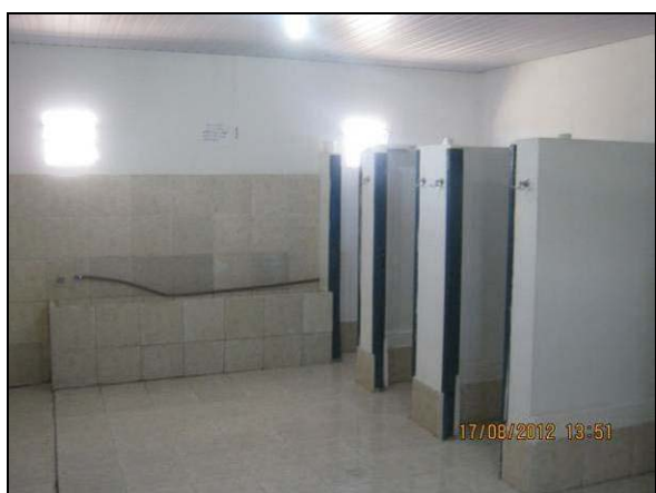
Foto 4.21.39. Banheiro disponível aos colaboradores nos alojamentos (ago/2012).
