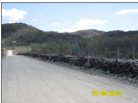
Foto 4.10.45. Armazenamento de material lenhoso nas margens da estrada de acesso ao canteiro de obras do Lote 08 (mai/2012)
