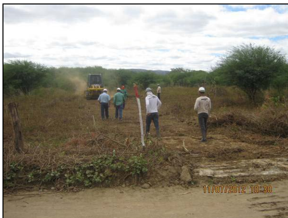
Foto 4.10.8. Delimitação mecanizada de área a ser suprimida no reservatório Terra Nova (jul/2012).
