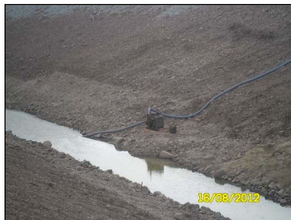
Foto 2.20.2. Esgotamento de água acumulada no eixo do canal para evitar possível proliferação de vetores e hospedeiros de doenças (ago/2012).
