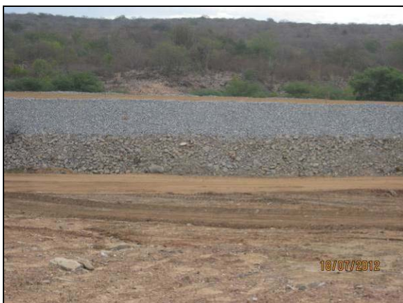
Foto 4.27.75. Enrocamento como método preventivo de erosão nos taludes do reservatório Cacimba Nova (jul/2012).
