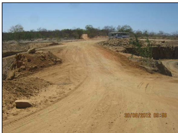
Foto 4.34.6. Estrada vicinal (EN-I-033) no WBS 1208 em funcionamento (ago/2012).
