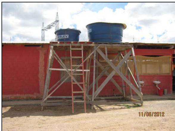
Foto 4.21.240. Armazenamento adequado da água para consumo dos colaboradores nos pontos de apoio às frentes de obras (jun/2012).
