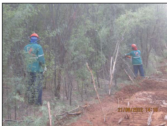
Foto 4.10.13. Supressão semimecanizada na área do reservatório Terra Nova (ago/2012).
