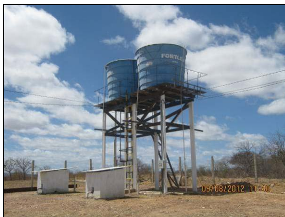
Foto 4.21.78. Estrutura para armazenamento de água do canteiro de obras (jul/2012).
