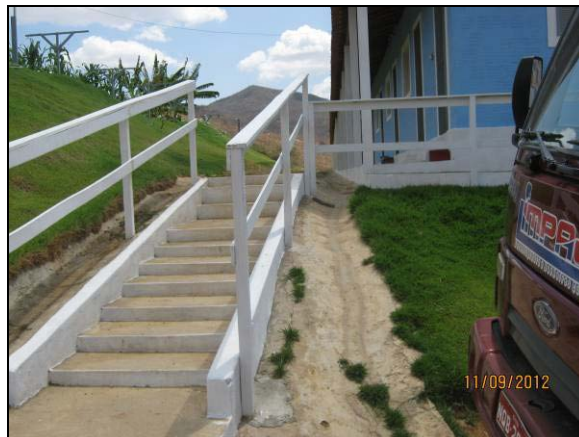
Foto 4.27.106. Talude revestido com gramíneas e canaleta para escoamento de águas pluviais na área do canteiro central (set/2012).
