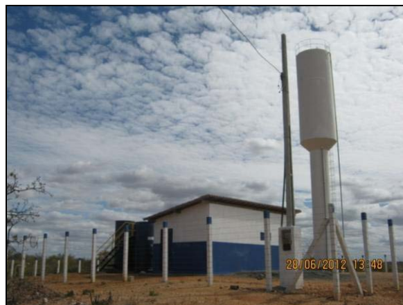
Foto 4.12.10. Estação de tratamento de água concluída, mas inoperante, na aldeia Cruzinha, etnia Tumbalalá, Abaré - BA (jun/2012).
