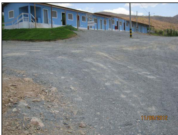
Foto 4.27.107. Deposição de pedrisco como medida preventiva à erosão laminar (set/2012).
