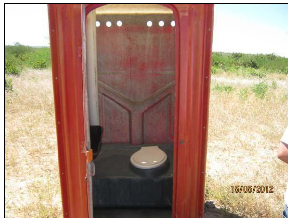
Foto 4.21.324. Banheiro disponível aos colaboradores da obra (mai/2012).
