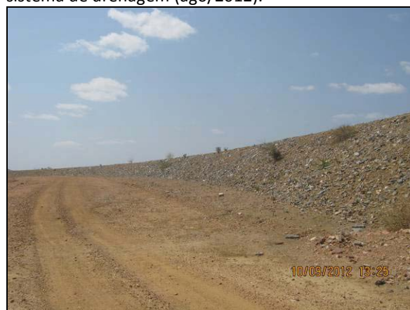
Foto 4.27.27. Enrocamento para dissipação das águas drenadas superficialmente (set/2012).
