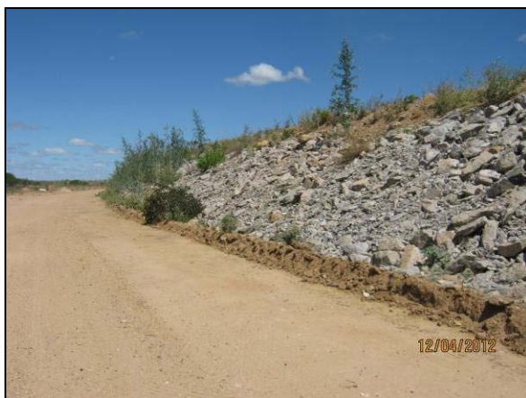
Foto 4.27.88. Enrocamento de talude do canal como medida preventiva (abr/2012).
