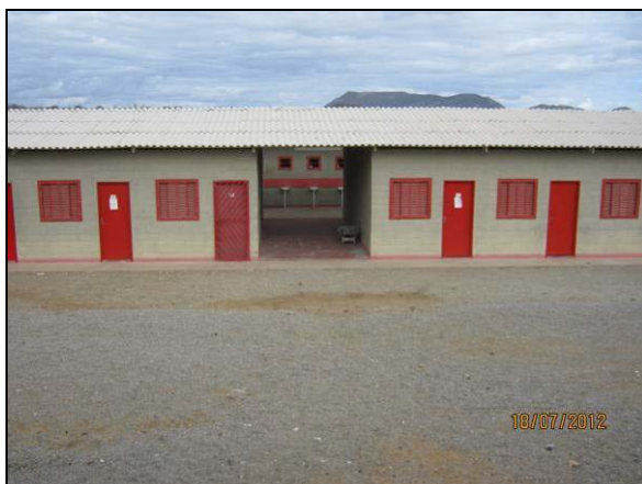
Foto 4.21.133. Alojamento disponibilizado aos colaboradores no canteiro de obras (jul/2012).
