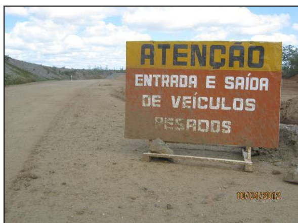
Foto 4.21.168. Placa de sinalização de alerta quanto a entrada e saída de veículos pesados na via (abr/2012)
