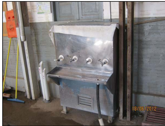
Foto 4.21.259. Bebedouro disponibilizado aos colaboradores da janela do túnel Cuncas I (jun/2012).
