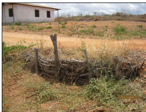
Foto 4.27.121. Paliçada implantada na lateral da via de acesso (ago/2012).
