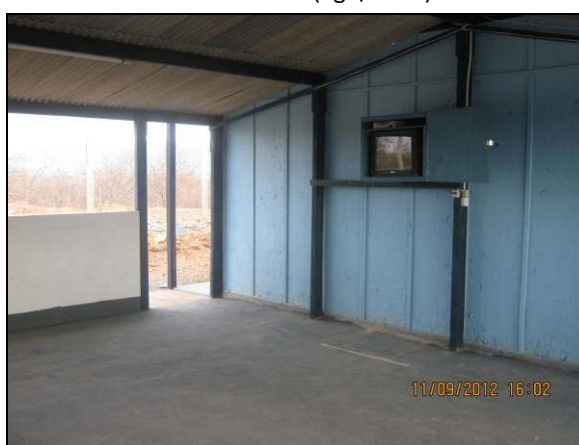
Foto 4.21.66. Sala de TV disponível aos colaboradores de obras (set/2012).
