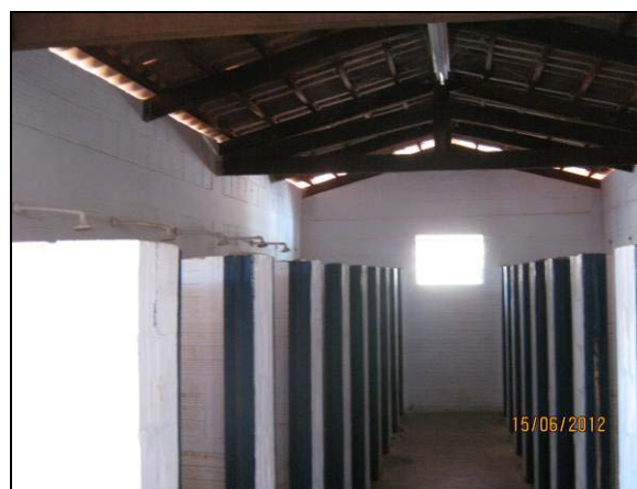
Foto 4.21.82. Banheiro disponível aos colaboradores na área do alojamento (jun/2012).
