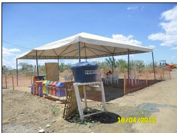
Foto 4.21.112. Área de apoio na frente de serviço – EBI-1 (abr/2012).
