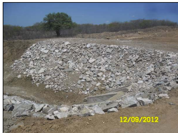
Foto 4.27.95. Medida preventiva a processos erosivos implantada nos taludes do canal de restituição do bueiro (set/2012).
