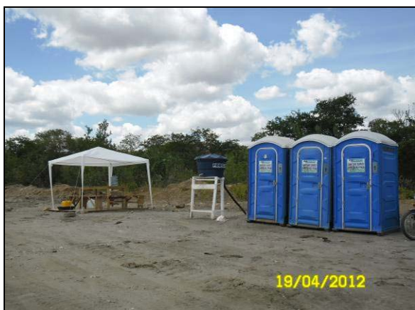
Foto 4.21.46. Banheiros químicos e tenda de apoio e vivência disponibilizados aos colaboradores (abr/2012).
