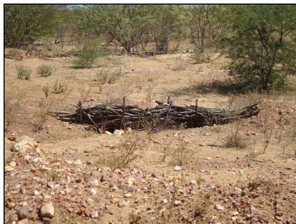
Foto 4.27.17. Cerca paliçada implantada como medida preventiva ao carreamento de sólidos (mai/2012).
