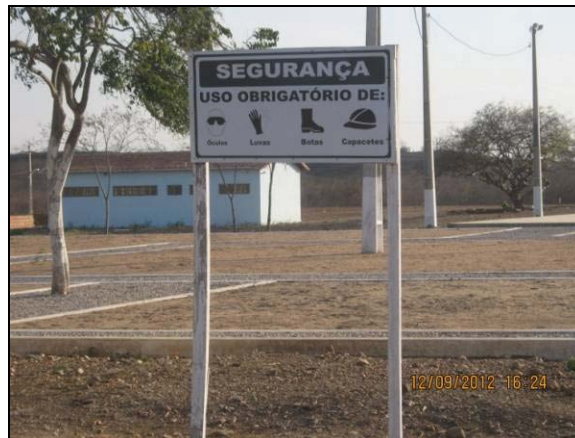
Foto 4.21.310. Divulgação do código de conduta do trabalhador nas frentes de obras (set/2012).
