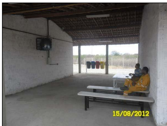
Foto 4.21.207. Área de vivência disponível para os colaboradores do canteiro de obras (ago/2012).
