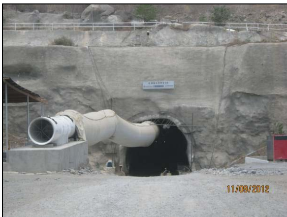
Foto 4.27.109. Projeção de concreto em talude como medida preventiva a erosão na porção superior ao espelho do túnel (set/2012).
