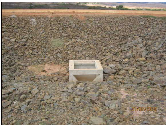
Foto 4.27.63. Enrocamento nas adjacências da caixa coletora do bueiro 3 (jul/2012).
