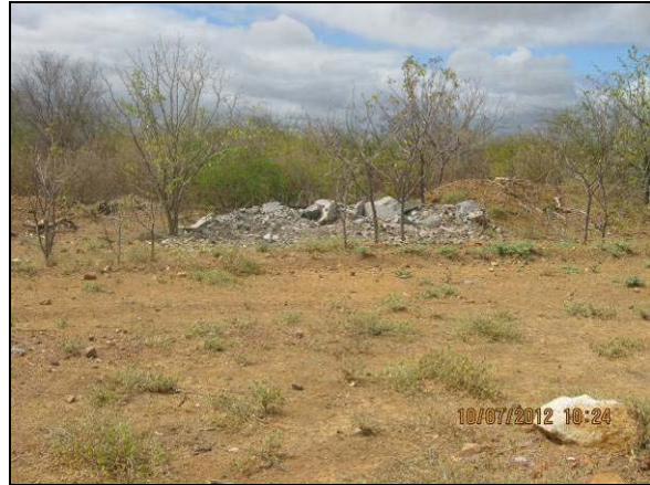
Foto 4.27.19. Filtro de rocha como medida preventiva ao carreamento de solo (jul/2012).
