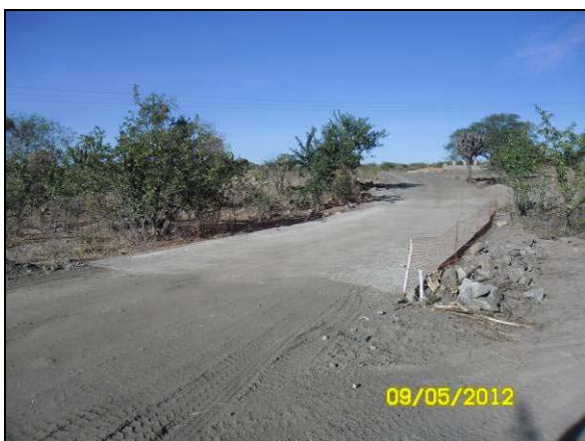
Foto 4.27.69. Implantação de passagem molhada em via de serviço (mai/2012).
