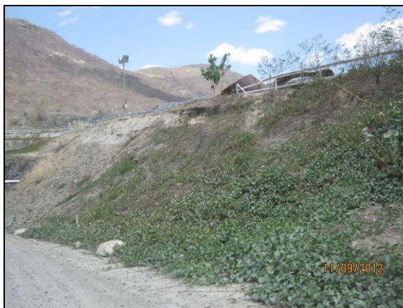
Foto 4.27.110. Revegetação natural do talude adjacente ao espelho do túnel (set/2012).
