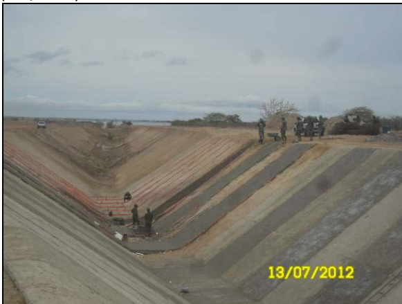
Foto 4.27.9. Implantação do canal para drenagem do riacho Mata Mole (jul/2012).
