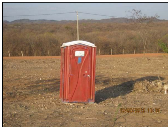
Foto 4.21.312. Banheiro químico disponível aos colaboradores da obra (set/2012).
