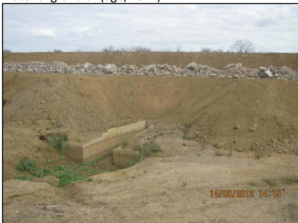
Foto 4.27.39. Reconformação de talude de sistema de drenagem (ago/2012).
