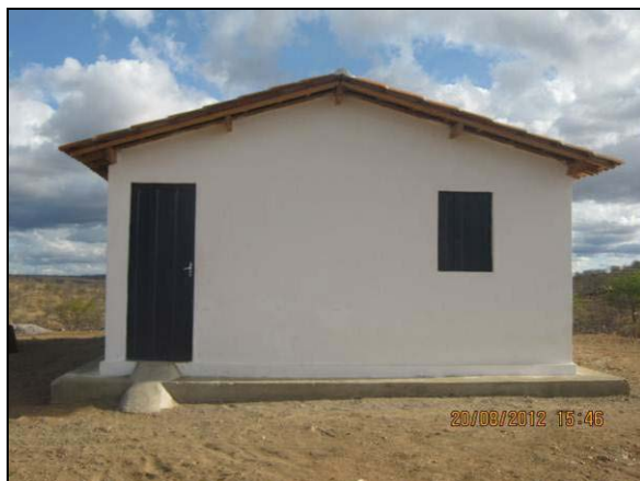
Foto 4.12.7. Casa concluída, aldeia Alto do Gavião, etnia Tumbalalá (ago/2012).
