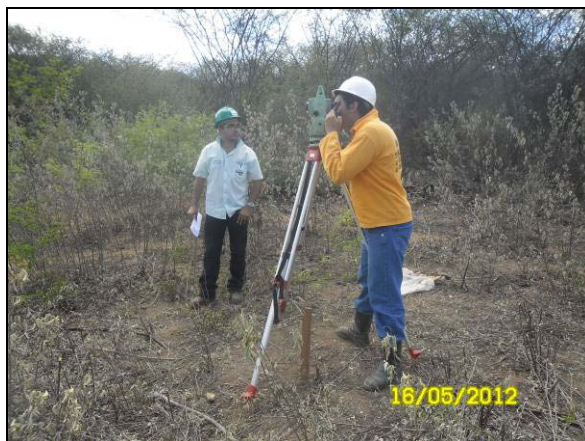
Foto 4.10.47. Delimitação por equipe de topografia da área a ser suprimida (mai/2012).
