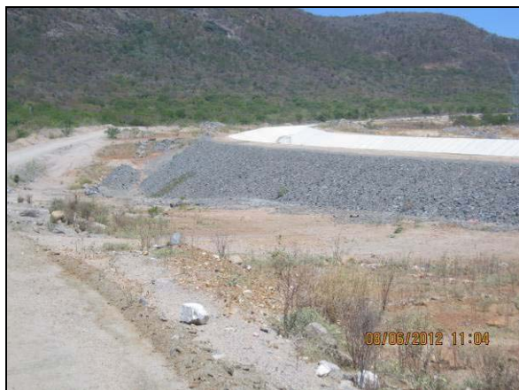
Foto 4.27.55. Talude enrocado, medida preventiva a instalação de processos erosivos e carreamento de solo (jun/2012).
