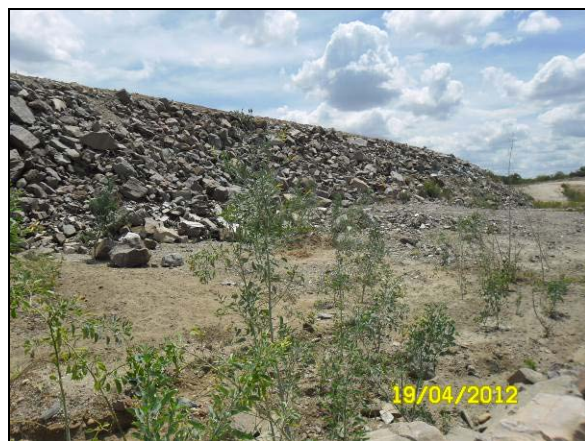
Foto 4.27.45. Enrocamento para dissipação das águas drenadas superficialmente e estabilização de talude (abr/2012).
