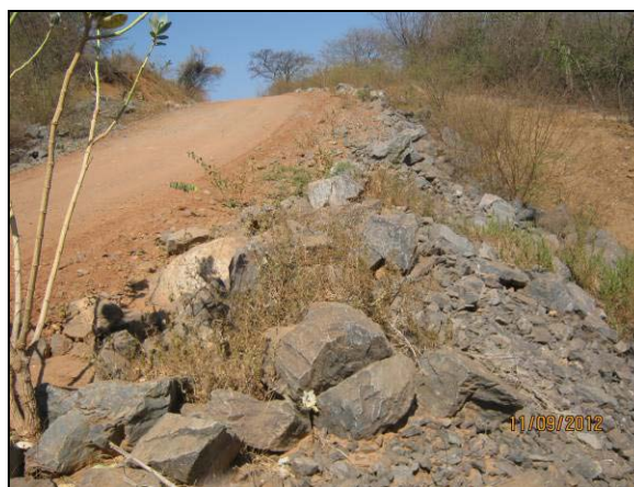
Foto 4.27.103. Enrocamento como método preventivo de erosão na via de acesso à janela do túnel (set/2012).
