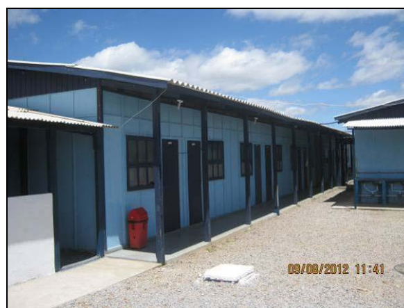
Foto 4.21.68. Vista parcial dos alojamentos disponíveis aos colaboradores das frentes de serviço (ago/2012).
