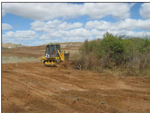
Foto 4.10.15. Supressão mecanizada e remoção de solo orgânico no WBS 1211 (jul/2012).
