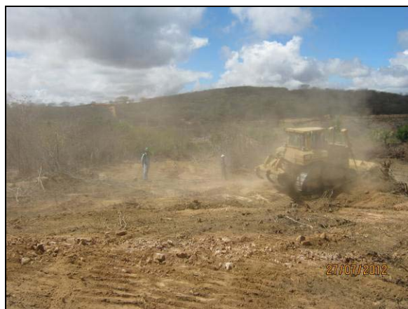
Foto 4.10.71. Supressão vegetal mecanizada em área do WBS 2226 (jul/2012).
