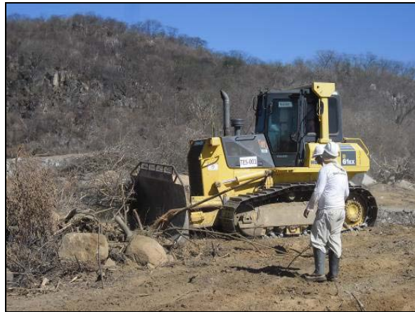
Foto 4.10.41. Supressão mecanizada na frente de serviço da EBI-3 (jul/2012).
