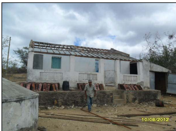
Foto 4.10.76. Demolição de casa no WBS 2226 no Lote 12 (ago/2012).
