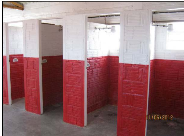
Foto 4.21.225. Banheiros disponíveis aos colaboradores nos alojamentos (jun/2012).
