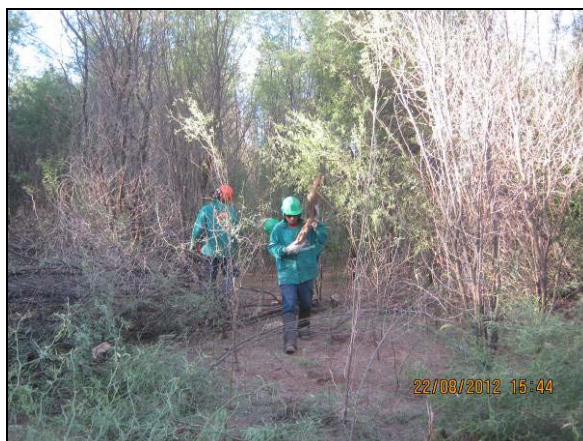
Foto 4.10.23. Transporte manual de material lenhoso do interior de área suprimida do reservatório Terra Nova (ago/2012).
