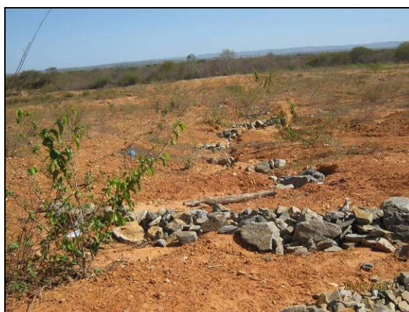
Foto 4.27.67. Dissipadores de energia para controle de processo erosivo na área em recuperação da jazida 02 (jul/2012).
