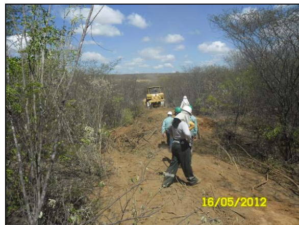
Foto 4.10.51. Afugentamento e resgate de fauna pela equipe do CEMAFUNA – UNIVASF, durante supressão na área da jazida JA1(mai/2012).
