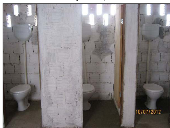
Foto 4.21.337. Banheiro disponível aos colaboradores da obra (jul/2012).
