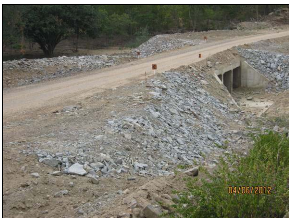
Foto 4.27.80. Enrocamento dos taludes das estradas de serviço adjacente ao sistema de drenagem (jun/2012).
