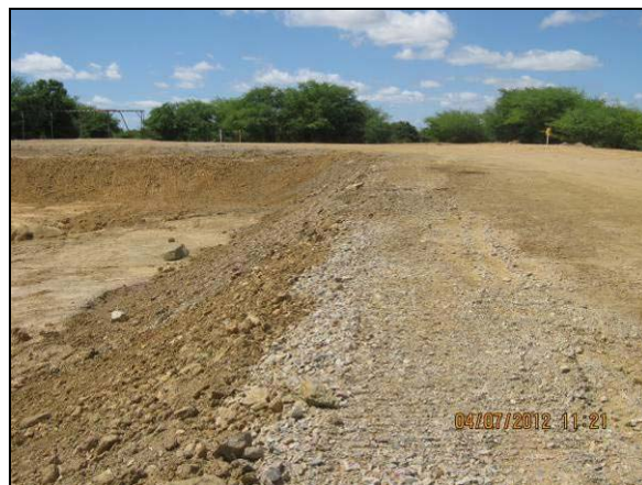
Foto 4.27.6. Reconformação de talude lateral a via de serviço do canal de aproximação (jul/2012).
