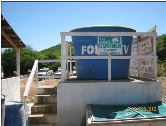
Foto 4.21.275. Armazenamento adequado da água a ser utilizada pelos colaboradores da frente de obra da janela do túnel Cuncas I (abr/2012).
