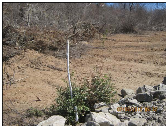
Foto 4.10.38. Estaca delimitando limite de supressão na área do bota-fora do reservatório Negreiros (ago/2012).
