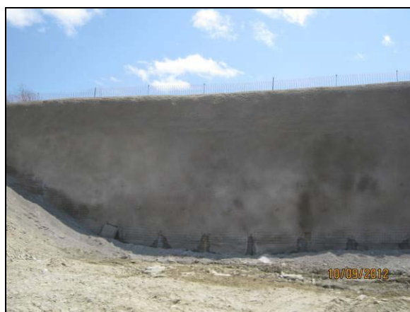
Foto 4.27.118. Aplicação de concreto projetado na área do espelho do túnel para prevenção e controle de processo erosivo. (set/2012).
