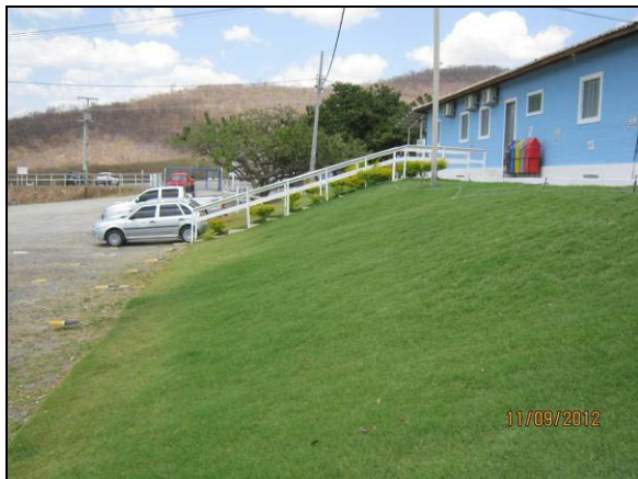
Foto 4.27.105. Suavização de desnível e revestimento com gramíneas na área do canteiro de obras (set/2012).
