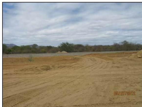
Foto 4.34.18. Acesso temporário sobre o canal para continuidade do fluxo da comunidade EL-V-058 (jul/2012).
