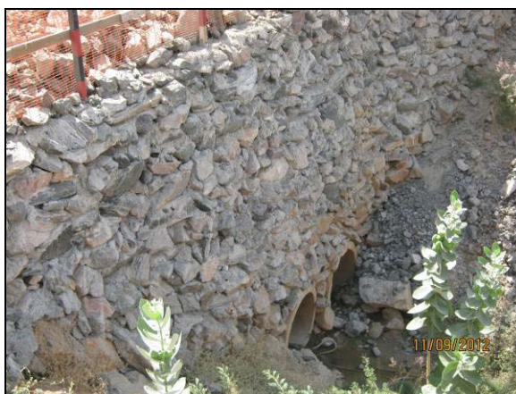
Foto 4.27.117. Enrocamento do talude nas adjacências do sistema de drenagem sob a via de acesso (set/2012).
