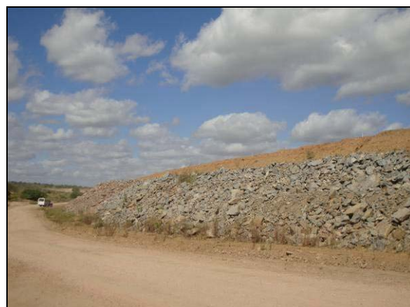
Foto 4.27.48. Talude enrocado, medida preventiva a instalação de processos erosivos e carreamento de solo (mai/2012).
