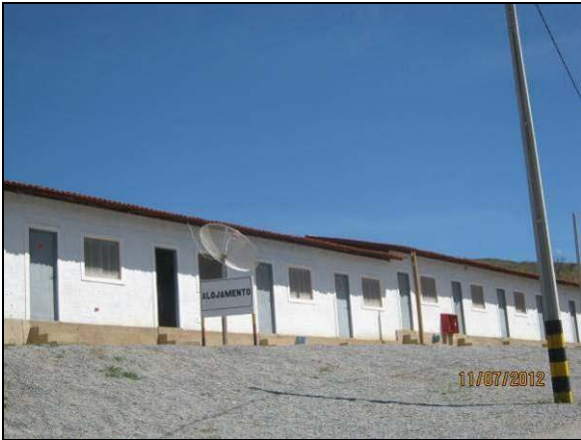
Foto 4.21.256. Vista geral do alojamento localizado no canteiro de obras central (jul/2012).
