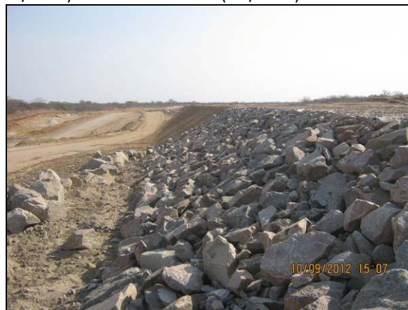
Foto 4.27.43. Implantação de material granular em talude de canal como medida preventiva a processos erosivos (set/2012).
