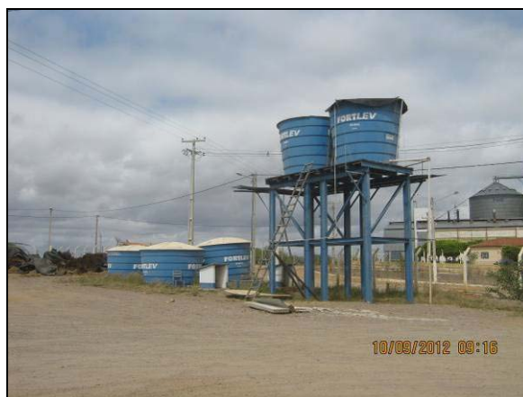
Foto 4.21.55. Reservatórios de água para consumo dos colaboradores do canteiro de obras (set/2012).
