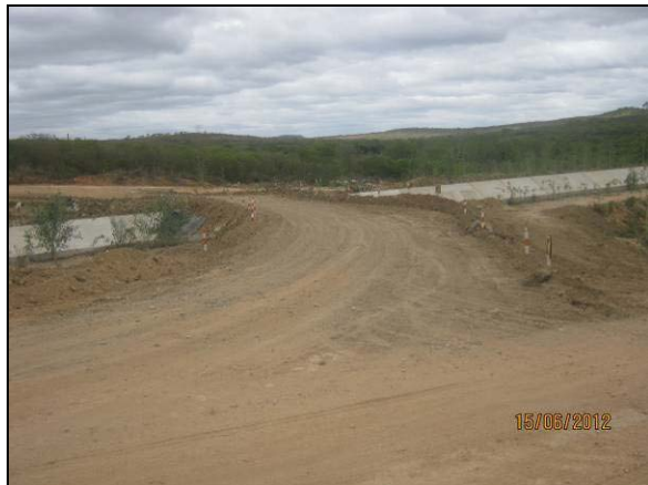
Foto 4.34.20. Acesso provisório construído pelo Consórcio Construtor para manter o fluxo na estrada vicinal, EL-V-182-RCA (jun/2012).
