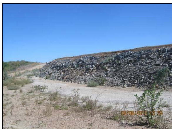
Foto 4.27.49. Talude estabilizado por enrocamento (jun/2012).
