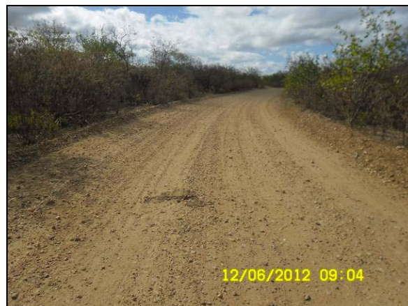
Foto 4.34.11. Estrada vicinal (EN-I-071-RMA) no reservatório Mangueira em funcionamento (jun/2012).
