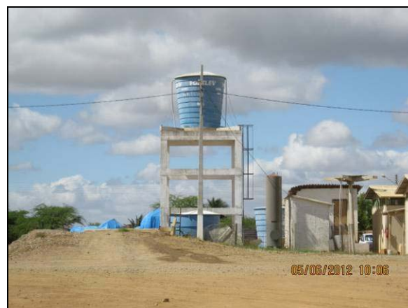
Foto 4.21.16. Reservatório de água presente no canteiro de obras (jun/2012).
