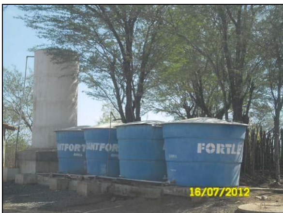
Foto 4.21.185. Armazenamento adequado da água utilizada pelos colaboradores do canteiro de obras (jul/2012).
