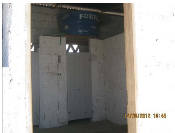
Foto 4.21.298. Banheiro e vestiário disponível aos colaboradores das obras da VPR (set/2012).
