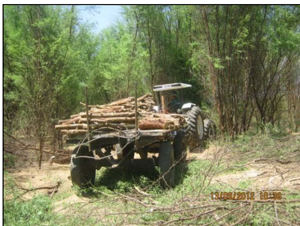
Foto 4.10.30. Transporte do material lenhoso segregado para armazenamento em pilhas (set/2012).
