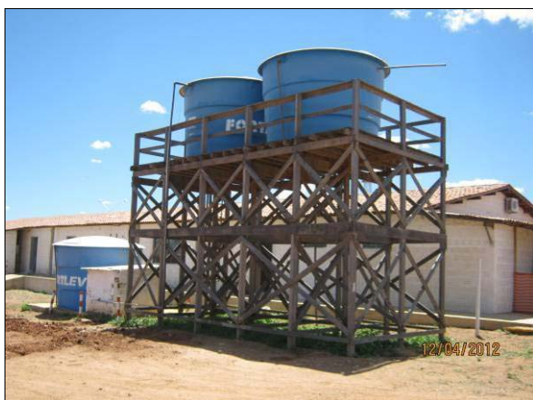
Foto 4.21.218. Armazenamento adequado da água para consumo dos colaboradores no canteiro de obras (abr/2012).
