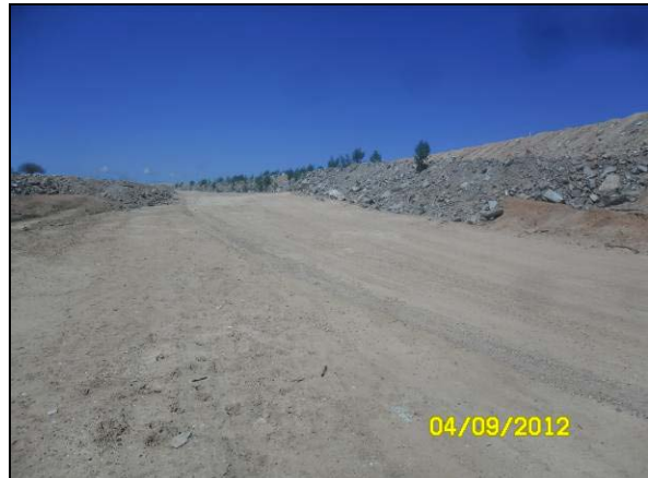
Foto 4.27.73. Reconformação e enrocamento de talude para dissipação das águas drenadas superficialmente (set/2012).
