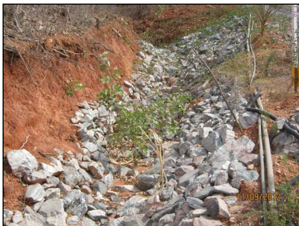
Foto 4.27.113. Vala de escoamento pluvial revestida com filtro de rocha para contenção de sedimentos e prevenção à erosão (set/2012).
