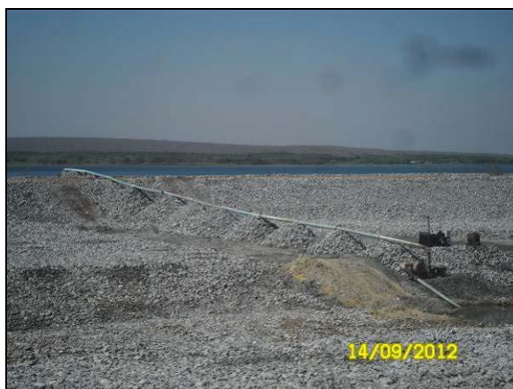
Foto 2.20.3. Esgotamento de água acumulada no eixo do canal para evitar possível proliferação de vetores e hospedeiros de doenças (set/2012).
