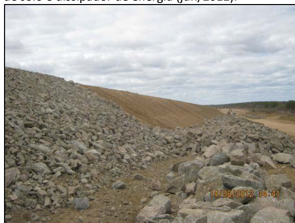
Foto 4.27.38. Reconformação e enrocamento de talude para dissipação das águas drenadas superficialmente (ago/2012).
