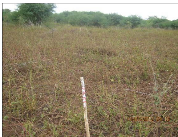
Foto 4.10.10. Delimitação com estacas da área a ser suprimida no segmento de canal WBS 1212 (jul/2012).
