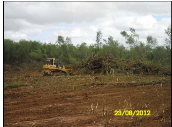
Foto 4.10.18. Armazenamento de expurgo às margens da áreas suprimida no reservatório Terra Nova (ago/2012).
