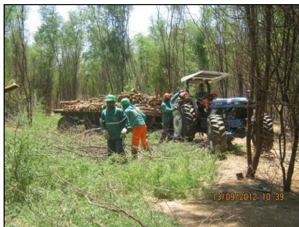
Foto 4.10.31. Transporte manual de material lenhoso oriundo de supressão vegetal do aqueduto Salgueiro (set/2012).
