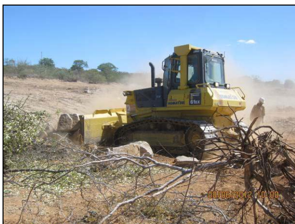
Foto 4.10.2. Supressão mecanizada com destocamento e remoção do solo orgânico no WBS 1216 (jun/2012).
