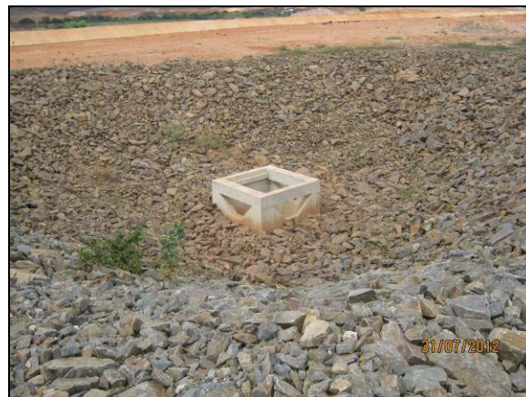
Foto 4.27.64. Caixa coletora do bueiro 4 com enrocamento de proteção (jul/2012).
