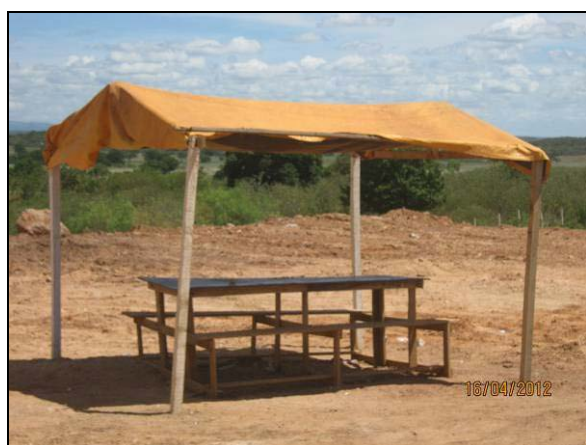
Foto 4.21.86. Tenda de apoio disponível aos colaboradores nas frentes de serviço (abr/2012).
