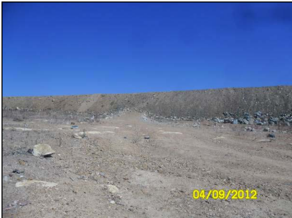
Foto 4.27.72. Talude de canal reconformado (set/2012)
