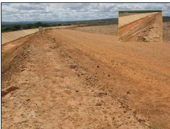
Foto 4.27.65. Sistematização do talude como método de controle de processo erosivo. (jul/2012).
