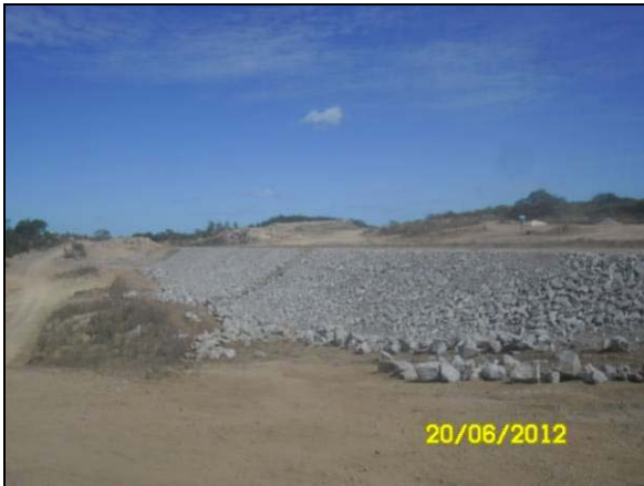
Foto 4.27.90. Enrocamento de talude do canal como medida preventiva (jun/2012).
