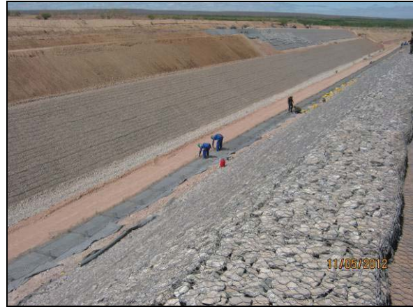
Foto 4.27.8. Implantação de colchão Reno como método preventivo a erosão nos taludes do canal de aproximação (mai/2012).
