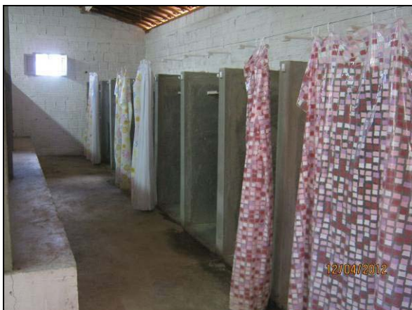
Foto 4.21.198. Banheiro disponível aos colaboradores nos alojamentos (abr/2012).
