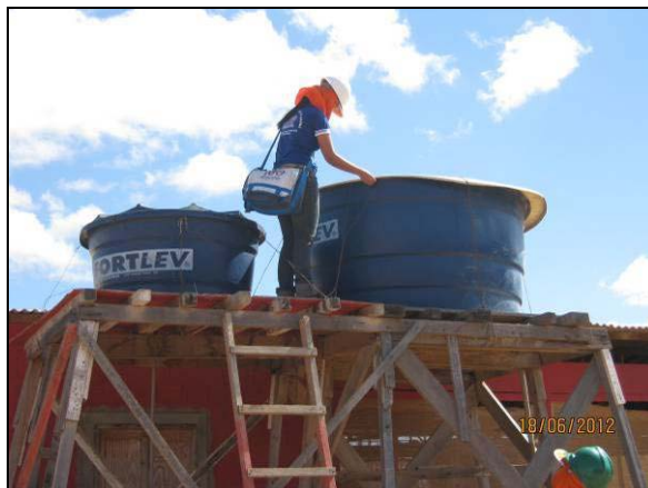
Foto 4.21.241. Fiscalização, por agente de saúde municipal de Petrolândia – PE, nas caixas d'água potável do canteiro de obras e frentes de serviço (jun/2012).
