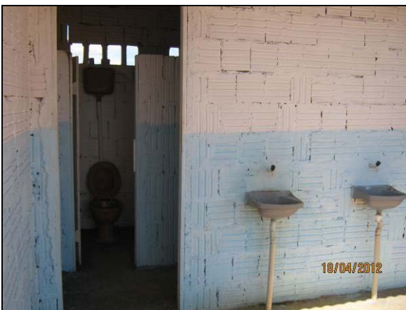
Foto 4.21.315. Banheiros disponíveis aos colaboradores da obra (abr/2012).
