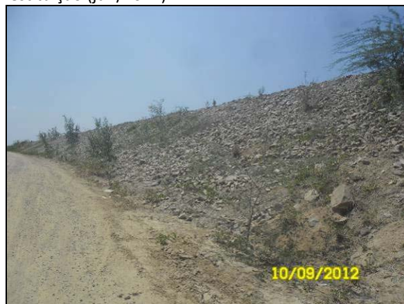
Foto 4.27.86. Enrocamento como medida preventiva a processos erosivos nos taludes de canal (set/2012).
