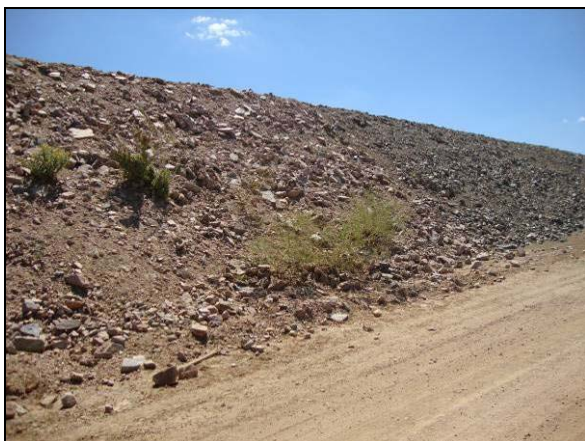
Foto 4.27.22. Estabilização de talude de canal com enrocamento de material granular (mai/2012).
