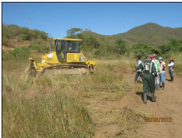
Foto 4.10.90. Supressão mecanizada na área do desemboque do túnel Cuncas II (jun/2012).
