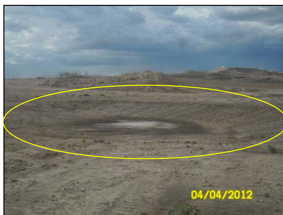
Foto 4.27.15. Construção de bacias de captação de águas pluviais na área BF-05-CL (abr/2012).
