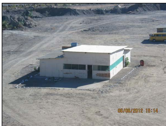
Foto 4.21.14. Estrutura de apoio, disponível aos colaboradores das frentes de obras do reservatório Tucutu (jun/2012).
