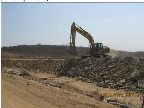
Foto 4.27.33. Reconformação de talude de canal para aplicação de enrocamento (set/2012)
