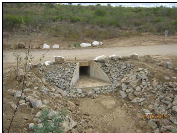
Foto 4.27.84. Enrocamento como medida preventiva nos taludes marginais aos bueiros e nos canais de restituição (jun/2012).
