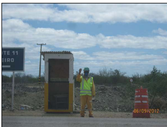
Foto 4.21.172. Sinalização manual para cruzamento de veículos pela BR 232 (set/2012)
