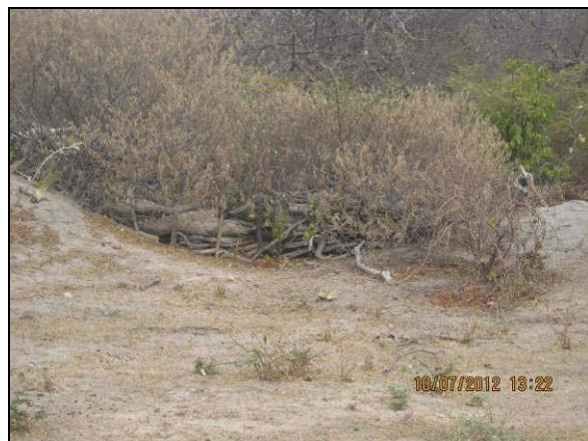
Foto 4.27.23. Cerca paliçada para contenção do carreamento do solo e estabilização (Jul/2012).
