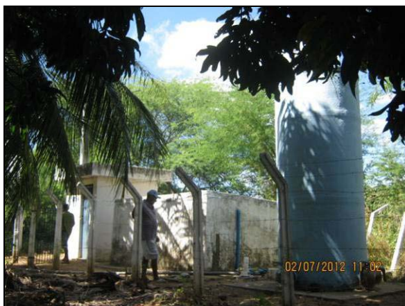
Foto 4.12.11. Sistema de abastecimento de água da aldeia Caatinguinha, etnia Truká (jul/2012).
