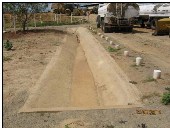
Foto 4.27.68. Canaleta trapezoidal para escoamento pluvial na lateral da via de acesso (jul/2012).
