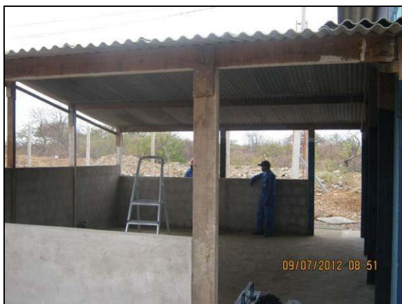
Foto 4.21.64. Construção da sala de vivência no canteiro de obras (jul/2012).
