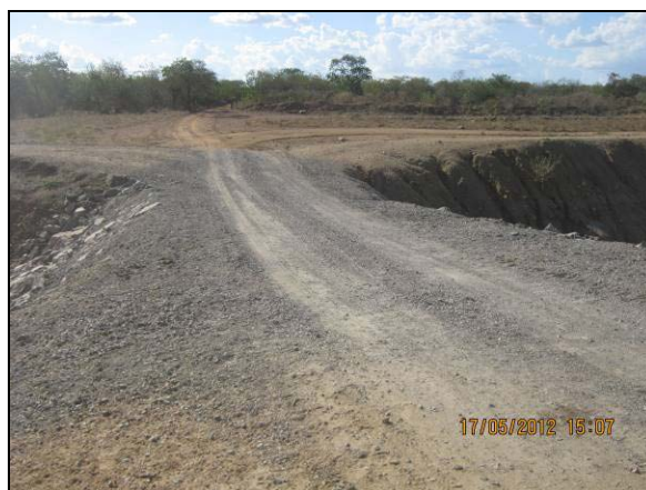
Foto 4.34.5. Estrada vicinal (EN-I-023) no WBS 1208 em funcionamento (maio/2012).
