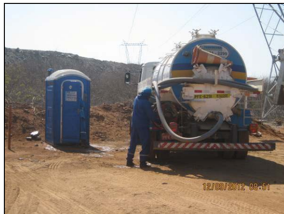
Foto 4.21.117. Banheiros em manutenção disponível aos colaboradores de obras e serviço (set/2012).
