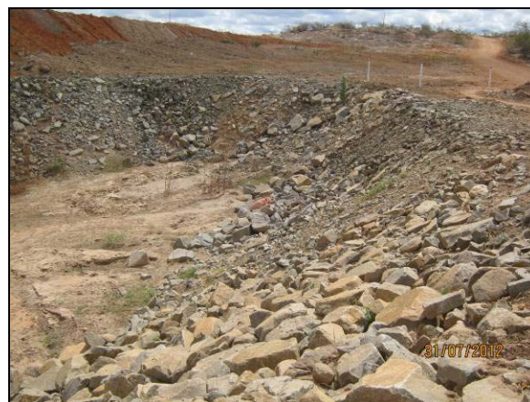
Foto 4.27.66. Enrocamento de talude como método preventivo a processos erosivos nas adjacências do bueiro 13 (jul/2012).
