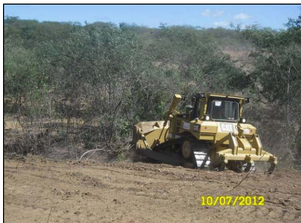
Foto 4.10.61. Supressão vegetal mecanizada na jazida JSV1 (jul/2012).
