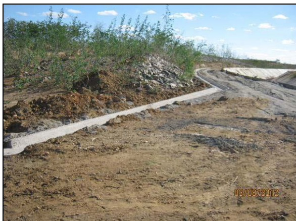
Foto 4.27.83. Canaletas trapezoidais implantadas na base dos taludes nas vias de serviço do canal (ago/2012).
