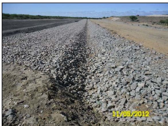
Foto 4.27.3. Instalação de canal de drenagem e enrocamento margeando o canal de aproximação (mai/2012).
