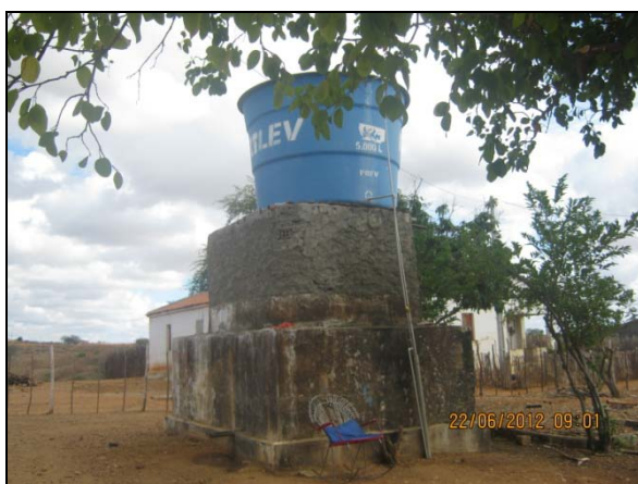
Foto 4.18.1. Reservatório para distribuição de água por gravidade, atendendo 20% das famílias na comunidade Monte Alegre, Salgueiro – PE (jun/2012).
