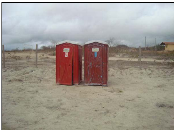
Foto 4.21.296. Disponibilização de banheiros químicos aos colaboradores da obra (ago/2012).
