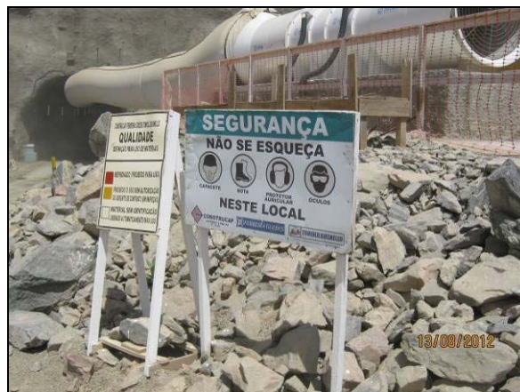
Foto 4.21.253. Placa informativa de conduta dos trabalhadores na frente de serviço do desemboque do túnel Cuncas II. (ago/2012).
