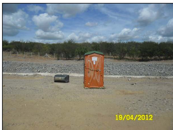
Foto 4.21.11. Banheiro químico disponibilizado na frente de serviço do canal de aproximação – WBS 1204 (abr/2012).
