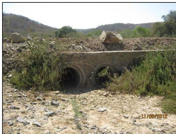
Foto 4.27.101. Enrocamento superior e lateral ao sistema de drenagem na via de acesso ao bota-fora da janela do túnel Cuncas I (set/2012).
