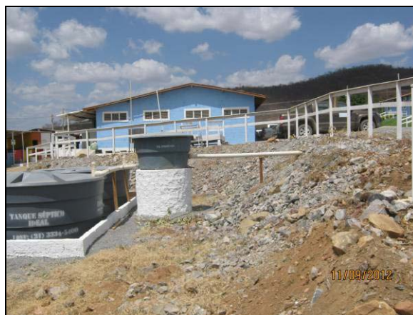
Foto 4.27.108. Enrocamento de talude como medida preventiva a processos erosivos (set/2012).
