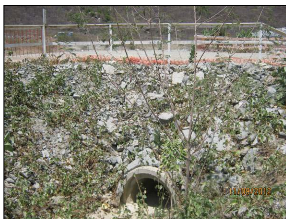
Foto 4.27.111. Enrocamento e revegetação em sistema de drenagem sob via de acesso (set/2012).
