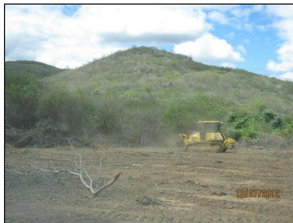
Foto 4.10.84. Supressão vegetal mecanizada na área da janela do túnel Cuncas I (jul/2012).
