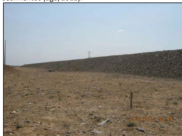
Foto 4.27.34. Talude enrocado, medida preventiva a instalação de processos erosivos e carreamento de solo (set/2012).
