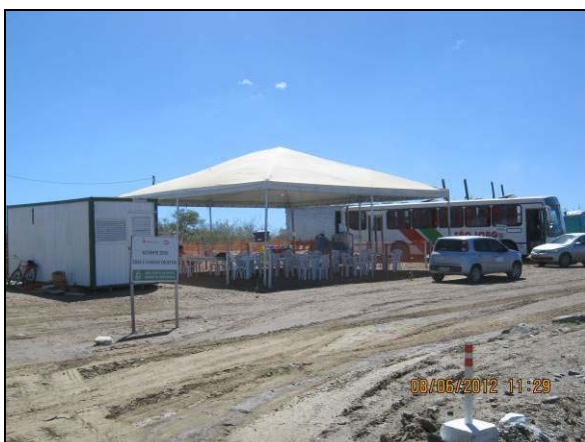
Foto 4.21.114. Estrutura de apoio de vivência na frente de serviço – EBI-2 (jun/2012).
