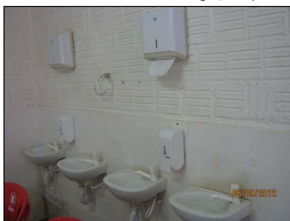
Foto 4.21.167. Banheiros disponíveis aos colaboradores no canteiro de obras (set/2012).
