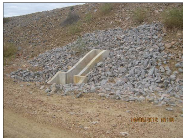
Foto 4.27.25. Medida de contenção de processos erosivos com enrocamento do talude em cabeceira de sistema de drenagem (ago/2012).
