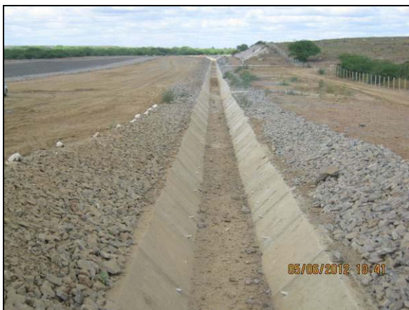
Foto 4.27.5. Canaleta trapezoidal de escoamento hídrico nas adjacências do canal de aproximação (jun/2012).
