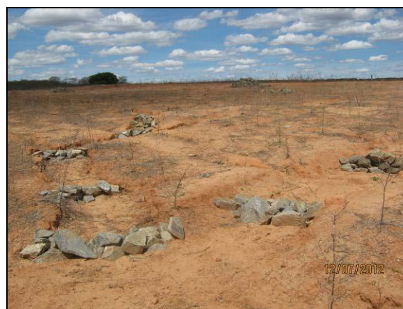
Foto 4.27.123. Implantação de dissipadores de energia em canal de escoamento superficial na área de recuperação da Jazida 04 (jul/2012).
