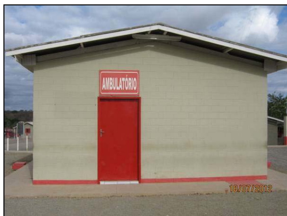
Foto 4.21.157. Visão externa do ambulatório médico para o atendimento dos colaboradores no canteiro de obras (jul/2012).
