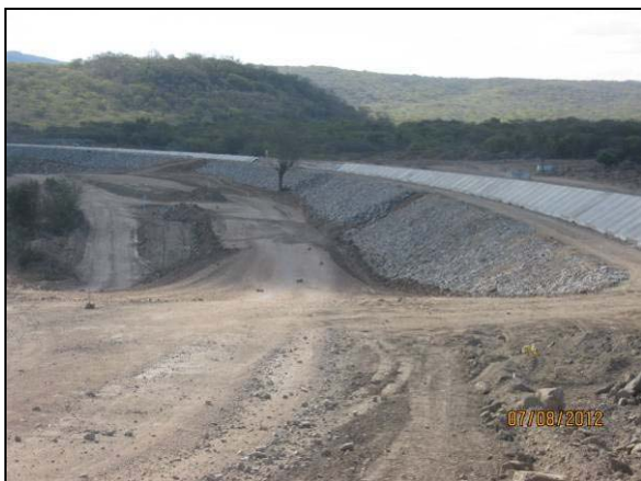
Foto 4.27.94. Enrocamento como medida preventiva a processos erosivos nos taludes do canal (ago/2012).
