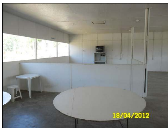
Foto 4.21.6. Sala de TV (abr/2012).
