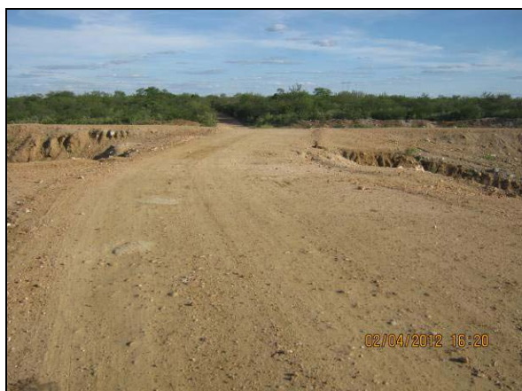
Foto 4.34.4. Estrada vicinal (EN-I-017) no WBS 1206 em funcionamento (abr/2012).
