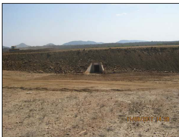
Foto 4.27.52. Talude reconformado (set/2012).
