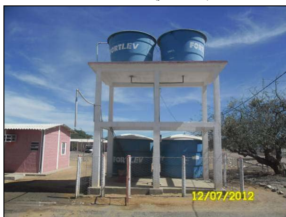
Foto 4.21.242. Armazenamento adequado da água utilizada pelos colaboradores do canteiro de obras (jul/2012).
