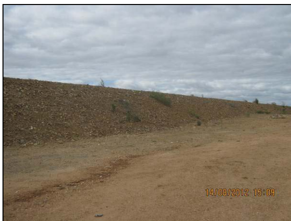
Foto 4.27.24. Enrocamento de talude, prevenção à implantação de processos erosivos e carreamento de sólidos (ago/2012).
