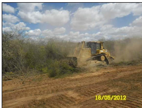
Foto 4.10.49. Supressão vegetal mecanizada no interior do reservatório Barro Branco (mai/2012).
