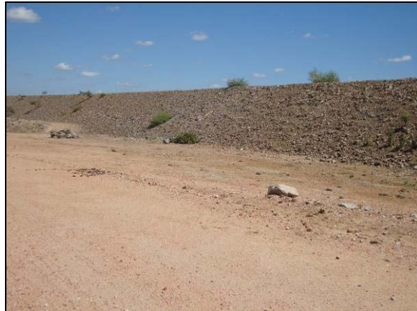
Foto 4.27.30. Talude de canal enrocado para dissipação das águas drenadas superficialmente (Jun/2012).
