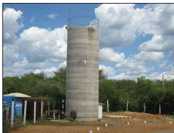
Foto 4.21.93. Armazenamento adequado da água para consumo dos colaboradores do canteiro de obras (abr/2012).
