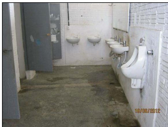
Foto 4.21.165. Banheiros disponíveis aos colaboradores no canteiro de obras (jun/2012).
