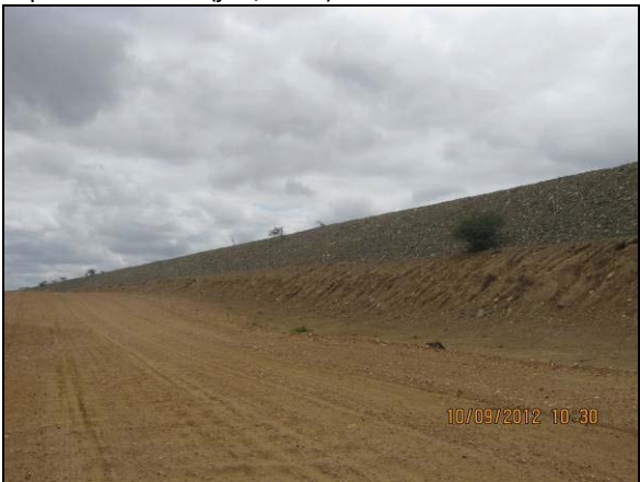
Foto 4.27.20. Enrocamento para estabilização de talude e dissipação de energia de águas drenadas superficialmente (set/2012).
