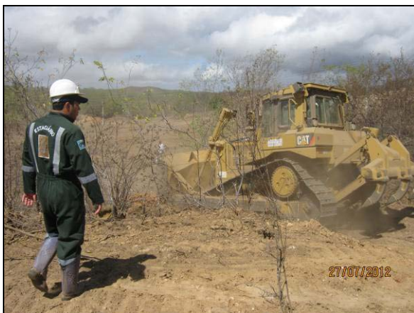
Foto 4.10.72. Acompanhamento pela equipe do CEMAFAUNA – UNIVASF da supressão vegetal mecanizada no WBS 2226 (jul/2012)
