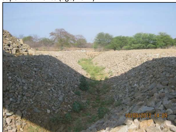
Foto 4.27.40. Estabilização de canal de drenagem por enrocamento (set/2012).
