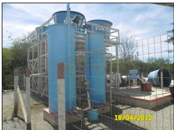
Foto 4.21.147. Armazenamento adequado da água a ser utilizada pelos colaboradores no canteiro de obras (abr/2012).
