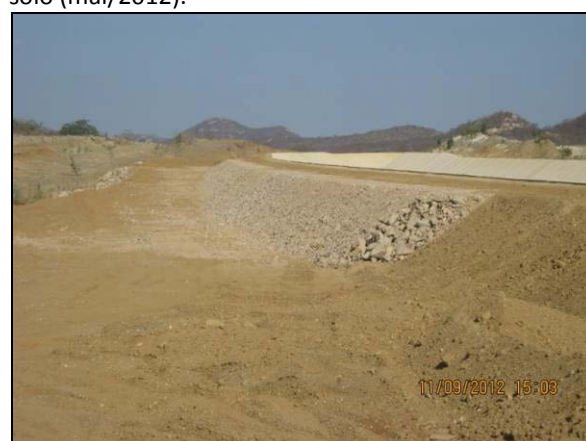
Foto 4.27.50. Disposição de material granular em talude de canal (set/2012).
