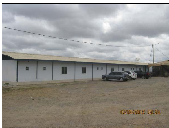
Foto 4.21.40. Área destinada ao alojamento dos colaboradores de obras e serviços (set/2012).
