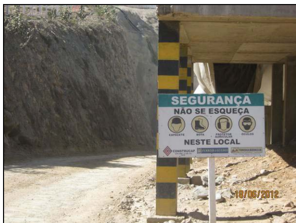
Foto 4.21.252. Placa informativa de conduta dos trabalhadores na frente de serviço da janela do túnel Cuncas I (jun/2012).
