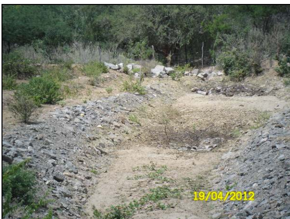
Foto 4.27.44. Estabilização de canal de restituição por enrocamento e implantação de filtro de rocha (abr/2012).
