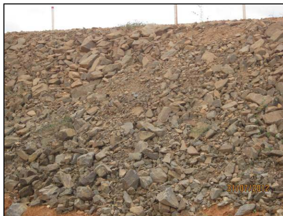
Foto 4.27.60. Implantação de rocha para estabilização de talude e dissipação de energia de águas pluviais do bueiro 21 (jul/2012).
