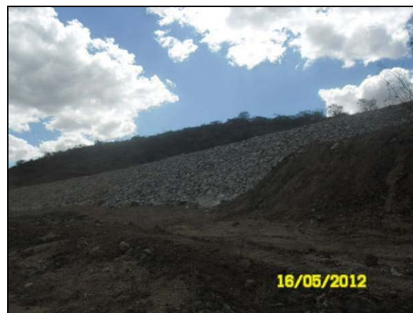
Foto 4.27.89. Talude de canal enrocado como medida preventiva a instalação de processos erosivos (mai/2012).
