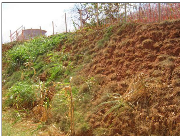
Foto 4.27.115. Revestimento vegetal no talude do ambulatório do canteiro auxiliar (set/2012).
