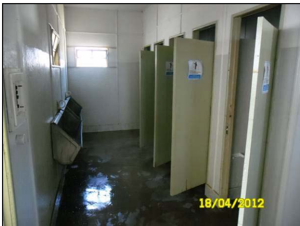
Foto 4.21.1. Banheiro disponível aos colaboradores nos alojamentos (abr/2012).
