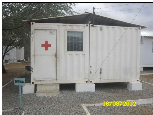
Foto 4.21.32. Ambulatório médico para o atendimento dos colaboradores no canteiro de obras (ago/2012).
