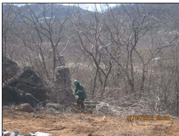
Foto 4.10.40. Supressão manual de vegetação arbustiva na área do bota-fora do reservatório Negreiros (ago/2012).
