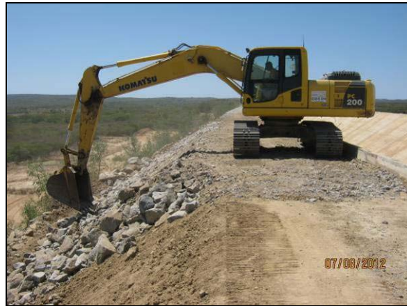
Foto 4.27.91. Implantação de material granular em talude de canal como medida preventiva a processos erosivos (ago/2012).
