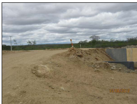
Foto 4.34.19. Desvio provisório construído pelo Consórcio Construtor sobre trecho do WBS 2218, permitindo o deslocamento da comunidade (ago/2012).
