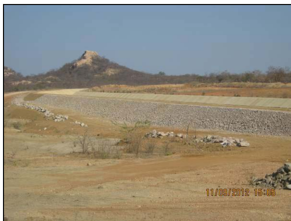
Foto 4.27.51. Talude enrocado, medida preventiva a instalação de processos erosivos (set/2012).
