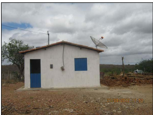
Foto 4.12.5. Casa concluída, aldeia Alto do Gavião, etnia Truká (ago/2012).
