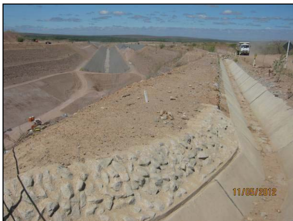
Foto 4.27.98. Canaleta trapezoidal implantada como medida preventiva a processos erosivos (mai/2012).
