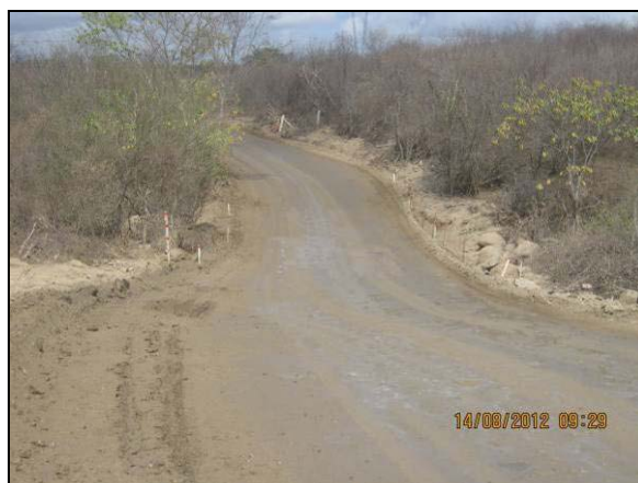
Foto 4.27.70. Passagem molhada implantada em estrada de acesso ao reservatório Negreiros (ago/2012).
