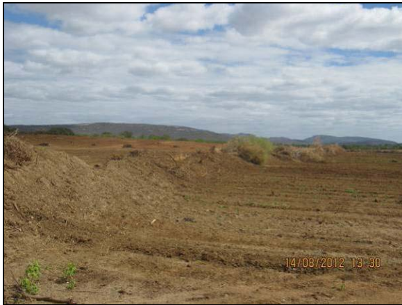
Foto 4.10.17. Armazenamento de solo orgânico no interior da área suprimida do reservatório Terra Nova (ago/2012).
