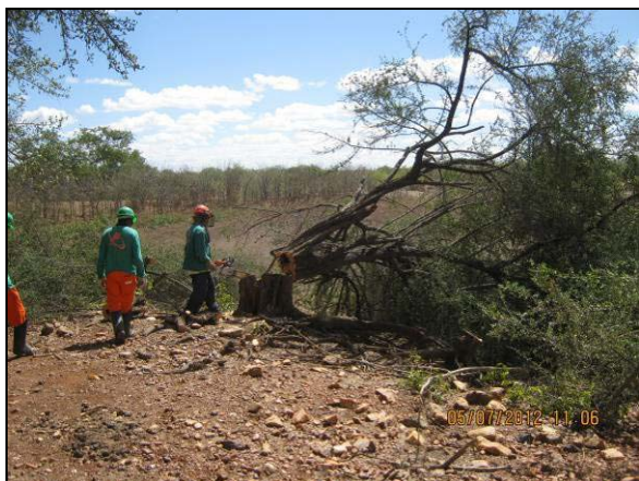
Foto 4.10.11. Supressão vegetal semimecanizada no WBS 1211 (jul/2012).
