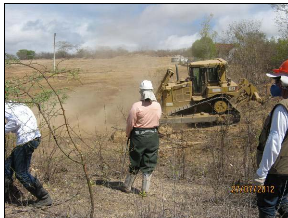
Foto 4.10.73. Acompanhamento pela equipe do CEMAFAUNA – UNIVASF da supressão vegetal mecanizada no WBS 2226 (jul/2012).
