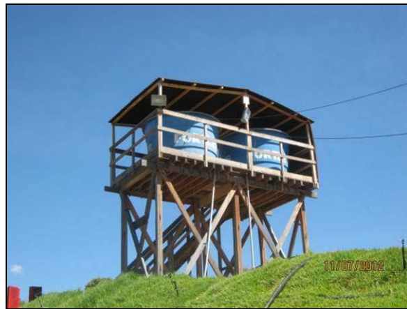
Foto 4.21.276. Armazenamento adequado da água para consumo dos colaboradores do canteiro de obras (jul/2012).
