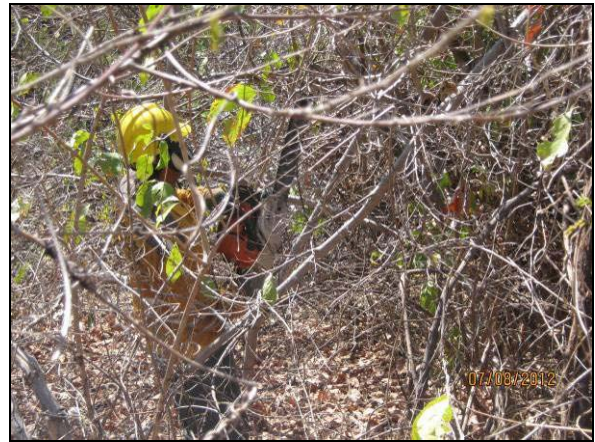
Foto 4.10.98. Supressão semimecanizada na área do emboque do Cuncas II (ago/2012).
