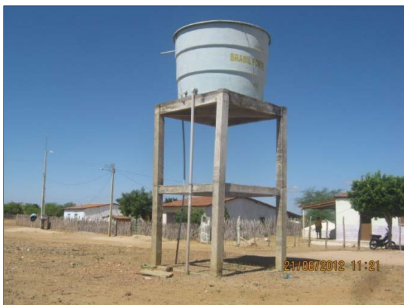
Foto 4.15.5. Estrutura de reservação e distribuição de água do Projeto de Assentamento Riacho dos Bois, Cabrobó - PE.
