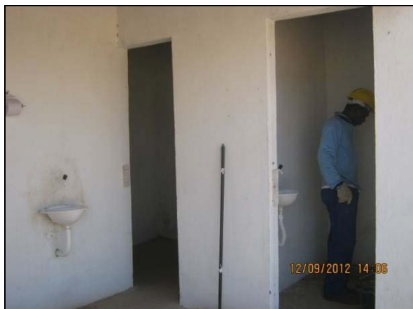
Foto 4.21.302. Banheiros e vestiários disponíveis aos colaboradores da obra (set/2012).
