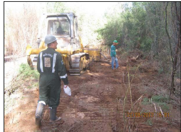
Foto 4.10.20. Acompanhamento da supressão mecanizada pela equipe do CEMAFAUNA – UNIVASF no WBS 1212 (ago/2012).
