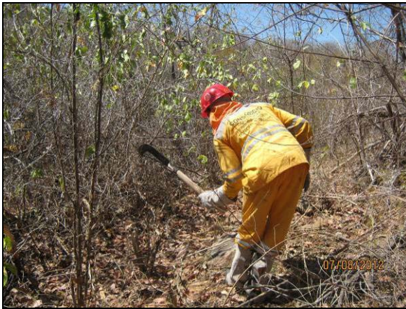
Foto 4.10.97. Supressão manual na área do emboque do Cuncas II (ago/2012).
