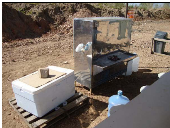
Foto 4.21.47. Bebedouro disponibilizado na frente de obra no WBS 1219 (mai/2012).
