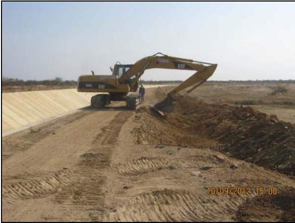
Foto 4.27.41. Reconformação de talude de canal para aplicação de enrocamento (set/2012).
