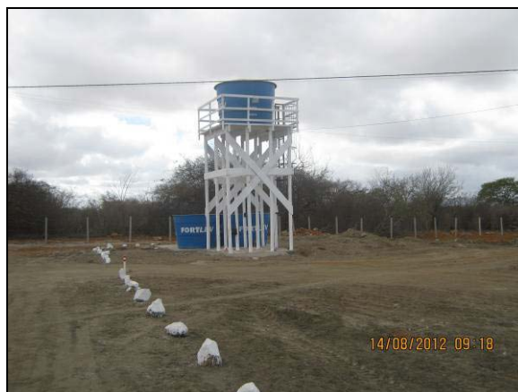
Foto 4.21.122. Reservatório para os alojamentos no canteiro - CCL8 (ago/2012).
