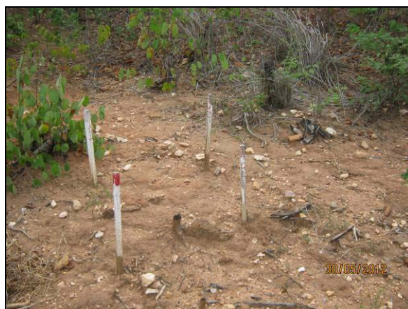
Foto 4.10.89. Estaca de demarcação da poligonal a ser suprimida do desmatamento do túnel Cuncas II a (mai/2012).
