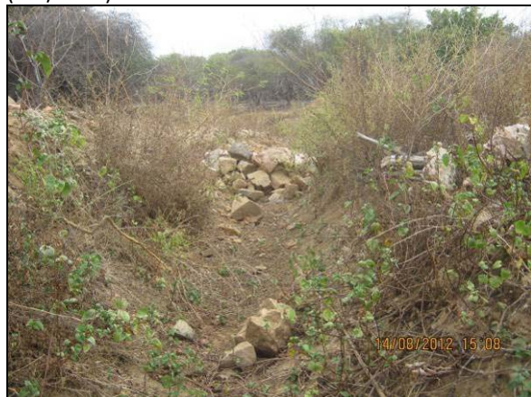
Foto 4.27.32. Abatimento de material rochoso como redutor de velocidade de água e carreamento de sedimentos (ago/2012).
