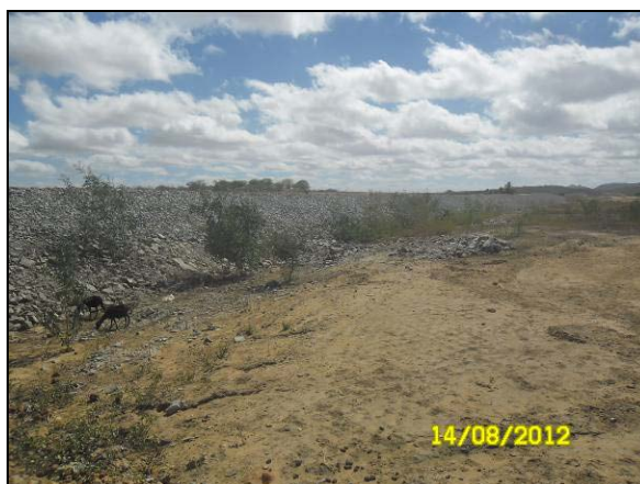
Foto 4.27.77. Enrocamento como método preventivo de erosão nos taludes do reservatório Cacimba Nova (ago/2012).
