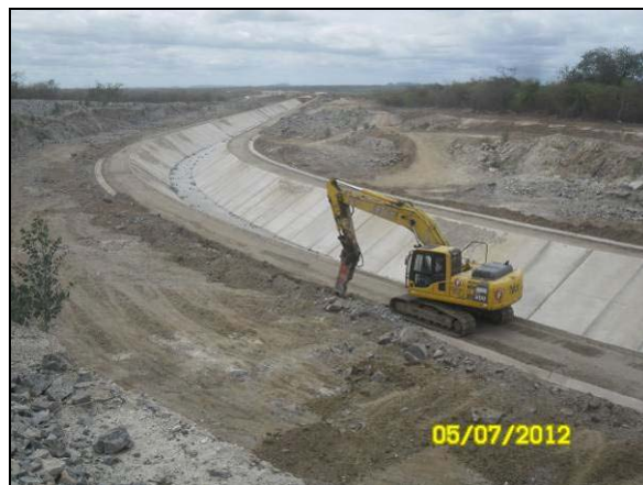
Foto 4.27.82. Abertura das canaletas nas vias de serviço do canal (jul/2012).
