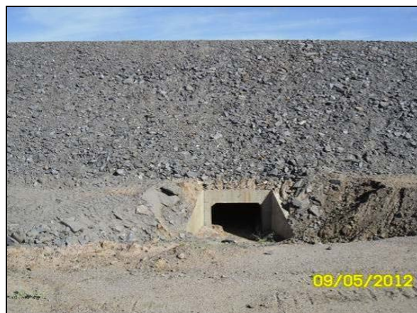
Foto 4.27.54. Medida de contenção de processos erosivos com enrocamento do talude em cabeceira de sistema de drenagem (mai/2012).
