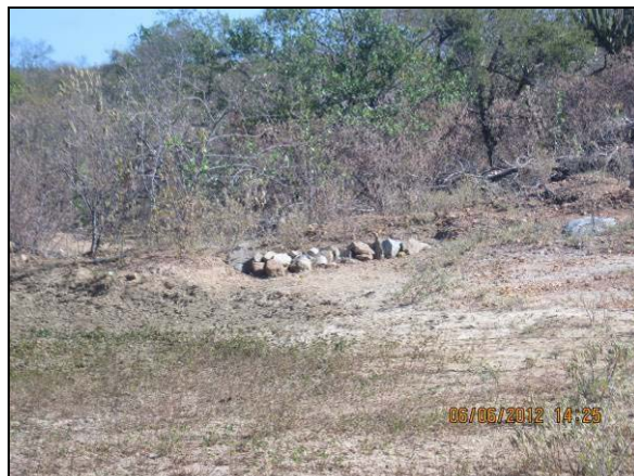
Foto 4.27.36. Barreira física atuando como retentor de solo e dissipador de energia (jun/2012).
