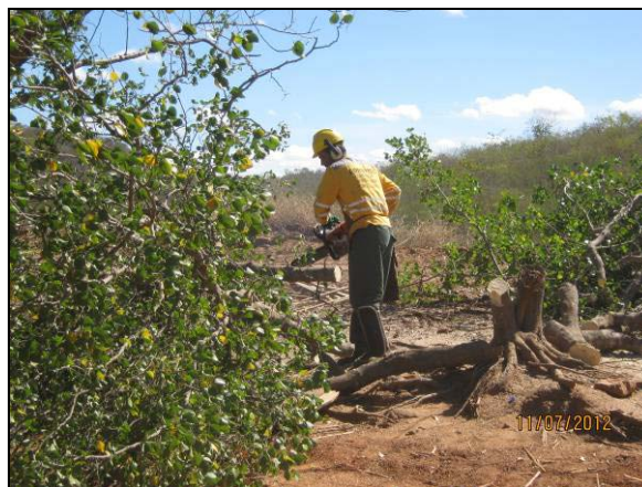
Foto 4.10.92. Supressão vegetal semimecanizada na área do desemboque do túnel Cuncas II (jul/2012).
