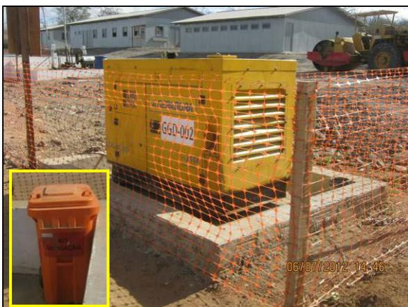
Foto 4.2.244. Bacia de contenção construída para disposição de gerador e disponibilidade de kit mitigação no canteiro de apoio da EBI-02 (jul/2012).
