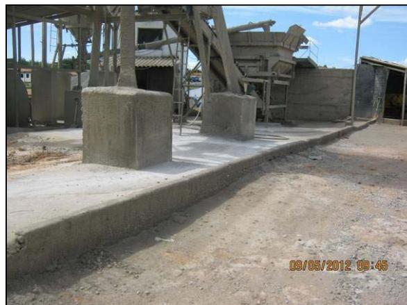
Foto 4.2.190. Mureta de contenção da central de concreto em condições adequadas (maio/2012).
