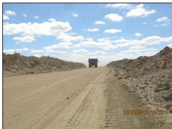
Foto 4.2.208. Via de acesso a EBI-2 bem dimensionada e em boas condições de conservação (jun/2012).
