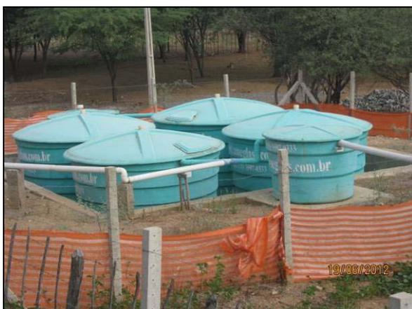
Foto 4.2.317. ETE (reator anaeróbico) instalada no canteiro de obras (jun/2012).
