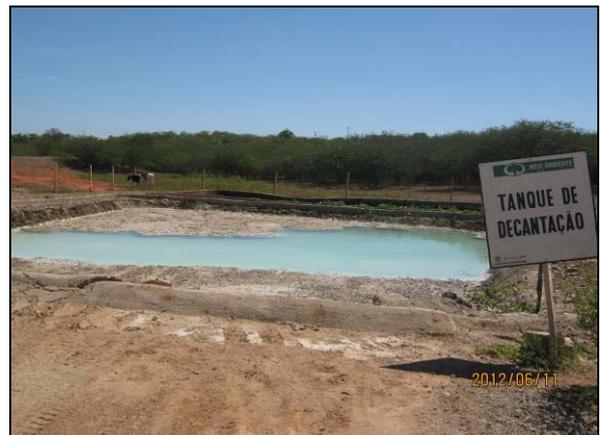
Foto 4.2.202. Tanque de decantação de efluentes oriundos da lavagem de caminhões betoneira em condições adequadas de funcionamento (jun/2012).
