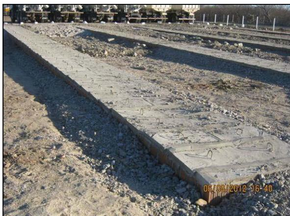
Foto 4.2.252. Disposição final dos efluentes gerados no canteiro por valas de infiltração (ago/2012).
