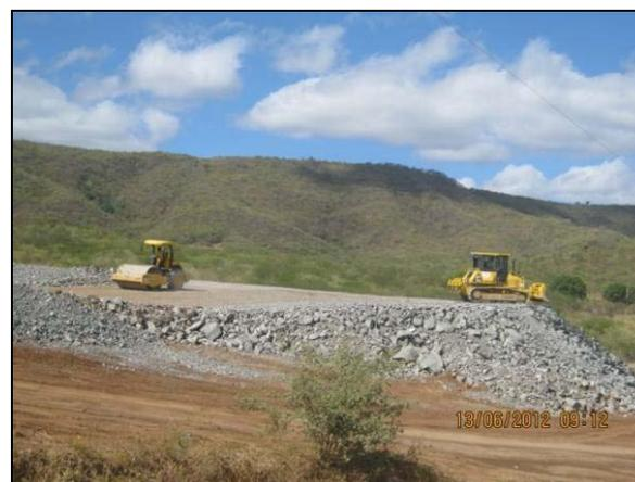
Foto 4.2.435. Conformação de bota-fora proveniente das escavações do desemboque do túnel Cuncas II (jun/2012).
