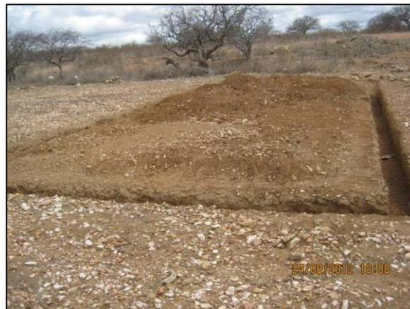
Foto 4.8.12. Escavação do alicerce para construção da associação da VPR Captação (ago/2012).
