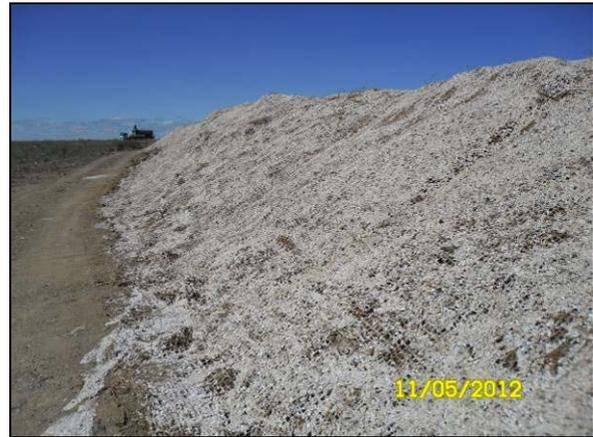
Foto 4.9.18. Talude revestido com material orgânico e sementes de gramíneas na área do BF 04-CN e BF 05-CN (mai/2012).
