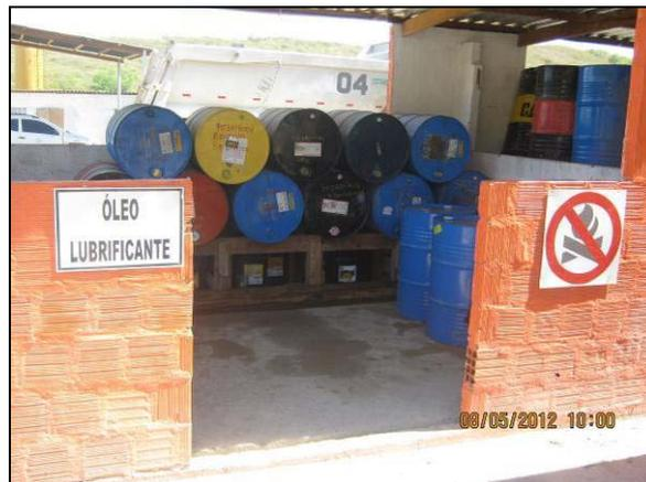
Foto 4.2.425. Baia para armazenamento de óleo usado com canaletas ligadas ao SAO do lava jato na janela do túnel Cuncas I (maio/2012).
