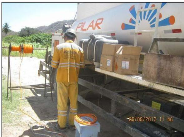
Foto 4.2.432. Manuseio de cordel detonante na frente de serviço do Desemboque do Túnel Cuncas II (ago/2012).
