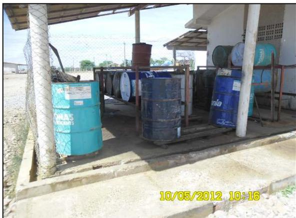
Foto 4.2.20. Baía para armazenamento de tambores com óleos lubrificantes com piso impermeabilizado e canaleta de drenagem (maio/2012).
