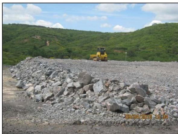
Foto 4.2.434. Bota-fora com material de 3ª categoria, janela do túnel Cuncas I (abr/2012).
