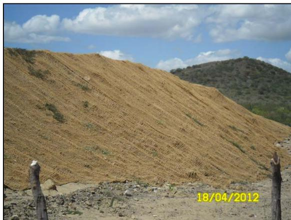
Foto 4.9.12. Implantação de biomanta para estabilização vegetativa em talude entre a área do britador e o BF 05-CN (abr/2012).
