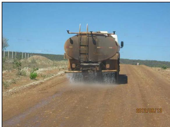
Foto 4.2.168. Umectação de via de acesso visando minimizar a suspensão de material particulado, WBS 1231 (jun/2012).
