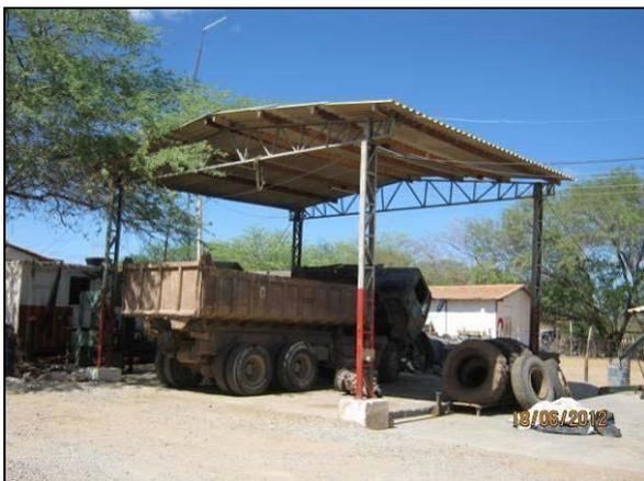
Foto 4.2.47. Oficina mecânica coberta e com piso impermeabilizado (jun/2012).
