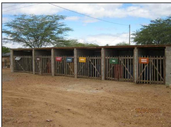
Foto 4.2.59. Baias para segregação e acondicionamento temporário no canteiro de obras (abr/2012).
