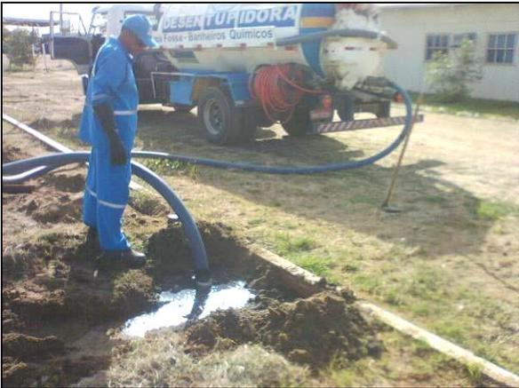
Foto 4.2.28. Limpeza e manutenção do sistema de tratamento dos efluentes domésticos composto por fossas sépticas e filtro anaeróbio (abr/2012).
