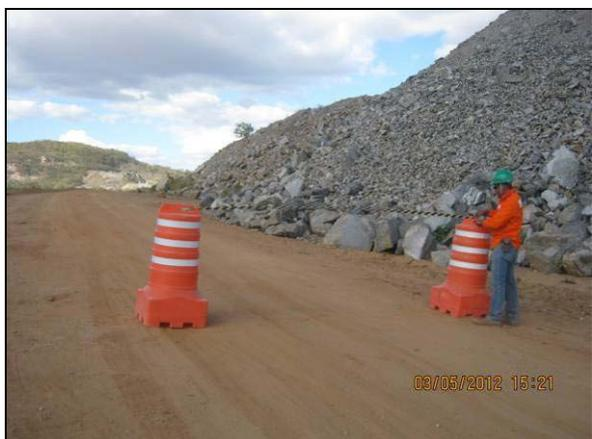
Foto 4.2.256. Barreira de segurança implantada em via de acesso da EBI-3 durante os procedimentos de desmonte de rocha (maio/2012).
