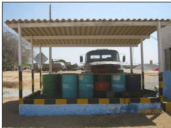
Foto 4.2.58. Baia para armazenamento de produtos perigosos coberta e com piso impermeabilizado (set/2012).
