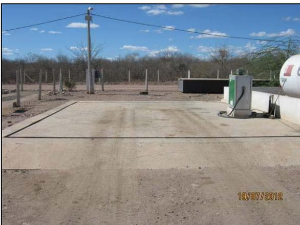
Foto 4.2.380. Canaletas do posto de abastecimento do canteiro de obras em boas condições de manutenção (jul/2012).
