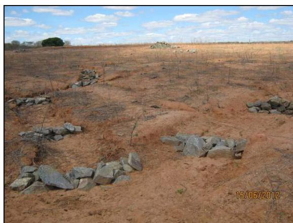
Foto 4.9.83. Filtro de rocha e dissipador de energia para contenção de processo erosivo no interior da jazida (jun/2012).
