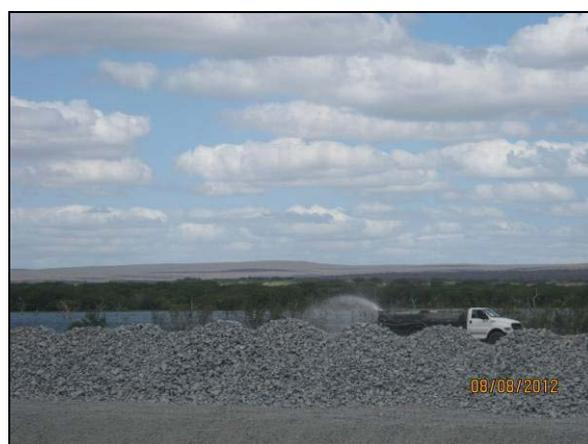
Foto 4.2.36. Umectação para controle do material particulado em via de acesso do Canal de aproximação – WBS 2204 (ago/2012).
