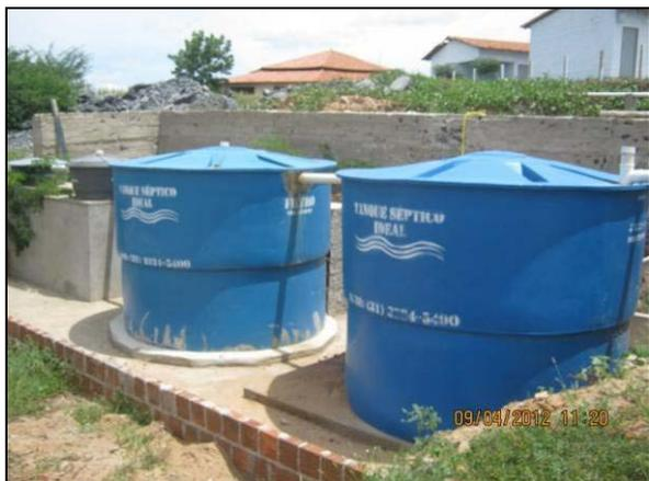
Foto 4.2.416. Sistema de tratamento de esgoto do alojamento do canteiro de obras em operação (abr/2012).
