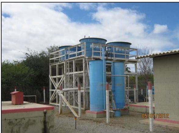
Foto 4.2.275. Estruturas da ETA composta por dupla filtração, na área do canteiro de obras (jul/2012).
