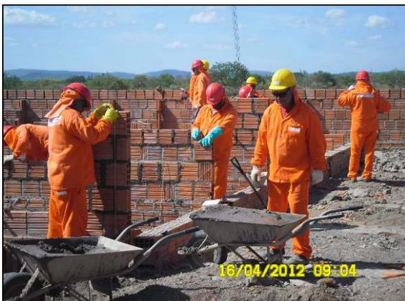
Foto 4.2.218. Utilização de EPI pelos colaboradores na construção do canteiro central (abr/2012).
