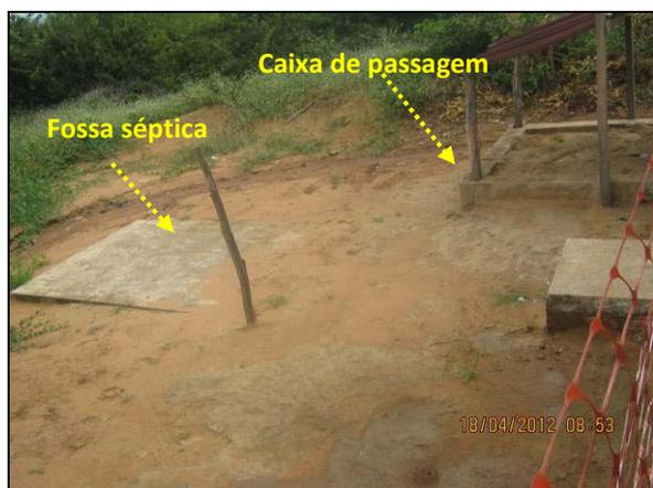
Foto 4.2.497. Fossa séptica utilizada para o tratamento de efluentes proveniente da estrutura de apoio (abr/2012).
