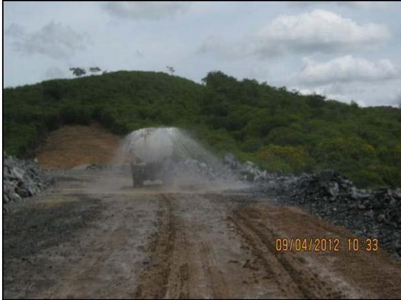
Foto 4.2.386. Umedecção em via de acesso que interliga bota-fora e estrutura de apoio, janela do túnel do Cuncas I (abr/2012).
