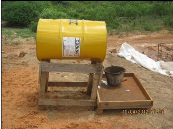
Foto 4.2.199. Disposição temporária de aditivo de concreto contendo bacia de contenção com serragem, WBS 1229 (abr/2012).
