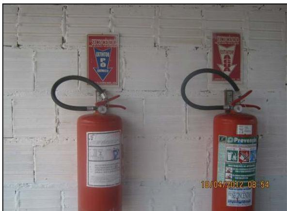
Foto 4.2.489. Extintores bem sinalizados na estrutura de apoio (abr/2012).
