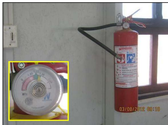
Foto 4.2.127. Extintor de incêndio no refeitório em condições adequadas (ago/2012).
