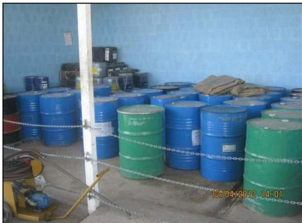
Foto 4.2.424. Baia para armazenamento de produtos perigosos na área do posto de abastecimento do canteiro de obras em conformidade (abr/2012).
