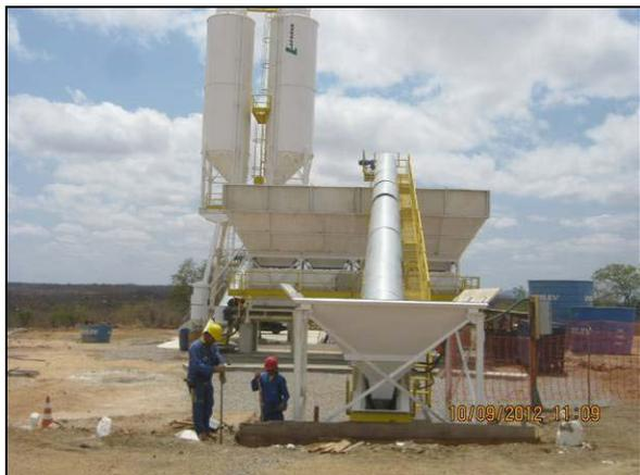
Foto 4.2.140. Montagem das estruturas da central de concreto, WBS 1214 (set/2012).
