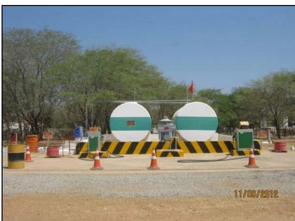
Foto 4.2.49. Posto de abastecimento com bacia de contenção, pista impermeabilizada, canaletas ligadas ao SAO e kit mitigação (set/2012).
