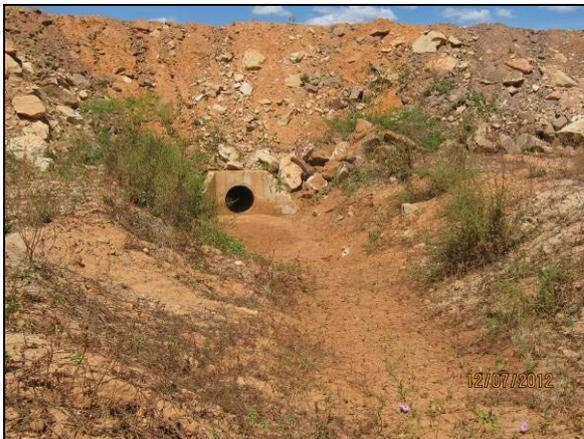
Foto 4.2.205. Bueiro 30, no WBS 1229, com manutenção adequada, garantindo o fluxo de curso hídrico intermitente (jul/2012).
