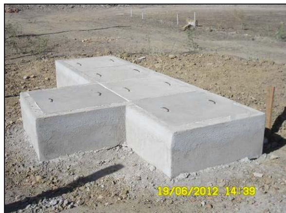
Foto 4.2.251. Sistemas Separadores Água e Óleo implantado no posto de abastecimento da EBI-01 (jun/2012).
