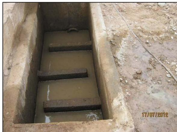
Foto 4.2.62. Separador de água e óleo do lavajato com manutenção adequada (jul/2012).
