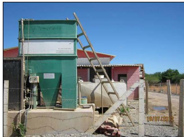
Foto 4.2.379. Estação de tratamento de água para reuso próximo ao lava jato do canteiro de obras (jul/2012).
