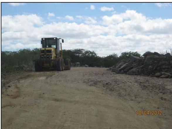
Foto 4.2.291. Manutenção em via de acesso do WBS 2220 com auxílio de máquina niveladora (abr/2012).
