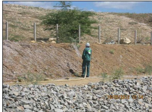
Foto 4.2.34. Recuperação do talude de corte com implantação de hidrossemeadura (maio/2012).
