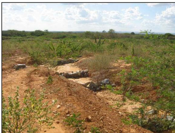
Foto 4.9.79. Filtros de rocha nas calhas de drenagem como dissipadores de energia e contentores de sedimentos na Jazida 02 (mai/2012).
