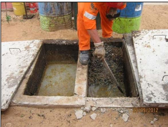
Foto 4.2.378. Colaborador realizando manutenção na caixa de gordura da cozinha do canteiro de obras (maio/2012).
