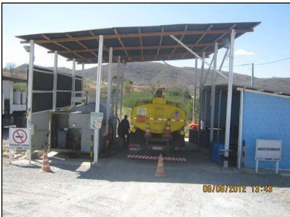
Foto 4.2.412. Área do posto de abastecimento coberta, devidamente sinalizada e com piso impermeabilizado no canteiro de obras (ago/2012).
