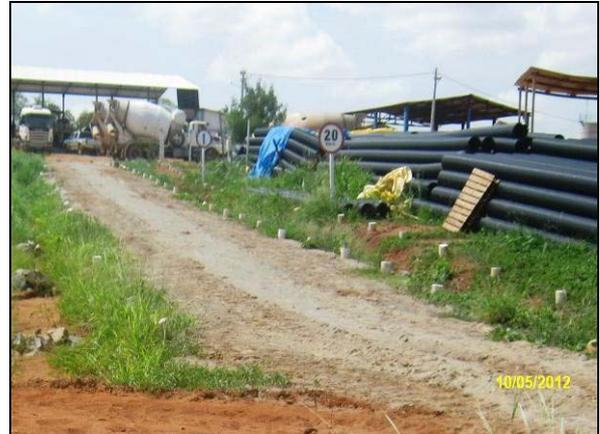
Foto 4.2.200. Utilização de material inerte para revestimento primário em via de acesso do canteiro de obras (maio/2012).
