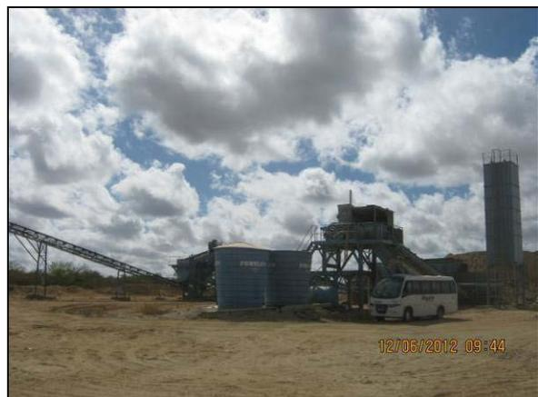
Foto 4.2.94. Usina de solo-cimento em funcionamento no segmento de canal WBS 1207
