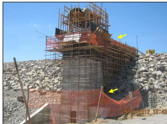
Foto 4.2.9. Implantação de tela sinalizadora durante a construção da tomada d'água no reservatório Tucutu (mai/2012).
