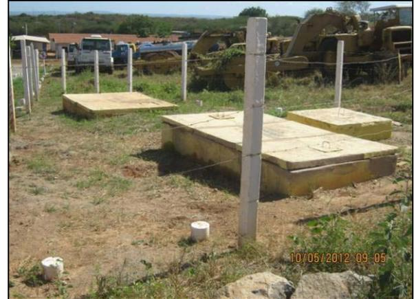
Foto 4.2.194. SAO que atende a oficina mecânica, lava jato e depósito de óleo com manutenção adequada. (maio/2012).
