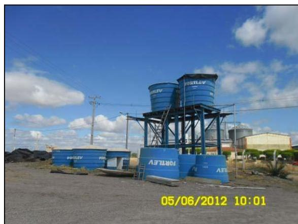
Foto 4.2.80. Reservatórios de água para o abastecimento do canteiro de obras (jun/2012).
