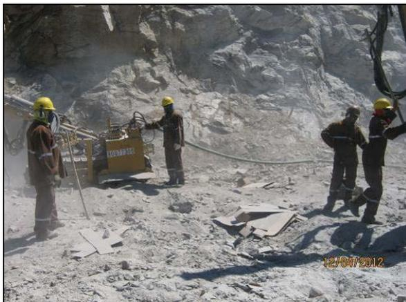
Foto 4.2.331. Colaboradores utilizando EPI durante perfuração em rocha no WBS 2226 (abr/2012).
