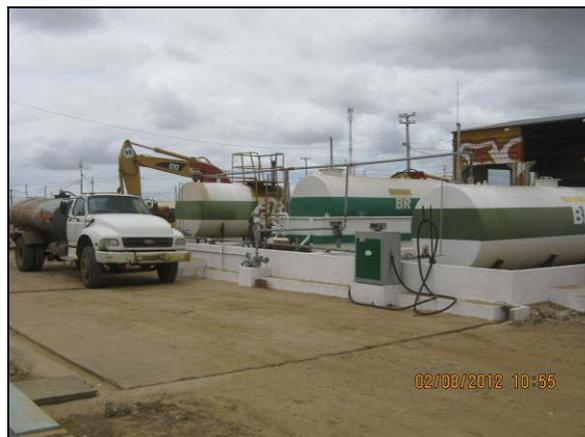
Foto 4.2.89. Posto de abastecimento com pista impermeabilizada e canaletas de direcionamento dos efluentes ao SAO (ago/2012).
