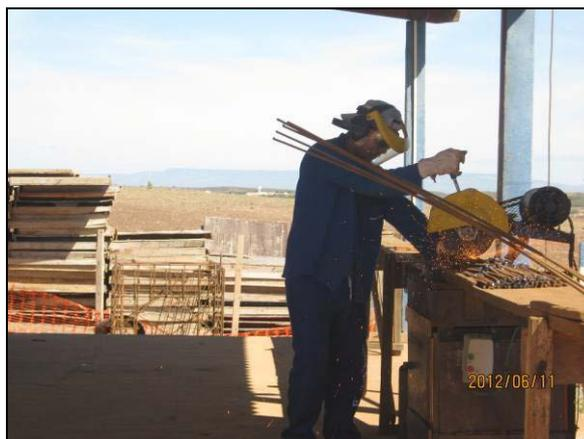
Foto 4.2.174. Colaborador com os EPI adequados em atividade com serra circular no canteiro de obras (jun/2012).
