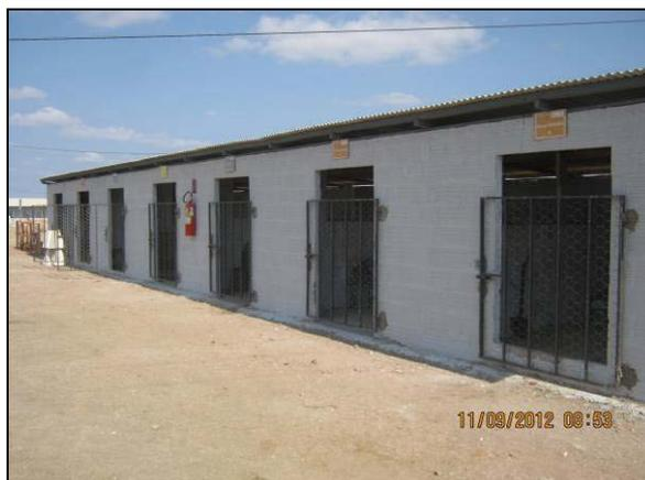
Foto 4.2.249. Construção das baias para armazenamento temporário de resíduos no canteiro de obras (set/2012).
