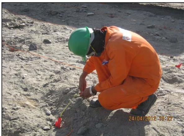
Foto 4.2.254. Montagem dos retardos nos cordéis de detonação (abr/2012).
