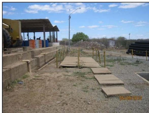
Foto 4.2.346. Separador de Água e Óleo do lava jato em condições adequadas de manutenção (set/2012).
