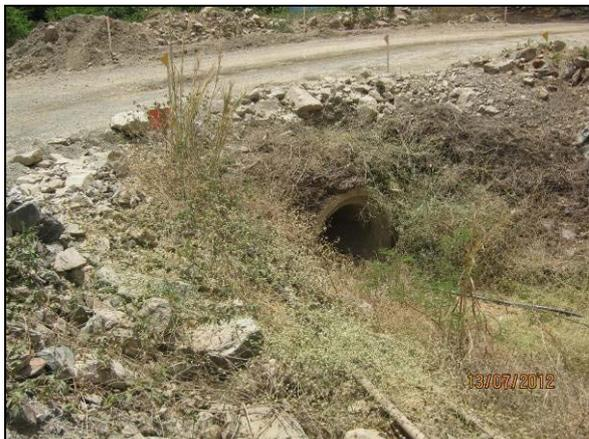
Foto 4.2.436. Bueiro implantado sob via de acesso na frente de serviço do Emboque do túnel Cuncas I, garantindo o fluxo de curso hídrico (jul/2012).
