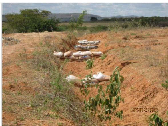
Foto 4.9.82. Dissipadores de energia e contentores de sedimentos em canal para escoamento pluvial no interior da Jazida 04 (mai/2012).
