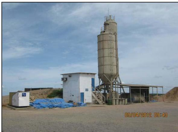
Foto 4.2.189. Central de concreto com piso impermeabilizado e canaletas de drenagem ligadas a bacia de decantação (abr/2012).
