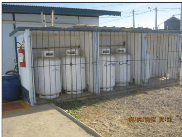
Foto 4.2.85. Botijões de gás armazenados de forma adequada (set/2012).
