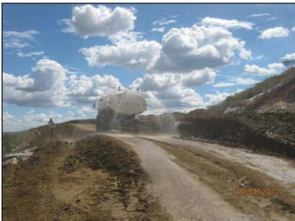
Foto 4.2.327. Umectação de via de acesso para controle do material particulado WBS 2224 (abr/2012).
