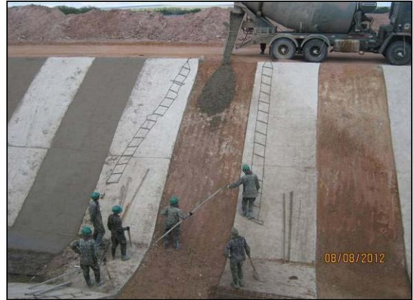
Foto 4.2.42. Uso de EPI por colaboradores durante atividade de concretagem no trecho I do Canal de Aproximação – WBS 2204 (ago/2012).
