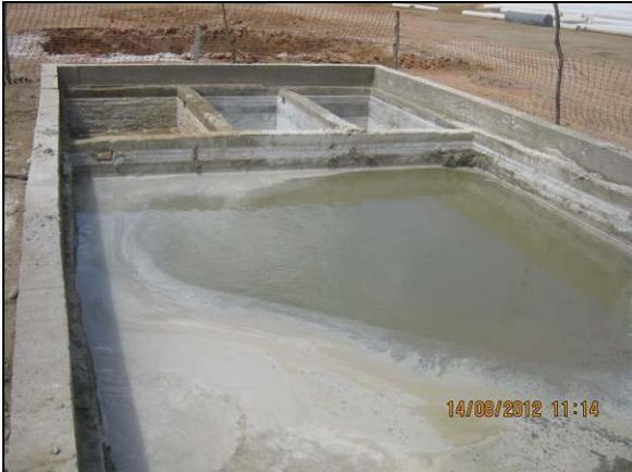
Foto 4.2.103. Tanque de sedimentação dos efluentes proveniente da lavagem dos caminhões betoneira (ago/2012).
