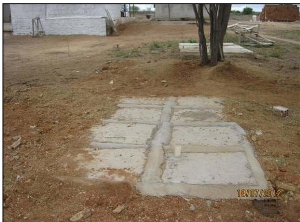
Foto 4.2.510. Fossa séptica utilizada para o tratamento de efluentes proveniente da estrutura de apoio (jul/2012).
