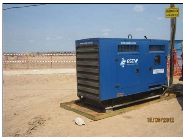
Foto 4.2.377. Grupo gerador utilizado nas obras da EBV-1, instalado sobre bandeja de contenção (set/2012).
