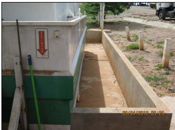
Foto 4.2.183. Mureta de contenção do tanque de combustível em condições adequadas de conservação (abr/2012).
