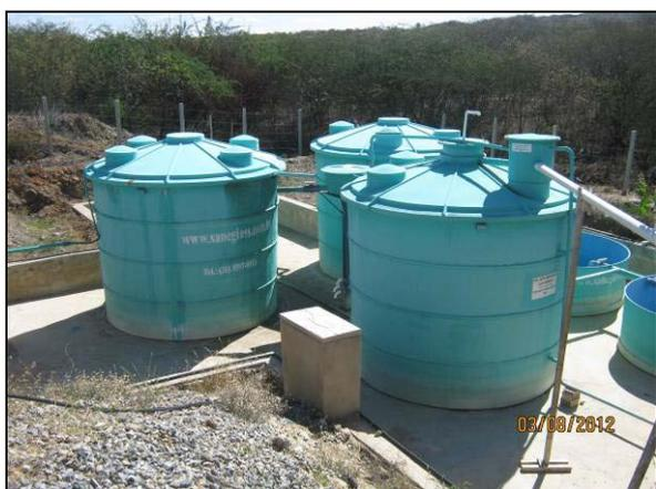
Foto 4.2.345. Estação de Tratamento de Esgoto (ETE) instalada no canteiro de obras (ago/2012).
