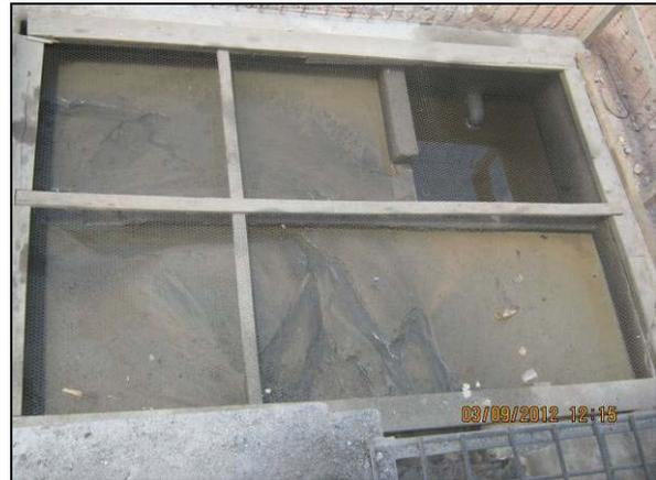
Foto 4.2.429. Manutenção adequada do SAO do lava jato do desemboque do túnel Cuncas II (set/2012).
