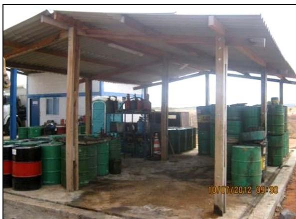
Foto 4.2.198. Área para armazenamento de óleo, com piso impermeabilizado e canaletas desobstruídas (jul/2012).
