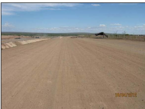
Foto 4.2.35. Via de acesso aplainada e reconformada, no Trecho III do Canal de Aproximação – WBS 2204 (abr/2012).
