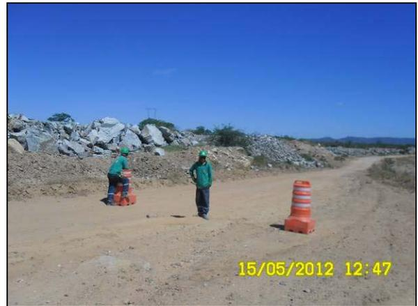
Foto 4.2.160. Barreira de segurança implantada em via de acesso durante os procedimentos de desmonte de rocha (maio/2012).
