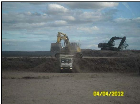
Foto 4.9.65. Retirada de solo para reconformação do terreno (abr/2012).
