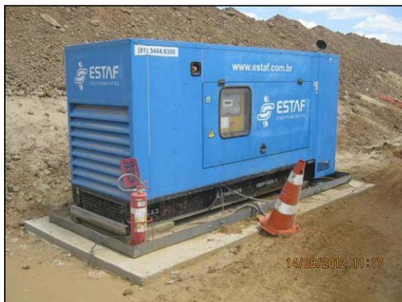
Foto 4.2.100. Gerador da central de concreto disposto sobre bandeja coletora (ago/2012).
