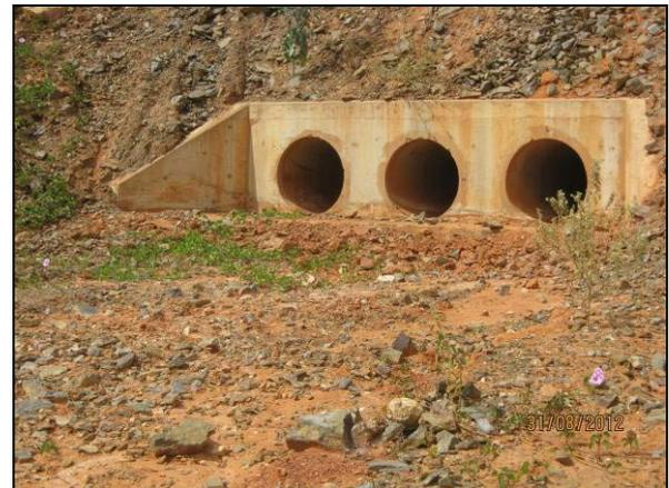
Foto 4.2.206. Bueiro 31, instalado sob o canal adutor possibilitando fluxo hídrico intermitente no WBS 1229 (ago/2012).
