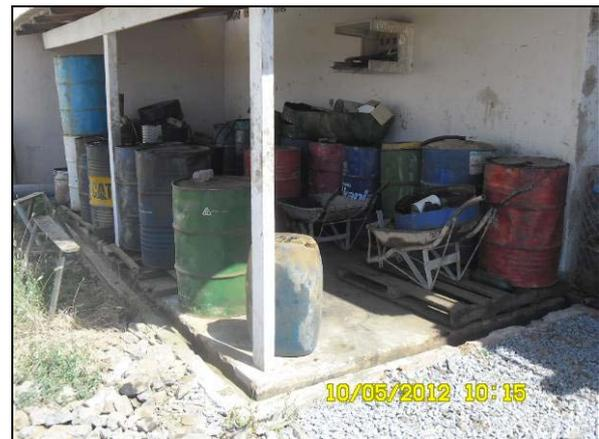
Foto 4.2.32. Área para armazenamento de óleo usado, com piso impermeabilizado e canaletas para direcionamento do efluente ao SAO (maio/2012).
