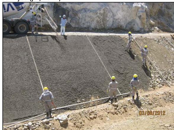
Foto 4.2.336. Colaboradores com uso de EPI adequados durante concretagem de canal, WBS 2224 (ago/2012).
