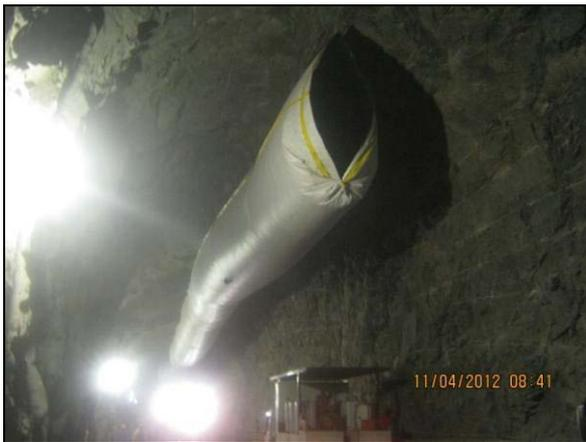
Foto 4.2.390. Substituição do duto de ventilação da frente de serviço da janela – WBS 1410, para manter o padrão de ventilação em espaço confinado (abr/2012).
