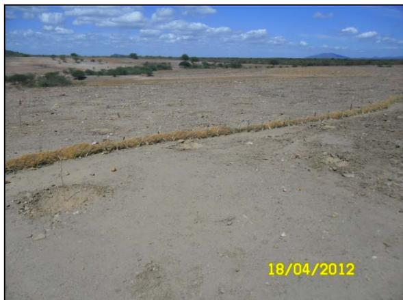
Foto 4.9.11. Implantação de retedores de sedimentos em curva de nível no BF 06-CN (abr/2012).
