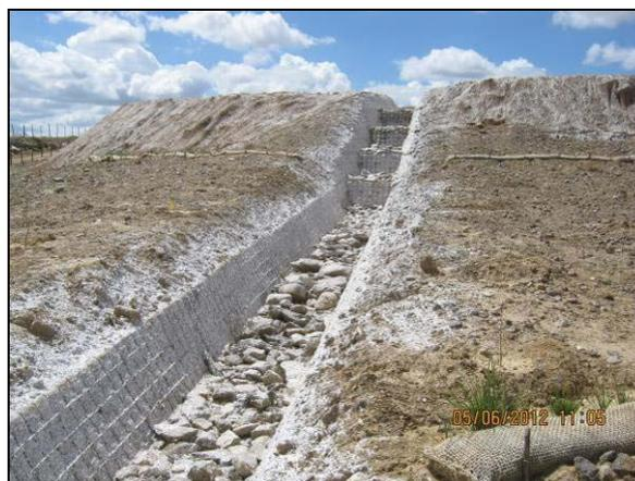
Foto 4.9.26. Hidrossemeadura aplicada nos taludes da ecocalha (BF 06-CN) (jun/2012).
