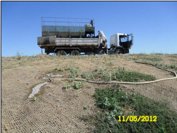
Foto 4.9.17. Aplicação de hidrossemeadura em talude de área em recuperação na área do britador (mai/2012).
