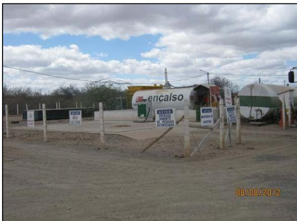
Foto 4.2.374. Posto de abastecimento sinalizado, pista impermeabilizada e bacia de contenção no canteiro de obras (ago/2012).
