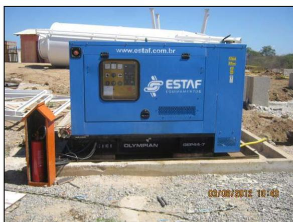
Foto 4.2.150. Gerador da central de concreto disposto sobre bacia de contenção (ago/2012).
