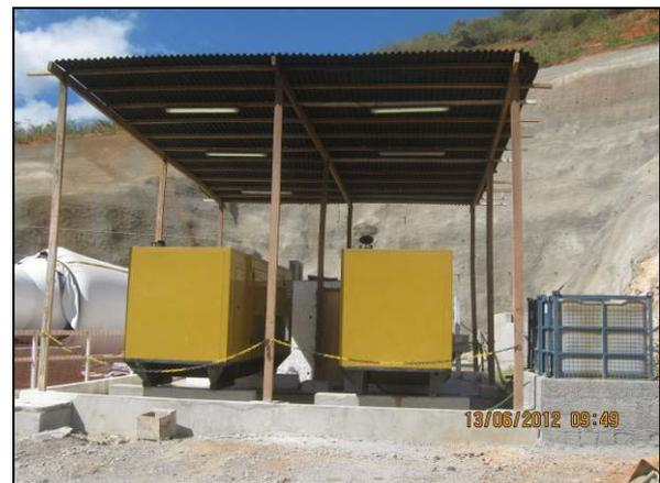
Foto 4.2.431. Bacia de contenção de grupo gerador no espelho do desemboque do túnel Cuncas II (jun/2012).
