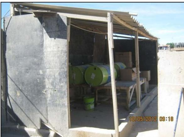
Foto 4.2.197. Local para armazenamento de aditivos de concreto com cobertura, piso impermeabilizado e caixa coletora de efluentes (maio/2012).
