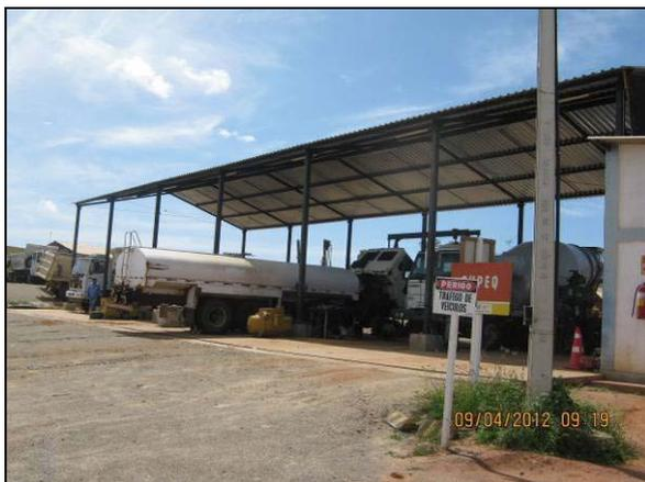
Foto 4.2.185. Oficina coberta, com piso impermeabilizado e canaletas de drenagem em condições adequadas (abr/2012).
