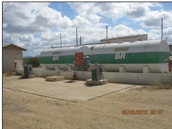
Foto 4.2.21. Posto de abastecimento com canaletas, bacia de contenção e extintor de incêndio (jun/2012).
