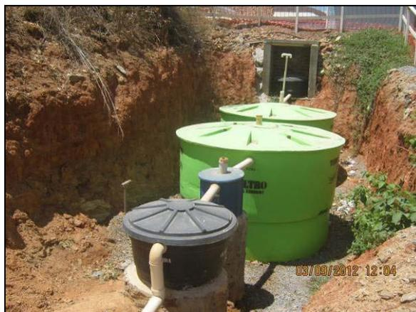
Foto 4.2.419. ETE que atende a estrutura de apoio do desemboque do túnel Cuncas II (set/2012).
