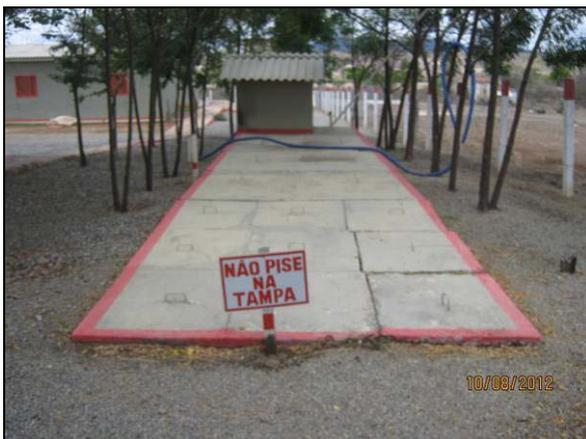
Foto 4.2.285. Tanque séptico para recebimento de efluentes do refeitório em condições adequadas de manutenção (ago/2012).
