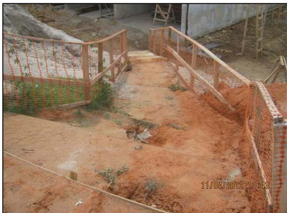
Foto 4.2.173. Instalação adequada de guarda corpo e corrimão em escada de acesso ao bueiro Palha – WBS 1355 (abr/2012).
