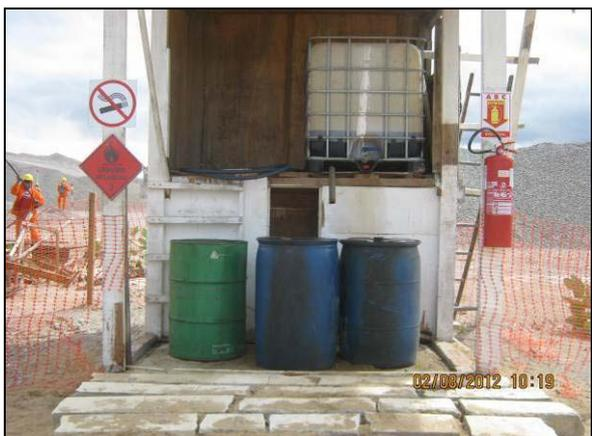
Foto 4.2.248. Tambores com resíduos perigosos armazenados em local específico na frente de serviço do britador, reservatório Tucutu (ago/2012).
