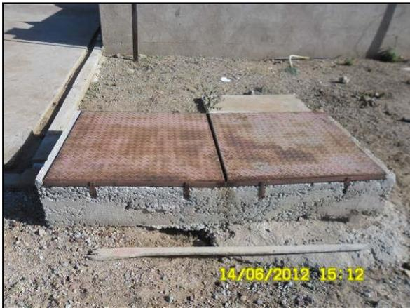
Foto 4.2.151. SAO do posto de abastecimento localizado na estrutura de apoio do WBS 1214 (jun/2012).
