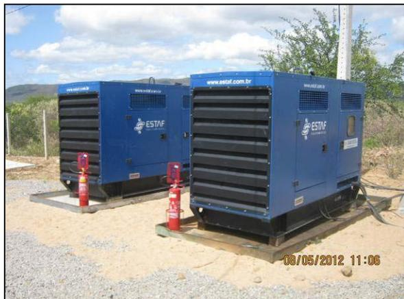
Foto 4.2.148. Grupos geradores do canteiro de apoio dispostos de forma adequada e disponibilidade de extintor de incêndio (maio/2012).
