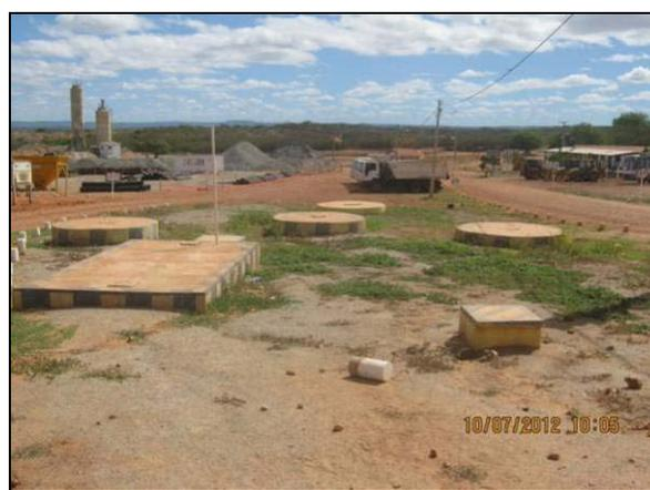
Foto 4.2.192. Sistema fossa-séptica/sumidouro que atende o refeitório em conformidade (jul/2012).
