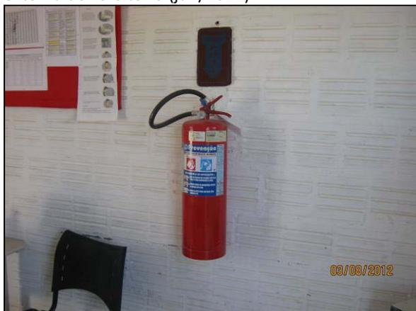
Foto 4.2.335. Extintor em condições adequadas na área interna do ambulatório (ago/2012).
