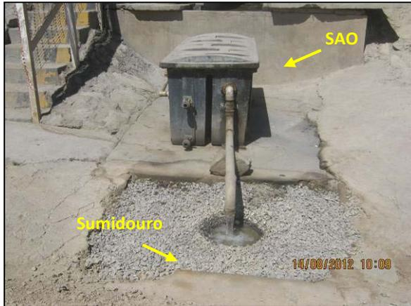
Foto 4.2.428. Sistema de tratamento de efluentes do lava jato da janela do túnel Cuncas I (ago/2012).
