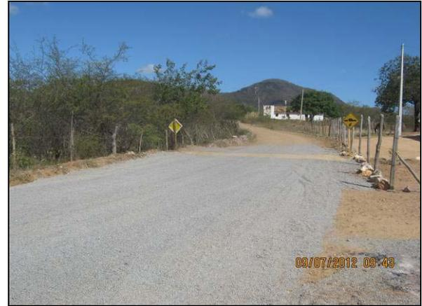
Foto 4.2.387. Melhoria realizada com aplicação de brita em via de acesso ao desemboque do túnel Cuncas II (jul/2012).
