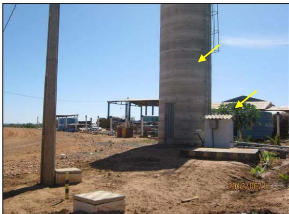
Foto 4.2.181. Reservatório de água e abrigo com bomba de sucção e dosador de cloro (jun/2012).
