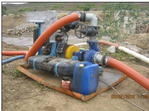
Foto 4.2.99. Motobomba disposta sobre bandeja coletora na frente de serviço do aqueduto Terra Nova (jul/2012).
