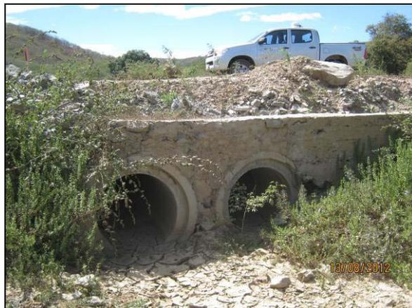
Foto 4.2.437. Drenagem com manutenção adequada sob via de acesso ao desemboque do túnel Cuncas II (ago/2012).
