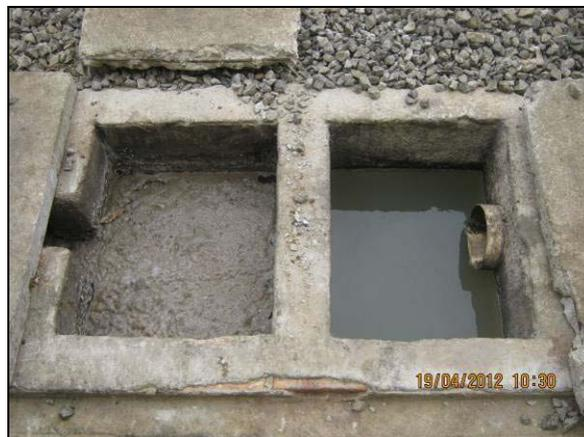
Foto 4.2.30. Caixa de gordura dos efluentes da cozinha condições adequadas de manutenção (abr/2012).
