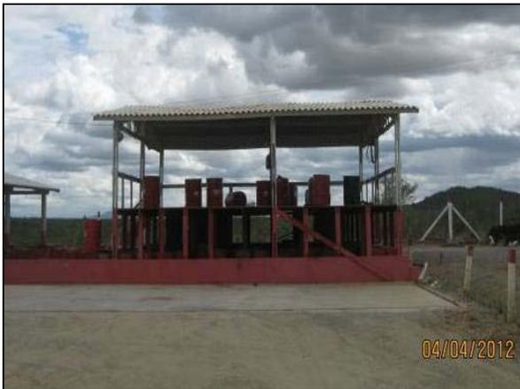
Foto 4.2.287. Óleos e lubrificantes armazenados em baia coberta, com piso impermeabilizado e canaletas ligadas ao SAO do posto de combustível (abr/2012).
