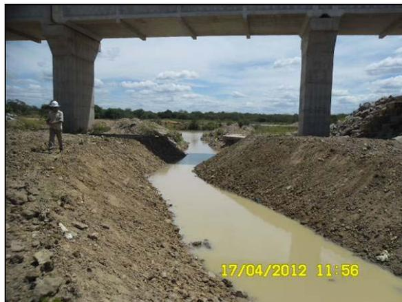
Foto 4.2.117. Canal de drenagem aberto no antigo leito do riacho Saco da Serra tendo em vista manter o fluxo hídrico (abr/2012).
