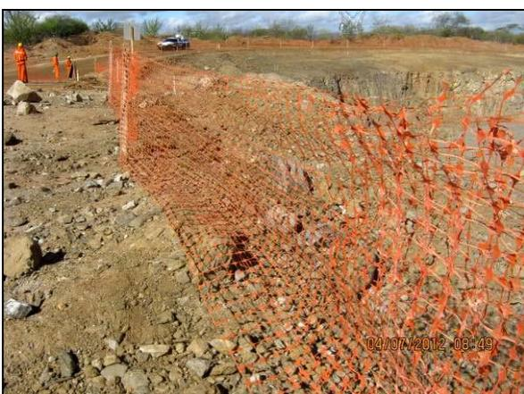
Foto 4.2.220. Implantação de barreira de isolamento, próximo à área de escavação da EBI-3 (jul/2012).
