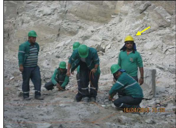
Foto 4.2.111. Implantação de explosivos acompanhado por um Blaster em área de desmonte de rocha (abr/2012).
