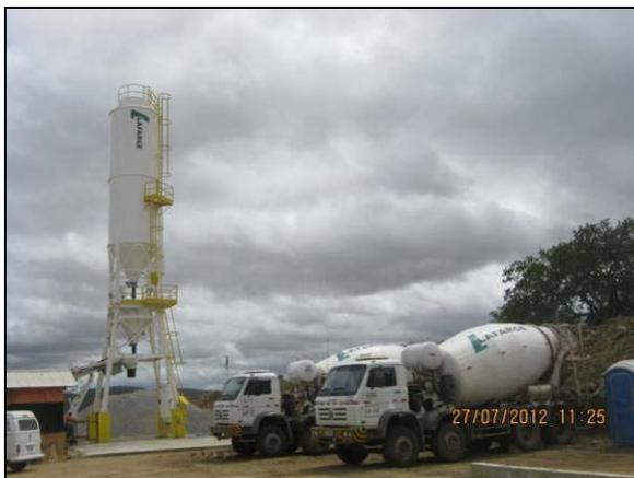
Foto 4.2.95. Central de concreto instalada no segmento de canal WBS 1210 (jul/2012).
