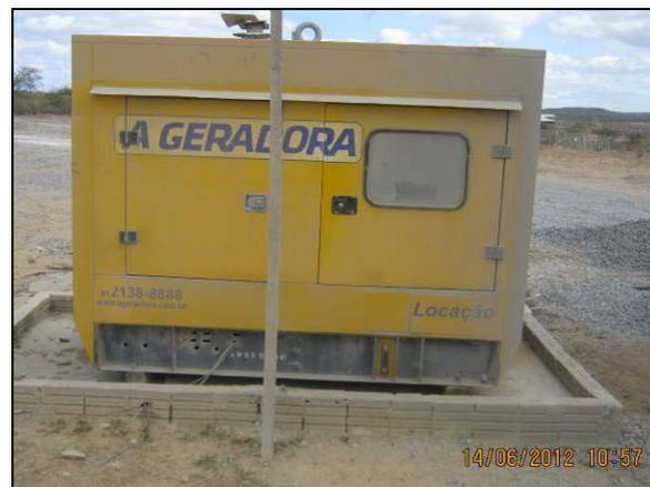
Foto 4.2.27. Gerador de energia da central de concreto disposto sobre bacia de contenção ligada à caixa de retenção de óleo (jun/2012).
