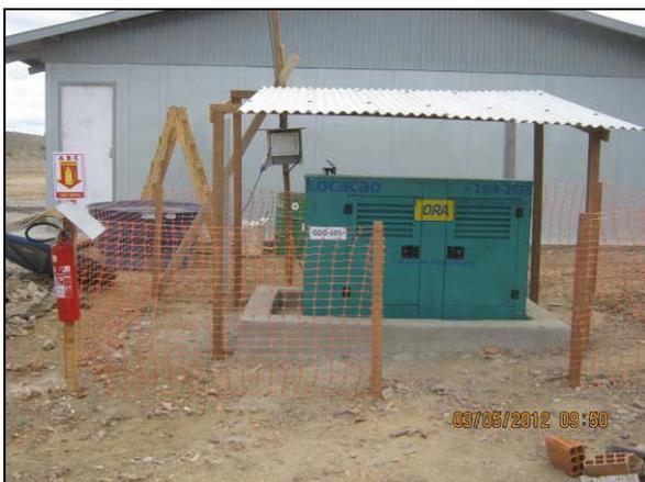
Foto 4.2.242. Gerador disposto sobre bacia de contenção no escritório de apoio da EBI-1 (maio/2012).
