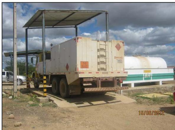
Foto 4.2.343. Posto coberto, com piso impermeabilizado e canaletas ligadas ao SAO (jun/2012).
