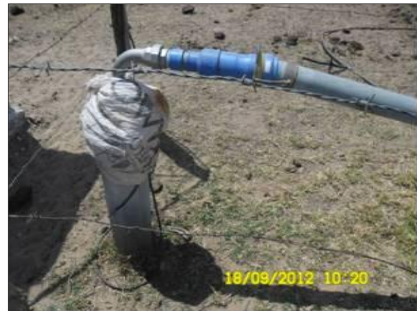
Foto 26 - Detalhes do Poço 14.
