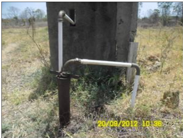
Foto 50 - Vista do Poço localizado na ME do Reservatório Eng. Ávido.
