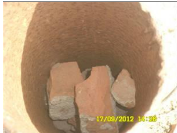
Foto 12 - Detalhes da obstrução do Poço 07.
