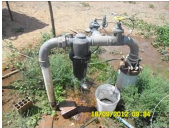
Foto 24 - Detalhes do Poço 13.
