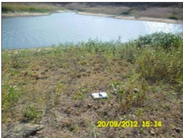
Foto 58 - Vista para jusante da ME do Reservatório Eng. Ávido contendo o local onde deveria estar o poço 27.
