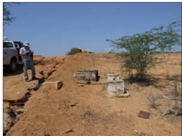
Foto 70 - Vista para montante do talude da futura Barragem Mandantes, contendo o poço abandonado.
