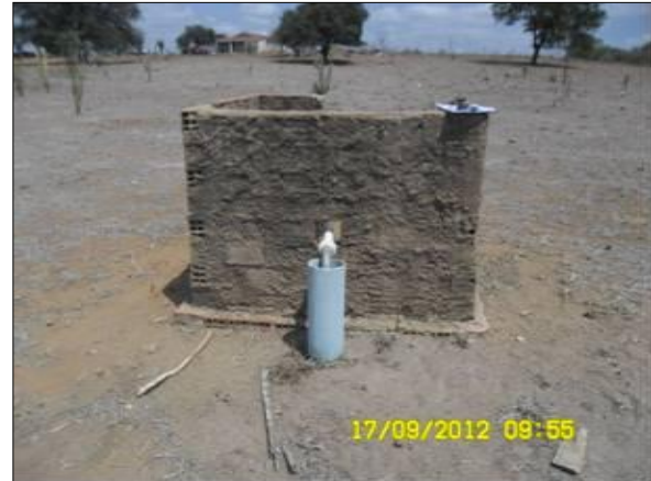
Foto 5 - Vista para montante do Poço na planície de inundação do Talvegue intermitente que drena o futuro Reservatório Terra Nova.
