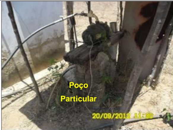
Foto 56 - Vista do Poço localizado na ME do reservatório Eng. Ávido.
