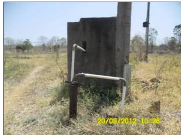
Foto 51 - Vista do Poço localizado na ME do Reservatório Eng. Ávido.
