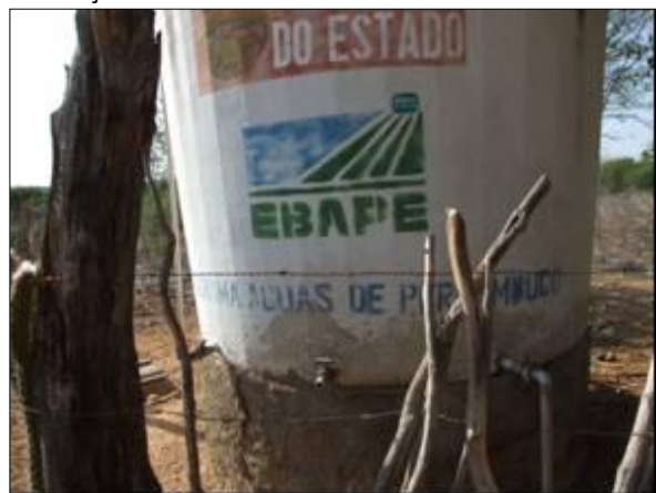
Foto 130 - Vista do reservatório de água próximo ao poço.
