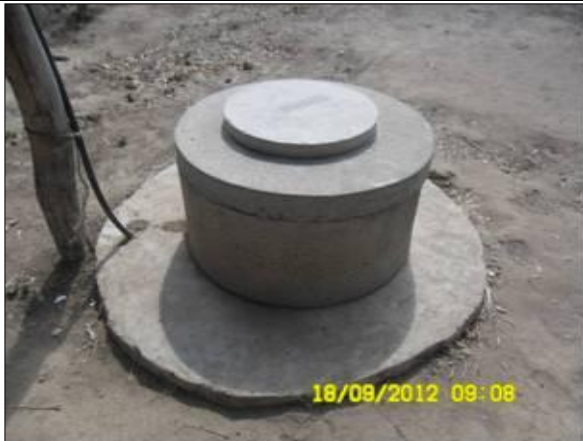
Foto 19 - Detalhes do Poço 12.
