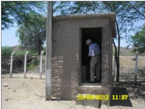
Foto 148 - Vista da casa de bombas para a MD da planície de inundação do talvegue intermitente que drena o reservatório Barro Branco.
