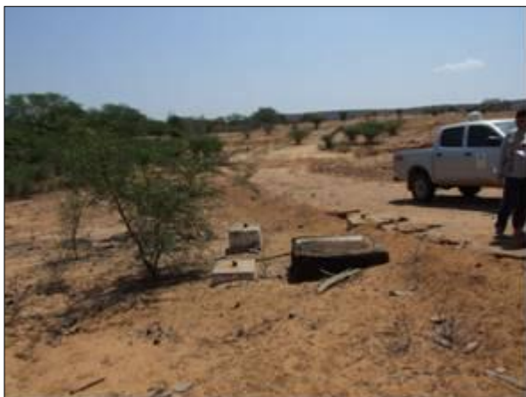
Foto 69 - Vista para montante do talude da futura Barragem Mandantes, observando-se o poço abandonado.
