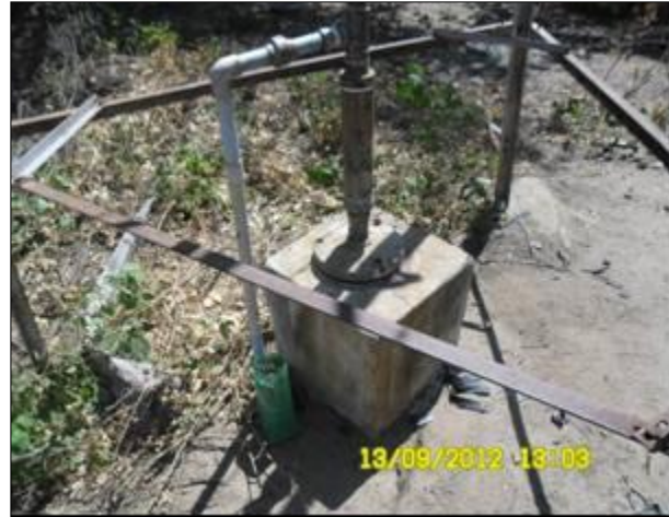
Foto 141 - Detalhe do poço na planície de inundação do talvegue intermitente, que drena o futuro Reservatório Campos.
