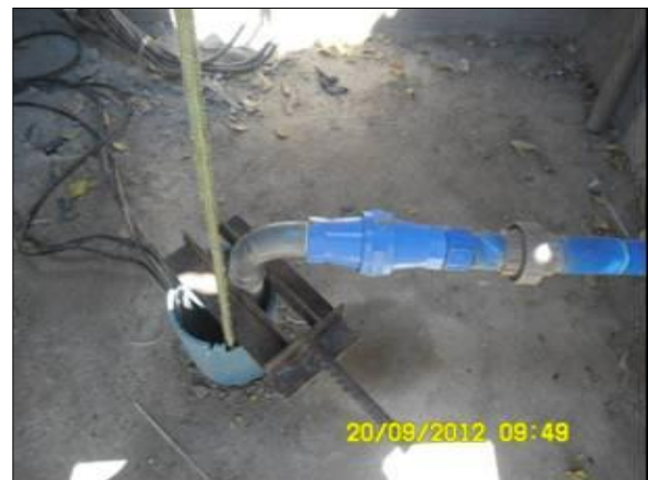
Foto 42 - Detalhes do Poço.
