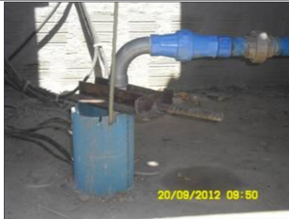
Foto 43 - Detalhes do Poço.
