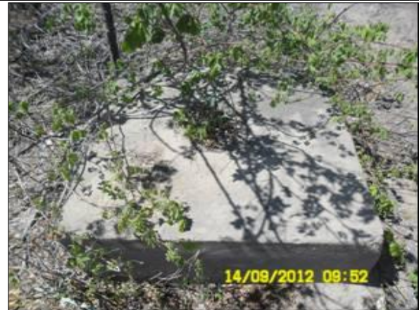
Foto 118 - Detalhe do poço localizado no Ponto 42.
