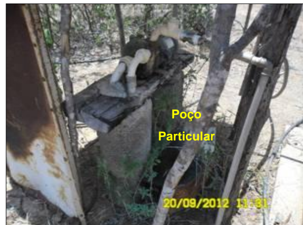
Foto 55 - Vista do Poço localizado na ME do reservatório Eng. Ávido.
