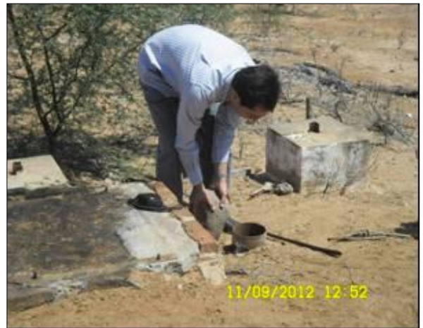
Foto 74 - Vista do poço abandonado no talude de jusante da futura Barragem Mandantes.
