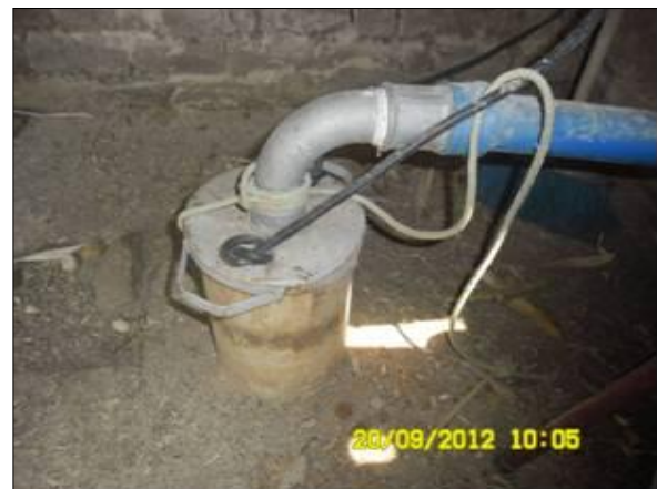
Foto 45 - Vista de detalhes do Poço.
