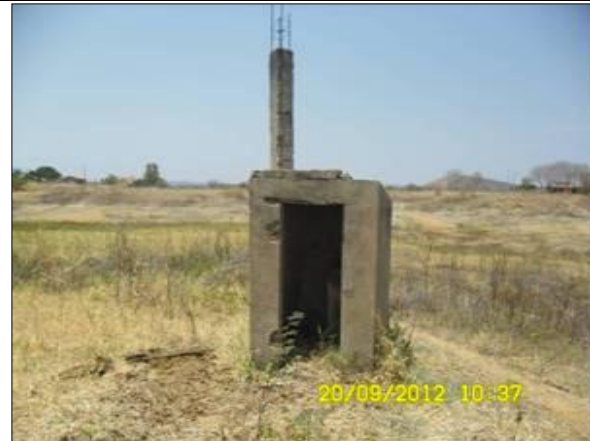
Foto 53 - Vista do Poço localizado na ME do reservatório Eng. Ávido.
