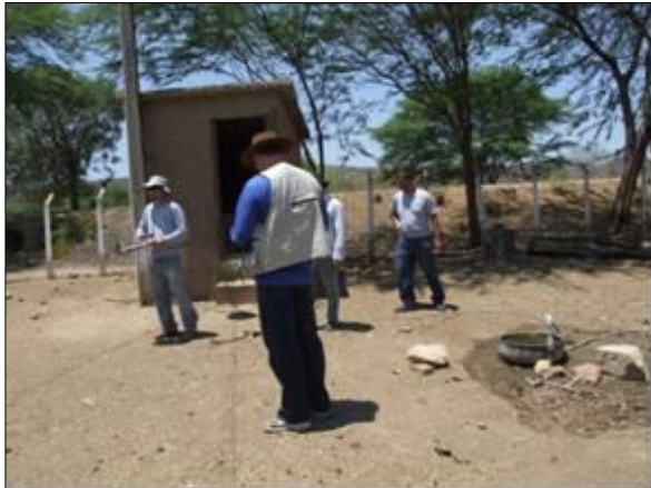
Foto 146 - Vista da casa de bombas para a MD da planície de inundação do talvegue intermitente que drena o reservatório Barro Branco.
