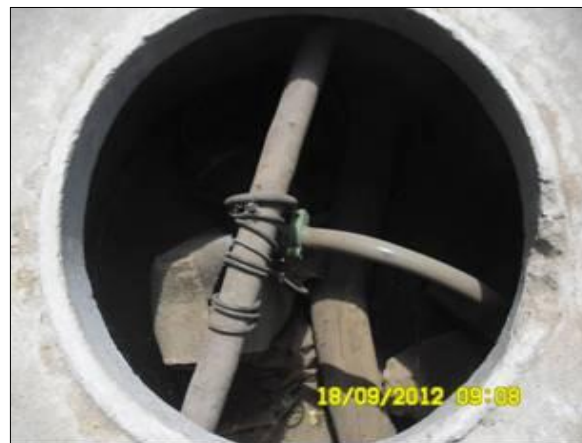
Foto 21 - Detalhes do Poço 12.
