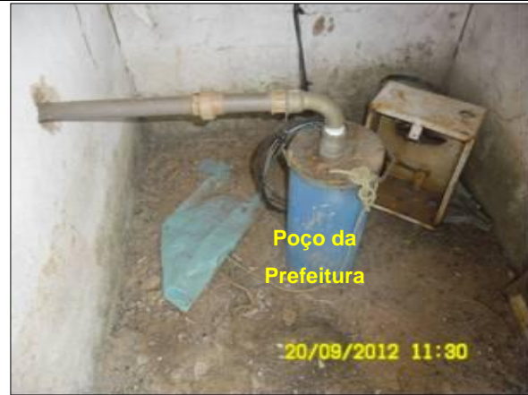
Foto 57 - Vista do Poço localizado na ME do reservatório Eng. Ávido.
