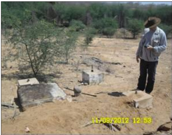
Foto 73 - Vista para jusante do talude da futura Barragem Mandantes, observando-se o poço abandonado.
