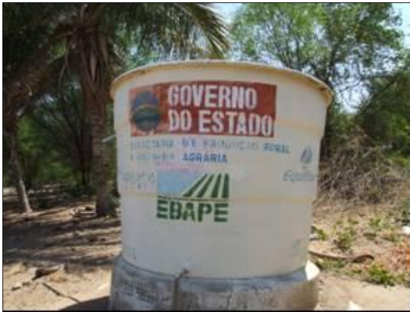
Foto 142 - Detalhe da caixa d'água.
