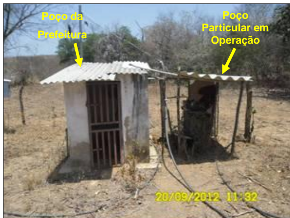
Foto 54 - Vista do Poço localizado na ME do reservatório Eng. Ávido.
