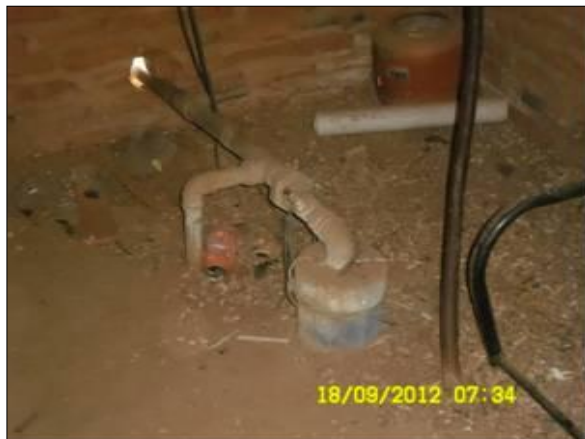
Foto 17 - Detalhes do Poço 11.
