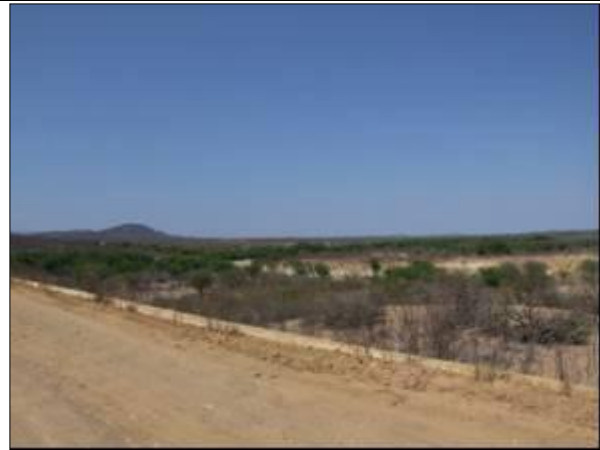
Foto 82 - Vista da ombreira direita para jusante.
