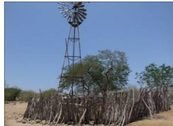
Foto 80 - Vista do catavento que encontra-se em pleno funcionamento.
