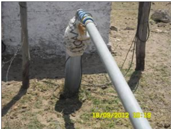
Foto 25 - Detalhes do Poço 14.
