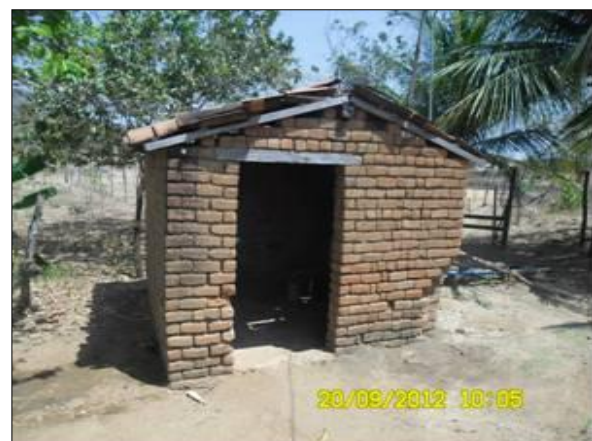
Foto 47 - Vista de detalhes da casa de abrigo do poço.
