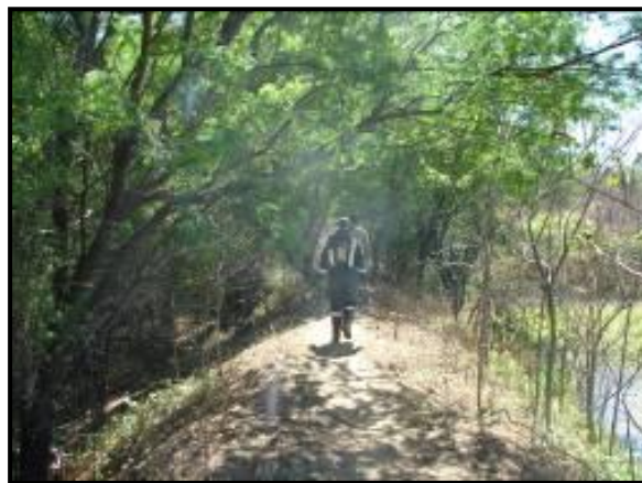
Foto 4.23.286. Remoção de expurgo Lote 3 Eixo Norte (Junho/2011).
