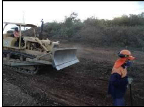
Foto 4.23.293. Remoção de expurgo Lote 3 Eixo Norte (Junho/2011).
