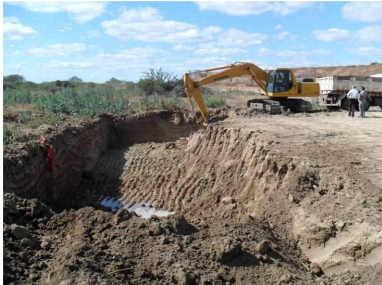
**Foto 113 – Escavação e carga de solo orgânico (top soil) para recuperação de áreas.
