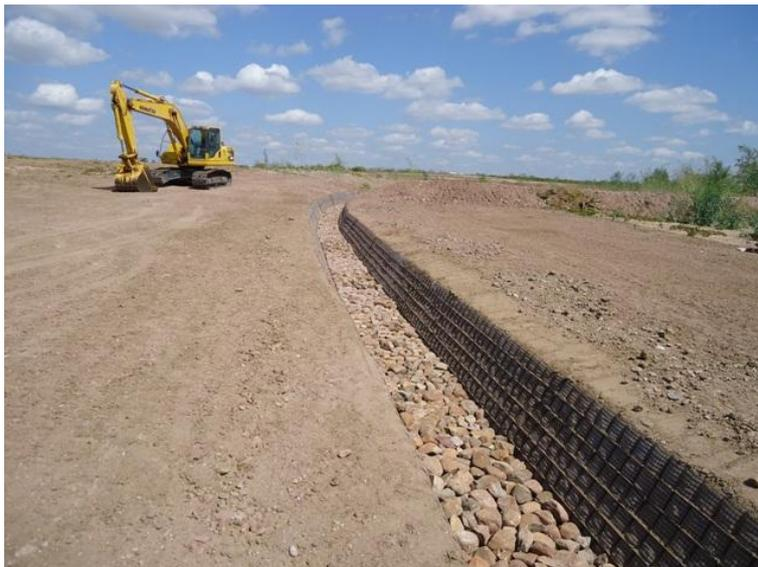
**Foto 30 – Calha de drenagem (Ecocalha). Dezembro 2011.**
