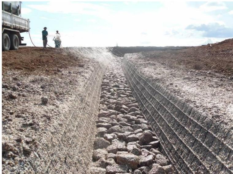
**Foto 14 – Execução de hidrossemeadura para revegetação da calha de drenagem (Ecocalha). Junho/2010.**
