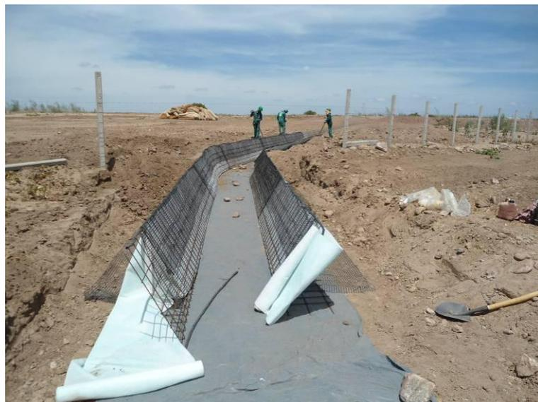
**Foto 32 – Execução de calha de drenagem (Ecocalha). Janeiro/2012.**
