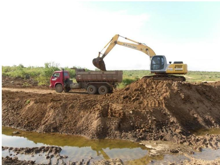
**Foto 2 – Carga e transporte de solo orgânico para recuperação de áreas degradadas. Junho/2009.**
