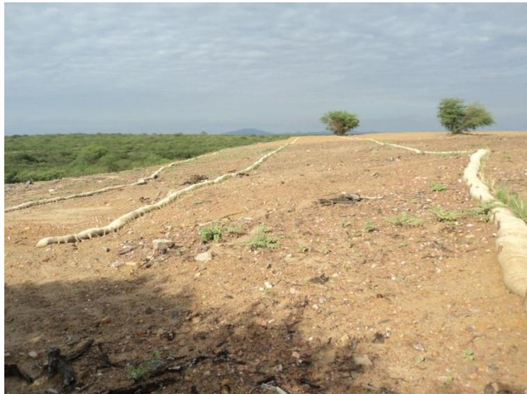
**Foto 10 – Aplicação de retentores de sedimentos.**
