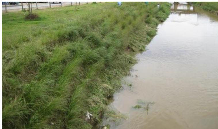
**Foto 7 – Aplicação de barreiras Vetiver em margem fluvial.**
