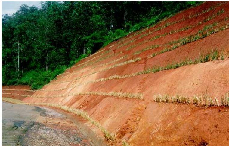
**Foto 8 – Aplicação de barreiras com capim Vetiver em talude de corte íngreme.**
