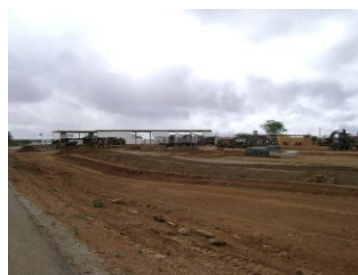
Figura III-5: Canteiro em fase de instalação – Eixo Norte
