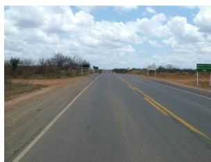
Figura III-7: Sinalização instalada estrada principal
