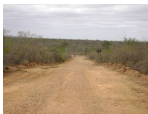
Figura III-6: Recuperação e manutenção de acesso existente
