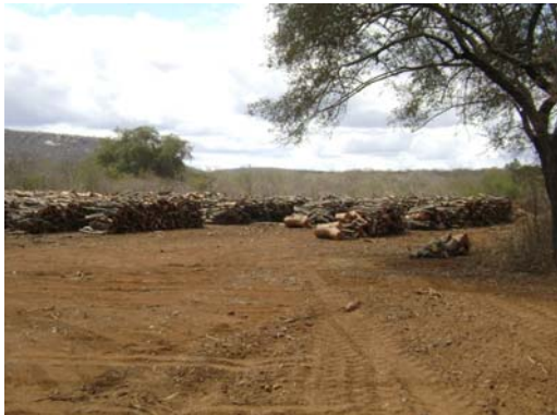
Madeira empilhada no local de barramento do reservatório Tucutu. Primeira quinzena de setembro, 2007.
