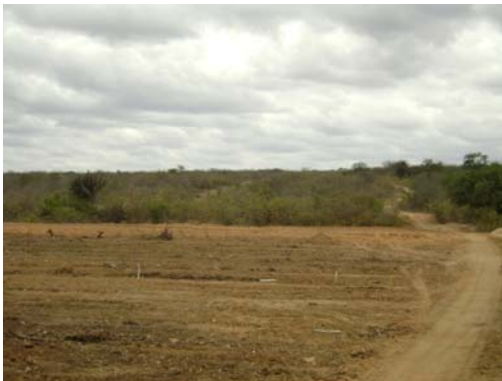
Vista parcial da supressão de vegetação em fase de finalização. Local: futuro barramento do reservatório Tucutu. Primeira quinzena de setembro, 2007.
