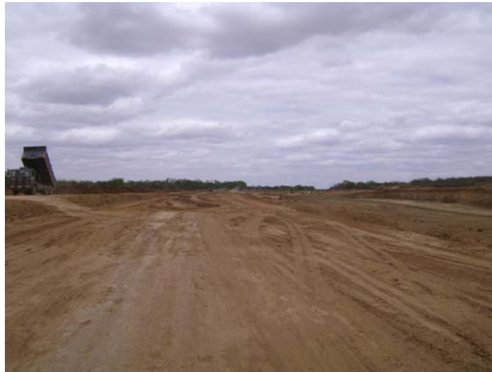
Terraplanagem no canal de aproximação do eixo norte. Primeira quinzena de setembro, 2007.
