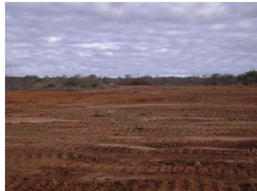
Vista parcial da supressão de vegetação em fase de finalização. Local: futuro barramento do reservatório Areias. Primeira quinzena de setembro, 2007.
