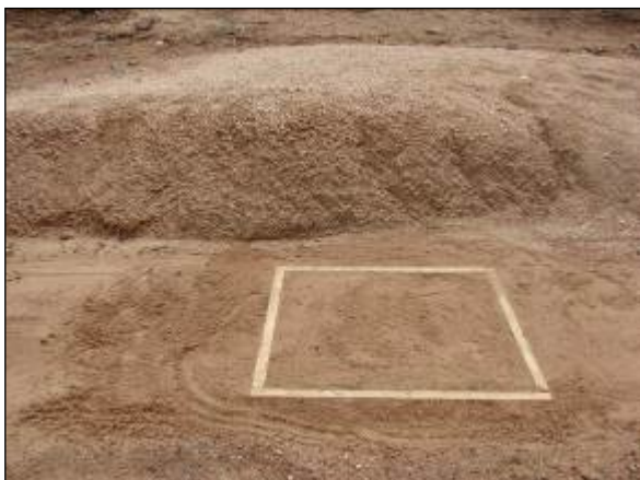
Foto 4.23.4.4. Instalação dos moldes de madeira em Unidade Amostral do PISF.
