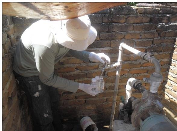
Foto 78. Coleta de amostras de água para análise físico-química e microbiológica (fev/2017).
