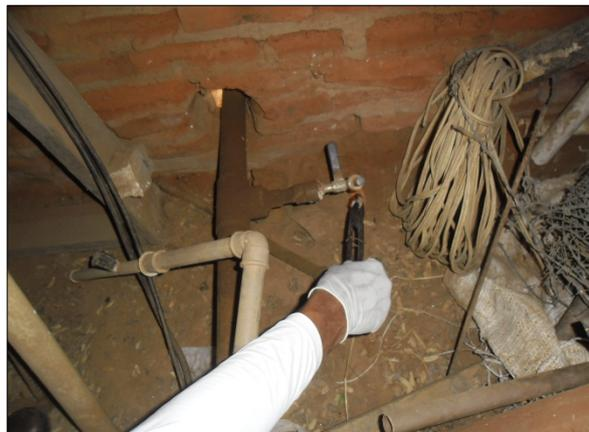
Foto 56. Flambagem anterior à coleta de água para análise físico-química e microbiológica (fev/2017).
