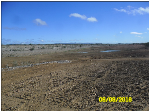
Foto 17. Reservatório Cacimba Nova com acúmulo de água no interior do reservatório (Set/2016).
